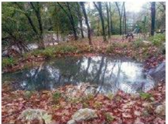
Balsas de fitodepuración conectadas (arriba balsa filtro de gravas y helófitos, y abajo balsa humedal).
