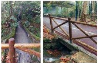
Cuneta lateral para la recogida de agua de escorrentía de la A8.
