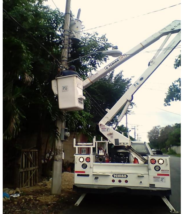
Rehabilitación de luminaria en la Colonia Ejido
