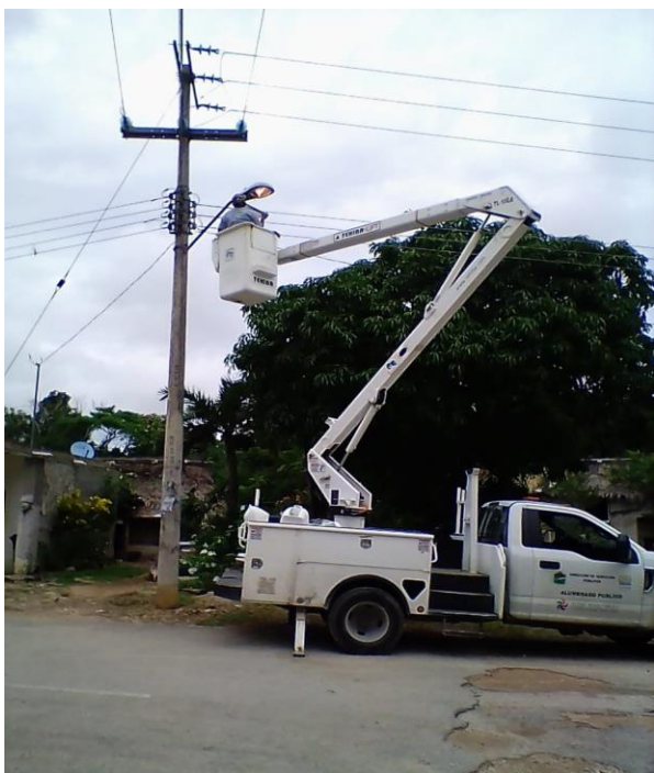
Rehabilitación de luminaria en la comunidad de Hondzonot
