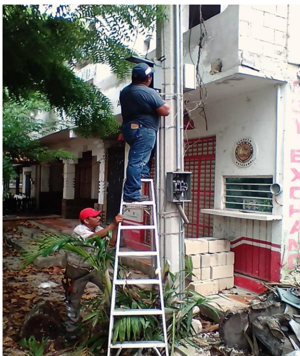
Rehabilitación de sector en la Ciclovía Col. Sac-Be
