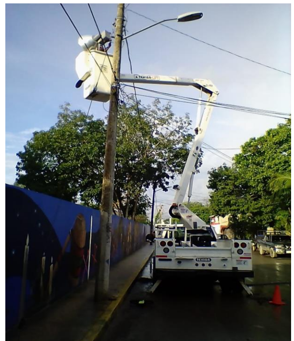
Rehabilitación de luminaria en el Panteón Municipal
