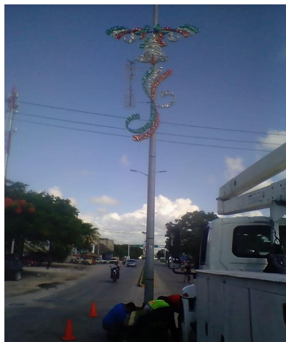
Rehabilitación de poste en la Col. Guerra de Castas
