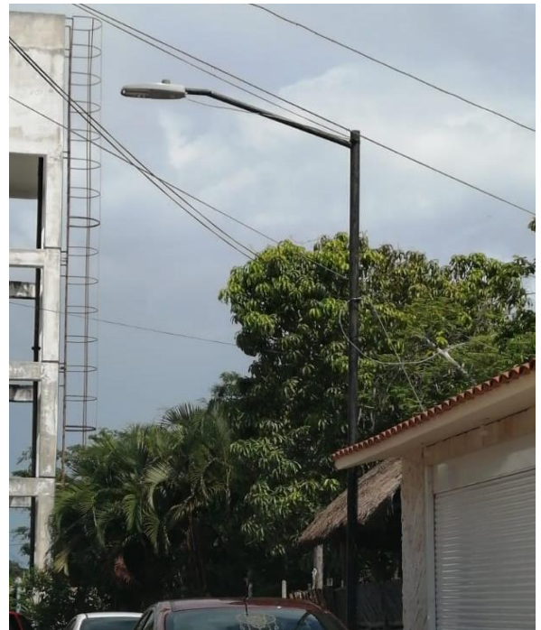
Cambio de luminaria led en la Col. Villas Tulum
