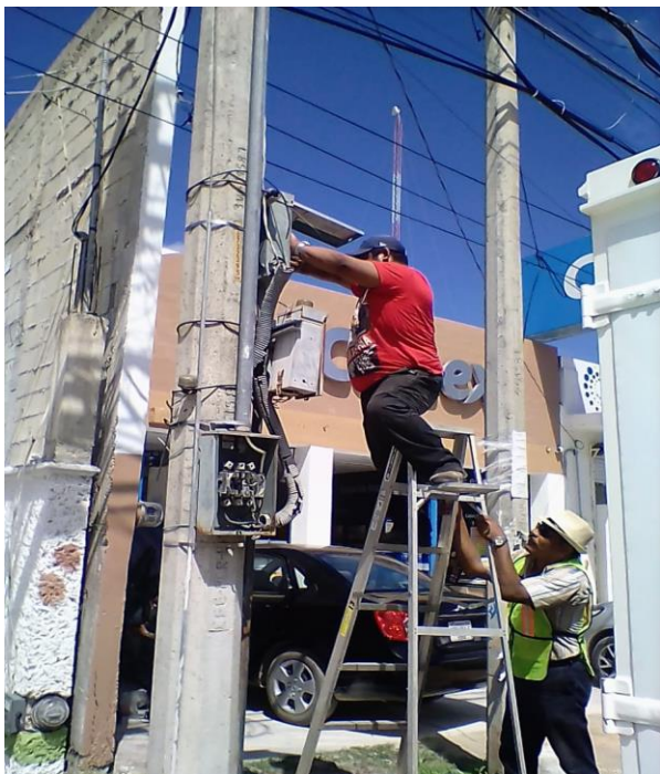
Rehabilitación de sector en la Av. Tulum
