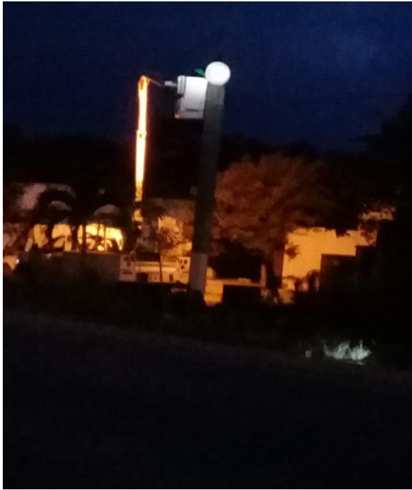
Colocación de reflector en el Filtro Policiaco ubicado en la salida a Coba
