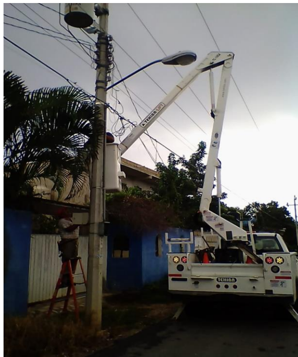
Rehabilitación de sector en la Col. Ejido
