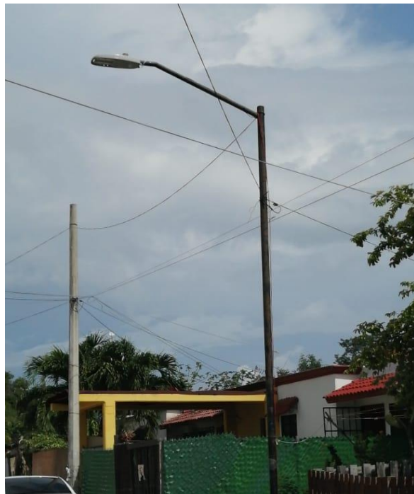
Cambio de luminaria led en la Col. Villas Tulum
