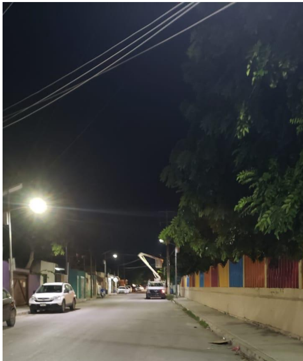
Rehabilitación de luminarias solares en la colonia Centro calle 2 Ote.
