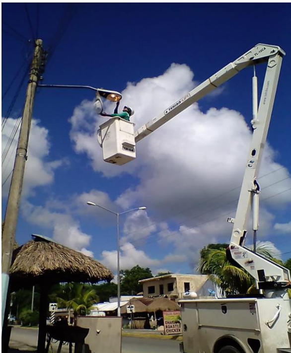
Rehabilitación de luminarias en la comunidad de Macario Gómez
