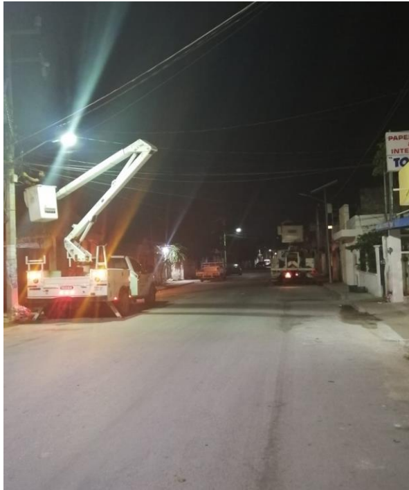
Rehabilitación de luminarias en la colonia Mayapax
