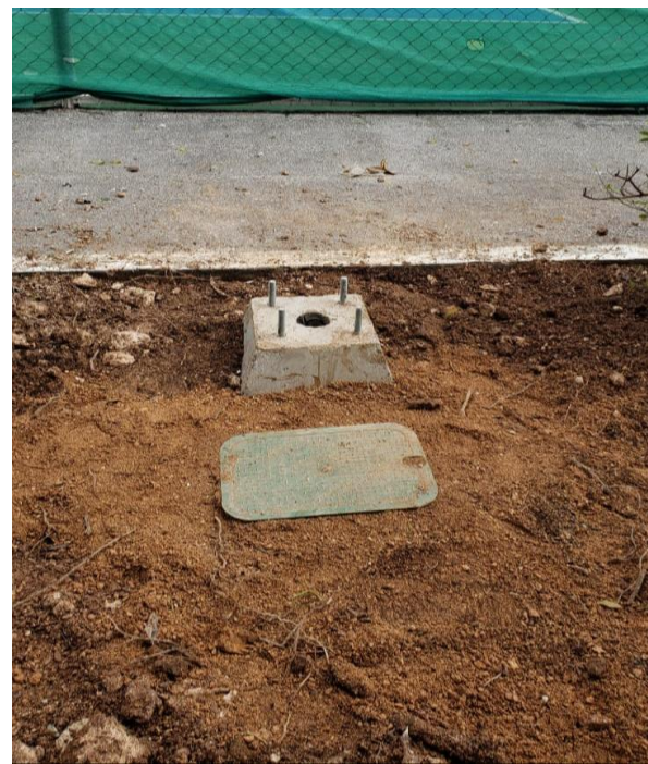
Colocación de dados y registros para instalación de postes
