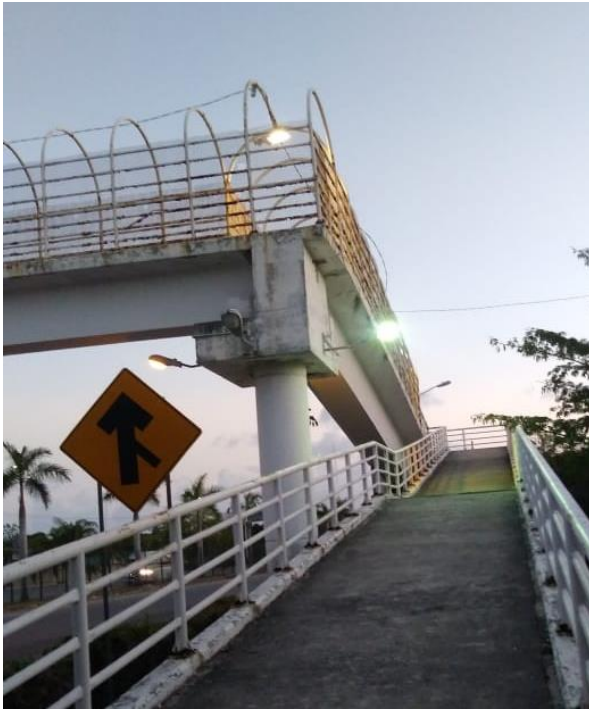
Rehabilitación de luminarias en el puente peatonal de la comunidad de Akumal
