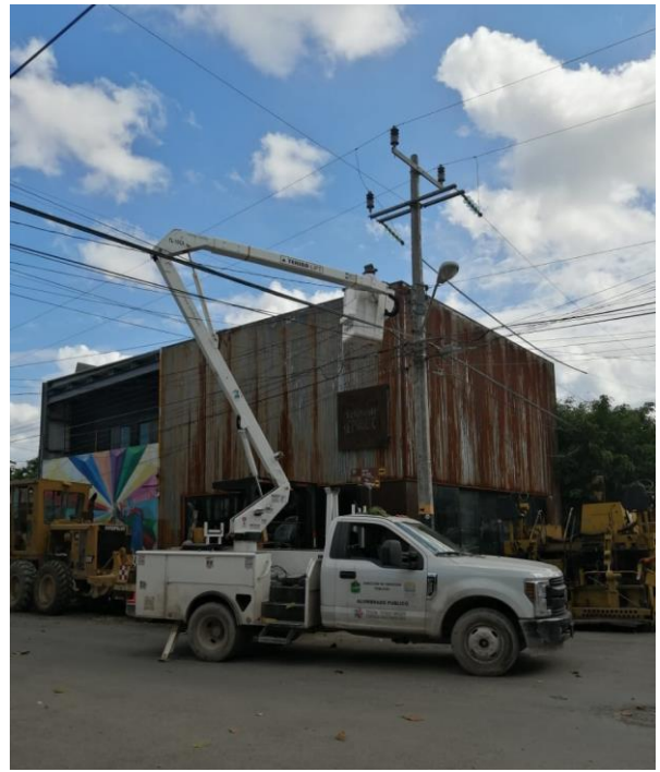
Rehabilitación de luminarias solares en la colonia Centro calle Sol
