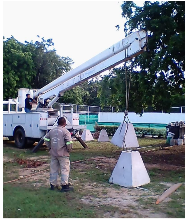
Colocación de dados para postes en la Unidad Deportiva
