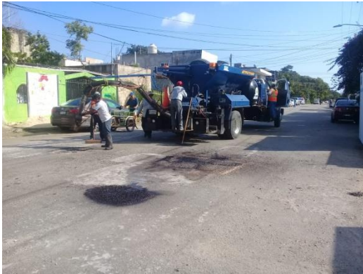
Calle tunkul entre la av. satélite norte
