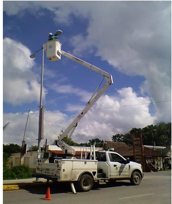
Rehabilitación de luminarias en la comunidad de Francisco Uh May
