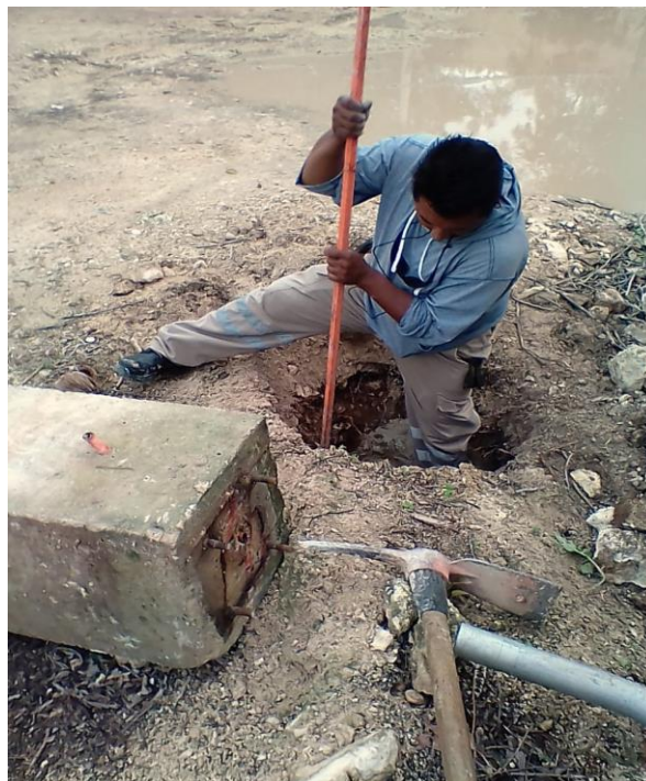
Colocación de dados para poste en la Colonia Tumben Kaa
