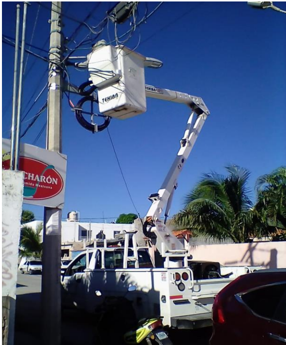
Rehabilitación de luminaria en la Colonia Mayapax
