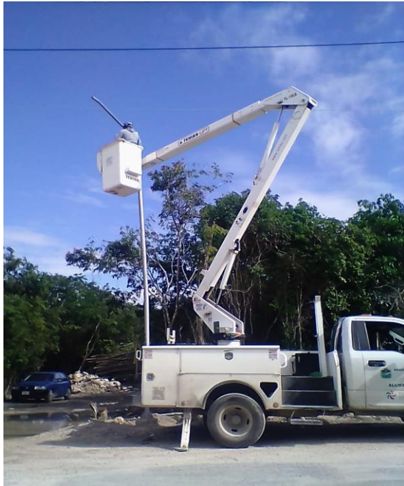
Instalación de poste en la Colonia Tumben Kaa
