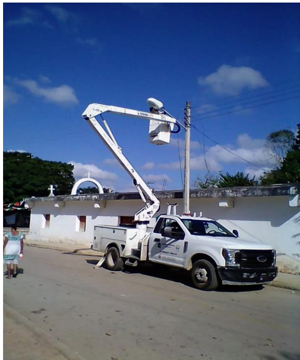
Rehabilitación de luminarias en la comunidad de San Silverio
