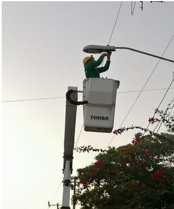
Cambio de luminaria led en la Colonia Ejido
