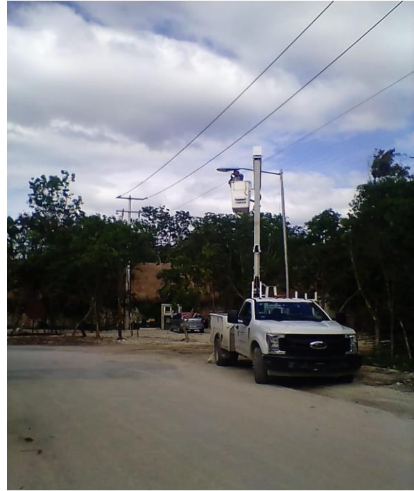
Instalación de luminaria en la Colonia Tumben Kaa
