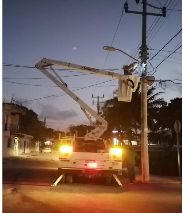
Rehabilitación de sector en la Colonia Huracanes
