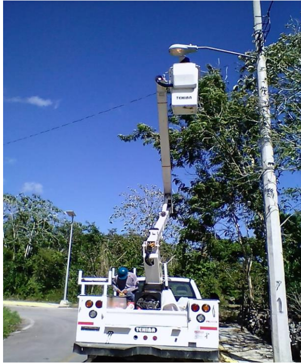
Rehabilitación de luminarias en la comunidad de Chanchen 1
