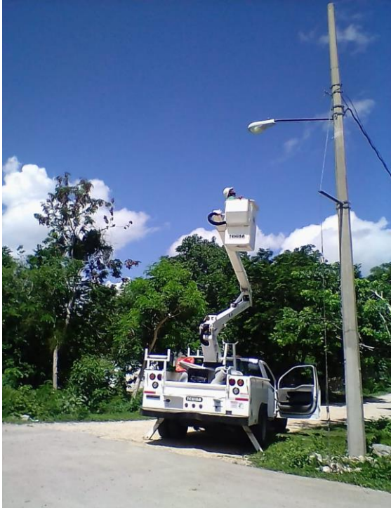
Rehabilitación de luminarias en la Comunidad de Sacabmucuy
