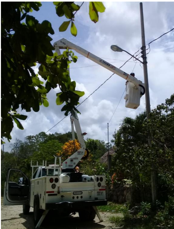
Rehabilitación de luminarias en la Comunidad de Yaxche
