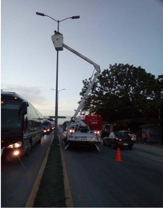
Rehabilitación de luminarias en la Av. Coba
