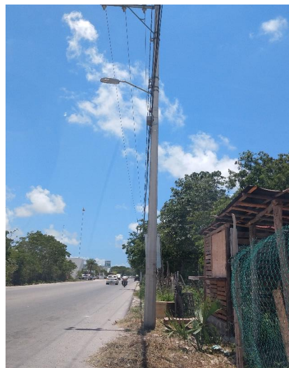
Rehabilitación de luminarias en la Col. Guerra de Castas
