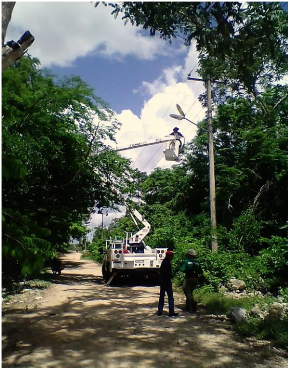
Rehabilitación de luminarias en la Comunidad de Chan Chen 1
