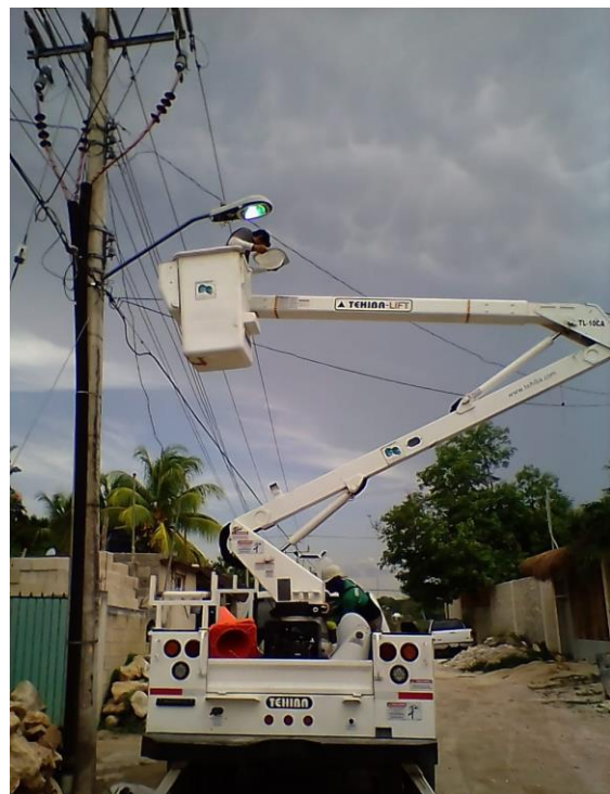
Rehabilitación de luminarias en la Comunidad de Coba
