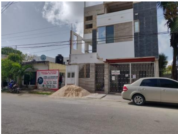
FOTO 7: Material de construcción tipo polvo sobre la vía pública, Tunkul/alfa y omega nte.
