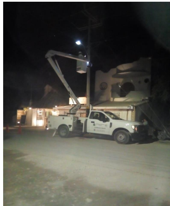
Rehabilitación de luminaria en la Col. Ejido
