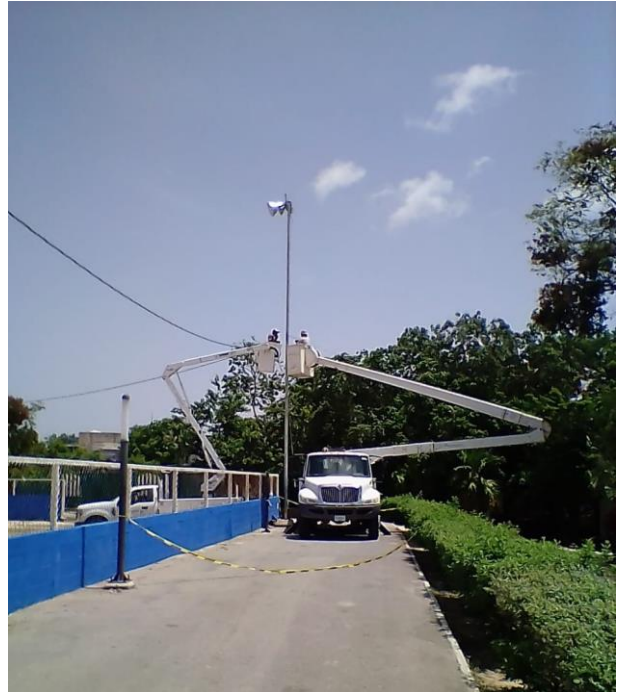
Rehabilitación de poste en la Unidad Deportiva
