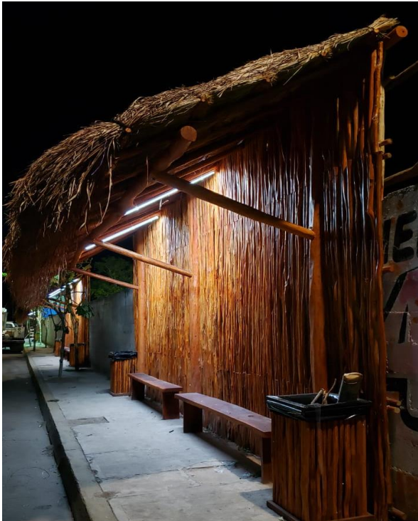
Instalación de lámparas en el paradero
