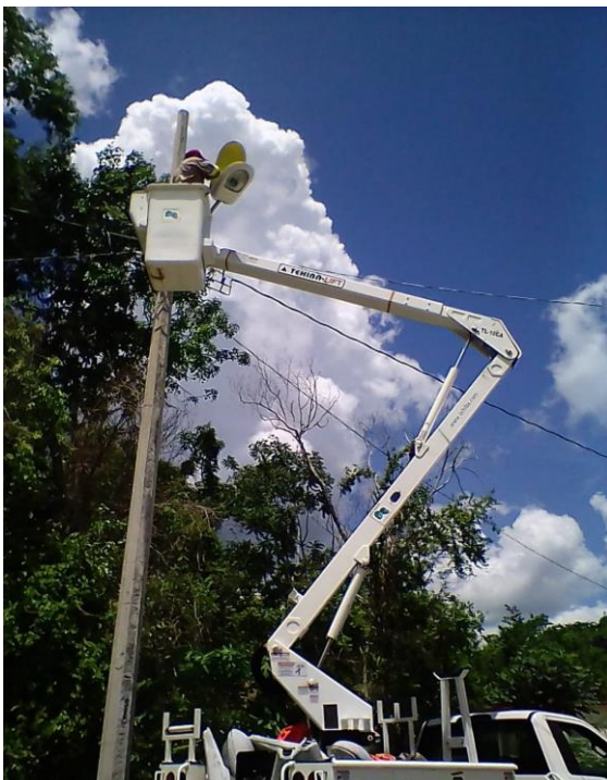
Rehabilitación de luminarias en la Comunidad de Hondzonot
