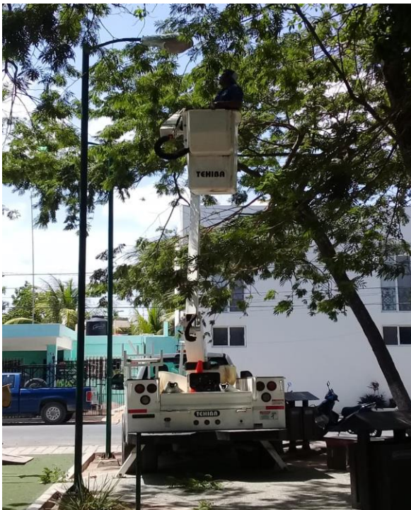
Rehabilitación de luminarias en el Parque de la Croc.
