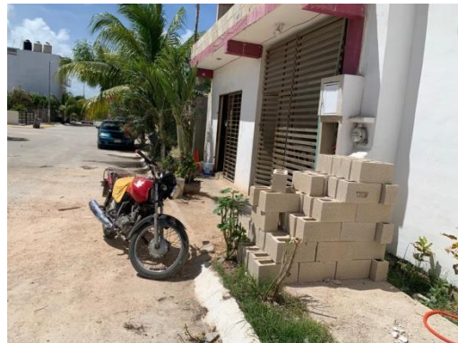
FOTO 4: Sanción por hacer caso omiso a notificaciones anteriores (F:1265,1299), donde se le solicita retirar material para la construcción tipo block que esta sobre la vía publica, C. Bubullek/Libra nte/Escorpión nte.
