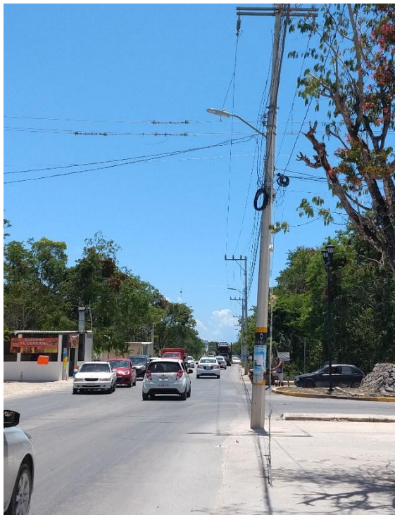
Rehabilitación de luminarias en la Col. Maya Paax
