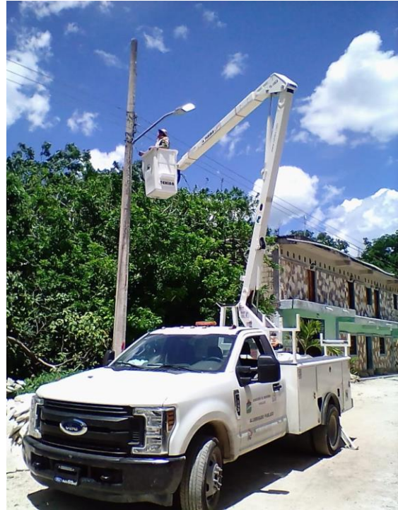
Rehabilitación de luminarias en la Comunidad de San Juan
