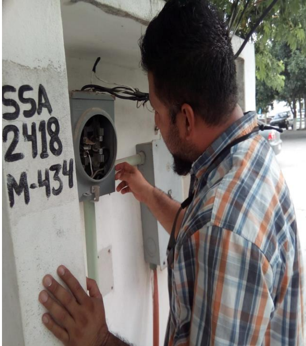
Revisión de la base de medidor en el DIF
