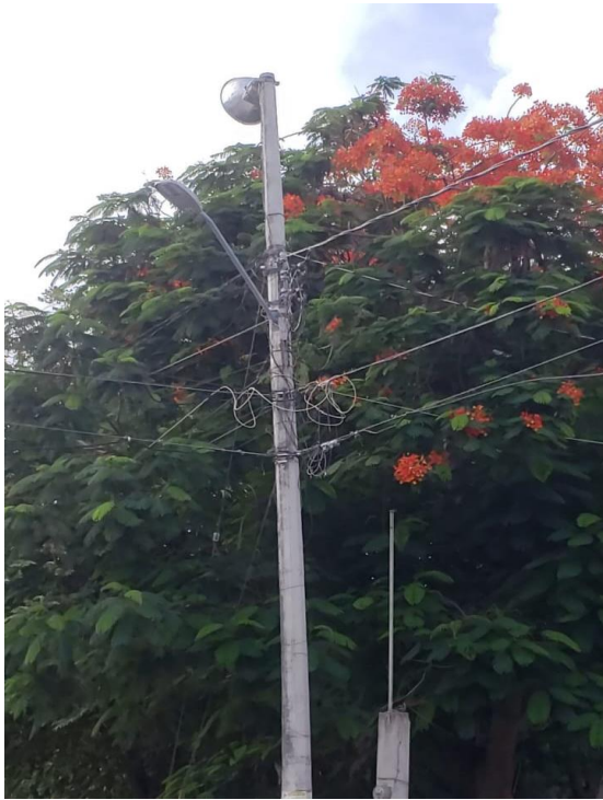
Rehabilitación de luminarias en colonia Maya
