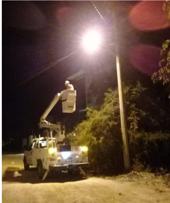
Rehabilitación de luminarias en la calle 5 Sur de la Colonia Veleta
