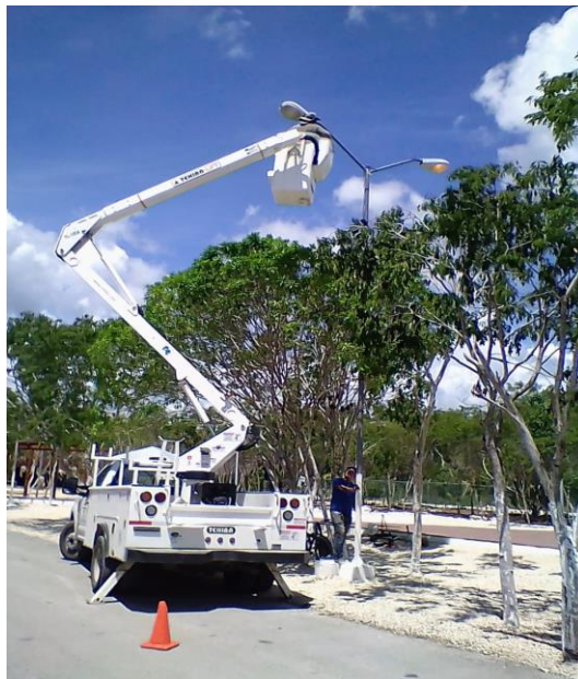
Rehabilitación de luminaria en la Colonia Tumben Ka Av. 1
