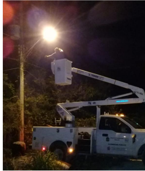
Rehabilitación de luminaria en la calle Asunción de la Colonia Veleta
