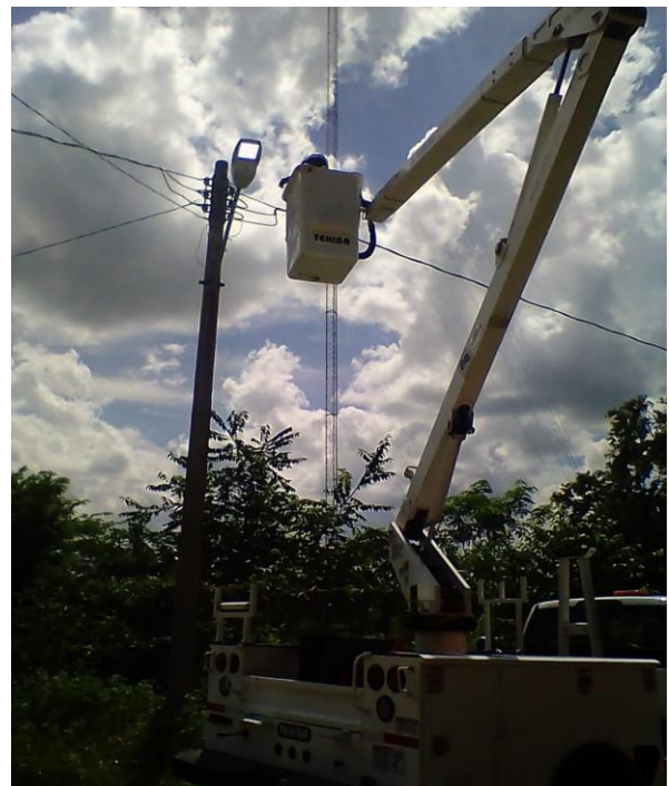
Rehabilitación de luminaria en la Comunidad de San Silverio
