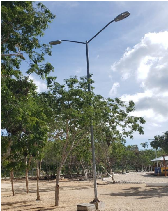
Cambio de luminaria a led en la Colonia Tumben K a Av 1
