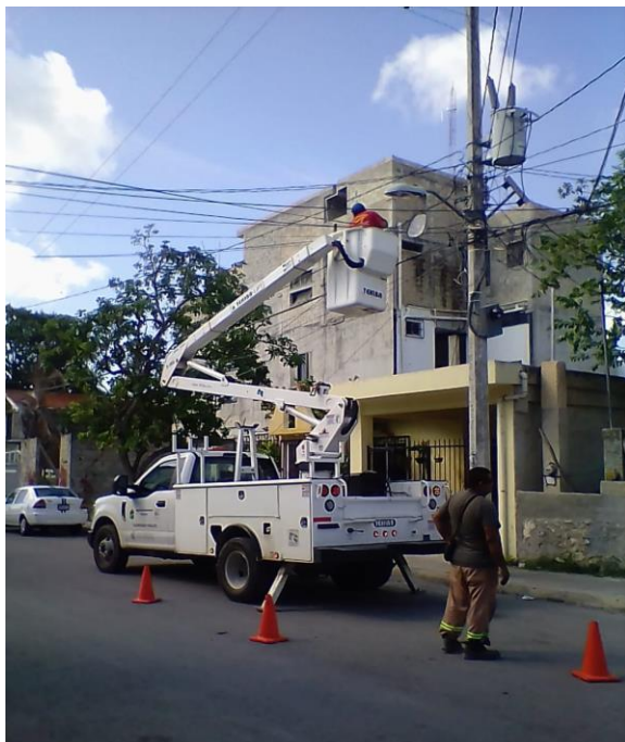
Rehabilitación de luminaria en la Colonia Centro
