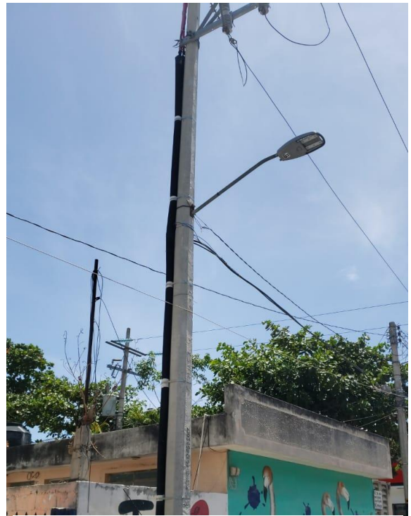
Cambio de luminaria a led en la Colonia Lakin
