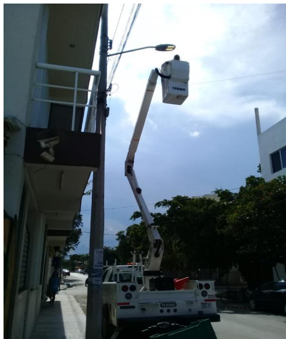
Rehabilitación de luminaria en la Colonia Huracanes
