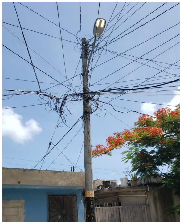
Cambio de luminaria a led en el Fraccionamiento Huracanes
