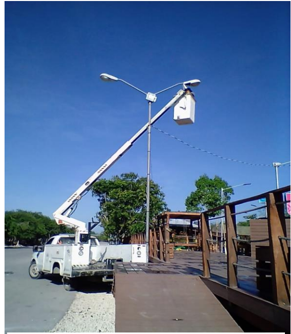
Rehabilitación de luminaria en la Colonia Tumben
