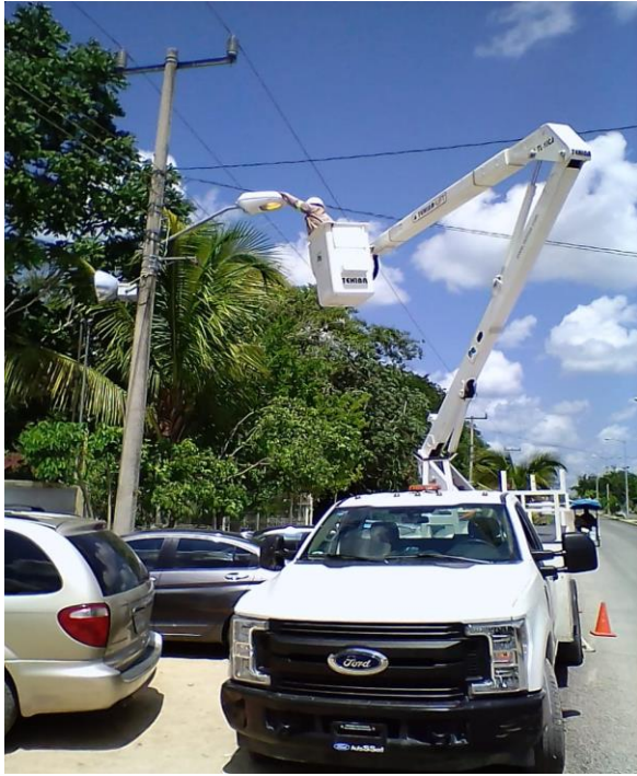
Rehabilitación de luminaria en la Comunidad de Francisco Uh May
