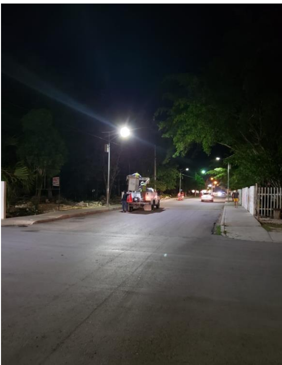
Rehabilitación de luminaria en la Comunidad de Manuel Antonio Ay
