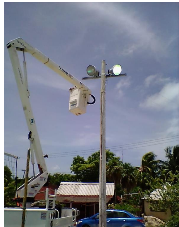
Rehabilitación de luminaria en la Comunidad de Punta Allen
