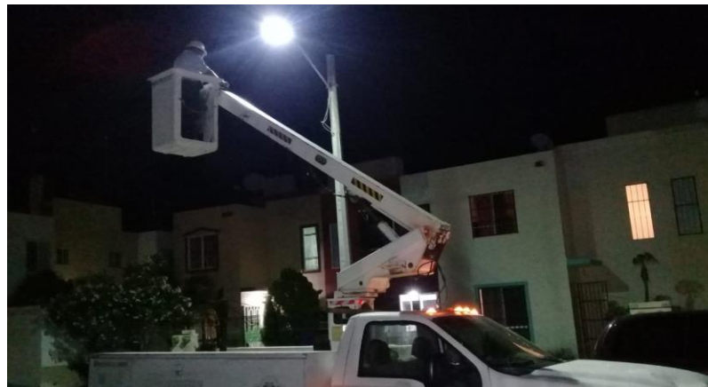
Rehabilitación de luminaria en la Colonia Ejido
