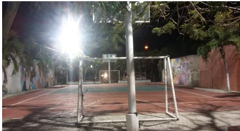
Rehabilitación de reflectores en el parque de la Colonia Villas Tulum
