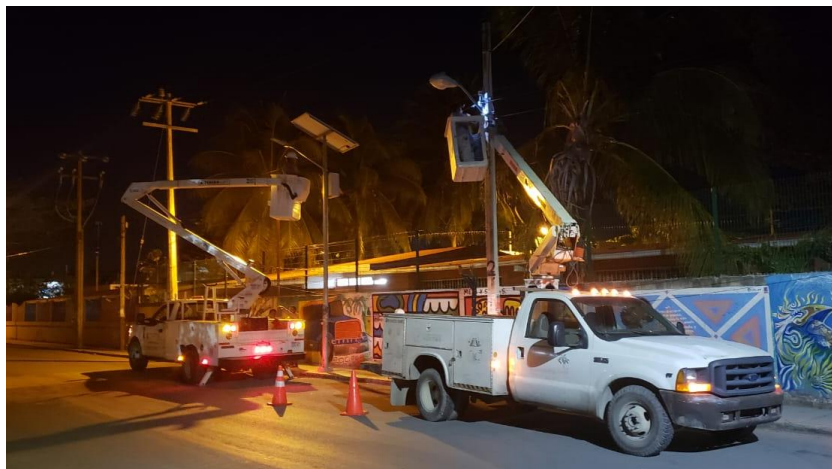
Rehabilitación de luminarias solares tipo led
