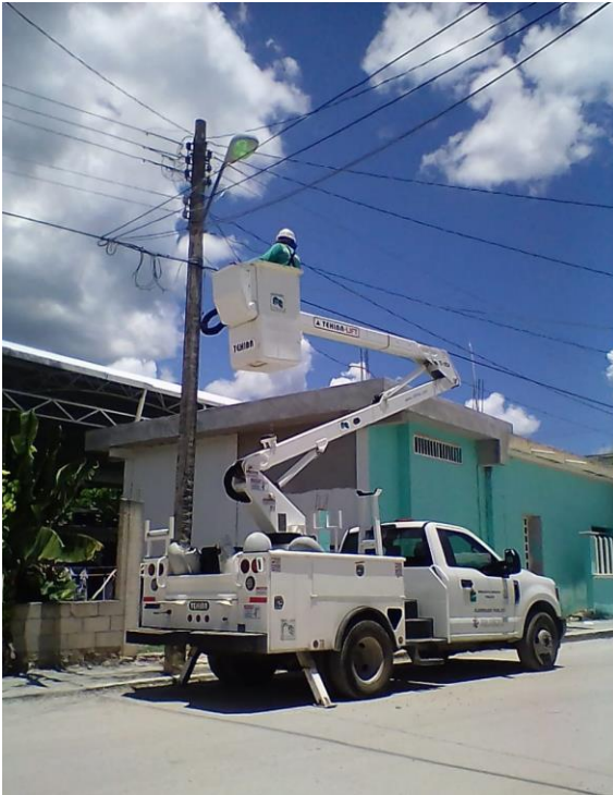
Rehabilitación de luminaria en la Comunidad de Coba
