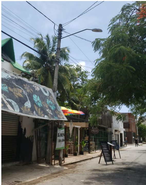
Cambio de luminaria led en la Colonia Centro
