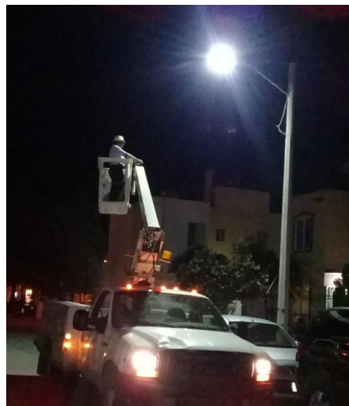
Rehabilitación de luminaria en el Fraccionamiento las Palmas 2
