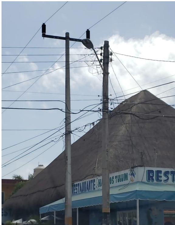
Cambio de luminaria led en la Colonia Lakin
