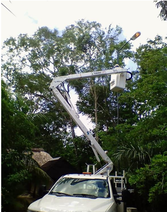
Rehabilitación de luminaria en la Comunidad de San Pedro
