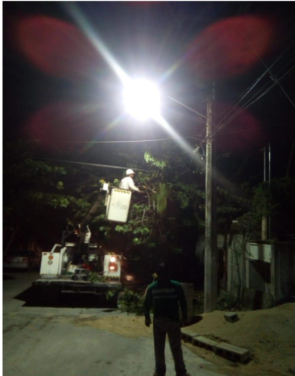
Rehabilitación de lámpara en la Comunidad de Akumal
