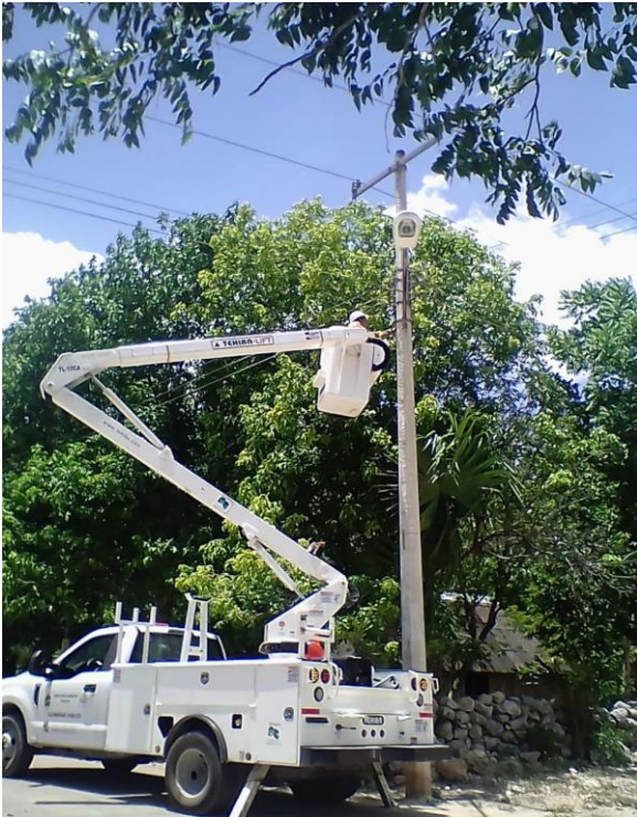
Rehabilitación de luminarias en la Comunidad de Yalchen
