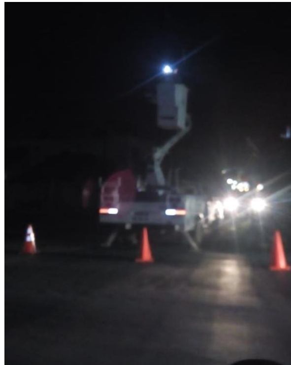
Instalación de reflector en la calle Alfa Colonia Centro
