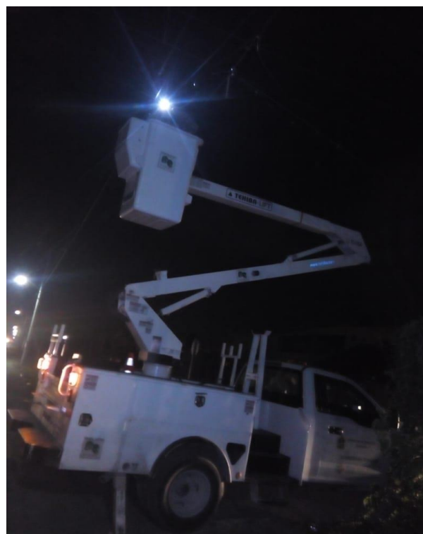
Rehabilitación de luminarias en la Comunidad de Macario Gómez
