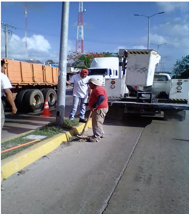
Rehabilitación de postes en la Av. Coba
