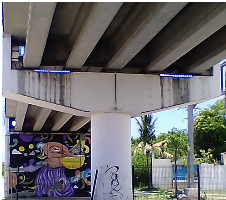
Rehabilitación de lámparas led en el puente de la Comunidad de Chemuyil
