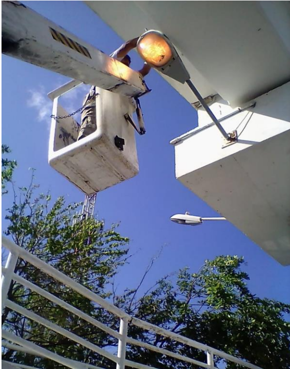
Rehabilitación de luminarias en el puente vial de la Comunidad de Akumal
