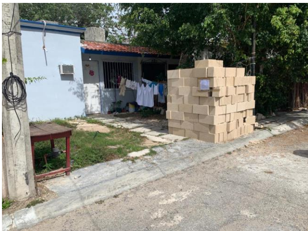
FOTO 3: Material de construcción tipo blocks sobre la vía pública, calle chemuyil/c. 4 ote, fracc Villas Tulum.
