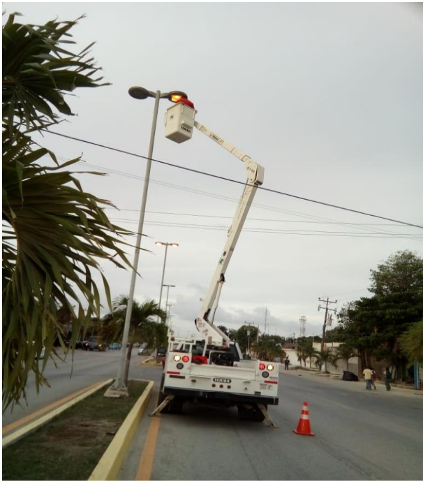
Rehabilitación de luminarias en la Colonia Centro, Av. Principal
