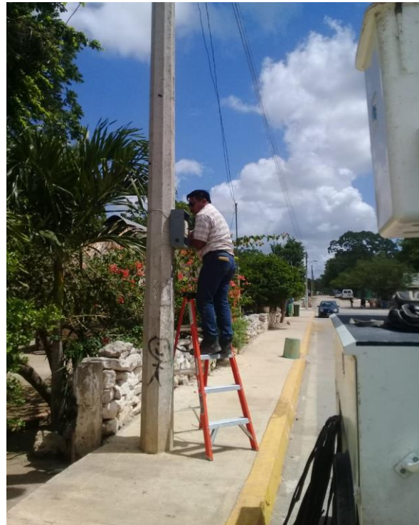
Rehabilitación de sector en la Comunidad de Chanchen 1
