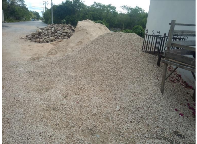
FOTO 2: material de construcción sobre la vía pública. En la calle chanchen/ zazol-ha y nicté-ha, col. Ejido.
