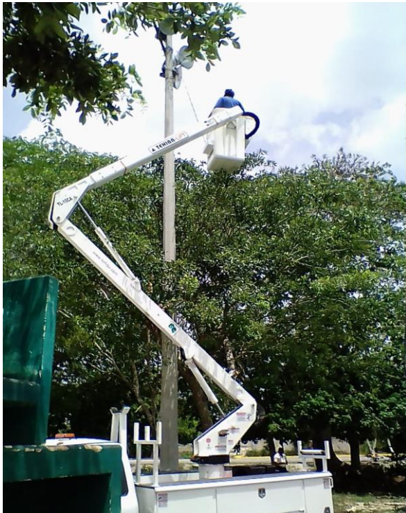
Instalación de reflectores en la Escuela de la Comunidad de Coba
