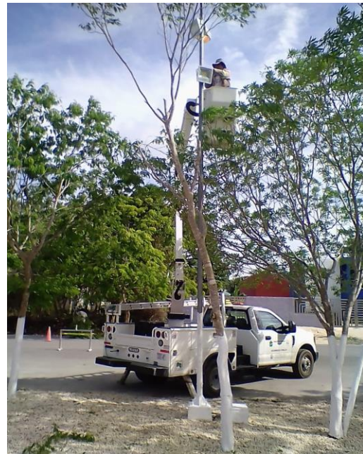
Instalación de reflectores en el parque La Alearía de la colonia Tumben Kaa
