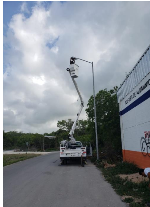
Rehabilitación de lámpara en la colonia Xul- Ká
