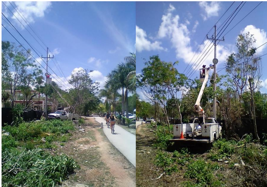
Rehabilitación de lámparas en la Ciclovía rumbo a Boca Paila
