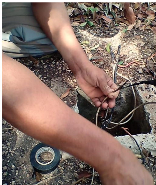
Revisión de registros de línea subterránea en la colonia Palmas
