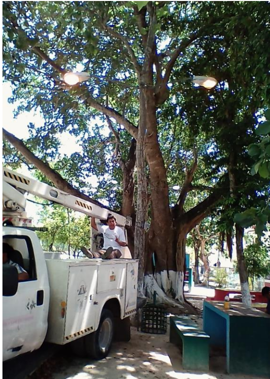
Rehabilitación de lámpara en el parque Xel-Ha de la Comunidad de Chemuyil
