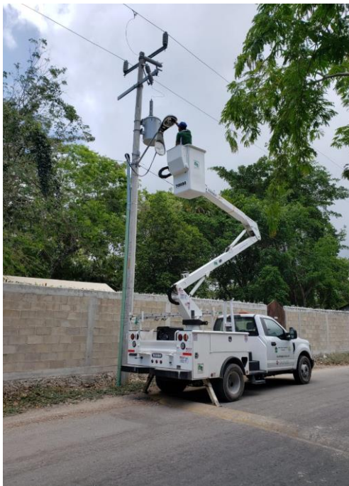
Rehabilitación de lámpara en la colonia Centro
