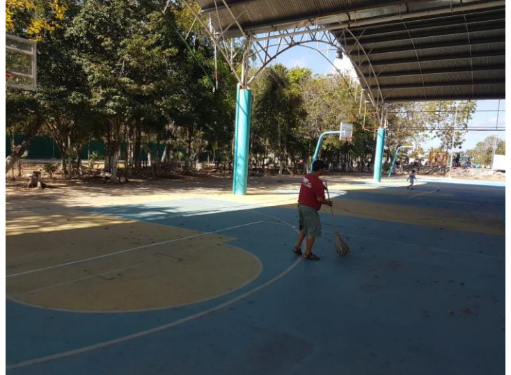
Barrido en la cancha del doble domo de la unidad deportiva de la ciudad de Tulum
