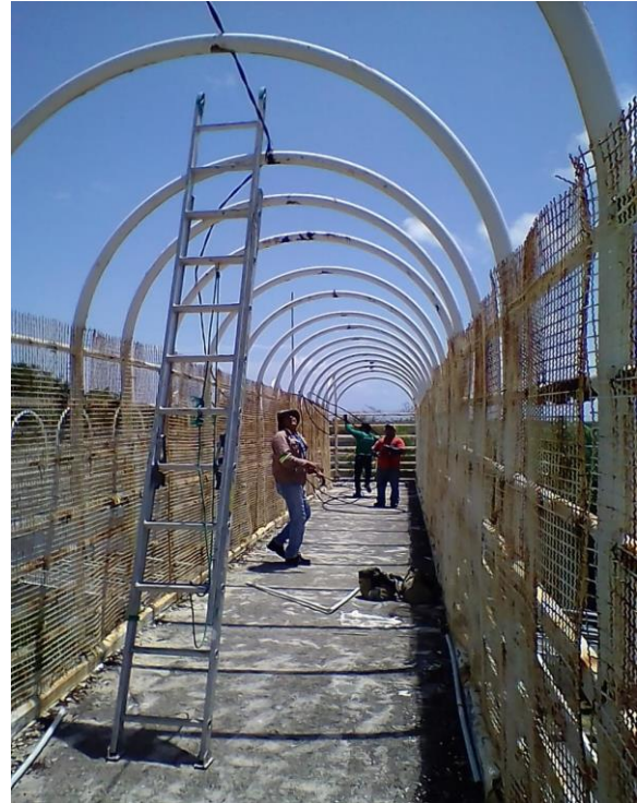
Se rehabilitaron líneas en el puente peatonal de la comunidad de Chemuyil.
