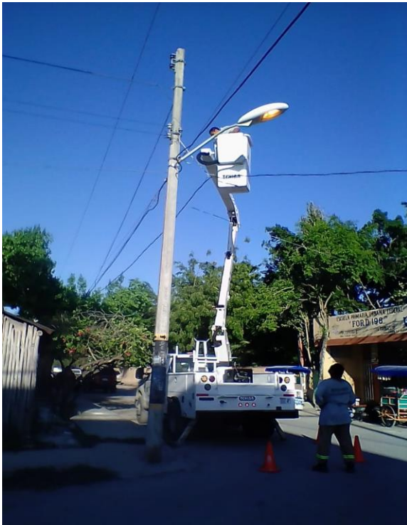
Se rehabilitaron de lámparas que estaban apagadas en la colonia Lakin.
