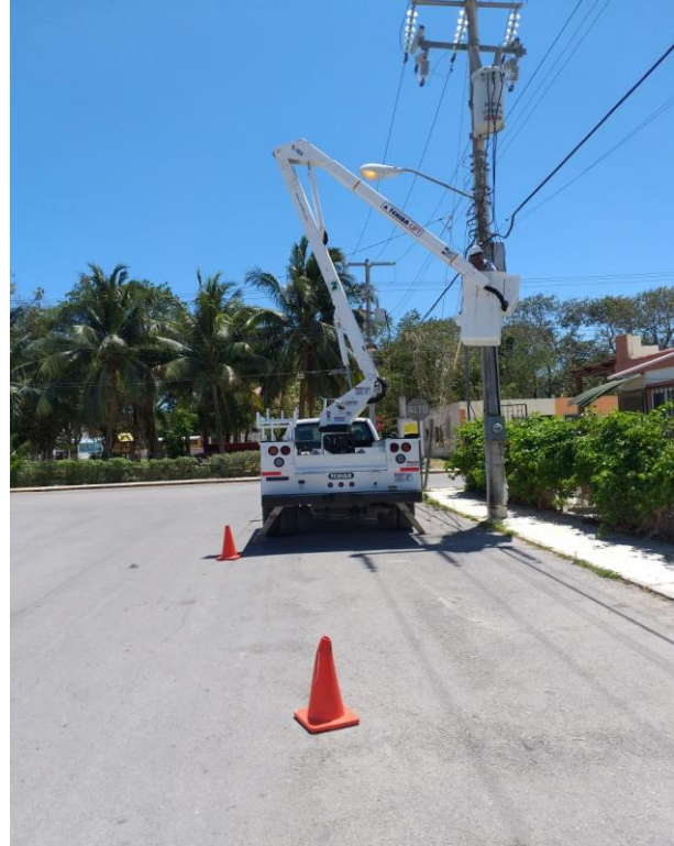
Se rehabilita sector apagado en la colonia Huracanes
