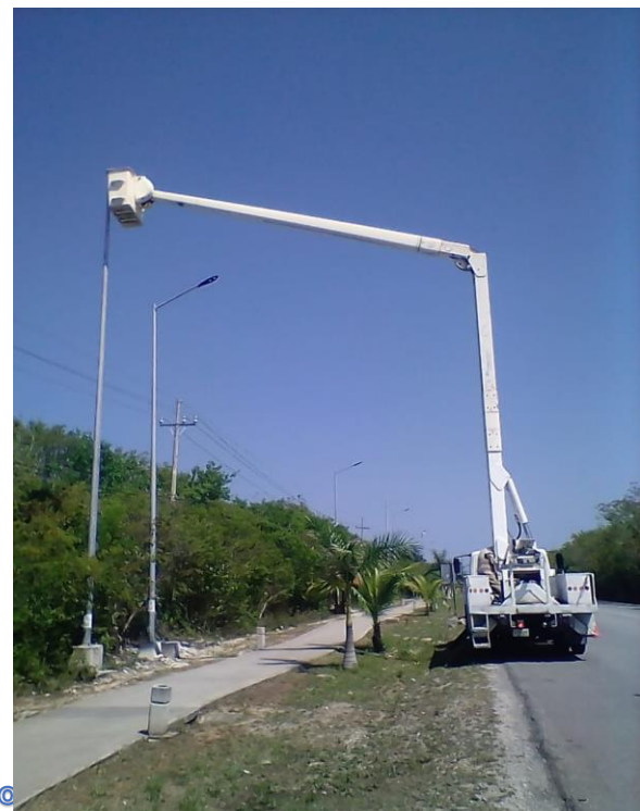
Se retiran luminaria y postes en la ciclovia avenida coba
