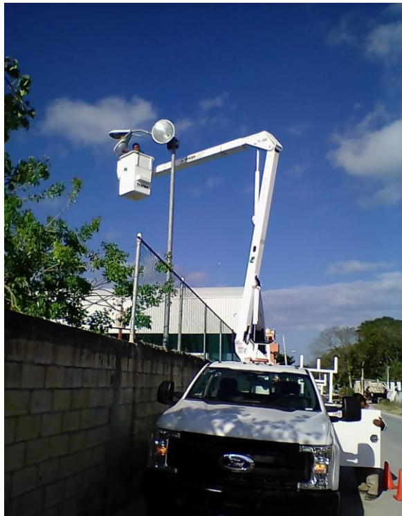
Se rehabilitan lámparas en la colonia Maya Privada
