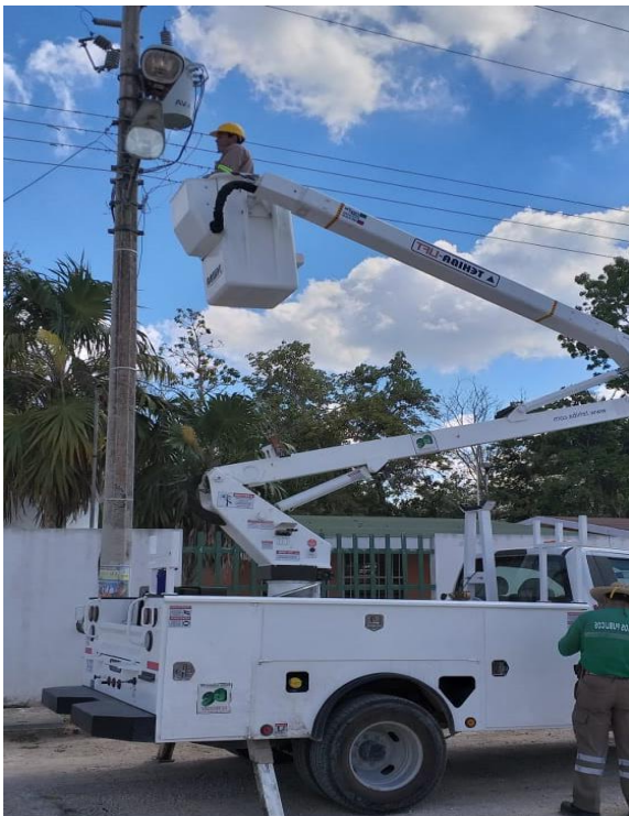
Se rehabilitan luminarias en la comunidad de Hondzonot.
