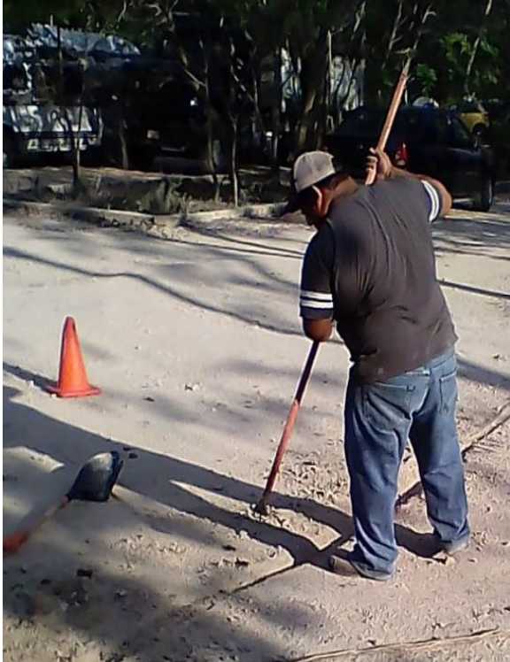
Se corrige corto circuito en línea subterránea de la colonia Villas Holística
