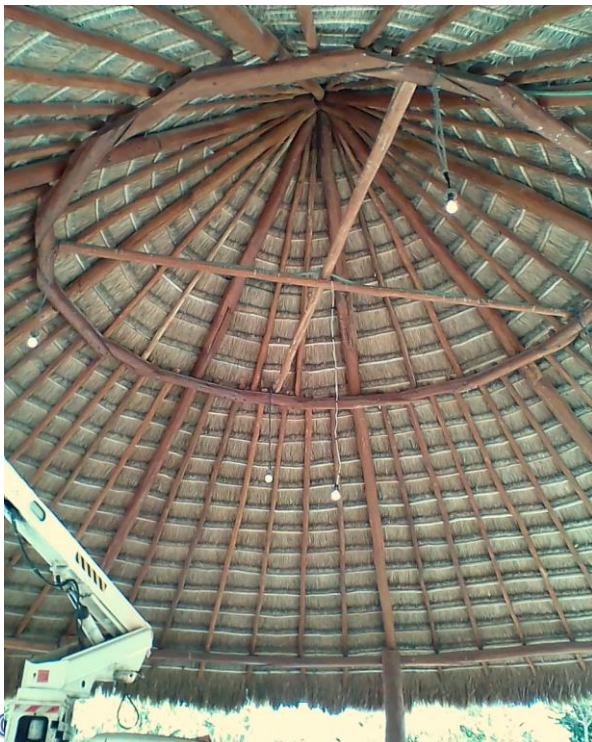
Se rehabilitó lámparas en la palapa de la Unidad Deportiva
