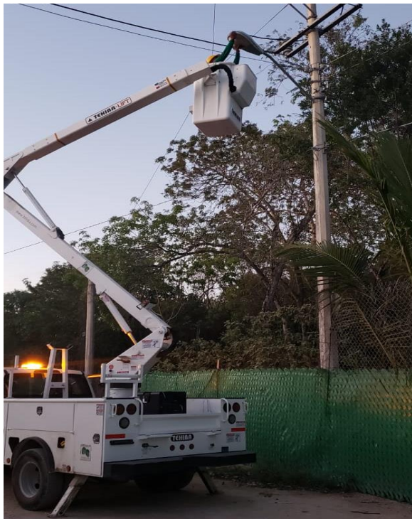
Se rehabilitaron de 2 lámparas que estaban apagadas en la colonia Veleta.
