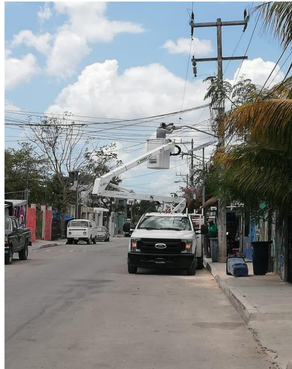
Se rehabilitaron 2 lámparas que estaban apagadas en la colonia Centro calle 2 poniente.
