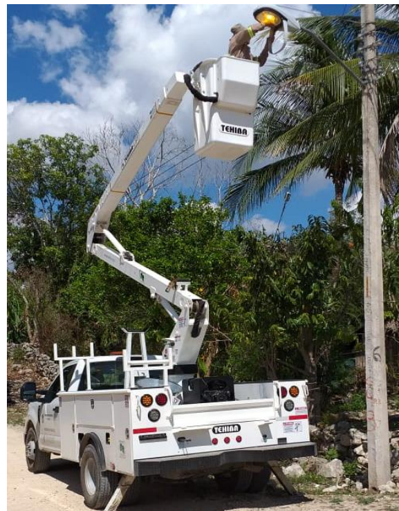
Se rehabilitan luminarias en la comunidad de Sacamucuy
