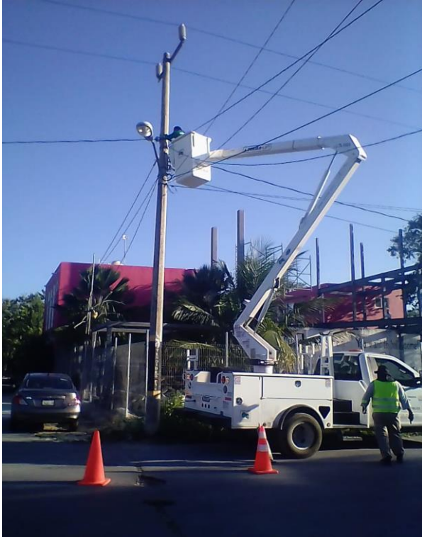
Se rehabilitan lámparas en la colonia Lakin
