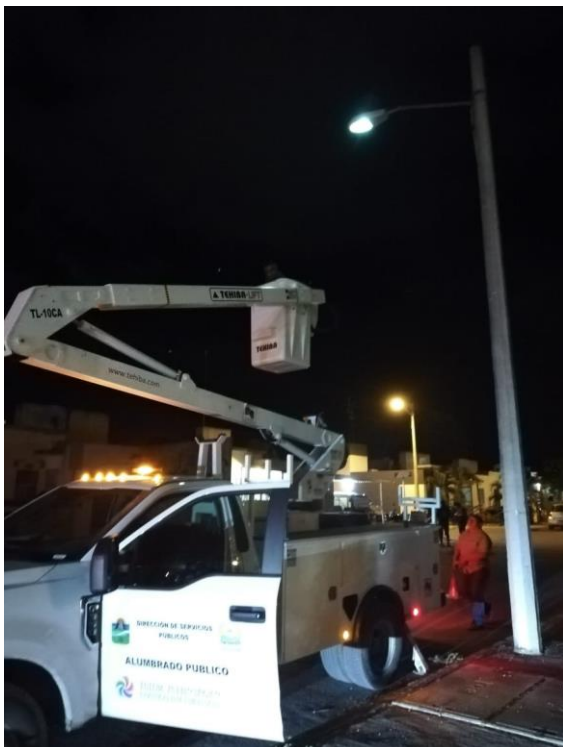
Se rehabilitaron 6 lámparas en la colonia Palmas 1
