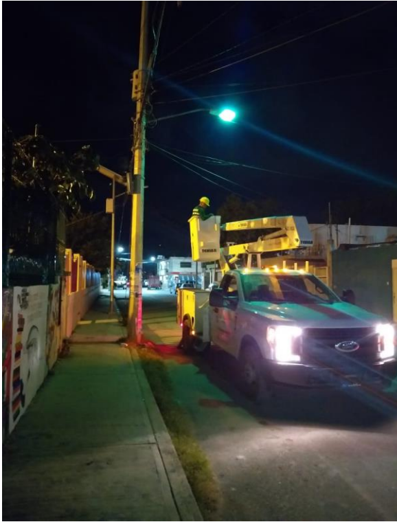
Se rehabilitaron 2 lámparas en colonia Centro en calle 2 oriente
