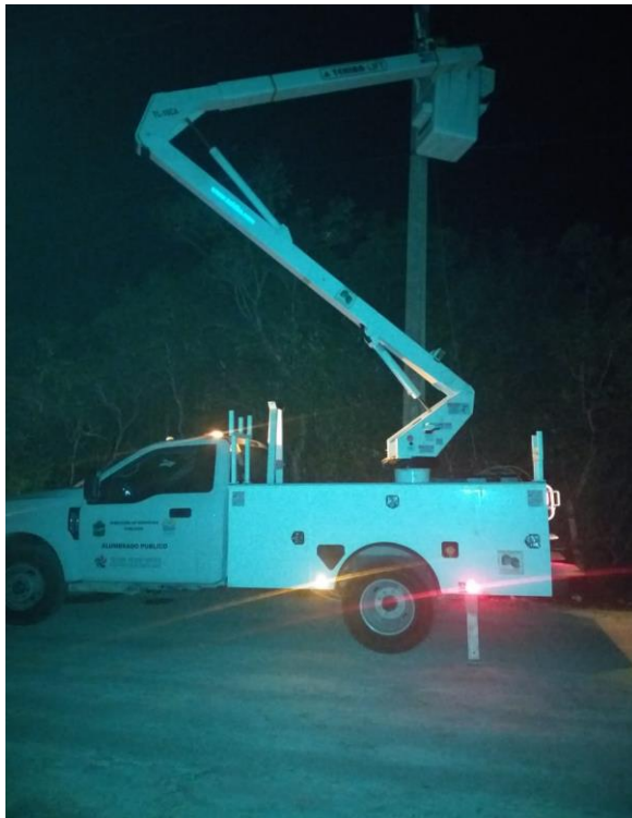
Se rehabilitaron de lámparas en la comunidad de Chan Chemuyil
