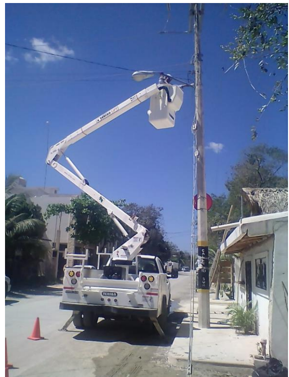
Se rehabilitó lámpara en la colonia Lakin, Calle Mercurio
