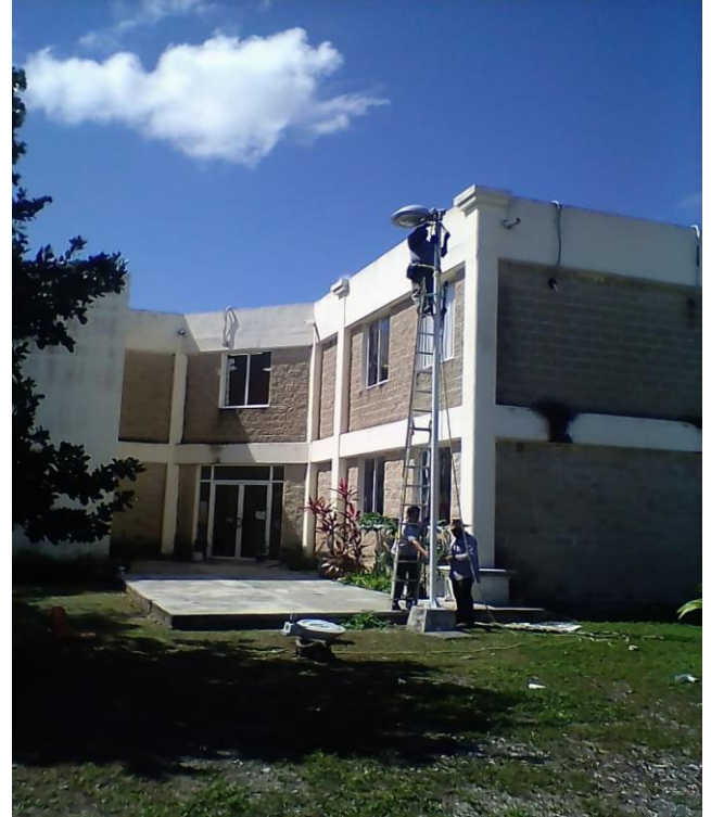
Se coloco luminaria en la Biblioteca Pública
