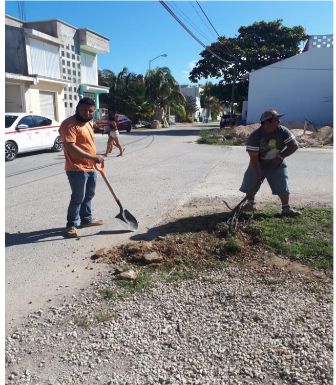
Se colocó registro frente al Comedor Comunitario
