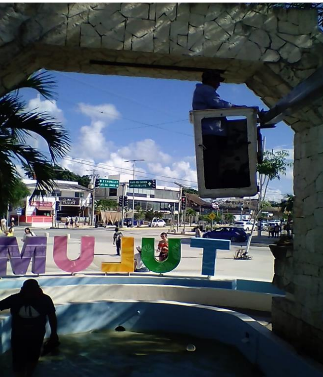
Se desmantela piezas del sistema hidráulico de la fuente del Palacio Municipal
