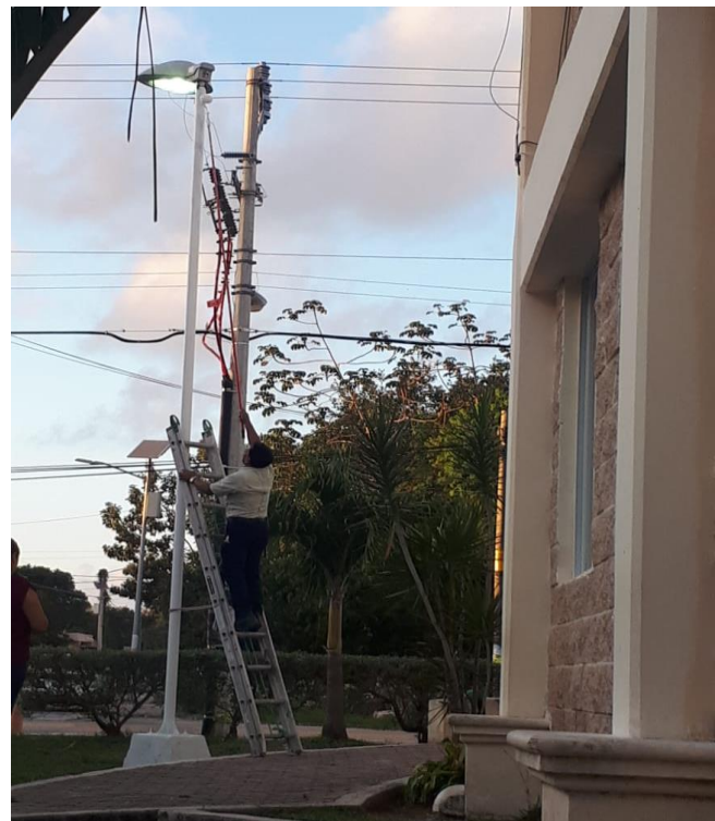
Se rehabilitaron postes en la Biblioteca Pública
