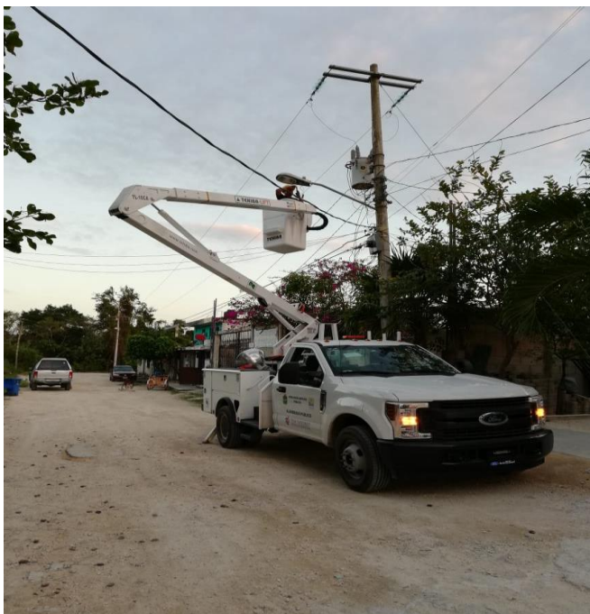
Se rehabilitaron luminarias en la comunidad de Akumal
