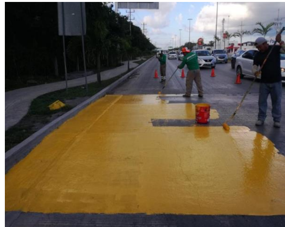
Paso Peatonal de la Carretera Federal
