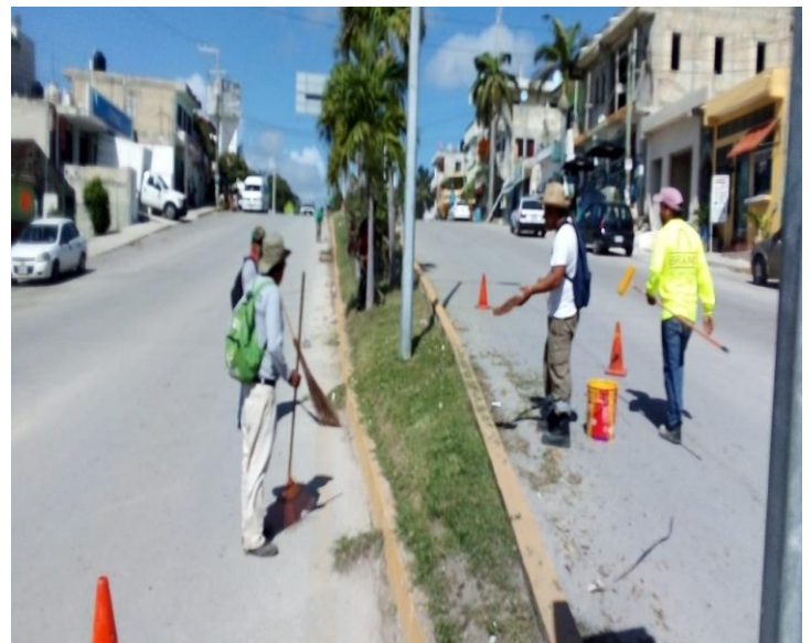
Trabajos de limpieza en avenida del poblado de akumal.
