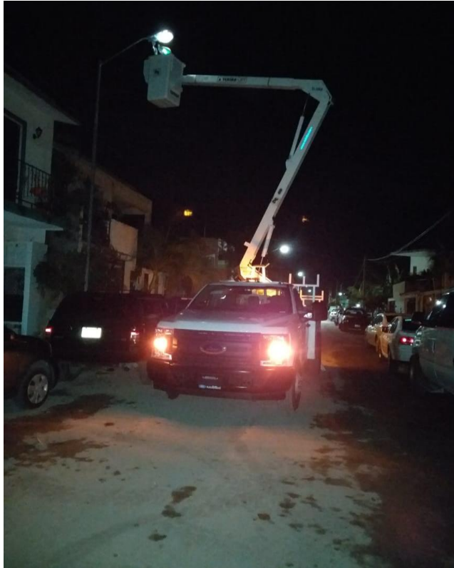
Se rehabilitaron 3 luminarias que estaban apagadas en la colonia Tumben Kaa
