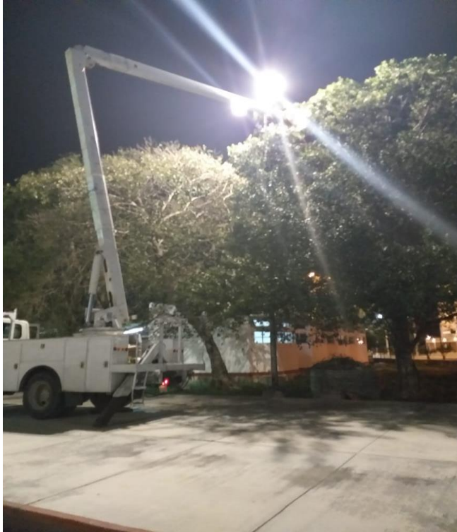
Se rehabilitó luminaria en la Casa de la Cultura
