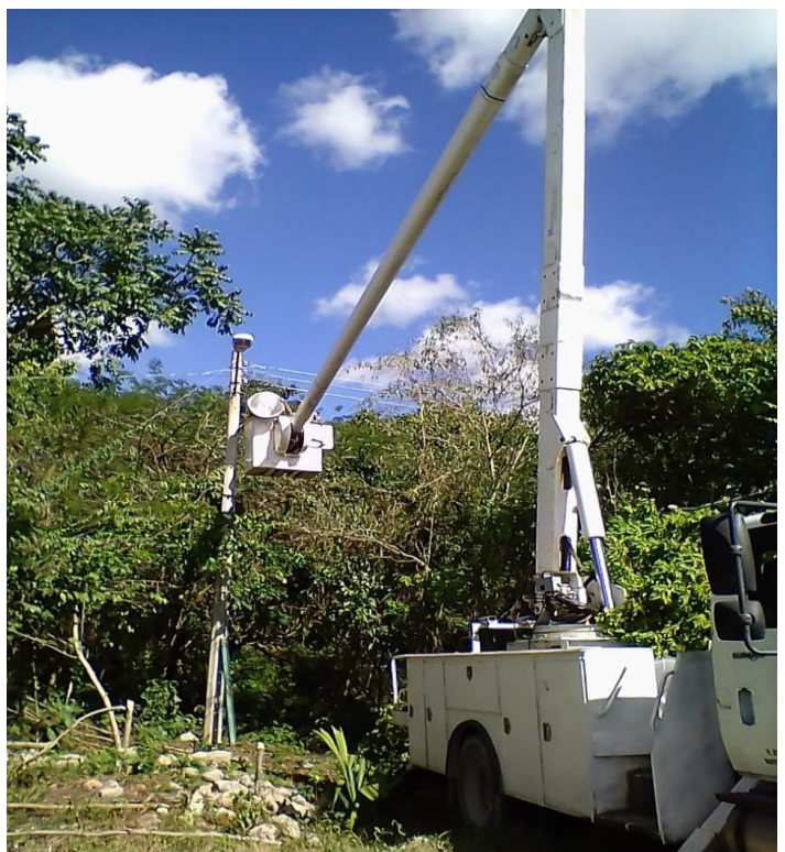
Instalación de reflectores en el campo de beisbol de la comunidad de Yalchen
