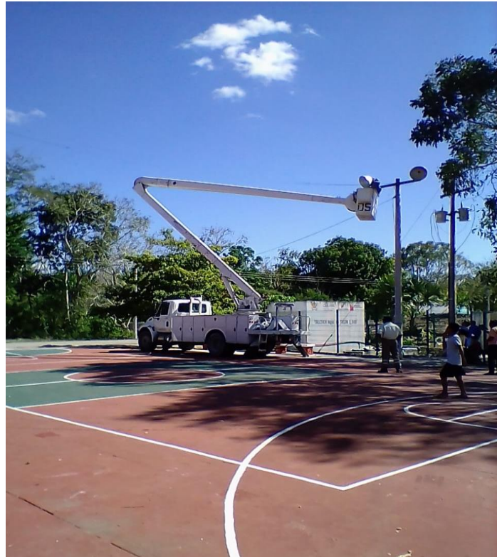
Rehabilitación de luminarias en la comunidad de Yalchen
