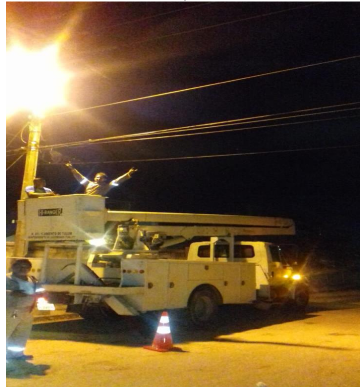
Rehabilitación de en la colonia Villas Tulum
