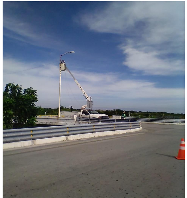
Rehabilitación de luminarias en el puente de la comunidad de Chemuyil
