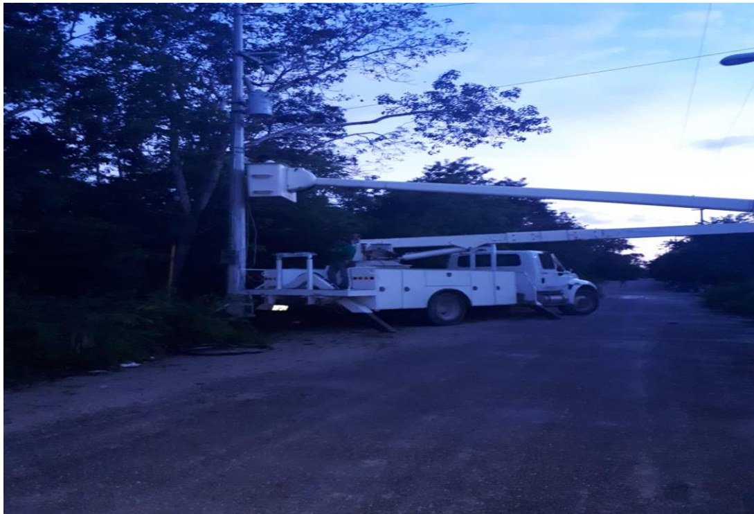
Rehabilitación de luminaria que estaba apagada.
