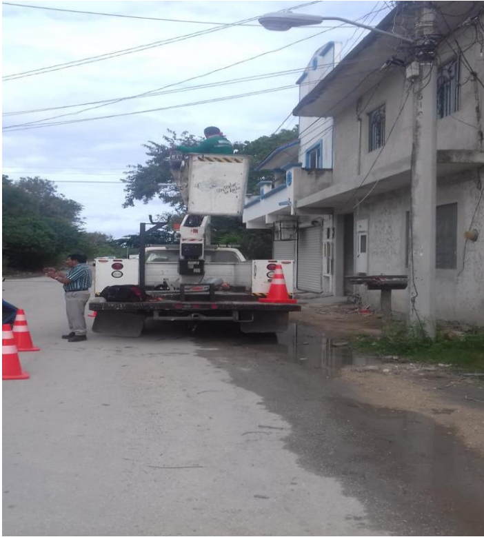
Reparación de luminarias en la calle Bubulek, colonia Mayapaax.
