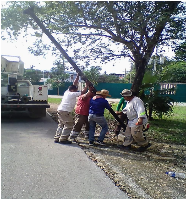
Instalación de postes para reflectores en los andadores de la Unidad Deportiva
