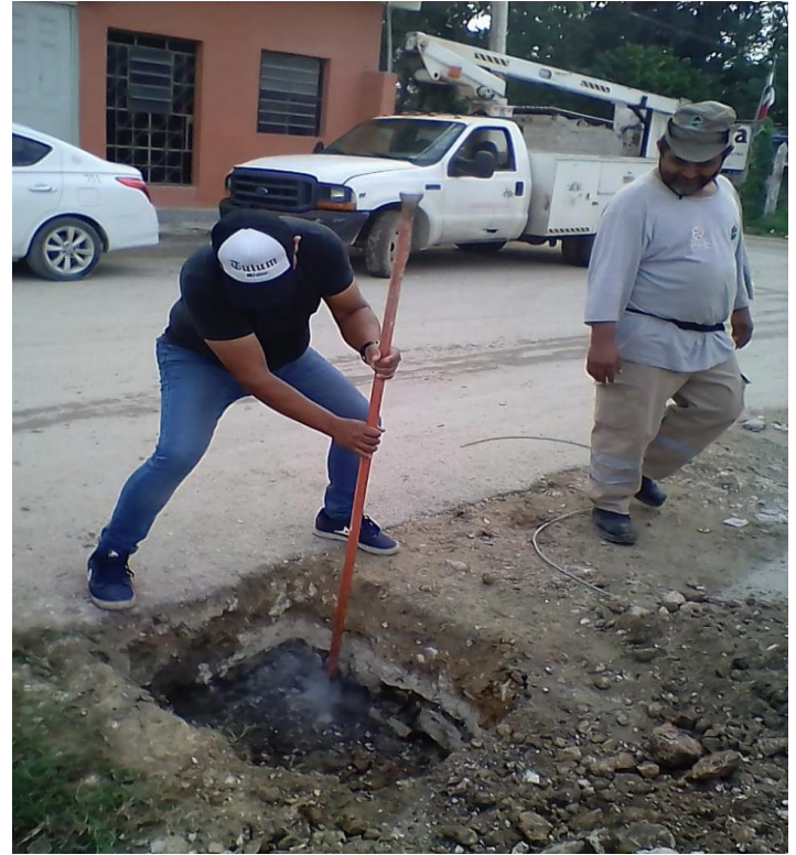
Limpieza de cepas y colocación de dados en Av. Osiris Col. Centro
