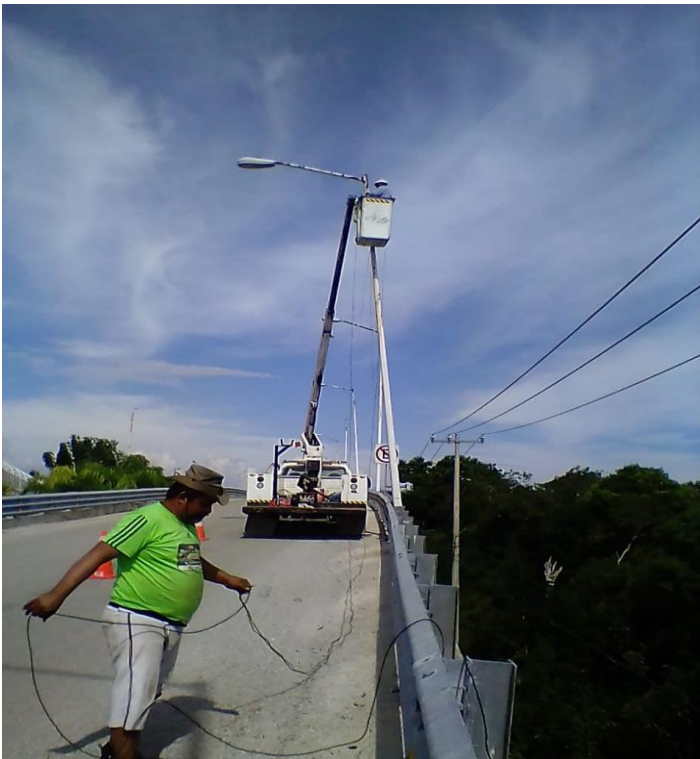
Tensionado de Cables para activar luminarias en el puente de la comunidad de Chemuyil
