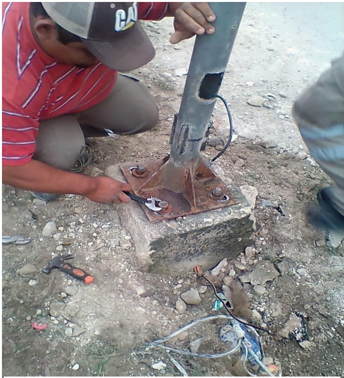
Rehabilitación de postes en Av. Osiris Col. Centro
