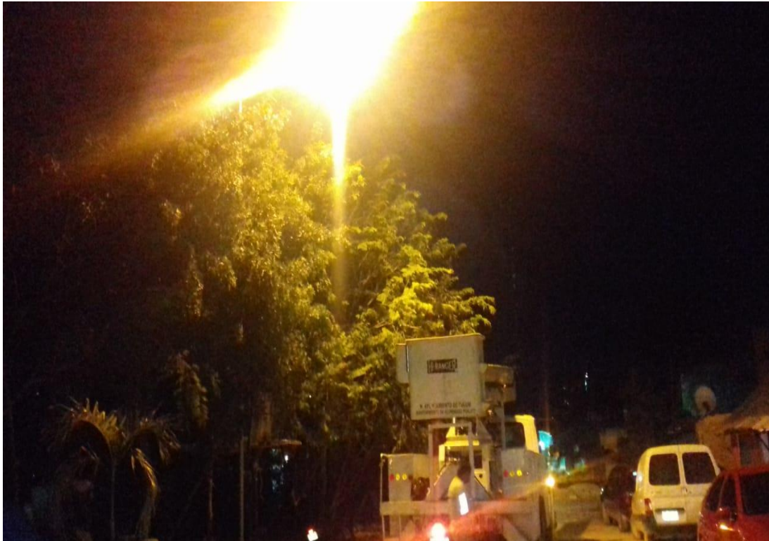
Rehabilitación de luminarias en Calle Kaan por calle Luuch y calle Nabal, Col.Mayapaax
