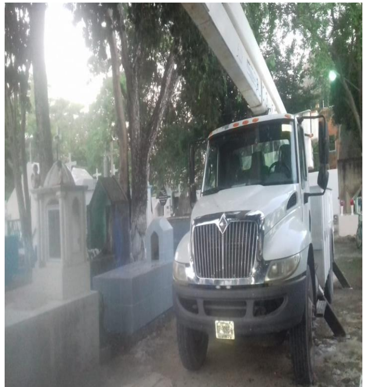
Colocación de alimentación eléctrica a la capilla del panteón
