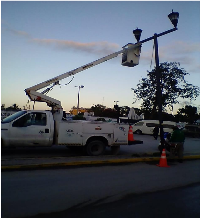
Rehabilitación de luminarias en la Comunidad de Macario Gómez
