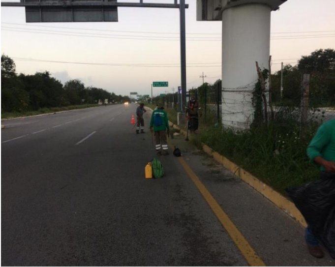
Poda y limpieza del camellón central, debajo del puente peatonal hacia el poblado de akumal., carretera Tulum-playa del Carmen.
