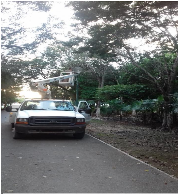
Instalación de reflectores en los andadores de la Unidad Deportiva
