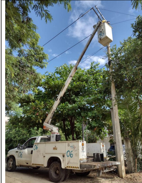
Se realizó cambio de fotocelda a lámparas encendidas en la colonia Veleta calle 6 entre Av Tulum y Tzol Kin
