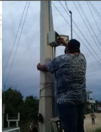
Poblado de Akumal para revisar y reparar 2 sectores en la col Tortugas
