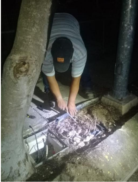
Reconexión de líneas sulfatadas en colonia Guerra de Castas calle 4 Ote y 2 Poniente
