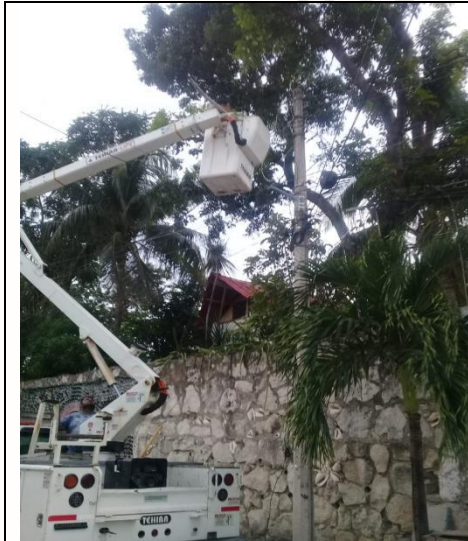
Se instaló una luminaria ov15 en calle Aries Sur entre calle Saturno pte y calle Ontario. Col centro
