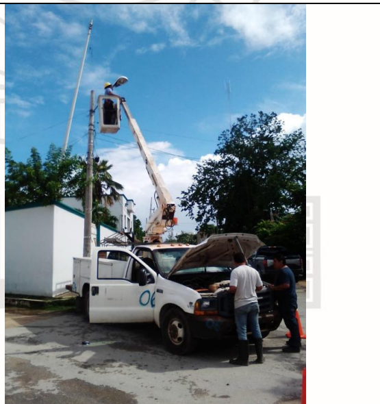
Con motivo de prueba de góndola 06 se repara luminaria ov15 frente oficinas de servicios públicos
