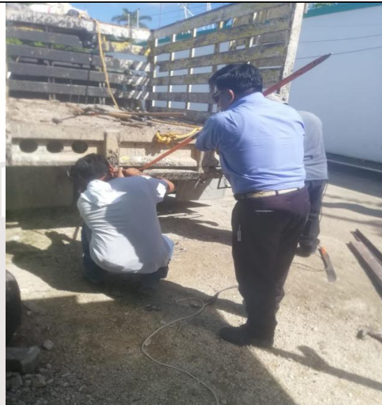
Trabajos realizados, y modificaciones en el camión del equipo de bacheo
