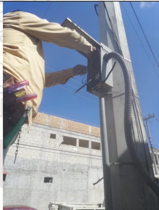
Se da limpieza correctiva a contactor y renovando confecciones, tomando lectura de amperaje por línea, en la colonia Tumben Ka en la calle 19 entre la Av. 28 y Av. La selva
