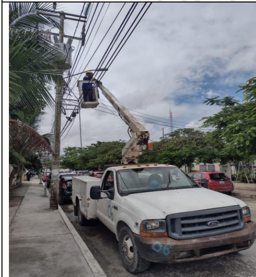
Se brindó apoyo para conectar bajante 220 voltios para los compañeros de eventos especiales, col centro C. sol, entre Av Osiris y Alfa parque 2 Aguas
