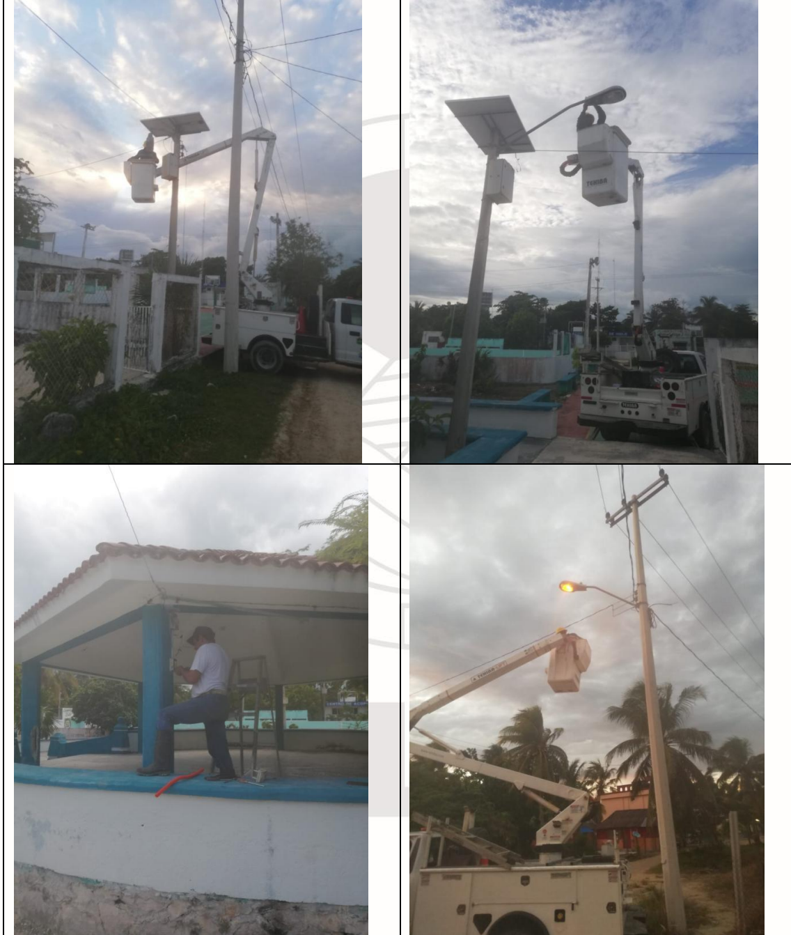
Trabajos realizados en el kiosco y parque, de Punta Allen
