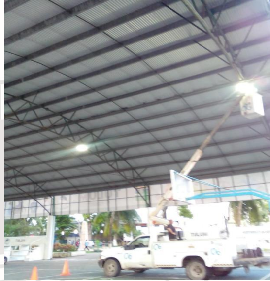
Reemplazo de luminaria LED quemado en domo del parque 2 aguas
