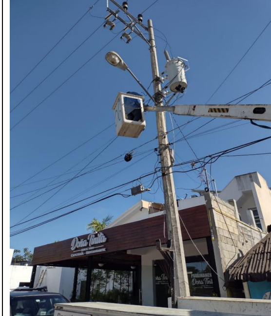
Se repararon 3 luminarias una ov 15 y 2 lámparas leds modificadas en Col. Centro C. Alfa entre Sagitario y Polar Pte.
