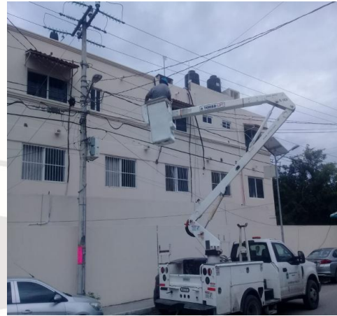
Se rehabilitación 7 luminarias tipo led de 73 watts en colonia Centro calle Sol Pte y Alfa Sur.
