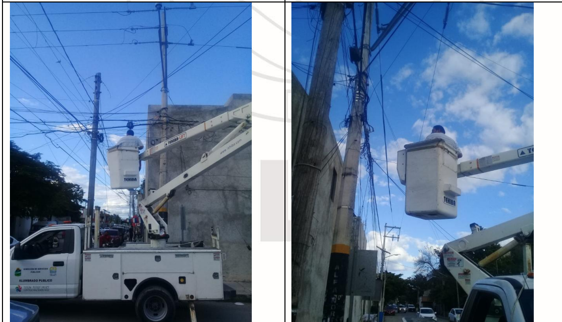
Cambio de fotoceldas quemadas a mini sectores de luminarias LED solares modificadas. Calle sagitario entre calle Osiris norte y calle alfa norte. Col centro
