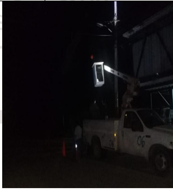
Reconexión de luminarias apagadas tipo led 73 watts en la colonia atrás de Huracanes calle asteroides Ote Libra Sur
