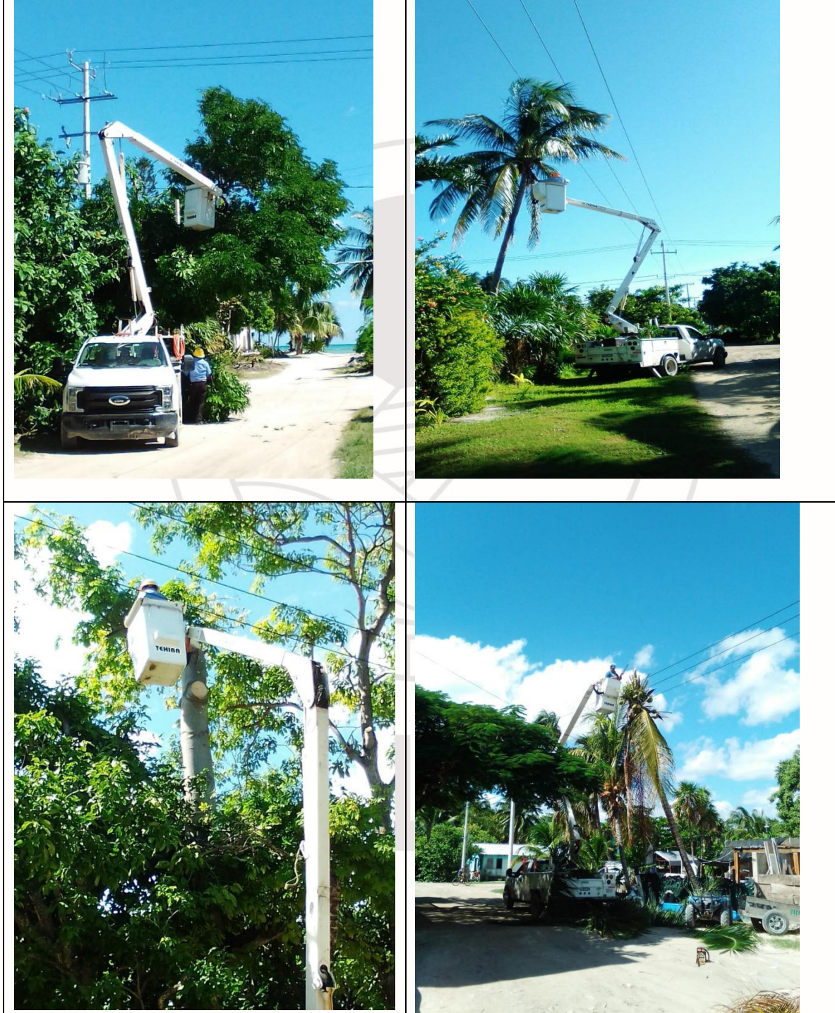
Trabajos de poda y mantenimiento de líneas de alta tensión en calles de la comunidad de Punta Allen
