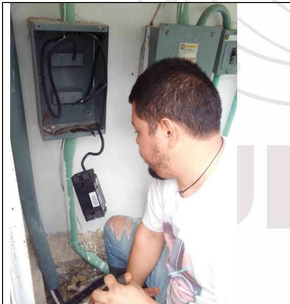
Se brindó apoyo para cambiar break quemado en escuela primaria de la Xulka
