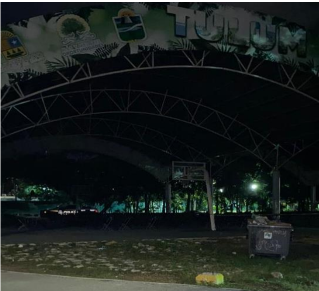
Barrido realizado en el doble domo de la unidad deportiva
