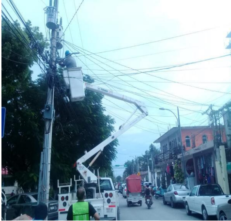
Se rehabilitación 7 luminarias tipo led de 73 watts en colonia Centro calle Sol Pte y Alfa Sur.
