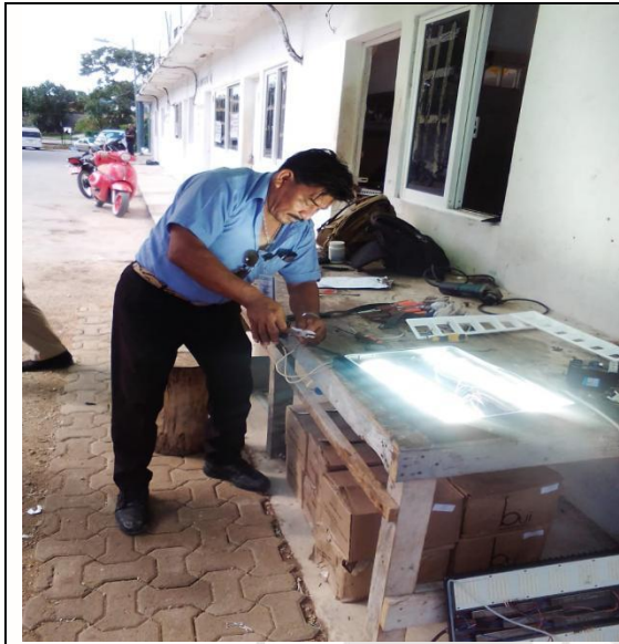
Trabajos de revisión y algunas reparaciones de luminarias led en bodega de alumbrado
