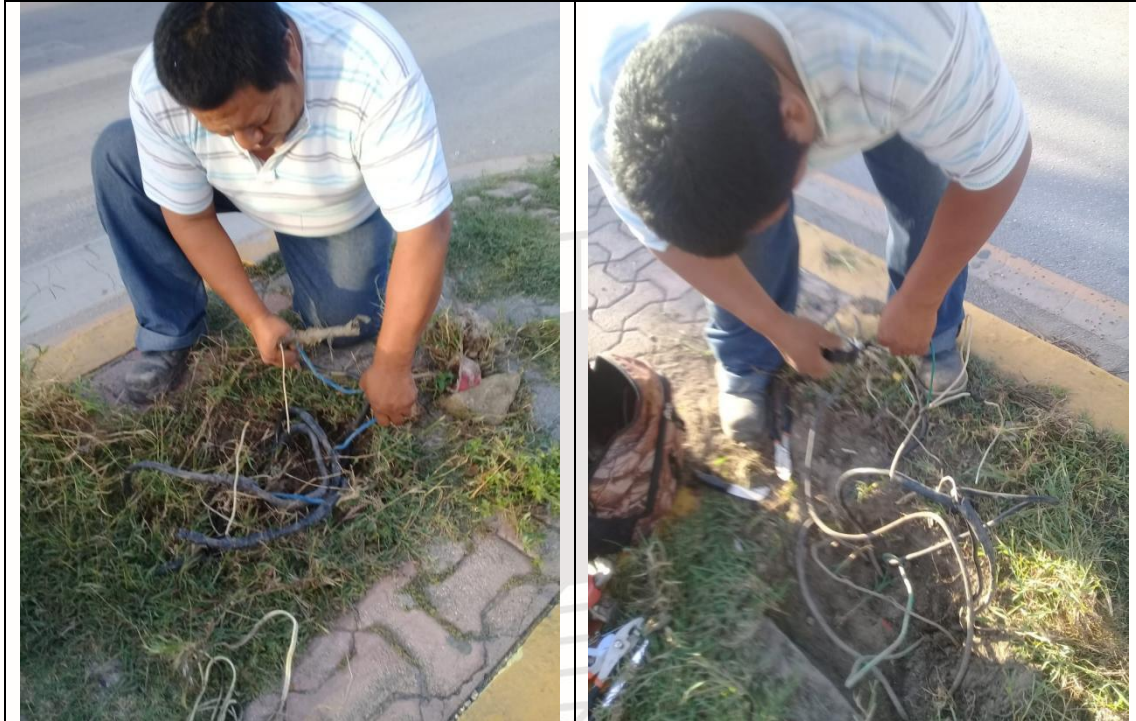
Se reconecta y activan luminarias LED apagadas y otro intermitente por falseo de líneas. Av tulum entre calle Centauro y calle Orión. Col. Centro
