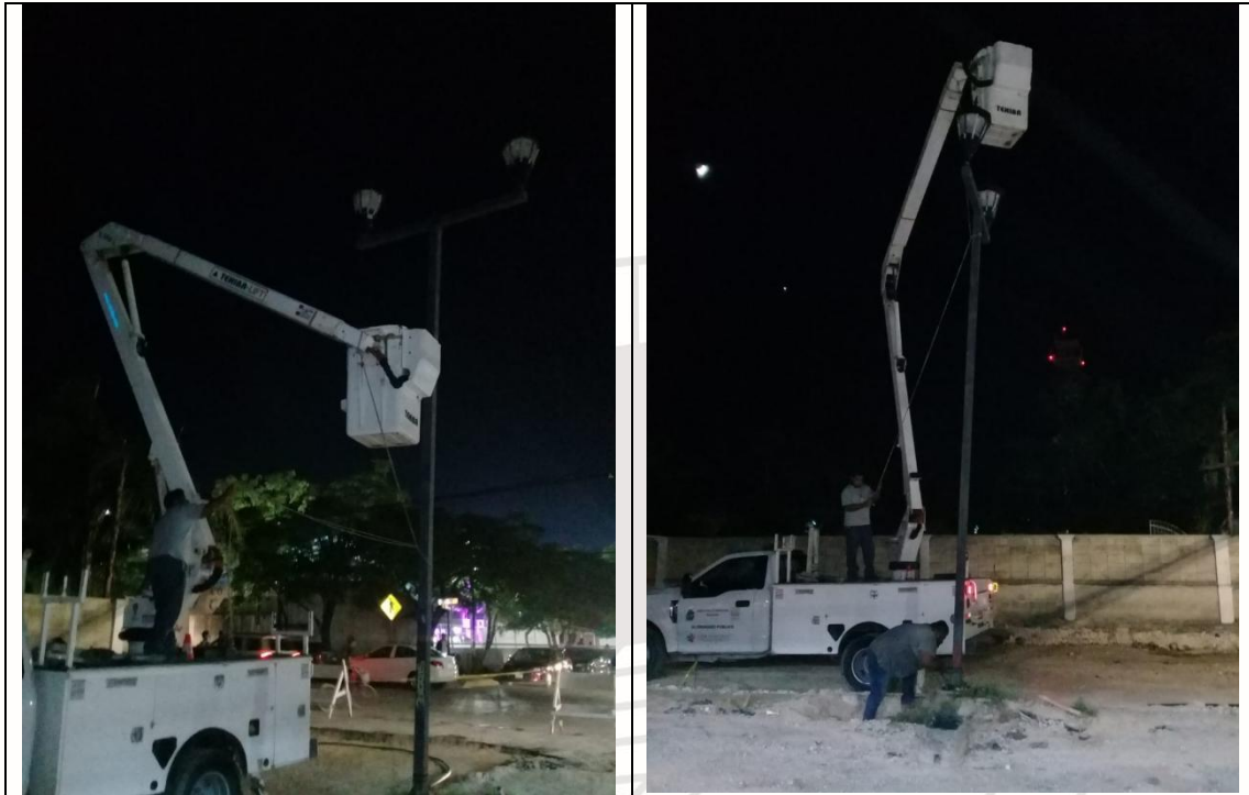
Se realizó trabajo para retirar poste sobre Av Osiris sur por trabajos de remodelación
