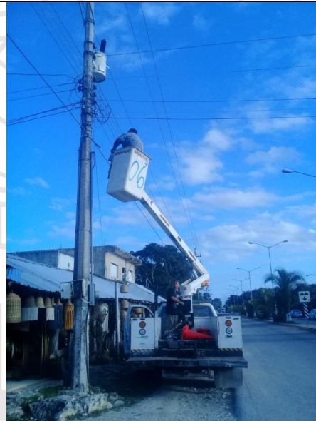
Reconexión de líneas aéreas sulfatadas el sector quedo rehabilitado se quedó puentado la base del medidor x posible fallo en el medidor, poblado de Macario Gómez
