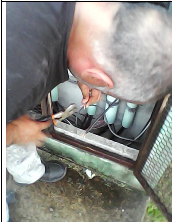
Se cambio break 2x20 en la unidad deportiva para la cancha de futbol infantil con material recuperado
