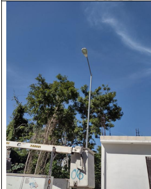
Reparación de 3 luminarias C. Chum entre Omm y Puut de la Col. Tumben Kah
