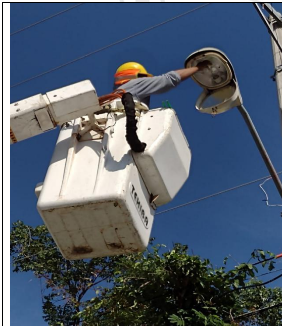
Reparación y cambio de 4 lámparas ov 15 en la Col. Tumben Kah
