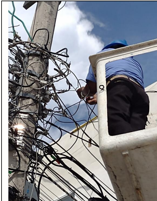
Se reconecto los cables que alimentan las cámaras del C 5, Av Tulum entre Satélite y Centauro Col. Centro
