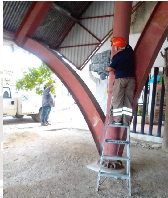
Se instala contacto con corriente a 110v en el domo del parque de la croc. Calle Gama Oriente por Av Satélite Sur
