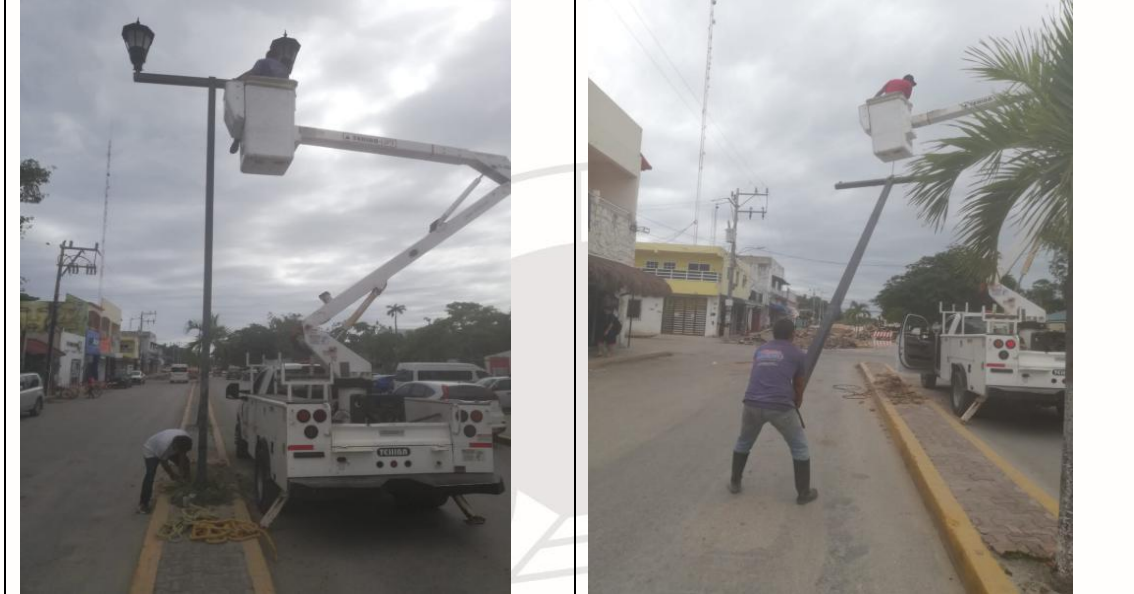
Se retira lámparas y poste en la Av. Osiris entre Av. tulum y calle sol colonia centro
