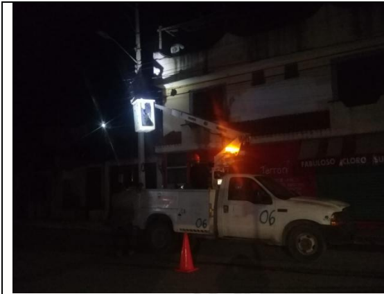
Rehabilitación de luminaria tipo led de 73 watts en la colonia Maya Pax calle Tun Kul con Orión Nte
