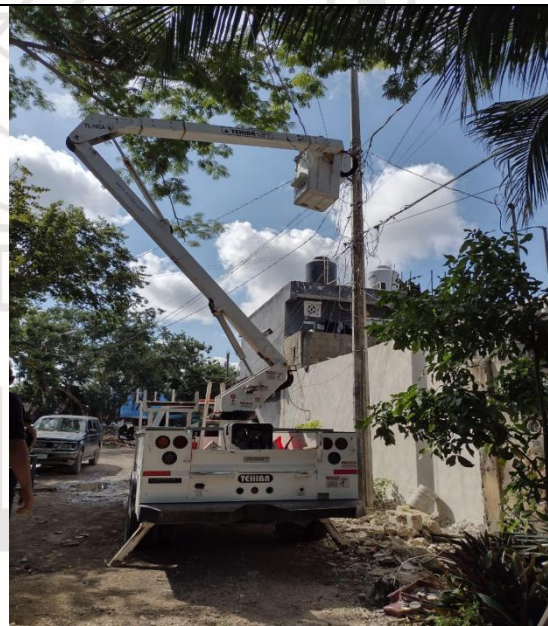
Reconexión de la lámpara quemada en la Col. Cancha Maya C. Luna Pte. Entre Privada
