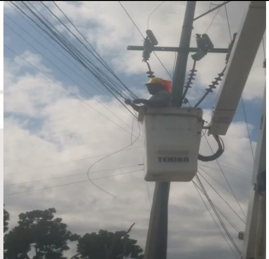
Se quitó la cuchilla y se reconectó las líneas que estaban quemadas y se reconectaron las líneas cerca del break colonia Tumbeka calle Faisan con Av. 18 y Calle Nabal
