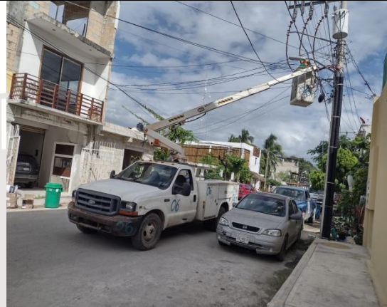
Reconexión de línea principal Col Maya Pax calle Bululek entre Av. Satélite y Libra
