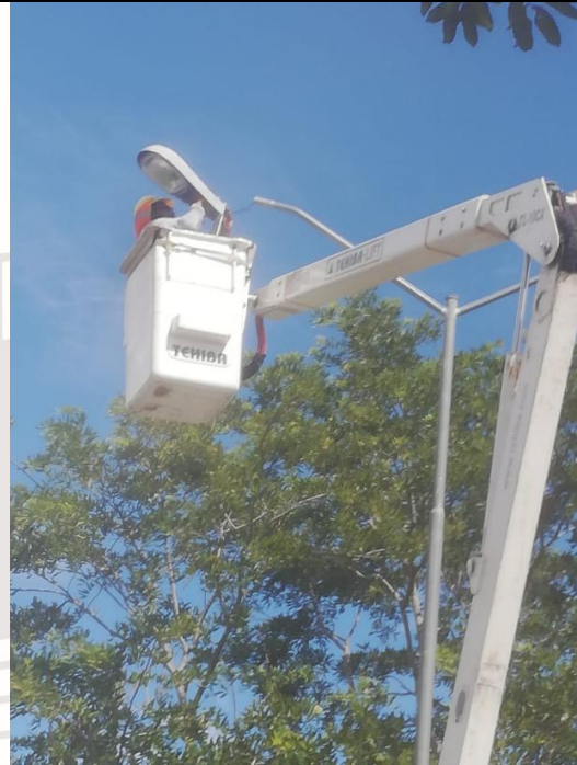
Se rehabilita luminaria de un poste, en la av 28 entre la calle 17 y 15 de la colonia Tumbem Ka
