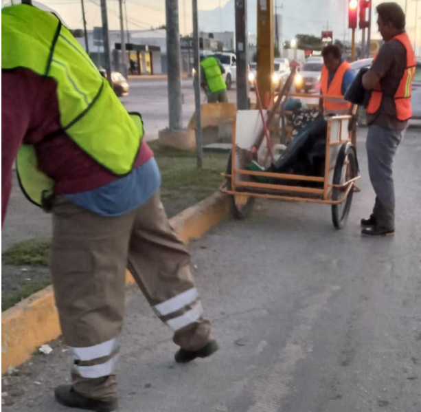
Se realizó barrido y limpieza en avenida Tulum
