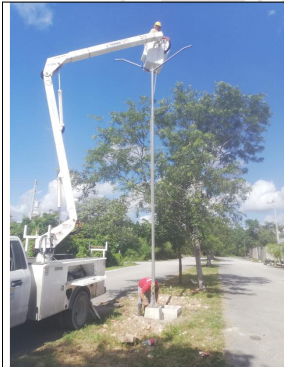
Se instala poste en la Av. 28 de la colonia Tumben Ka entre Yodzonot y C. 19
