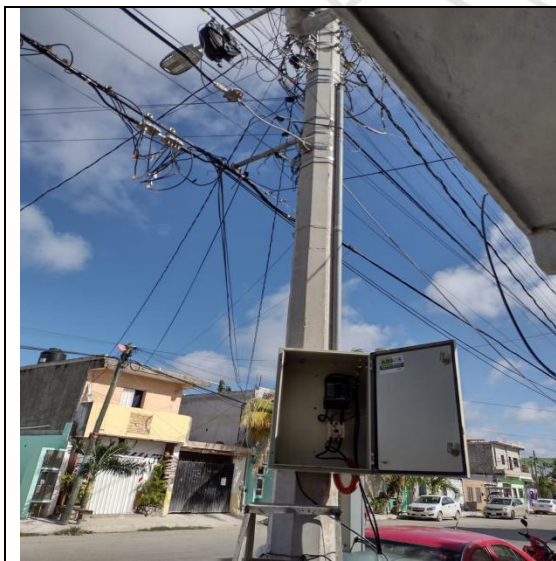
Se cambió contactor quemado del sector de la Col. Maya Pax, calle Tunkul entre Alfa y Omega Nte.
