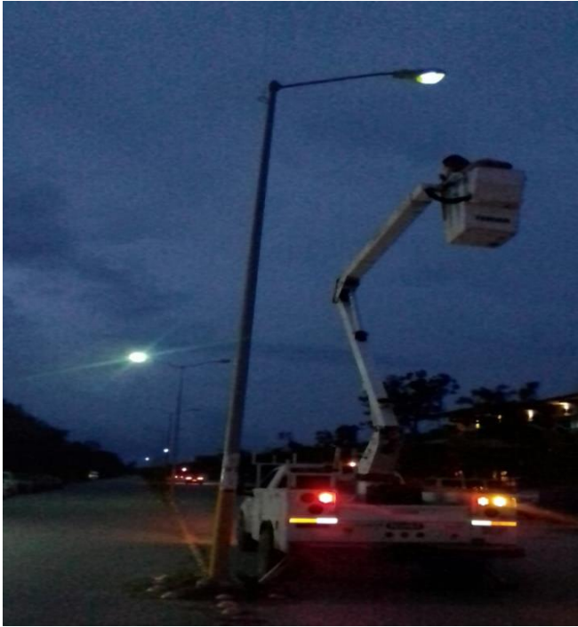
Rehabilitación de luminaria en la Colonia Holística
