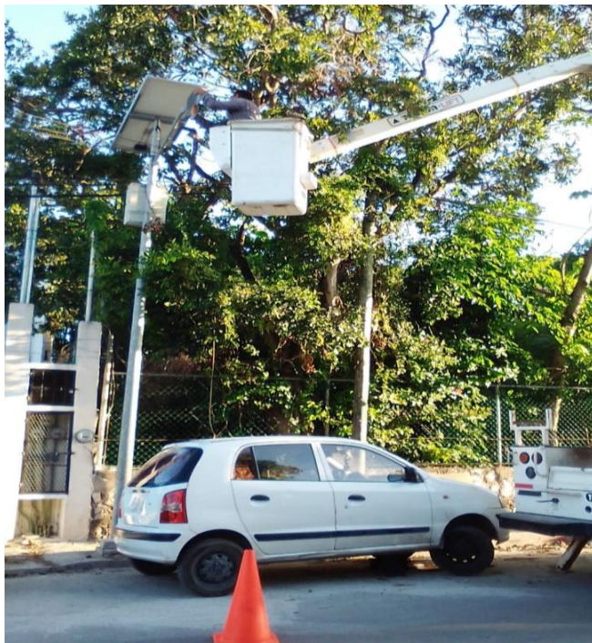
Rehabilitación de luminaria en la Colonia Centro
