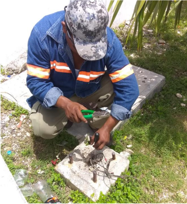
Corrección de corto circuito en la Unidad Deportiva de la Col. Luna
