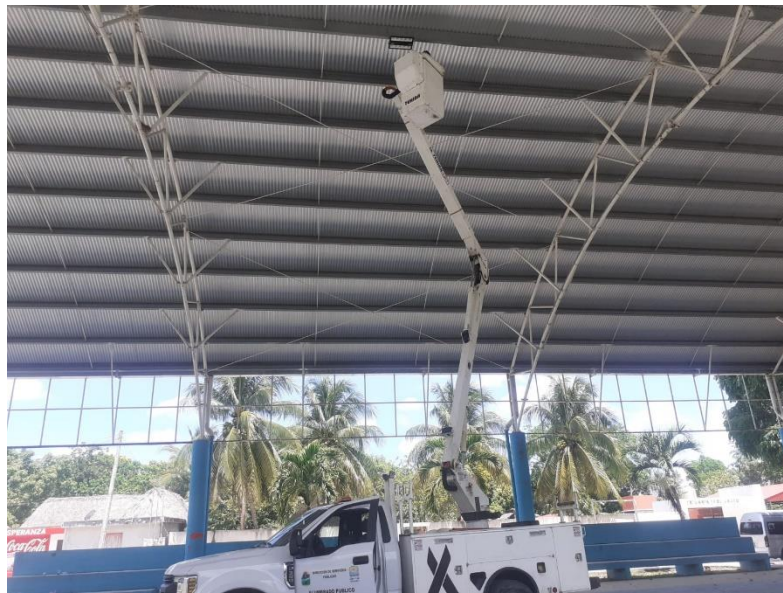
Cambio de luminarias en la comunidad de Coba
