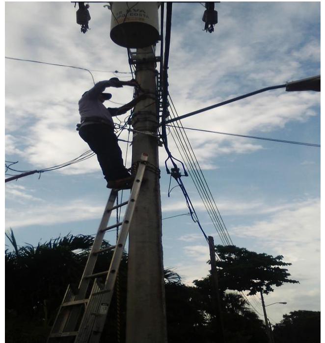
Rehabilitación de sector en la Comunidad de Coba
