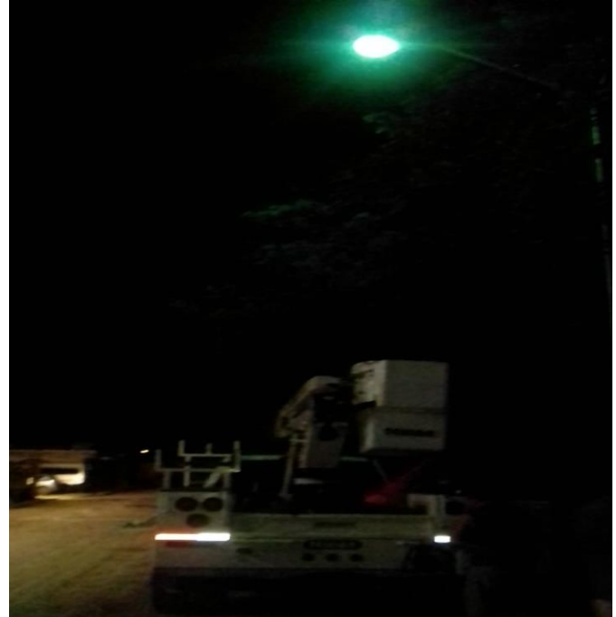
Rehabilitación de luminarias en la Col. Tumben kaa
