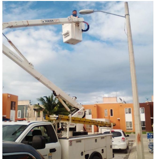
Rehabilitación de luminaria en la Colonia Palmas
