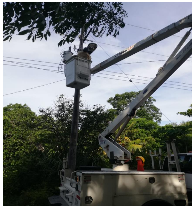
Rehabilitación de luminaria en la Comunidad de Yalchen
