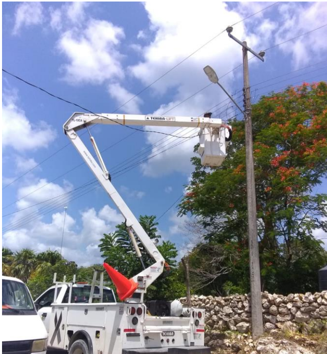
Rehabilitación de luminarias en la Comunidad de San Silverio
