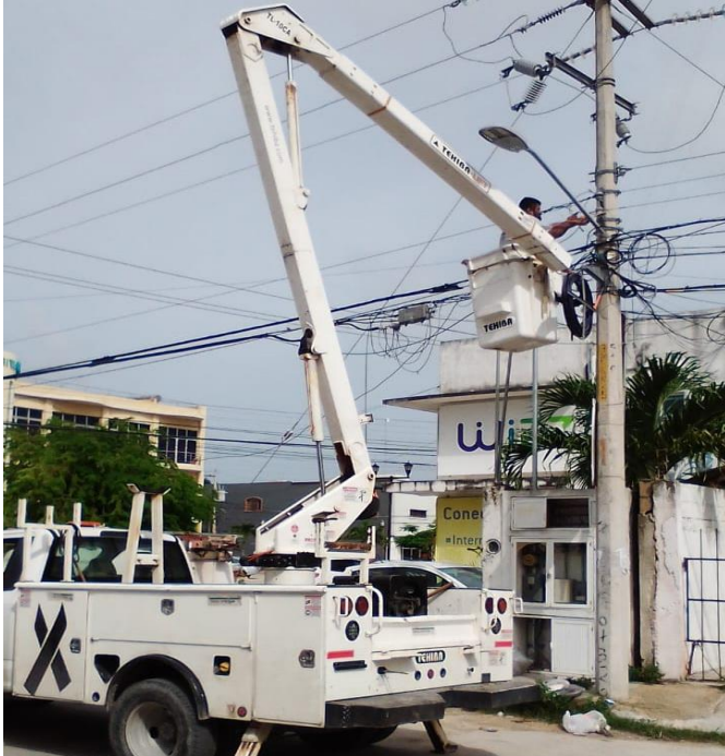
Rehabilitación de sector en la Col. Mayapax
