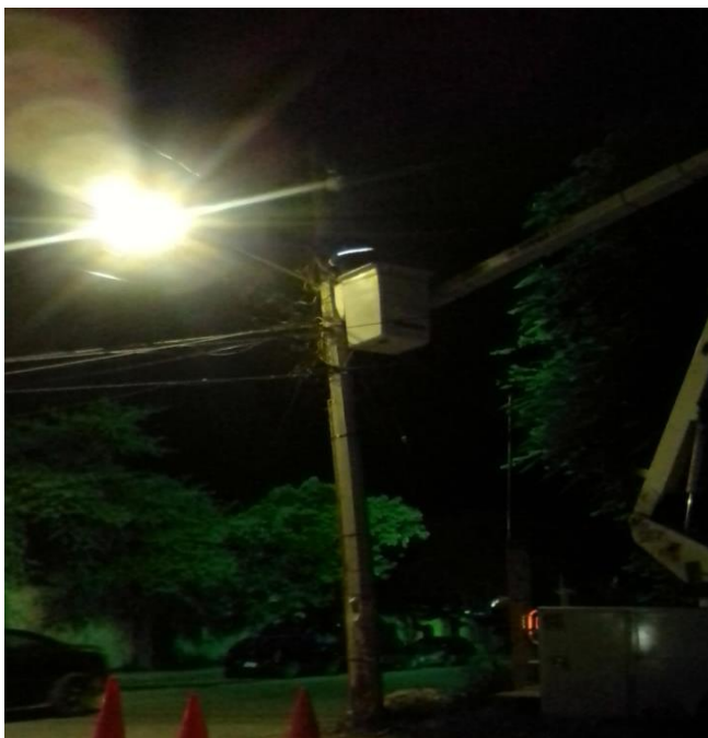
Rehabilitación de luminaria en la Colonia Maya
