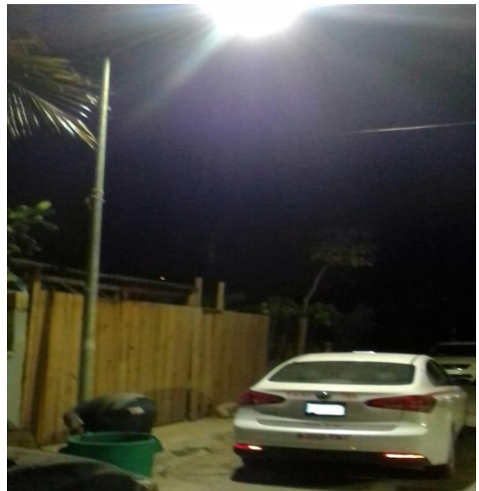
Rehabilitación de luminaria en el Fracc. Villas Tulum
