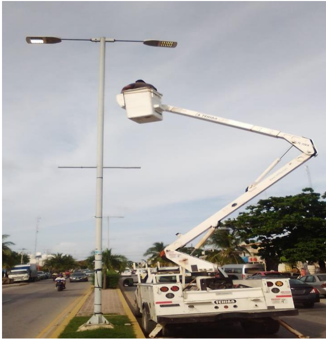
Rehabilitación de luminaria en la Colonia Centro
