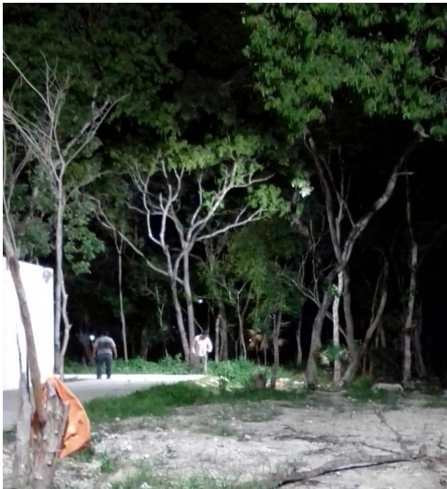
Instalación de luminarias en el Área del DIF y Casa del Adulto Mayor
