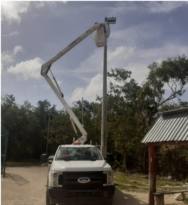
Rehabilitación de luminarias en el campo de la Comunidad de Akumal
