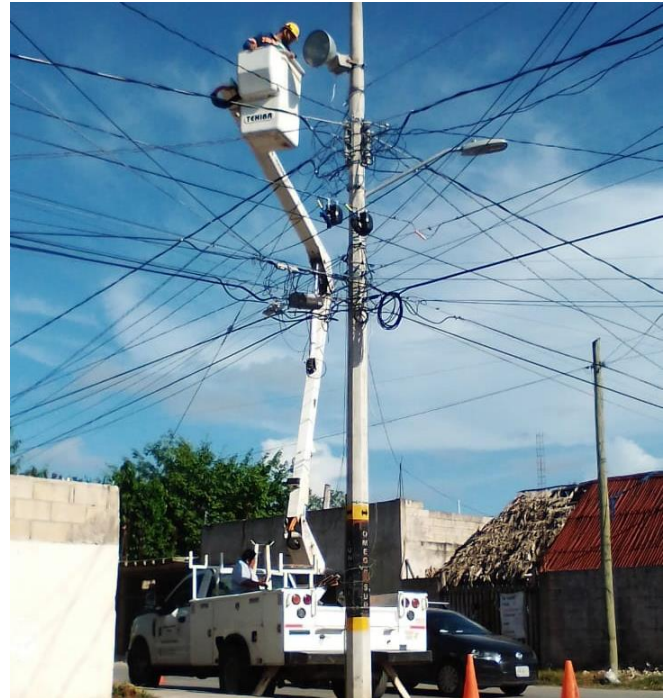
Rehabilitación de luminarias en la Colonia Maya
