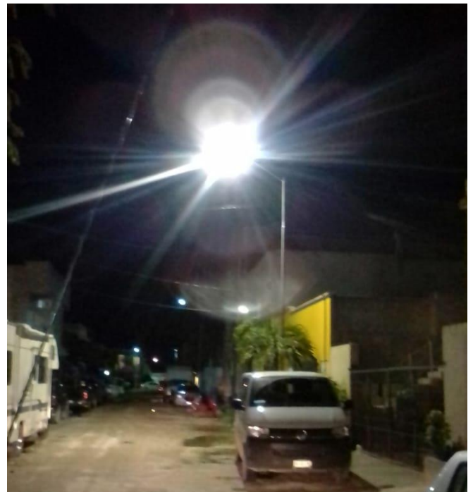
Rehabilitación de luminarias en la Colonia Tumben Kaa
