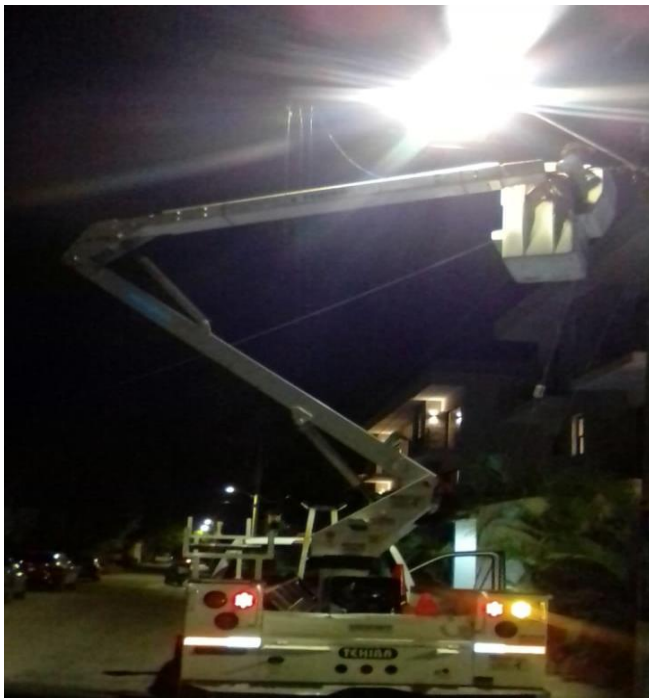
Rehabilitación de luminarias en la Colonia YaaxTulum
