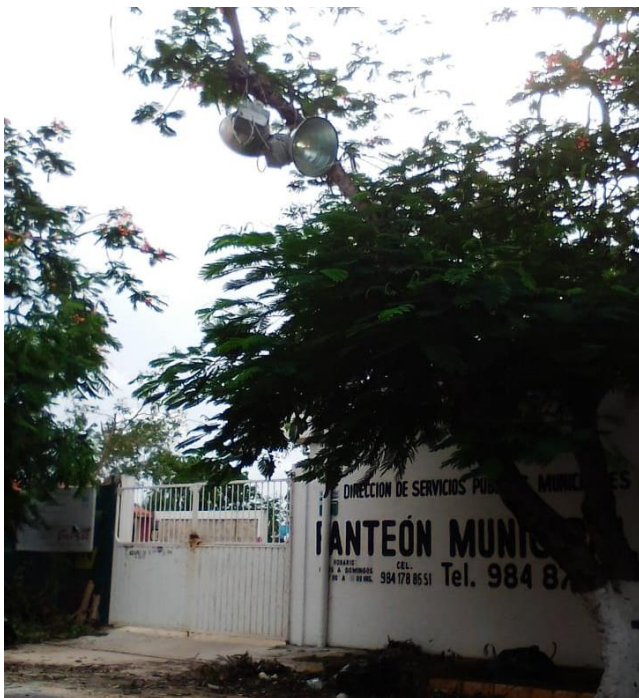
Tensión de líneas y rehabilitación de luminaria en el panteón Municipal, Col. Maya
