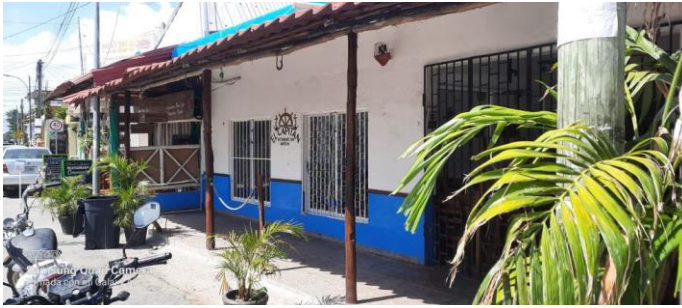
FOTO 1: Notificación donde se le solicita retirar pared de concreto que obstruye la vía pública: c. alfa entre av. Tulum y sol, col. Centro.
