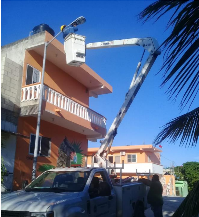
Rehabilitación de luminarias en la Comunidad de Akumal
