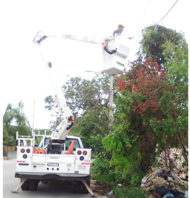
Rehabilitación de luminarias en la Col. Ejido
