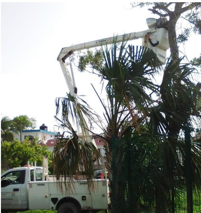
Rehabilitación de luminaria en la Colonia Luna
