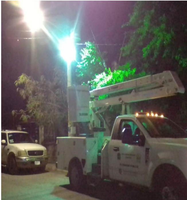
Rehabilitación de luminarias en la Colonia Lak'iin
