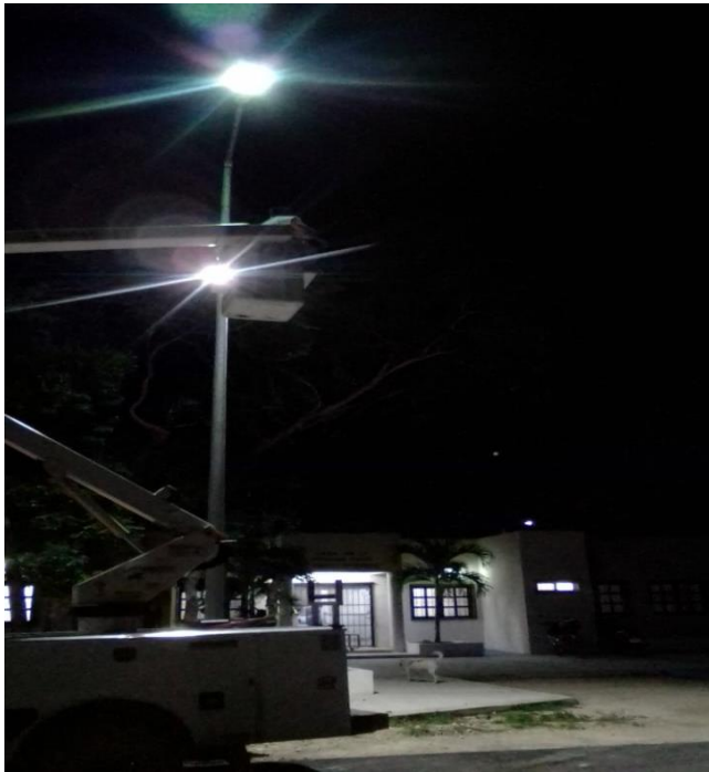
Rehabilitación y reposicionamiento de luminarias en la Casa del Adulto Mayor, Col. Yaax Tulum
