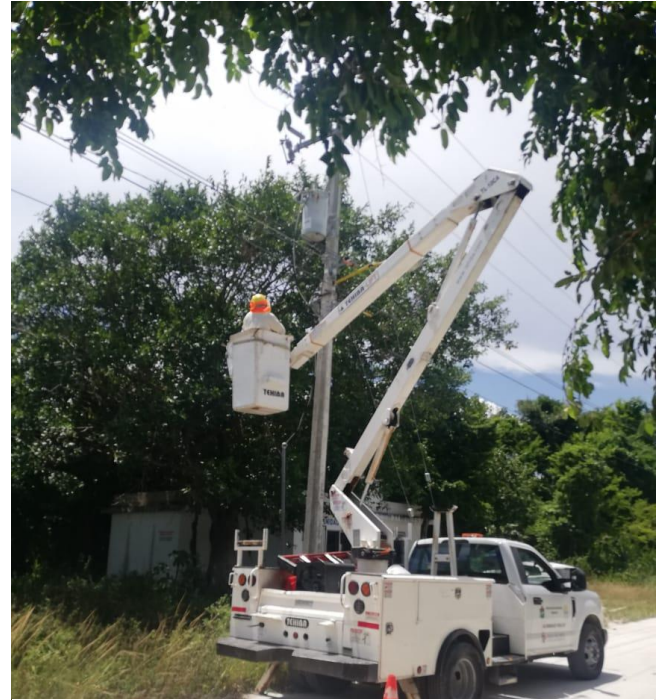
Rehabilitación de luminarias en la Comunidad de Chemuyil
