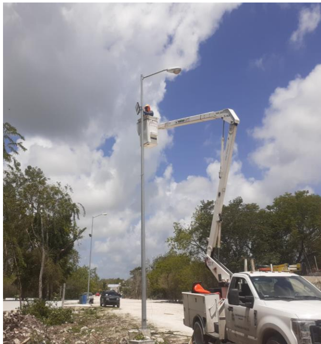
Instalación de luminaria en la Casa del Adulto Mayor, Col. Yaaxtulum
