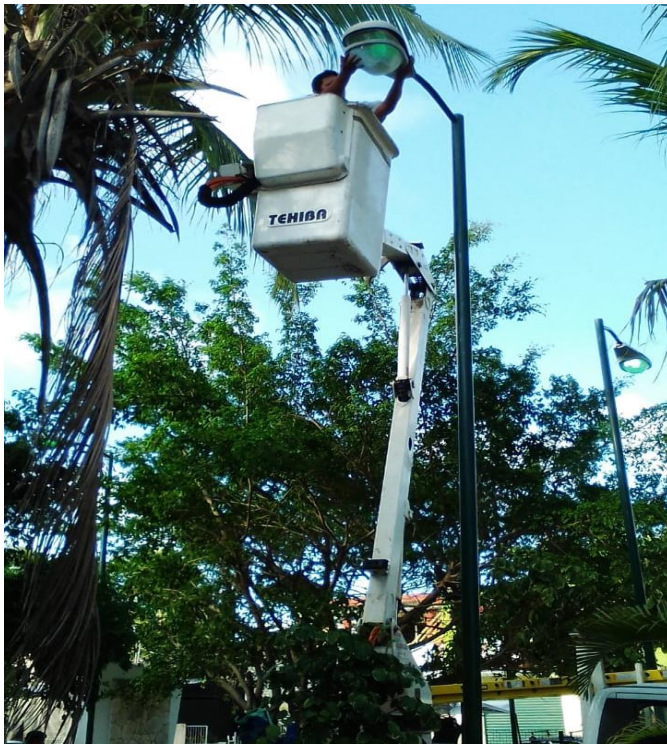
Rehabilitación de luminaria en el Fraccionamiento Aldea Zama
