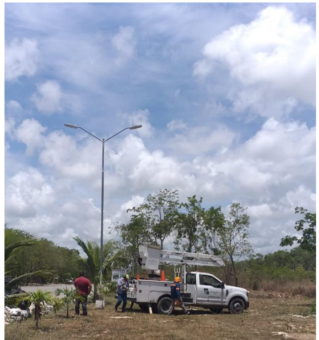
Instalación de luminaria en la estación de bomberos, Col. Tumbenka
