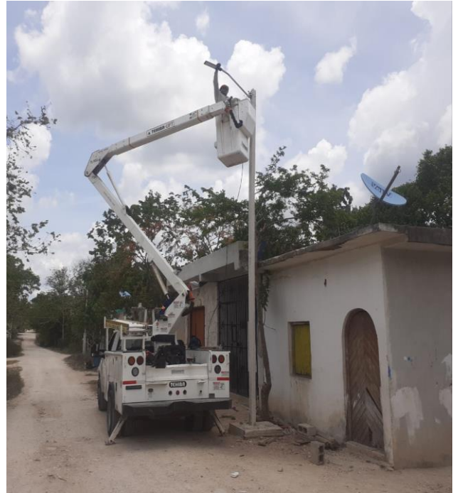
Instalación de luminarias en la Comunidad de Francisco Uh May
