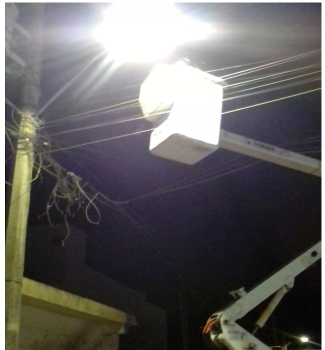
Rehabilitación de luminaria en la Calle Asteroide / Géminis Sur, Col. Sac Be
