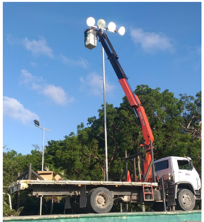
Rehabilitación de luminarias en la Unidad Deportiva de la Col. Luna
