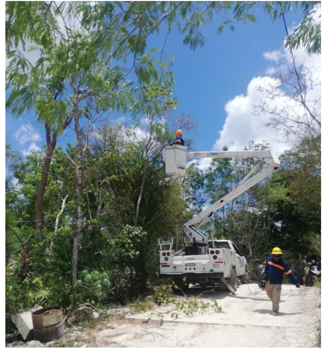
Tensionado de líneas en la Comunidad de Francisco Uh May
