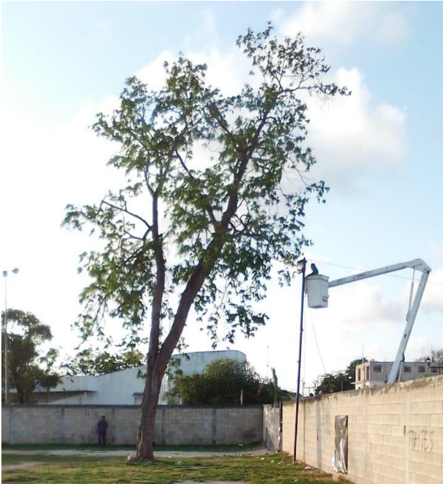
Instalación de luminarias en los terrenos de la expo feria, Col. Lak'iin
