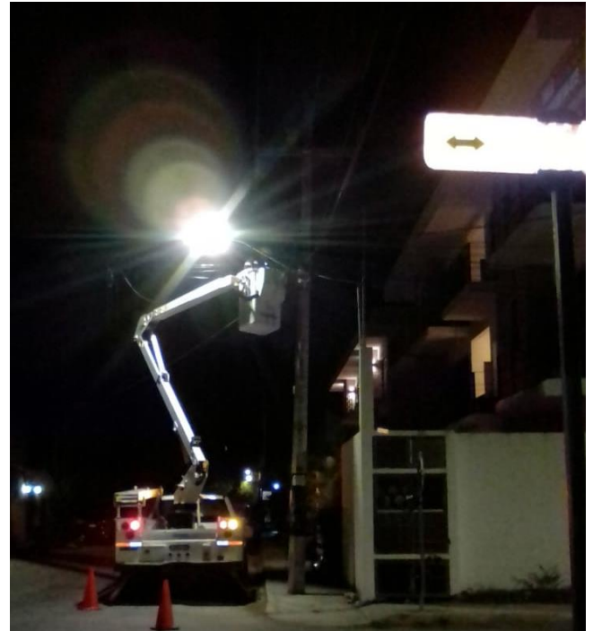
Rehabilitación de luminaria en la Calle Andrómeda con libra y Escorpión, Col. Centro
