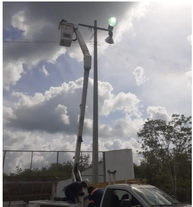
Rehabilitación de luminaria en la Comunidad de Coba
