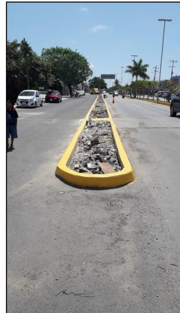
Guarniciones de la carretera federal
