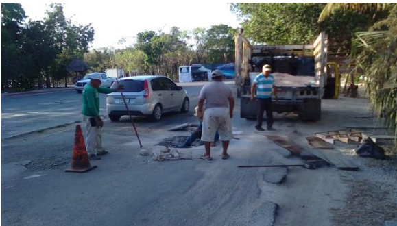
Reparación de pozo carretera federal
