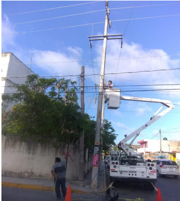
Tensionado de línea para colocar multicontactos a puestos en la Col. Lak'iin
