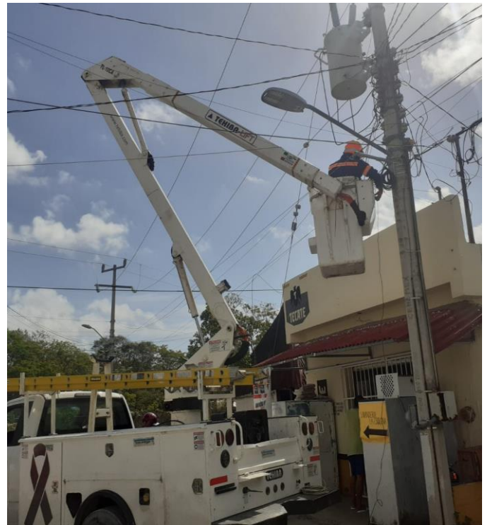
Rehabilitación de luminaria en la Col. Ejido
