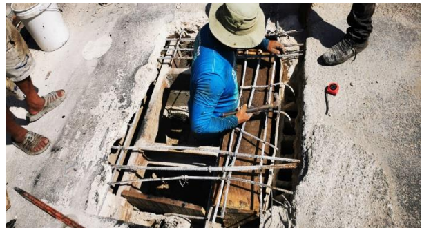
Reparación de pozo carretera federal
