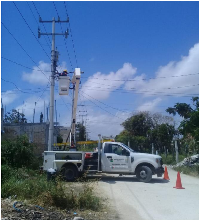
Rehabilitación de luminaria en la Comunidad de Akumal
