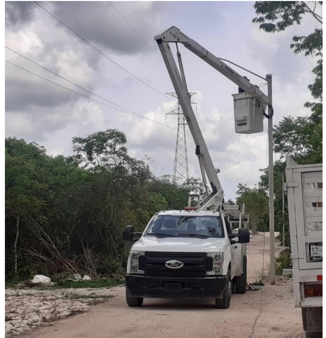
Instalación de luminarias y tendido de líneas en la Comunidad de Macario Gómez
