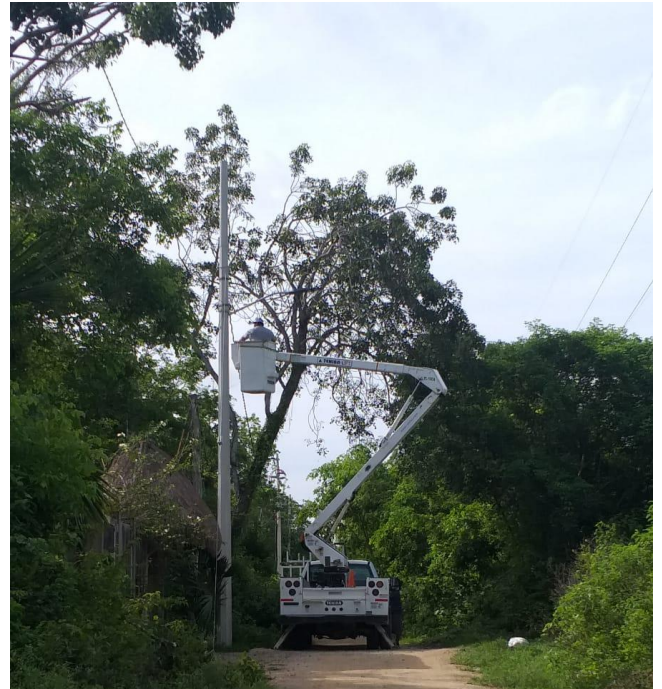
Rehabilitación de luminaria en la Comunidad de Macario Gómez
