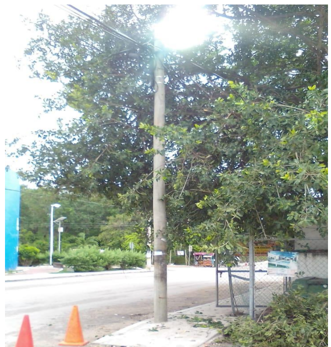
Instalación de luminarias frente a las instalaciones del CADI, Col. Mayapax
