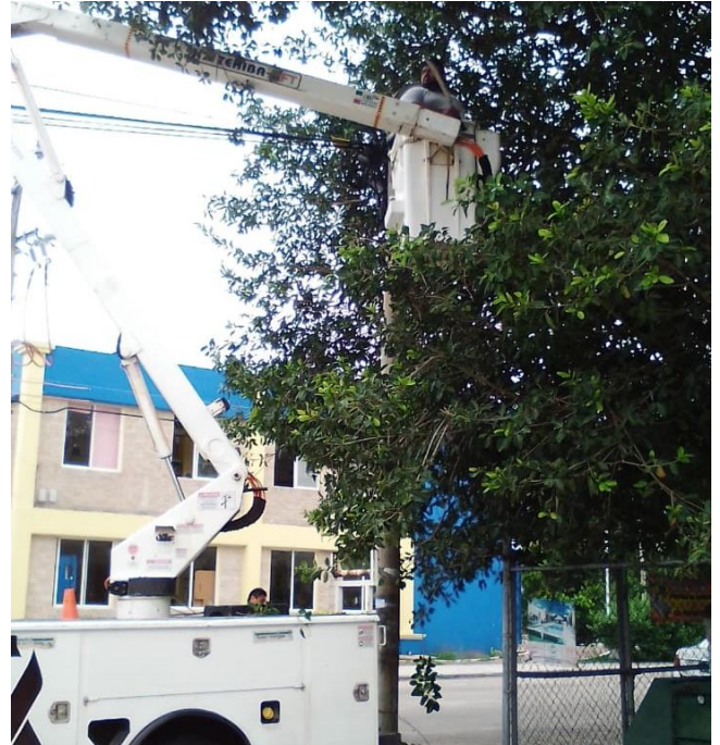
Instalación de acometida para conectar el alumbrado a la Biblioteca Pública, Col. Mayapax
