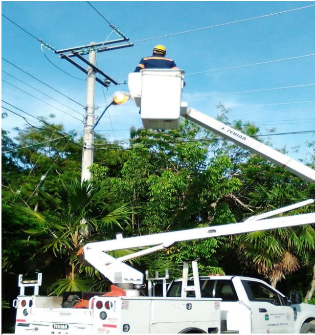
Rehabilitación de luminarias en la Comunidad de Chan Chemuyil
