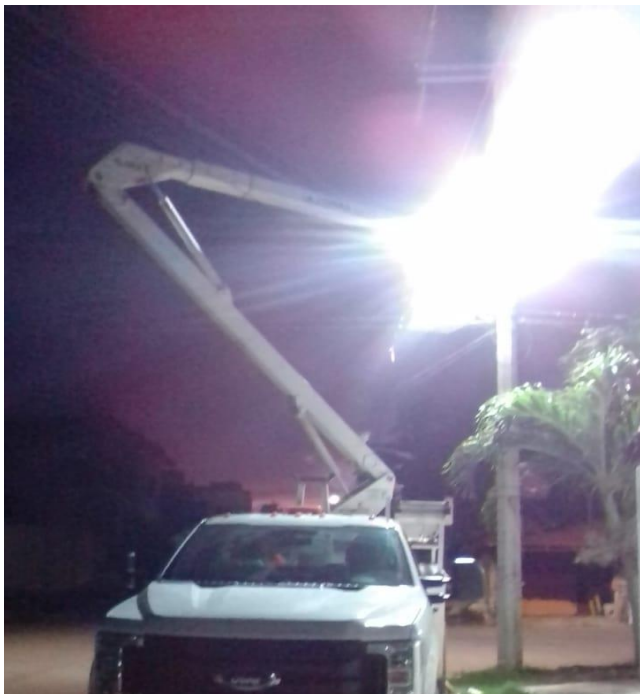
Instalación de reflectores en lugares donde se ubicaron las casillas electorales
