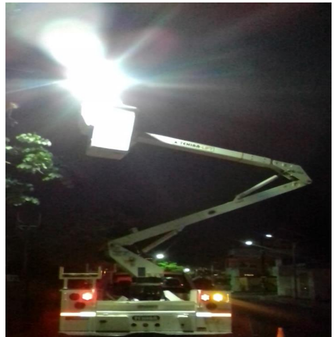
Rehabilitación de luminaria en la Colonia Centro
