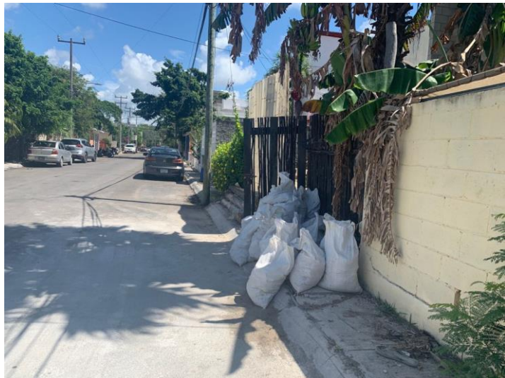
FOTO 2: Sanción por haber caso omiso a notificaciones anteriores, donde se le solicita retirar material de construcción, c. 17 mz 12, lt 02-A, / c. 2 bis ote y c. 4 ote. Fracc. Villas Tulum.
