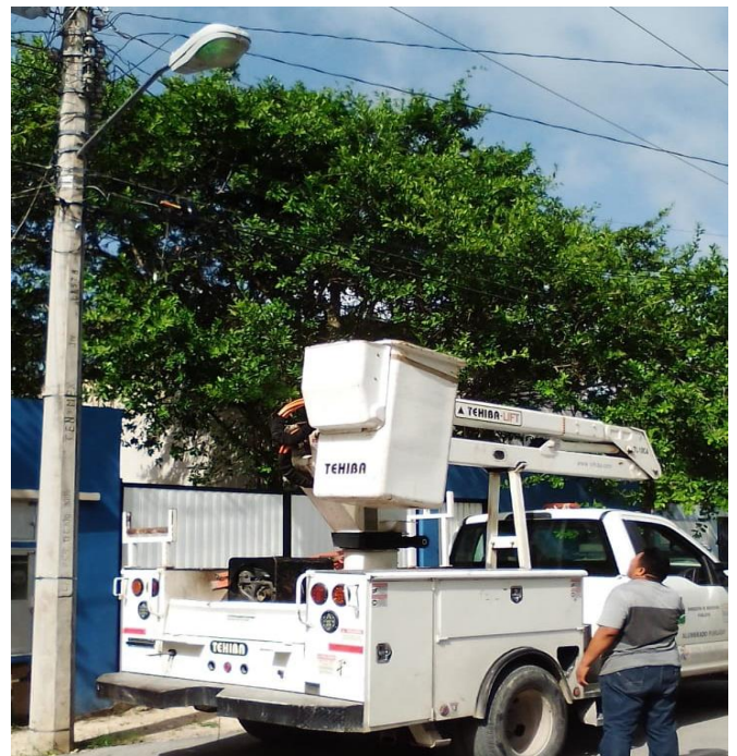
Rehabilitación de luminaria en la Col. Ejido
