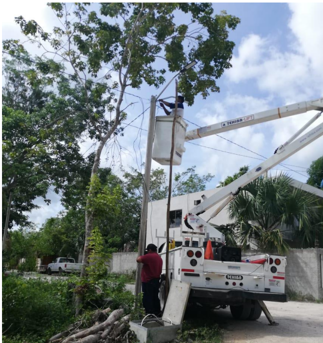
Rehabilitación de luminaria en la Comunidad de Francisco Uh May
