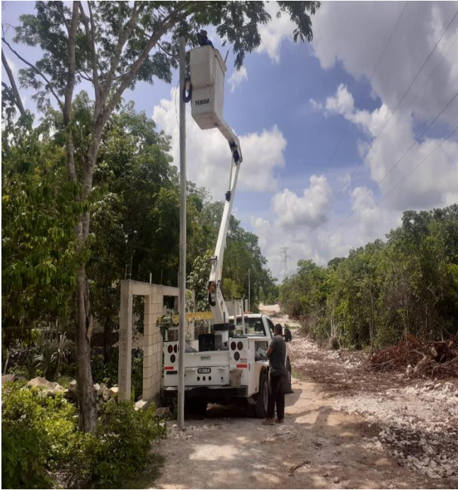
Instalación de luminarias y tendido de líneas en la Comunidad de Macario Gómez
