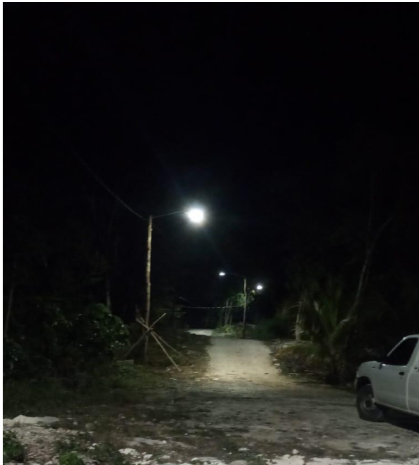
Rehabilitación de luminaria en el Fraccionamiento Huracanes
