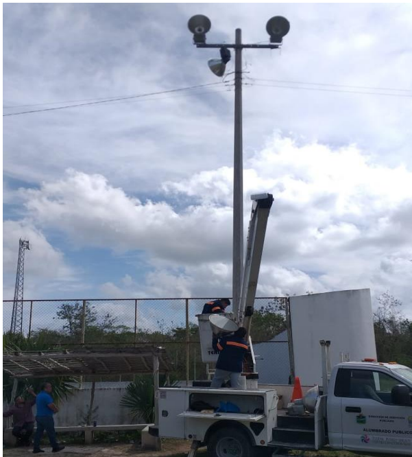
Rehabilitación de luminaria en la Comunidad Coba
