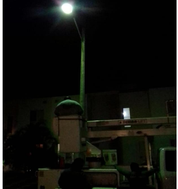
Rehabilitación de luminaria en la Colonia Sac-Be
