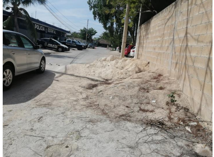
FOTO 2: Sanción por haber caso omiso a notificaciones anteriores, donde se le solicita retirar material de construcción, : c. 8 entre av. Tulum a un costado de la carretera federal a carrillo pto.
