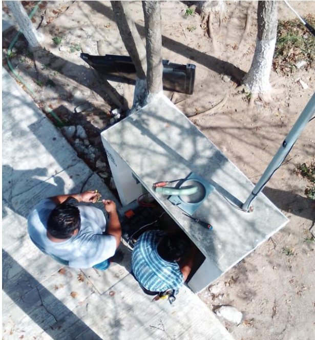
Reconexión de líneas quemadas en base de medidor del DIF Municipal.
