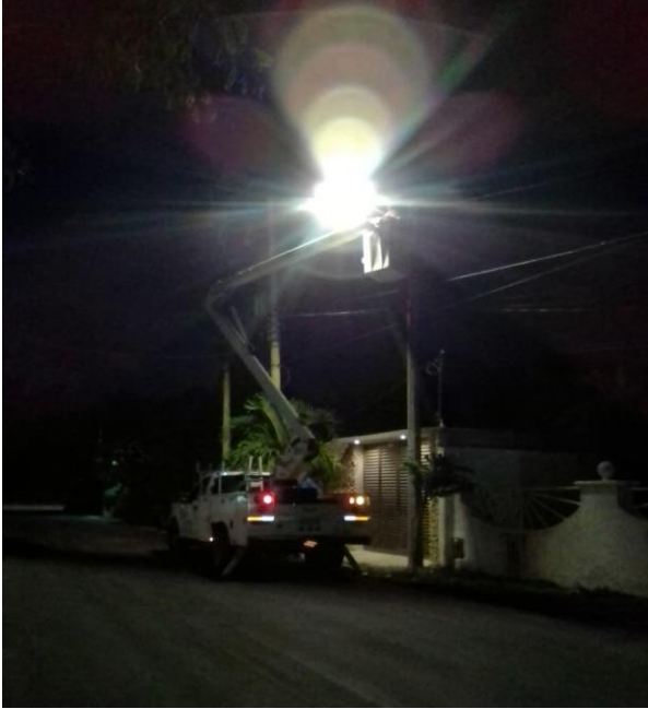
Rehabilitación de luminaria en la Colonia Ejido
