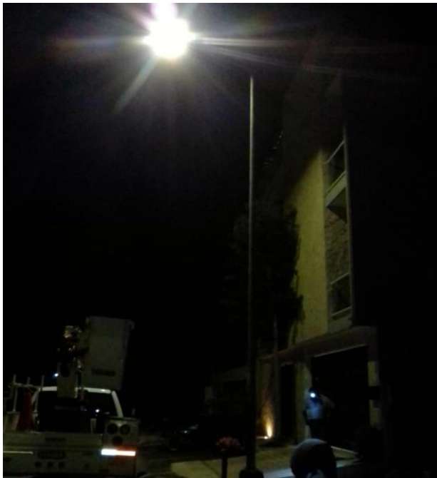
Rehabilitación de luminaria en la Colonia Xul-Ka
