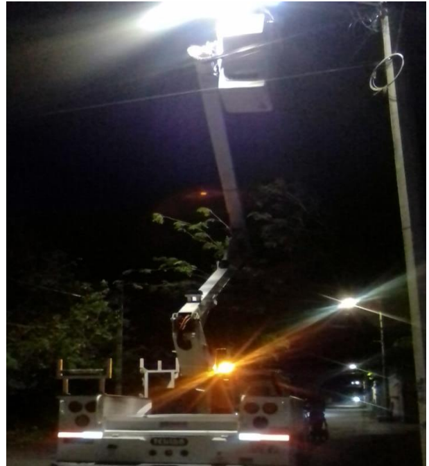
Rehabilitación de luminaria en la Colonia Ejido
