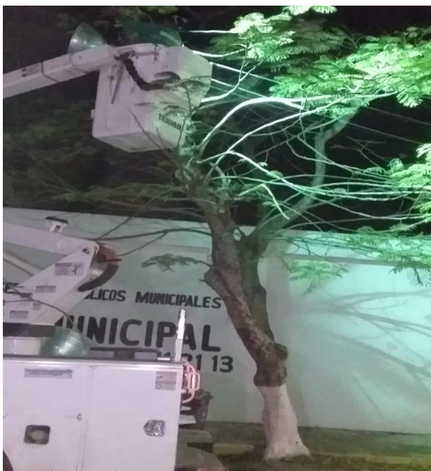
Rehabilitación de luminarias en el Panteón Municipal
