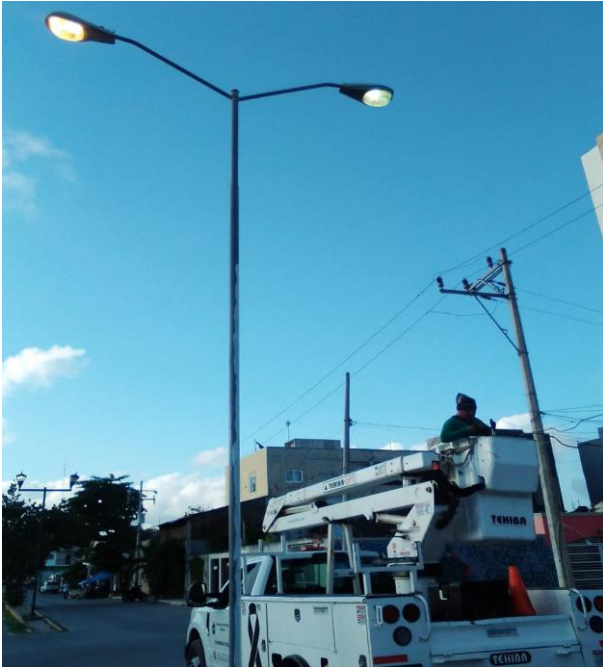
Rehabilitación de luminaria en la Colonia Centro
