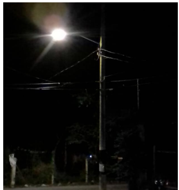
Rehabilitación de luminaria en la Colonia Lak'iin
