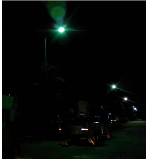
Rehabilitación de luminaria en la Colonia Yaax-Tulum
