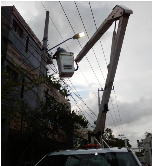
Rehabilitación de luminaria en la Colonia Maya
