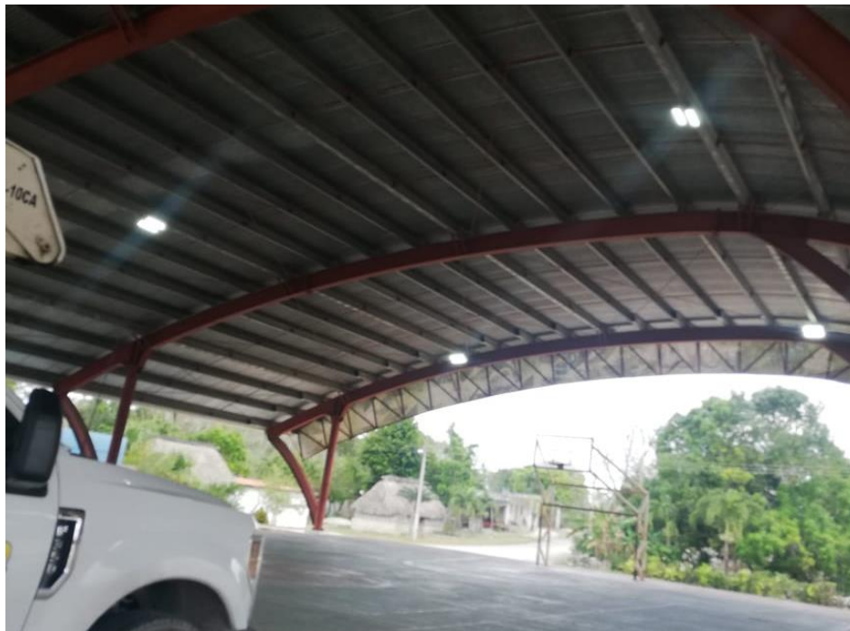
Cambio de luminarias en el domo de la Comunidad de Hondzonot
