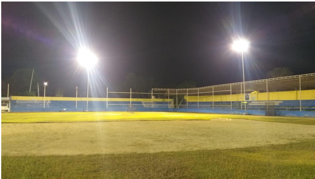
Rehabilitación de luminarias en el campo de beisbol de la Unidad Deportiva
