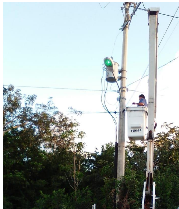
Rehabilitación de luminaria en la Colonia Veleta
