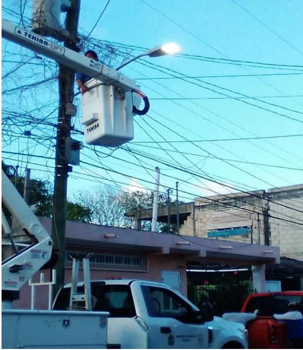
Rehabilitación de luminaria en la Colonia Centro
