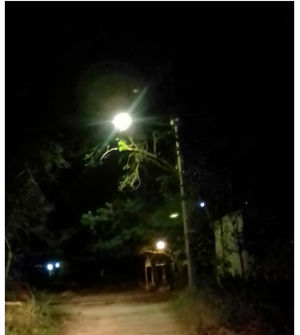
Rehabilitación de luminaria en la Colonia Sacbe
