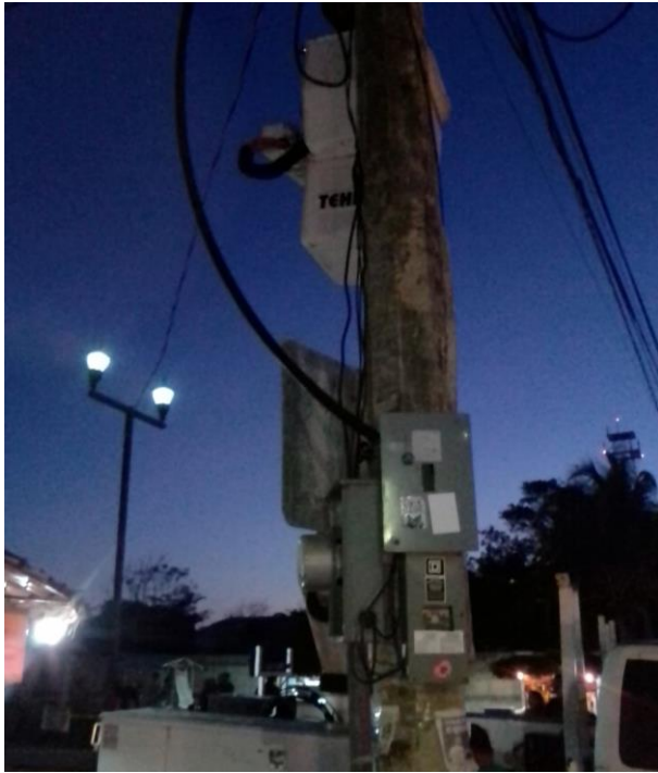
Rehabilitación de luminaria en la Colonia Centro
