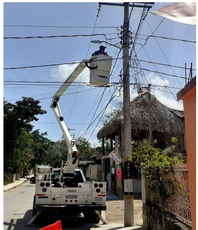
Rehabilitación de luminaria en la Colonia Maya
