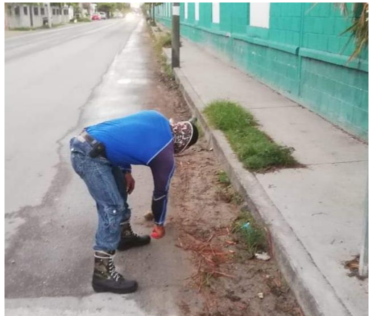
FOTO 12.- Limpieza realizada en la calle Júpiter
