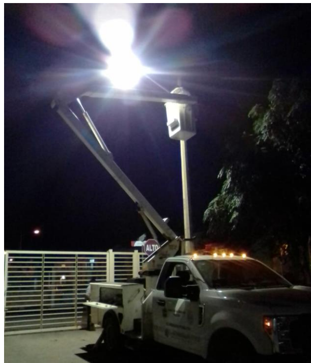
Rehabilitación de luminaria en el Fracc. Palmas
