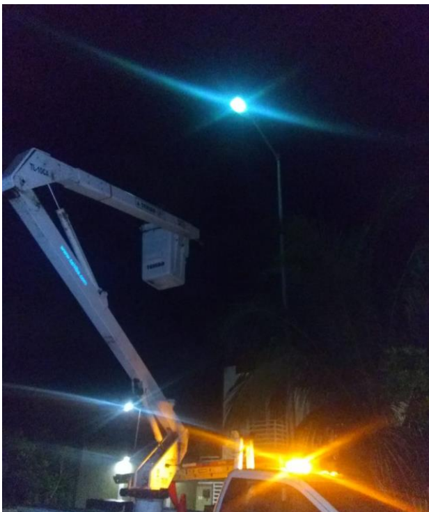
Rehabilitación de luminaria en la Colonia Yaaxtulum
