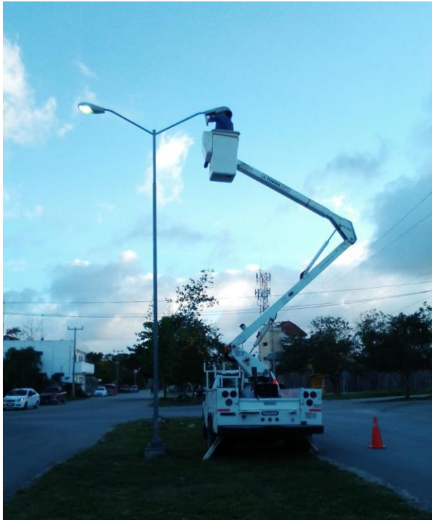
Rehabilitación de luminaria en la Colonia Tumbenka
