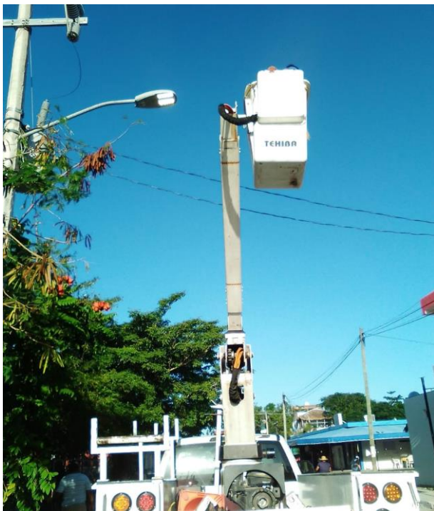
Rehabilitación de luminaria en la Colonia Lakin
