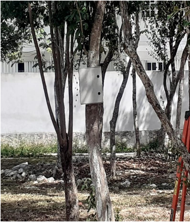
Instalación de multicontacto en el parque de Xul-Ka
