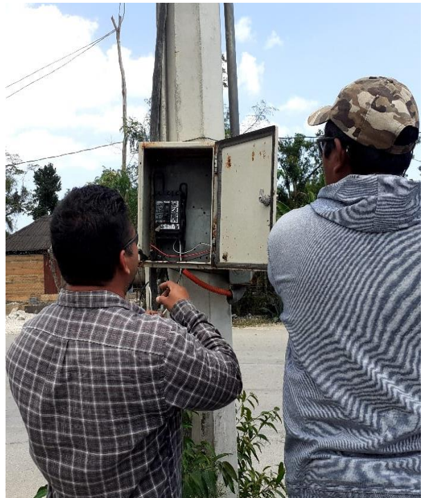
Rehabilitación de sector en la Colonia Ejido
