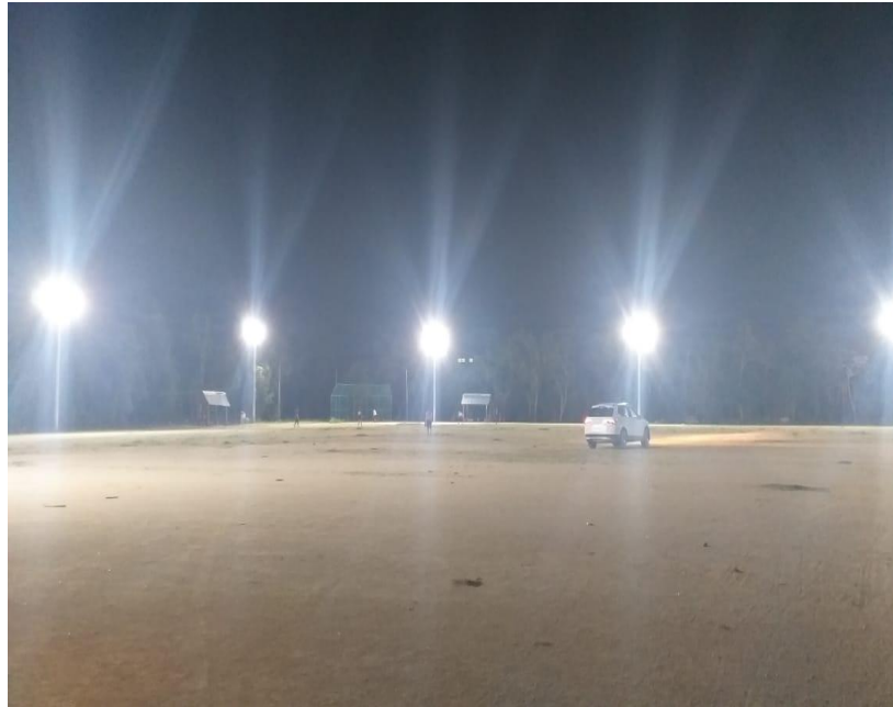
Cambio de luminaria tipo led en el campo deportivo de la comunidad de Akumal
