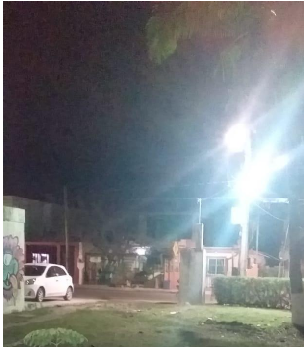
Rehabilitación de luminaria en la Colonia Huracanes
