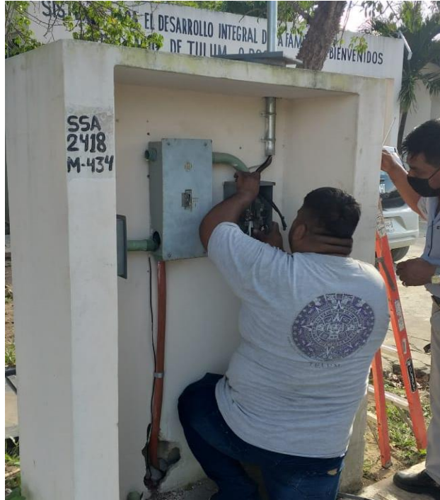
Rehabilitación de líneas sulfatadas en base de medidor del DIF.
