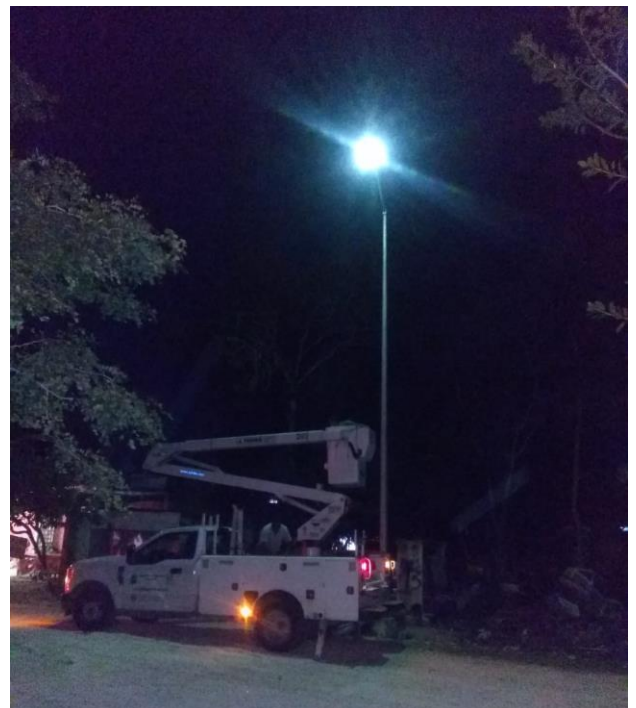
Rehabilitación de luminarias en la Colonia Yaaxtulum
