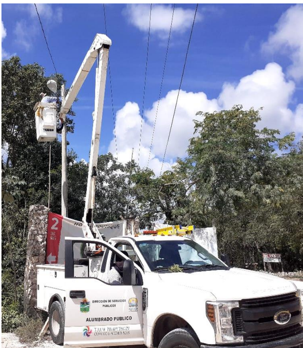
Rehabilitación de luminaria en la Comunidad de Chemuyil
