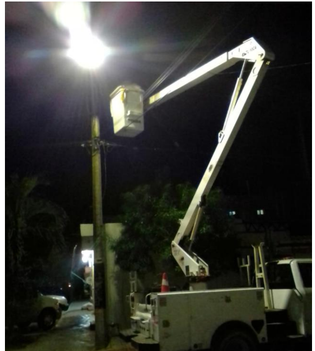
Rehabilitación de luminarias en la Colonia Lakin
