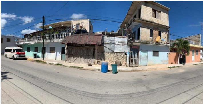
FOTO 1: Sanción por haber caso omiso a notificaciones anteriores, donde se le solicita retirar material de construcción tipo polvo,; c.venus ote/ c. orion sur y c. centauro sur, mz 24 lt 11.
