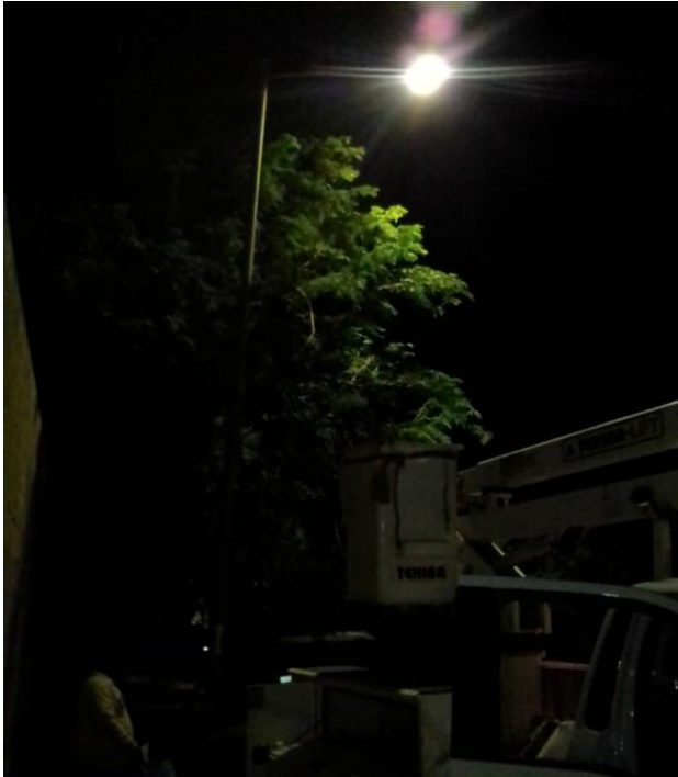
Rehabilitación de luminarias en la Colonia Guerra de Castas
