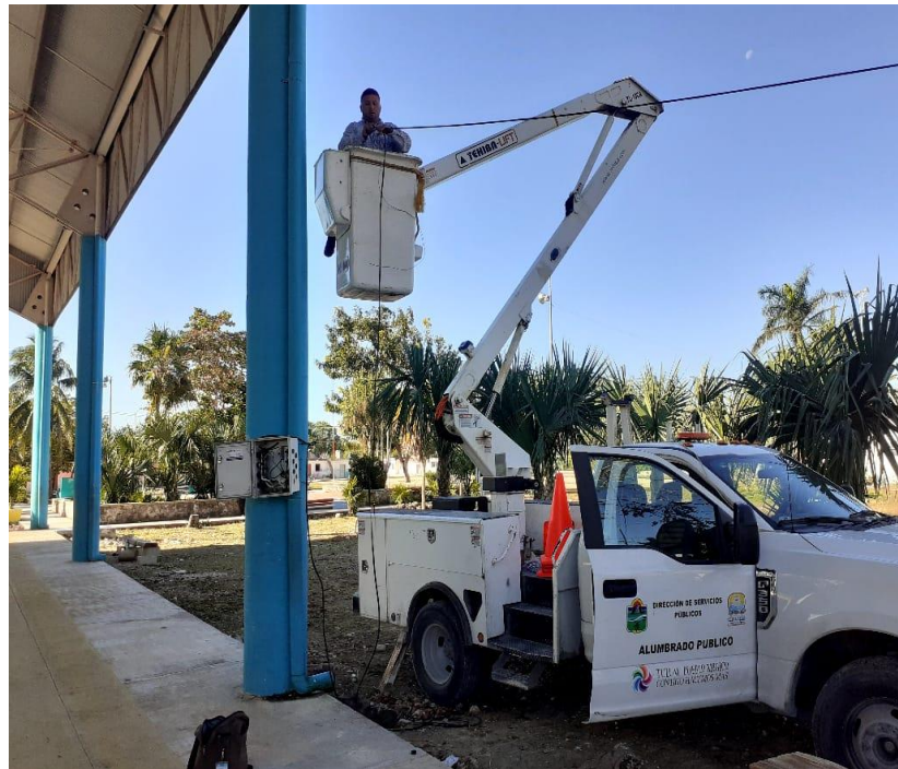
Instalación de multicontacto en la comunidad de San Juan de Dios para la Caravana Ciudadana
