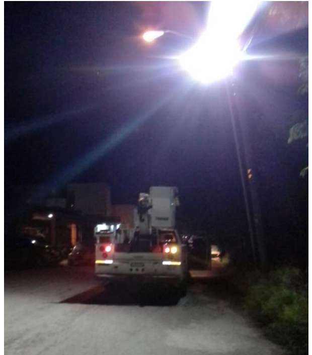
Instalación de luminarias tipo reflector en el Área de Recolección
