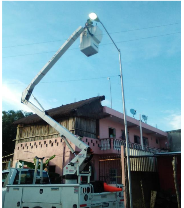
Rehabilitación de luminarias en la Colonia Mayapax
