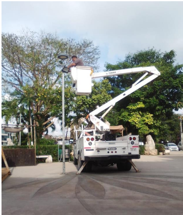
Rehabilitación de luminaria en la Colonia Centro
