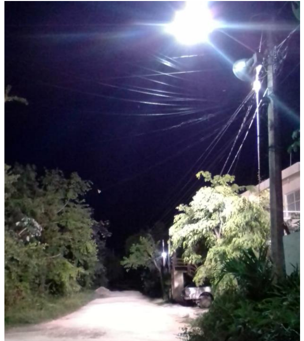
Rehabilitación de luminarias en la Colonia Ejido
