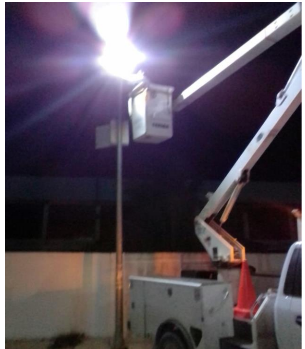
Rehabilitación de luminaria en la Colonia Mayapax
