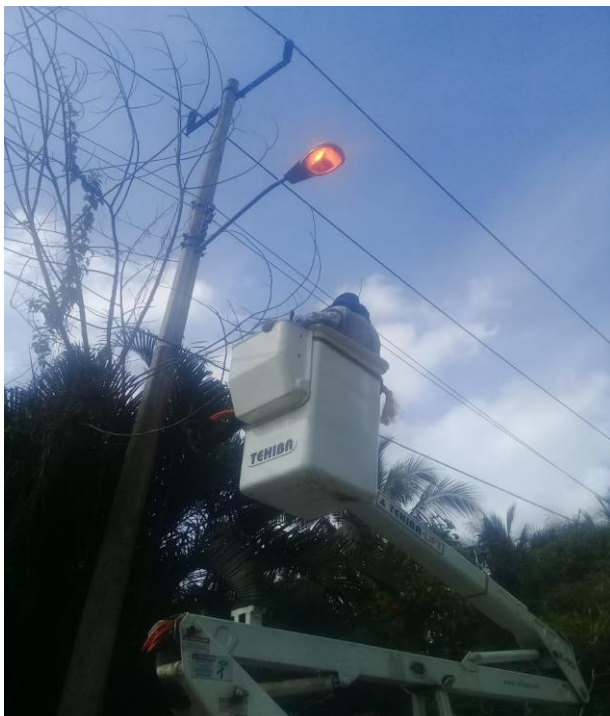
Rehabilitación de luminaria en la Comunidad de Coba
