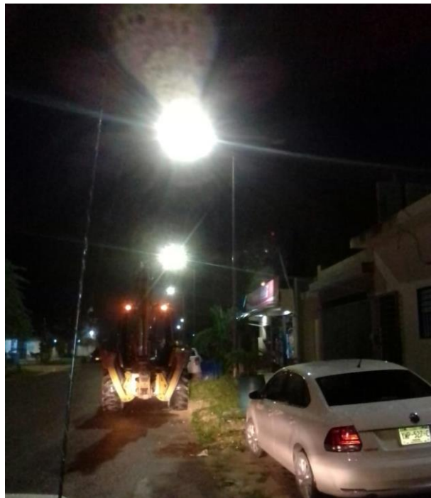
Rehabilitación de luminaria en la Colonia Xul-Ka
