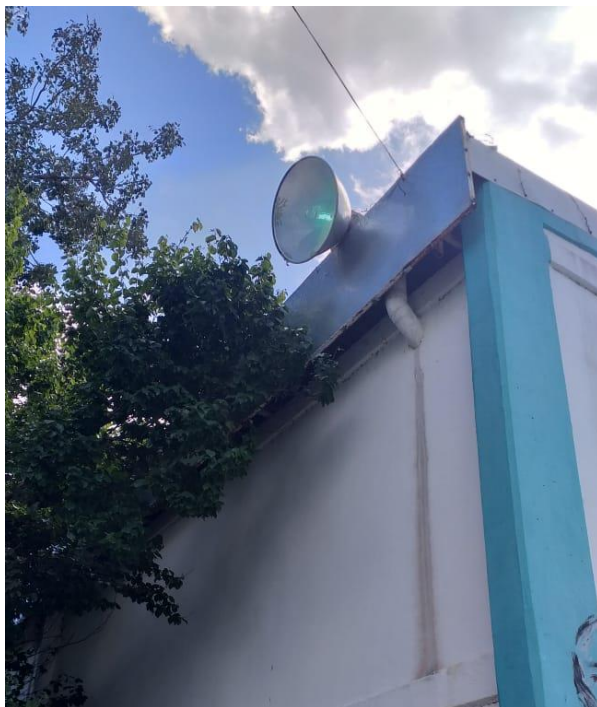
Rehabilitación de luminaria en la Unidad Deportiva
