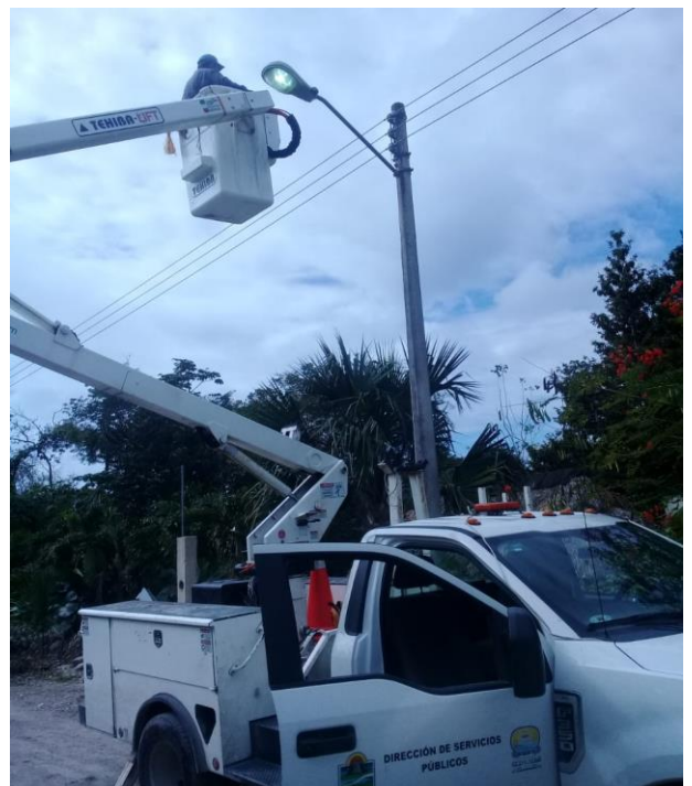
Rehabilitación de luminaria en la Comunidad de Sahcab Mucuy
