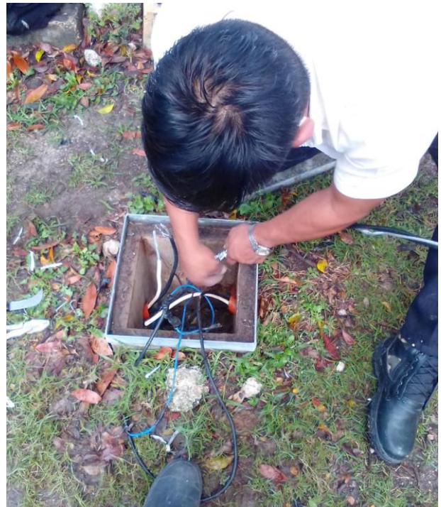
Reparación de corto circuito en la Colonia Centro
