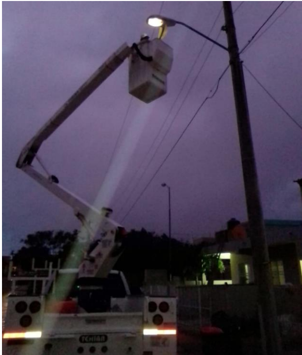
Rehabilitación de luminaria en la Colonia Tumben Ka
