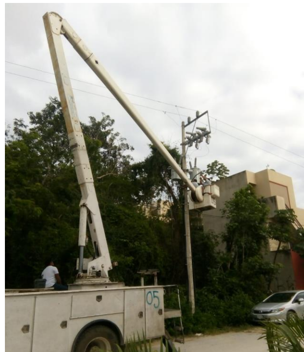
Rehabilitación de sector en la Col. Xul-Ka
