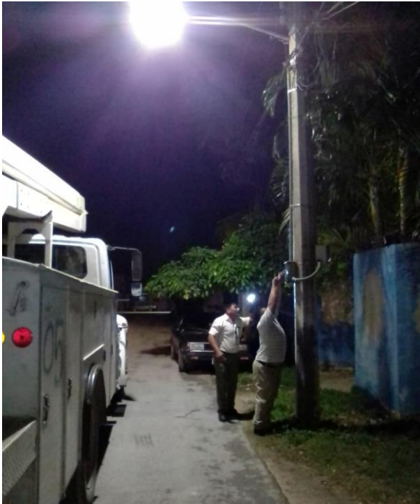
Rehabilitación de sector en la Col. Ejido
