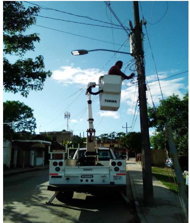
Rehabilitación de luminaria en la Col. Luna
