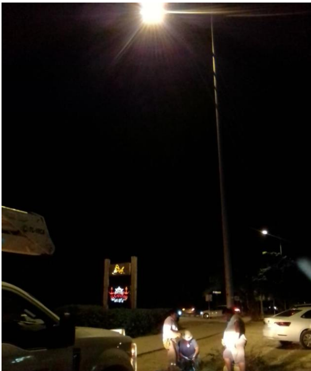
Rehabilitación de sector en la Col. Sac-Be
