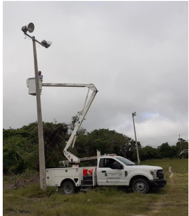
Rehabilitación de luminarias en la Comunidad de Chemuyil
