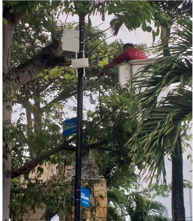
Alimentación de líneas al codificador de internet parque dos aguas
