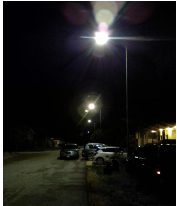
Rehabilitación de luminaria en la Col. Xul-Ka
