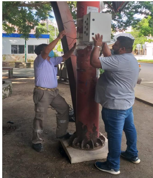
Instalación de gabinete multicontacto en la colonia Lak'iin para la Caravana de Servicios Municipales
