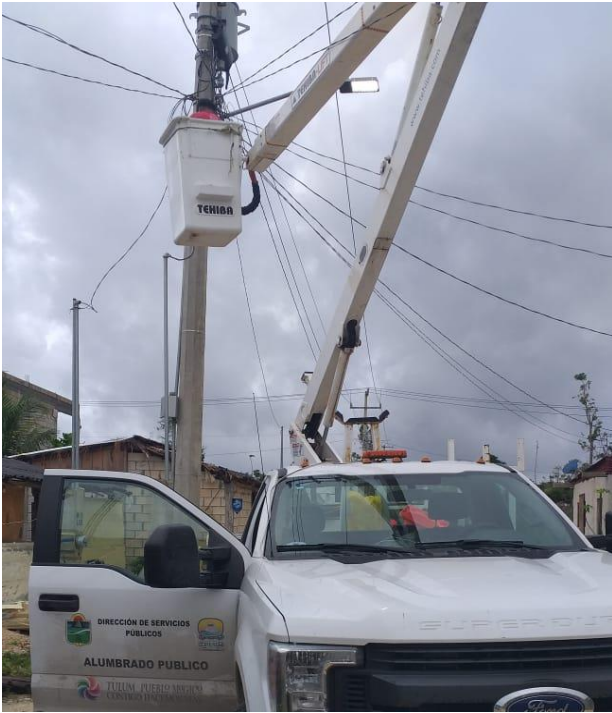
Rehabilitación de luminarias en la Comunidad de Akumal
