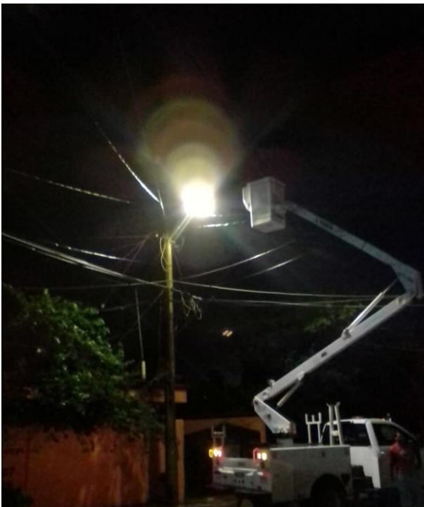
Rehabilitación de luminaria en la Col. Maya
