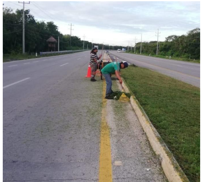
Limpieza realizada en carretera federal
