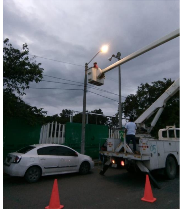
Rehabilitación de luminaria en la Col. Mayapax
