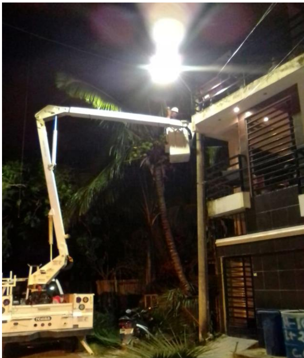
Rehabilitación de luminaria en el Fracc. Villas Tulum
