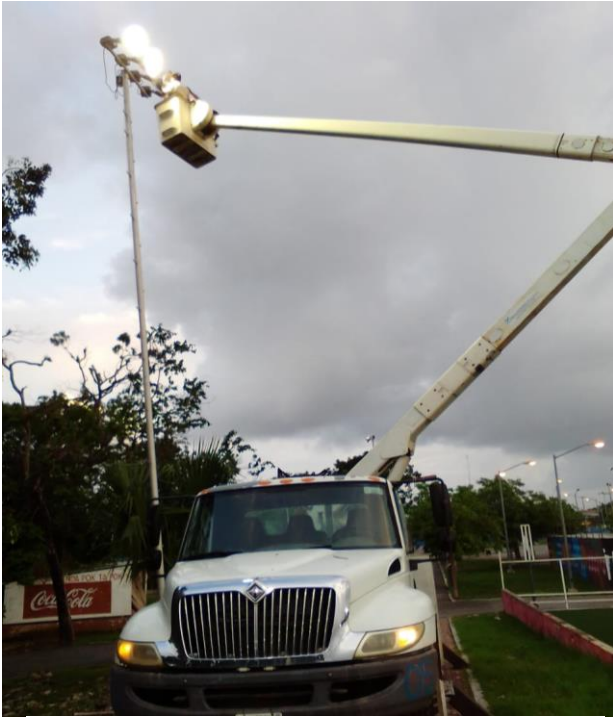
Rehabilitación de luminarias en la Unidad Deportiva
