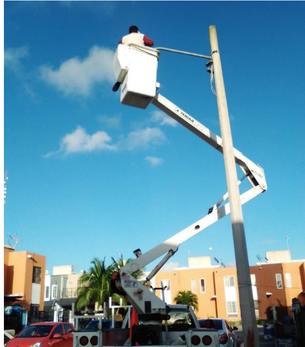
Rehabilitación de luminaria en la Colonia Palmas
