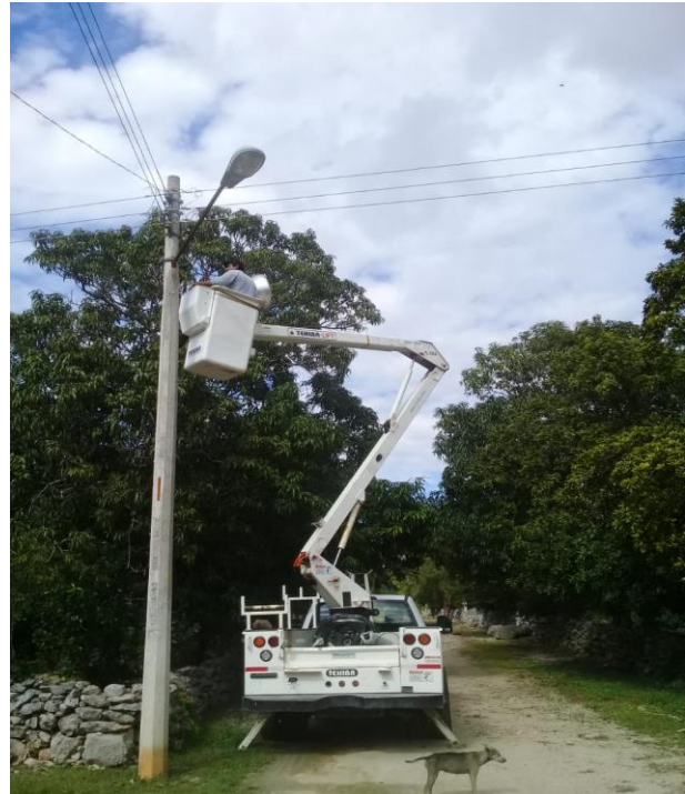
Rehabilitación de luminaria en la Comunidad de Chanchen Palmar
