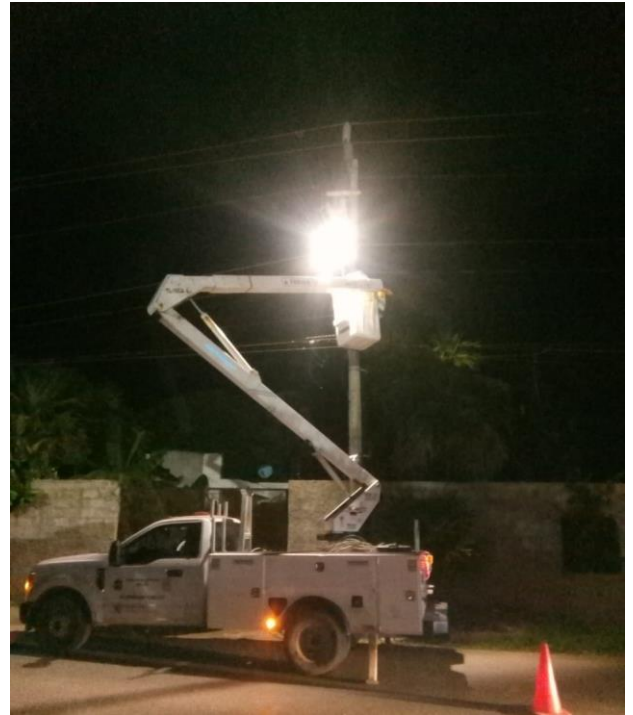
Rehabilitación de luminarias en la Colonia Ejido
