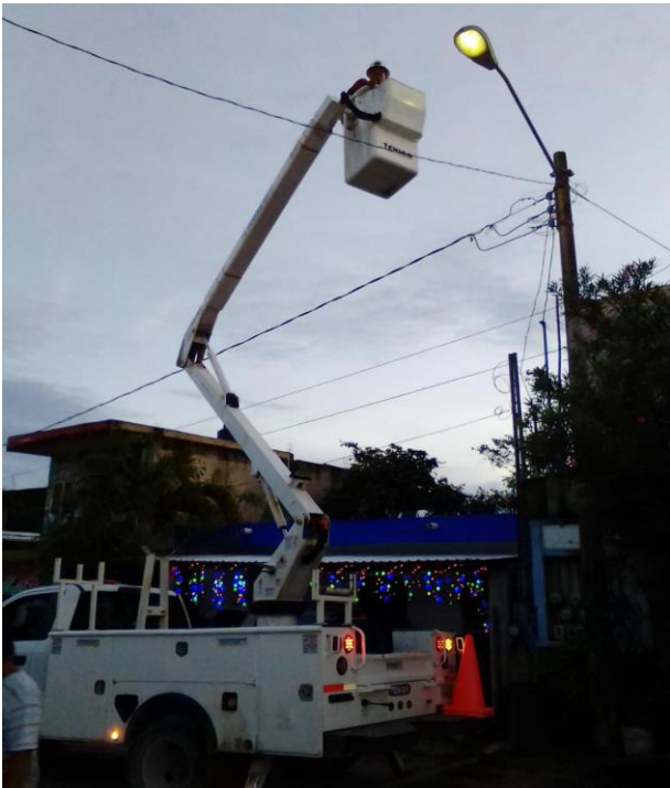
Rehabilitación de luminaria en la Comunidad de Akumal
