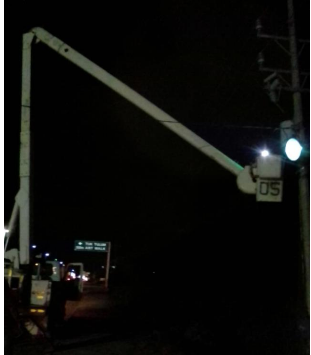
Rehabilitación de luminaria en la Av. Tulum
