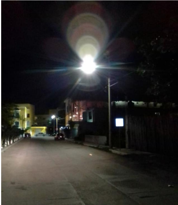
Rehabilitación de luminarias en la Colonia Centro
