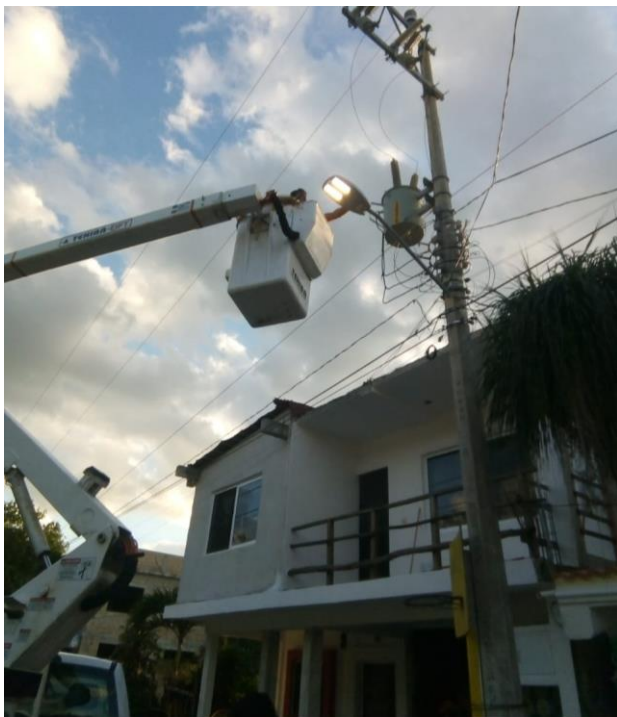
Rehabilitación de luminaria en la Colonia Veleta
