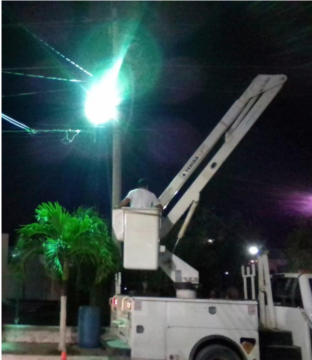
Rehabilitación de luminaria en la Colonia Centro
