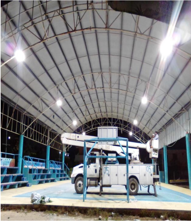
Cambio de reflector en el domo de la Comunidad de Akumal
