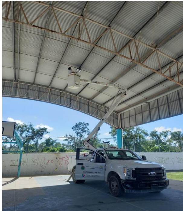
Cambio de reflector en el domo de la Colonia Lakin
