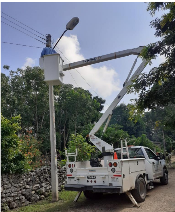
Rehabilitación de luminaria en la Comunidad de Chanchen Palmar
