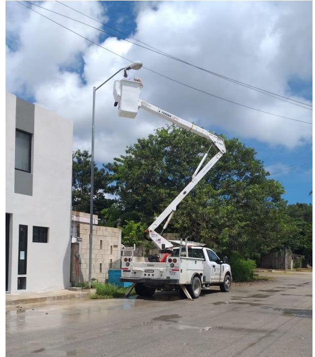
Rehabilitación de luminaria en la Col. Tumben Ka
