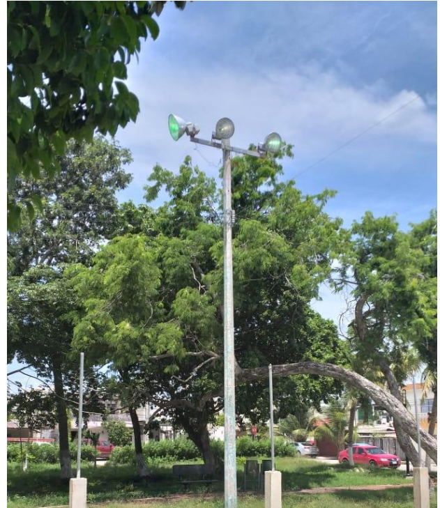
Rehabilitación de luminaria en la Col. Huracanes
