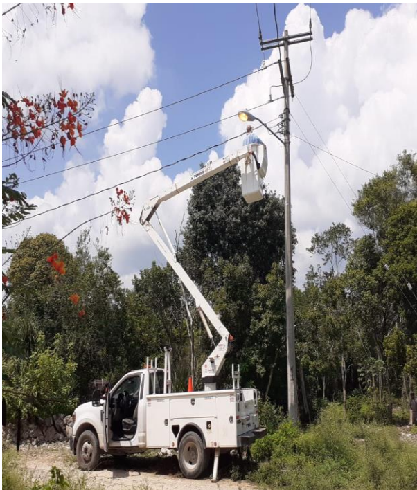
Rehabilitación de luminaria en la Comunidad de Sacabmucuy
