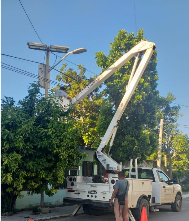
Rehabilitación de luminaria en la Colonia Sacbe
