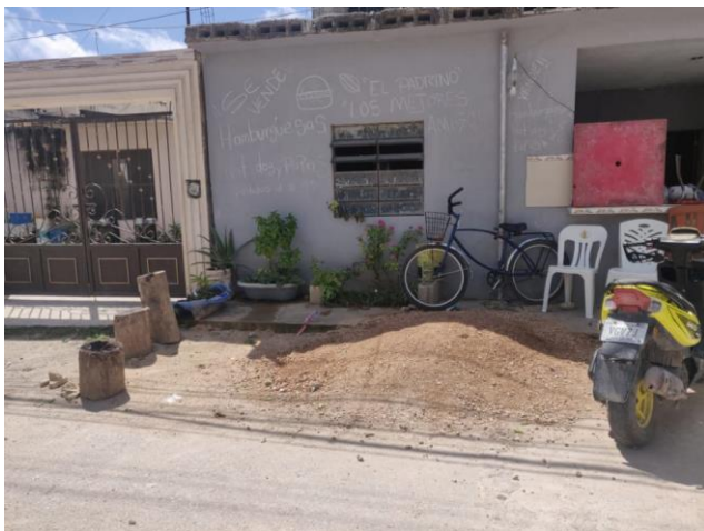
FOTO 2: Sanción por hacer caso omiso a notificaciones anteriores, donde se le solicita retirar material de construcción, Ubicado: c. le xiu pte/omega nte y júpiter nte.
