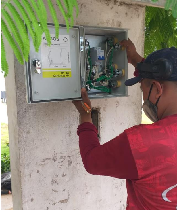
Rehabilitación de bancos de control en la Col. Centro
