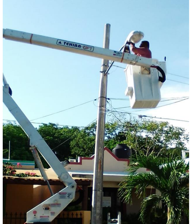
Rehabilitación de luminaria en la Comunidad de Chan Chemuyil
