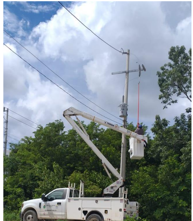
Rehabilitación de sector en la Col. Veleta
