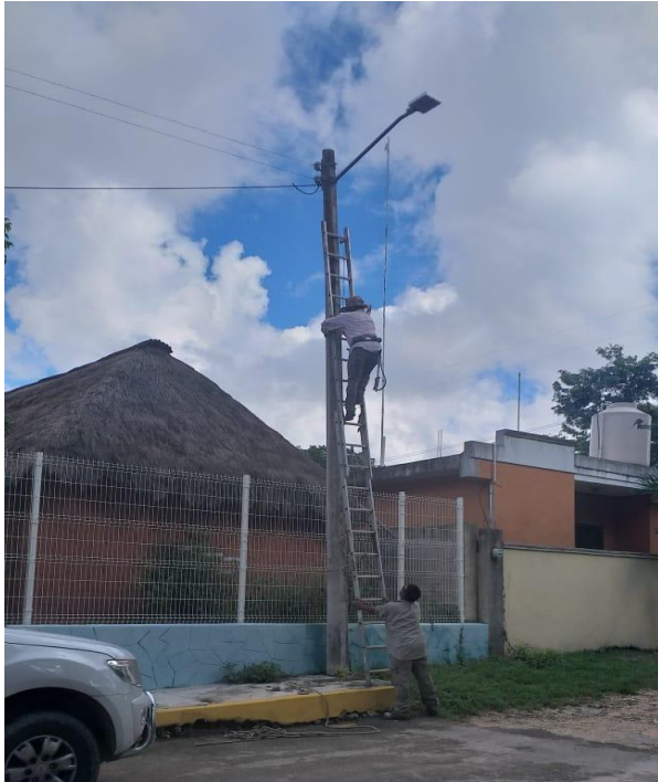
Rehabilitación de luminaria en la Comunidad de Macario Gómez
