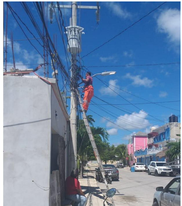
Rehabilitación de luminaria en la Col. Maya
