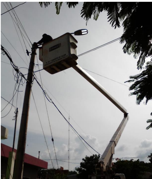
Rehabilitación de luminaria en la Colonia Mayapax
