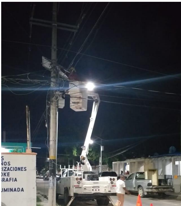
Rehabilitación de luminaria en la Colonia Centro
