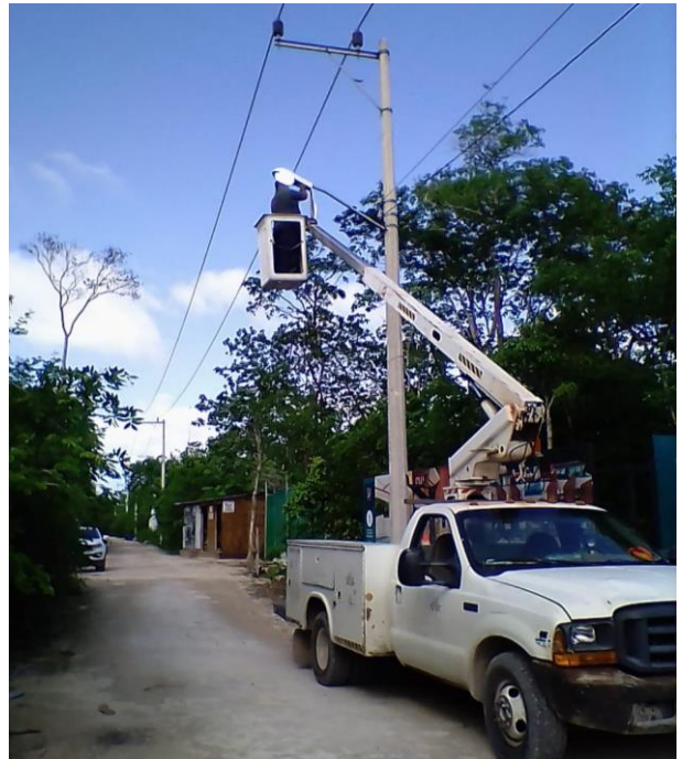
Rehabilitación de luminaria en el Fraccionamiento Heaven
