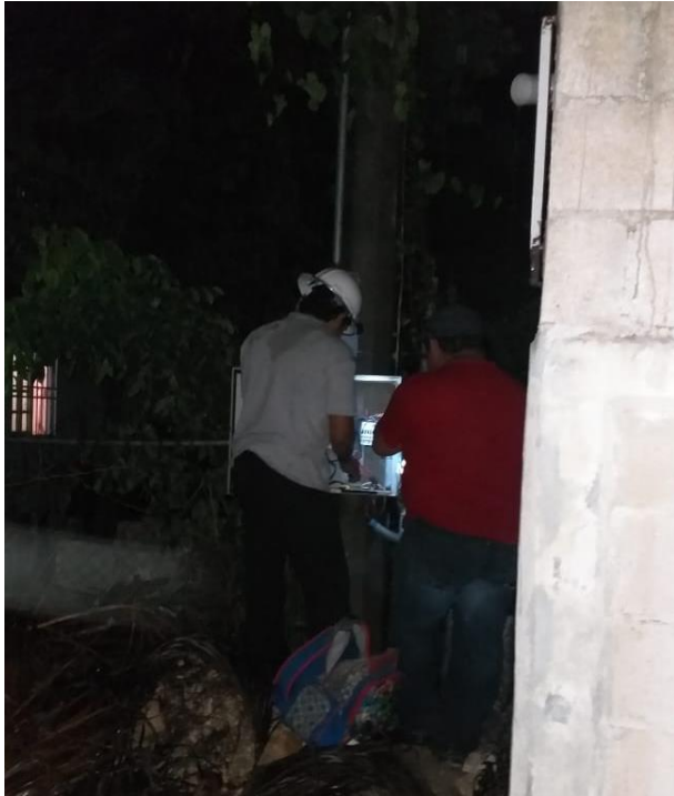
Rehabilitación de sector en el Fraccionamiento Villas Tulum
