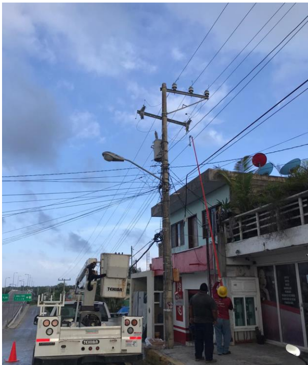
Rehabilitación de sector en la Comunidad de Akumal
