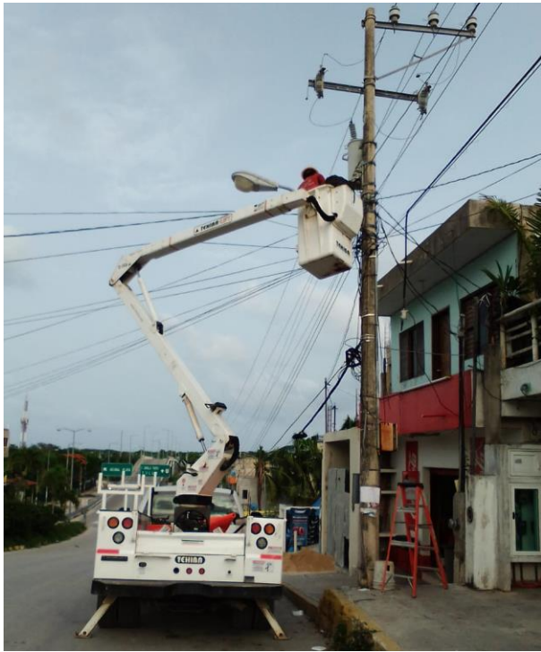
Rehabilitación de luminaria en la Comunidad de Akumal
