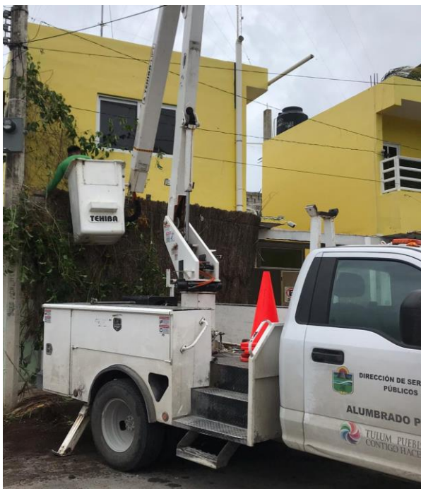
Retiro de un tinglado con zacate que estaba energizado y provocaba corto en la Col. Centro
