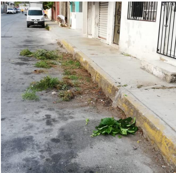
limpieza realizado en calle júpiter
