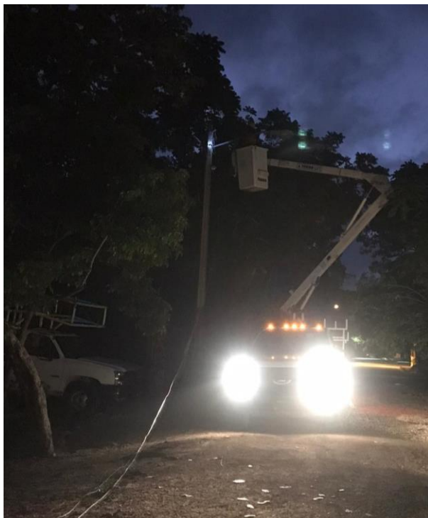
Rehabilitación de líneas reventadas en la Comunidad de Macario Gómez
