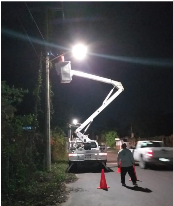
Rehabilitación de luminaria en la Colonia Sacbe
