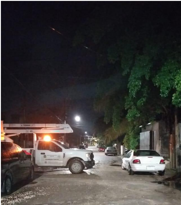
Rehabilitación de luminaria en el Fraccionamiento Villas Tulum
