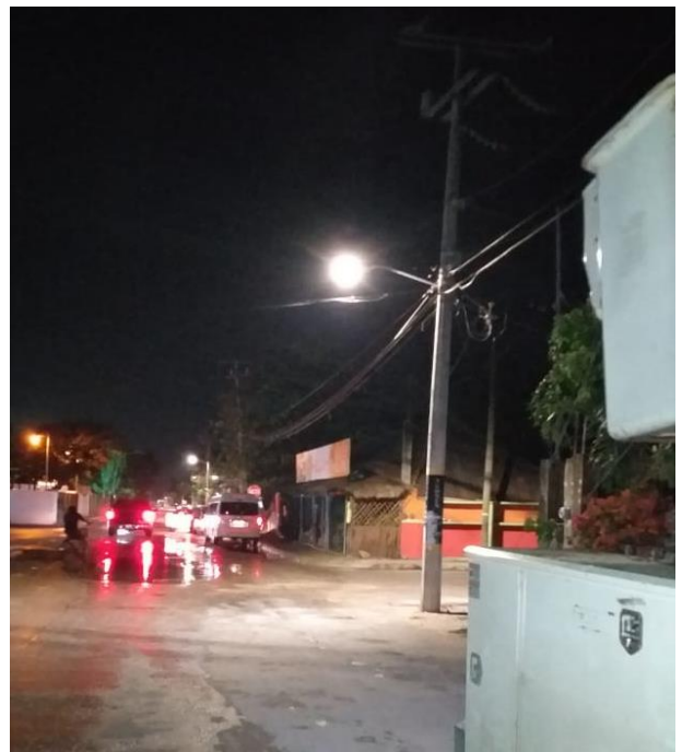
Rehabilitación de luminaria en la Colonia Ejido
