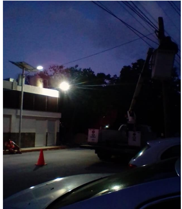
Rehabilitación de luminaria en la Colonia Veleta
