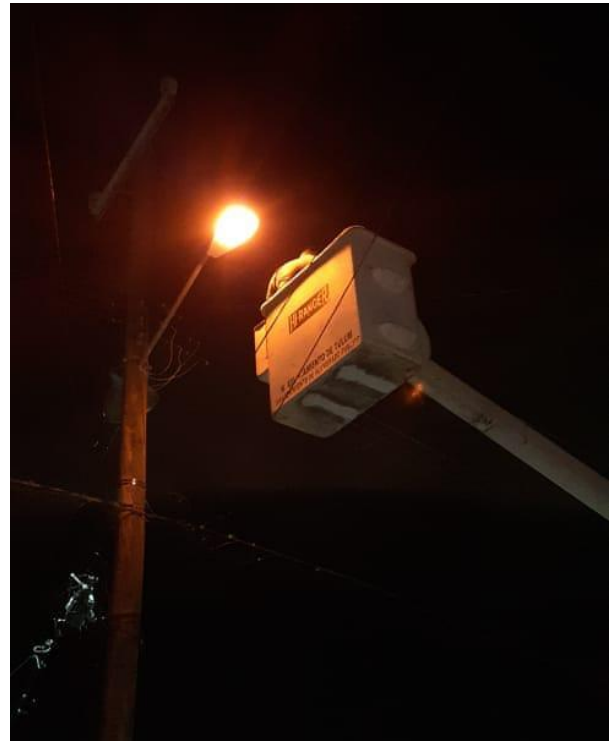
Rehabilitación de luminaria en la Comunidad de Chemuyil
