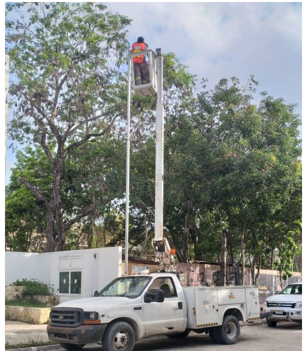
Rehabilitación de luminaria en el Fraccionamiento Aldea Zama
