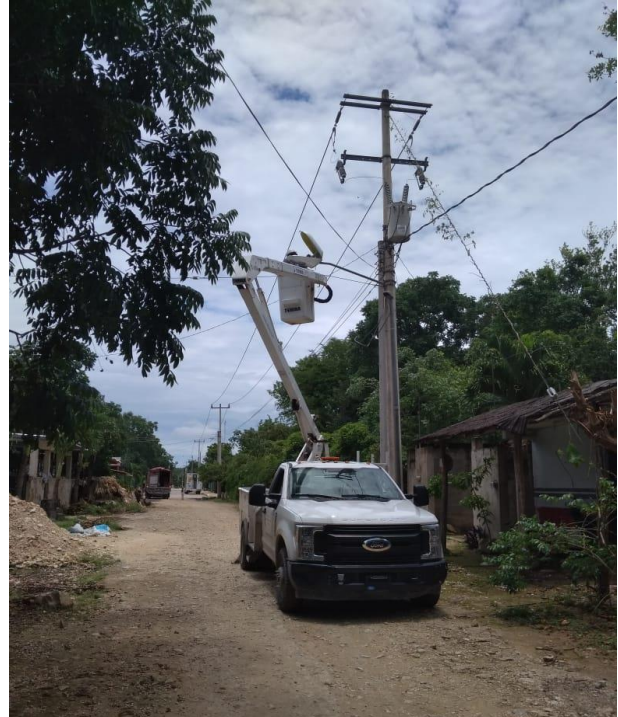
Rehabilitación de luminarias en la Comunidad de San Juan
