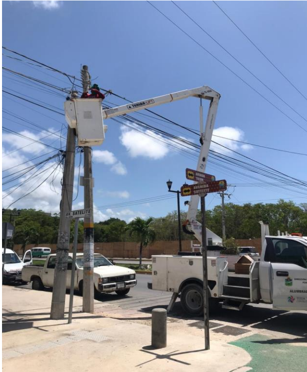
Apoyo a la Dirección de Tránsito para reestablecer energía en el semáforo
