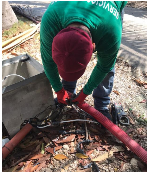
Reparación de corto circuito en la Av. Coba
