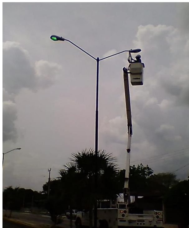
Rehabilitación de luminaria en la Comunidad de Manuel Antonio AY
