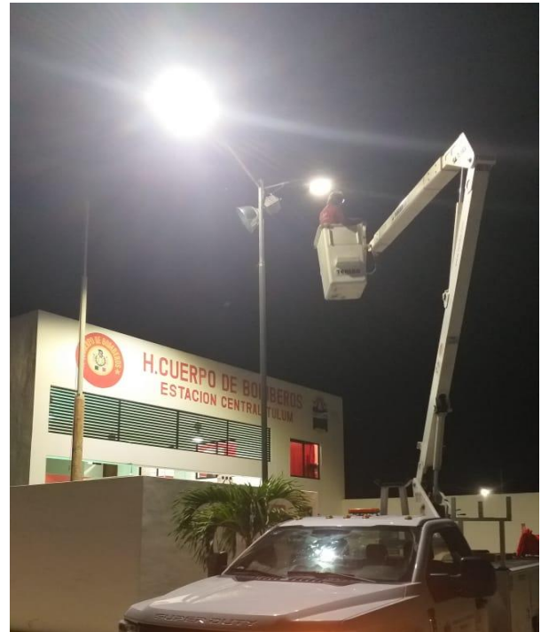
Cambio de luminaria led en la Colonia Tumben Ka
