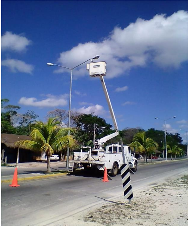
Rehabilitación de luminaria en la Comunidad de Macario Gómez
