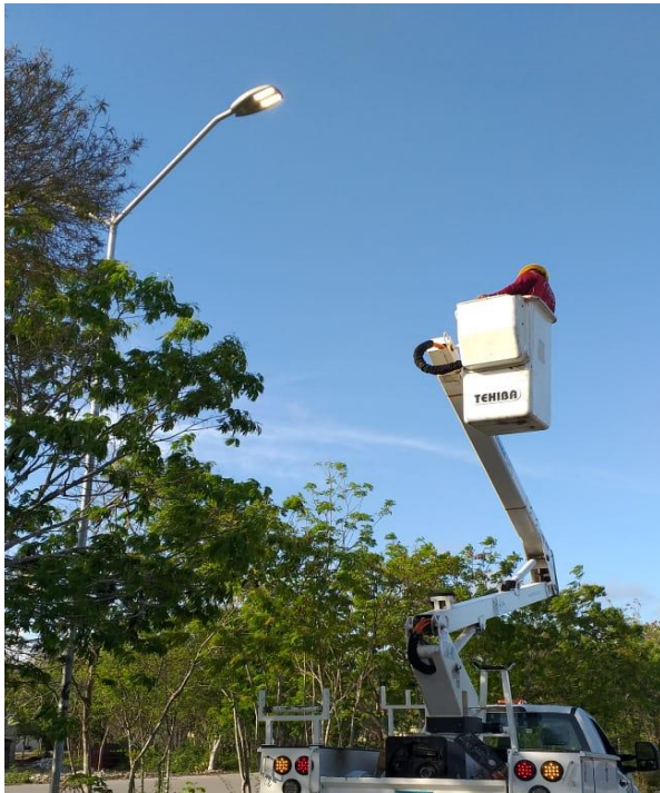
Cambio de luminaria led en la Colonia Tumben Ka
