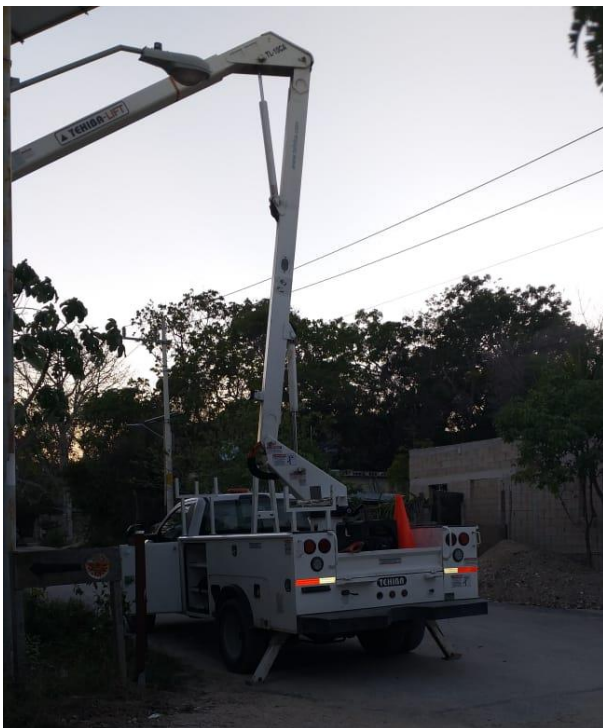
Rehabilitación de luminaria en la Colonia Veleta
