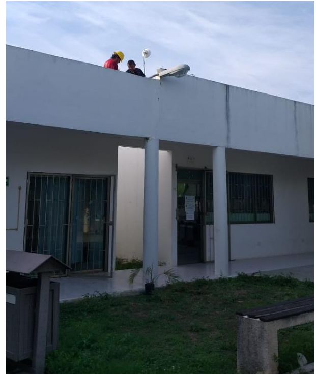
Instalación de luminaria tipo reflector en la Dirección de Desarrollo Social
