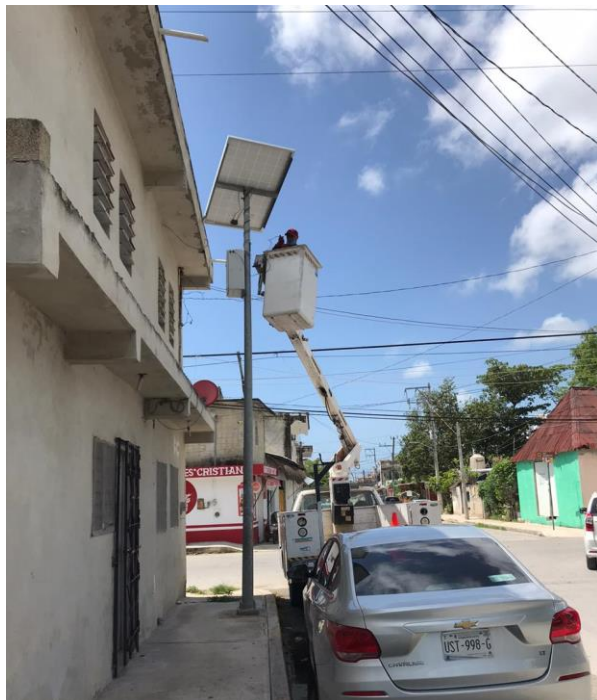
Rehabilitación de luminaria en la Colonia Centro
