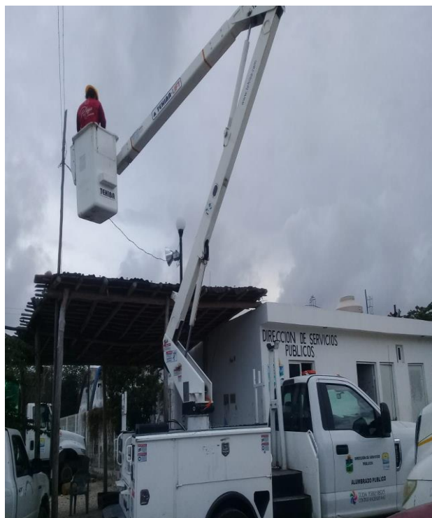
Rehabilitación de luminaria en el área de recolección de la Dirección de Servicios Públicos
