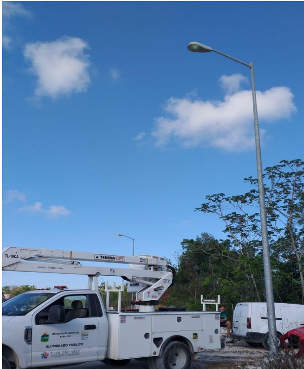
Rehabilitación de luminaria en la Colonia Yaax-Tulum
