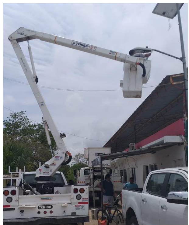
Rehabilitación de luminaria en la Dirección de Servicios Públicos
