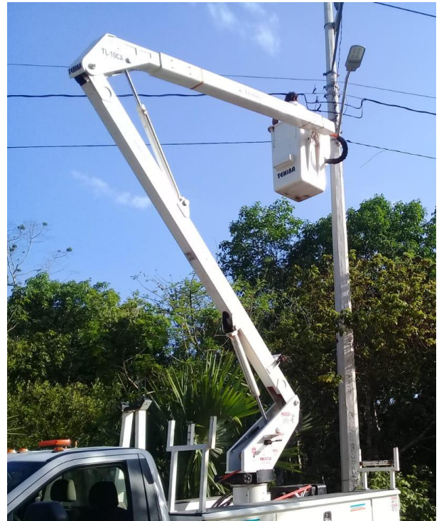
Tensión de líneas en la Comunidad de San Juan
