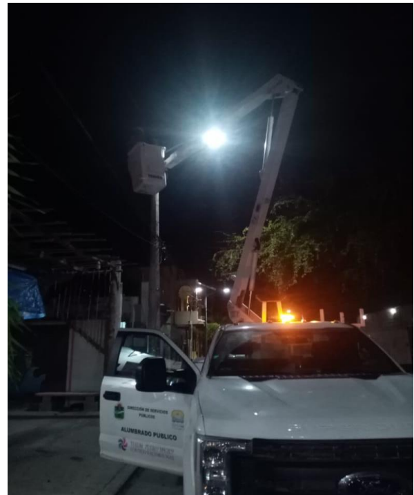
Rehabilitación de luminaria solar en la Col. Centro C. Sagitario
