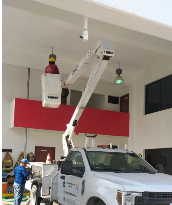
Rehabilitación de luminarias en la Dirección de Bomberos
