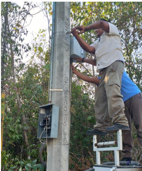
Rehabilitación de banco de control en la Colonia Tumben Ka
