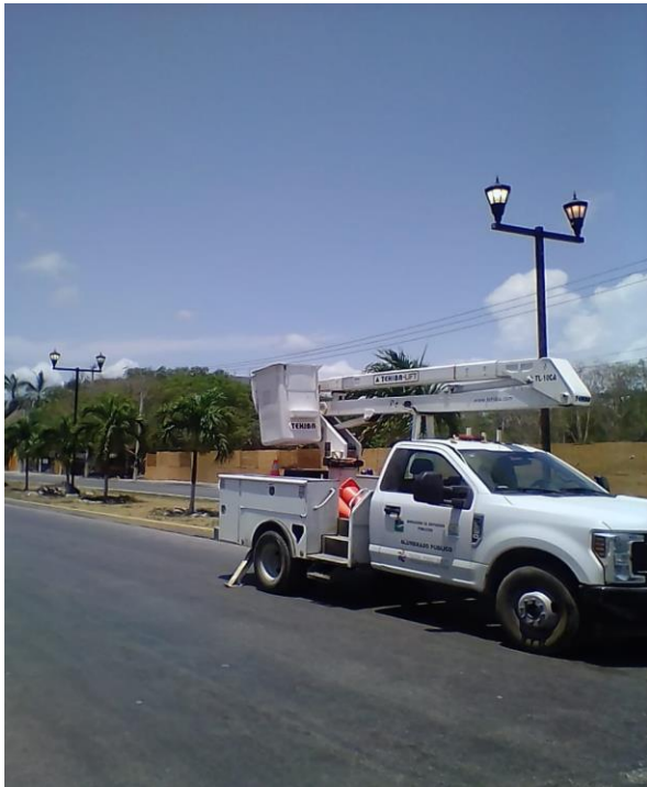
Rehabilitación de luminaria en la Colonia Centro Av. Satélite
