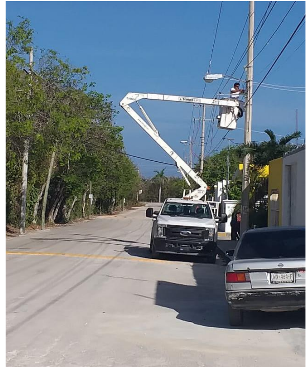
Cambio de líneas que estaban quemadas en la Comunidad de Chan Chemuyil
