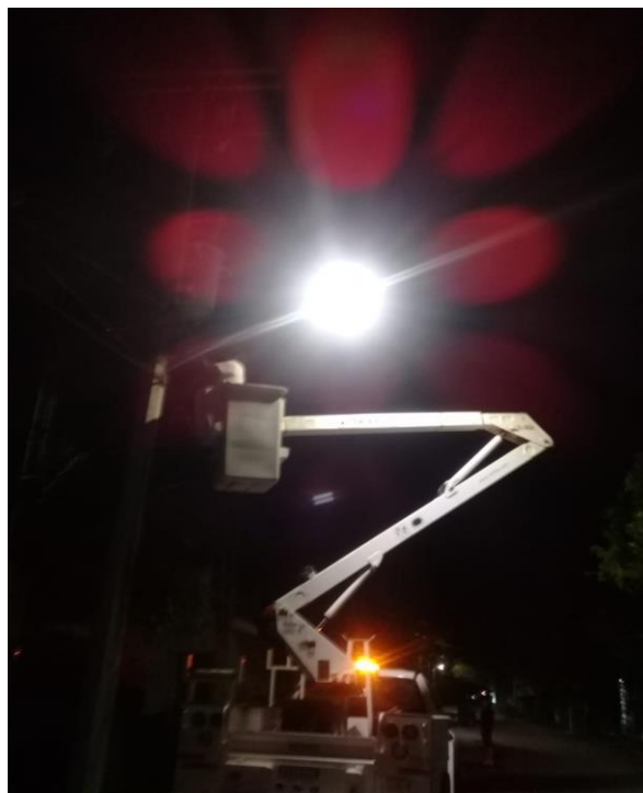
Rehabilitación de luminaria en la Col Centro, Calle Mercurio
