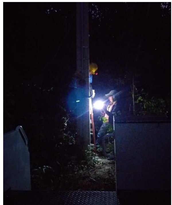
Rehabilitación de sector en la Colonia Heaven
