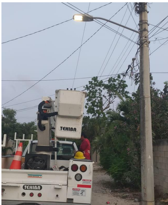
Rehabilitación de luminaria en la Colonia Ejido
