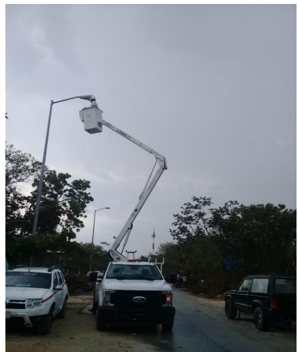
Rehabilitación de luminaria en la Colonia Yaax Tulum
