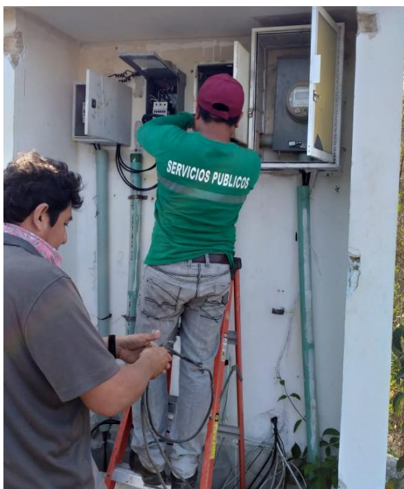
Instalación de contactor en la Comunidad de Coba
