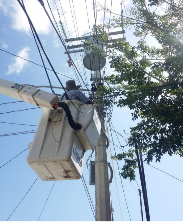
Corrección de líneas del alumbrado público en la Col. Mayapaax
