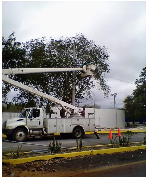
Rehabilitación de luminaria en la Comunidad de Coba
