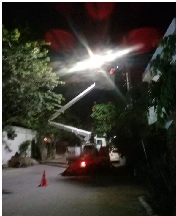
Rehabilitación de luminaria en la Colonia Veleta
