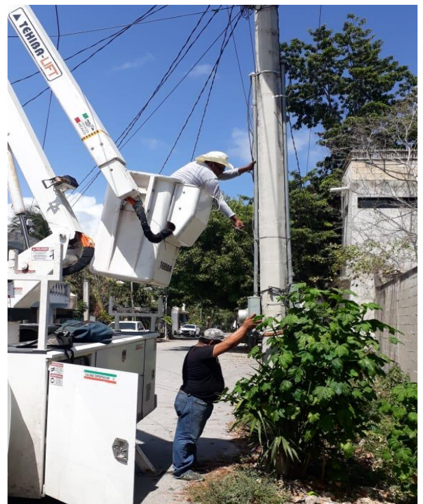
Rehabilitación de sector de alumbrado público en la Colonia Ejido
