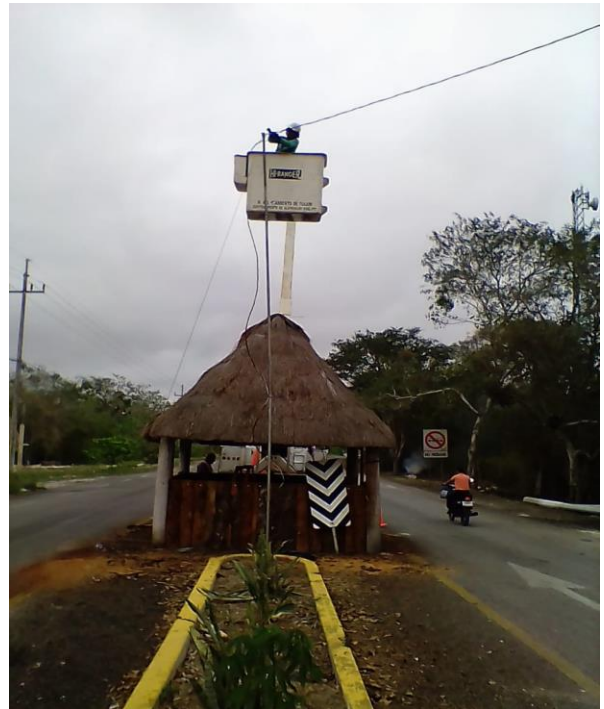
Tensión de líneas de líneas aéreas en la caseta de policía de la Comunidad de Coba
