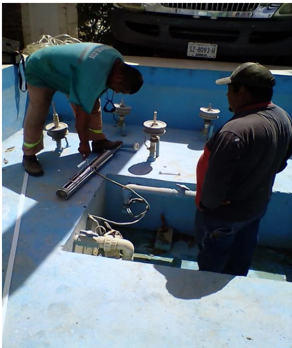
Mantenimiento de la fuente del parque Museo Maya ubicado en la Colonia Centro
