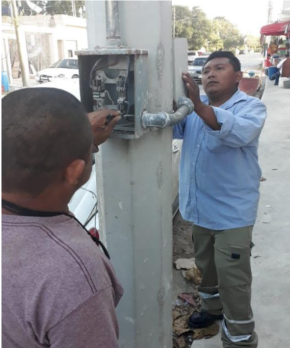
Instalación de centros de carga en la Cancha Maya
