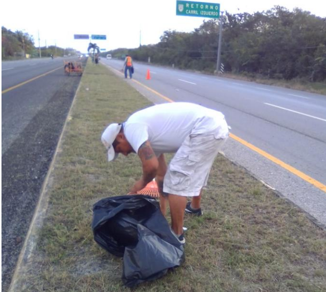
Poda de césped realizadas en camellón central de la carretera federal
