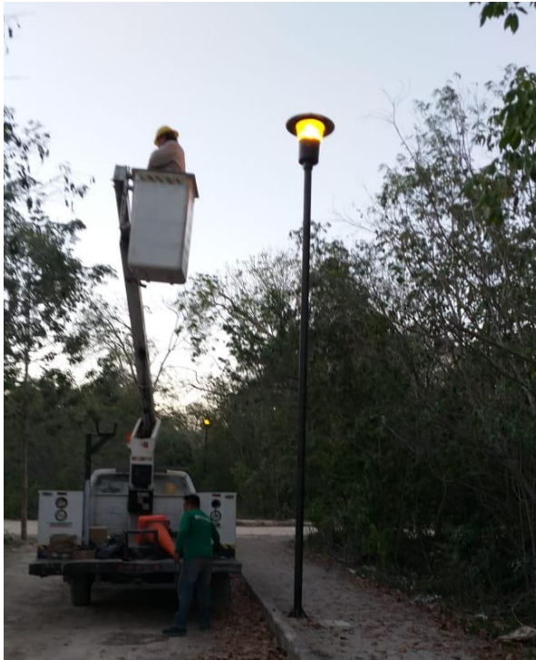
Rehabilitación de luminaria en la Colonia Holística
