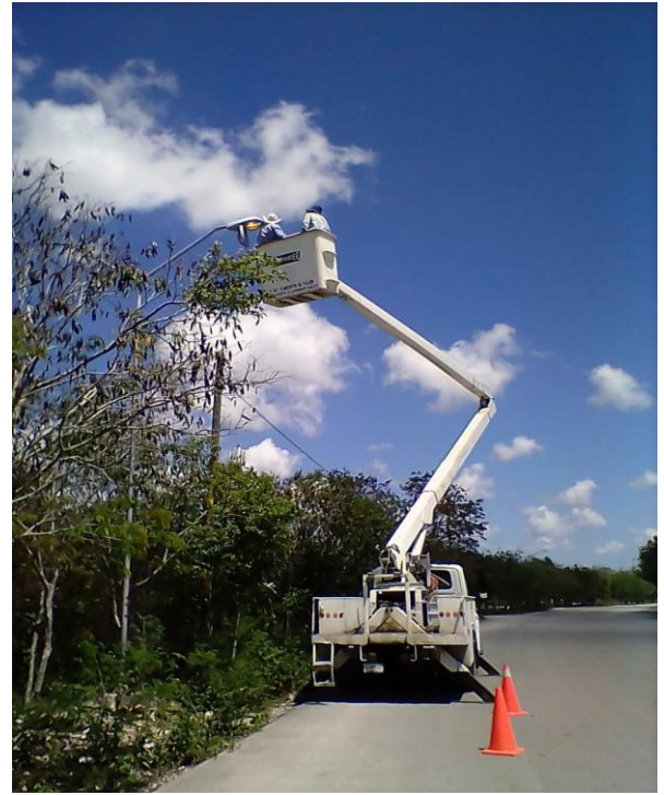
Rehabilitación de luminaria en la Tumben Ka
