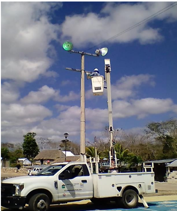
Rehabilitación de luminaria en la Comunidad de San Silverio
