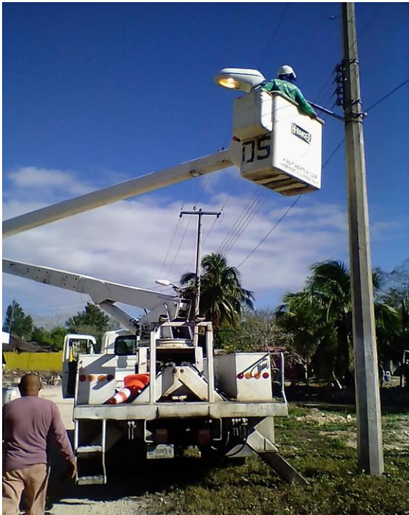
Rehabilitación de luminaria en la Comunidad de Chan Chen 1
