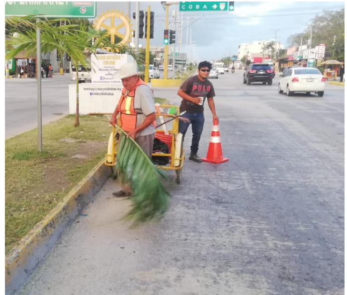
Poda de césped y limpieza realizada en la avenida Tulum entre avenida coba y avenida satélite.
