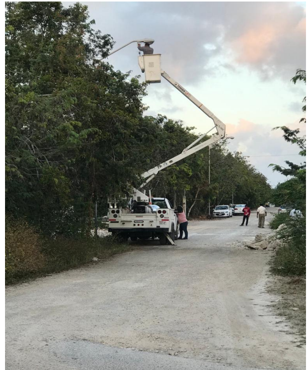
Rehabilitación de luminaria en la C. Kolop / C. Luuch y Av. Yondzonot, Col. Tumben Ka
