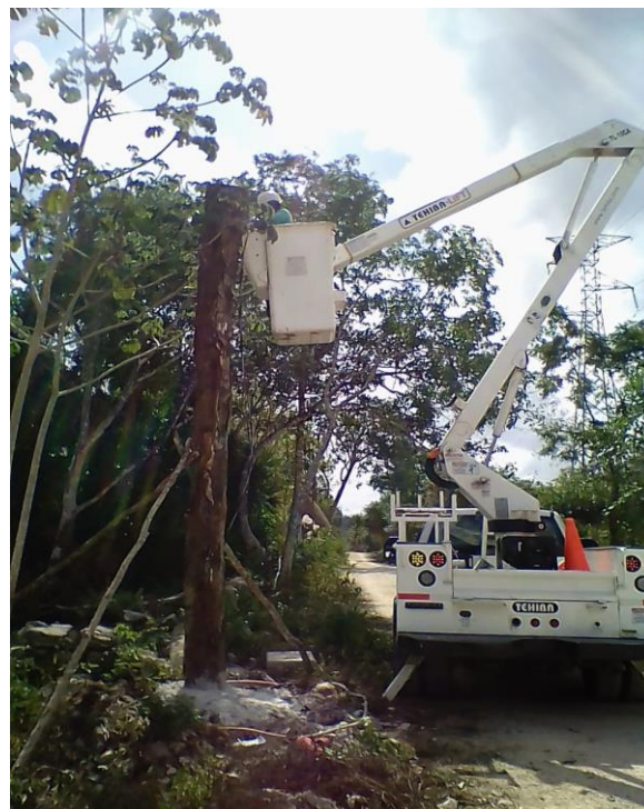
Ampliación de red en la Comunidad de Macario Gómez
