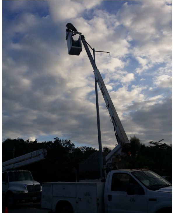
Rehabilitación de luminaria en la Col. Holística
