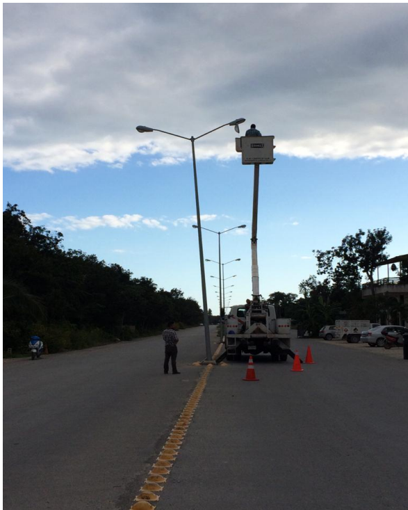
Rehabilitación de luminaria en la 5Av. Sur
