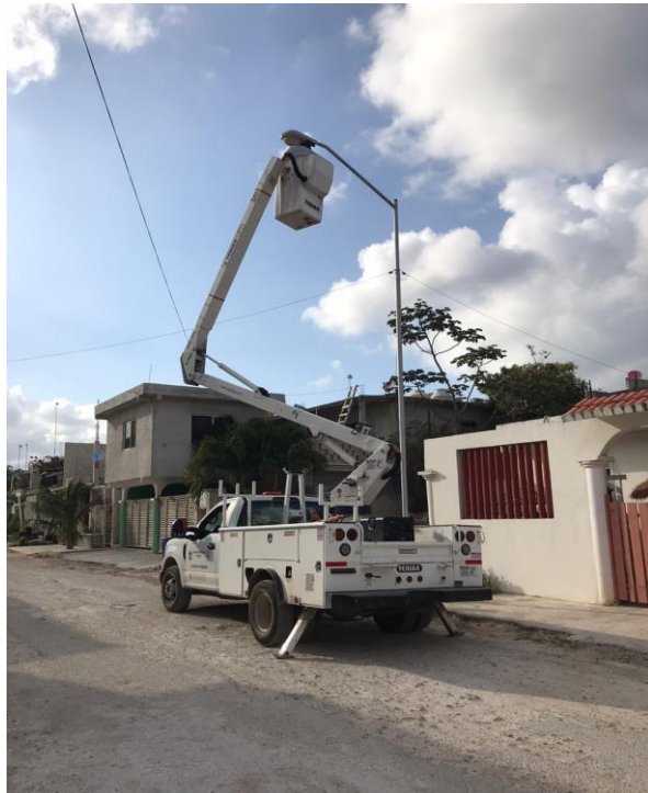
Rehabilitación de luminaria en la C. Kaan / C. Nabal y C. Luuch, Col. Tumben Ka
