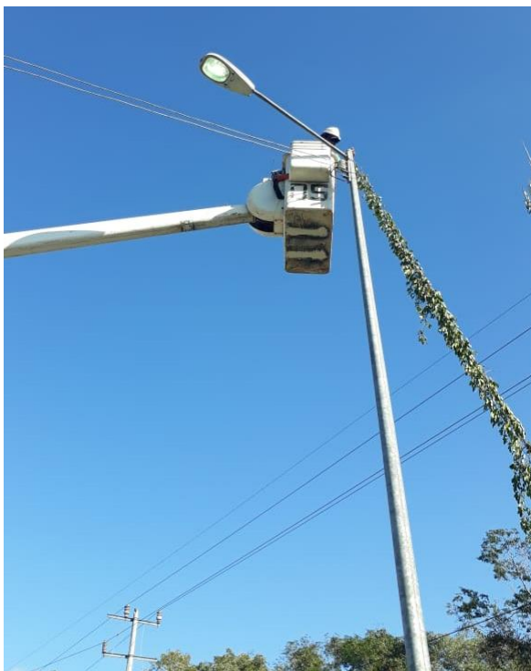
Tensionado de líneas en la Comunidad de Manuel Antonio Ay
