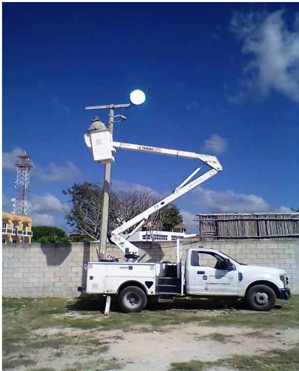
Rehabilitación de luminaria en la Expo feria
