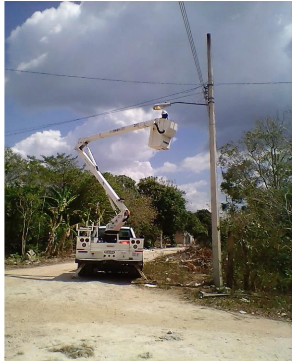
Rehabilitación de luminarias en la Comunidad de San Juan de Dios
