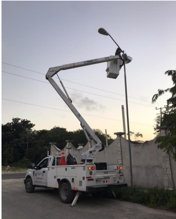
Rehabilitación de luminaria en el DIF
