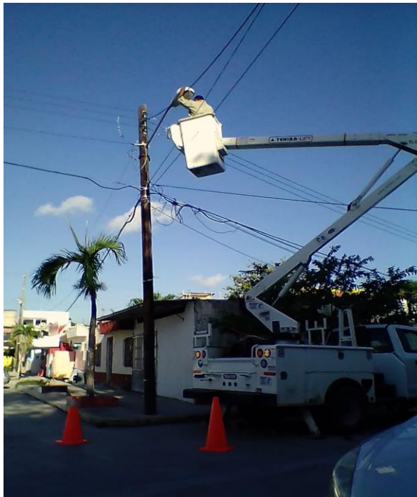
Rehabilitación de luminarias en la comunidad de Chemuyil
