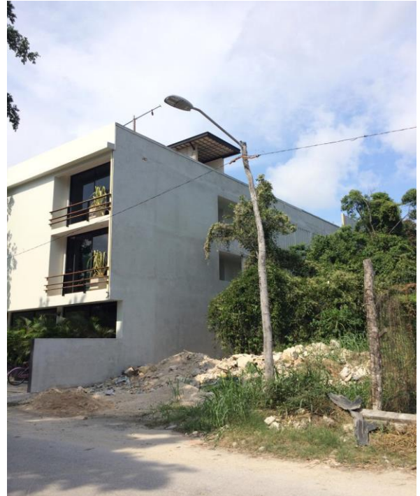
Cambio de luminaria Led en la Colonia Centro
