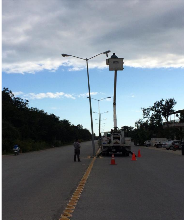
Rehabilitación de luminarias en la Av 5Sur col. Veleta
