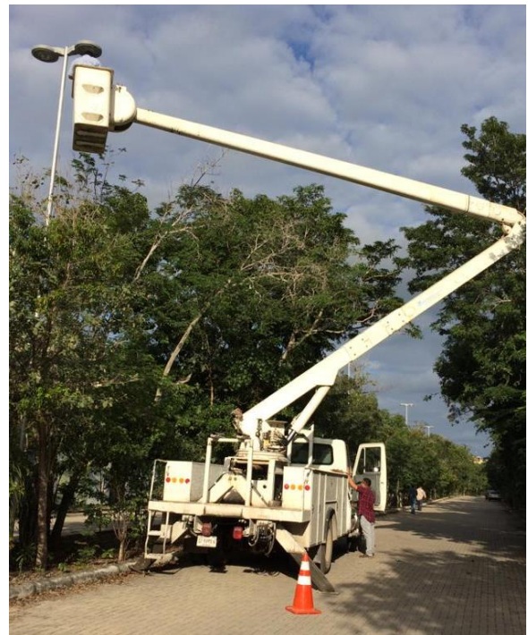
Rehabilitación de luminaria en el Fraccionamiento Aldea Zama
