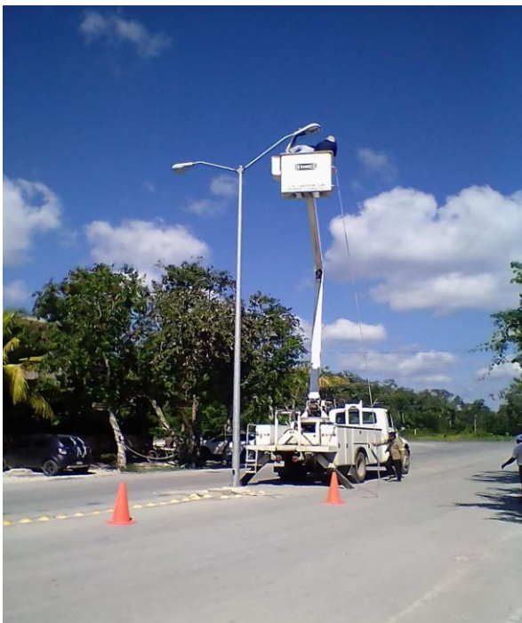
Rehabilitación de luminaria en la Colonia Veleta
