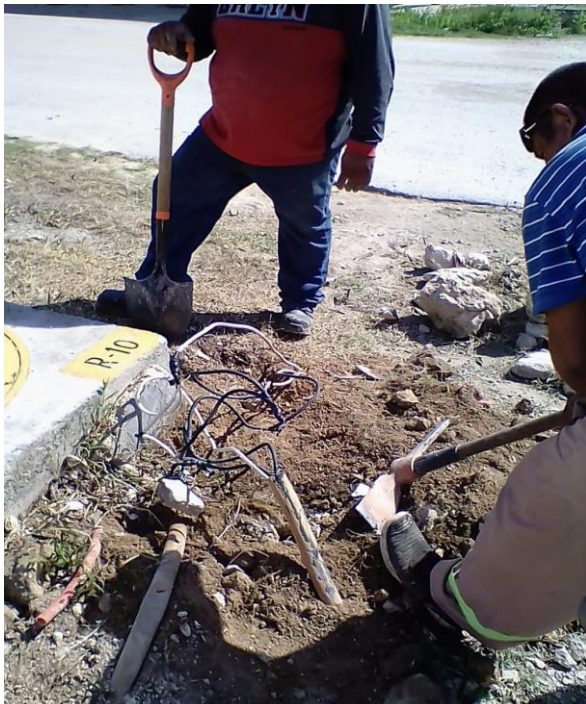
Reparación de corto circuito en la Col. Xulka
