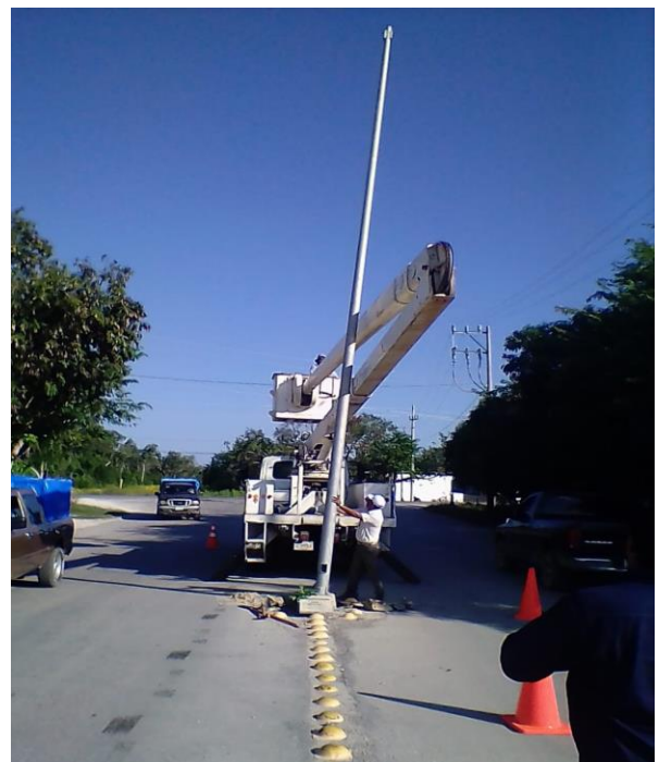
Rehabilitación de poste en la Colonia Veleta
