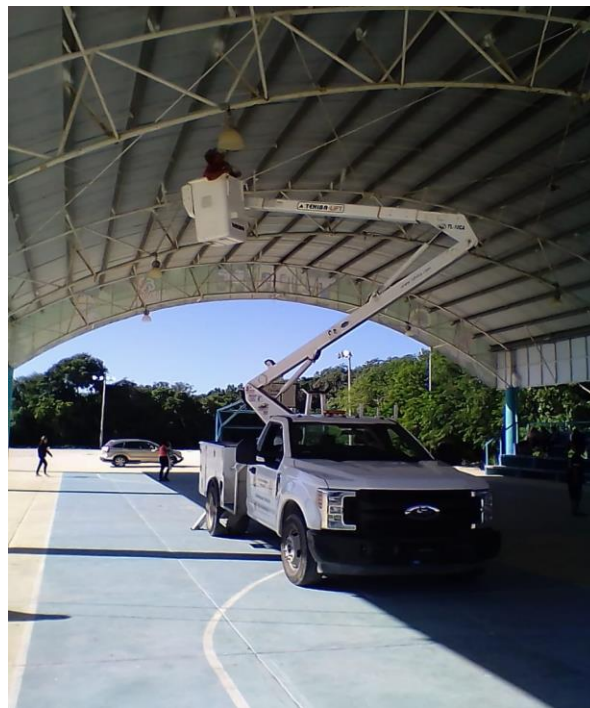
Rehabilitación de luminarias en el domo de la comunidad de Akumal
