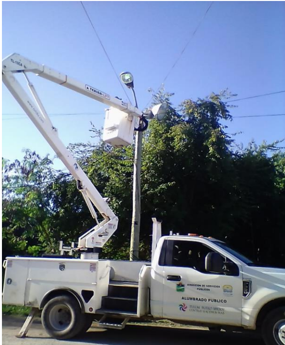
Rehabilitación de luminarias en la comunidad de Akumal
