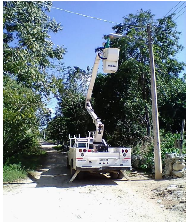
Rehabilitación de luminarias en la comunidad de Chanchen 1
