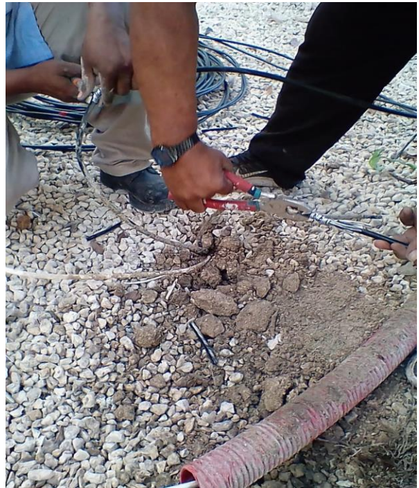
Reparación de Corto circuito en la ciclovia de la Colonia Lakiin
