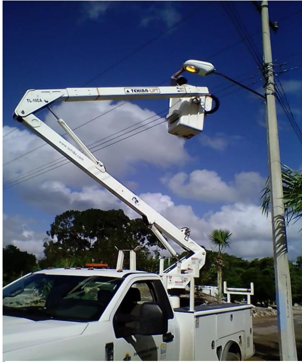
Rehabilitación de luminarias en la comunidad de Yalchen
