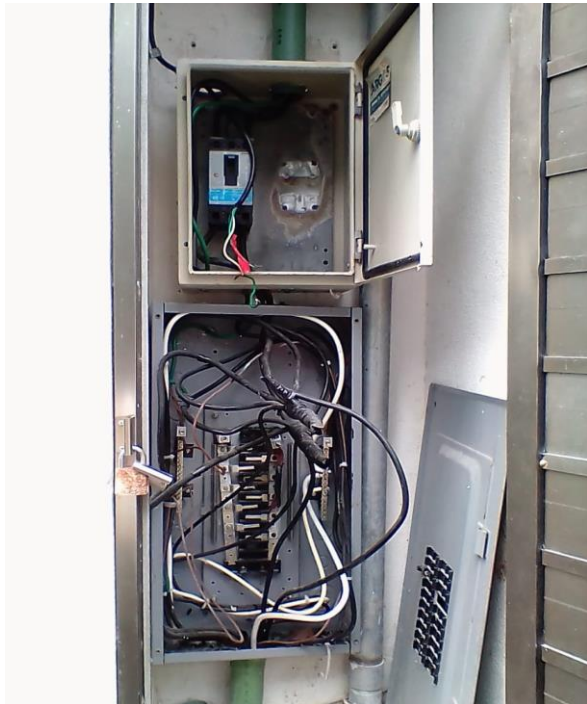
Rehabilitación de contactor en el fraccionamiento Aldea Zama
