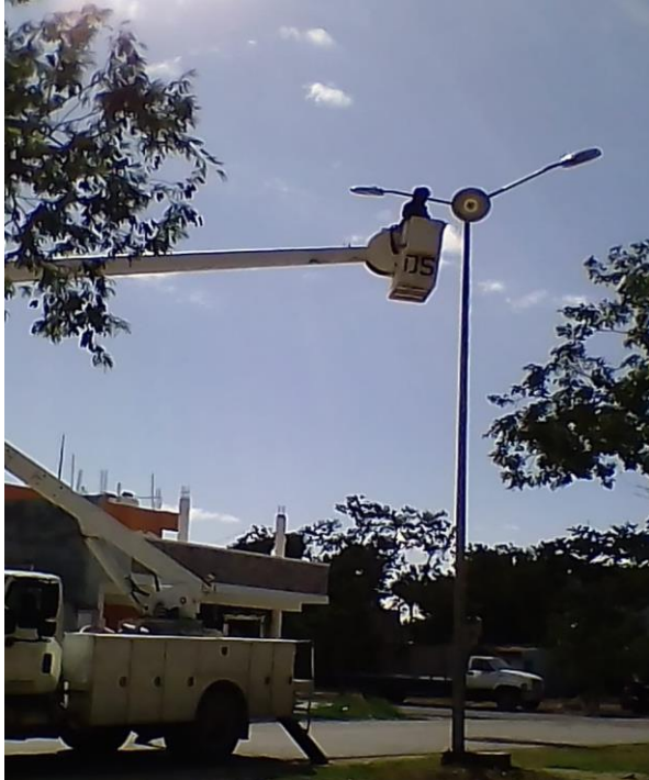
Cambio de luminaria Led en la Colonia Xulka
