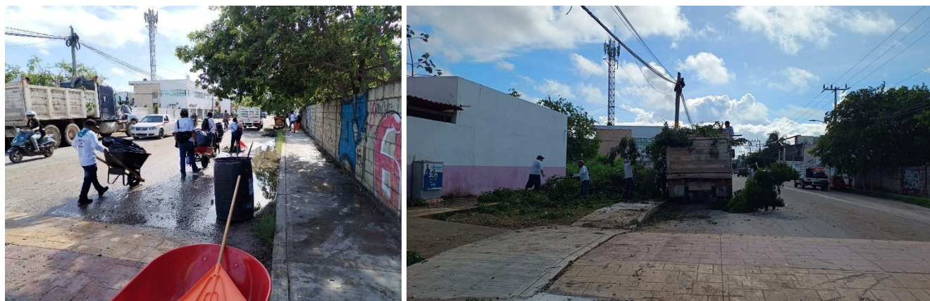
Figura 5.21. Reconstrucción de calles, postes y daños menores posterior al ingreso del huracán Beryl en Tulum, 5 de julio de 2024.
