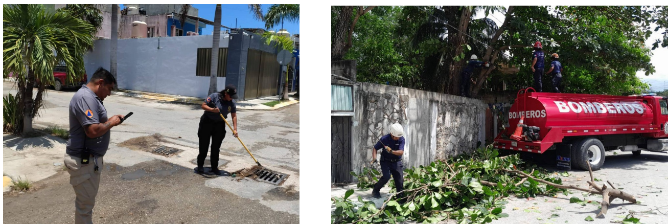
Figura 5.12. Podas programadas por parte de Protección Civil, Bomberos y CFE.
