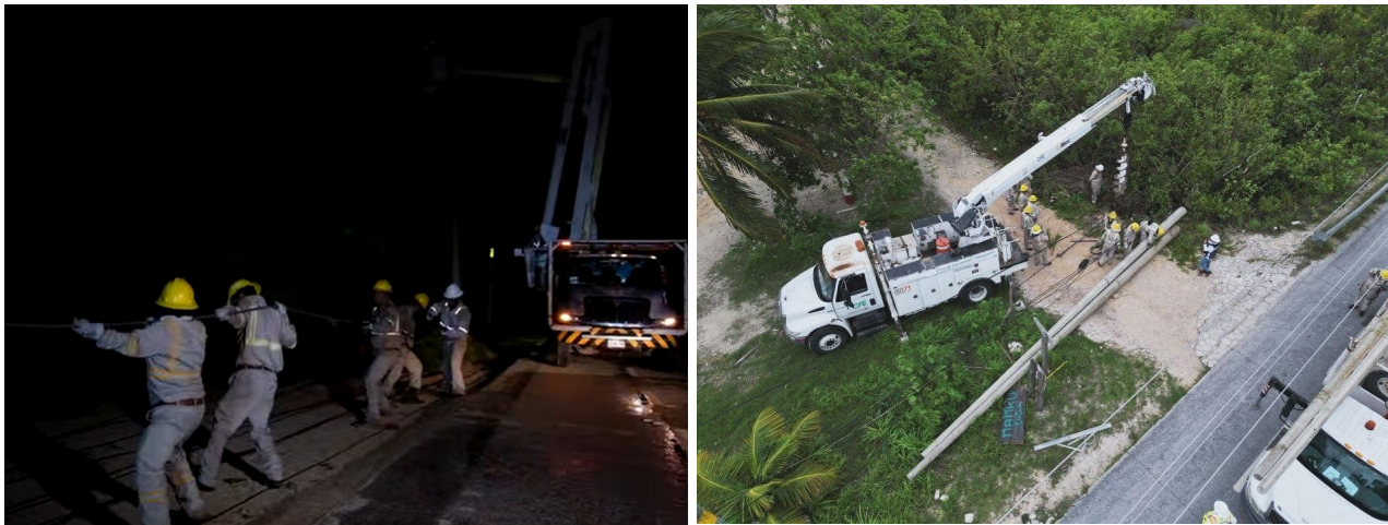
Figura 5.19. Rehabilitación de los servicios de luz posterior al ingreso del huracán Beryl en Tulum, 5 de julio de 2024.
