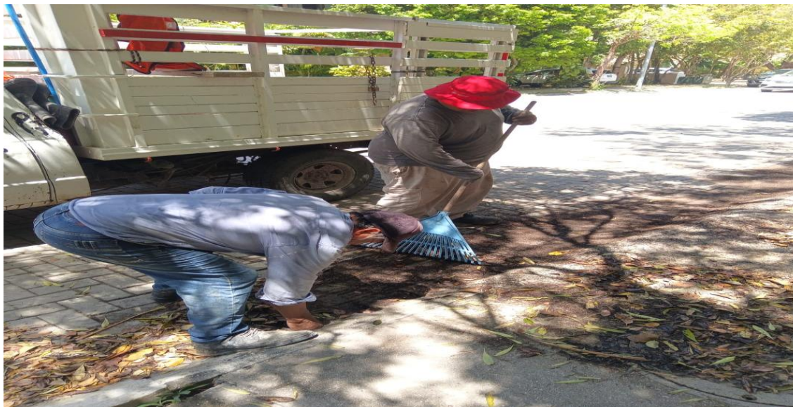
Limpeza de rejillas. Calle kabah entre calle Iximché; fraccionamiento aldea zama.
