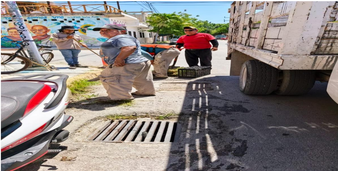
Limpieza de rejillas. Calle venus oriente entre calle osiris sur; colonia centro.
