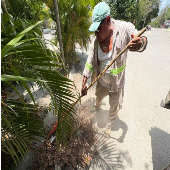
Limpieza de rejillas. Av. juanek entre calle cabah; fraccionamiento aldea zama.
