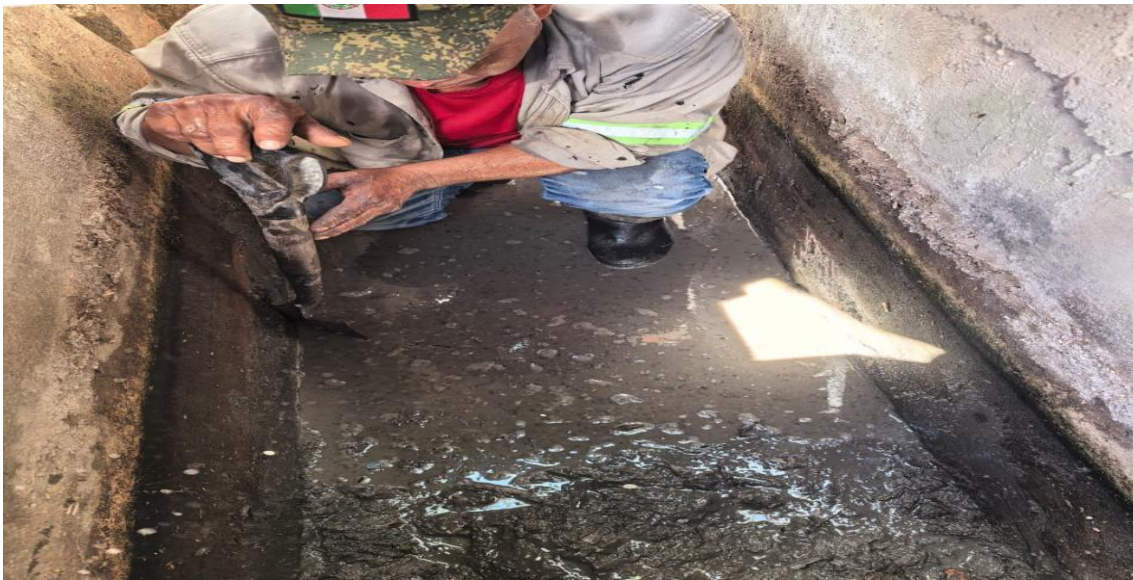
Limpieza de pozos. Calle beta norte entre calle 2 poniente y calle 4 oriente; colonia centro.
