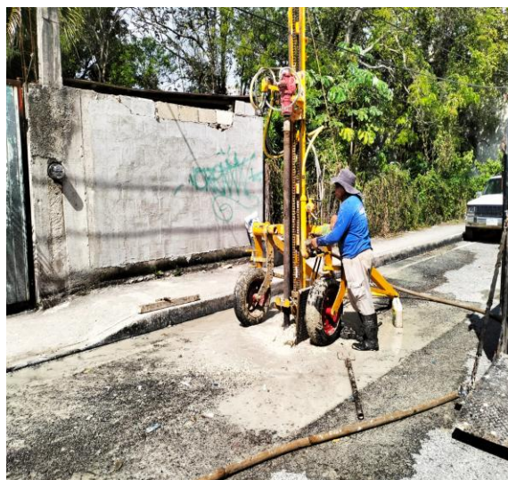
Desazolve. Calle faisán entre calle chun yaxché y av. la selva; colonia ejido norte. (Pozo 01).
