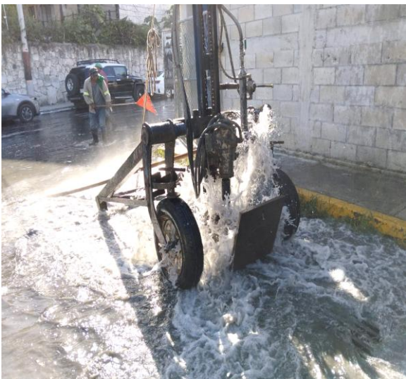
Desazolve. Calle plutón poniente entre calle alfa sur; colonia maya.
