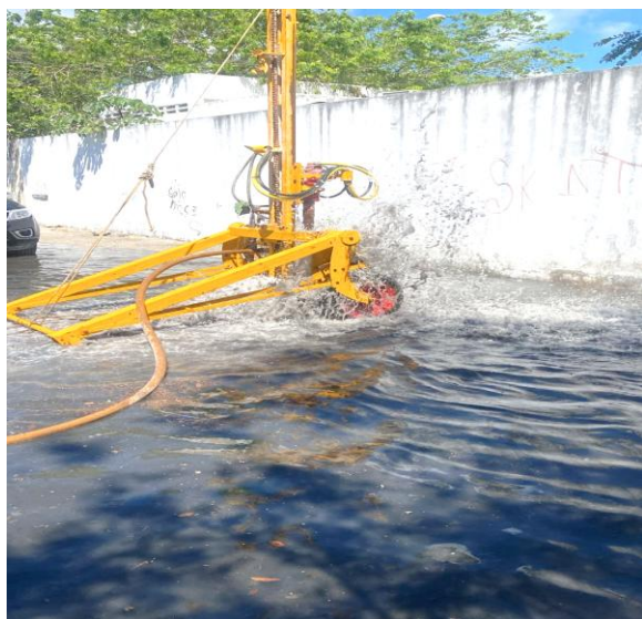
Desazolve. Calle palma abanico entre boulevard palmas Tulum; fraccionamiento las palmas.
