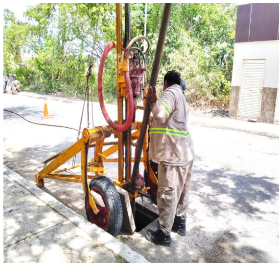
Desazolve. Calle faisán entre av. la selva y calle 26; colonia tumben kaa. (Pozo 02).
