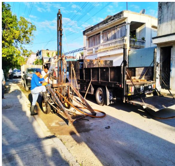
Desazolve. Calle privada alfa entre calle alfa sur; colonia maya.
