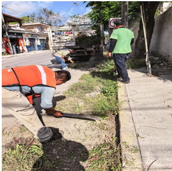
Limpeza de rejillas. Calle júpiter sur entre calle luna poniente; colonia maya.
