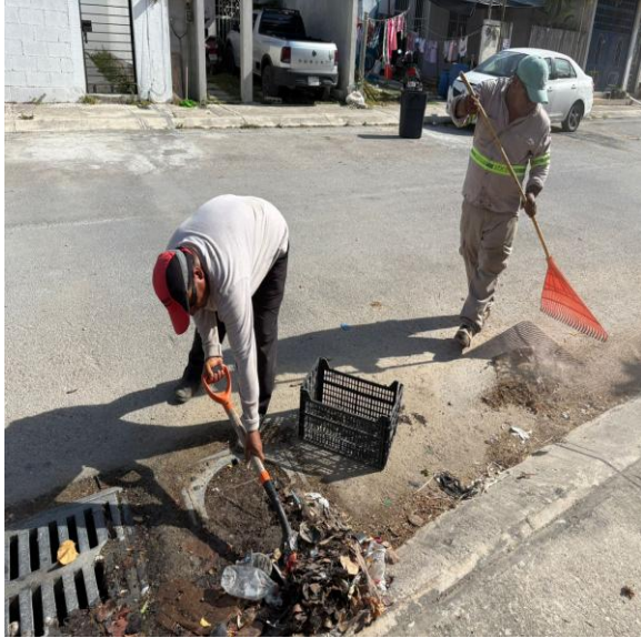
Limpieza de rejillas. Calle palma chat entre calle palma guinea; fraccionamiento las palmas.
