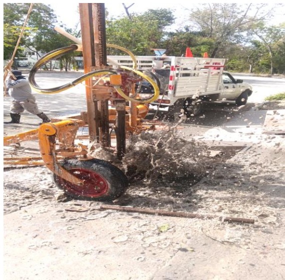
Desazolve. Av. central entre av. del parque y av. Itzamná; fraccionamiento aldea zama. (Pozo 02).
