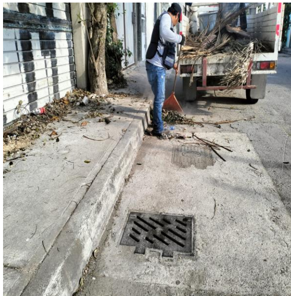
Limpieza de rejillas. Calle le'xiu entre calle ori3n norte y av. ook- k'ot; colonia mayapax.
