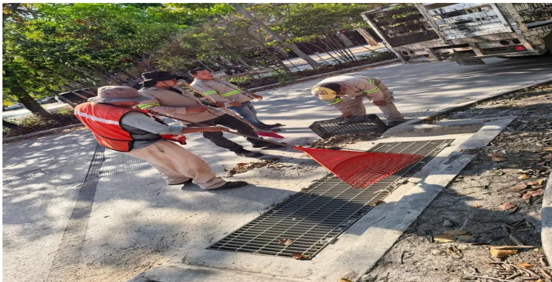
Limpieza de rejillas. Av. central; fraccionamiento aldea zama.
