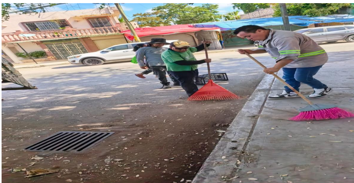
Limpeza de rejillas. Calle omega sur entre calle sol poniente; colonia maya.
