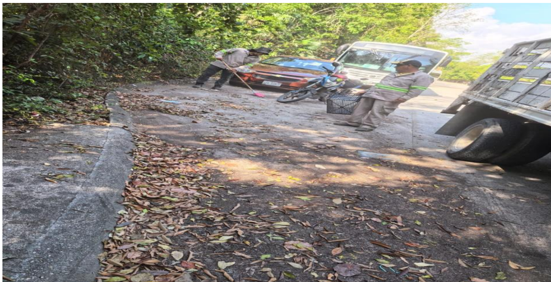
Limpeza de rejillas. Calle dzancab entre av. aldea zama; fraccionamiento aldea zama.
