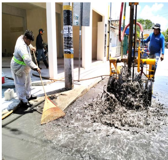
Desazolve. Calle tun-k'ul entre calle alfa norte y calle osiris norte; colonia mayapax.
