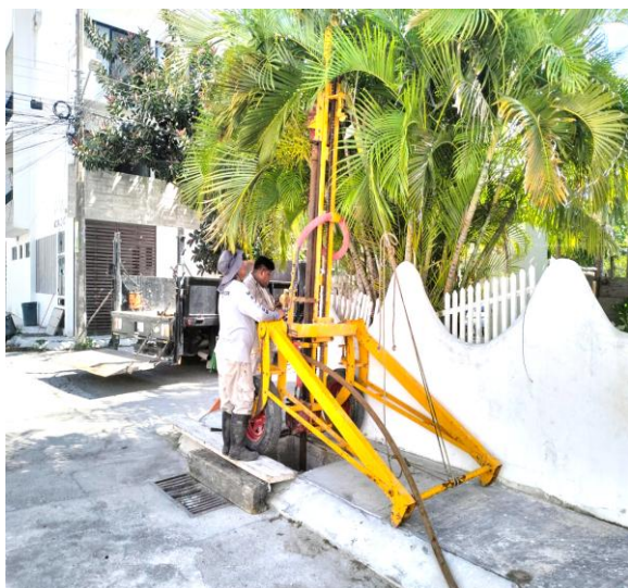
Desazolve. Calle 5 sur entre calle 2 oriente y calle 2 bis a oriente; fraccionamiento villas Tulum.
