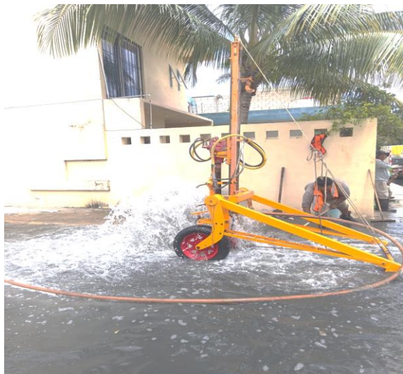
Desazolve. Calle palma guinea entre calle palma rapis y calle palma yagua; fraccionamiento las palmas.
