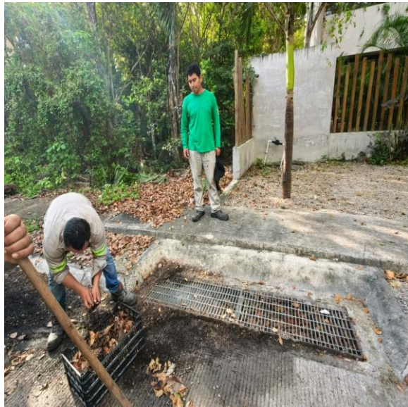
Limpeza de rejillas. Calle sayil entre calle balam dzancab; fraccionamiento aldea zama.
