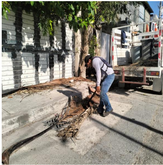
Limpeza de rejillas. Calle géminis norte entre calle sagitario oriente; colonia centro.
