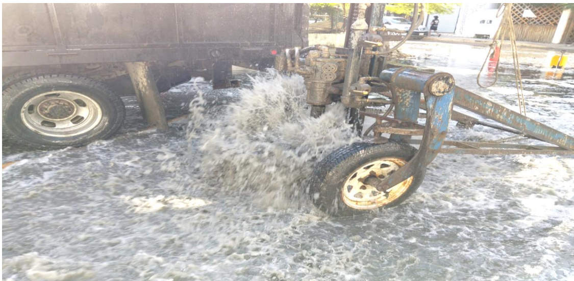
Desazolve. Calle júpiter poniente entre calle luna poniente; colonia maya.
