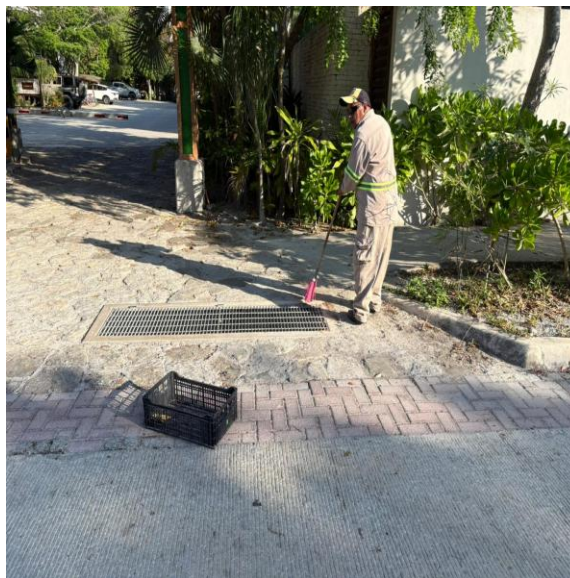
Limpeza de rejillas. Av. cobá entre av. aldea zama; fraccionamiento aldea zama.
