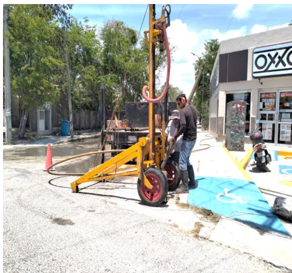
Desazolve. Calle faisán entre av. la selva y calle 26; colonia tumben kaa. (Pozo 01).
