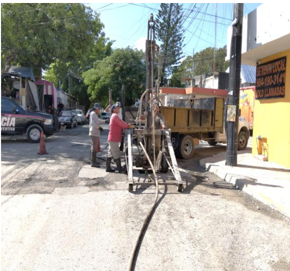
Desazolve. Calle júpiter sur entre calle sol poniente y calle neptuno poniente; colonia maya.
