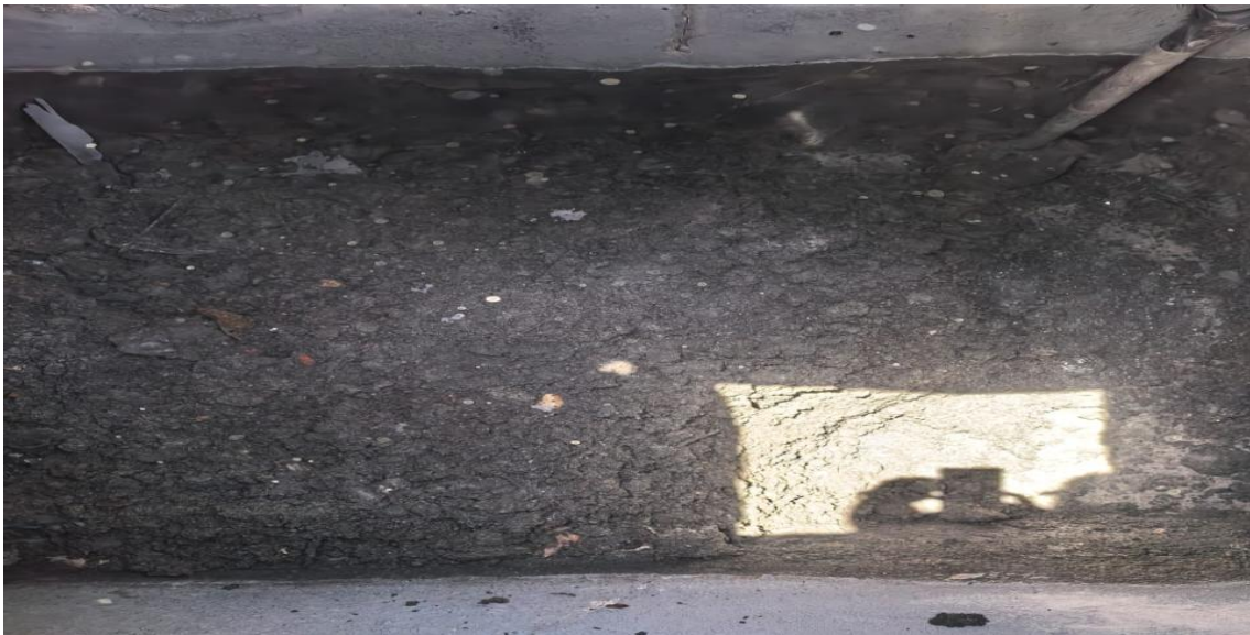
Limpieza de pozos. Calle chac mool entre av. kukulkán y calle boca paila; colonia ejido.
