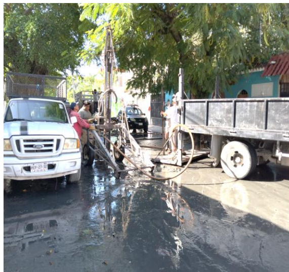
Desazolve. Calle júpiter sur entre calle sol poniente; colonia centro.
