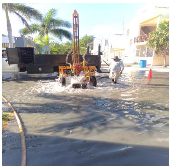
Desazolve. Calle 2 oriente entre calle escorpión norte y andador Tepich; fraccionamiento guerra de castas.
