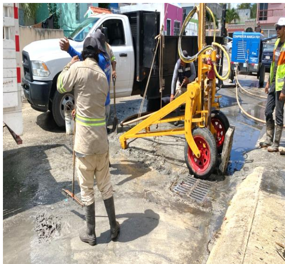
Desazolve. Calle palma botella entre boulevard palmas Tulum y calle palma guinea; fraccionamiento las palmas.
