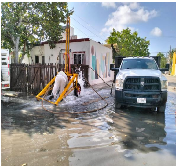
Desazolve. Calle 5 sur entre calle 2 oriente y calle 2 bis oriente; fraccionamiento villas Tulum. (Pozo 01).
