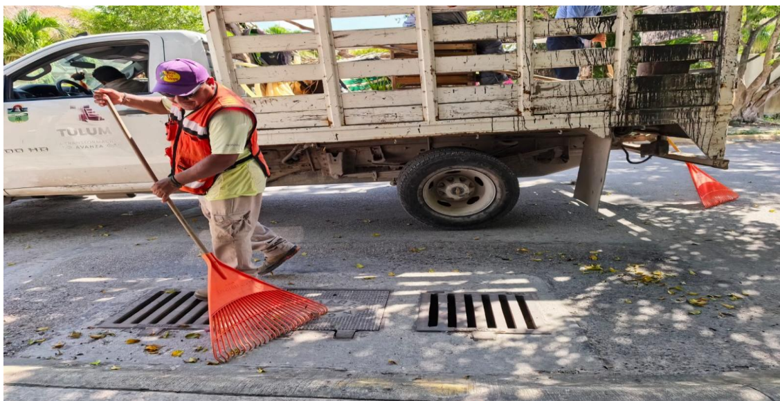
Limpieza de rejillas. Calle 4 oriente; fraccionamiento guerra de castas.
