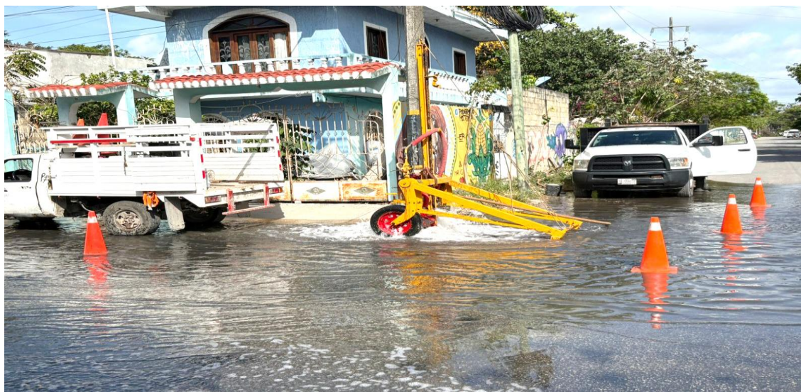
Desazolve. Av. kukulkán entre calle chac mool y calle cocodrilo; colonia ejido norte.
