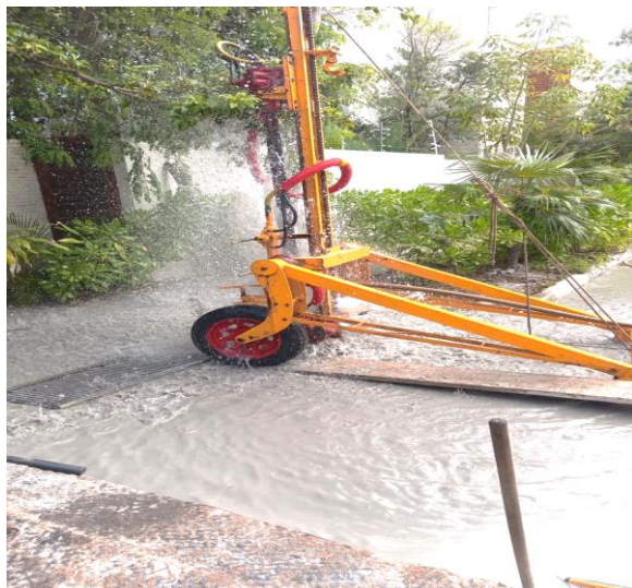
Desazolve. Av. aldea zama entre glorieta central y esquina del hotel yaxiik villas Tulum; fraccionamiento aldea zama.
