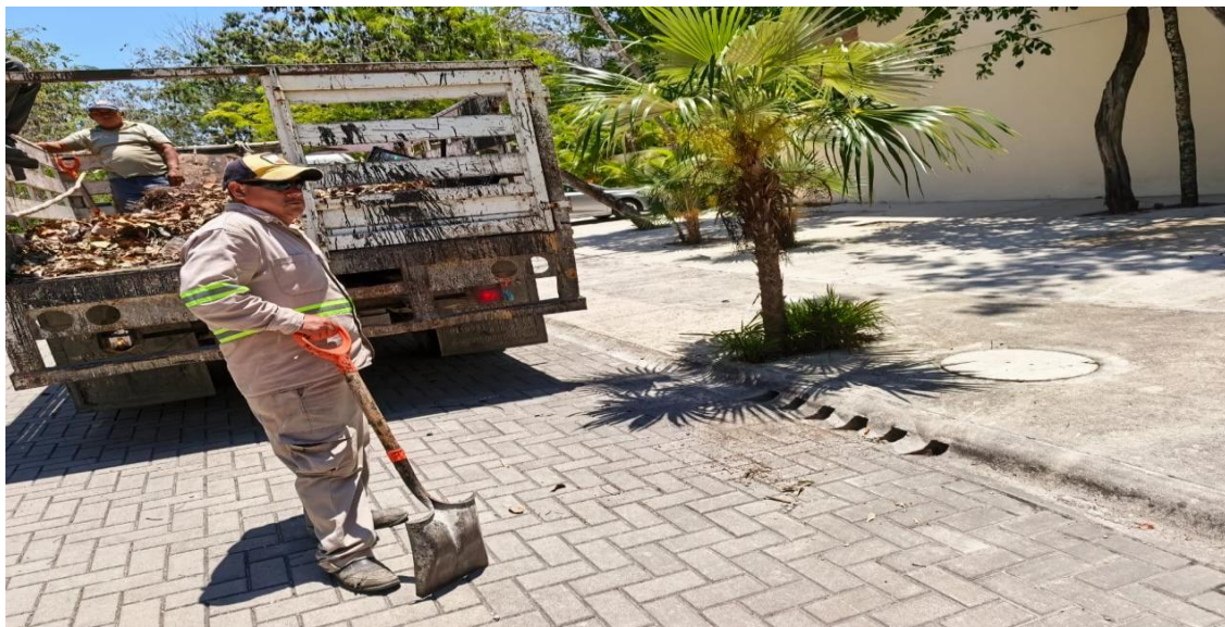
Limpieza de rejillas. Av. balam dzancab, fraccionamiento aldea zama.
