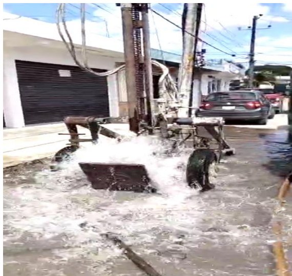
Desazolve. Calle júpiter sur entre av. Tulum y calle sol poniente; colonia maya.
