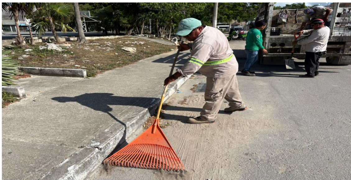
Limpieza de rejillas. Calle palma Tulum entre calle palma astil; fraccionamiento las palmas.
