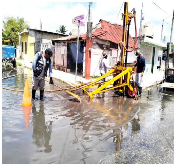
Desazolve. Calle luna norte entre calle polar poniente y calle tauro; colonia luna.
