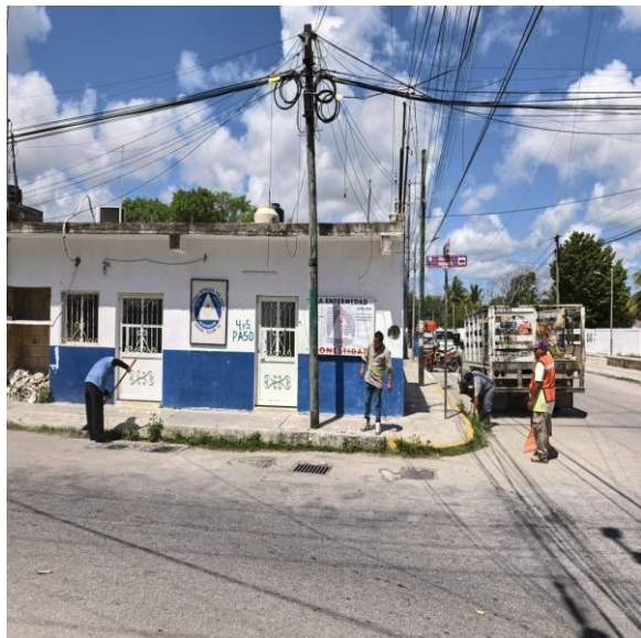
Limpieza de rejillas. Calle alfa norte entre calle 4 oriente; colonia mayapax.
