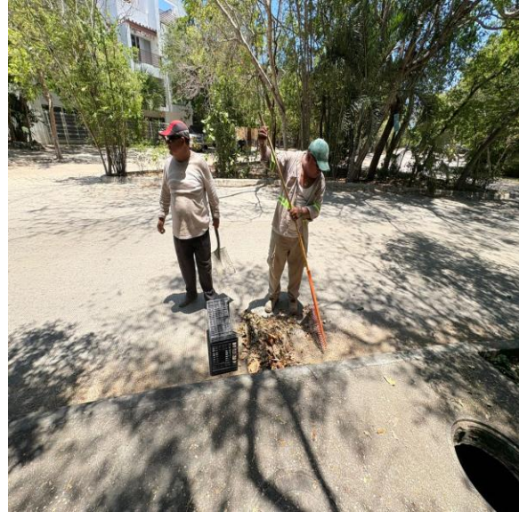
Limpieza de rejillas. Calle labnah entre calle balam dzancab; fraccionamiento aldea zama.
