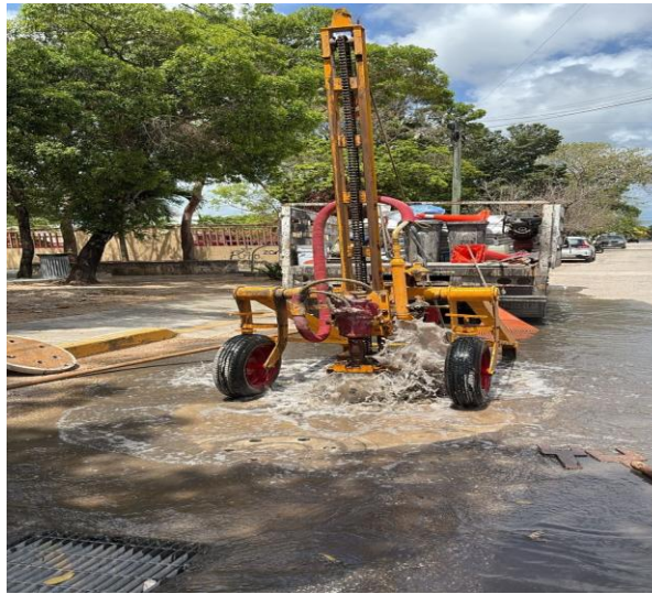
Desazolve. Calle 26 entre calle 23 y calle 25; colonia tumben kaa.
