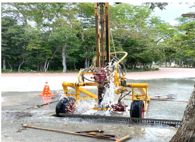
Desazolve. Av. central entre av. del parque y av. Itzamná; fraccionamiento aldea zama. (Pozo 03).
