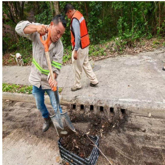
Limpeza de rejillas. Calle balam dzancab entre calle sayil; fraccionamiento aldea zama.
