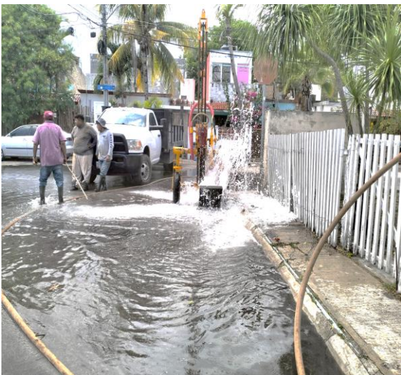
Desazolve. Calle 4 oriente entre calle Chemuyil y calle 17; fraccionamiento villas Tulum.
