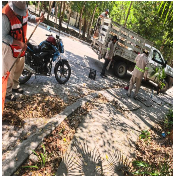
Limpieza de rejillas. Calle labnah entre av. balam dzancab; fraccionamiento aldea zama.
