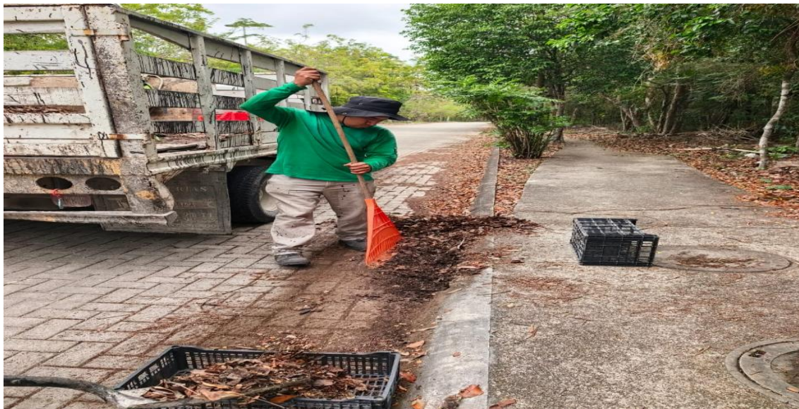
Limpeza de rejillas. Av. coba; fraccionamiento aldea zama.
