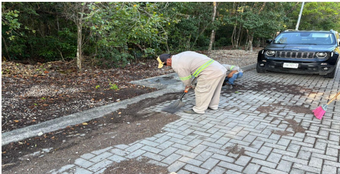
Limpieza de rejillas. Calle nak be entre calle yaxchilan; fraccionamiento aldea zama.
