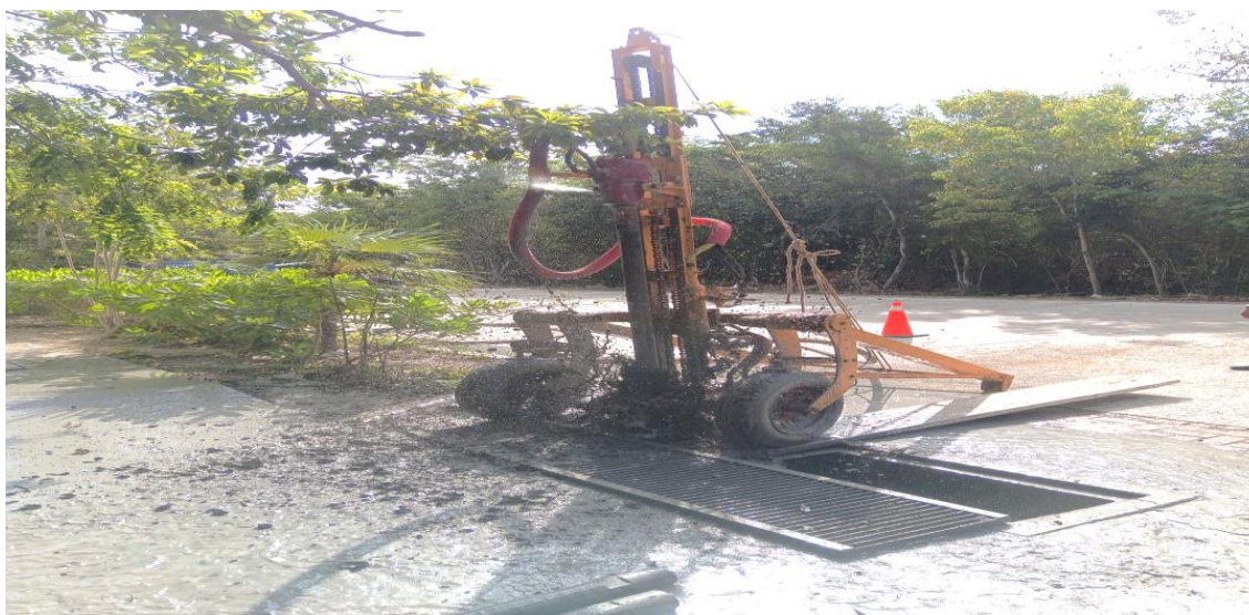
Desazolve. Av. aldea zama (Referencia casa Carmela Tulum y esquina de punto limpio); fraccionamiento aldea zama.
