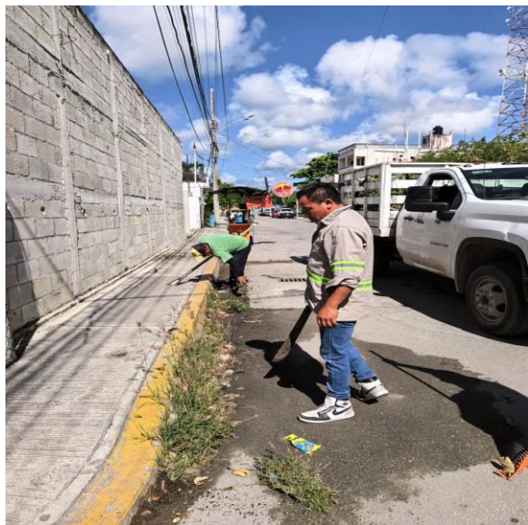
Limpieza de rejillas. Calle plutón poniente entre calle alfa sur; colonia maya.
