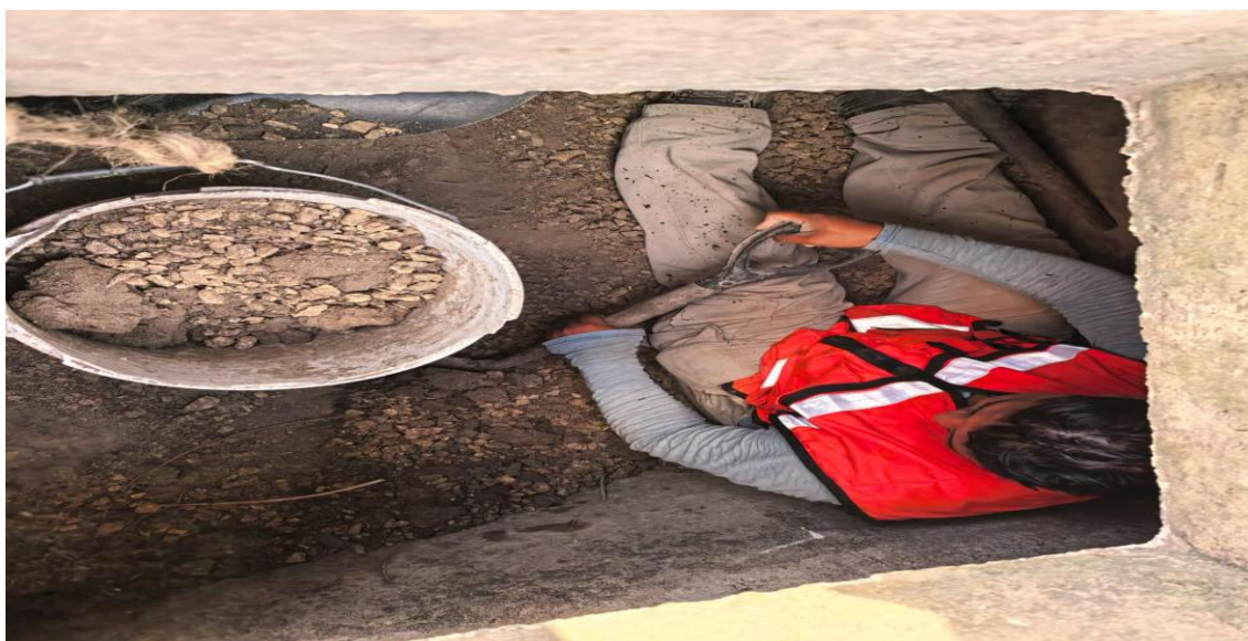
Limpieza de pozos. Calle 19 entre calle 24 y calle 26; colonia tumben kaa. (Pozo 02).
