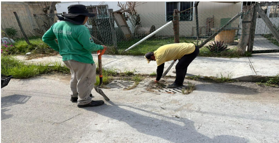
Limpieza de rejillas. Calle huracán Mitch entre calle huracán Rossana; fraccionamiento huracanes.
