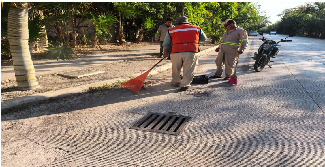
Limpeza de rejillas. Av. aldea zama; fraccionamiento aldea zama.
