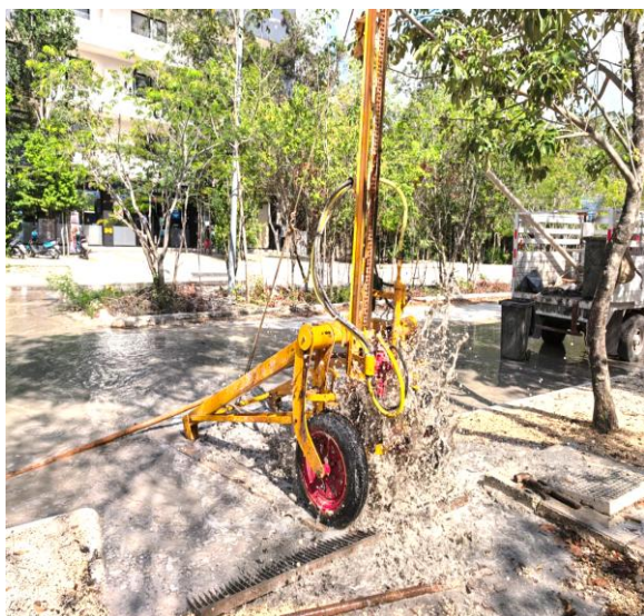
Desazolve. Av. central entre av. del parque y av. Itzamná; fraccionamiento aldea zama. (Pozo 01).
