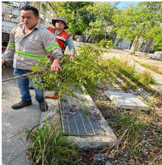
Limpeza de rejillas. Av. central entre av. del parque; fraccionamiento aldea zama.
