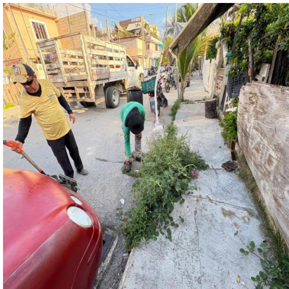
Limpieza de rejillas. Calle huracán Paulina entre calle huracán Rossana; fraccionamiento huracanes.
