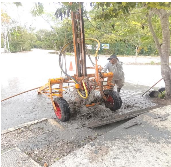
Desazolve. Av. central entre av. del parque y av. Itzamná; fraccionamiento aldea zama. (Pozo 04).
