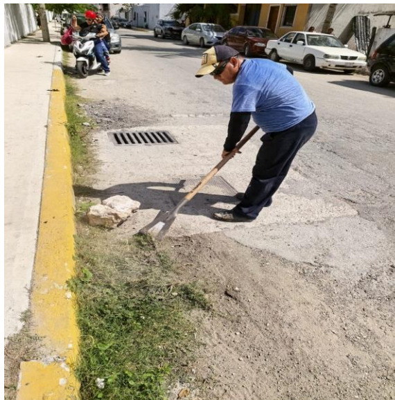
Limpieza de rejillas. Calle beta norte entre calle 4 oriente; colonia mayapax.
