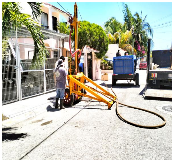
Desazolve. Calle 2 bis oriente entre calle 9 y calle 5 sur; fraccionamiento villas Tulum.
