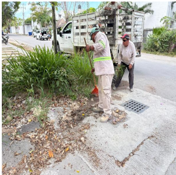
Limpieza de rejillas. Calle chan caa entre calle chichen Itzá; colonia tumben kaa.
