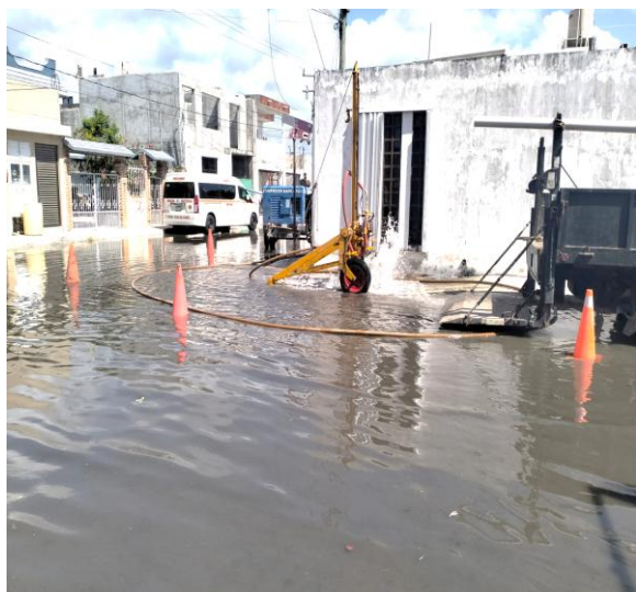
Desazolve. Calle le'xiu entre calle ori3n norte y calle centauro norte; colonia mayapax.
