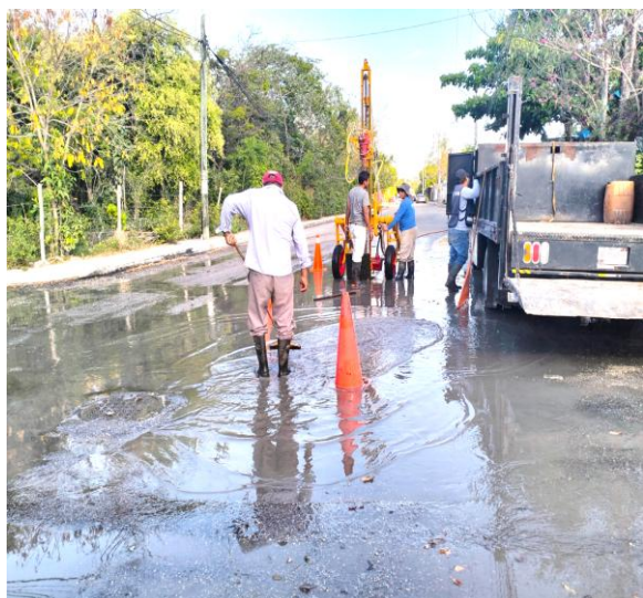
Desazolve. Av. boca paila entre calle faisán y calle chac mool; colonia ejido norte.
