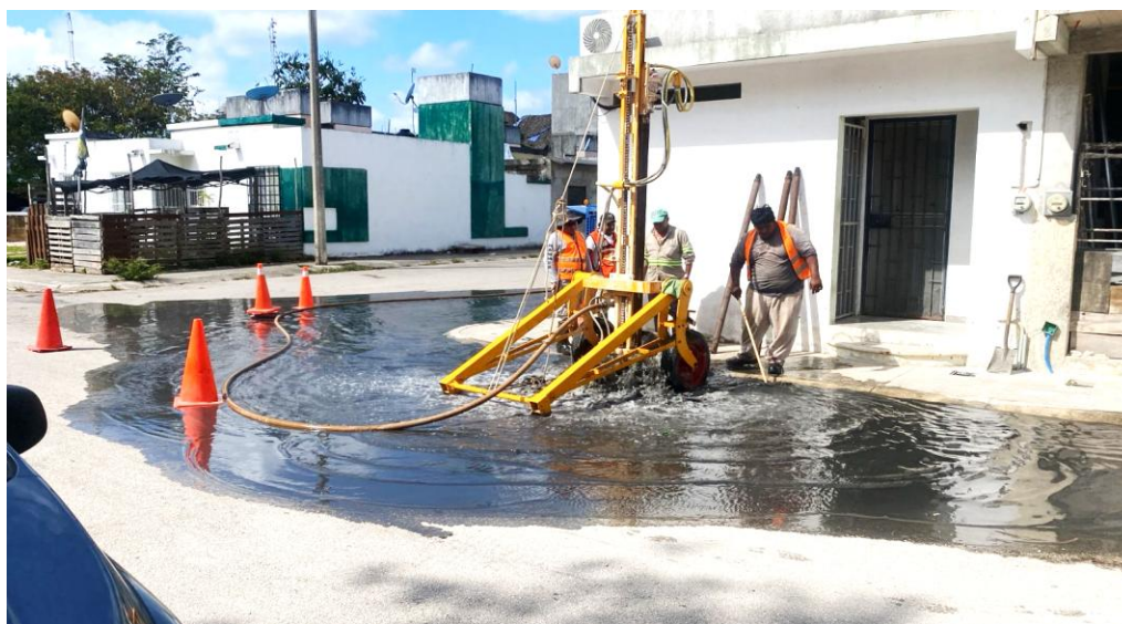
Desazolve. Calle palma rapis entre boulevard palmas Tulum y calle palma guinea; fraccionamiento las palmas. (Pozo 02).
