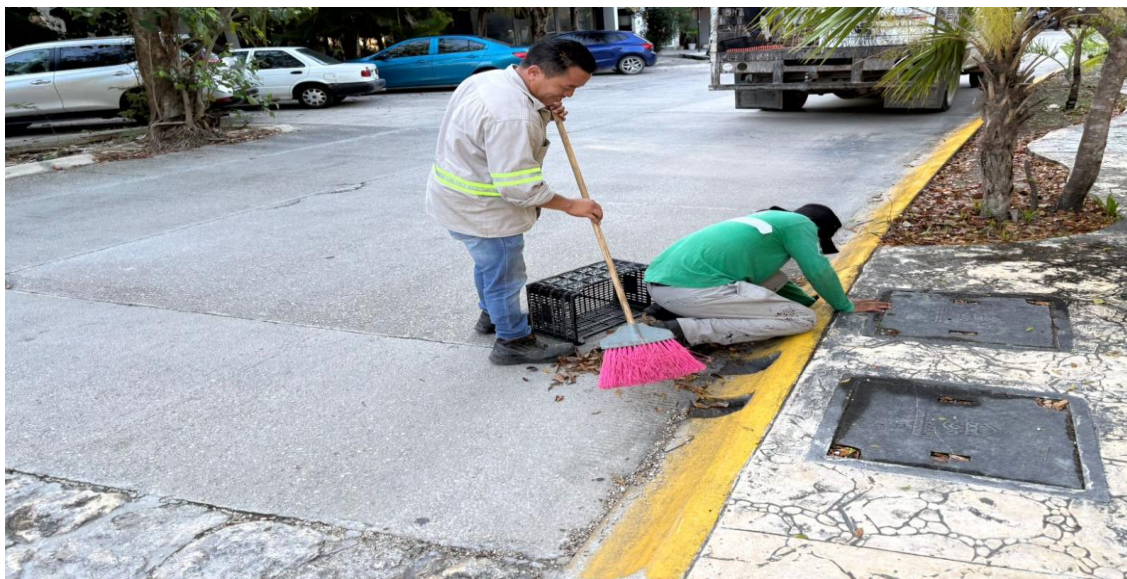
Limpeza de rejillas. Calle Itzamná entre av. aldea zama; fraccionamiento aldea zama.
