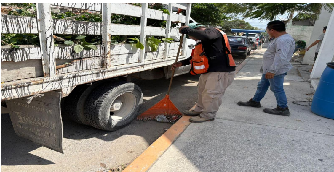
Limpieza de rejillas. Calle golondrinas entre calle chanchen; colonia ejido.
