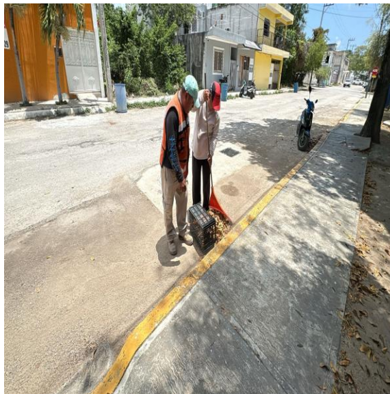
Limpieza de rejillas. Calle 19 entre; colonia tumben kaa.
