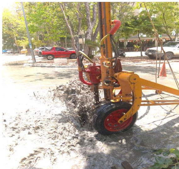
Desazolve. Glorieta central entre av. aldea zama y av. central; fraccionamiento aldea zama.
