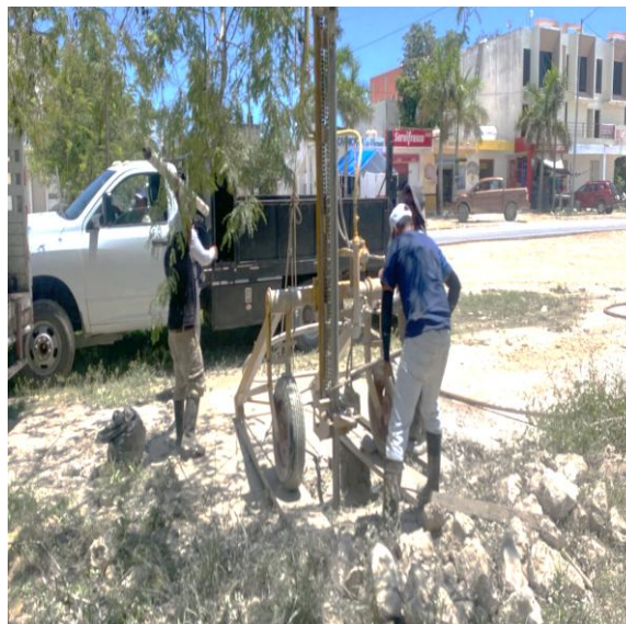
Desazolve. Calle palma reina entre 10 av. norte; fraccionamiento las palmas.
