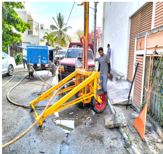
Desazolve. Calle 4 oriente entre calle 15 y calle 13; fraccionamiento villas Tulum. (Pozo 02).
