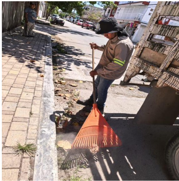
Limpieza de rejillas. Av. satélite sur entre calle sol oriente; colonia centro.
