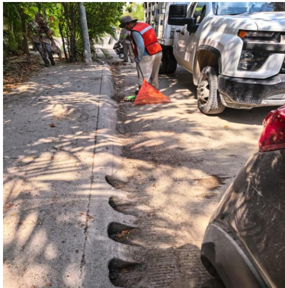
Limpieza de rejillas. Calle Ixchel entre calle kinich na; fraccionamiento aldea zama.
