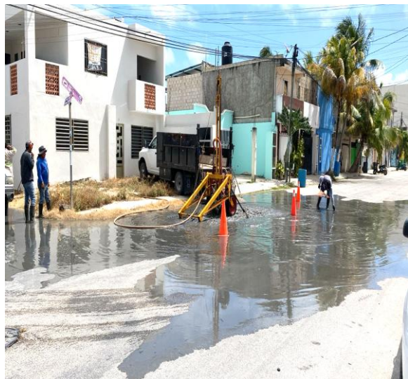
Desazolve. Calle tun-k'ul entre calle omega norte y calle alfa norte; colonia mayapax.
