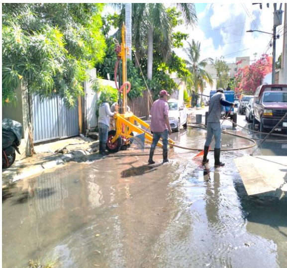
Desazolve. Calle 4 oriente entre calle 15 y calle 13; fraccionamiento villas Tulum. (Pozo 01).
