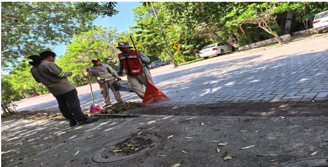
Limpeza de rejillas. Calle c. cda entre calle mayapán; fraccionamiento aldea zama.
