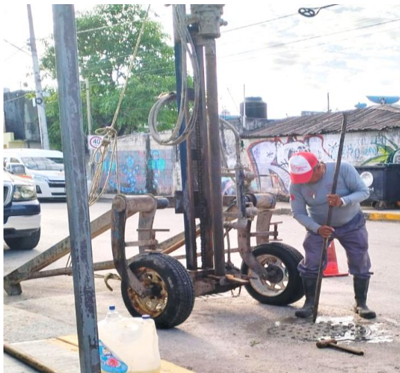
Desazolve. Calle beta sur entre calle mercurio oriente; colonia lak'iin.
