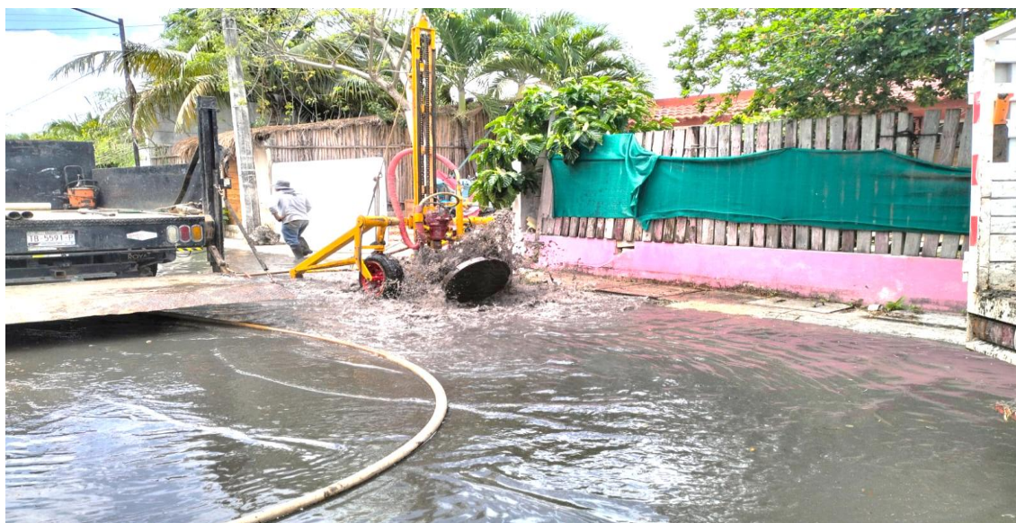
Desazolve. Calle 15 entre calle 4 oriente y calle 2 bis oriente; fraccionamiento villas Tulum.
