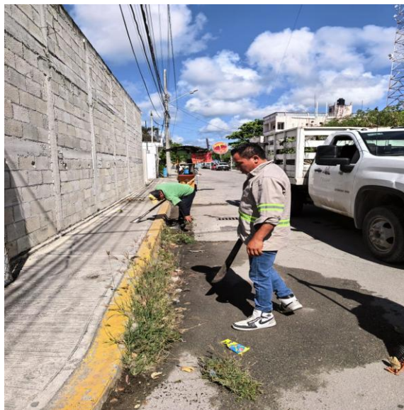
Limpieza de rejillas. Calle palenque entre calle 7 sur; colonia la veleta.
