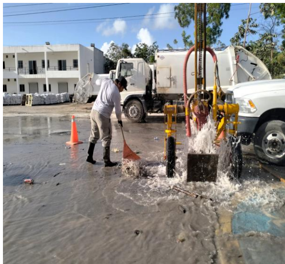
Desazolve. Calle faisán entre calle nabal y av. 18; colonia tumben kaa. (Pozo 01).
