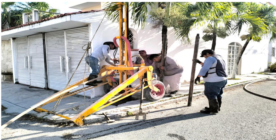
Desazolve. Calle 2 oriente entre calle 9 y calle 11; fraccionamiento villas Tulum.
