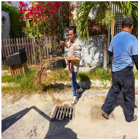
Limpieza de rejillas. Calle 2 poniente; fraccionamiento guerra de castas.
