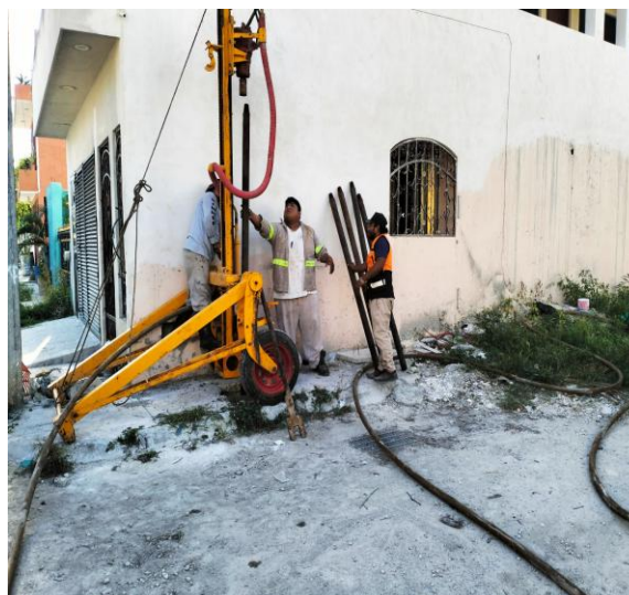
Desazolve. Calle 2 bis a oriente entre calle 5 sur y calle 9; fraccionamiento villas Tulum.
