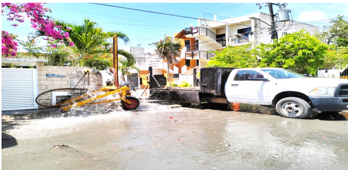
Desazolve. Calle 9 entre calle 2 a oriente y calle 4 poniente; fraccionamiento villas Tulum.
