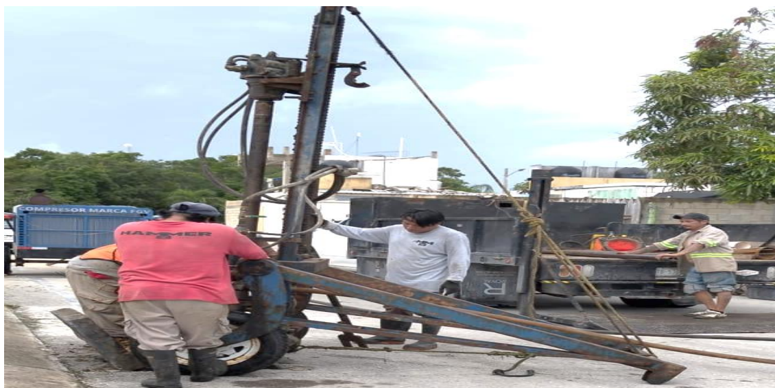
Desazolve. Calle sol oriente entre calle beta sur; colonia lak'iin.
