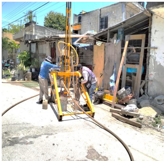
Desazolve. Calle chun yaxché entre calle faisán y calle quetzal; colonia ejido norte.
