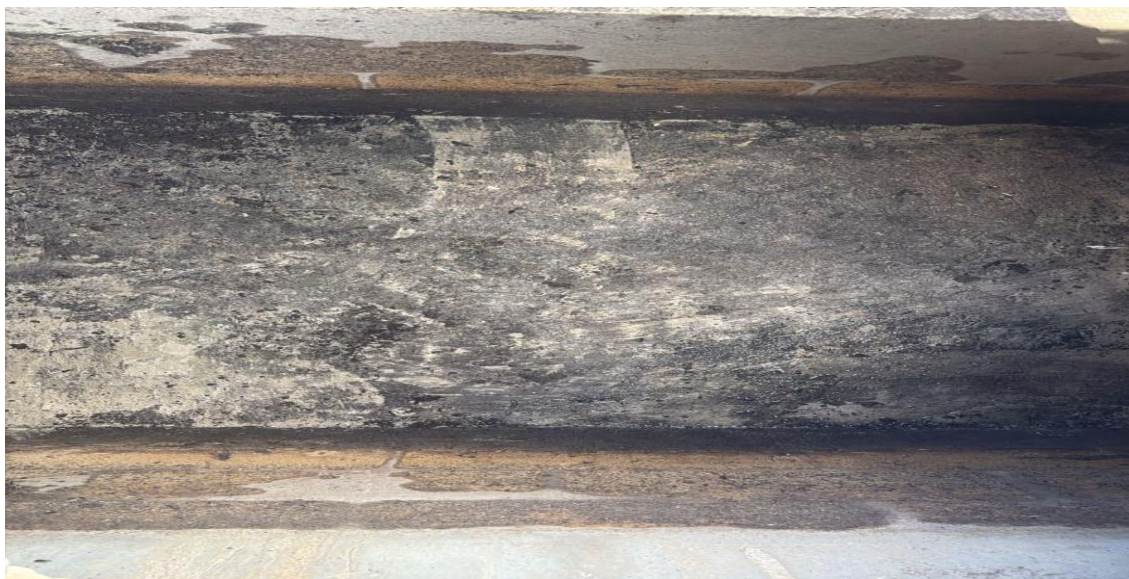
Limpieza de pozos. Calle 19 entre calle 24 y calle 26; colonia tumben kaa. (Pozo 01).
