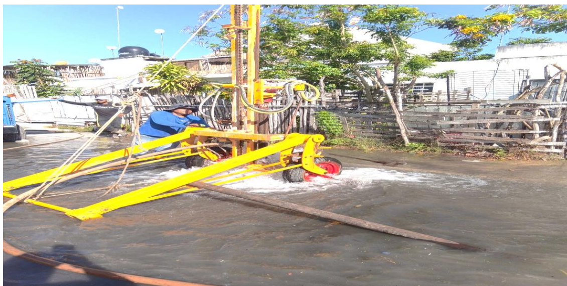
Desazolve. Boulevard palmas Tulum entre calle palma reina y calle palma rapis; fraccionamiento las palmas.
