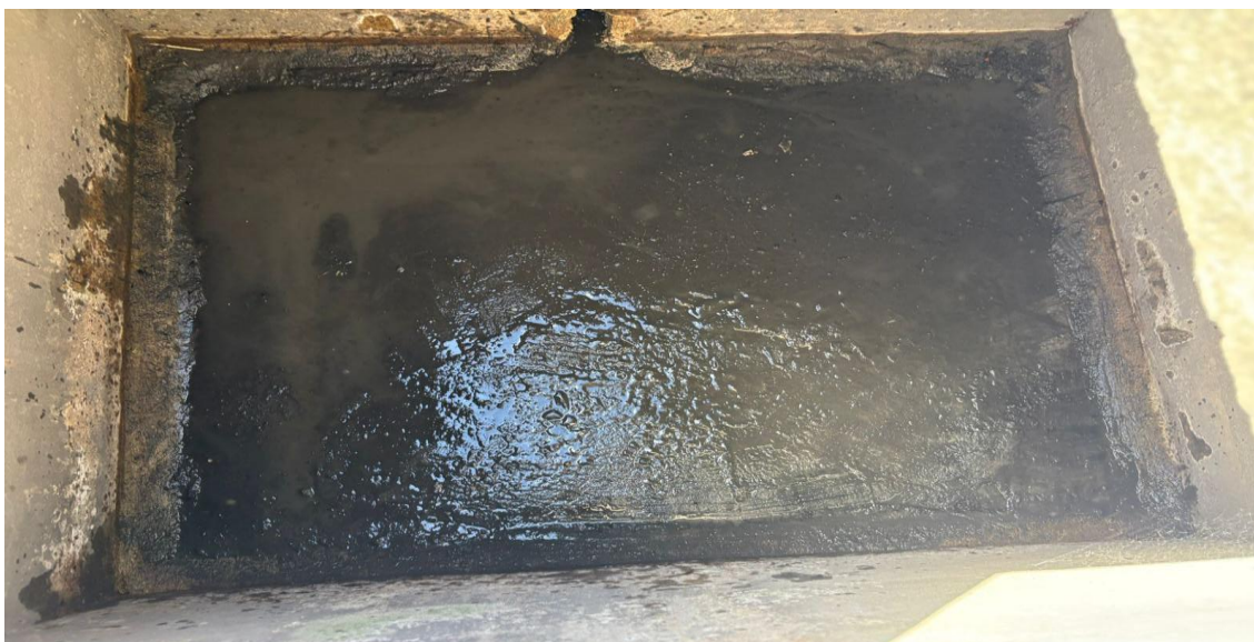
Limpieza de pozos. Calle golondrinas entre calle boca paila y av. kulkán; colonia ejido.
