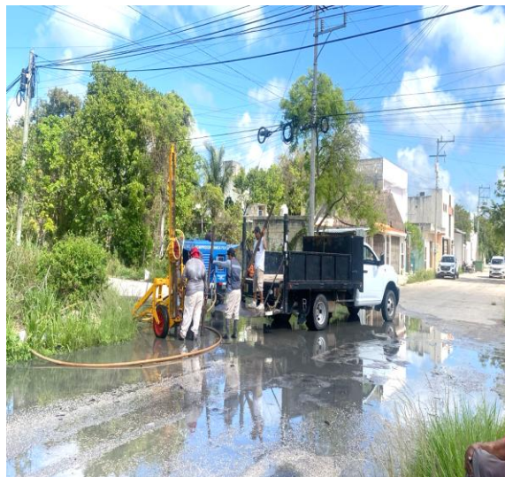
Desazolve. Av. 18 entre calle 19 y av. yodzonot; colonia tumben kaa. (Pozo 02).
