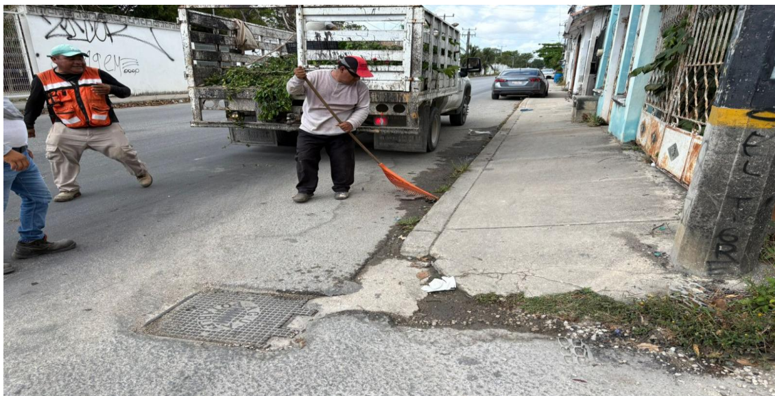
Limpieza de rejillas. Av. kulkán entre calle chacmool; colonia ejido.
