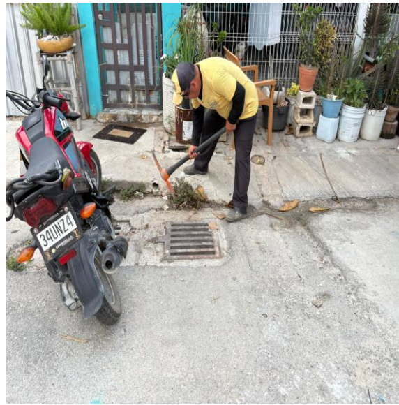
Limpieza de rejillas. Calle huracán Mitch entre calle huracán Irene; fraccionamiento huracanes.
