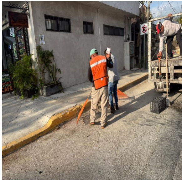
Limpieza de rejillas. Av. satélite entre calle sagitario poniente; colonia centro.
