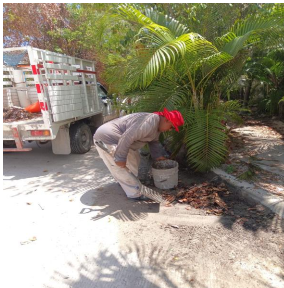
Limpeza de rejillas. Av. juanek entre calle kabah; fraccionamiento aldea zama.
