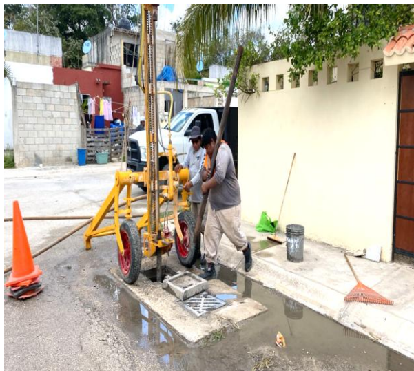
Desazolve. Boulevard palmas Tulum entre calle palma rapis y calle palma yagua; fraccionamiento las palmas.
