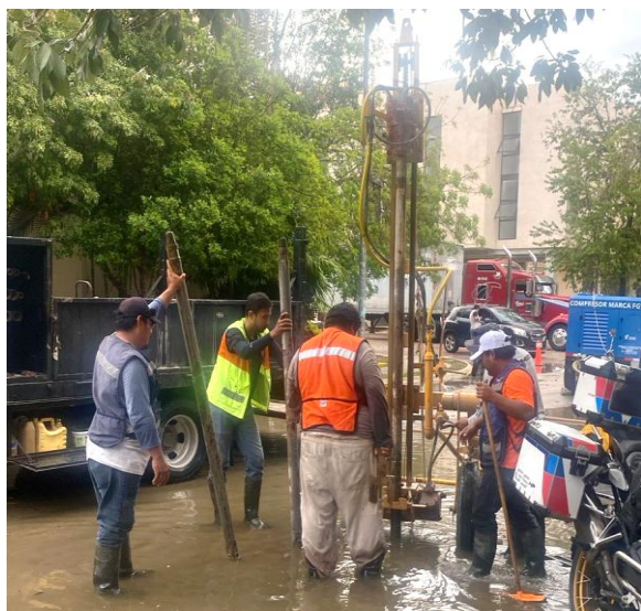
Desazolve. Av. Itzamná entre av. yaxchilán y av. juanek; fraccionamiento aldea zama. (Pozo 01).
