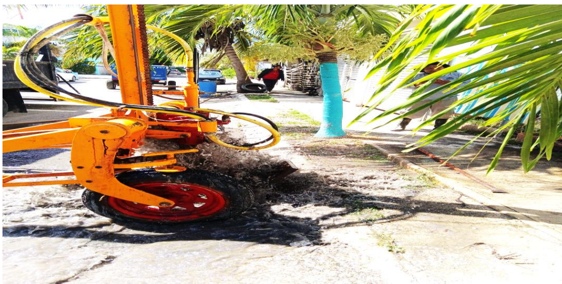
Desazolve. Calle 2 oriente entre calle Jacinto Pat y calle escorpión norte; fraccionamiento guerra de castas.
