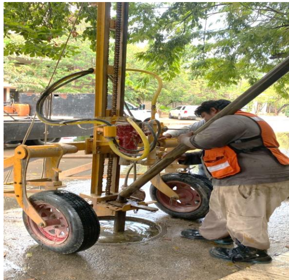
Desazolve. Av. Itzamná entre av. yaxchilán y av. juanek; fraccionamiento aldea zama. (Pozo 02).
