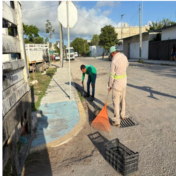
Limpieza de rejillas. Calle nabal entre calle faisán; colonia tumben kaa.
