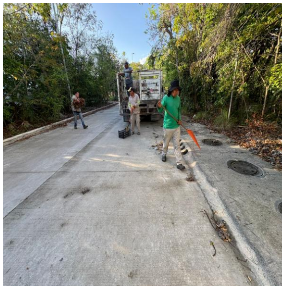
Limpeza de rejillas. Calle Itzamná entre calle nak be; fraccionamiento aldea zama.
