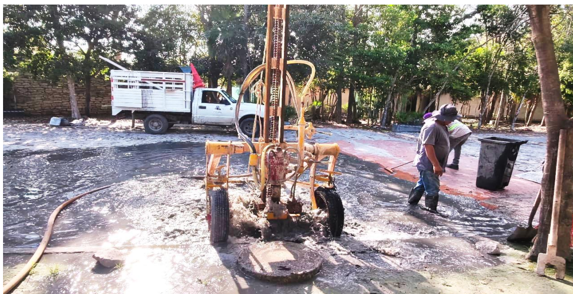
Desazolve. Av. aldea zama entre av. cobá; fraccionamiento aldea zama.
