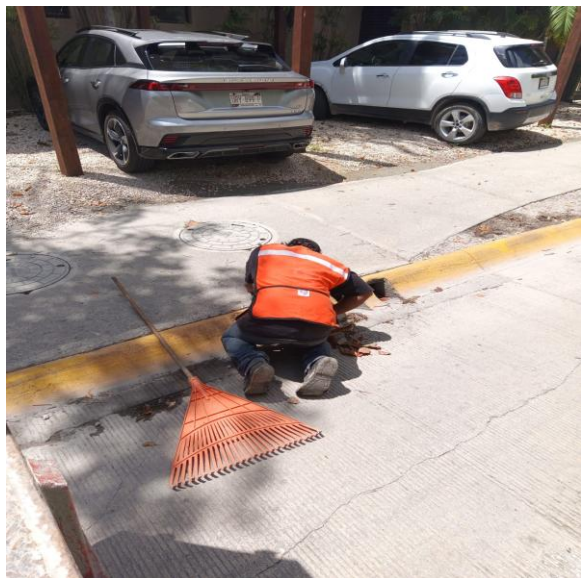
Limpeza de rejillas. Av. juanek; fraccionamiento aldea zama.
