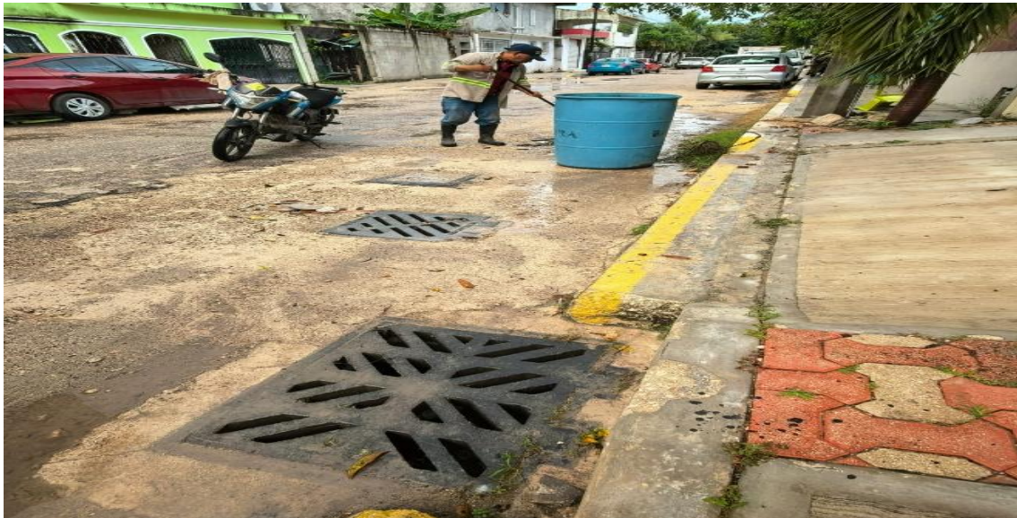
Limpieza de rejillas. Calle calche entre calle naal; colonia tumben kaa.
