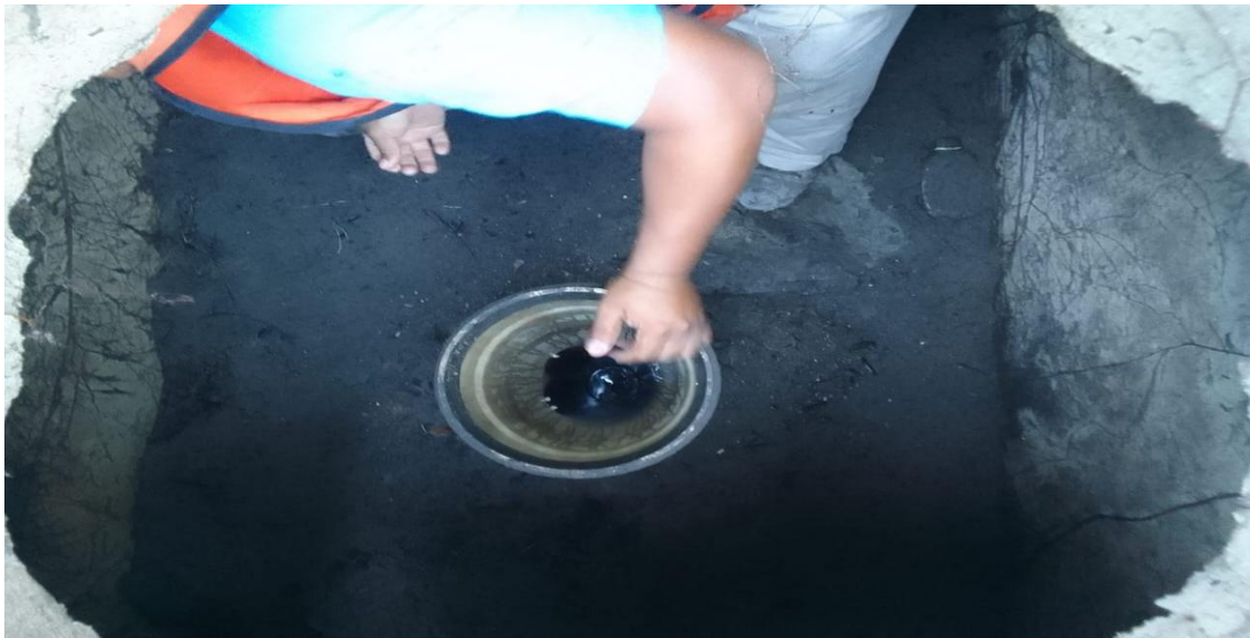
Limpieza de pozos. Calle boxkay entre calle Itzamná; fraccionamiento aldea zama.
