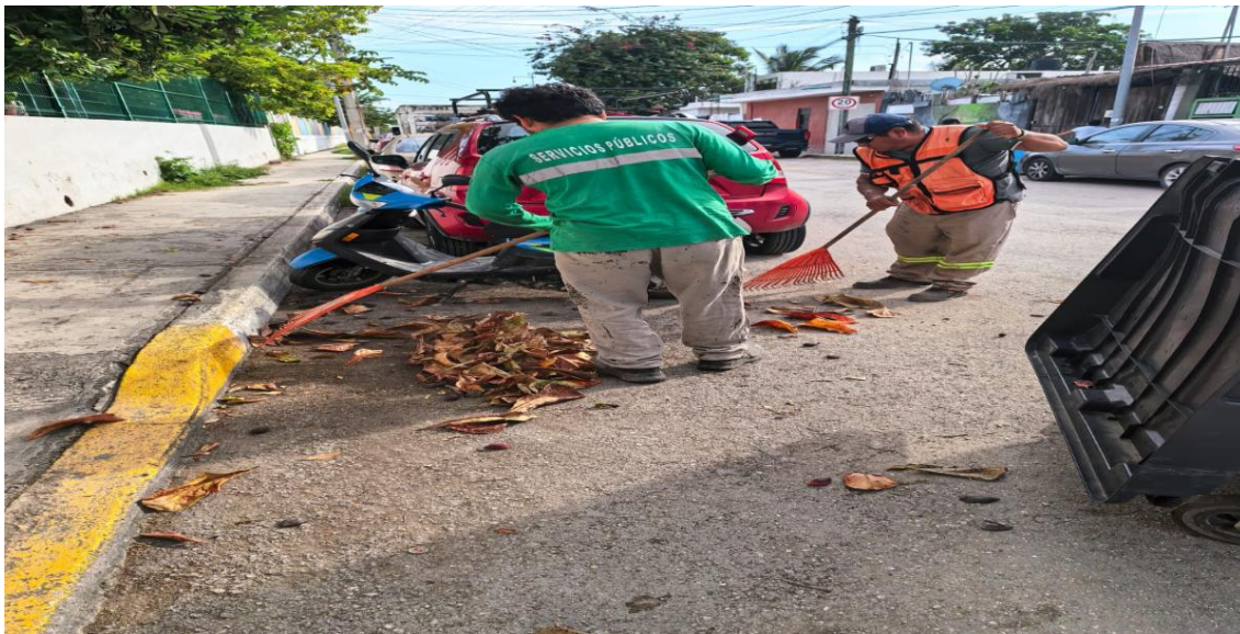
Limpieza de rejillas. Calle 2 poniente; colonia centro.
