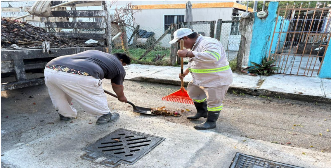
Limpieza de rejillas. Calle huracán mitch; fraccionamiento huracanes.
