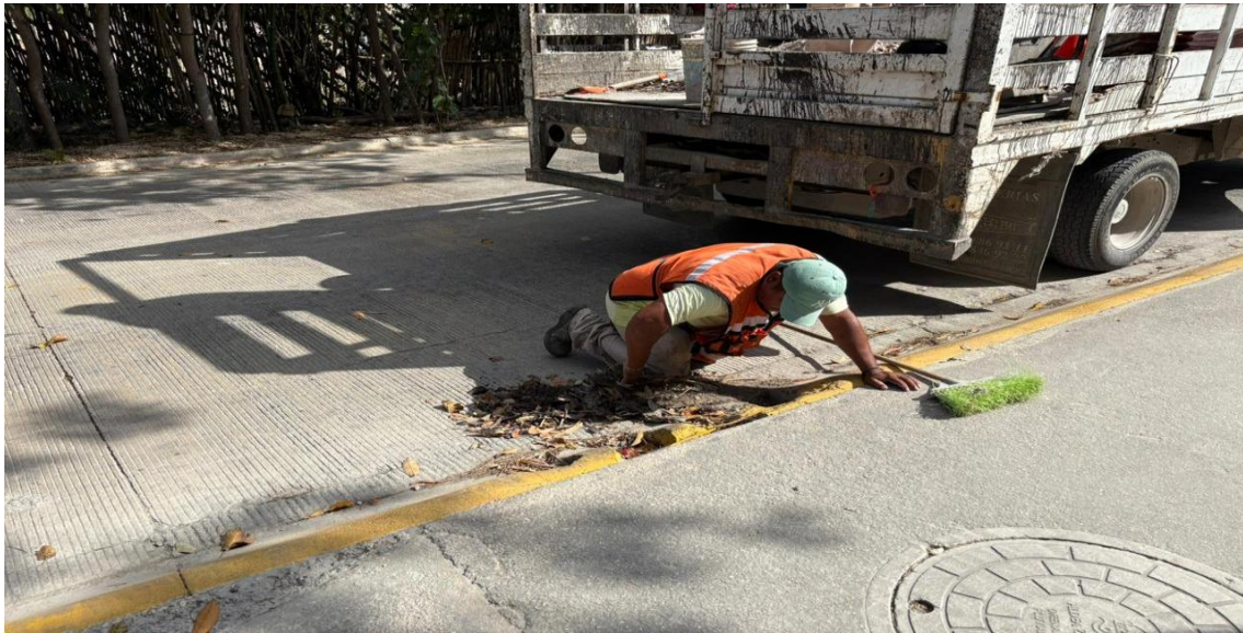
Limpieza de rejillas. Calle juan-ek; fraccionamiento aldea zama.
