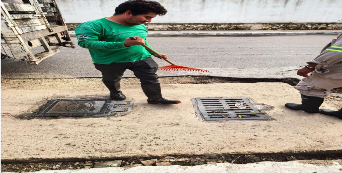
Limpieza de rejillas. Calle júpiter norte; colonia centro.
