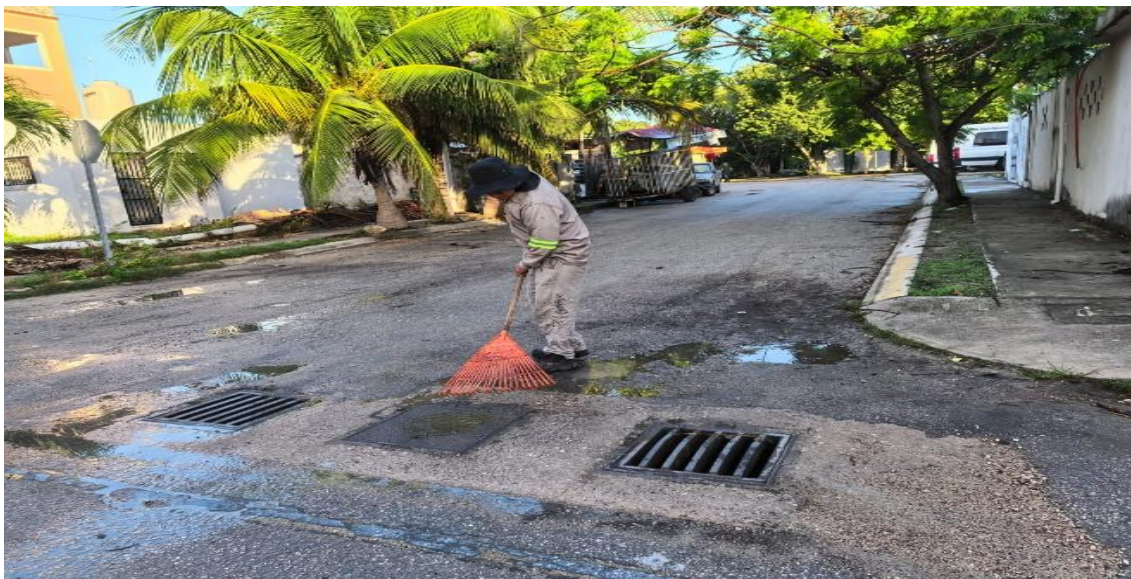
Limpieza de rejillas. Calle 2 poniente entre calle escorpión norte; fraccionamiento guerra de castas.
