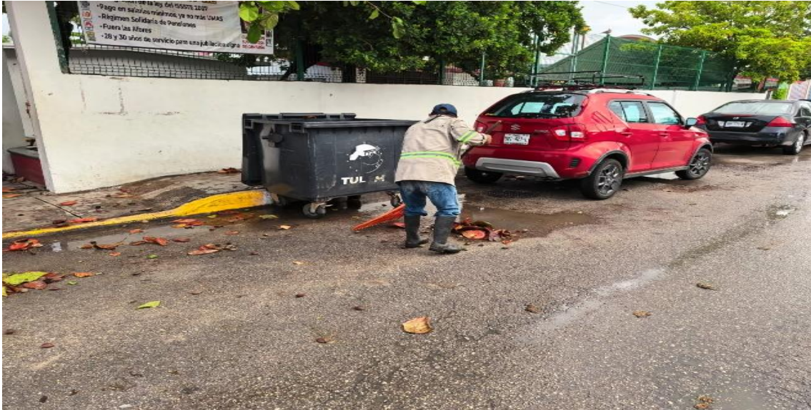
Limpieza de rejillas. Calle 2 poniente; colonia centro.
