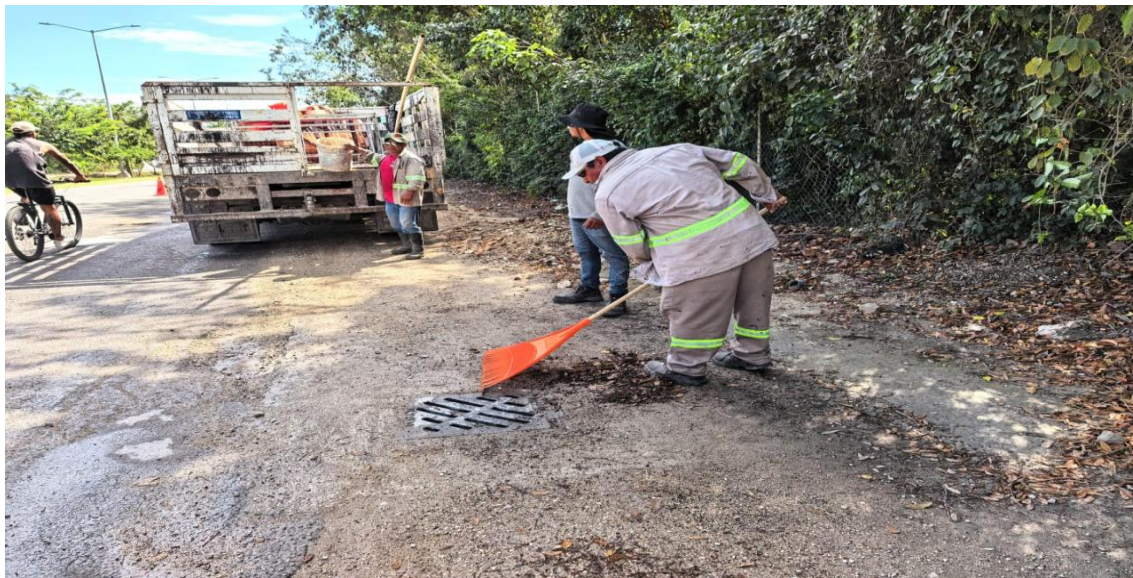
Limpieza de rejillas. Av. la selva entre calle kohunlich; colonia ejido.
