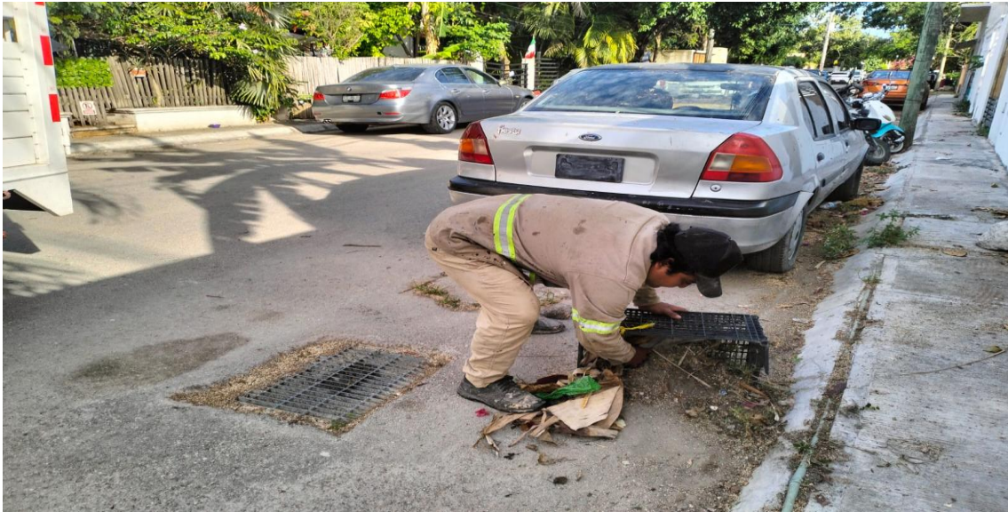
Limpeza de rejillas. Calle 17 entre calle 4 poniente; fraccionamiento villas Tulum.
