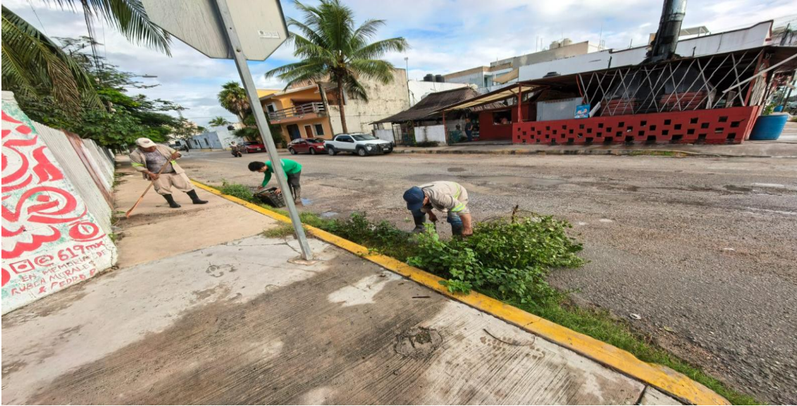
Limpieza de rejillas. Calle 4 poniente entre calle beta norte; colonia centro.
