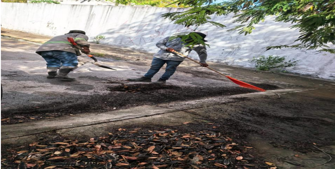
Limpieza de rejillas. Calle palma abanico; fraccionamiento las palmas.
