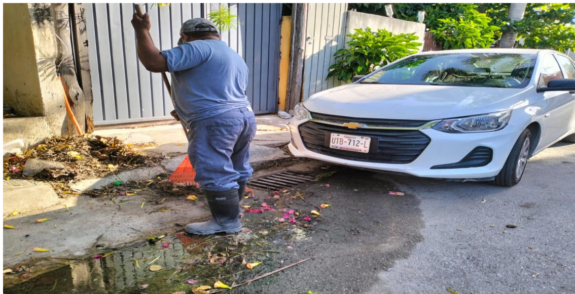
Limpieza de rejillas. Calle 15 entre calle 11; fraccionamiento villas Tulum.
