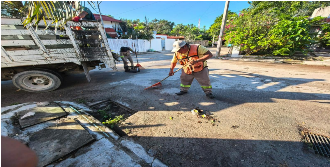
Limpieza de rejillas. Calle 17; fraccionamiento villas Tulum.
