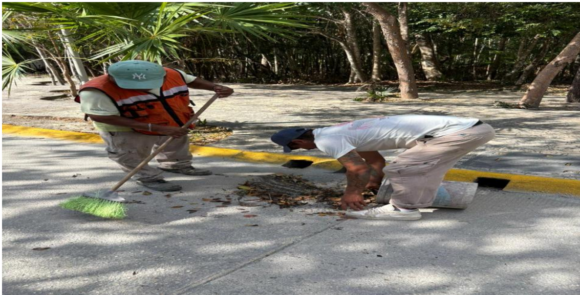
Limpieza de rejillas. Av. aldea zama entre calle and kaan; fraccionamiento aldea zama.
