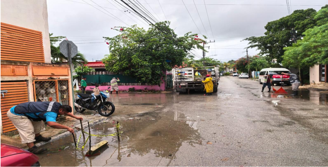
Limpeza de rejillas. Calle 4 oriente entre calle 15; colonia centro.
