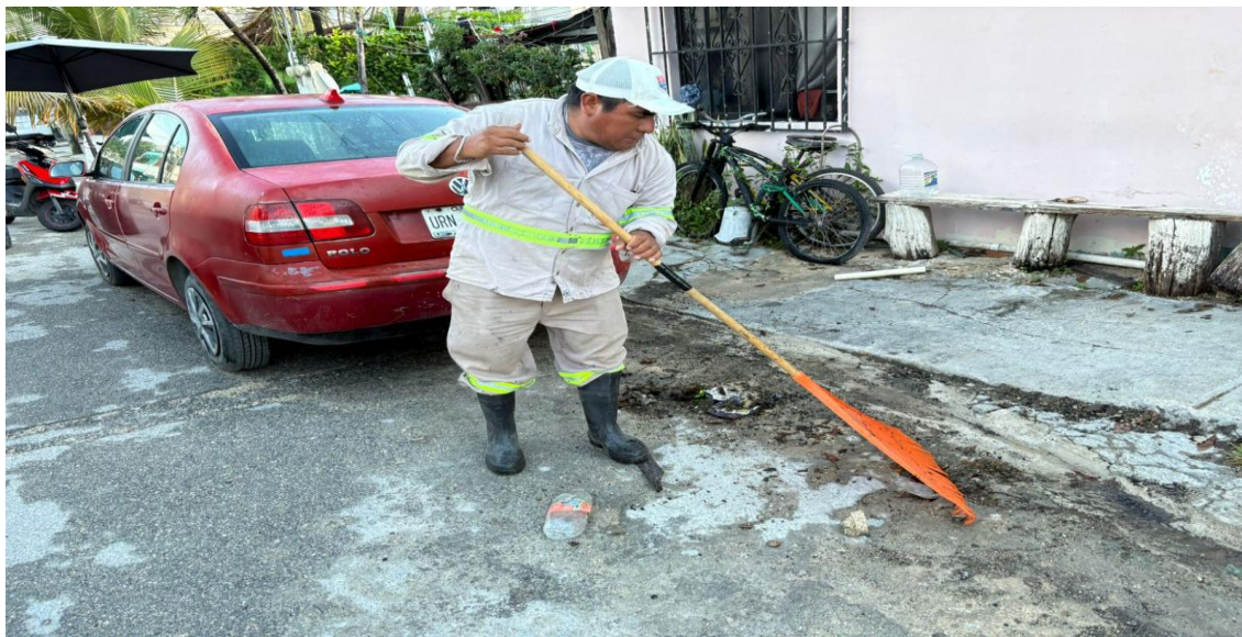
Limpieza de rejillas. Calle huracán rossana; fraccionamiento huracanes.
