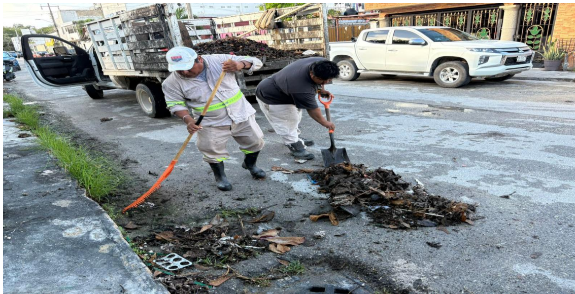
Limpieza de rejillas. Calle huracán Beulah; fraccionamiento huracanes.
