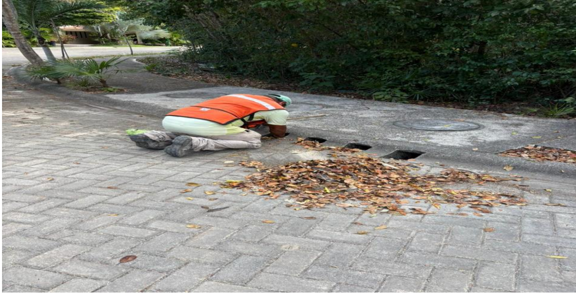
Limpieza de rejillas. Calle kinich-na; fraccionamiento aldea zama.
