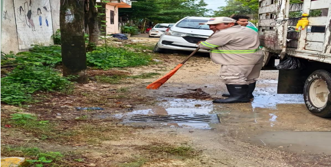
Limpeza de rejillas. Calle 2 poniente entre calle júpiter norte; colonia centro.
