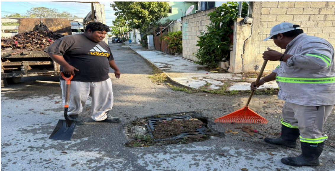
Limpeza de rejillas. Calle huracán paulina entre calle huracán gilberto; fraccionamiento huracanes.
