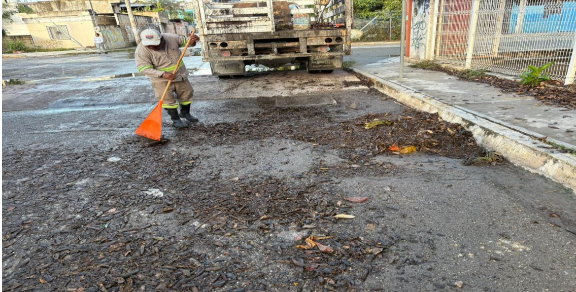
Limpieza de rejillas. Calle sol oriente entrecalle libra sur; fraccionamiento huracanes.
