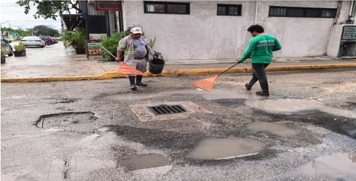
Limpieza de rejillas. Calle sagitario oriente entre av. satélite; colonia centro.
