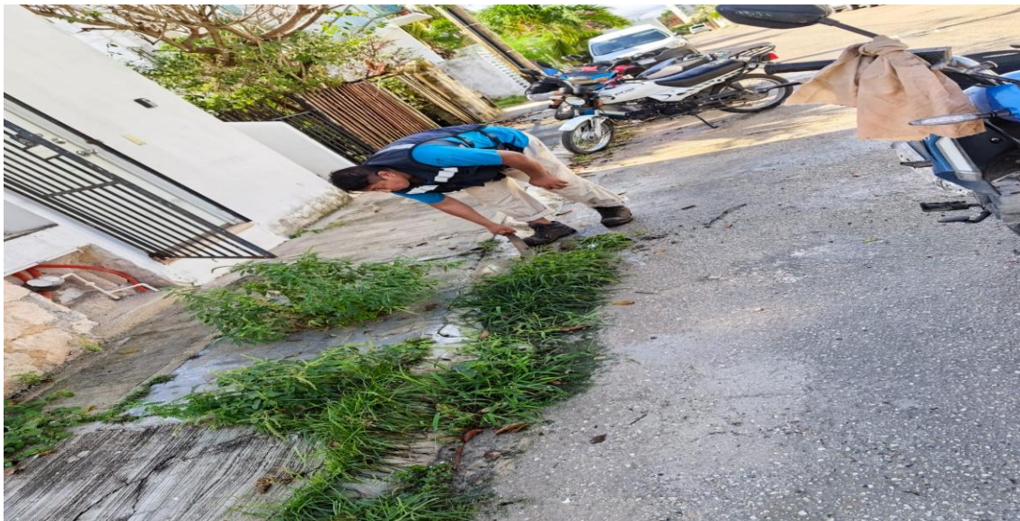
Limpeza de rejillas. Calle 7 sur entre calle 2 oriente a; fraccionamiento villas Tulum.
