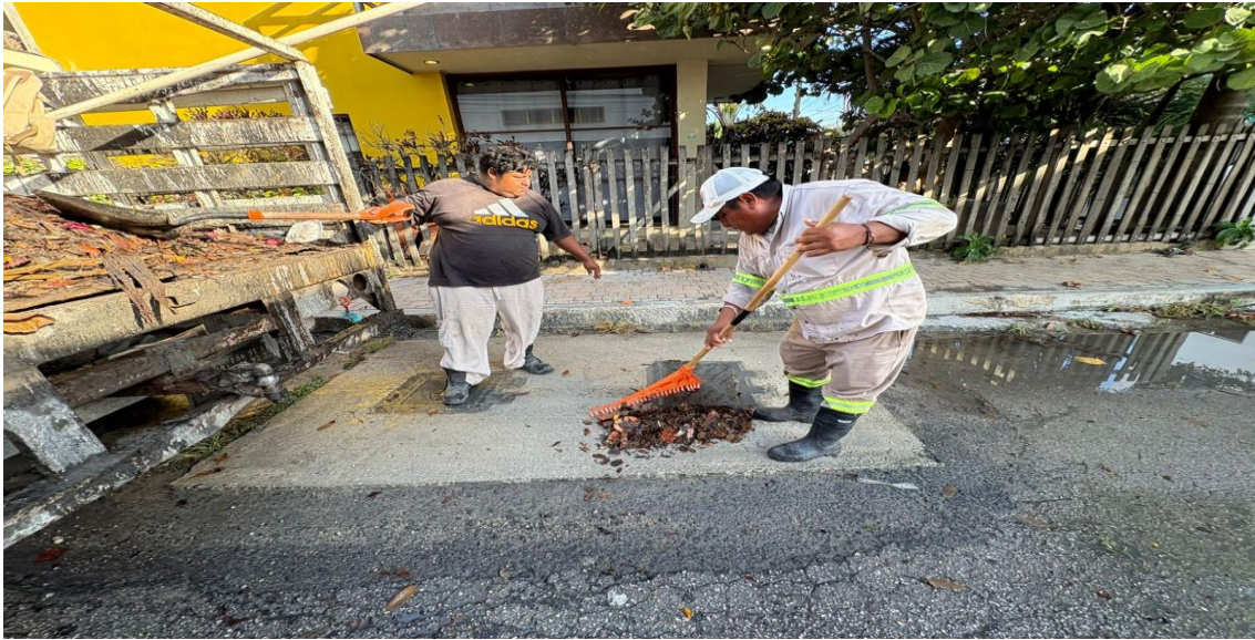
Limpieza de rejillas. Calle sol oriente; colonia sac be.
