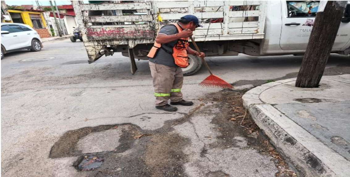
Limpieza de rejillas. Calle 2 poniente entre calle alfa norte; colonia centro.
