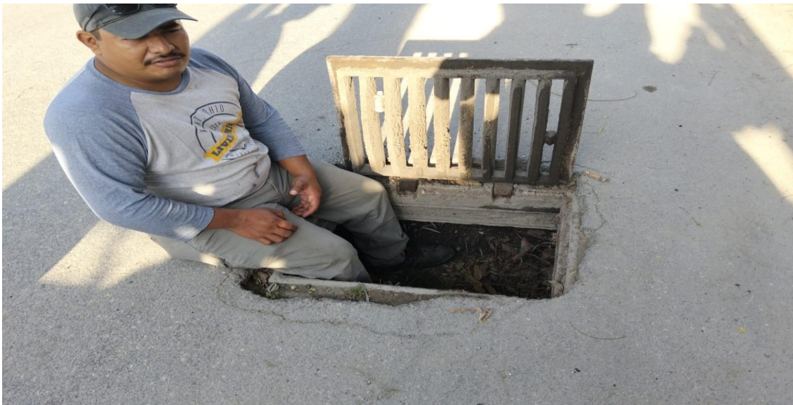
Limpieza de pozos. Calle luna poniente entre calle aries sur; colonia luna, (Pozo 02).
