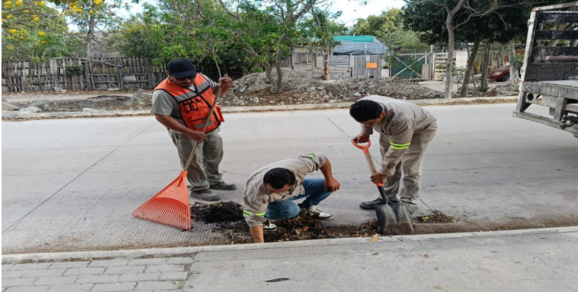
Limpieza de rejillas. Av. Juan-ek entre av. Aldea Zama.
