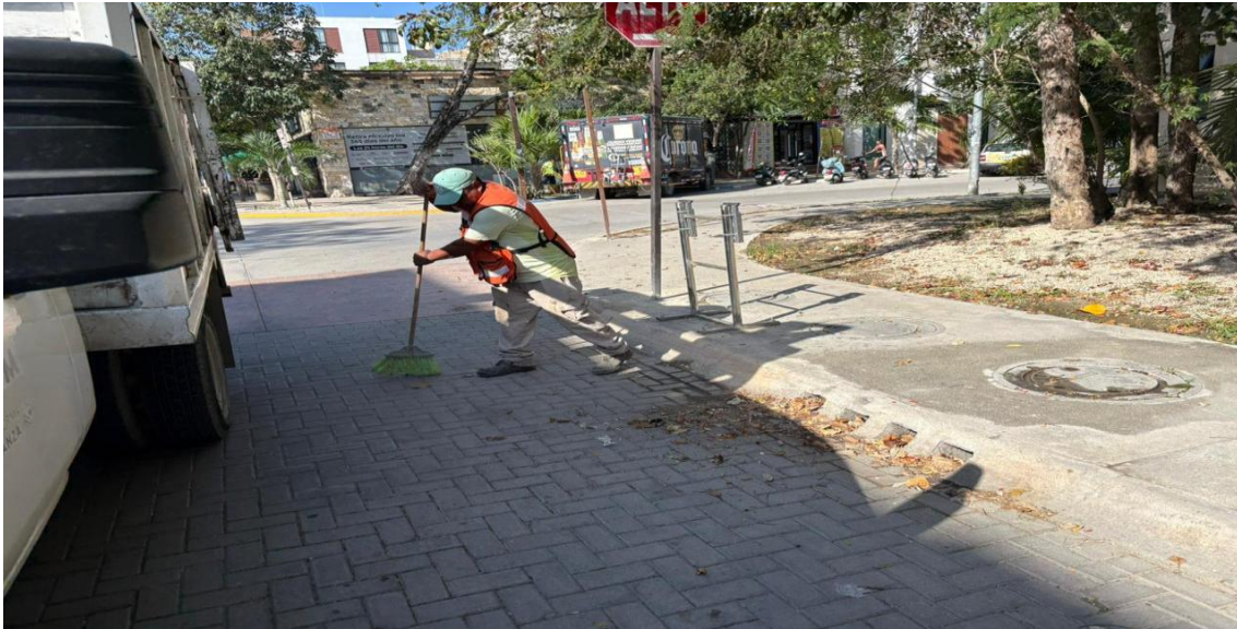
Limpieza de rejillas. Calle Itzamná; fraccionamiento aldea zama.
