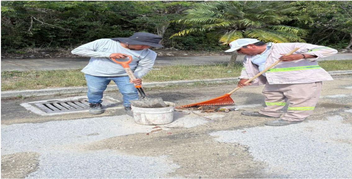
Limpieza de rejillas. Av. 10 norte entre calle palmas Tulum; fraccionamiento las palmas.
