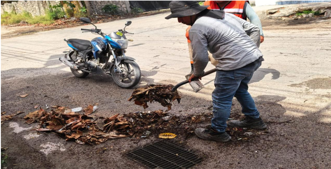
Limpieza de rejillas. Calle mercurio poniente entre calle palenque; colonia maya.
