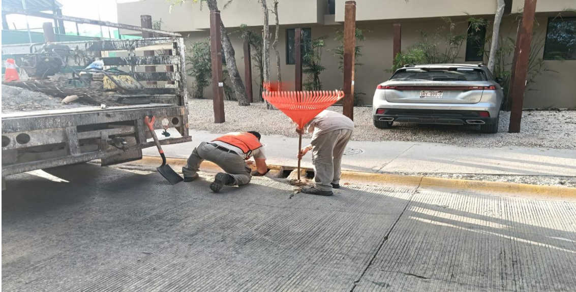
Limpieza de rejillas. Av. Juan-ek entre calle Yaxchilan; fraccionamiento Aldea Zama.
