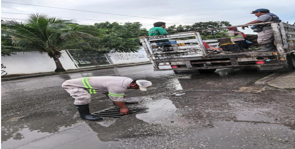
Limpieza de rejillas. Av. kukulkán entre calle chacmool; colonia ejido.
