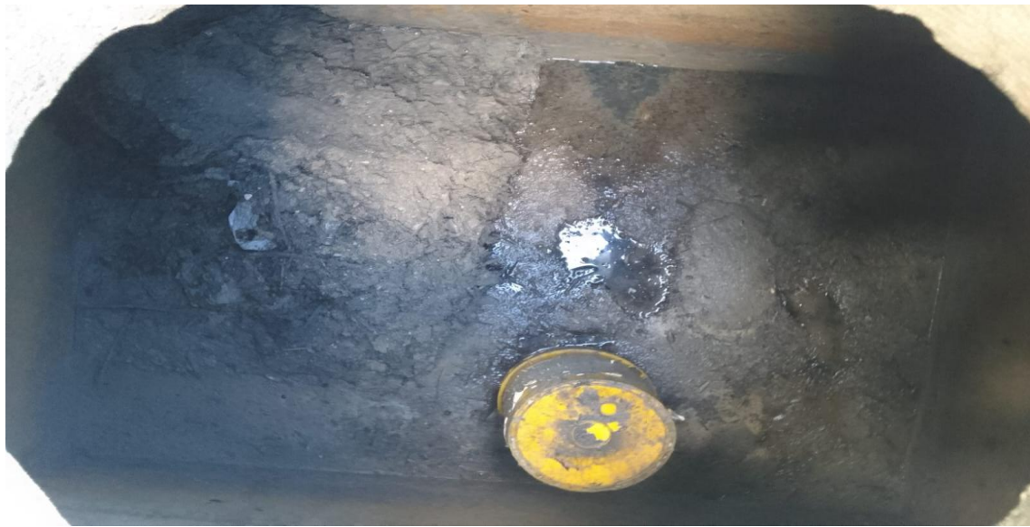
Limpieza de pozos. Av. juanek entre calle kabah y calle balam dzancab; fraccionamiento aldea zama.
