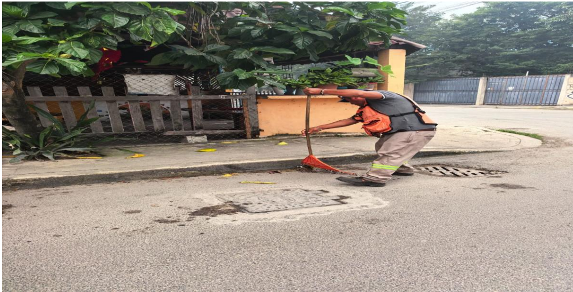
Limpieza de rejillas. Calle golondrina; colonia tumben kaa.
