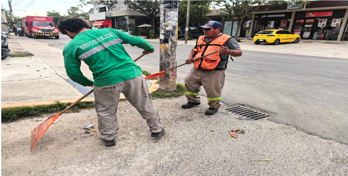
Limpieza de rejillas. Calle golondrina entre calle chanchen; colonia tumben kaa.
