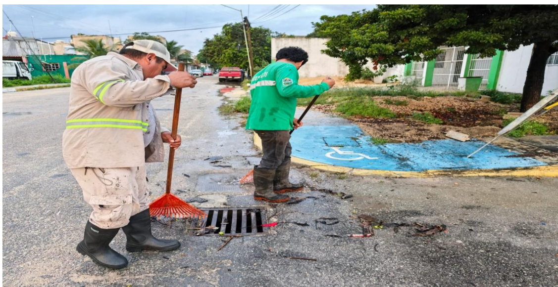
Limpieza de rejillas. Calle faisán entre calle nabal; colonia tumben kaa.
