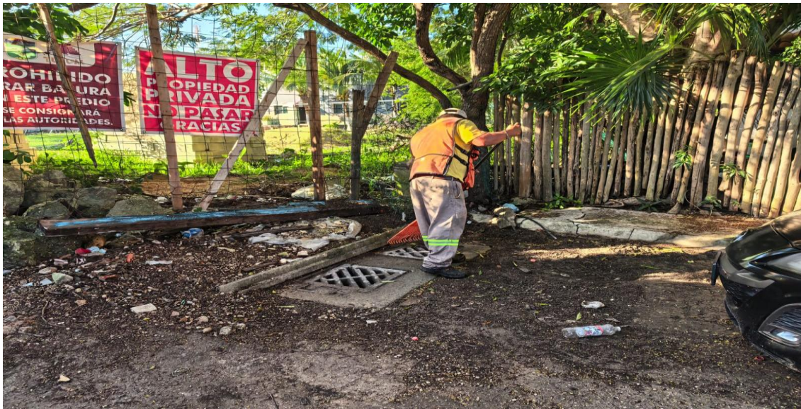
Limpieza de rejillas. Calle chemuyil; fraccionamiento villas Tulum.
