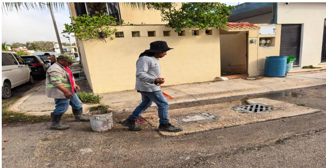
Limpieza de rejillas. Calle palma rapis entre calle palma guinea; fraccionamiento las palmas.
