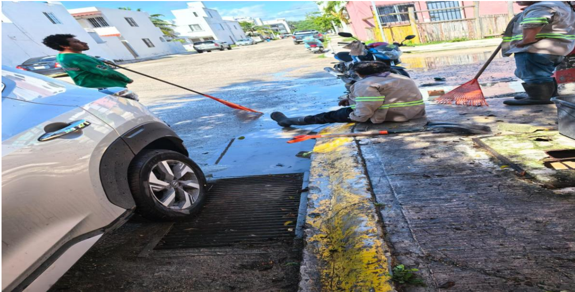
Limpieza de rejillas. Calle 2 bis oriente entre calle 7 sur; fraccionamiento villas Tulum.
