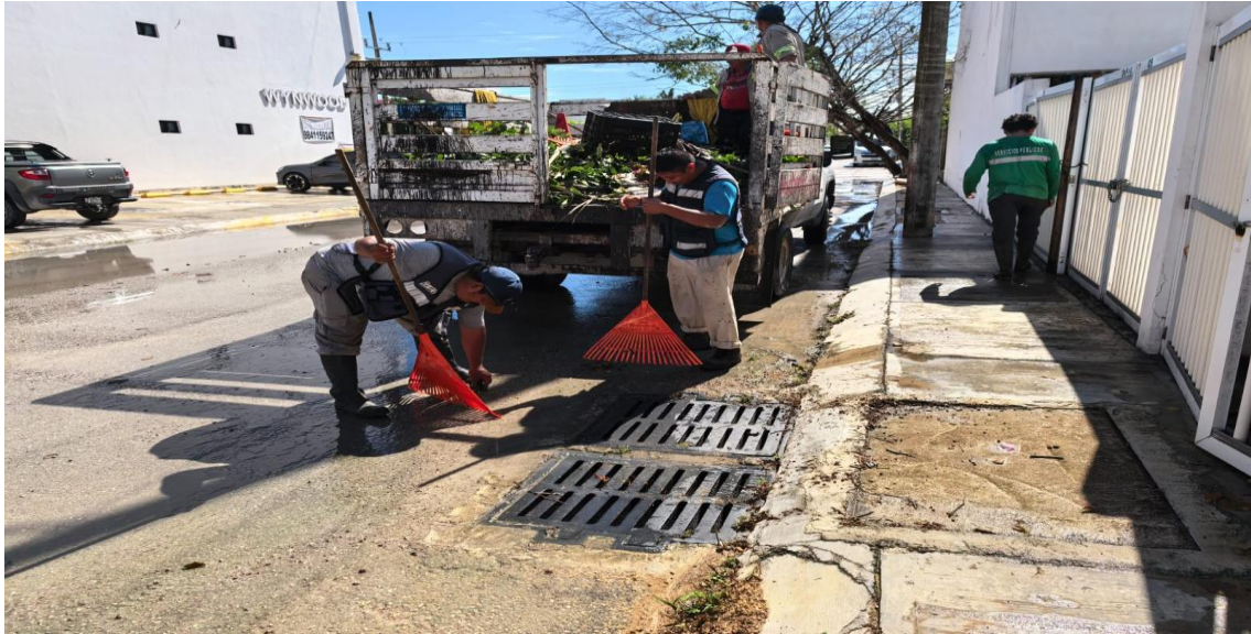
Limpeza de rejillas. Calle 5 sur entre calle 4 oriente; fraccionamiento villas Tulum.
