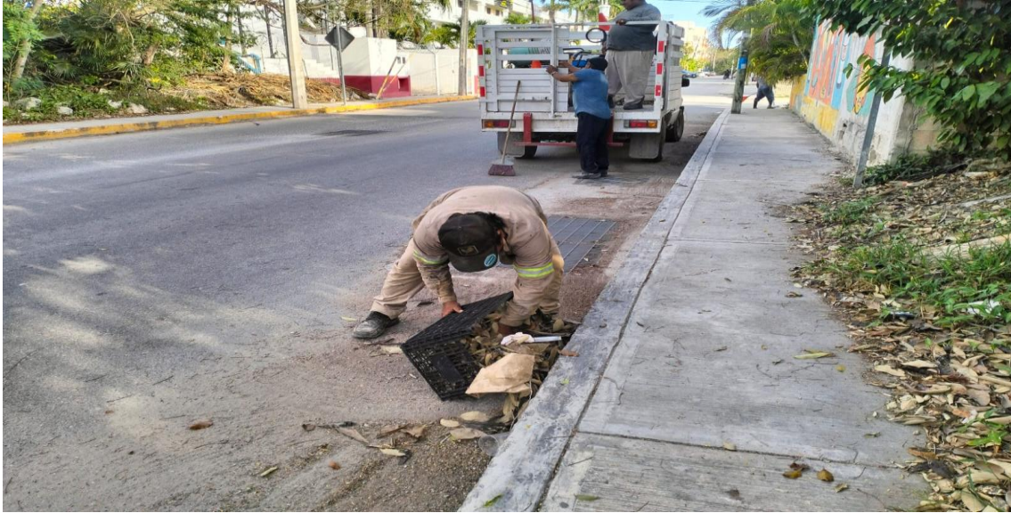
Limpieza de rejillas. Calle 15 entre calle 12; fraccionamiento villas Tulum.
