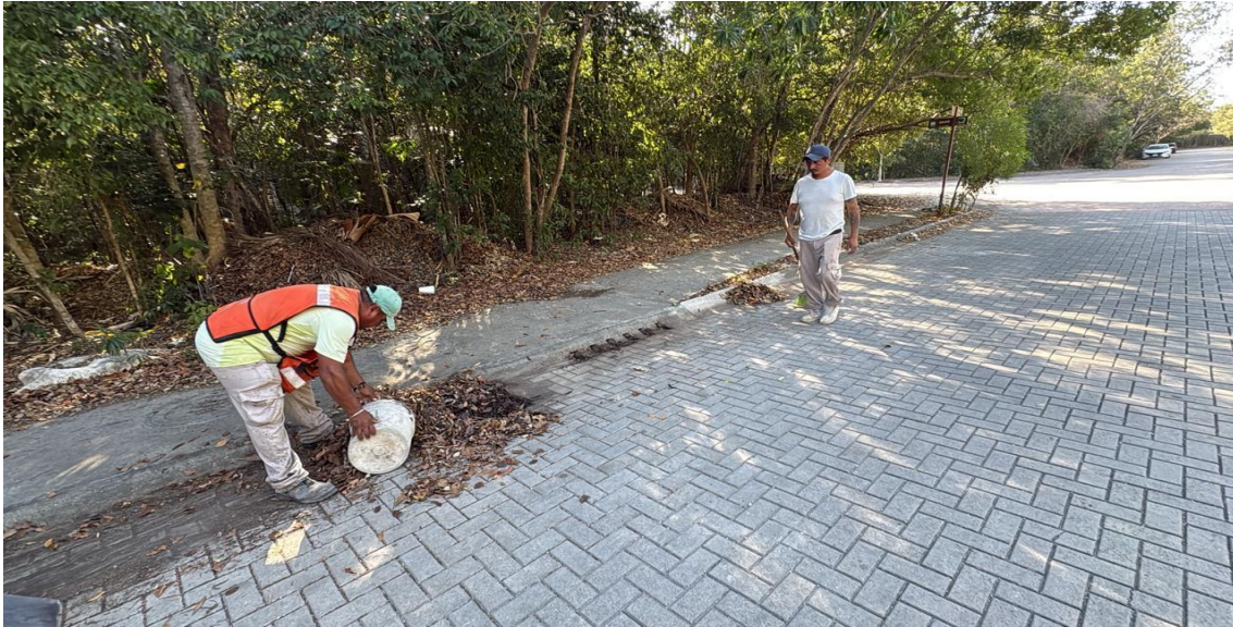
Limpieza de rejillas. Calle kabah entre calle mayapán; fraccionamiento aldea zama.
