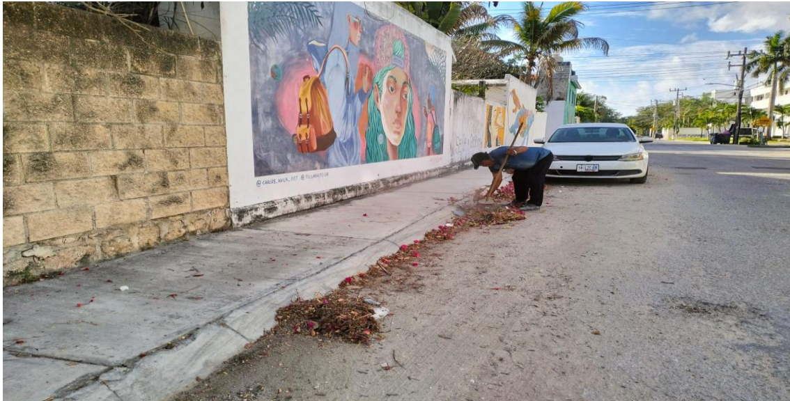
Limpieza de rejillas. Calle 11 entre calle 15; fraccionamiento villas Tulum.
