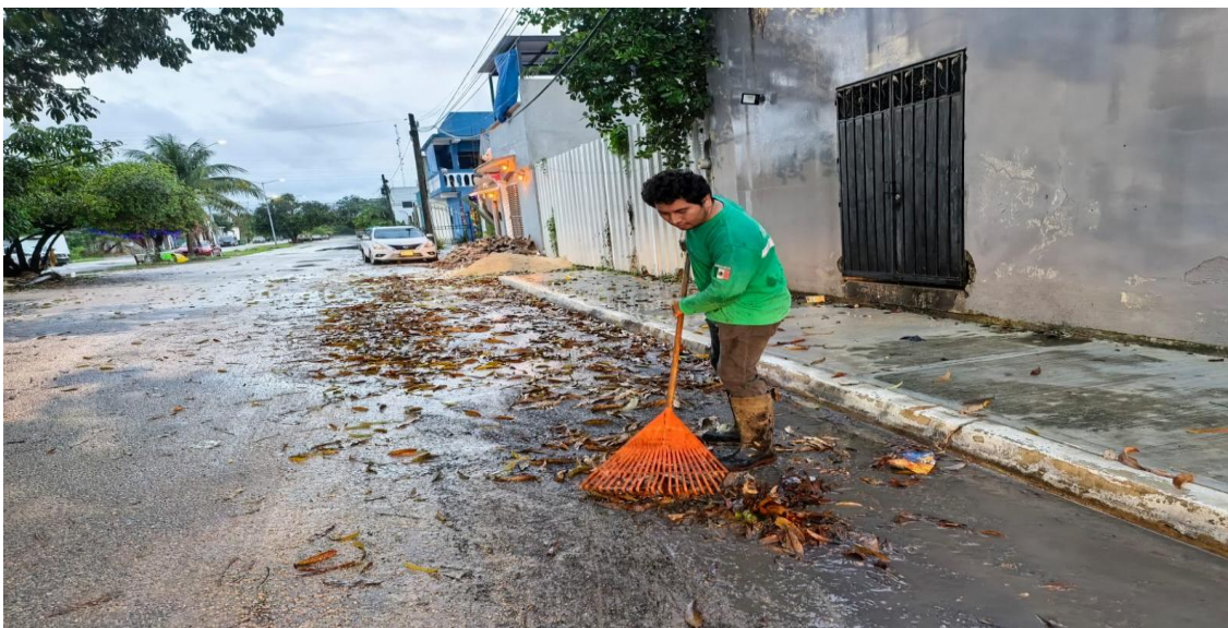
Limpieza de rejillas. Av. 18 entre calle faisán; colonia tumben kaa.
