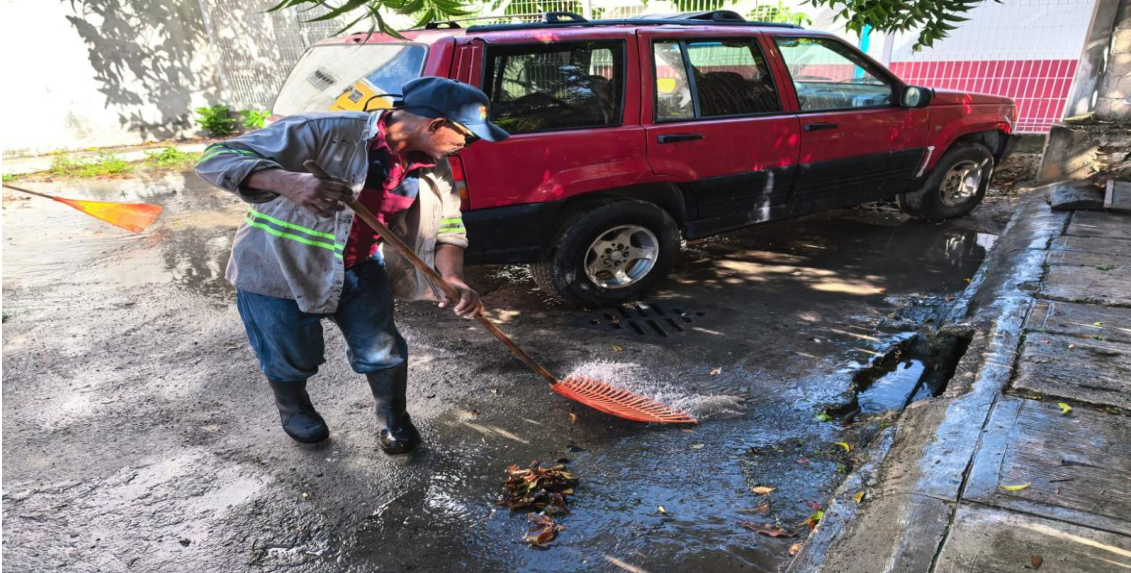
Limpeza de rejillas. Calle 2 bis oriente entre calle 11; fraccionamiento villas Tulum.
