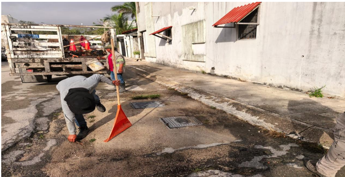
Limpieza de rejillas. Calle palma rapis entre boulevard palmas Tulum; fraccionamiento las palmas.
