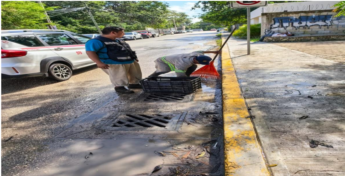
Limpieza de rejillas. Calle 3 sur entre calle 2 bis oriente; fraccionamiento villas Tulum.
