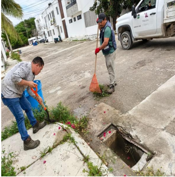
Limpeza de rejillas. Calle 7 sur entre calle 2 oriente; fraccionamiento villas Tulum.
