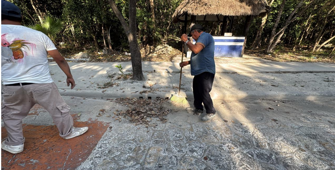
Limpieza de rejillas. Av. aldea zama entre av. cobá; fraccionamiento aldea zama.
