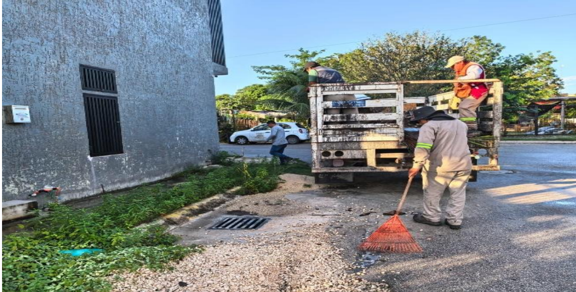
Limpieza de rejillas. Calle cecilio chi entre calle 4 poniente; fraccionamiento guerra de castas.
