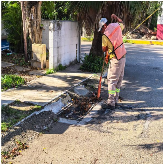
Limpeza de rejillas. Calle 2 bis oriente; fraccionamiento villas Tulum.
