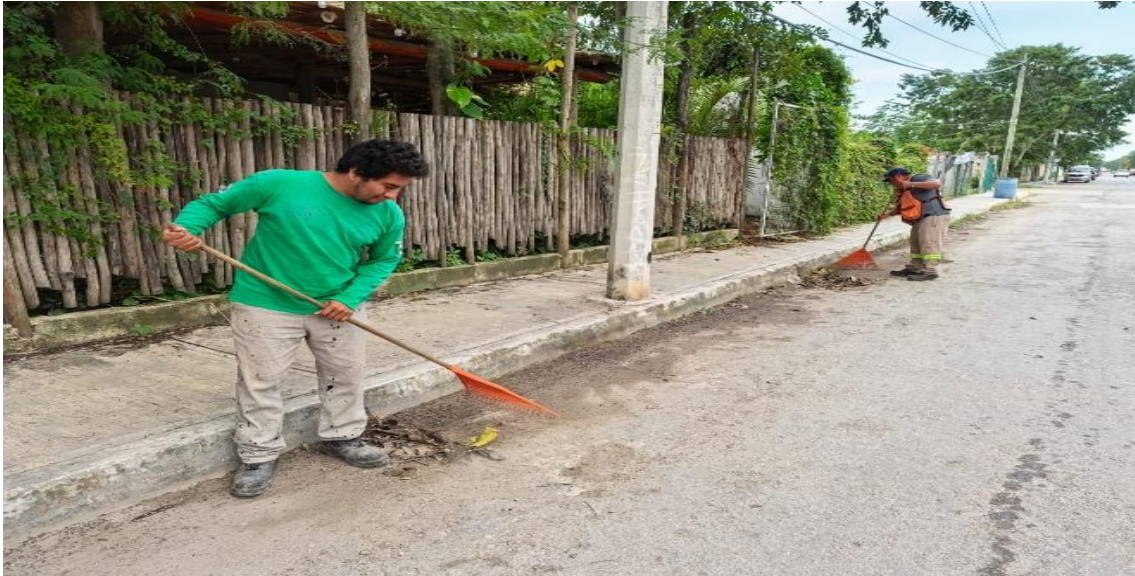
Limpieza de rejillas. Calle tumben ha entre av. la selva; colonia tumben kaa.
