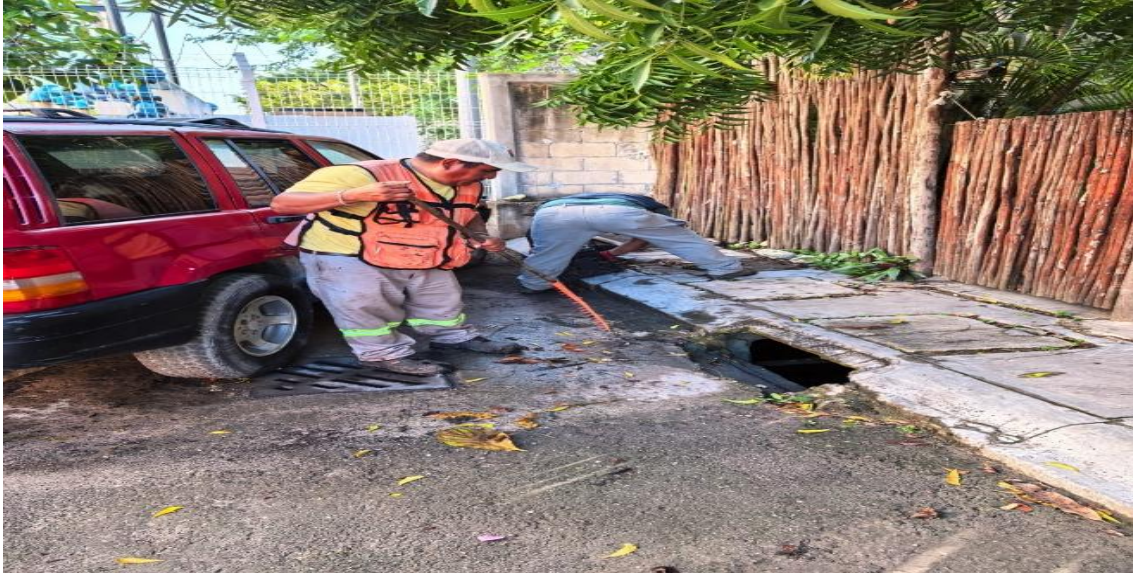
Limpieza de rejillas. Calle 11; fraccionamiento villas Tulum.
