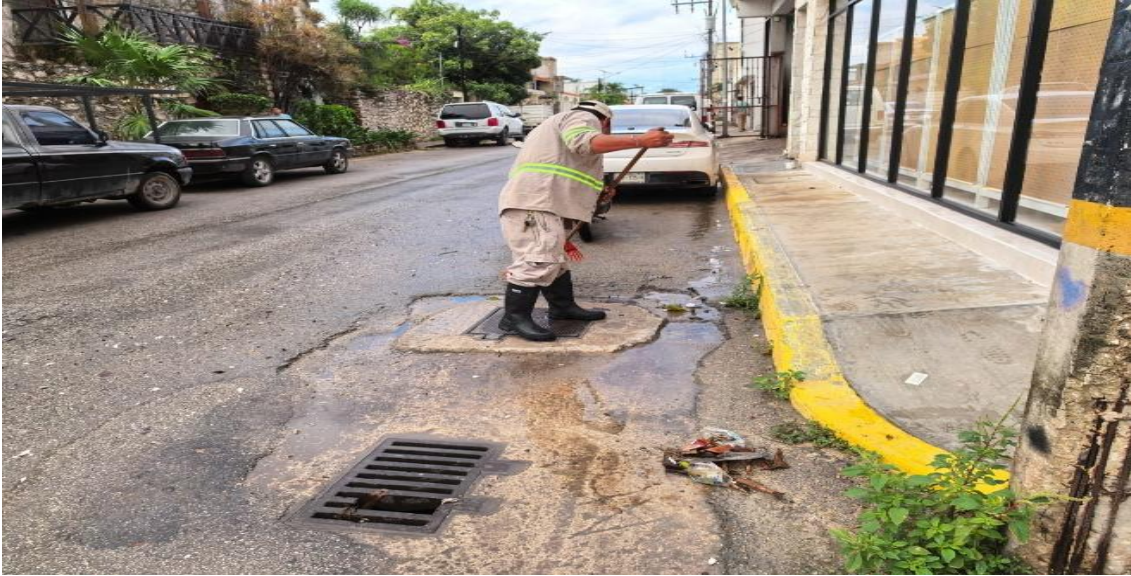
Limpieza de rejillas. Calle sagitario oriente entre calle centauro norte; colonia centro.
