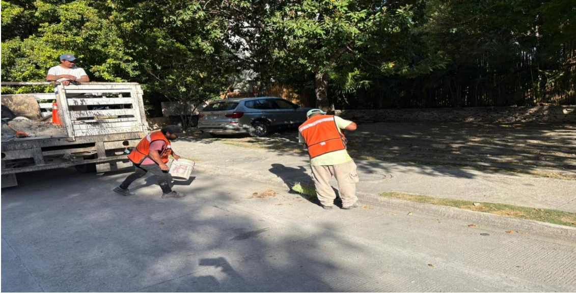
Limpieza de rejillas. Av. aldea zama entre calle balam dzancab; fraccionamiento aldea zama.
