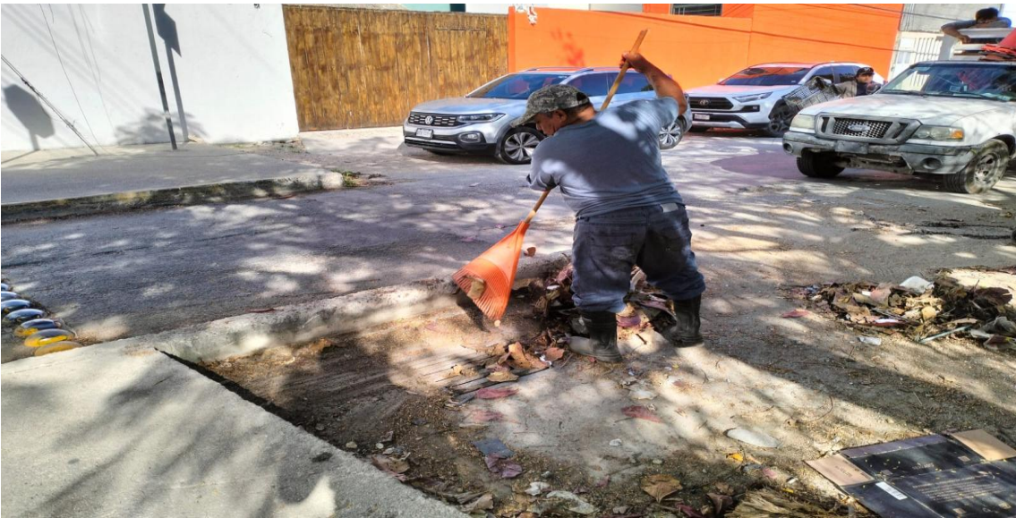
Limpeza de rejillas. Calle polar poniente entre av. satélite y calle ori3n norte; colonia centro.
