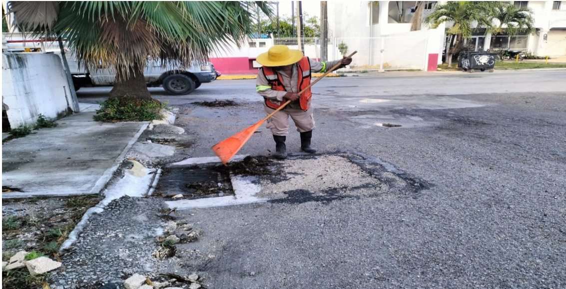
Limpeza de rejillas. Calle 2 oriente entre calle escorpión; fraccionamiento villas Tulum.
