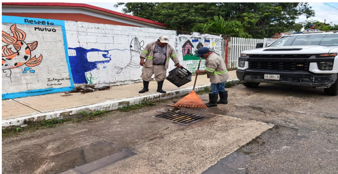
Limpeza de rejillas. Calle bubul-lek; colonia mayapax.
