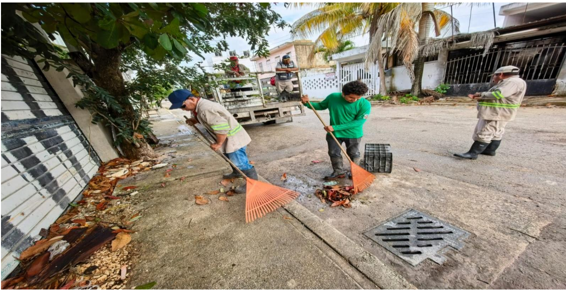
Limpieza de rejillas. Calle tun-k'ul entre calle chikil; colonia mayapax.
