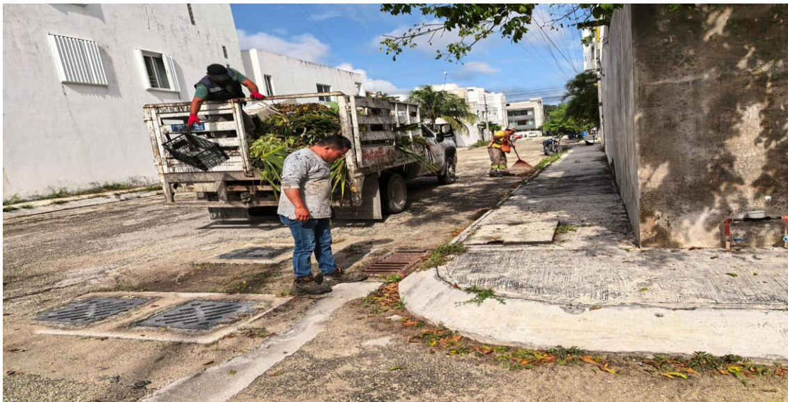
Limpeza de rejillas. Calle 7 sur entre calle 2 bis oriente a; fraccionamiento villas Tulum.
