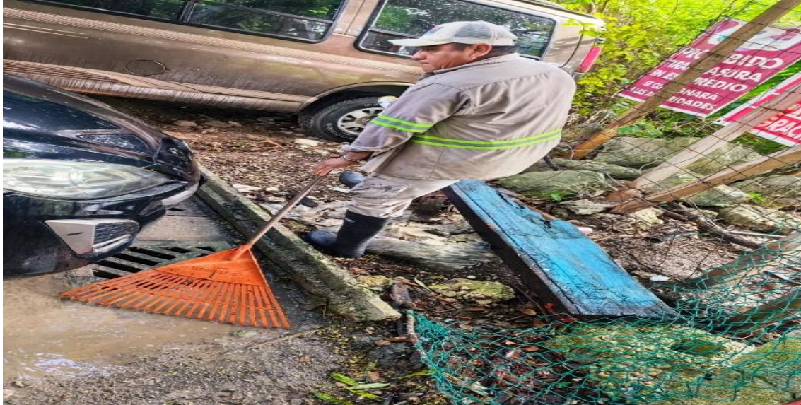
Limpieza de rejillas. Calle chemuyil entre calle 4 oriente; fraccionamiento villas Tulum.
