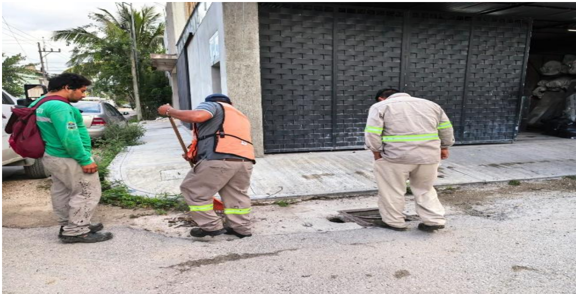
Limpieza de rejillas. Calle naal entre calle bojom; colonia tumben kaa.
