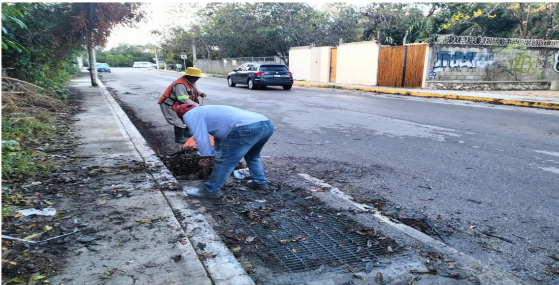
Limpieza de rejillas. Calle 3 sur; fraccionamiento villas Tulum.
