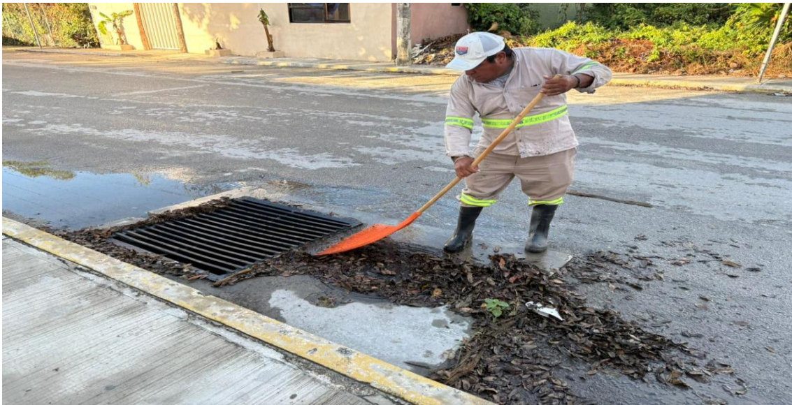
Limpieza de rejillas. Calle libra sur entre calle andrómeda oriente; fraccionamiento huracanes.
