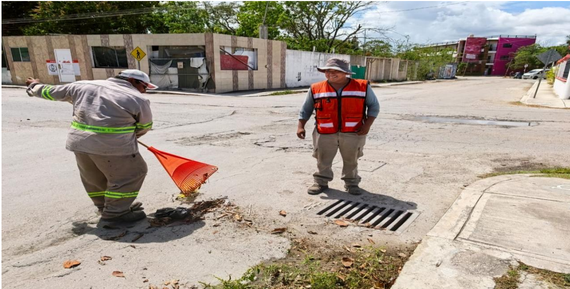
Limpieza de rejillas. Calle polar poniente entre calle saturno norte; colonia centro.
