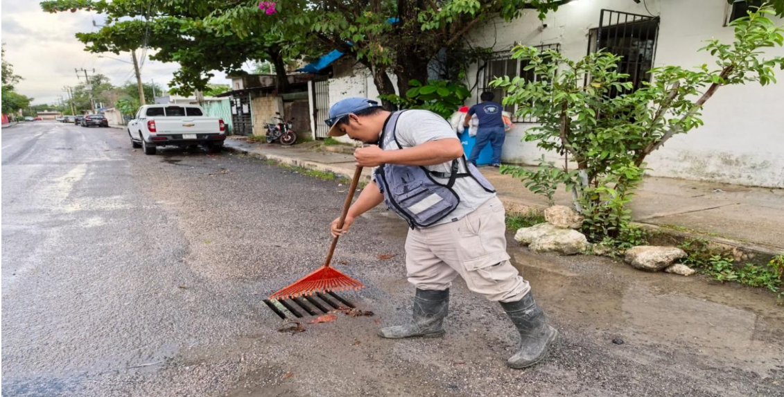
Limpeza de rejillas. Calle faisán entre calle boca paila; colonia ejido.
