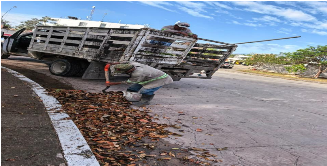
Limpieza de rejillas. Calle palmas reyna; fraccionamiento las palmas.
