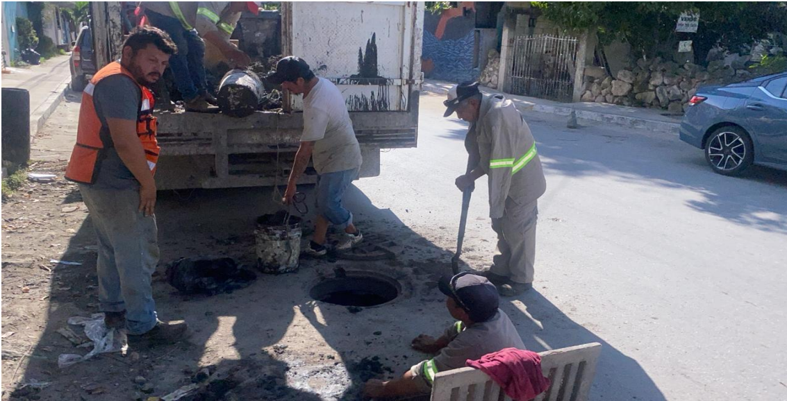
Limpieza de pozos. Calle luna poniente entre calle aries sur; colonia luna, (Pozo 01).
