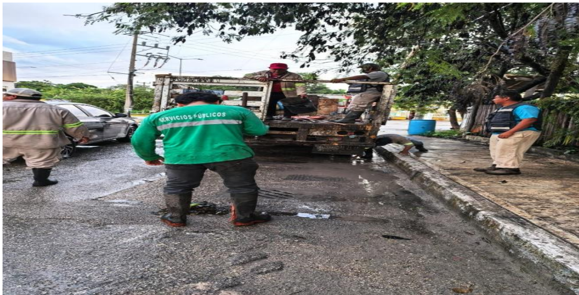
Limpieza de rejillas. Calle faisán entre av. la selva; colonia ejido.
