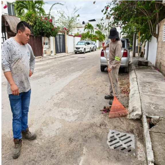
Limpeza de rejillas. Calle 3 sur entre calle 2 oriente a; fraccionamiento villas Tulum.
