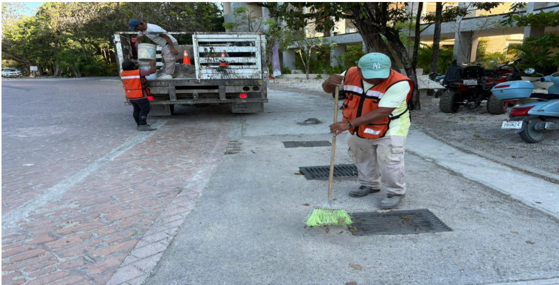
Limpieza de rejillas. Av. aldea zama entre av. consejo ciudadano; fraccionamiento aldea zama.
