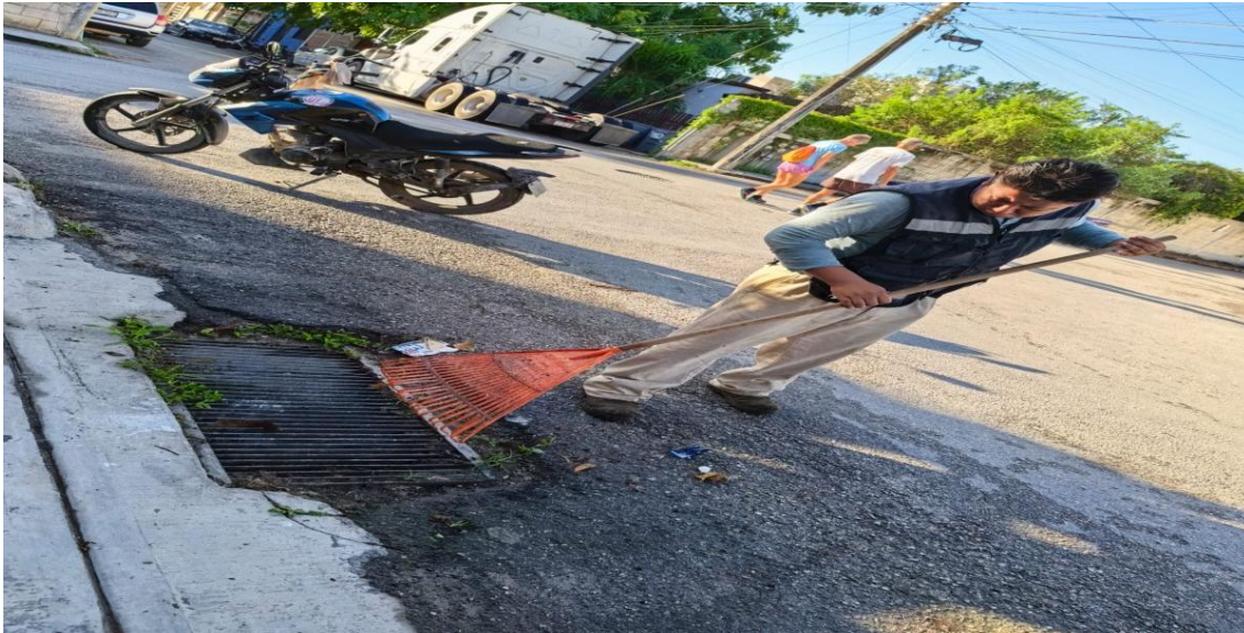
Limpieza de rejillas. Calle 11 entre calle 2 oriente; fraccionamiento guerra de castas.
