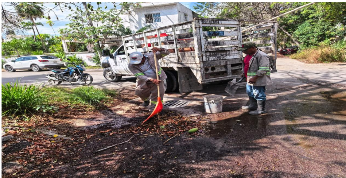
Limpieza de rejillas. Calle chan-caa entre calle chichen Itzá; colonia ejido.
