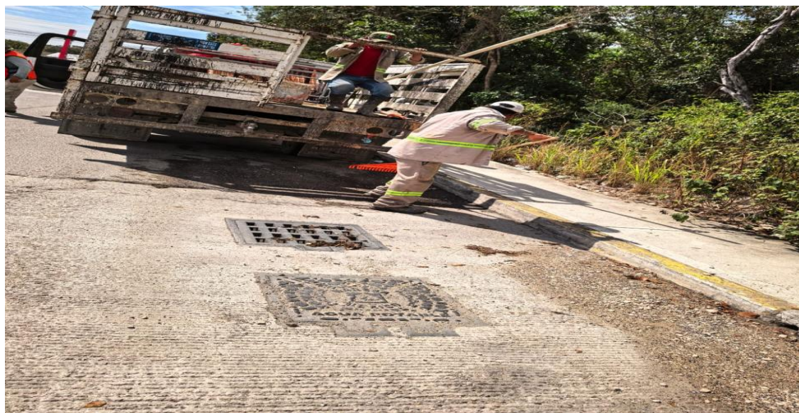
Limpieza de rejillas. Calle kohunlich entre calle akumal; colonia ejido.
