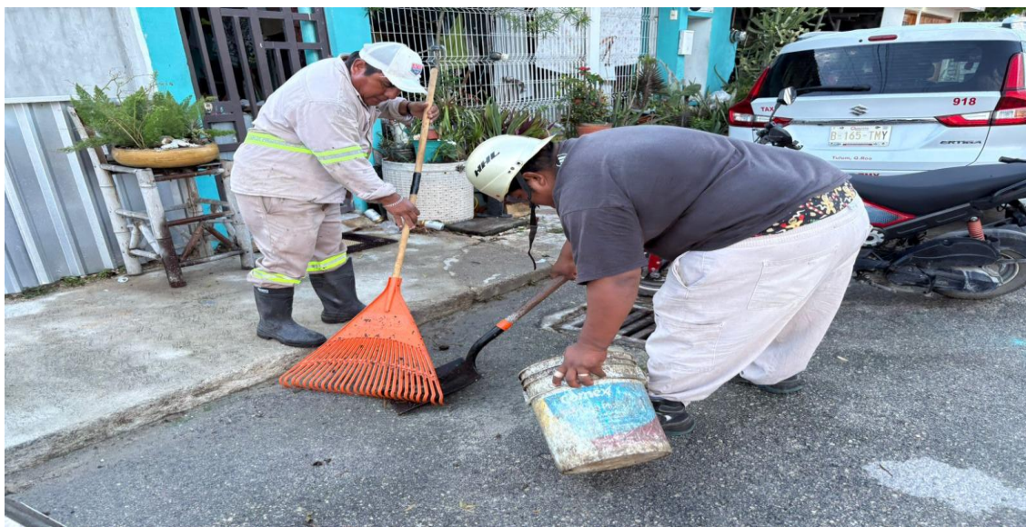
Limpieza de rejillas. Calle huracán irene; fraccionamiento huracanes.
