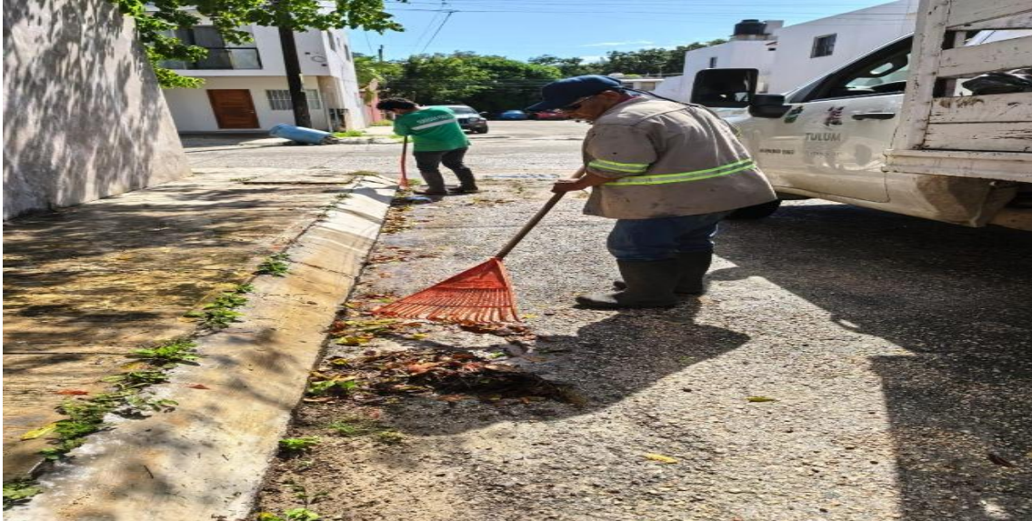
Limpieza de rejillas. Calle 7 sur entre calle 2 bis oriente; fraccionamiento villas Tulum.
