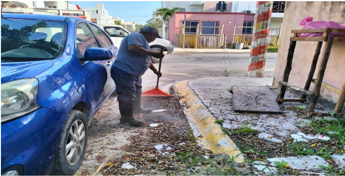
Limpieza de rejillas. Calle 12 entre calle 15; fraccionamiento villas Tulum.
