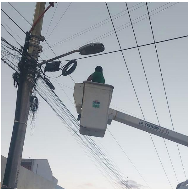
RECONEXIÓN DE LINEAS QUEMADAS Y CAMBIO DE FOTOCELDA OBSOLETA POR NUEVA; C. 11 ENTRE C. 12 Y C. 14, COL. LA VELETA.
