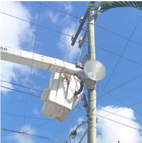
REPARACIÓN DE LÁMPARA TIPO SOL; POBLADO CHEMUYIL.
