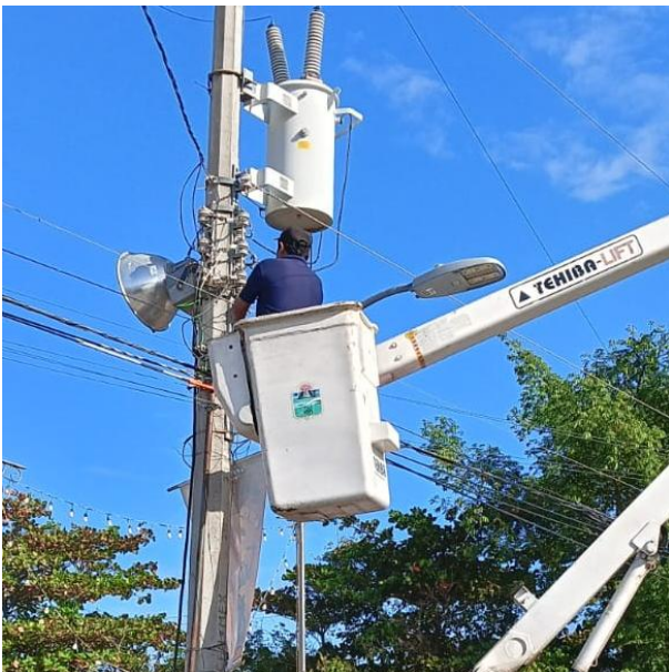
CAMBIO DE BRAZOS OBSOLETOS A LUMINARIAS Y REHABILITACIÓN DE LINEAS; C. CODORNICES ENTRE AV. SIAN-KAAN Y C. CHAN-CHEN, COL. EJIDO.
