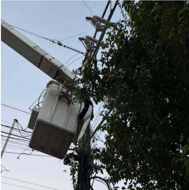
CAMBIO DE LUMINARIA OBSOLETA POR LED NUEVA; C. 2 OTE ENTRE C. OSIRIS NTE Y C. BETA NTE, COL. CENTRO.
