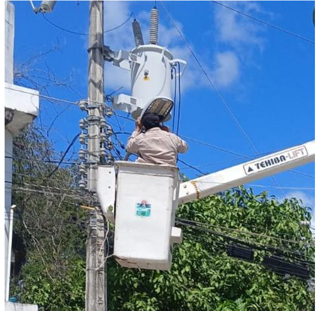
CAMBIO DE FOTOCELDA PARA HABILITAR SECTOR; AV. LA SELVA ENTRE C. TAURO, COL. EJIDO.
