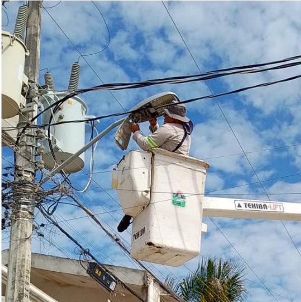
CAMBIO DE LUMINARIA OBSOLETA POR LED NUEVA; C. AKUMAL ENTRE C. CHEMUYIL Y C. CHICHENITZA, COL. EJIDO.
