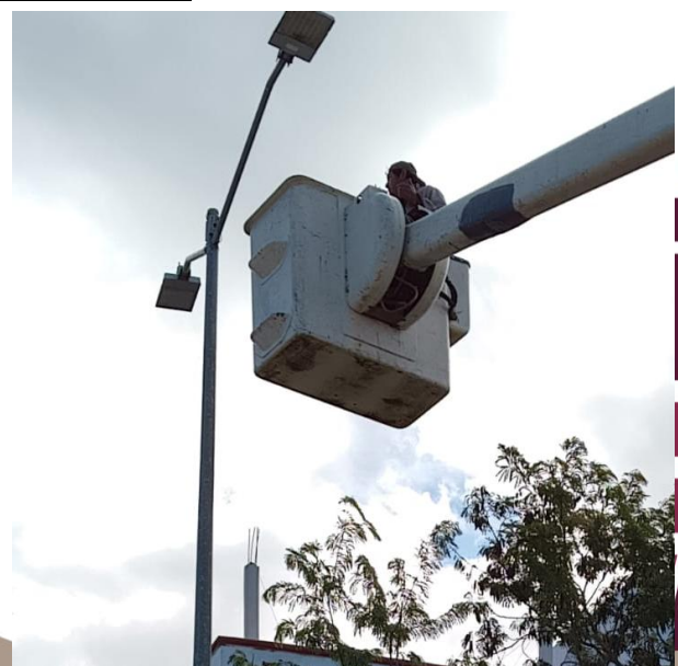
CAMBIO DE LUMINARIAS OBSOLETAS POR LED NUEVAS; AV. 18, COL. TUMBEN-KAA.
