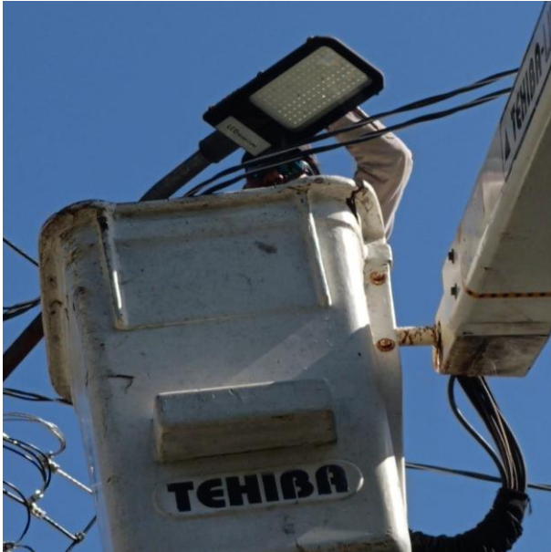
CAMBIO DE FOTOCELIDAS OBSOLETAS POR NUEVAS; PUNTA ALLEN.
