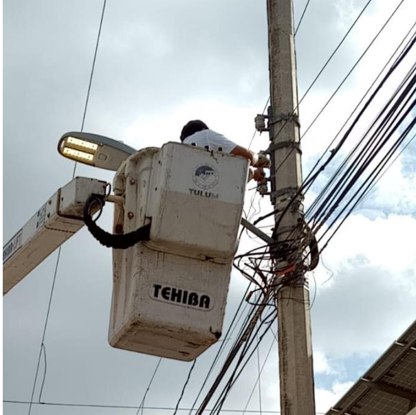
RECONEXIÓN DE ACOMETIDA PARA HABILITAR SECTOR; AV. OK-K'OT ENTRE C. BETA SUR Y C. ORIÓN SUR, COL. CENTRO.
