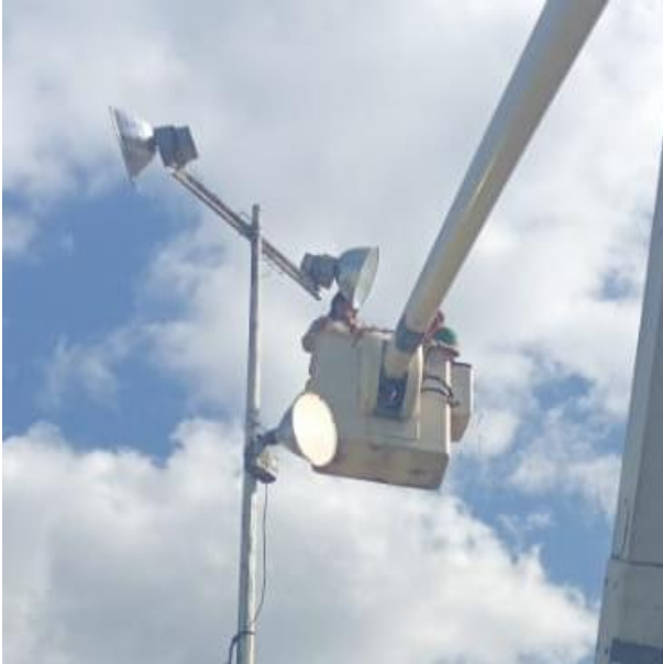
REPARACIÓN DE REFLECTORES OBSOLETOS; POBLADO MACARIO GÓMEZ.
