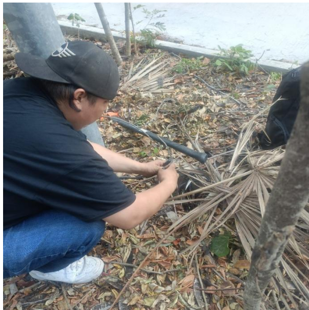
RECONEXIÓN DE LINEAS SUBTERRANEAS; C. YAX-CHILAN, FRACC. ALDEA ZAMA.
