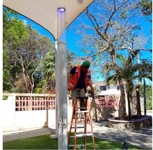
CAMBIO DE LÁMPARA OBSOLETA POR NUEVA; PARQUE, COL. TUMBEN-KAA.
