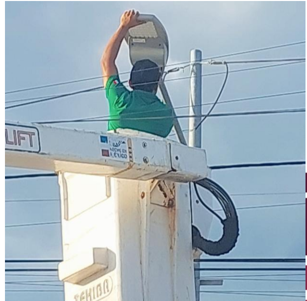
CAMBIO DE BRAZOS E INSTALACIÓN DE LUMINARIAS; AV. GONZALO GUERRERO, POBLADO AKUMAL.
