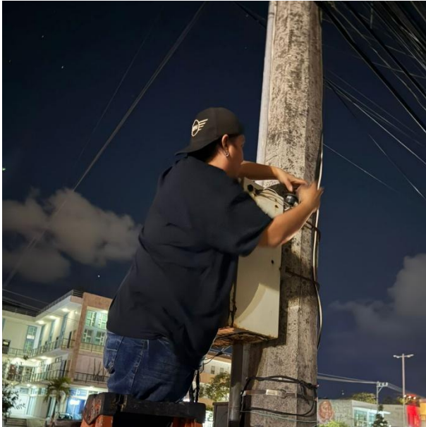
CAMBIO DE FOTOCELDA A SECTOR; AV. TULUM ENTRE C. LIBRA NTE Y C. GEMINIS, COL. CENTRO.
