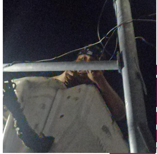
INSTALACIÓN DE LINEAS AEREAS PARA HABILITAR LUMINARIAS; C. BETA NTE ENTRE C. 2 OTE Y C. SAGITARIO OTE, COL. MAYAPAX.
