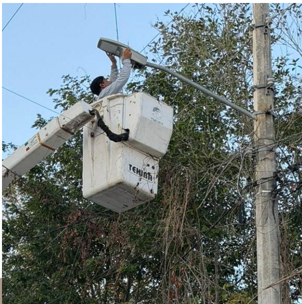
CAMBIO DE LUMINARIA OBSOLETA POR LED NUEVA Y CAMBIO DE LINEAS DEL BRAZO; C. PINO SUAREZ ENTRE C. COBA Y C. TZOLKIN, COL. LA VELETA.
