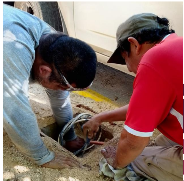
CAMBIO DE LINEAS SUBTERRANEAS REVENTADAS; C. ITZAMNA ENTRE AV. YAXCHE, FRACC. ALDEA ZAMA.
