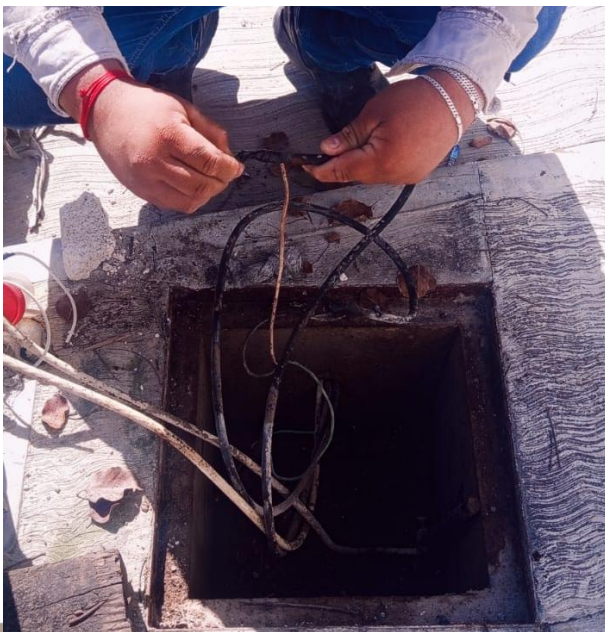
RECONEXIÓN DE LINEAS REVENTADAS PARA HABILITAR LUMINARIAS; FRACC XUL-KA.
