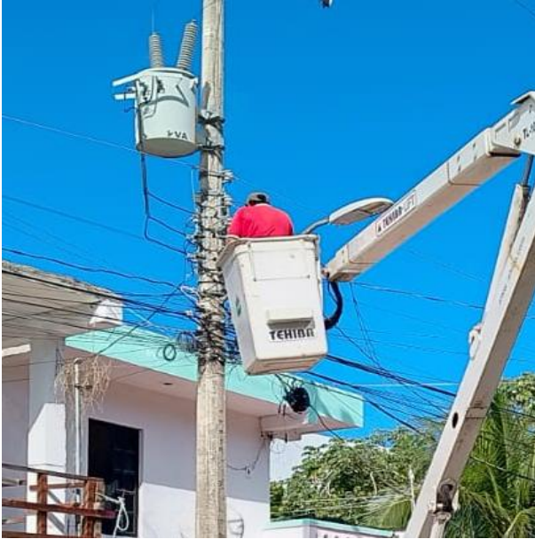
RECONEXIÓN DE LINEAS PARA HABILITAR LUMINARIA; C. 2 ENTRE C. 7 Y C. 11, COL. LA VELETA.
