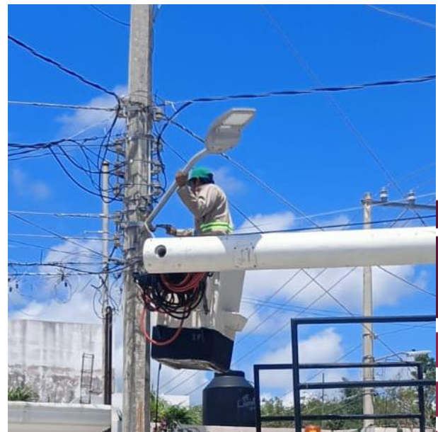
CAMBIO DE LUMINARIAS OBSOLETAS POR LED NUEVAS; FRACCIONAMIENTO CHAN- CHEMUYIL.
