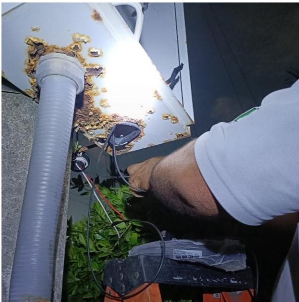
CAMBIO DE BASE DE FOTOCELDA Y SE INSTALAN SEPARADORES EN LINEAS; C. 2 OTE ENTRE C. 5 SUR Y C. 7 SUR, FRACC. VILLAS TULUM.
