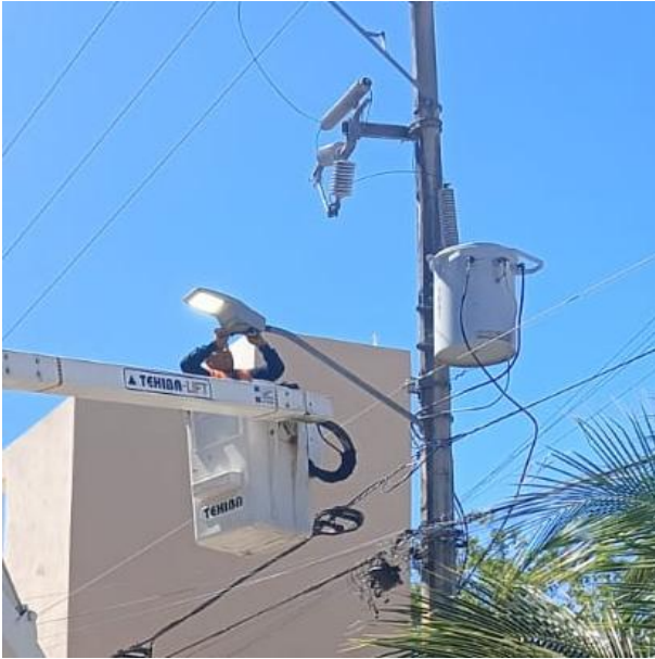
CAMBIO DE LUMINARIA OBSOLETA POR LED NUEVA; C. 19 ENTRE AV. 18, COL. TUMBEN-KAA.
