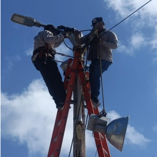
CAMBIO DE REFLECTORES OBSOLETOS POR NUEVOS Y CAMBIO DE LUMINARIA; PUNTA ALLEN.
