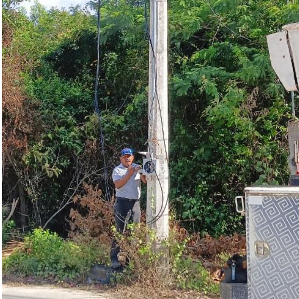
RECONEXIÓN DE ACOMETIDA PARA HABILITAR SECTOR; C. TAURO ENTRE C. XCARET Y C. ZACIL-HA, COL. EJIDO.
