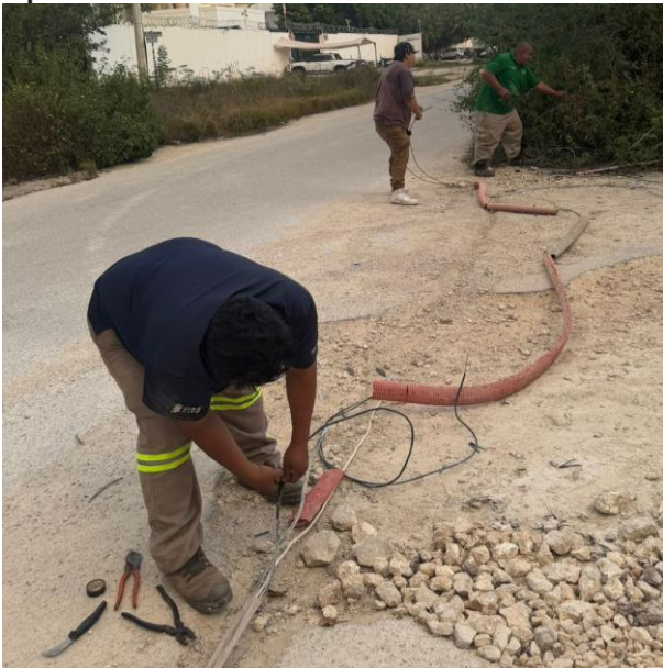
RECONEXIÓN DE LINEAS SUBTERRANEAS EN CORTO CIRCUITO; AV. 1 ENTRE C. RIO CALIENTE, COL. TUMBEN-KAA.
