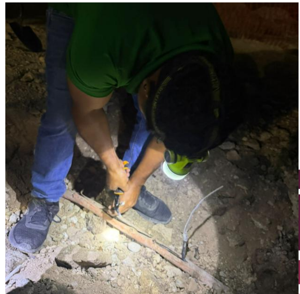
REHABILITACIÓN DE LINEAS SUBTERRANEAS REVENTADAS POR MAQUINARIA; C. LIRIO ENTRE C. MARGARITA Y C. AZUCENA, FRACC. YA'AX TULUM.
