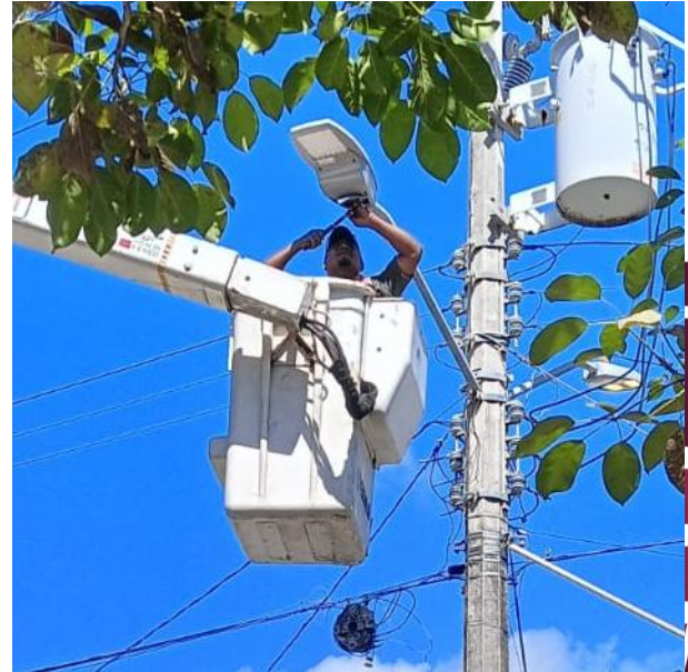
CAMBIO DE LUMINARIAS OBSOLETAS POR LED NUEVAS; FRACC. HURACANES.
