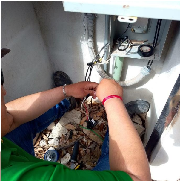
REPARACIÓN DE CORTO CIRCUITO; POBLADO COBA.
