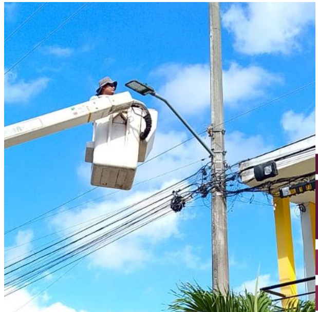
CAMBIO DE LUMINARIA OSBOELTA POR LED NUEVA; C. 21 ENTRE C. NAVAL, COL. TUMBEN-KAA.
