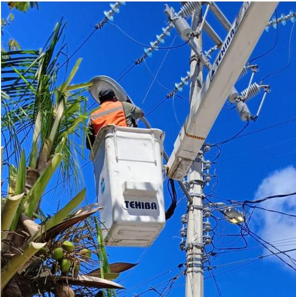
CAMBIO DE LUMINARIAS OBSOLETAS POR LED NUEVAS; FRACC. HURACANES.
