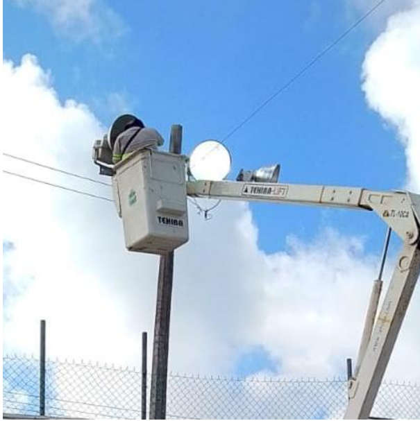
REPARACIÓN DE REFLECTORES; FRACC. HURACANES.
