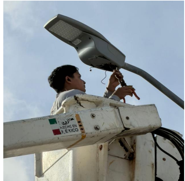
CAMBIO DE LUMINARIAS OBSOLETAS POR LED NUEVAS; COL. TUMBEN-KAA.
