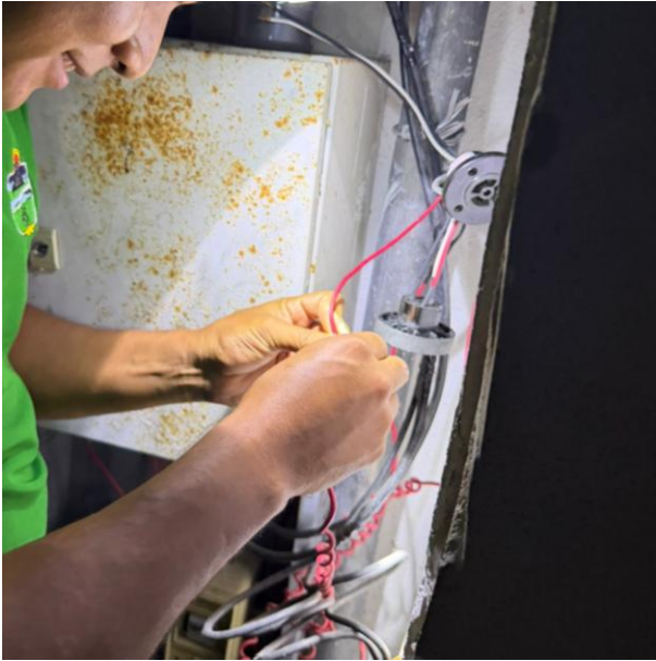
CAMBIO DE BASE DE FOTOCELDA PARA HABILITAR SECTOR; FRACC. ALDEA ZAMA.
