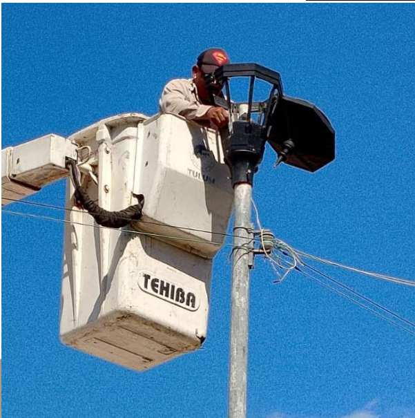
REPARACIÓN DE LUMINARIAS HACIENDO CAMBIO DE MATERIAL OBSOLETO POR NUEVO; POBLADO CHAN-CHEN 1.
