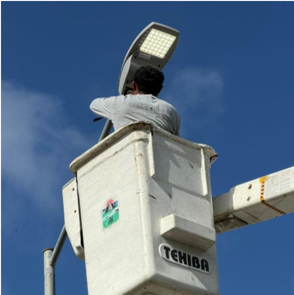
CAMBIO DE LUMINARIAS OBSOLETAS POR LED NUEVAS; COL. TUMBEN-KAA.
