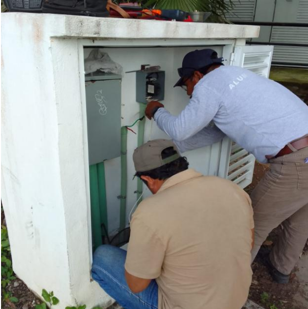
CAMBIO DE CONTACTOR OBSOLETO A SECTOR DE A.P; UNIDAD DEPORTIVA, COL. CENTRO.
