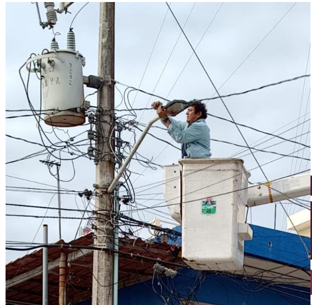
CAMBIO DE LÁMPARAS OBSOLETAS POR LED NUEVAS; POBLADO AKUMAL.
