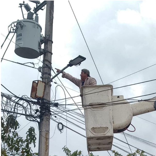
CAMBIO DE LUMINARIAS OBSOLETAS POR LED NUEVAS; POBLADO AKUMAL.
