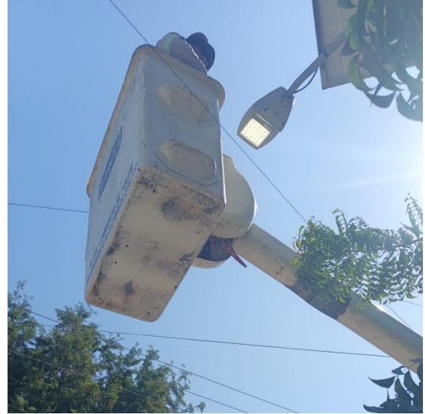
CAMBIO DE FOTOCELDA OBSOLETA POR NUEVA A LUMINARIA; C. OSIRIS NTE ENTRE C. 2 Y C. SAGITARIO PTE, COL. CENTRO.
