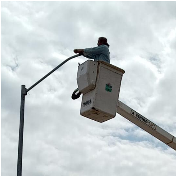
CAMBIO DE LÁMPARAS OBSOLETAS POR LED NUEVAS; POBLADO AKUMAL.
