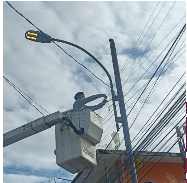
RECONEXIÓN DE LINEAS AEREAS PARA HABILITAR LUMINARIAS; C. ALFA SUR ENTRE AV. TULUM Y C. GAMA OTE, COL. CENTRO.
