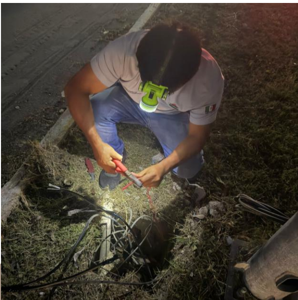
RECONEXIÓN DE LINEAS PARA HABILITAR LÁMPARAS SULFATADAS; AV. TULUM ENTRE AV. COBA, COL. CENTRO.
