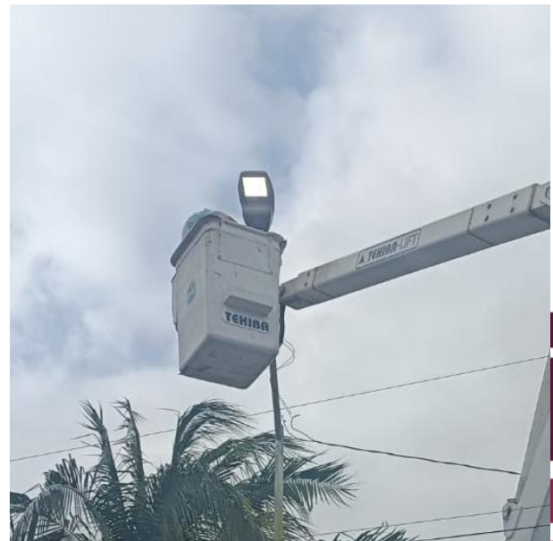
CAMBIO DE LUMINARIA OBSOLETA POR LED NUEVA; C. FAISAN ENTRE AV. 18 Y C. 12, COL. TUMBEN-KAA.
