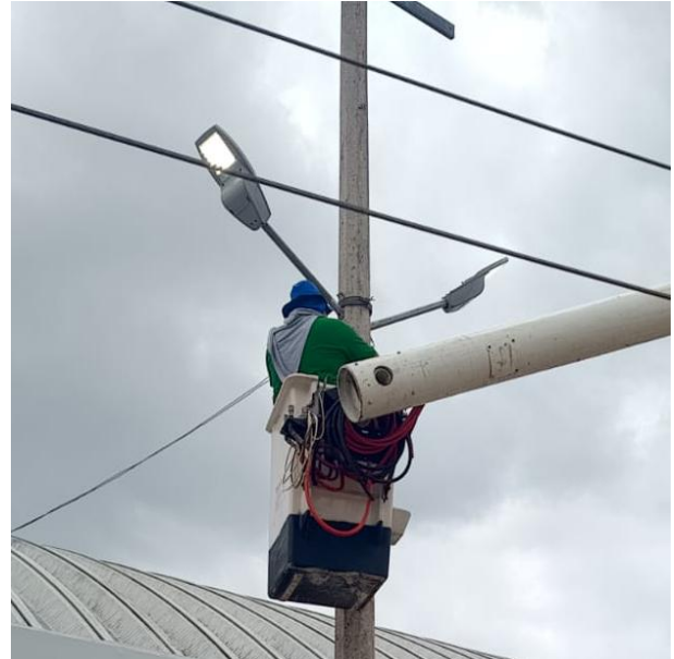
CAMBIO DE LUMINARIAS OBSOLETAS POR LED NUEVOS; POBLADO COBA.
