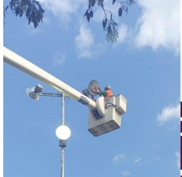
REPARACIÓN DE REFLECTORES OBSOLETOS; POBLADO MACARIO GÓMEZ.
