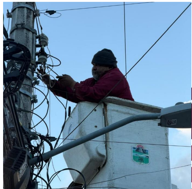
REPARACIÓN DE CORTO CIRCUITO EN LINEAS AEREAS; AV. OK-K'OT ENTRE C. ORIÓN NTE Y C. CENTAURO NTE, COL. MAYA-PAX.
