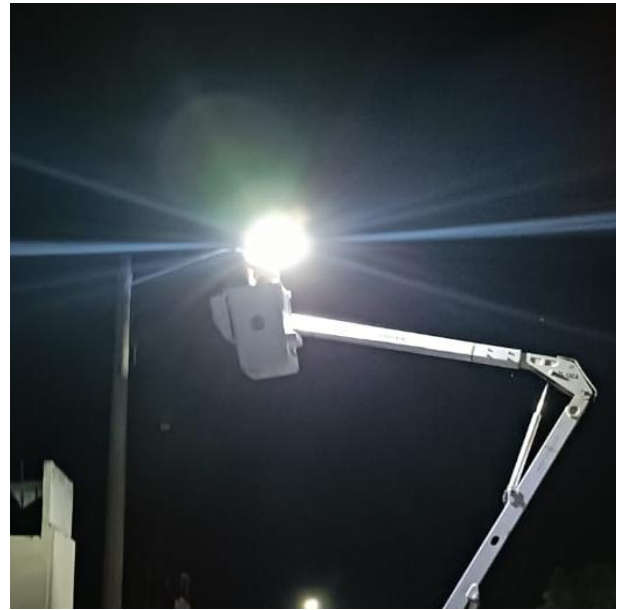
CAMBIO DE LUMINARIA OBSOLETA POR LED NUEVA; C. GUINEA ENTRE C. RAPIS, FRACC. PALMAS.
