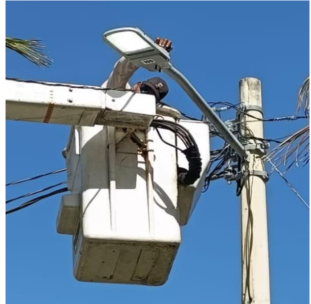
CAMBIO DE FOTOCELIDAS OBSOLETAS POR NUEVAS; PUNTA ALLEN.
