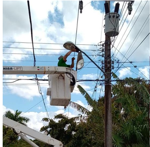
CAMBIO DE BASE DE FOTOCELDA, FOTOCELDA Y REHABILITACIÓN DE LINEAS EN EL CENTRO DE CARGA; POBLADO COBA.
