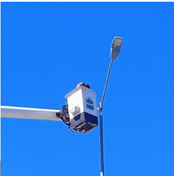
CAMBIO DE LUMINARIAS OBSOLETAS POR LED NUEVAS; AV. TULUM Y CASETA DE POLICIAS.
