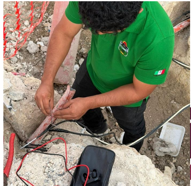
REHABILITACIÓN DE LINEAS PARA HABILITAR LUMINARIA; AV. 2 NTE ENTRE C. TULIPAN Y C. ALCATRAZ, FRACC. YA'AX TULUM.
