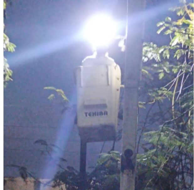
CAMBIO DE LUMINARIAS OBSOLETAS POR LED NUEVAS; AV. TULUM ENTRE C. ANDROMEDA Y C. SOL OTE, COL. CENTRO.
