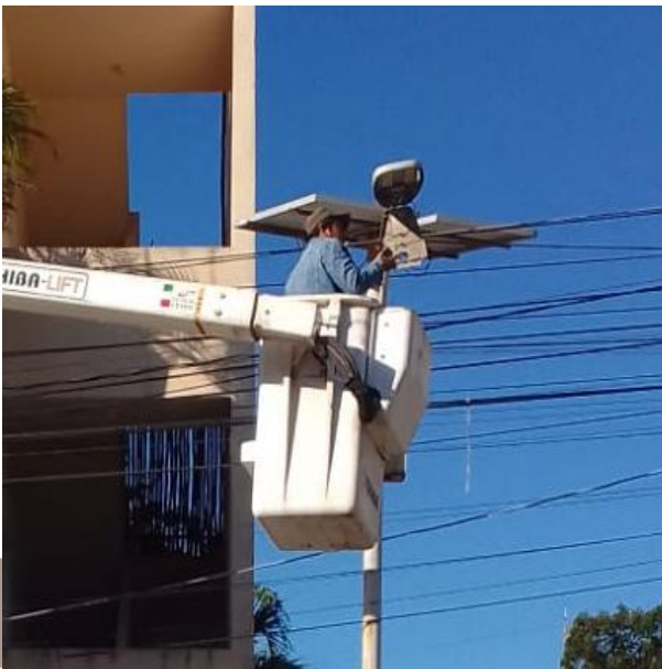
RECONEXIÓN DE LINEAS AEREAS Y CAMBIO DE FOTOCELDAS PARA HABILITAR LUMINARIAS; C. 7 ENTRE C. PALENQUE, COL. LA VELETA.
