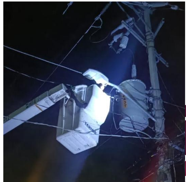
CAMBIO DE LUMINARIA OSBOLETA POR LED NUEVA; C. RIO LA ESCARLATA ENTRE C. RIO BASCA Y AV. LA SELVA, COL. TUMBEN-KAA.
