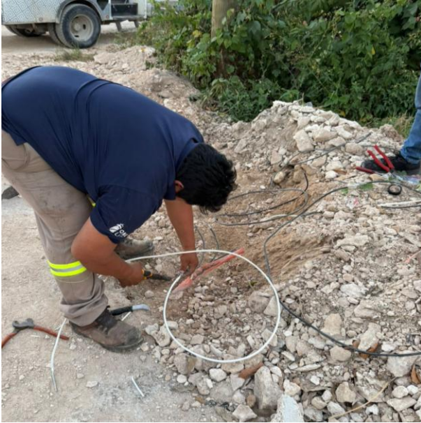
RECONEXIÓN DE LINEAS REVENTADAS POR MAQUINARIA; C. AZUCENA ENTRE C. CLAVEL Y C. TULIPAN, FRACC. YA'AX TULUM.
