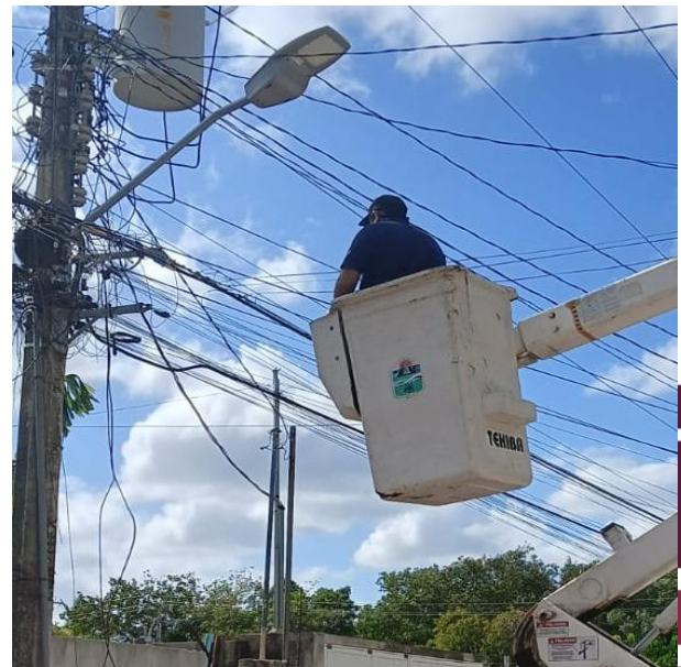
REHABILITACIÓN DE LÍNEAS AÉREAS PARA HABILITAR LUMINARIAS; C. KUKULKAN ENTRE C. GALLINOLAS Y C. CODORNICES, COL. EJIDO.
