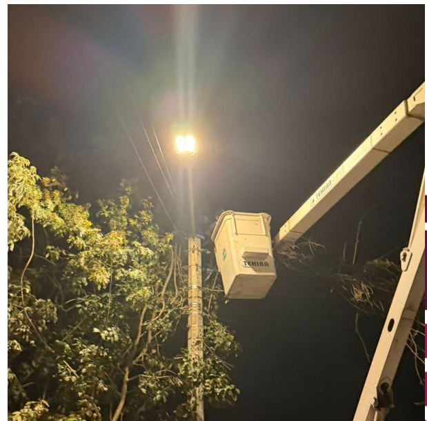
RECONEXIÓN E INSTALACIÓN DE LINEAS AEREAS; C. GAVILANES ENTRE AV. LA SELVA Y C. SIAN-KAA, COL. EJIDO.
