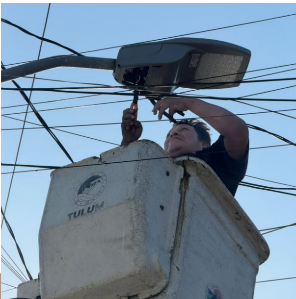
CAMBIO DE LUMINARIA OBSOLETA POR LED NUEVO; C. ONTARIO ENTRE AV. KUKULKAN, COL. CENTRO.
