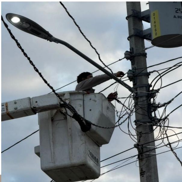
CAMBIO DE LUMINARIA OBSOLETA POR LED NUEVA; C. 2 BIS, COL. CRISTAL.
