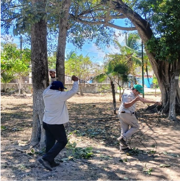
INSTALACIÓN Y RECONEXIÓN DE LINEAS AEREAS REVENTADAS; FRACC. HUARCANES.
