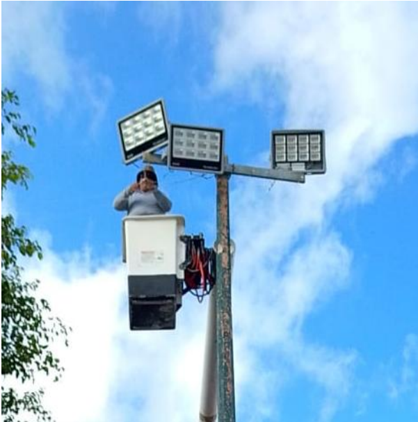
REPARACIÓN DE REFLECTORES HACIENDO RECONEXIÓN PARA HABILITARLOS; CANCHA MAYA.
