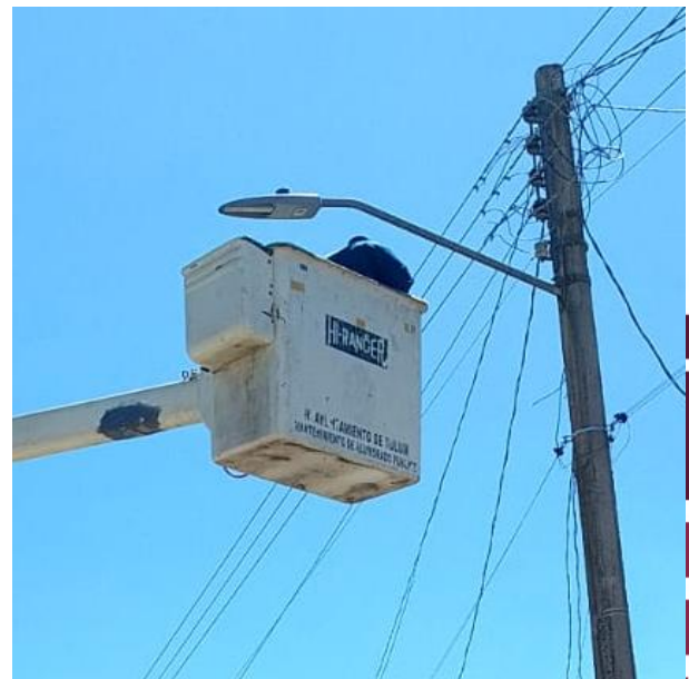
CAMBIO DE LUMINARIAS OBSOLETAS POR LED NUEVAS; POBLADO MACARIO GÓMEZ
