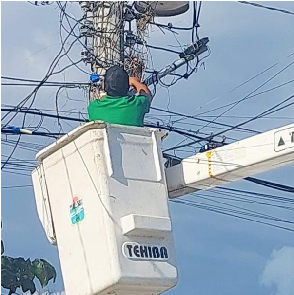
CAMBIO DE BRAZOS E INSTALACIÓN DE LUMINARIAS; AV. GONZALO GUERRERO, POBLADO AKUMAL.
