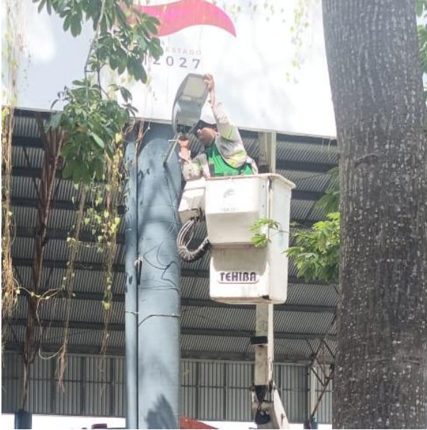
CAMBIO DE LUMINARIAS OBSOLETAS POR LED NUEVAS; POBLADO CHEMUYIL.
