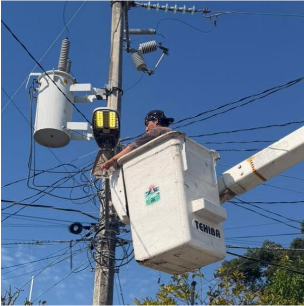
RECONEXIÓN DE LINEAS SULFATADAS; C. CHUN-YAXCHE ENTRE C. TAURO Y C. ZACIL-HA, COL. EJIDO.
