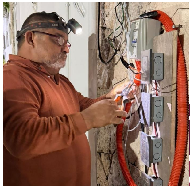
REHABILITACIÓN DE LINEAS SULFATADAS; AV. TULUM ENTRE AV. OSIRIS SUR Y C. ALFA SUR, COL. CENTRO.
