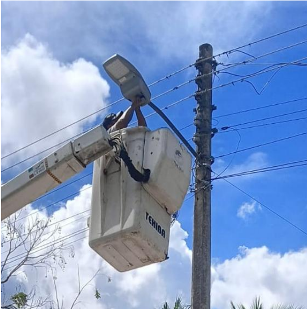
CAMBIO DE LUMINARIAS OBSOLETAS POR LED NUEVAS; POBLADO MANUEL ANTONIO AY.
