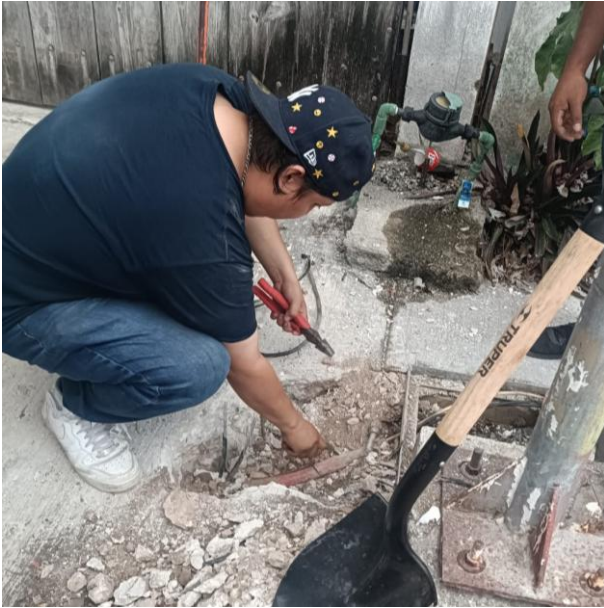
RECONEXIÓN DE LINEAS SUBTERRANEAS; C. FAISAN ENTRE AV. 18 Y C. 12, COL. TUMBEN-KAA.
