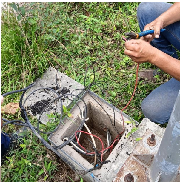
REHABILITACIÓN DE LINEAS SUBTERRANEAS PARA HABILITAR LUMINARIAS; C. TEPEZCUINTLE ENTRE AV. 2, COL. TUMBEN-KAA.
