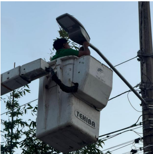
CAMBIO DE LUMINARIAS OBSOLETAS POR LED NUEVAS; C. 32 ENTRE C. 34 Y C. 36, COL. TUMBEN-KAA.
