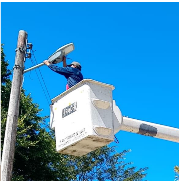
CAMBIO DE LUMINARIAS OBSOLETAS POR LED NUEVAS; POBLADO MACARIO GÓMEZ
