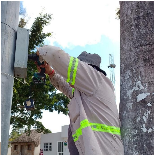
CAMBIO DE BREAK QUEMADO POR NUEVO; POBLADO SAN JUAN DE DIOS.
