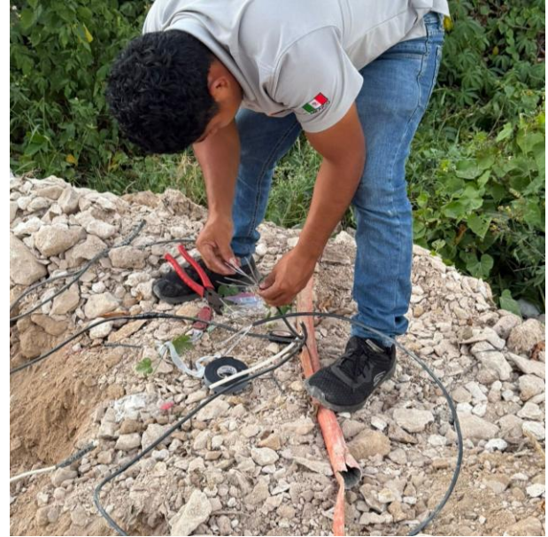
RECONEXIÓN DE LINEAS REVENTADAS POR MAQUINARIA; C. AZUCENA ENTRE C. CLAVEL Y C. TULIPAN, FRACC. YA'AX TULUM.
