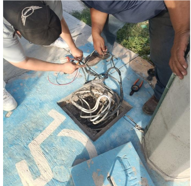
REHABILITACIÓN DE LINEAS SULFATADAS PARA HABILITAR LUMINARIAS; C. 19 ENTRE C. 24 Y C. 20, COL. TUMBEN-KAA.
