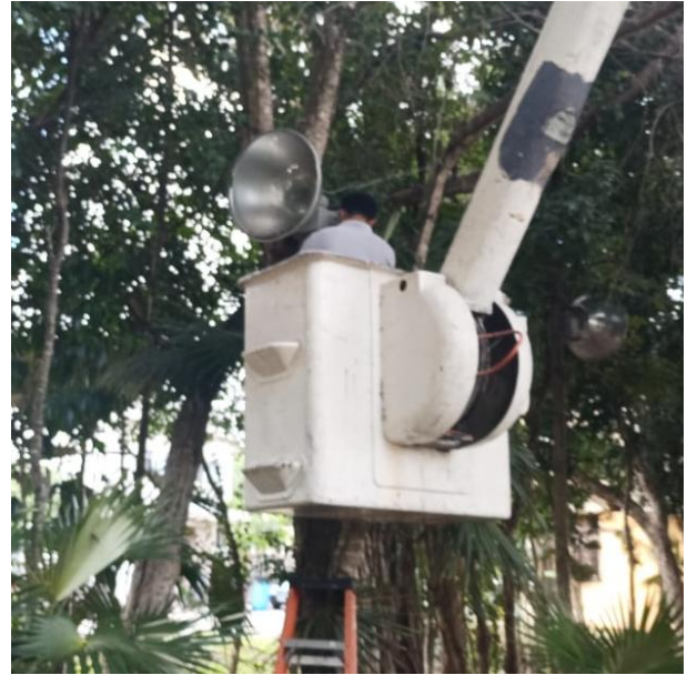
CAMBIO COMPLETO DE MATERIAL OBSOLETO POR NUEVO A REFLECTOR CIRCULAR Y RECONEXIÓN DE LINEAS SULFATADAS; C. 2 OTE ENTRE C. ESCORPIÓN Y C. LIBRA NTE, COL. GUERRA DE CASTAS.
