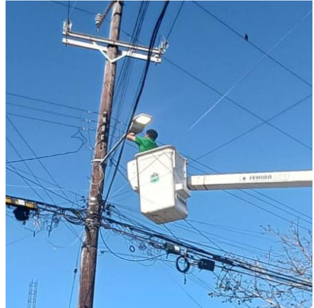
CAMBIO DE LUMINARIA OBSOLETA POR NUEVA Y CAMBIO DE FOTOCELDA Y BASE DE FOTOCELDA; C. PUMA ENTRE C. OROPENDULA Y C. RUISEÑOR, POBLADO CHEMUYIL.
