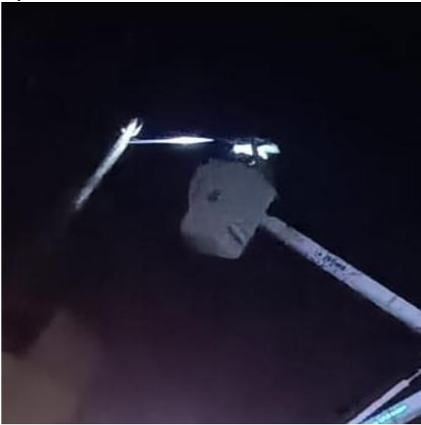
CAMBIO DE LUMINARIA OBSOLETA POR LED NUEVA; C. GUINEA ENTRE C. RAPIS, FRACC. PALMAS.
