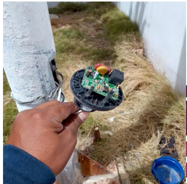
CAMBIO DE FOTOCELDA PARA HABILITAR LUMINARIA; AV. 1 ENTRE AV. LA SELVA, COL. TUMBEN-KAA.
