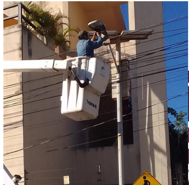
RECONEXIÓN DE LINEAS AEREAS Y CAMBIO DE FOTOCELDAS PARA HABILITAR LUMINARIAS; C. 7 ENTRE C. PALENQUE, COL. LA VELETA.
