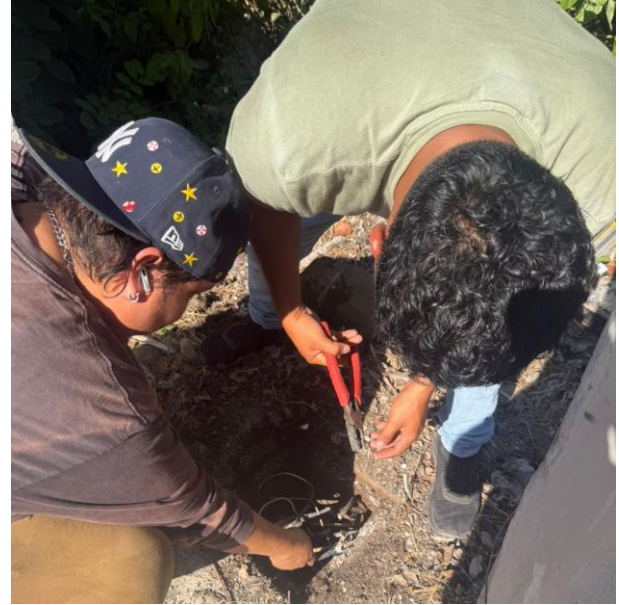
RECONEXIÓN DE LINEAS SUBTERRANEAS PARA HABILITAR LUMINARIAS; C. 19 ENTRE C. NAVAL Y C. 12, COL. TUMBENKAA.
