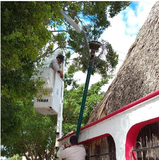
REPARACIÓN DE LUMINARIA; CANCHA MAYA, COL. CENTRO.
