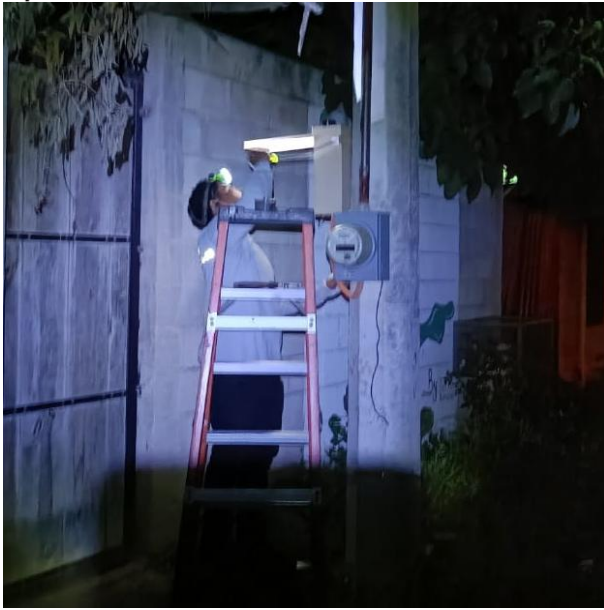
CAMBIO DE FOTOCELDA OBSOLETA POR NUEVO PARA HABILITAR SECTOR; AV. KUKULKAN ENTRE C. GOLONDRINAS Y C. GAVILANES, COL. EJIDO.
