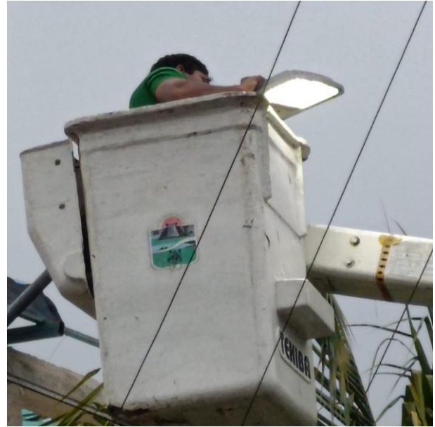
CAMBIO DE LUMINARIAS OSBOLETAS POR LED NUEVAS Y RECONEXIÓN DE LINEAS SUBTERRANEAS; C. FAISAN ENTRE AV. LA SELVA Y AV. 18, COL. TUMBEN-KAA.
