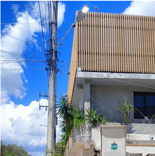
INSTALACIÓN DE LUMINARIA PARA ILUMINAR ZONA, C. 12 ENTRE C. 23, COL. TUMBEN-KAA.
