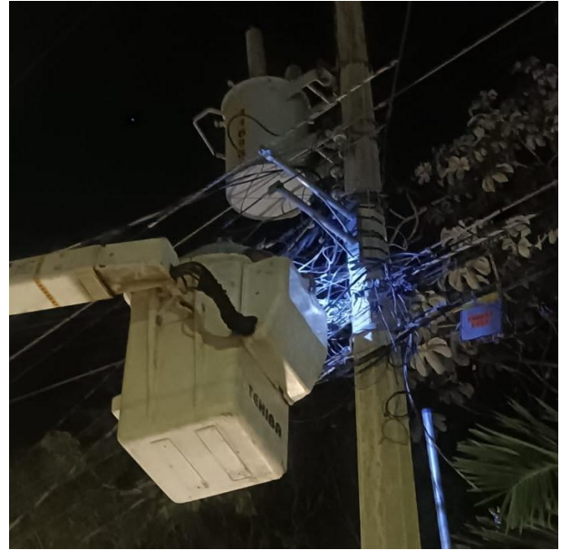
REHABILITACIÓN DE LINEAS AEREAS PARA HABILITAR SECTOR; C. PALENQUE ENTRE C. 11, COL. LA VELETA.
