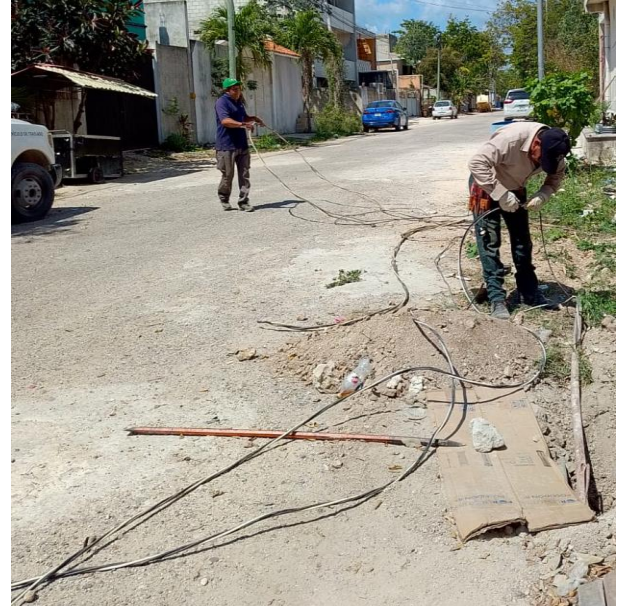
CAMBIO DE LINEAS SUBTERRANEAS DAÑADAS POR NUEVAS PARA HABILITAR LUMINARIAS; C. 12 ENTRE C. 23 Y C. NAVAL, COL. TUMBEN-KAA.
