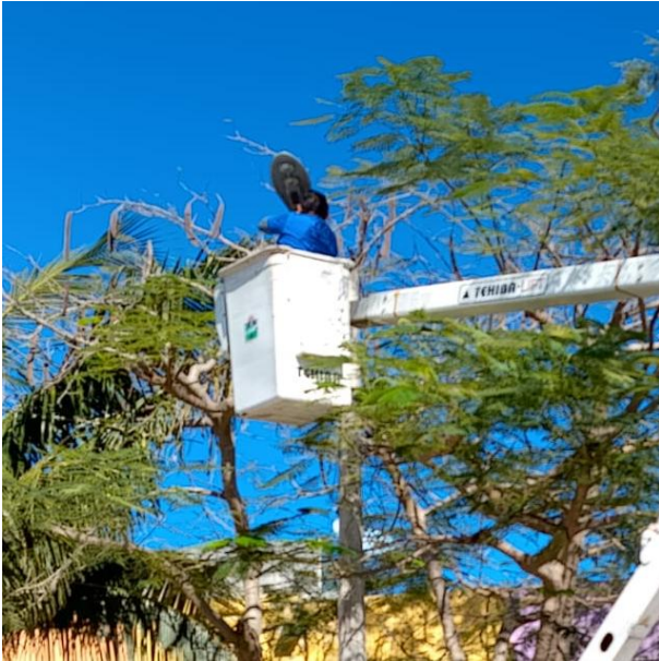
CAMBIO DE LUMINARIAS OBSOLETAS POR LED NUEVAS; FRACC. PALMAS.
