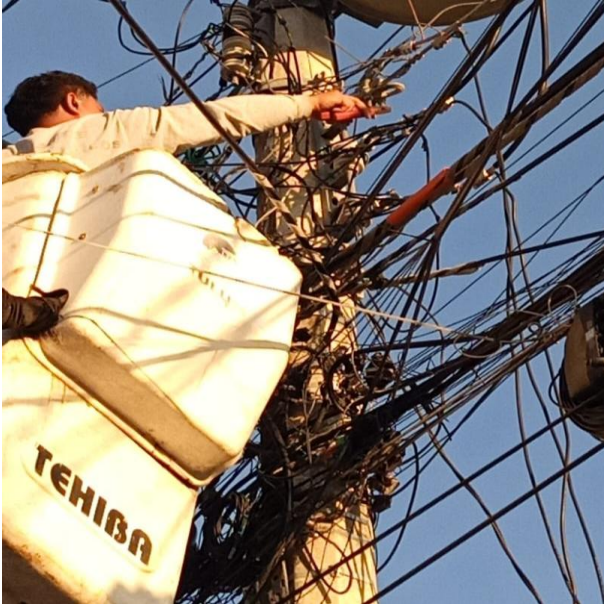
RECONEXIÓN DE LINEAS REVENTADAS Y CAMBIO DE FOTOCELDA; C. VENADO ENTRE C. CHAN-CHEN Y AV. KUKULKAN, COL. EJIDO.
