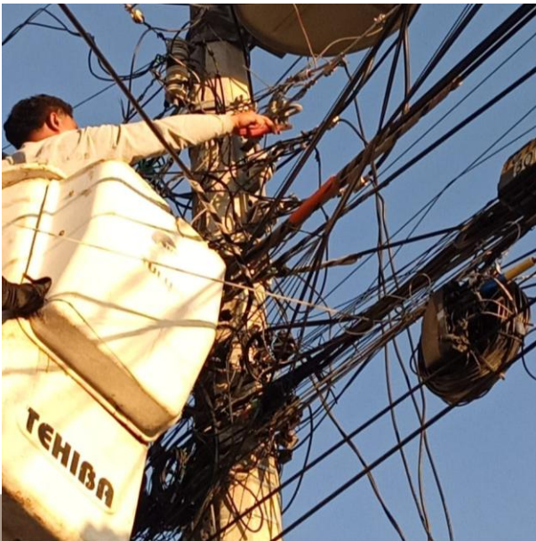
RECONEXIÓN DE LINEA REVENTADA PARA HABILITAR LUMINARIA; C. RIO PLAYON ENTRE C. RIO OTATE, COL. TUMBEN-KAA.
