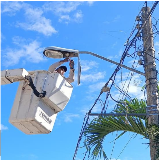
REPARACIÓN DE LUMINARIAS HACIENDO CAMBIO DE MATERIALES OSBOLETOS POR NUEVOS; POBLADO COBA.
