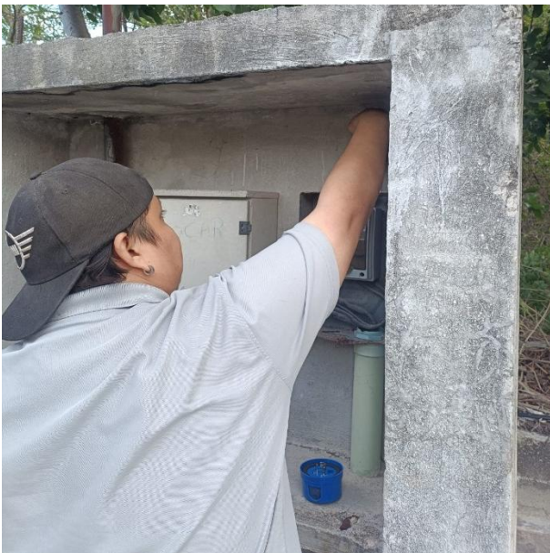
RECONEXIÓN DE ACOMETIDA PARA HABILITAR SECTOR Y CAMBIO DE FOTOCELDA; POBLADO AKUMAL.
