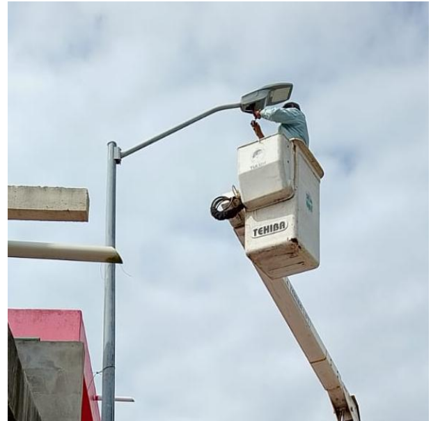
INSTALACIÓN DE LUMINARIAS LED CON BRAZOS; POBLADO AKUMAL.
