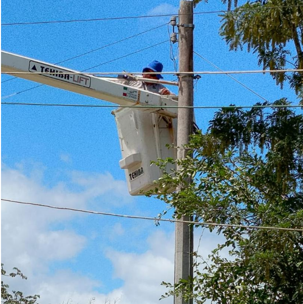
REHABILITACIÓN DE LINEAS AEREAS PARA HABILITAR LUMINARIAS; POBLADO MANUEL ANTONIO AY.
