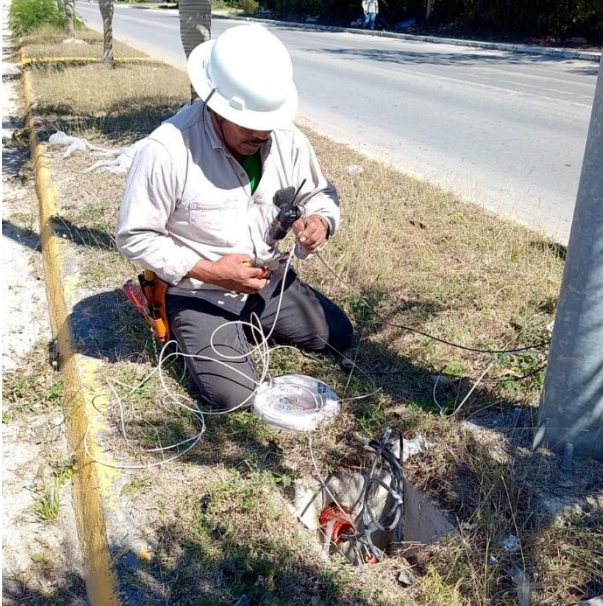
REPARACIÓN DE CORTO CIRCUITO; AV. TULUM ENTRE Y CASETA DE POLICIAS.
