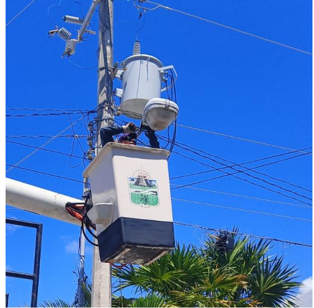
REPARACIÓN DE LUMINARIAS; FRACCIONAMIENTO CHAN- CHEMUYIL.
