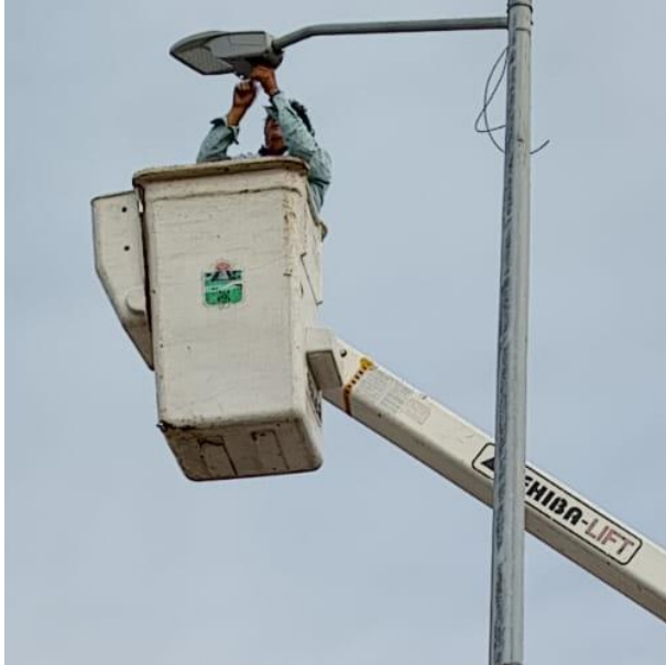
INSTALACIÓN DE LUMINARIAS LED CON BRAZOS; POBLADO AKUMAL.
