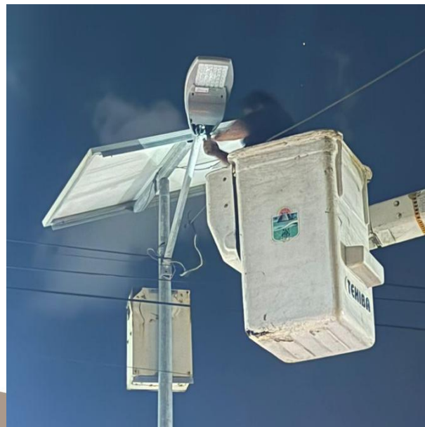
CAMBIO DE LUMINARIA OBSOLETA POR LED NUEVA; C. ALFA SUR ENTRE C. VENUS OTE Y C. NEPTUNO OTE, COL. CENTRO.
