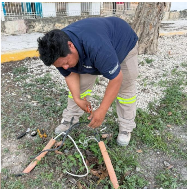
RECONEXIÓN DE LINEAS SULFATADAS PARA HABILITAR LUMINARIA; C. KITAM ENTRE C. CHA'AB Y C. 5 AV BIS NTE, FRACC. XUL-KAA.
