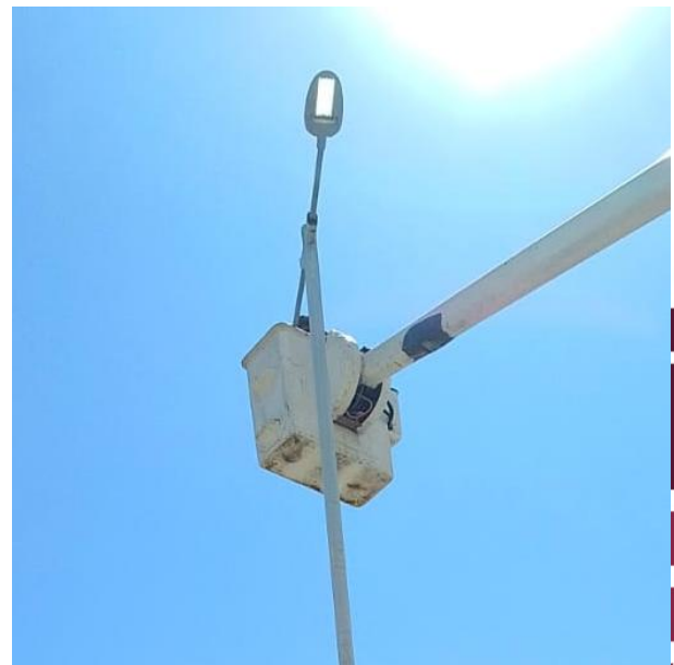
CAMBIO DE LUMINARIAS OBSOLETAS POR LED NUEVAS; AV. TULUM ENTRE AV. SATÉLITE Y C. ACUARIO, COL. CENTRO.
