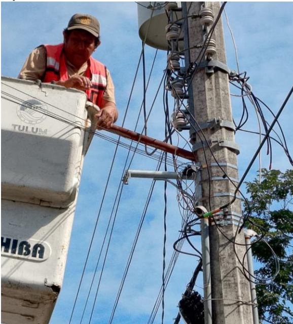
CAMBIO DE FOTOCELDA QUEMADA PARA HABILITAR LUMINARIA; AV. OSIRIS SUR ENTRE C. SOL OTE Y C. BETA OTE, COL. CENTRO.
