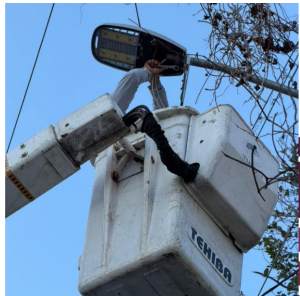
CAMBIO DE LUMINARIA OBSOLETA POR LED NUEVA Y CAMBIO DE LINEAS DEL BRAZO; C. PINO SUAREZ ENTRE C. COBA Y C. TZOLKIN, COL. LA VELETA.
