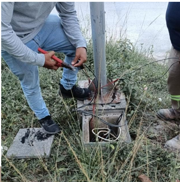
RECONEXIÓN DE LINEAS SUBTERRANEAS REVENTADAS PARA HABILITAR LUMIANRIAS; AV. 2 ENTRE C. 27 Y C. TEPEZCUINTLE, COL. TUMBEN-KAA.
