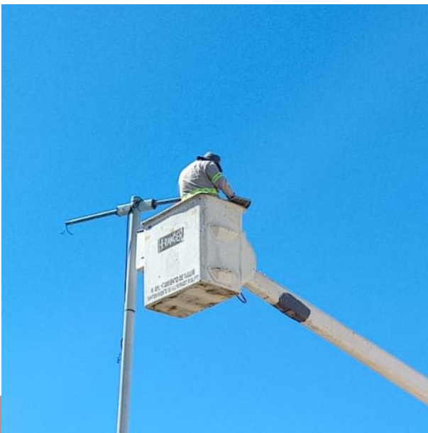
CAMBIO DE LUMINARIAS OBSOLETAS POR LED NUEVAS; AV. TULUM ENTRE AV. SATÉLITE Y C. ACUARIO, COL. CENTRO.
