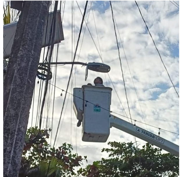
CAMBIO DE LUMINARIA OBSOLETA POR LED NUEVA; C. SOL OTE ENTRE C. CENTAURO SUR Y C. ORIÓN SUR, COL. CENTRO.
