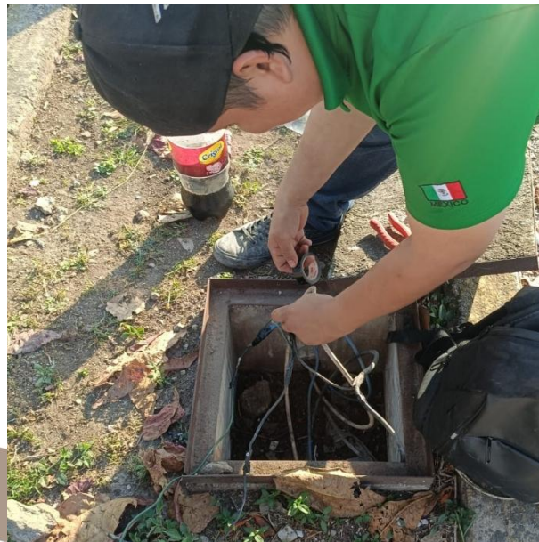
CAMBIO DE LINEAS SUBTERRANEAS DAÑADAS PARA HABILITAR SECTOR; POBLADO COBA.
