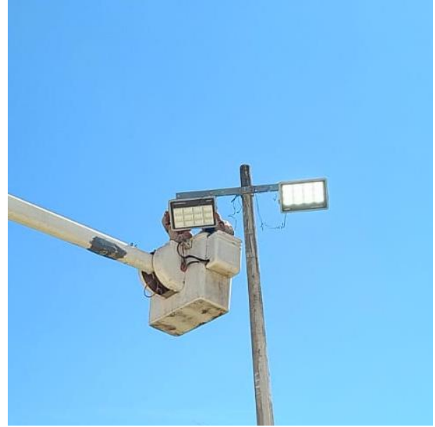
CAMBIO DE LÁMPARAS OBSOLETAS POR NUEVAS; CAMPO DE BEISBOL, POBLADO AKUMAL.
