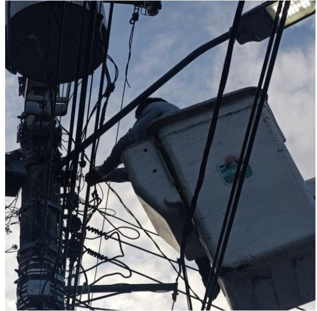
CAMBIO DE LINEAS AEREAS OBSOLETAS POR NUEVAS PARA HABILITAR LUMINARIAS; C. SOL OTE ENTRE AV. OSIRIS SUR Y C. ALFA SUR, COL. CENTRO.
