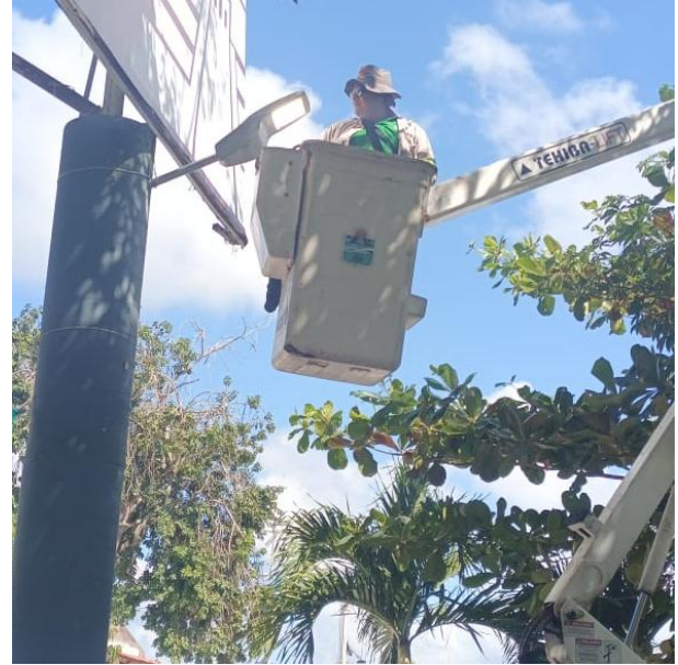
CAMBIO DE LUMINARIAS OBSOLETAS POR LED NUEVAS; POBLADO CHEMUYIL.
