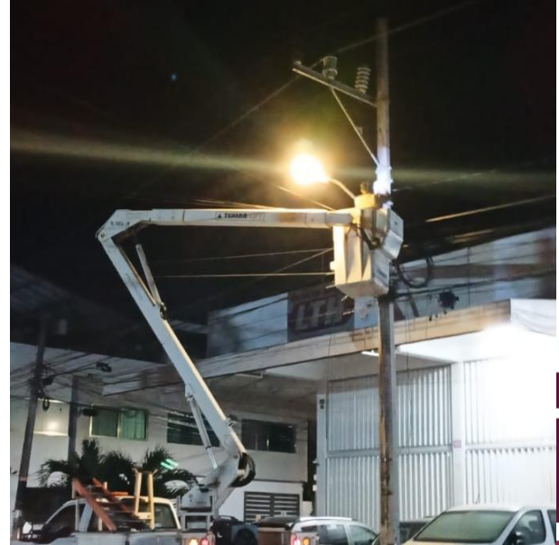
REHABILITACIÓN DE LINEAS SULFATADAS PARA HABILITAR LUMINARIA; C. OK-K'OT ENTRE C. ALFA NTE Y C. OMEGA NTE, COL. MAYAPAX.
