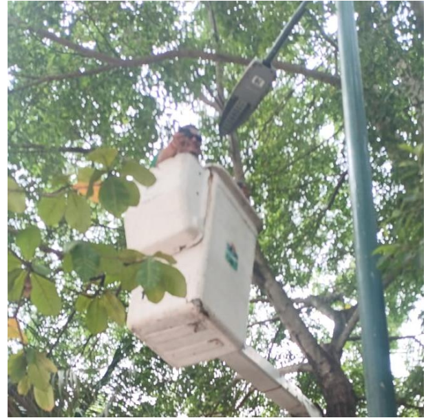
CAMBIO DE LUMINARIA OBSOLETA POR LED NUEVA; PARQUE ROTARIO.
