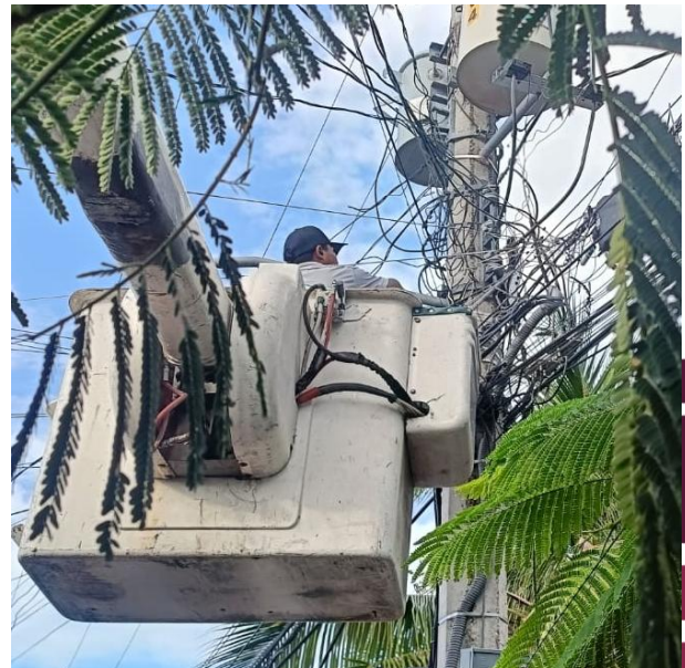
RECONEXIÓN DE LINEAS SULFATADAS PARA HABILITAR LUMINARIAS; C. ALFA SUR ENTRE AV. TULUM Y C. SOL OTE, COL. CENTRO.
