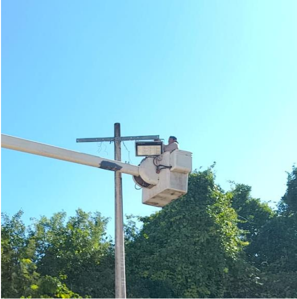
CAMBIO DE LÁMPARAS OBSOLETAS POR NUEVAS; CAMPO DE BEISBOL, POBLADO AKUMAL.
