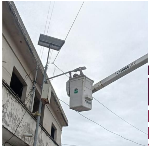
CAMBIO DE LUMINARIA OBSOLETA POR LED NUEVA; C. ALFA SUR ENTRE C. GAMA OTE Y C. MERCURIO PTE, COL. CENTRO.
