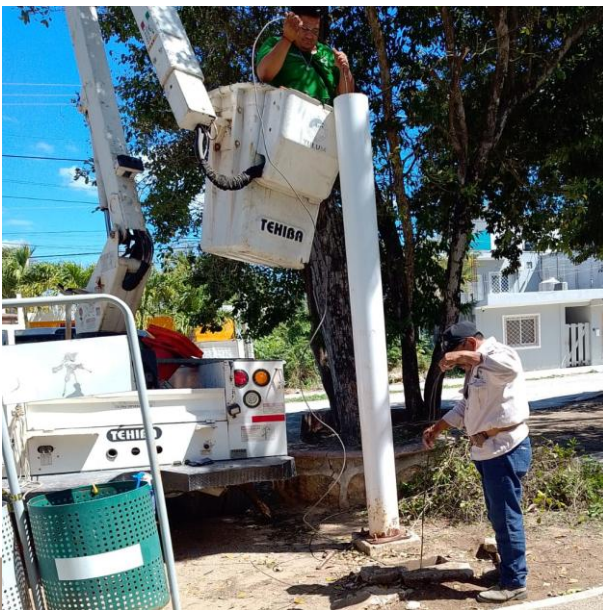
CAMBIO DE LINEAS A POSTE POR CORTO CIRCUITO; PARQUE, COL. TUMBEN-KAA.
