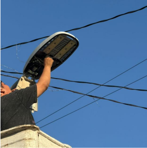
REPOSICIÓN Y RECONEXIÓN DE LUMINARIA; C. 5 SUR ENTRE C. 6, COL. LA VELETA.
