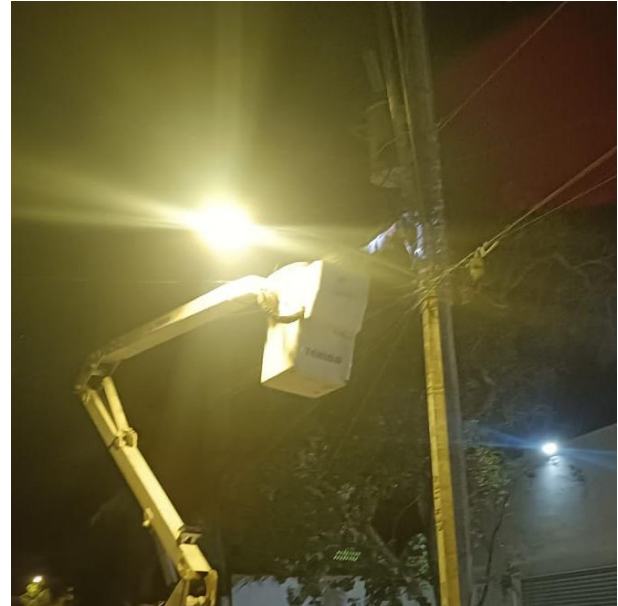
RECONEXIÓN DE LUMINARIAS; C. JABALI ENTRE AV. LA SELVA Y C. CHUN-YAXCHE, COL. EJIDO.
