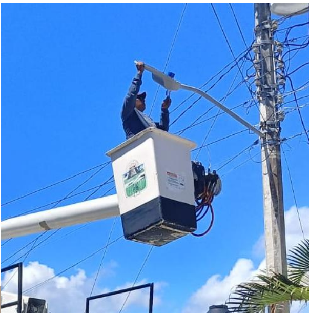
CAMBIO DE LUMINARIAS OBSOLETAS POR LED NUEVAS; FRACCIONAMIENTO CHAN- CHEMUYIL.
