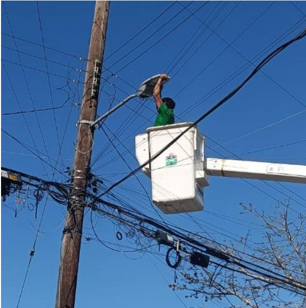
CAMBIO DE LUMINARIA OBSOLETA POR NUEVA Y CAMBIO DE FOTOCELDA Y BASE DE FOTOCELDA; C. PUMA ENTRE C. OROPENDULA Y C. RUISEÑOR, POBLADO CHEMUYIL.
