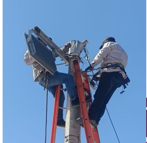
CAMBIO DE REFLECTORES OBSOLETOS POR NUEVOS Y CAMBIO DE LUMINARIA; PUNTA ALLEN.
