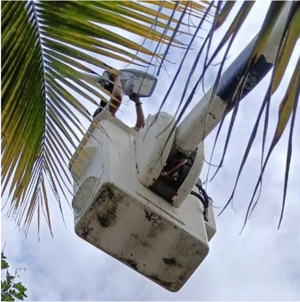
CAMBIO DE LUMINARIA OBSOLETA POR LED NUEVA; C. 17, COL. TUMBEN-KAA.
