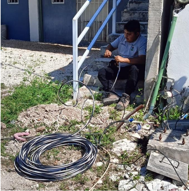
CAMBIO DE LINEAS SUBTERRANEAS DAÑADAS POR NUEVAS PARA HABILITAR LUMINARIAS; C. 12 ENTRE C. 23 Y C. NAVAL, COL. TUMBEN-KAA.
