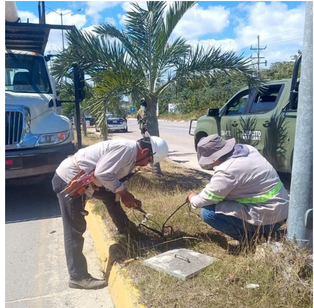
REPARACIÓN DE CORTO CIRCUITO; AV. TULUM ENTRE Y CASETA DE POLICIAS.
