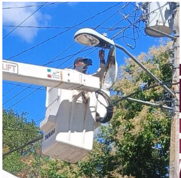
REPARACIÓN DE LUMINARIAS HACIENDO CAMBIO DE MATERIALES OSBOLETOS POR NUEVOS; POBLADO COBA.
