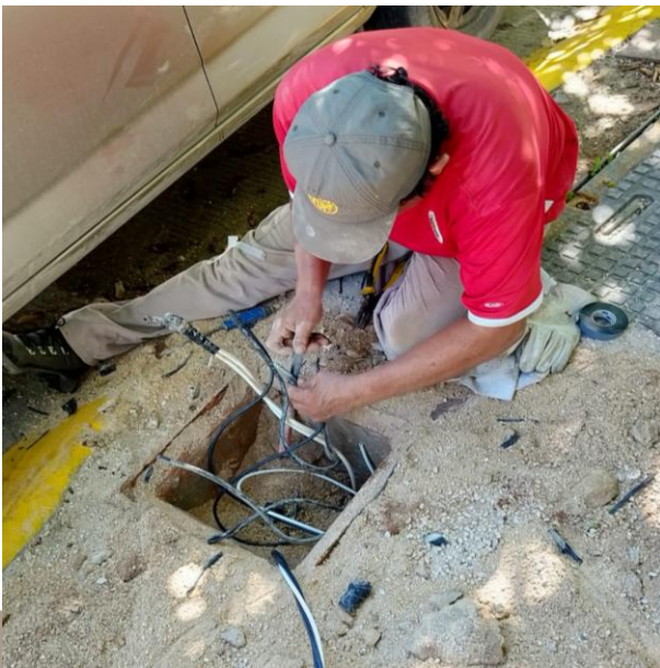
CAMBIO DE LINEAS SUBTERRANEAS REVENTADAS; C. ITZAMNA ENTRE AV. YAXCHE, FRACC. ALDEA ZAMA.
