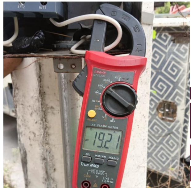
RECONEXIÓN DE ACOMETIDA; AV. LA SELVA ENTRE C. TAURO Y C. ZACIL-HA, COL. EJIDO.
