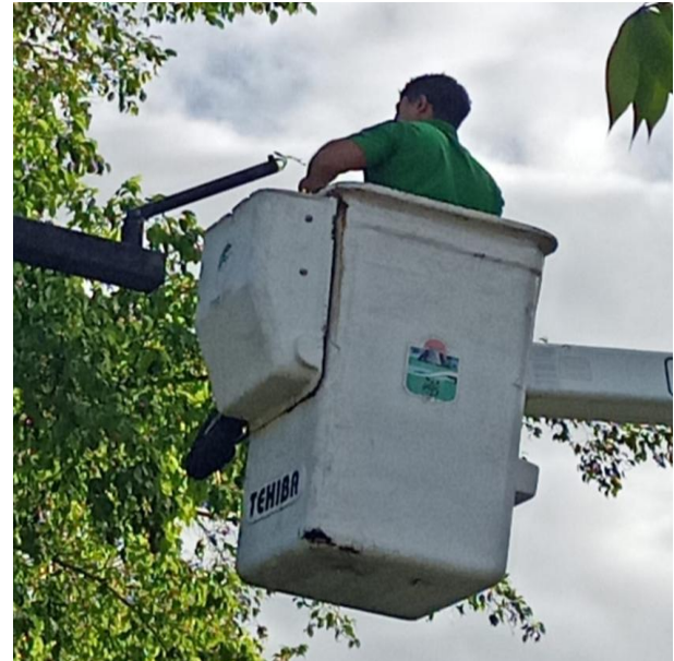
RECONEXIÓN DE LUMINARIA; AV. SATÉLITE SUR ENTRE C. NEPTUNO OTE Y C. SOL OTE, COL. LAK'IN.
