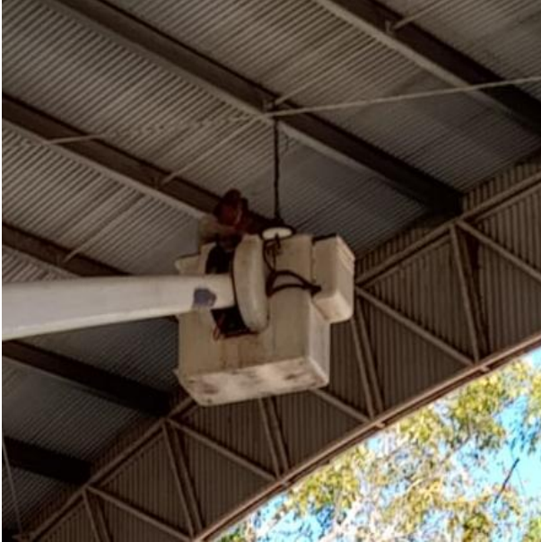
CAMBIO DE REFLECTOR OBSOLETO POR NUEVO; DOMO, POBLADO SAN JUAN DE DIOS.
