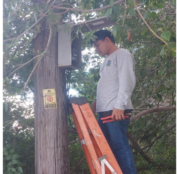
REHABILITACIÓN DE LINEAS SULFATADAS PARA HABILITAR SECTOR; AV. TULUM (CARRETERA TULUM-PLAYA).
