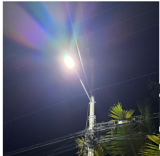
INSTALACIÓN DE BASE DE FOTOCELDA PARA HABILITAR SECTOR; C. RIO BASCA ENTRE C. RIO CONCORDIA Y C. RIO PLAYON, COL. TUMBEN-KAA.
