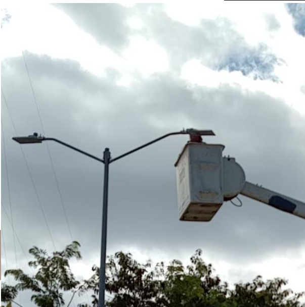
CAMBIO DE LUMINARIAS OBSOLETAS POR LED NUEVAS; AV. 18, COL. TUMBEN-KAA.
