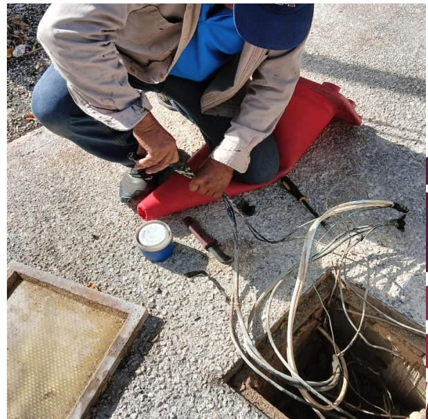
RECONEXIÓN DE LINEAS SUSBTERRANEAS REVENTADAS PARA HABILITAR LUMINARIAS; C. RUBI, FRACC. ALDEA TULUM.
