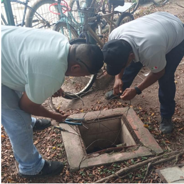
VERIFICACIÓN Y REHABILITACIÓN DE LINEAS SUBTERRANEAS POR CORTO CIRCUITO; PARQUE ROTARIO.
