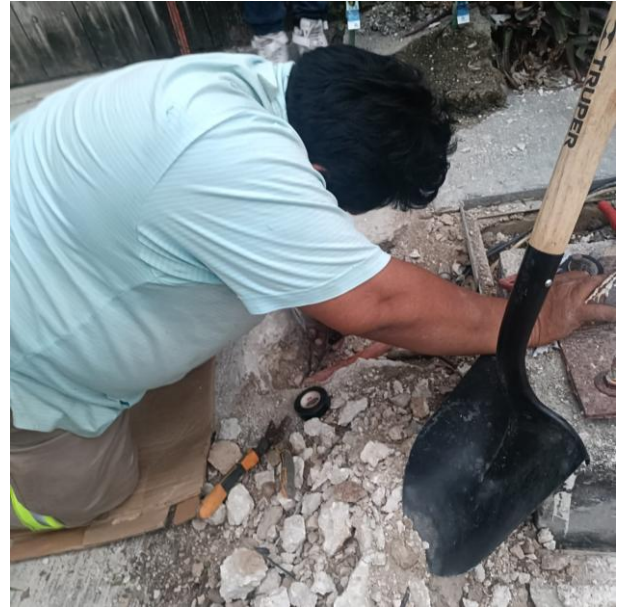
RECONEXIÓN DE LINEAS SUBTERRANEAS; C. FAISAN ENTRE AV. 18 Y C. 12, COL. TUMBEN-KAA.
