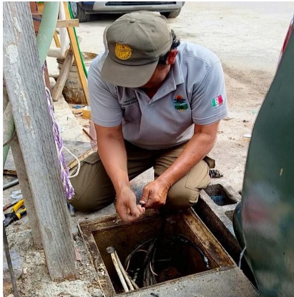
RECONEXIÓN DE LINEAS SUBTERRANEAS; C. 15 ENTRE C. 20 Y C. 24, COL. TUMBEN-KAA.
