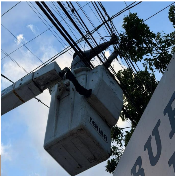
REHABILITACIÓN DE LUMINARIAS POR CORTO CIRCUITO; C. 2 SUR ENTRE C. 7 SUR, COL. LA VELETA.
