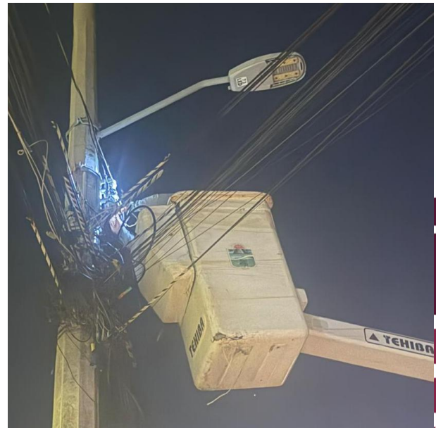
RECONEXIÓN DE LINEA REVENTADA PARA HABILITAR LUMINARIA; C. RIO PLAYON ENTRE C. RIO OTATE, COL. TUMBEN-KAA.
