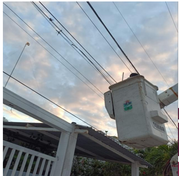
CAMBIO DE BASE DE FOTOCELDA Y SE INSTALAN SEPARADORES EN LINEAS; C. 2 OTE ENTRE C. 5 SUR Y C. 7 SUR, FRACC. VILLAS TULUM.
