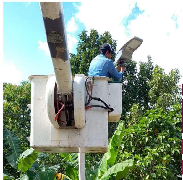
CAMBIO DE LUMINARIAS OBSOLETAS POR LED NUEVAS; POBLADO SAN JUAN DE DIOS.
