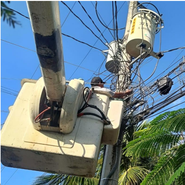
RECONEXIÓN DE LINEAS SULFATADAS PARA HABILITAR LUMINARIAS; C. ALFA SUR ENTRE AV. TULUM Y C. SOL OTE, COL. CENTRO.
