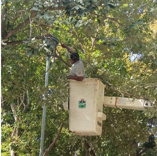
INSTALACIÓN DE LUMINARIA; UNIDAD DEPORTIVA, COL. CENTRO.
