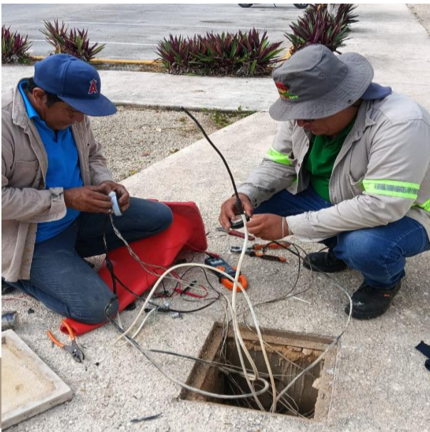
RECONEXIÓN DE LINEAS SUSBTERRANEAS REVENTADAS PARA HABILITAR LUMINARIAS; C. RUBI, FRACC. ALDEA TULUM.
