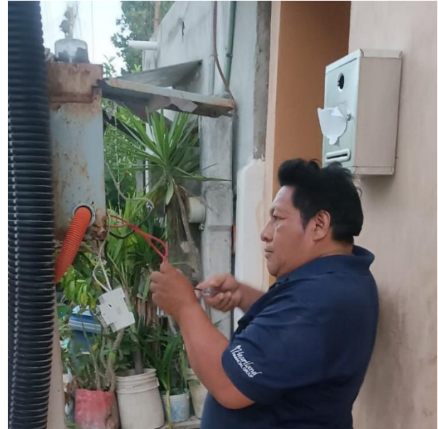
CAMBIO DE BREAK OBSOLETO POR NUEVO PARA HABILITAR SECTOR; C. MAYA BALAM ENTRE C. 30, COL. TUMBEN-KAA.
