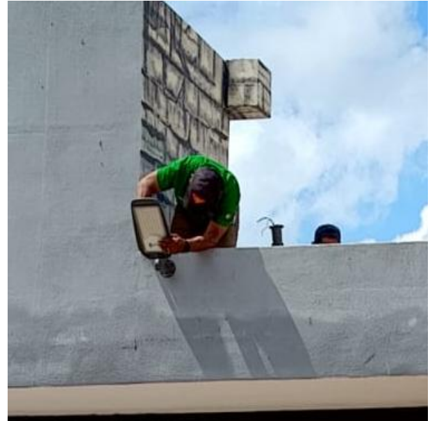
INSTALACIÓN DE LUMINARIA; UNIDAD DEPORTIVA, COL. CENTRO.
