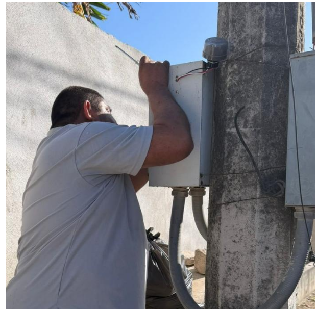
CAMBIO DE INTERRUPTOR OBSOLETO POR NUEVO; C. CHAN-CHEN ENTRE C. FAISAN Y C. QUETZAL, COL. EJIDO
