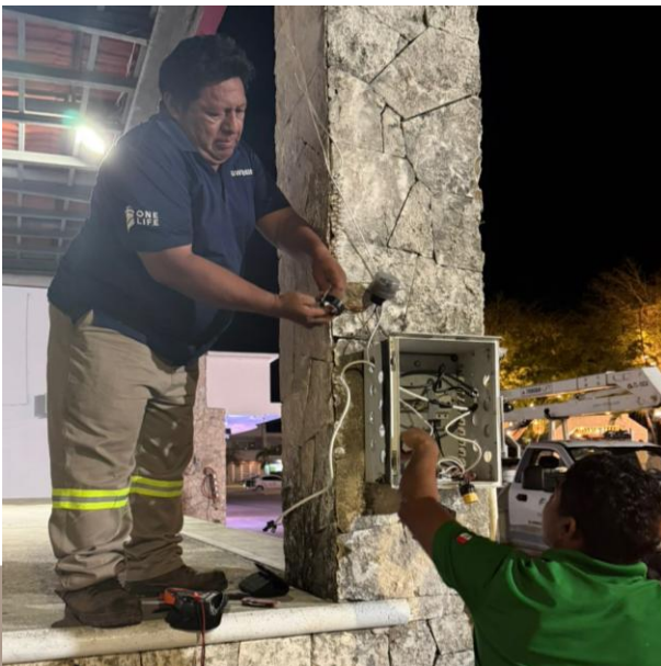
INSTALACIÓN DE BASE DE FOTOCELDA PARA AUTOMATIZAR SECTOR; PARQUE DEL MUSEO DE LA CULTURA MAYA.
