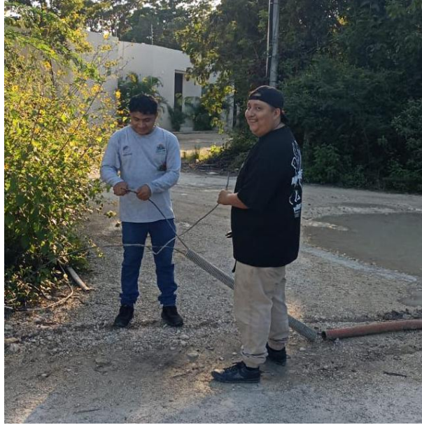
RECONEXIÓN DE LINEA REVENTADA PARA HABILITAR LUMINARIA; C. RIO PLAYON ENTRE C. RIO OTATE, COL. TUMBEN-KAA.
