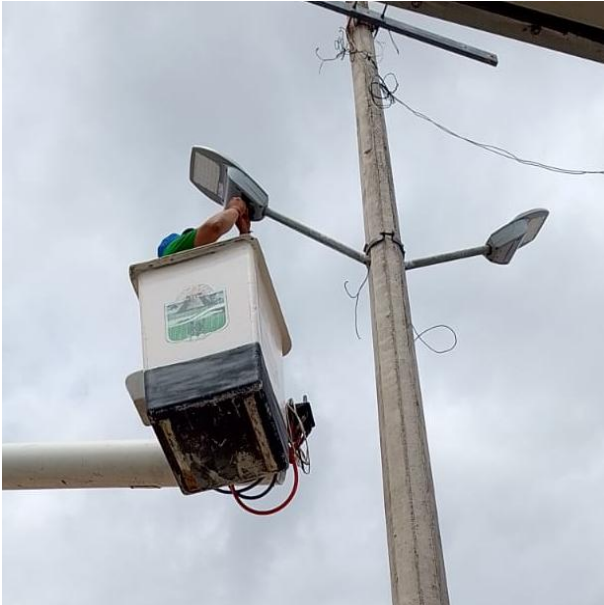
CAMBIO DE LUMINARIAS OBSOLETAS POR LED NUEVOS; POBLADO COBA.
