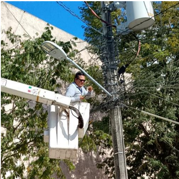
RECONEXIÓN DE ACOMETIDA PARA HABILITAR SECTOR; C. QUETZAL ENTRE C. SIAN-KAAN Y AV. BOCA PAILA, COL. EJIDO.
