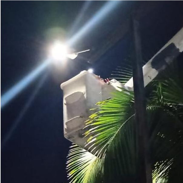
CAMBIO DE LUMINARIAS OBSOLETAS POR LED NUEVAS; AV. SATÉLITE ENTRE C. 2 OTE Y C. 4 OTE, COL. CENTRO.
