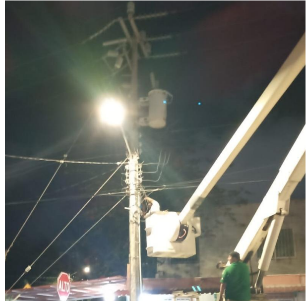
REPARACIÓN DE CORTO CIRCUITO EN LINEAS AEREAS; C. LIBRA SUR ENTRE C. SOL OTE Y C. ANDROMEDA OTE, COL. CENTRO.
