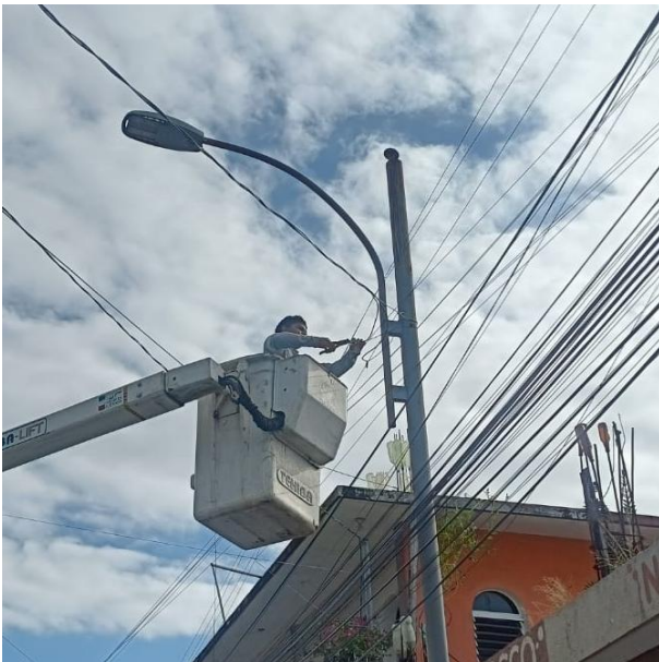
RECONEXIÓN DE LINEAS AEREAS PARA HABILITAR LUMINARIAS; C. ALFA SUR ENTRE AV. TULUM Y C. GAMA OTE, COL. CENTRO.
