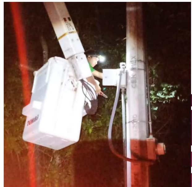
REHABILITACIÓN DE LINEAS SULFATADAS PARA HABILITAR SECTOR, C. 17 ENTRE AV. 1 Y AV. YODZONOT, COL. TUMBEN-KAA.
