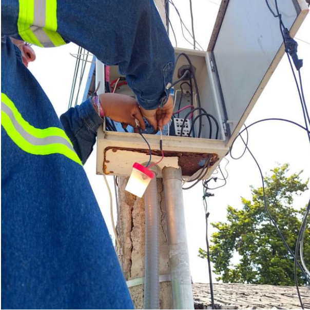
CAMBIO DE FOTOCELIDAS OBSOLETAS POR NUEVAS; C. SOL PTE ENTRE AV. OSIRIS SUR Y C. BETA SUR, COL. CENTRO.
