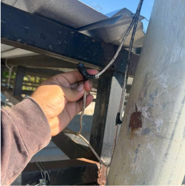
RECONEXIÓN DE REFLECTOR; UNIDAD DEPORTIVA, COL. CENTRO.
