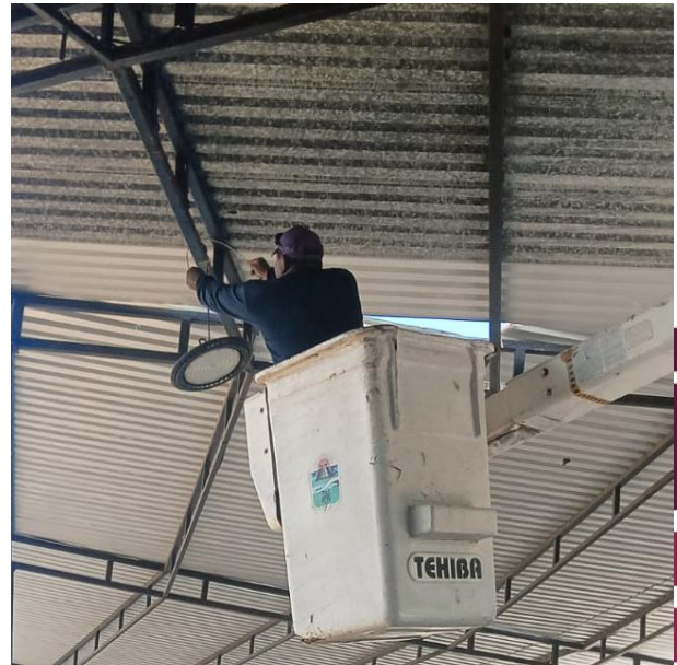
REPARACIÓN DE LÁMPARA Y RECONEXIÓN DE LINEAS, UNIDAD DEPORTIVA, COL. CENTRO.
