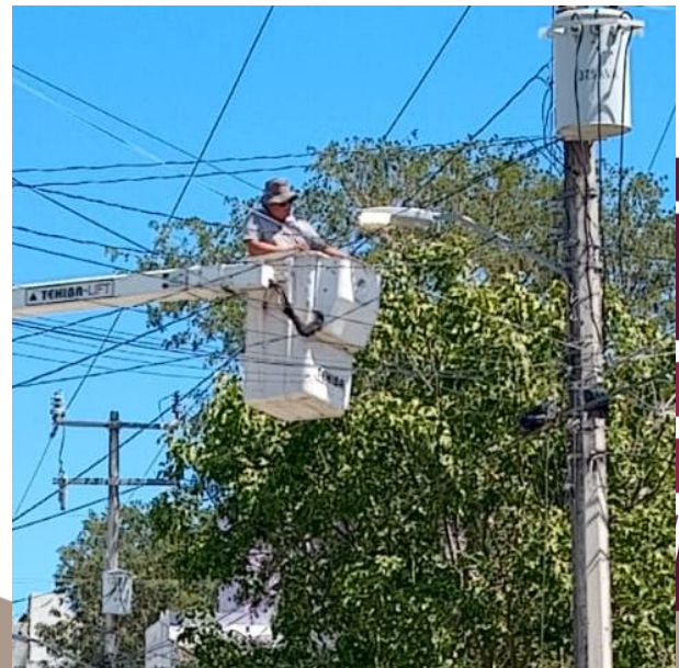
CAMBIO DE FOTOCELDAS QUEMADAS A LUMINARIAS; COL. CENTRO.
