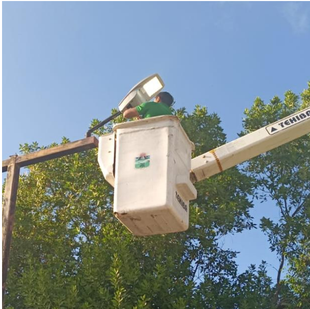
CAMBIO DE LUMINARIAS OBSOLETAS POR LED NUEVAS; AV. SATÉLITE SUR ENTRE C. NEPTUNO OTE Y C. SOL OTE, COL. LAK'IN.
