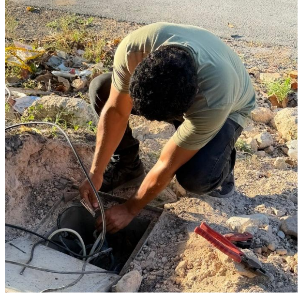
RECONEXIÓN DE LINEAS SULFATADAS; C. GLADIOLA ENTRE C. ORQUIDEA Y C. AZUCENA. FRACC. YA'AX TULUM.
