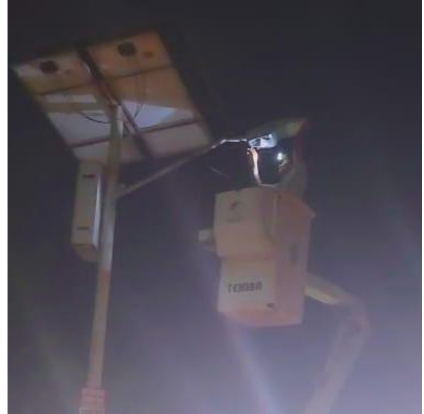
CAMBIO DE LUMINARIA OBSOLETA POR NUEVA; C. PALENQUE ENTRE C. ONTARIO, COL. LA VELETA.
