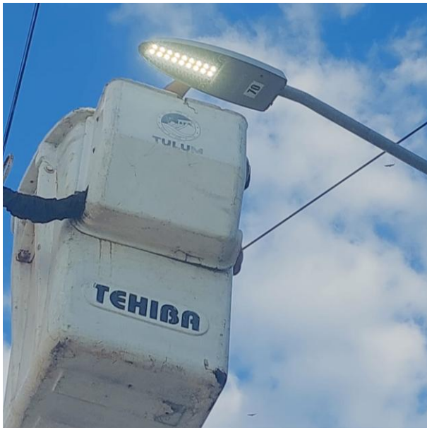
CAMBIO DE FOTOCELDAS OBSOLETAS POR NUEVAS; C. 2 OTE ENTRE C. OSIRIS NTE Y C. BETA NTE, COL. CENTRO.
