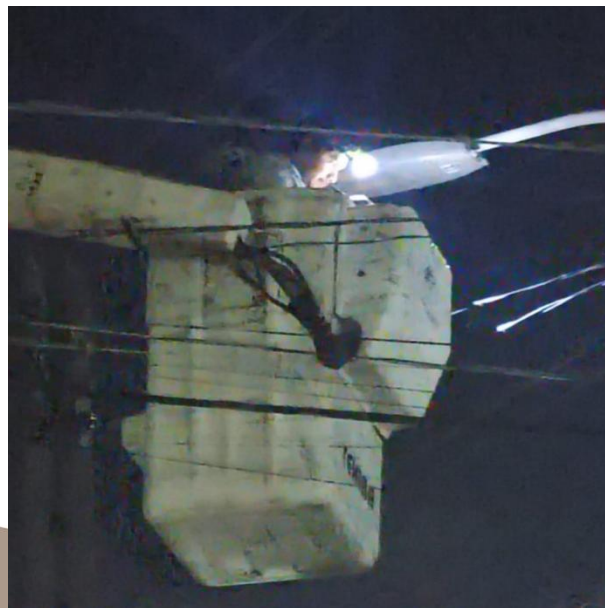
CAMBIO DE FOTOCELDA OBSOLETA POR NUEVA PARA HABILIKTAR LUMINARIA; C. LUNA NTE ENTRE C. POLAR PTE Y AV. TULUM, COL. CENTRO.
