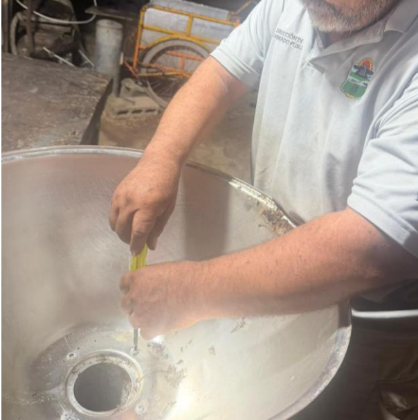
CAMBIO COMPLETO DE MATERIAL OBSOLETO POR NUEVO A REFLECTOR CIRCULAR Y RECONEXIÓN DE LINEAS SULFATADAS; C. 2 OTE ENTRE C. ESCORPIÓN Y C. LIBRA NTE, COL. GUERRA DE CASTAS.
