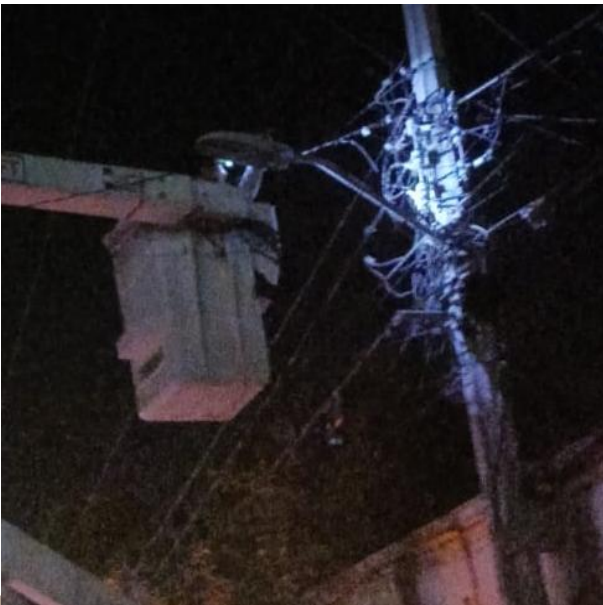
CAMBIO DE FOTOCELDA A LUMINARIA APAGADA; C. ALFA SUR ENTRE C AURORA SUR Y C. ALFA SUR, COL. CENTRO.
