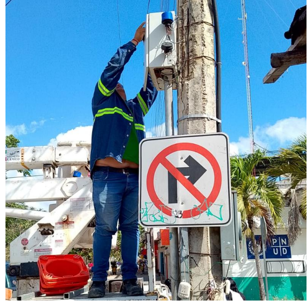
CAMBIO DE FOTOCELDA OBSOLETA POR NUEVA; AV. BOCA PAILA ENTRE C. QUETZAL Y C. FAISAN, COL. EJIDO.
