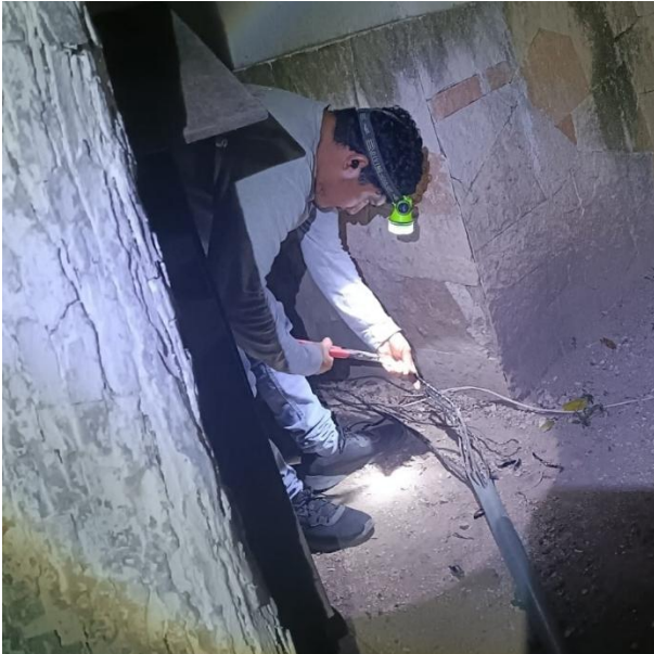
REHABILITACIÓN DE LINEAS SULFATADAS PARA HABILITAR SECTOR; AV. SATÉLITE SUR ENTRE C. VENUS OTE Y C. GAMA OTE, COL. LAK'IN.
