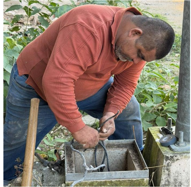
REHABILITACIÓN DE LINEAS SUBTERRANEAS DAÑADAS POR MAQUINARIA; C. TULIPAN ENTRE C. MARGARITA Y C. AZUCENA, FRACC. YA´AX TULUM.
