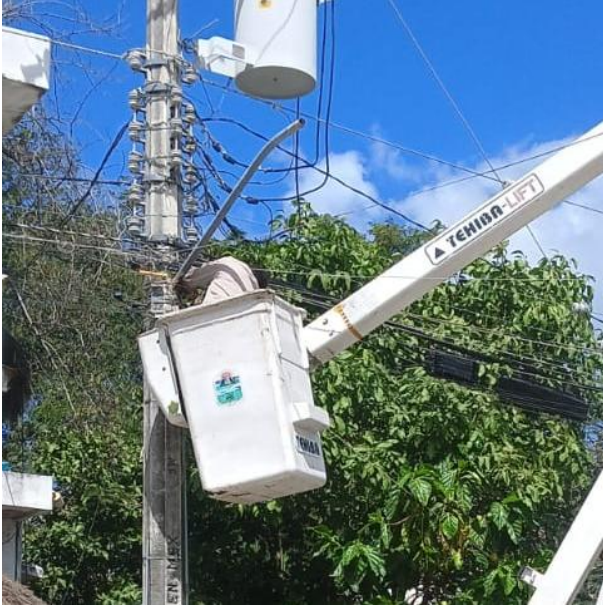
CAMBIO DE BRAZOS OBSOLETOS A LUMINARIAS Y REHABILITACIÓN DE LINEAS; C. CODORNICES ENTRE AV. SIAN-KAAN Y C. CHAN-CHEN, COL. EJIDO.
