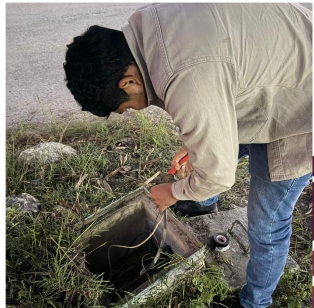
RECONEXIÓN DE LINEAS SUBTERRANEAS PARA HABILITAR LUMINARIAS; AV. 2 ENTRE C. 20 Y AV. 18, COL. TUMBEN-KAA.
