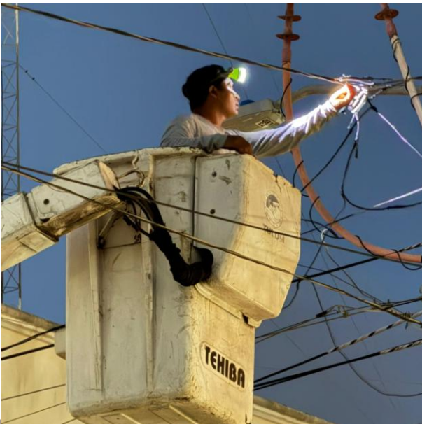
RECONEXIÓN DE LINEAS AEREAS SULFATADAS; C. ESCORPIÓN SUR ENTRE C. ANDROMEDA OTE, COL. SAC-BE.
