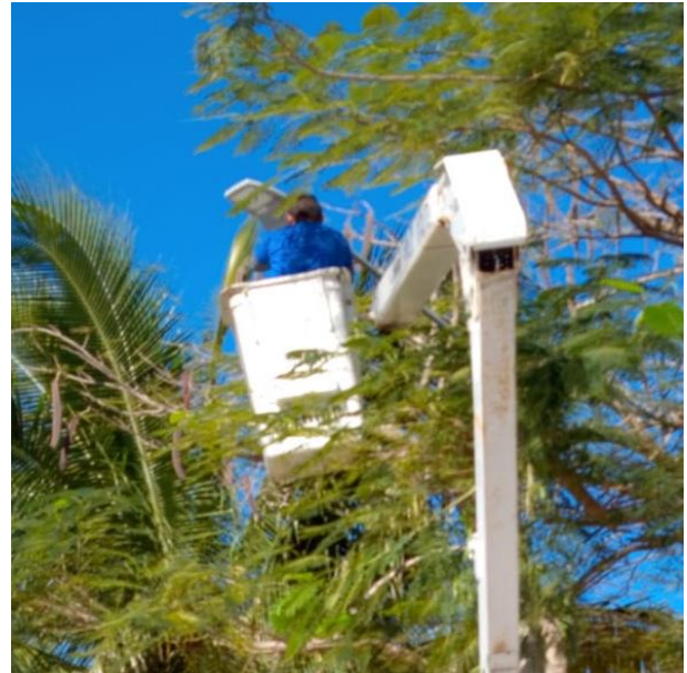
CAMBIO DE LUMINARIAS OBSOLETAS POR LED NUEVAS; FRACC. PALMAS.
