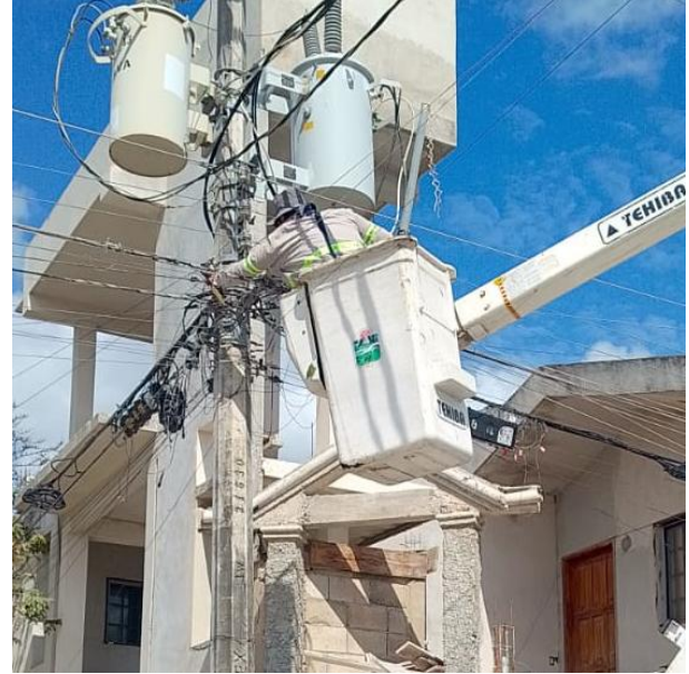
CAMBIO DE BRAZOS OBSOLETOS A LUMINARIAS Y REHABILITACIÓN DE LINEAS; C. CODORNICES ENTRE AV. SIAN-KAAN Y C. CHAN-CHEN, COL. EJIDO.
