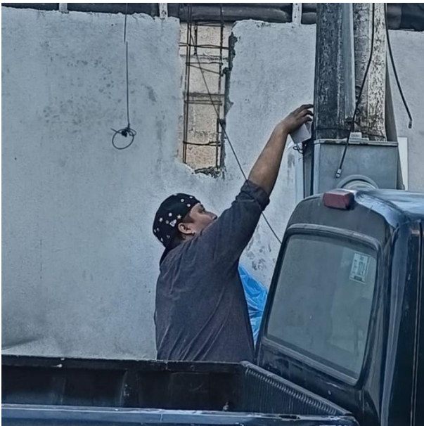
CAMBIO DE FOTOCELDA OBSOLETA POR NUEVA PARA HABILITAR SECTOR; C. CHAN-CHEN ENTRE C. FAISAN Y C. QUETZAL, COL. EJIDO.
