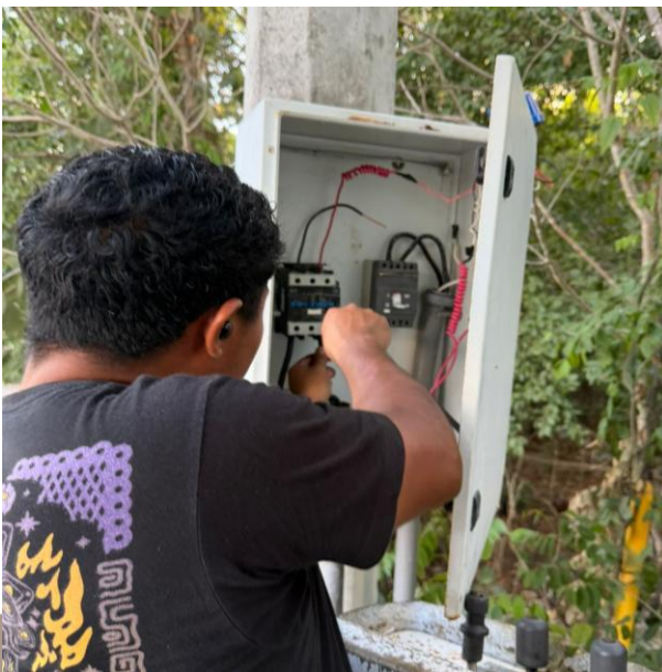
INSTALACIÓN DE CONTACTOR PARA AUTOMATIZAR SECTOR; C. RIO BASCO ENTRE C. RIO CONCORDIA Y C. RIO PLAYON, COL. TUMBEN-KAA.
