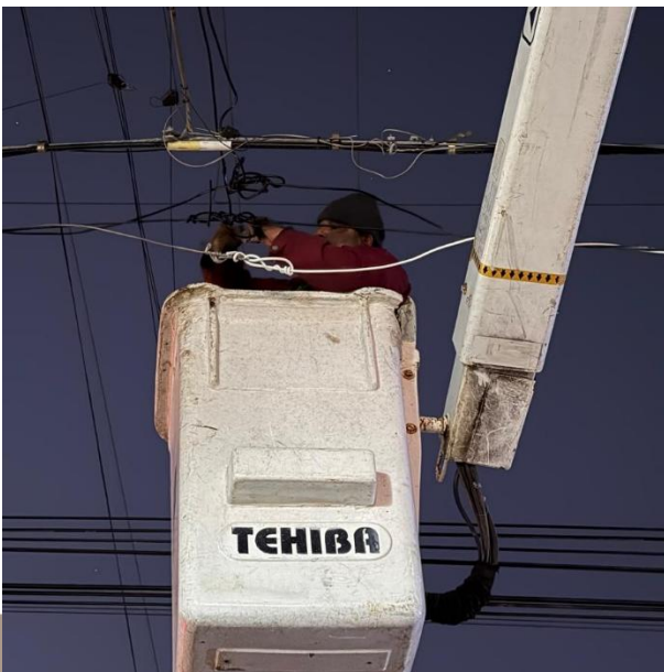
REPARACIÓN DE CORTO CIRCUITO EN LINEAS AEREAS; AV. OK-K'OT ENTRE C. ORIÓN NTE Y C. CENTAURO NTE, COL. MAYA-PAX.
