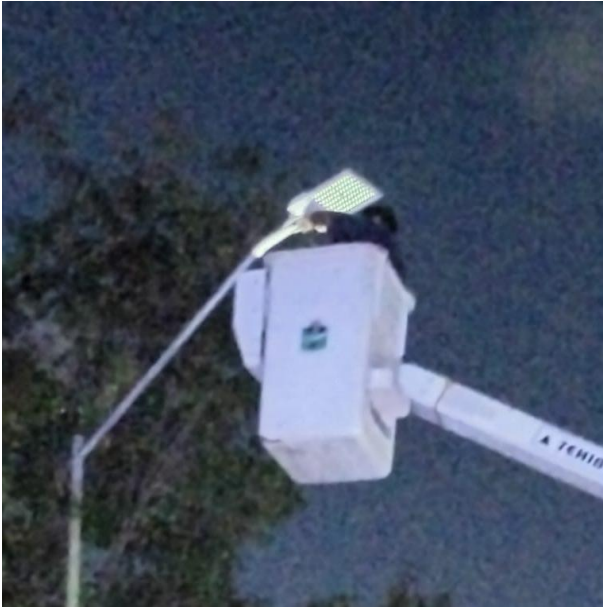
CAMBIO DE LUMINARIAS OBSOLETAS POR LED NUEVAS; C. 21 ENTRE C. NAVAL Y C. 12, COL. TUMBEN-KAA.
