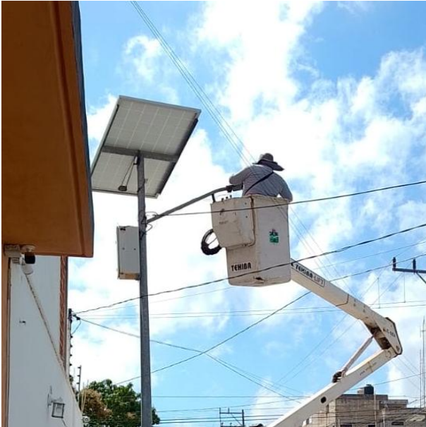
REPARACIÓN DE LUMINARIA HACIENDO CAMBIO DE FOTOCELDA; C. CENTAURO NTE ENTRE C. 4 PTE Y C. 2 PTE, COL. CENTRO.
