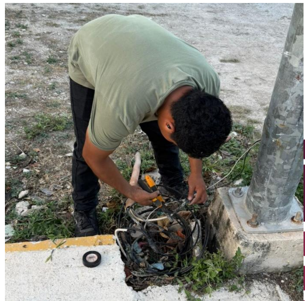
RECONEXIÓN DE LINEAS SULFATADAS PARA HABILITAR LUMINARIA; C. KITAM ENTRE C. CHA'AB Y C. 5 AV BIS NTE, FRACC. XUL-KAA.
