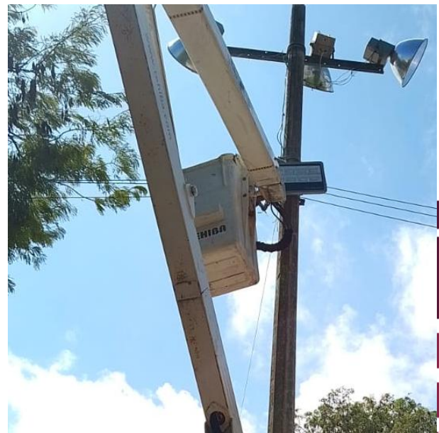
CAMBIO DE LAMPARA OBSOLETA POR LED NUEVA; FRACC. HURACANES.
