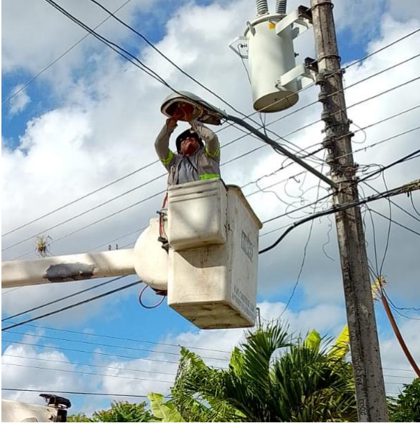
REHABILITACIÓN DE LUMINARIAS; POBLADO COBA.
