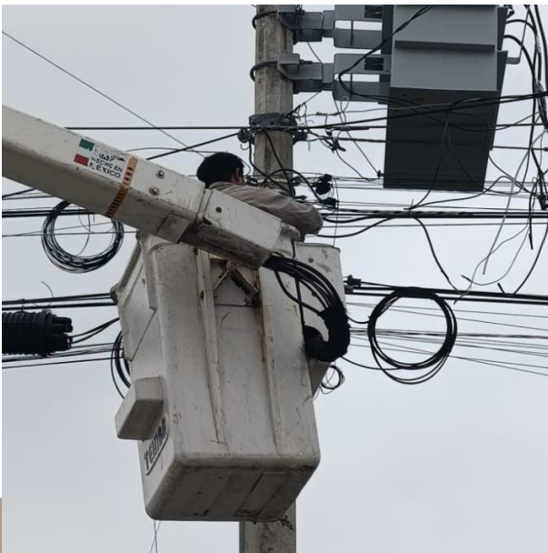
RECONEXIÓN DE LINEAS AEREAS PARA HABILITAR SECTOR; C. ALFA SUR ENTRE C. GAMA OTE Y C. MERCURIO PTE, COL. CENTRO.
