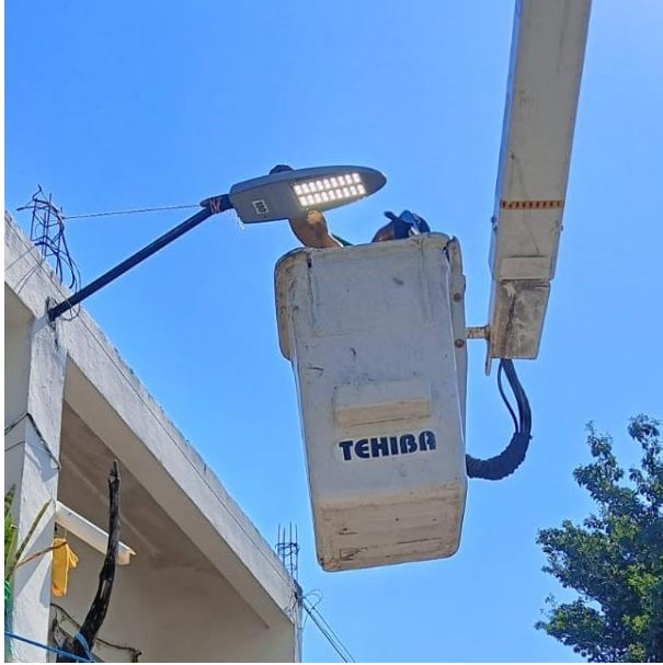
REPARACIÓN Y RECONEXIÓN DE LUMINARIAS; POBLADO CHEMUYIL.
