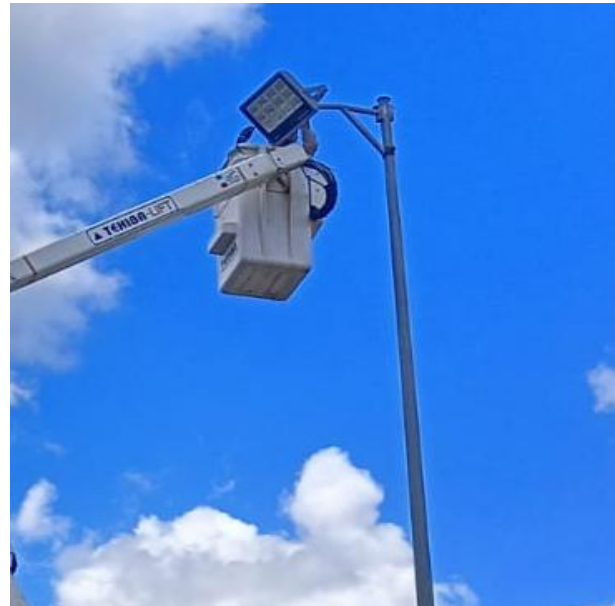
CAMBIO DE LUMINARIAS OBSOLETAS POR LED NUEVAS; POBLADO COBA.
