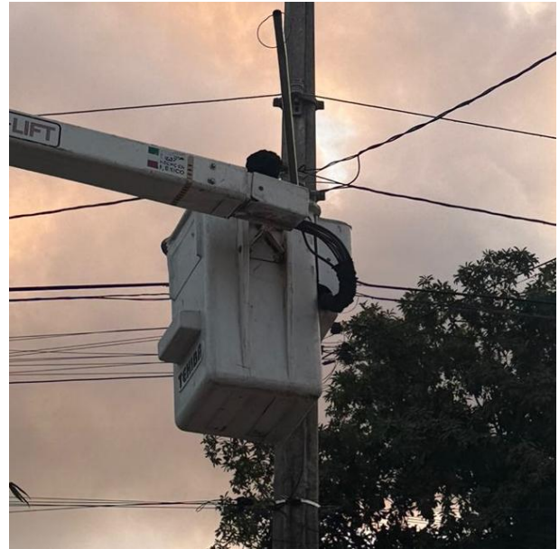
CAMBIO DE BASE DE FOTOCELDA Y FOTOCELDA PARA HABILITAR SECTOR; C. 32 ENTRE C. 34 Y C. 36, COL. TUMBEN-KAA.
