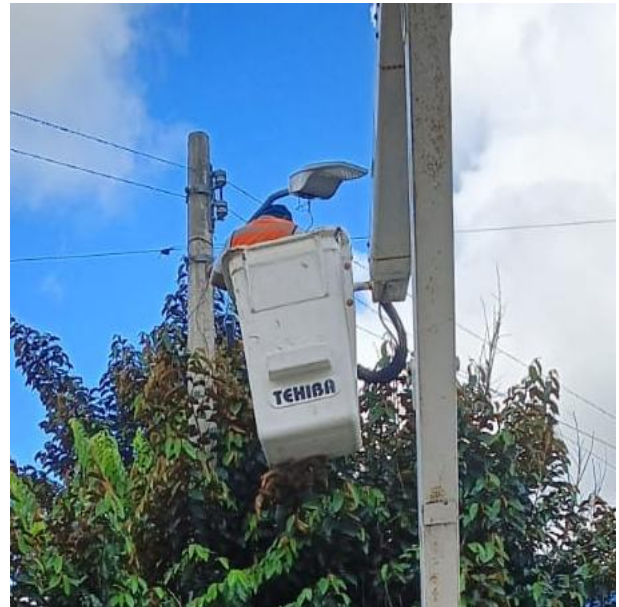
CAMBIO DE LUMINARIAS OBSOLETAS POR LED NUEVAS; POBLADO MANUEL ANTONIO AY.
