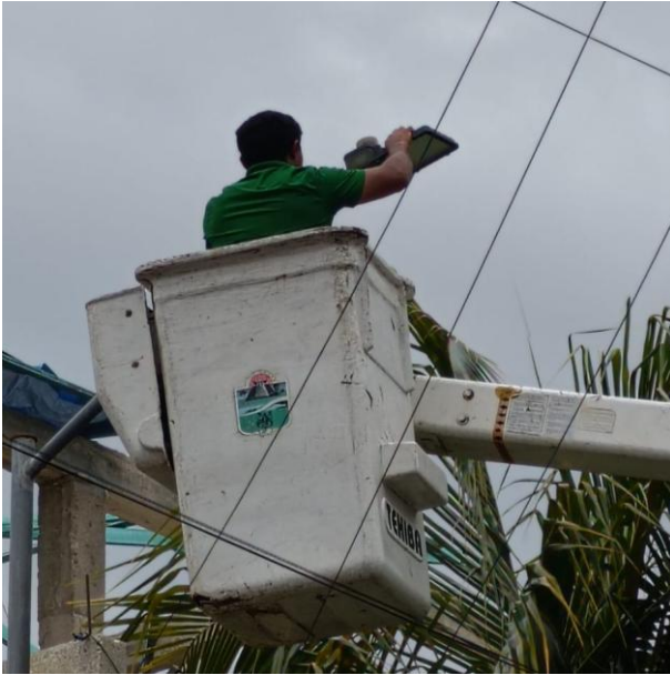
CAMBIO DE LUMINARIAS OSBOLETAS POR LED NUEVAS Y RECONEXIÓN DE LINEAS SUBTERRANEAS; C. FAISAN ENTRE AV. LA SELVA Y AV. 18, COL. TUMBEN-KAA.
