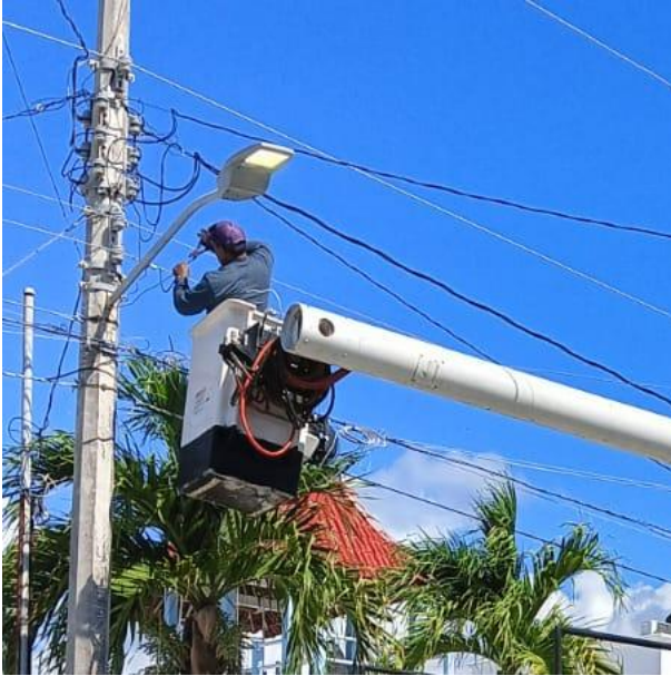
REPARACIÓN DE LUMINARIAS; FRACCIONAMIENTO CHAN- CHEMUYIL.
