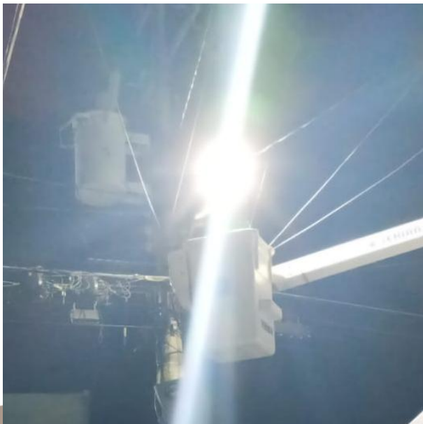
CAMBIO DE LUMINARIA OBSOLETA POR NUEVA; C. SOL OTE ENTRE C. BETA SUR Y AV. OSIRIS SUR, COL. CENTRO.
