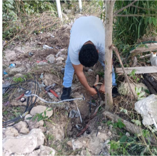
REHABILITACIÓN DE LINEAS SUBTERRANEAS DAÑADAS POR MAQUINARIA; C. MARGARITA ENTRE C. 2 NTE, FRACC. YA'AX TULUM.
