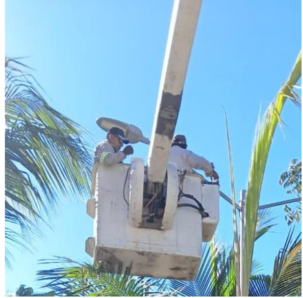
CAMBIO DE BRAZOS E INSTALACIÓN DE LUMINARIAS; AV. GONZALO GUERRERO, POBLADO AKUMAL.
