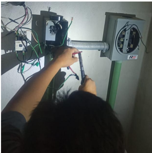
CAMBIO DE BREAK QUEMADO POR NUEVO PARA HABILITAR SECTOR; C. ALCATRAZ ENTRE C. AZUCENA, FRACC. YA'AX TULUM.
