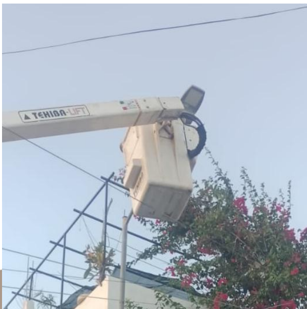
CAMBIO DE LUMINARIA OBSOLETA POR LED NUEVA; C. 19 ENTRE C. 24 Y C. 20, COL. TUMBEN-KAA.
