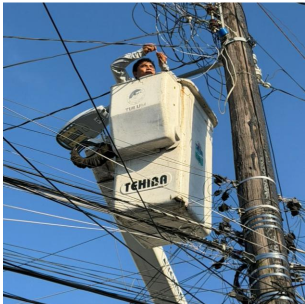
INSTALACIÓN DE LÍNEAS AÉREAS PARA HABILITAR LUMINARIAS; COLONIA CRISTAL.
