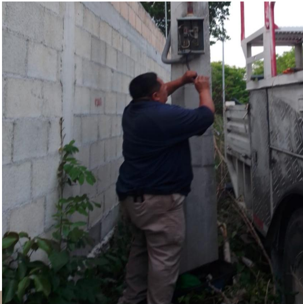
RECONEXIÓN DE ACOMETIDA; AV. 1 ENTRE C. RIO ROJO Y C. RIO JOAQUIN, COL. TUMBEN-KAA.
