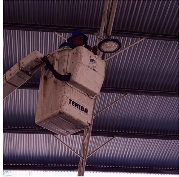
CAMBIO DE LUMINARIAS FLAT; DOMO, POBLADO SAHACABMUCUY.
