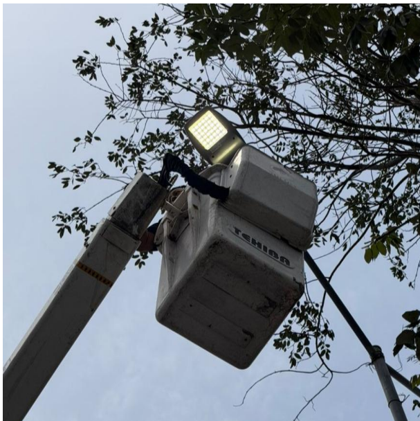
CAMBIO DE FOTOCELDA OBSOLETA PARA HABILITAR LUMINARIA; C. SOL PTE ENTRE C. JUPITER SUR Y C. OMEGA SUR, COL. CENTRO.
