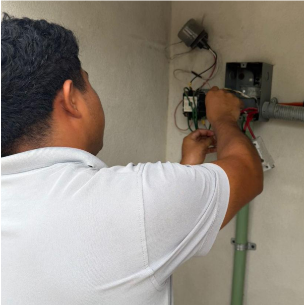
INSTALACIÓN DE INTERRUPTOR; C. ALCATRAZ ENTRE C. AZUCENA Y C. TULIPANES, FRACC. YA'AX TULUM.
