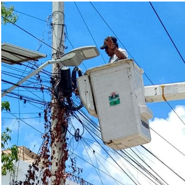
CAMBIO DE LAMPARA OBSOLETA POR LED NUEVA; C. PALENQUE ENTRE C. 16 SUR, COL. LA VELETA.
