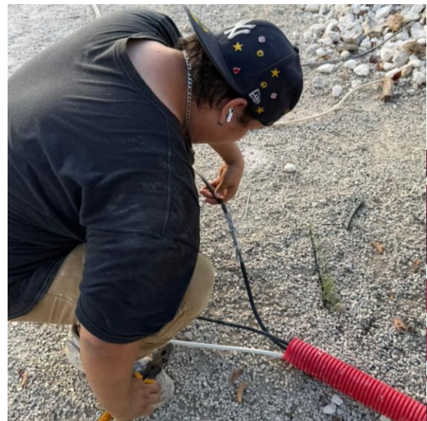
INSTALACIÓN DE LINEAS SUBTERRANEAS PARA HABILITAR LUMINARIAS; UNIDAD DEPORTIVA, COL. CENTRO.
