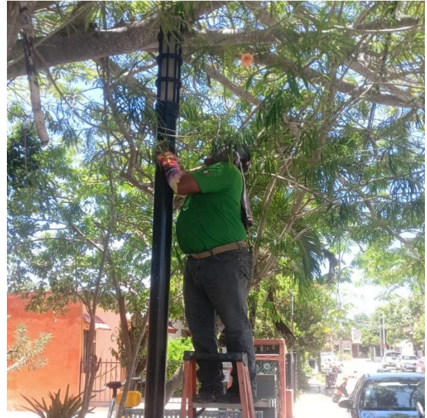
CAMBIO DE LUMINARIAS OBSOLETAS POR LED NUEVAS; FRACC. VILLAS TULUM.
