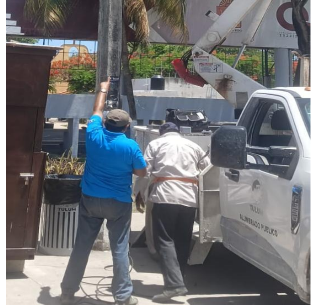
CAMBIO DE BTREACK OBSOLETO POR NUEVO; PARQUE DOS AGUAS, COL. CENTRO.
