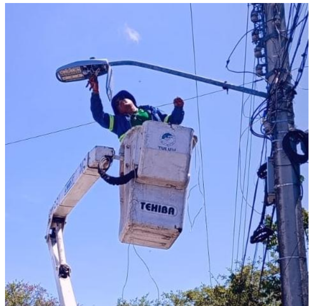
CAMBIO DE BRAZOS OBSOLETOS A LUMINARIAS; AV. LA SELVA ENTRE C. FAISAN, COL. EJIDO.
