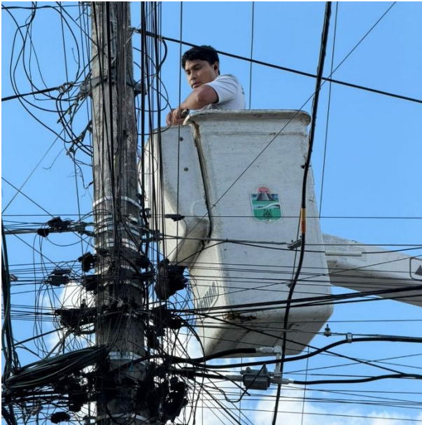
RECONEXIÓN DE LINEAS PARA HABILITAR LUMINARIA; C. 4 PTE ENTRE C. BETA NTE Y C. OSIRIS NTE, COL. CENTRO.
