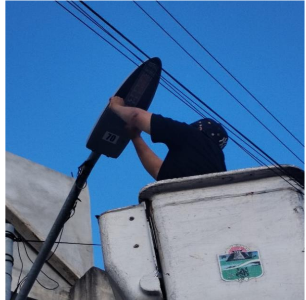
RECONEXIÓN DE LINEAS PARA AUTOMATIZAR LUMINARIA; C. BETA NTE ENTRE C. 2 PTE Y C. SAGITARIO PTE, COL. CENTRO.
