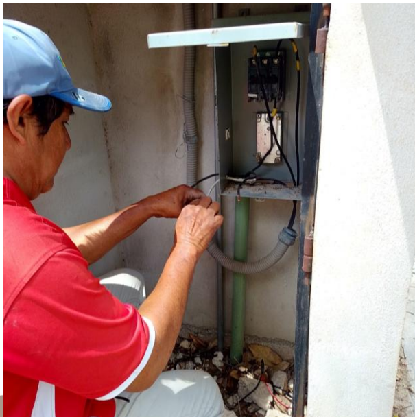
INSTALACIÓN DE BASE Y FOTOCELDA PARA AUTOMATIZAR SECTOR; POBLADO COBA.
