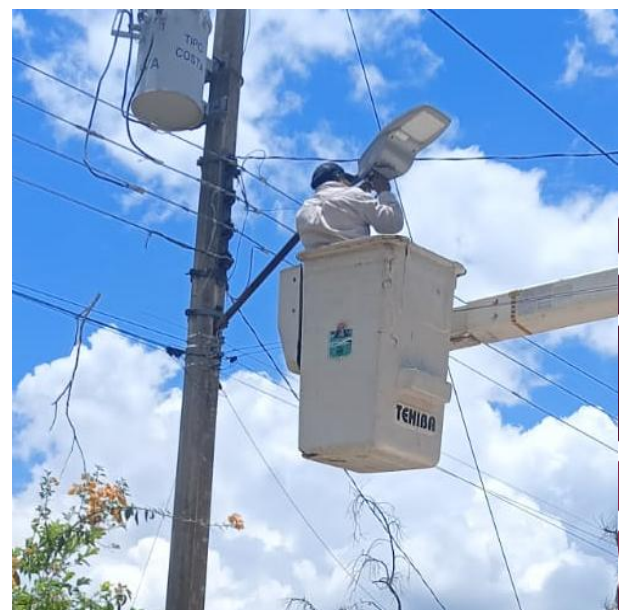
CAMBIO DE LUMINARIAS OBSOLETAS POR LED NUEVAS; POBLADO SAHACABMUCUY.
