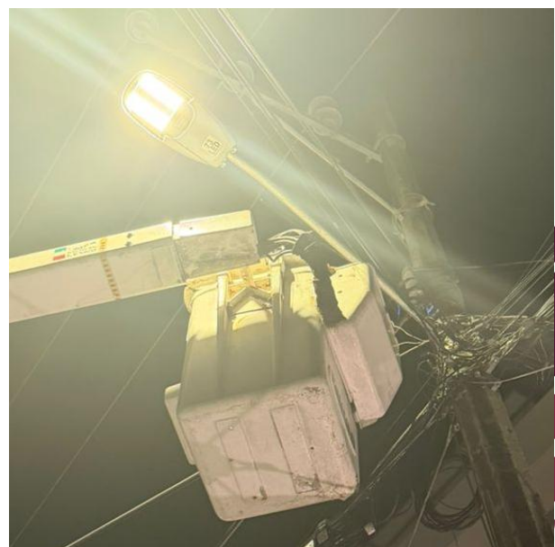
RECONEXIÓN DE LUMINARIAS APAGADAS; C. C. GEMINIS OTE ENTRE C. ESCORPIÓN SUR Y C. GEMINIS SUR, COL. SACBE.
