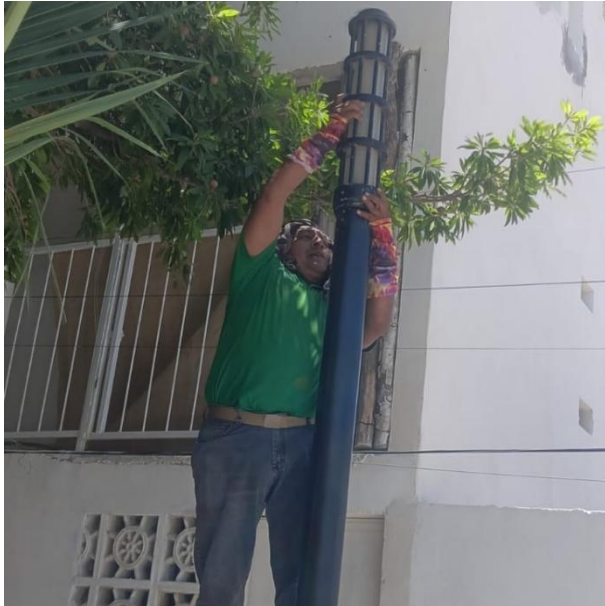
CAMBIO DE LUMINARIAS OBSOLETAS POR LED NUEVAS; FRACC. VILLAS TULUM.
