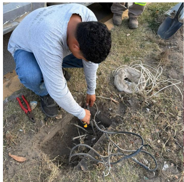
REHABILITACIÓN DE LINEAS QUEMADAS; AV. TULUM, COL. CENTRO.
