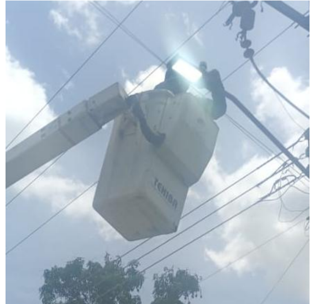
CAMBIO DE FOTOCELDA OBSOLETA POR NUEVA; POBLADO CHAN-CHEN PALMAR.
