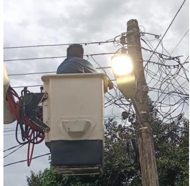
CAMBIO DE FOTOCELDAS OBSOLETAS POR NUEVAS; POBLADO MACARIO GOMEZ.
