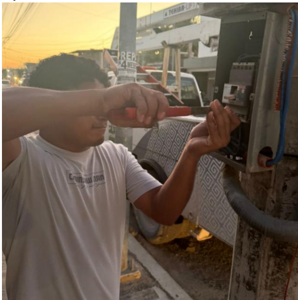
VERIFICACIÓN Y RECONEXIÓN DE ACOMETIDA PARA HABILITAR SECTOR; COL. MAYA PAX.
