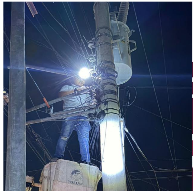
RECONEXIÓN DE ACOMETIDA; C. 4 OTE ENTRE C. CENTAURO NTE, COL. CENTRO.
