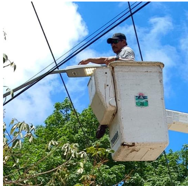
CAMBIO DE LAMPARA OBSOLETA POR LED NUEVA; C. PALENQUE ENTRE C. 16 SUR, COL. LA VELETA.
