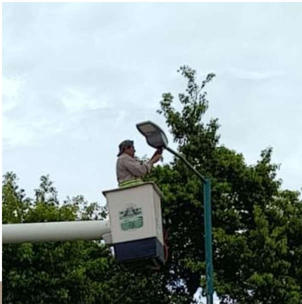
CAMBIO DE LUMINARIAS OBSOLETAS POR LED NUEVAS; POBLADO SAN PEDRO.
