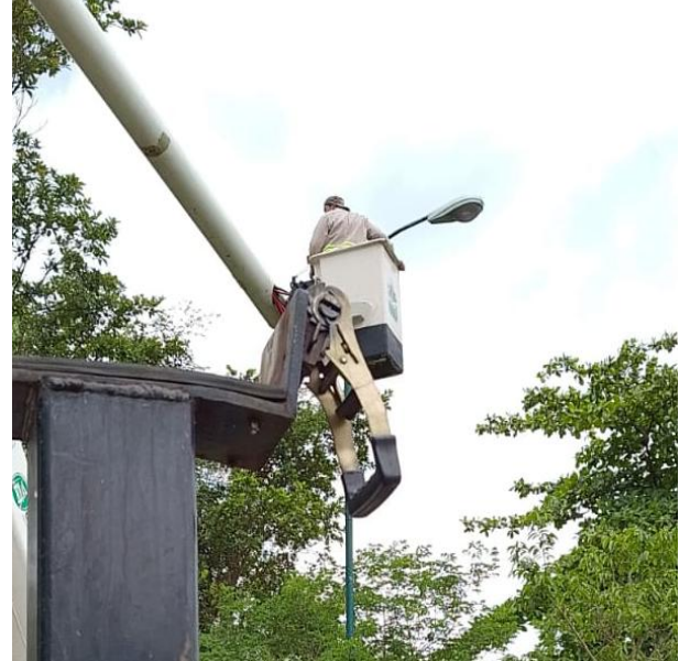
REHABILITACIÓN DE LUMINARIAS OBSOLETAS; POBLADO SAN PEDRO.
