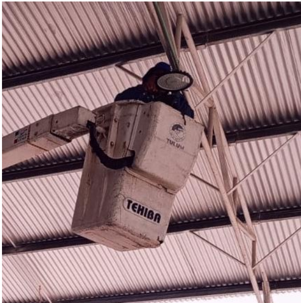
CAMBIO DE LUMINARIAS FLAT; DOMO, POBLADO SAHACABMUCUY.
