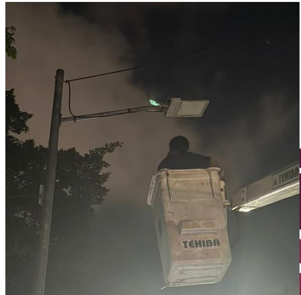
CAMBIO DE LUMINARIA OBSOLETA POR LED NUEVA; C. OSIRIS NTE ENTRE C. 4 OTE Y C. TUNKUL, COL. MAYAPAX.
