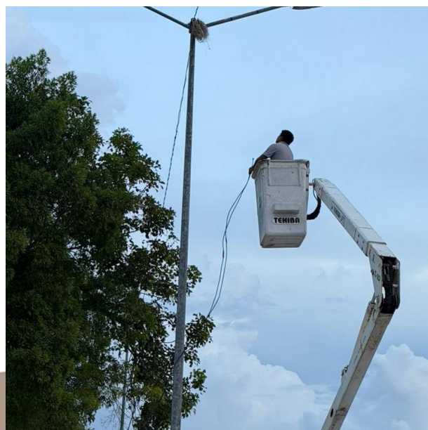
INSTALACIÓN DE LINEAS PARA HABILITAR SECTOR; C. KU'UK ENTRE C. TZ'UUB Y C. KO'OH, COL. XUL-KAA.
