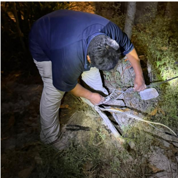
REHABILITACIÓN DE LINEAS SUBTERRANEAS DAÑADAS POR MAQUINARIA PARA HABILITAR SECTOR; C. AZUCENA ENTRE C. CLAVEL Y C. TULIPANES, COL. YA´AX TULUM.
