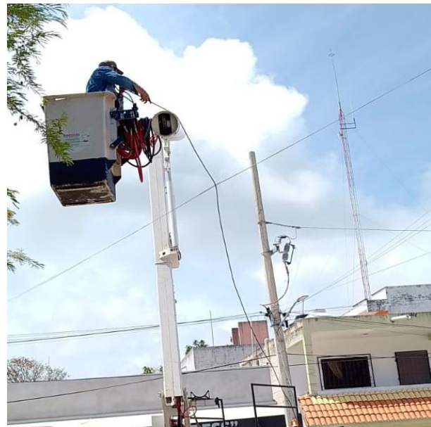
INSTALACIÓN DE LINEA AEREA PARA HABILITAR LUMINARIA; CIUDAD CHEMUYIL.
