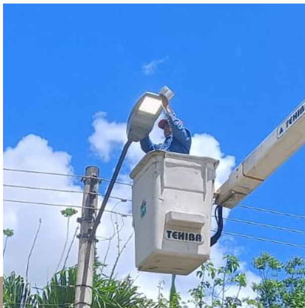
CAMBIO DE LUMINARIAS OBSOLETAS POR LED NUEVAS; POBLADO SAHACABMUCUY.
