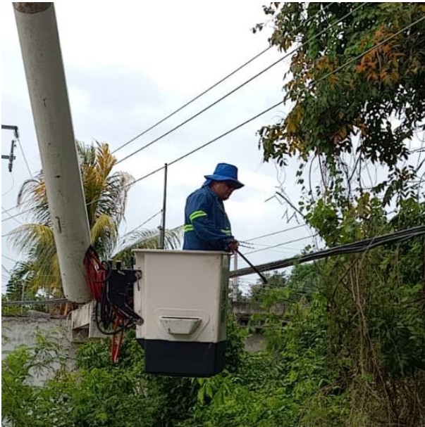
REHABILITACIÓN DE LINEAS AEREAS POR CORTO CIRCUITO; POBLADO COBA.
