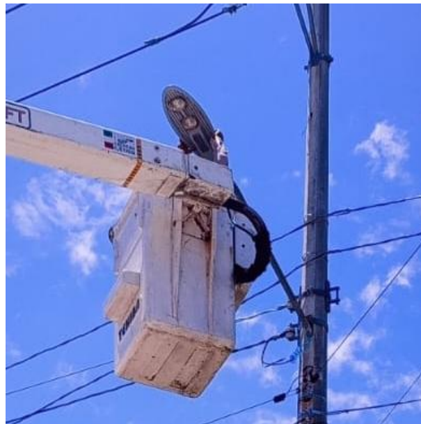
CAMBIO DE FOTOCELDA PARA HABILITAR LUMINARIA; C. JUPITER SUR ENTRE C. SATURNO PTE Y C. LUNA PTE, COL. CENTRO.
