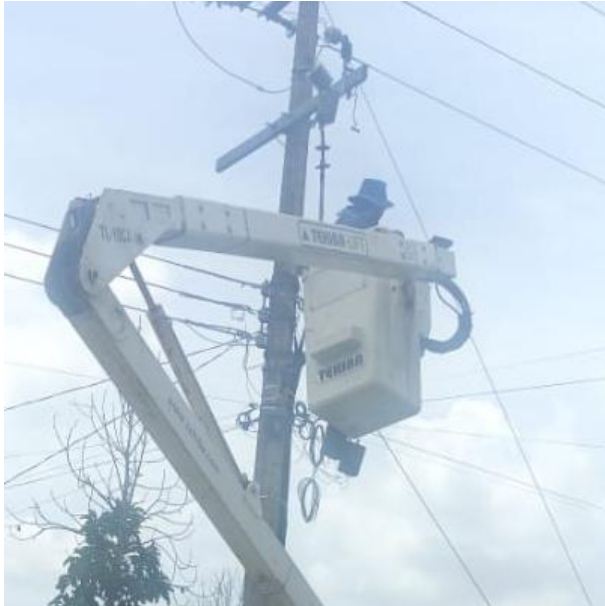
CAMBIO DE FOTOCELDA OBSOLETA POR NUEVA; POBLADO CHAN-CHEN PALMAR.
