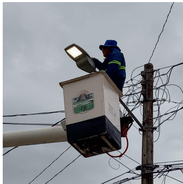
CAMBIO DE LAMPARAS OBSOLETAS POR LED NUEVAS; POBLADO COBA.
