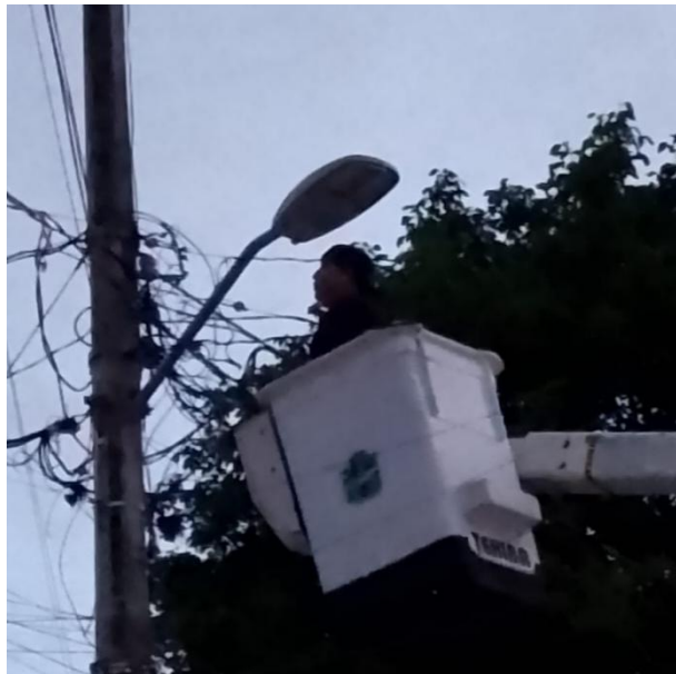
RECONEXIÓN DE LINEAS PARA HABILITAR LUMINARIAS; C. OMEGA SUR ENTRE C. NEPTUNO PTE Y C. MERCURIO PTE. COL. CENTRO.
