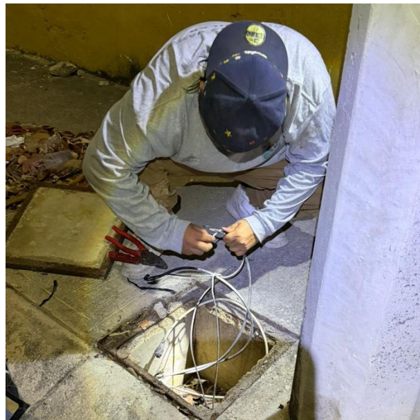
RECONEXIÓN DE LINEAS SUBTERRANEAS PARA HABILITAR LUMINARIA; C. GUINEA ENTRE C. RAPIS, FRACC. PALMAS.
