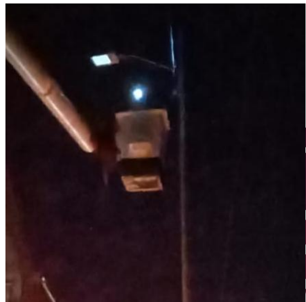
REPARACIÓN DE LUMINARIAS; C. PALMAS TULUM ENTRE C. 2 NTE, FRACC. XUL-KAA.
