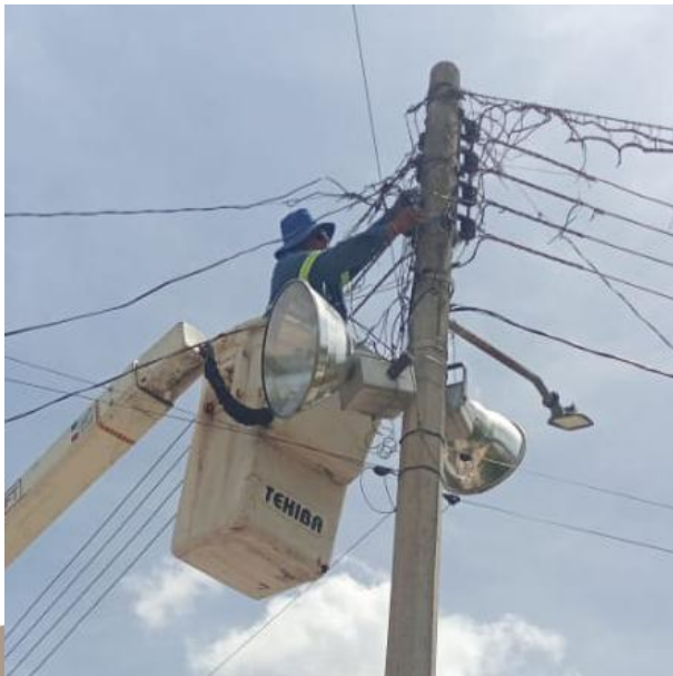
CAMBIO DE REFLECTOR OBSOLETO POR NUEVO; POBLADO CHAN-CHEN PALMAR.
