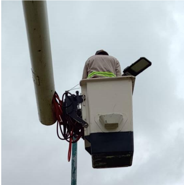
REHABILITACIÓN DE LUMINARIAS OBSOLETAS; POBLADO SAN PEDRO.
