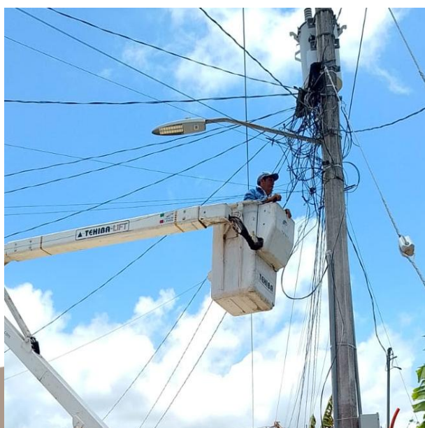
RECONEXIÓN DE LINEAS AEREAS DAÑADAS; POBLADO AKUMAL.
