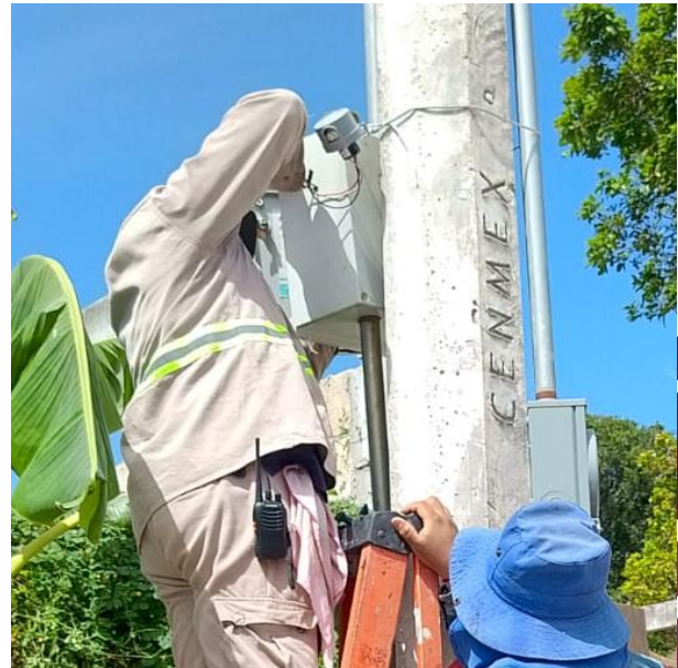
INSTALACIÓN DE CONTACTOR PARA AUTOMATIZAR SECTOR; COL. CRISTAL.
