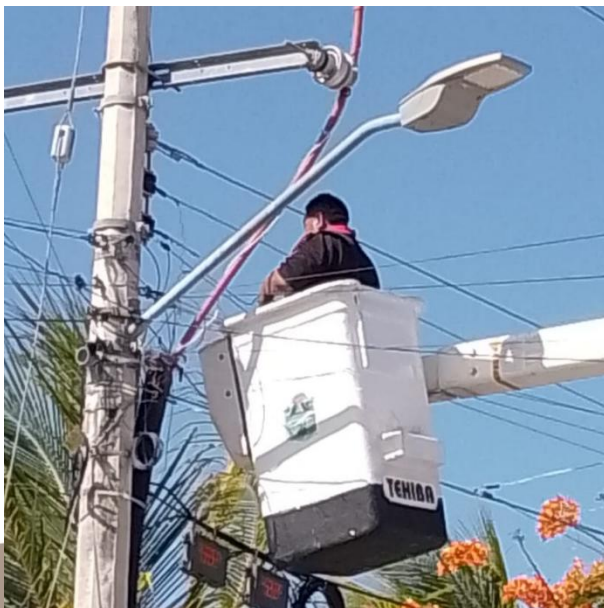
RECONEXIÓN DE LINEAS AEREAS PARA HABILITAR LUMINARIAS; C. 19 ENTRE AV. 28 Y C. 24, COL. TUMBEN-KAA.
