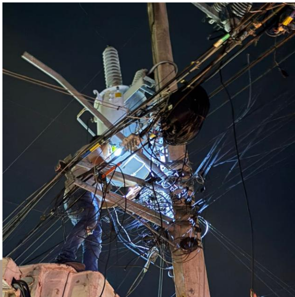
RECONEXIÓN DE ACOMETIDA; C. 4 OTE ENTRE C. CENTAURO NTE, COL. CENTRO.
