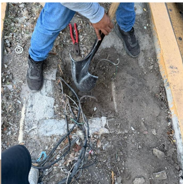
REHABILITACIÓN DE LINEAS QUEMADAS; AV. TULUM, COL. CENTRO.
