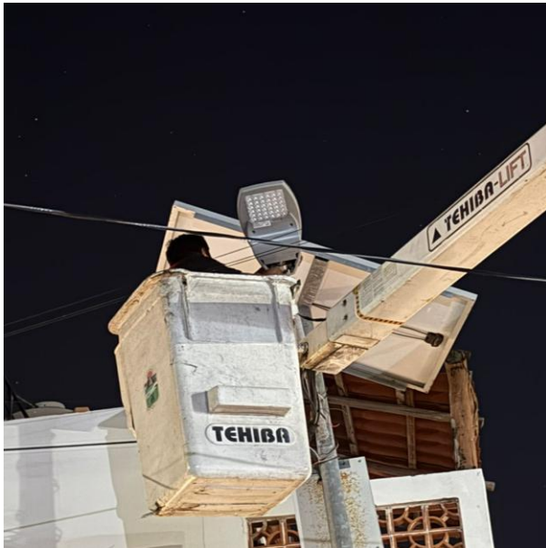
CAMBIO DE LUMINARIA OBSOLETA POR LED NUEVA; C. CENTAURO NTE ENTRE C. 2 OTE Y C. 4 OTE, COL. CENTRO.
