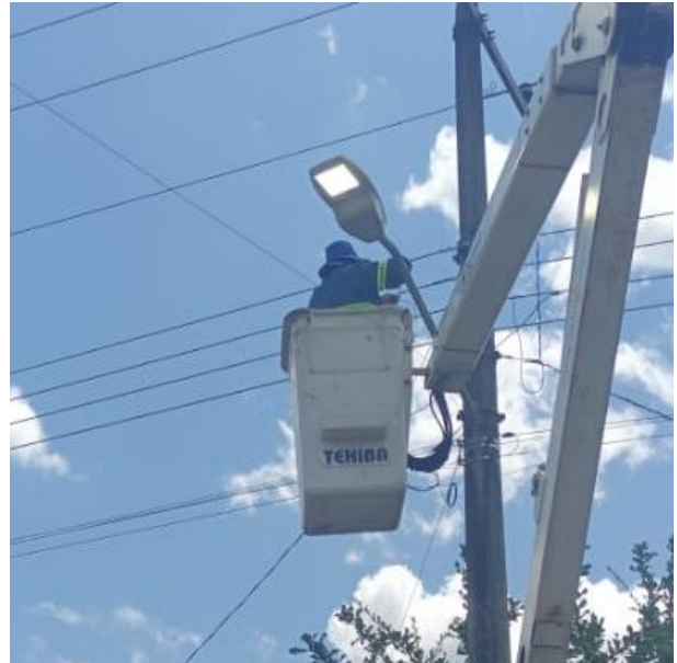
CAMBIO DE LUMINARIAS OBSOLETAS POR LED NUEVAS; POBLADO YAX-CHE.
