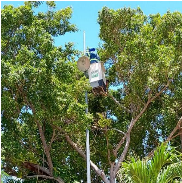
CAMBIO DE REFLECTOR OBSOLETO POR NUEVO; FRACC. VILLAS TULUM.
