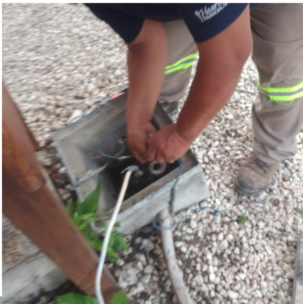
REHABILITACIÓN DE LÍNEAS SUBTERRÁNEAS; AV. 1 ENTRE C. RIO OTATE Y C. RIO CALIENTE, COL. TUMBEN-KAA.
