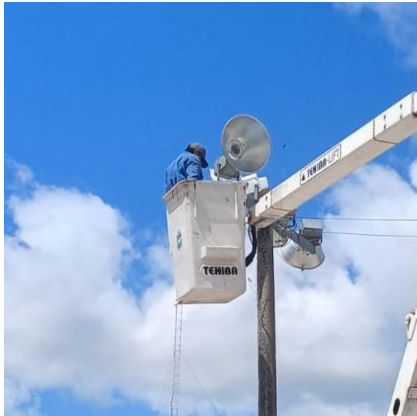
CAMBIO DE REFLECTORES OBSOLETOS POR NUEVOS; POBLADO YAX-CHE.
