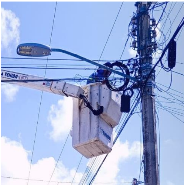
CAMBIO DE BRAZOS OBSOLETOS A LUMINARIAS; AV. LA SELVA ENTRE C. FAISAN, COL. EJIDO.
