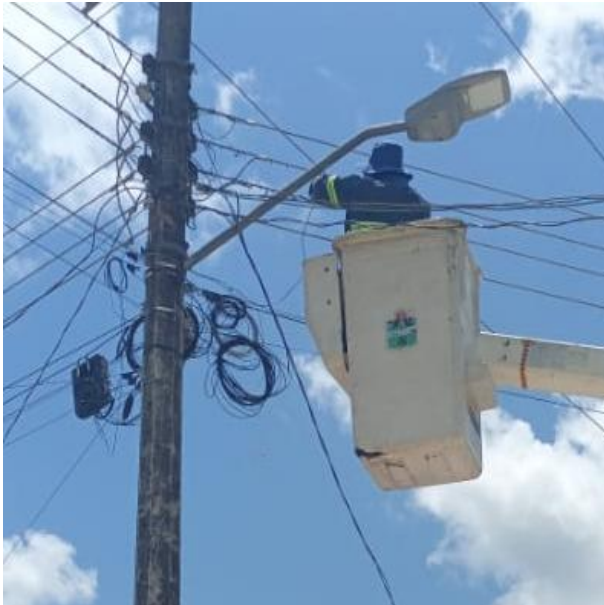
CAMBIO DE LUMINARIAS OBSOLETAS POR LED NUEVAS; POBLADO YAX-CHE.
