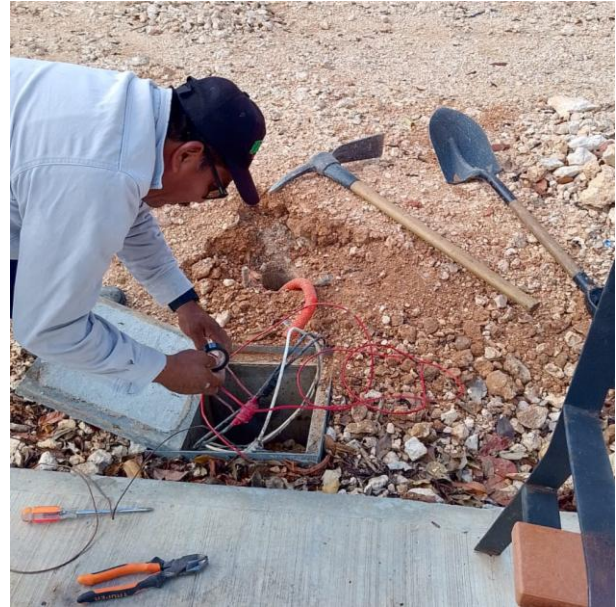
RECONEXIÓN DE LINEAS SUBTERRANEAS EN REGISTROS: POBLADO COBA.
