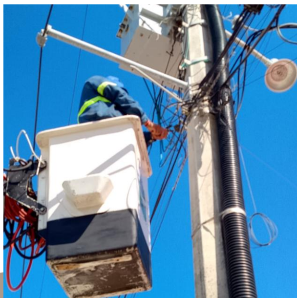
RECONEXIÓN DE LINEAS AEREAS PARA HABILITAR LUMINARIAS; POBLADO AKUMAL.
