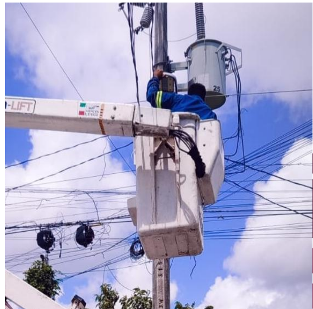
RECONEXIÓN DE LINEAS PARA HABILITAR LUMINARIA APAGADA; AV. KUKULKAN ENTRE C. GOLONDRINAS Y C. TEJÓN, COL. EJIDO
