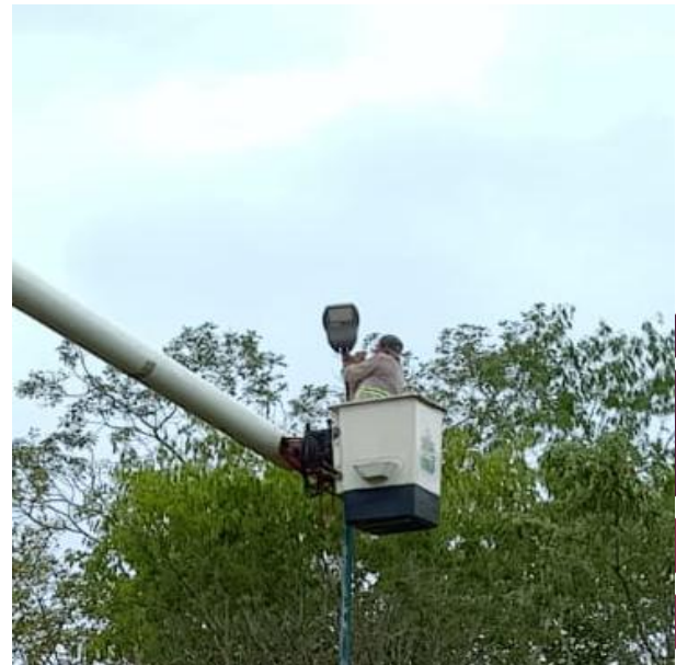
CAMBIO DE LUMINARIAS OBSOLETAS POR LED NUEVAS; POBLADO SAN PEDRO.
