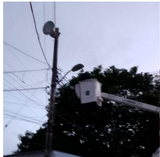
RECONEXIÓN DE LINEAS PARA HABILITAR LUMINARIAS; C. NEPTUNO PTE ENTRE C. AURORA SUR Y C. ALFA SUR, COL. CENTRO.
