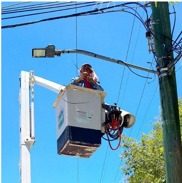
INSTALACIÓN DE LINEA AEREA PARA HABILITAR LUMINARIA; CIUDAD CHEMUYIL.
