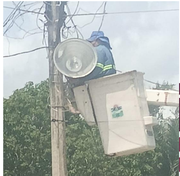
CAMBIO DE REFLECTOR OBSOLETO POR NUEVO; POBLADO CHAN-CHEN PALMAR.
