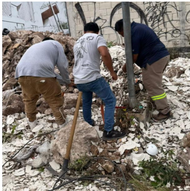
RECONEXIÓN DE LINEAS SUBTERRANEAS DAÑADAS POR MAQUINARIA PESADA; AV. 1 ENTRE AV. LA SELVA Y C. 24, COL. TUMBEN-KAA.
