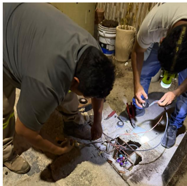
RECONEXIÓN DE LINEAS SUBTERRANEAS SULFATADAS; C. PALMA RAPIS ENTRE C. PALMA GUINEA Y BOULEVARD PALMAS, FRACC. PALMAS.
