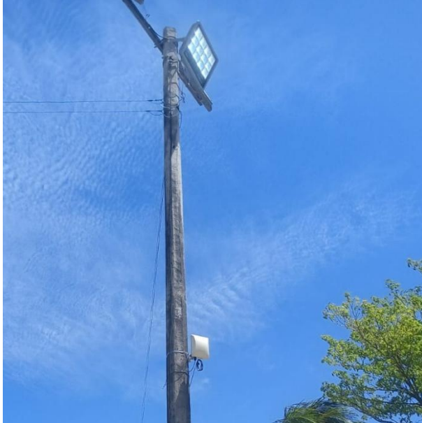
REPARACIÓN DE REFLECTOR; PARQUE DOS AGUAS, COL. CENTRO.
