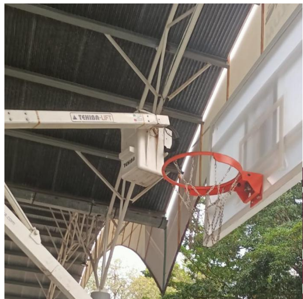
CAMBIO DE BASE Y FOTOCELDA PARA HABILITAR LUMINARIAS; UNIDAD DEPORTIVA, COL. CENTRO.
