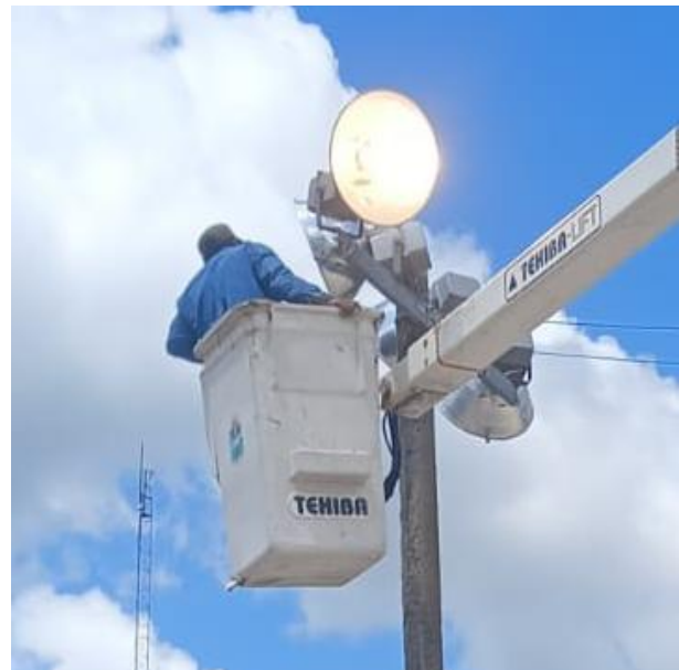
CAMBIO DE REFLECTORES OBSOLETOS POR NUEVOS; POBLADO YAX-CHE.
