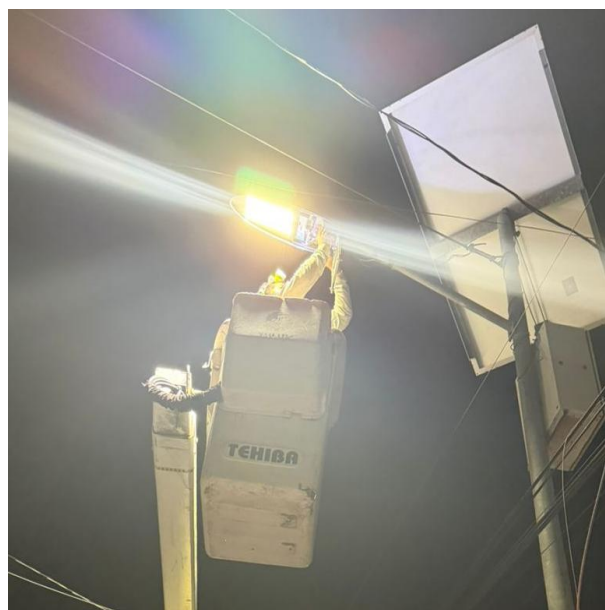
CAMBIO DE LUMINARIA OBSOLETA POR LED NUEVA; C. ORION NTE ENTRE C. 4 PTE Y C. 2 PTE, COL. CENTRO.
