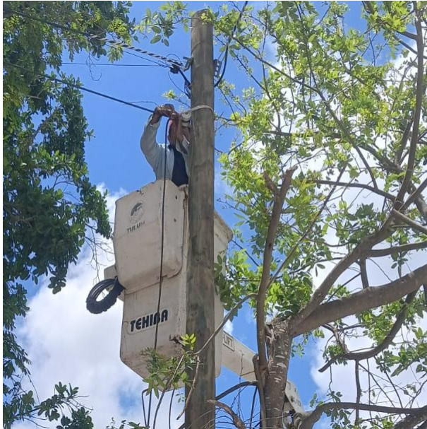
INSTALACIÓN DE LINEAS PARA HABILITAR LUMINARIA APAGADA; 20 AV NTE, FRACC. YA'AX TULUM.
