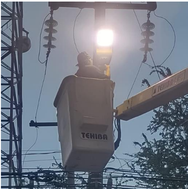
CAMBIO DE LUMINARIA OBSOLETA POR LED NUEVA; C. SOL OTE ENTRE C. ALFA SUR Y C. OMEGA SUR, COL. CENTRO.
