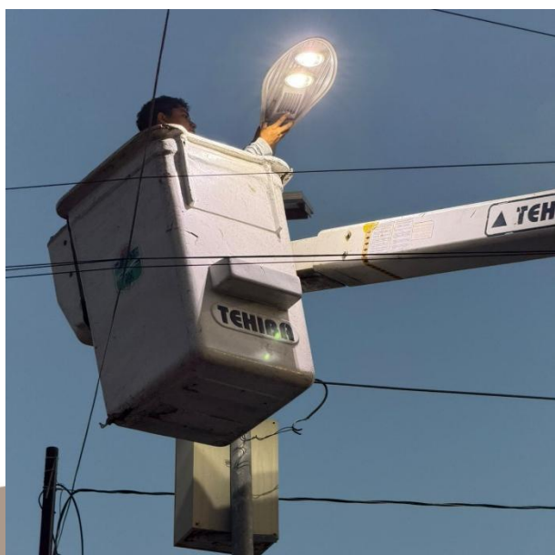
CAMBIO DE LUMINARIA OBSOLETA POR LED NUEVA; C. SAGITARIO OTE ENTRE AV. SATÉLITE Y C. CENTAURO NTE, COL. CENTRO.
