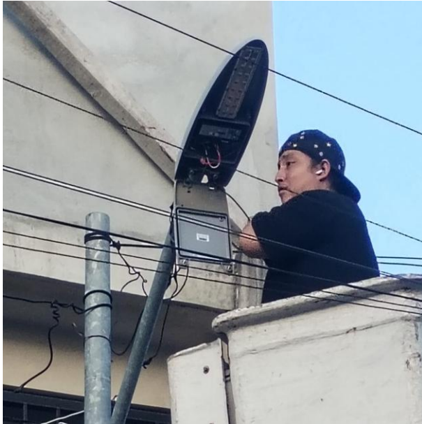
RECONEXIÓN DE LINEAS PARA AUTOMATIZAR LUMINARIA; C. BETA NTE ENTRE C. 2 PTE Y C. SAGITARIO PTE, COL. CENTRO.
