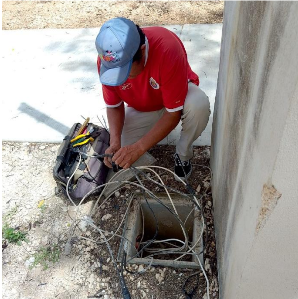
RECONEXIÓN DE LINEAS SUBTERRANEAS EN REGISTROS: POBLADO COBA.
