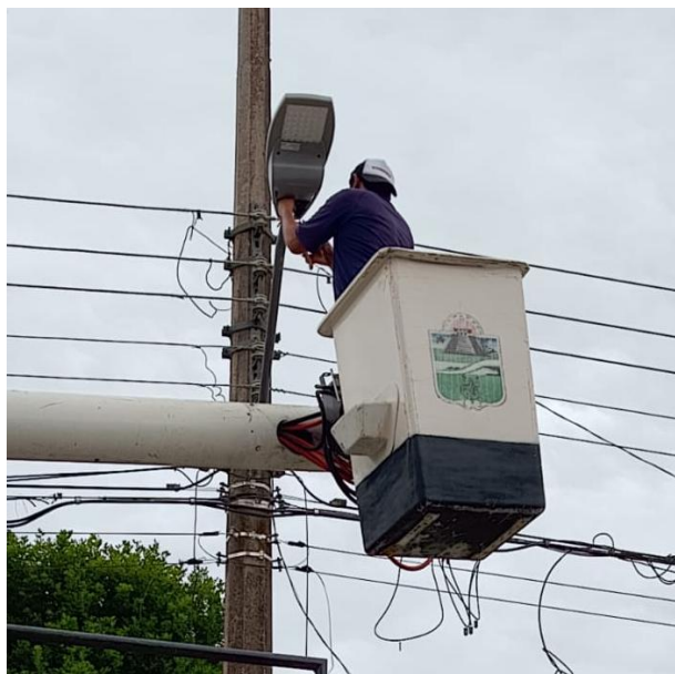
CAMBIO DE LAMPARAS OBSOLETAS POR LED NUEVAS; POBLADO COBA.
