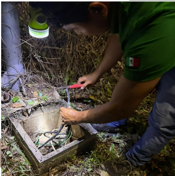
RECONEXIÓN DE LINEAS PARA HABILITAR LUMINARIA; AV. 1, COL. TUMBEN-KAA.
