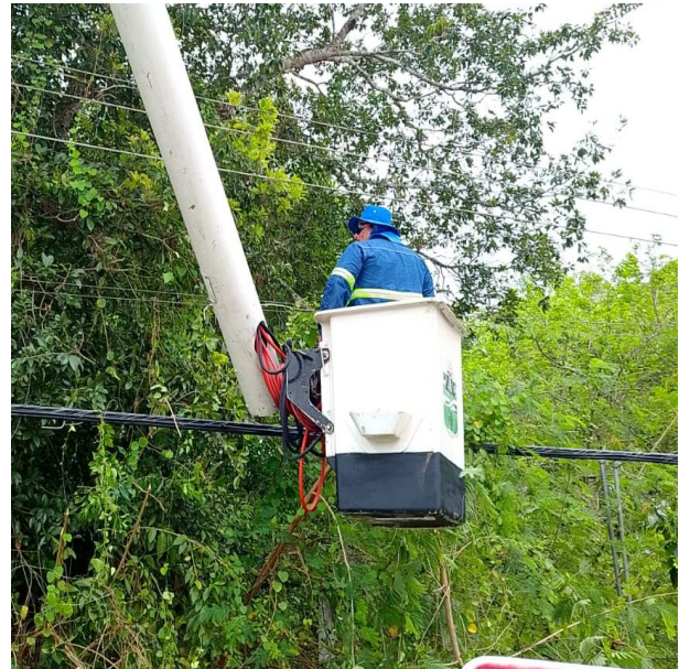
REHABILITACIÓN DE LINEAS AEREAS POR CORTO CIRCUITO; POBLADO COBA.
