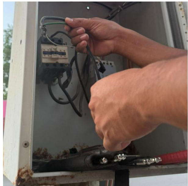
VERIFICACIÓN Y RECONEXIÓN DE ACOMETIDA PARA HABILITAR SECTOR; COL. MAYA PAX.
