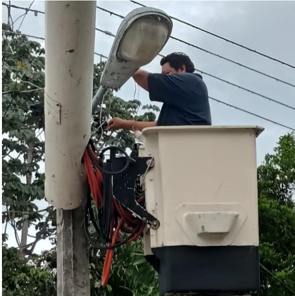
CAMBIO DE FOTOCELDAS OBSOLETAS POR NUEVAS; POBLADO MACARIO GOMEZ.
