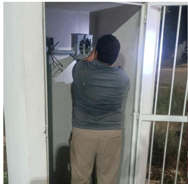
CAMBIO DE BREAK QUEMADO POR NUEVO PARA HABILITAR SECTOR; C. ALCATRAZ ENTRE C. AZUCENA, FRACC. YA'AX TULUM.
