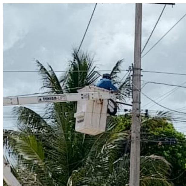
RECONEXIÓN DE LINEAS AEREAS DAÑADAS; POBLADO AKUMAL.
