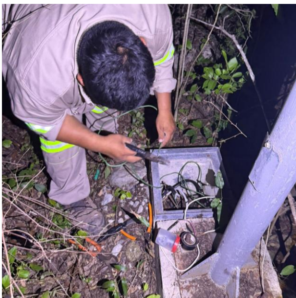
RECONEXIÓN DE LINEAS SULFATADAS PARA HABILITAR LUMINARIAS; COL. TUMBEN-KAA.
