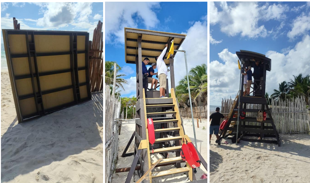
FOTO 20. Colocación de techo de plastimadera en la torre de la playa del pueblo
