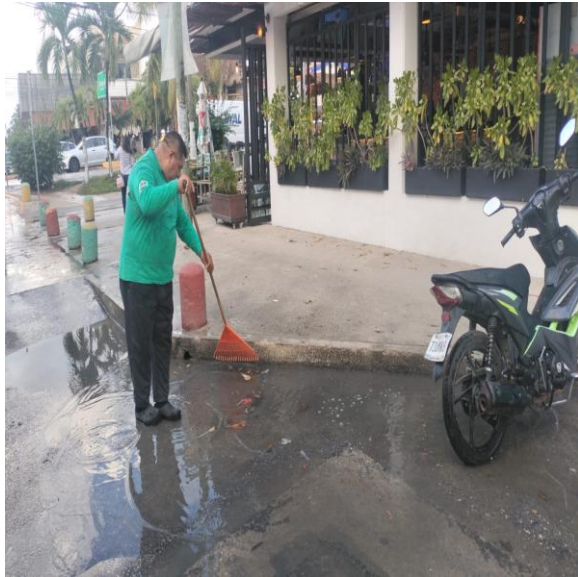
Calle beta sur entre av. Tulum y calle mercurio oriente (sector 04).
