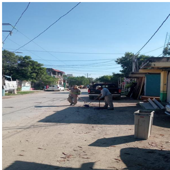
Calle mercurio oriente entre av. osiris sur y av. satélite sur (sector 04).
