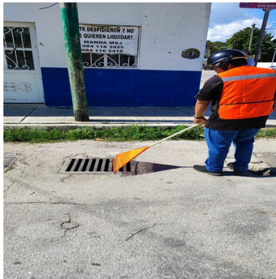
Limpeiza de rejillas. Calle alfa norte entre calle 2 poniente y calle 4 poniente; colonia mayapax.
