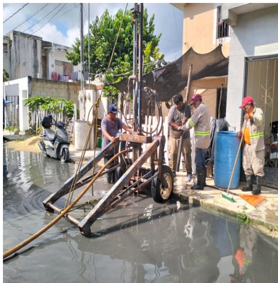
Desazolve. Calle huracán Rossana entre calle huracán Paulina; fraccionamiento huracanes, (Pozo 01).
