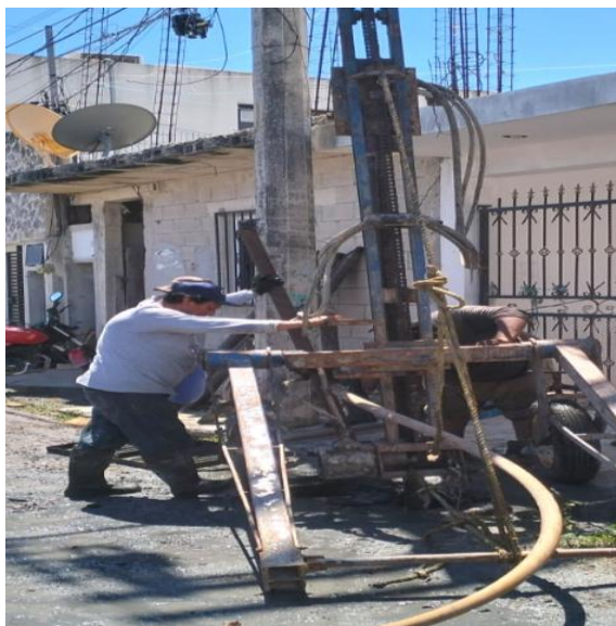
Desazolve. Calle gama oriente entre av. satélite sur; colonia lak'iin.
