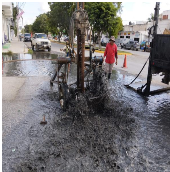
Desazolve. Calle kii's entre calle géminis norte; fraccionamiento guerra de castas, (Pozo 02).
