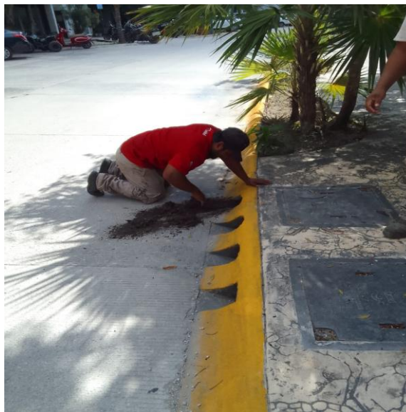
Limpeza de rejillas. Av. juanek entre calle yaxchilan; fraccionamiento aldea zama.
