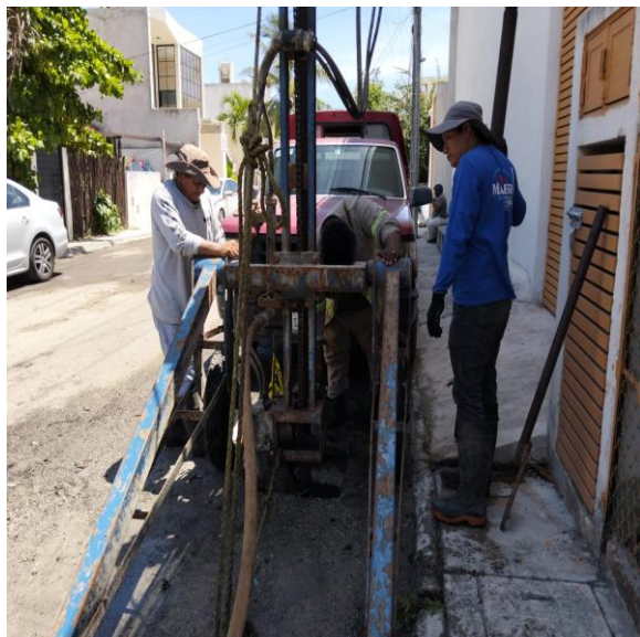
Desazolve. Calle 4 oriente entre calle 15 y calle 17; fraccionamiento villas Tulum, (Pozo 02).
