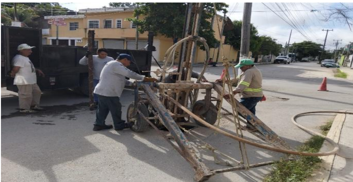
Desazolve. Av. kukulkán entre calle chac-mol; colonia ejido.
