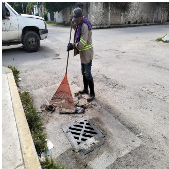
Limpeza de rejillas. Calle asteroides oriente entre calle ori3n sur; colonia lak'iin.
