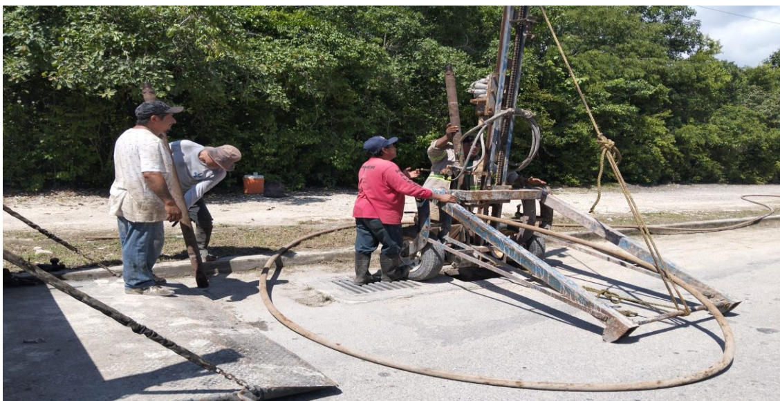
Desazolve. Av. 10 norte entre av. 2 norte y av. Tulum; fraccionamiento las palmas, (Pozo 01).
