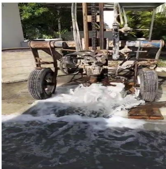
Desazolve. Calle 5 sur entre calle 4 oriente; fraccionamiento villas Tulum.
