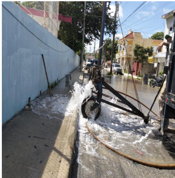
Desazolve. Calle júpiter poniente entre calle mercurio sur; colonia maya.
