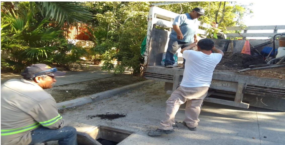
Limpieza de pozos. Av. aldea zama; fraccionamiento aldea zama, (Pozo 01).
