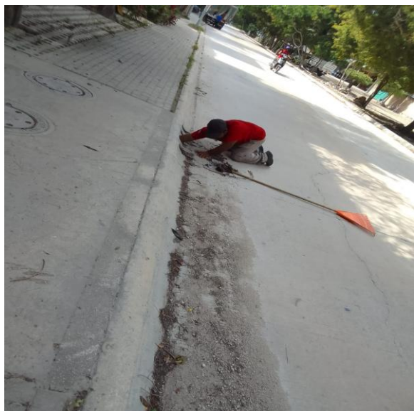
Limpieza de rejillas. Av. balam dzancab entre calle kinich ahw; fraccionamiento aldea zama.
