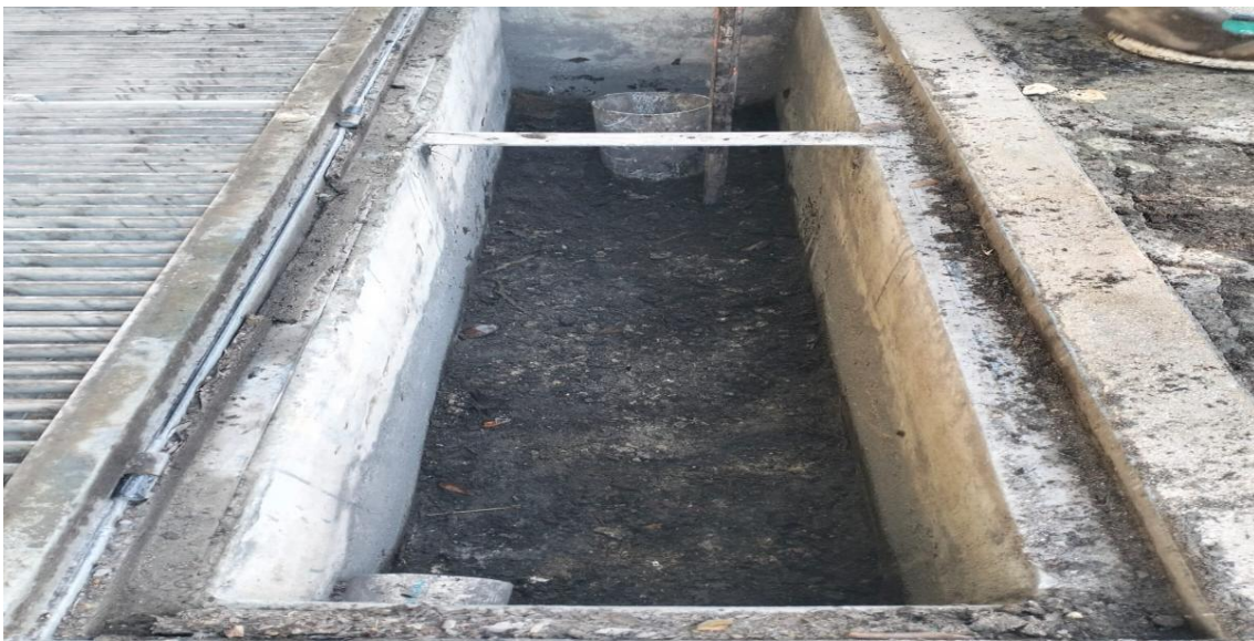
Limpieza de pozos. Av. aldea zama entre glorieta y av. consejo ciudadano; fraccionamiento aldea zama.
