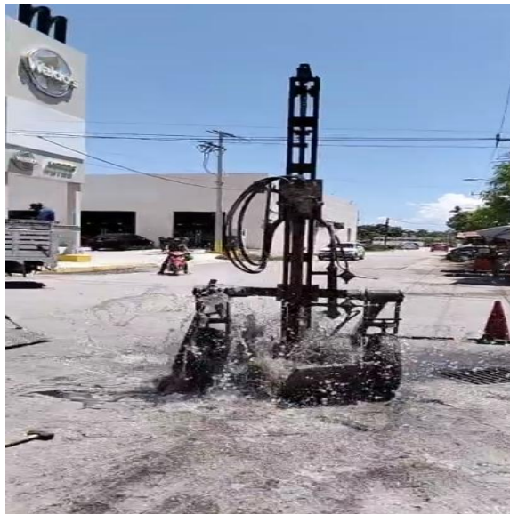
Desazolve. Av. satélite norte entre calle tun-k'ul; fraccionamiento guerra de castas.
