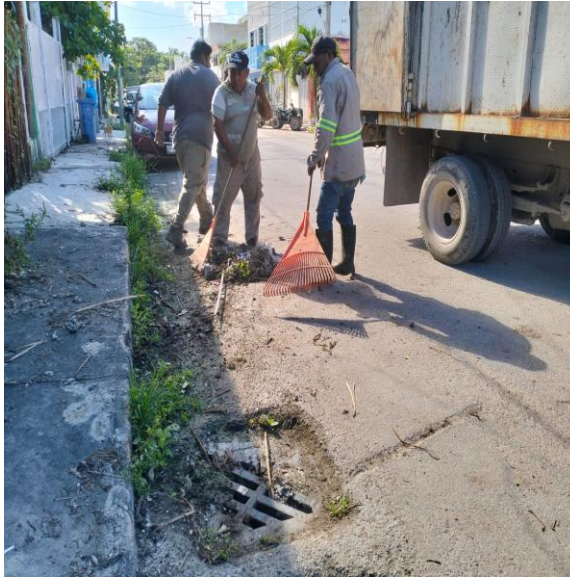
Limpeza de rejillas. Calle huracán Beulah entre calle huracán paulina; fraccionamiento huracanes.
