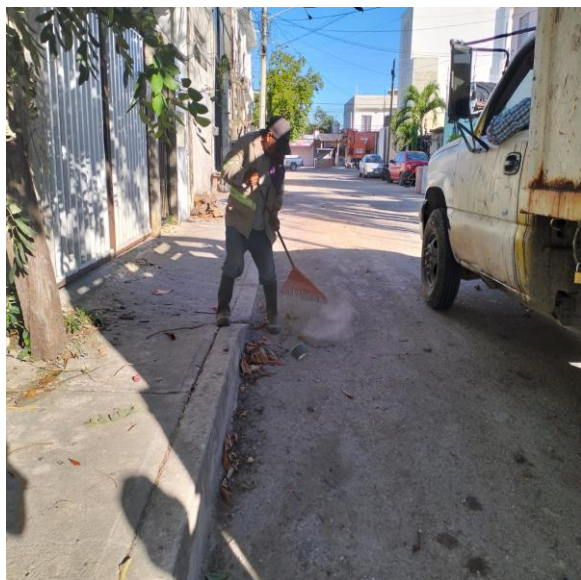
Limpeza de rejillas. Calle chikil entre av. ook-k'ot; colonia mayapax.
