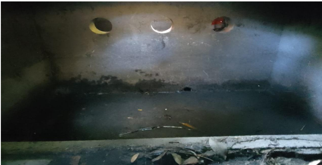
Limpieza de pozos. Av. balam dzancab entre calle kinich-ah; fraccionamiento aldea zama.
