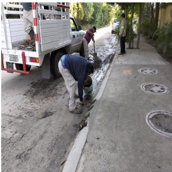
Limpieza de rejillas. Av. juanek entre calle izamna; fraccionamiento aldea zama.
