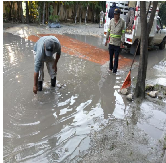
Limpieza de rejillas. Av. aldea zama; fraccionamiento aldea zama.
