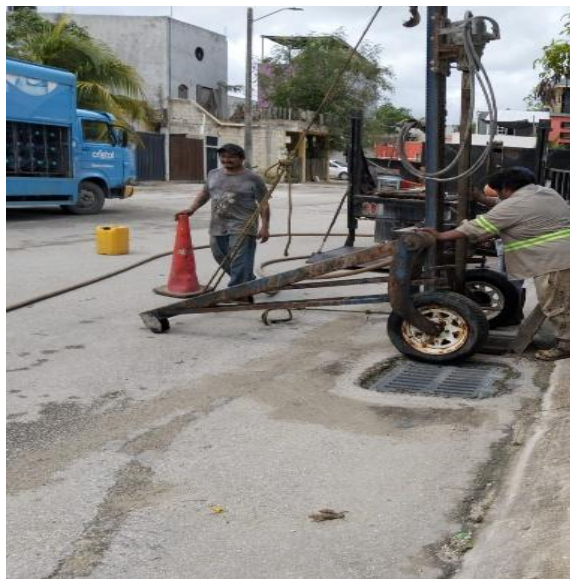
Desazolve. Calle orión sur entre av. Tulum; colonia centro.
