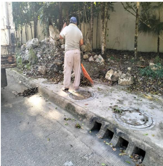
Limpieza de rejillas. Av. Itzamná; fraccionamiento aldea zama.
