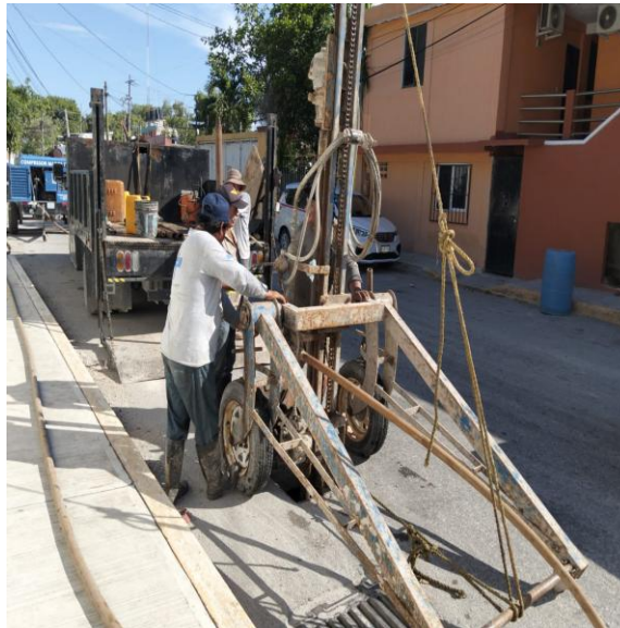
Desazolve. Calle saturno sur entre calle ontario poniente; colonia maya.
