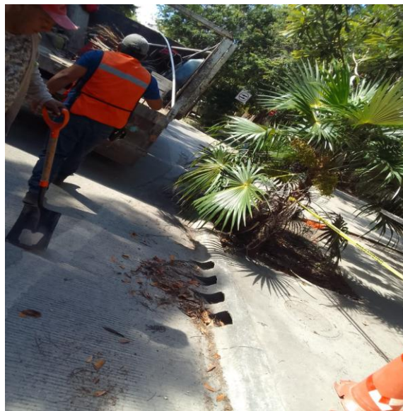
Limpieza de rejillas. Calle and kaan entre calle Itzamná; fraccionamiento aldea zama.
