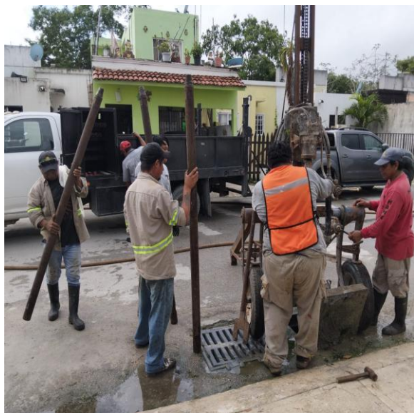
Desazolve. Calle palma abanico entre boulevard palmas Tulum; fraccionamiento las palmas, (Pozo 02).
