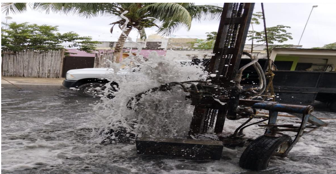
Desazolve. Calle palmas kerpis entre boulevard palmas Tulum; fraccionamiento las palmas.
