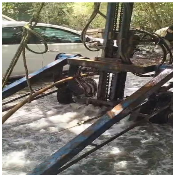
Desazolve. Calle chemuyil entre calle 4 oriente; fraccionamiento villas Tulum.
