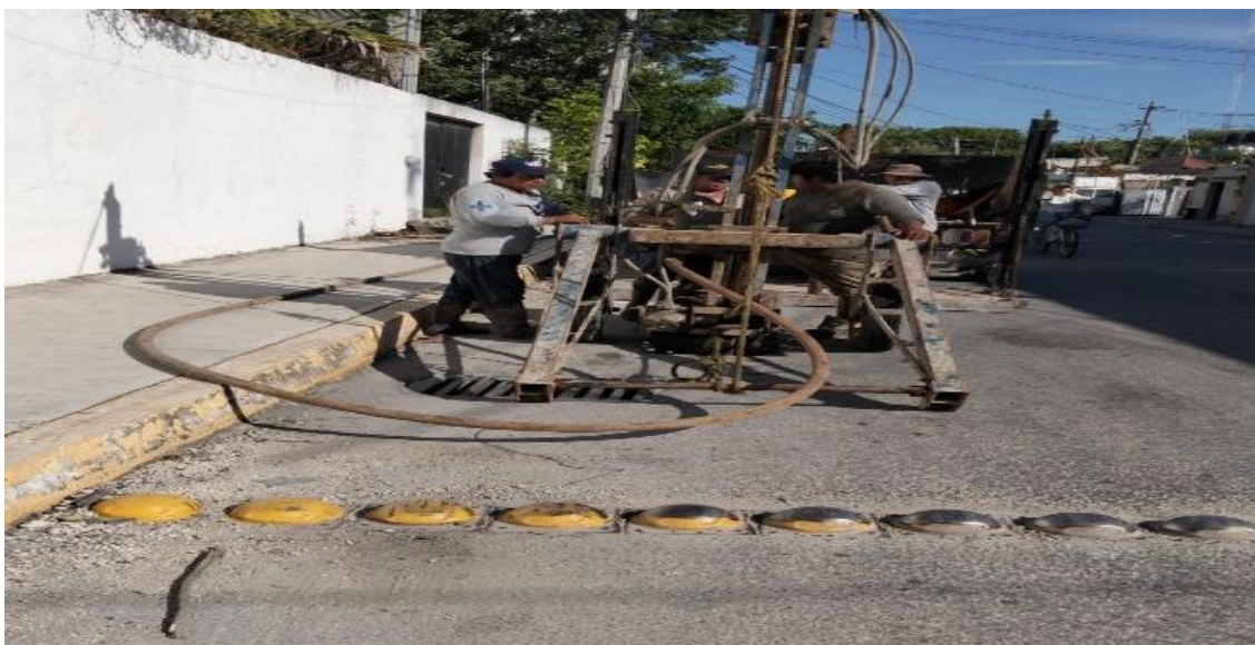
Desazolve. Calle 11 entre calle 32; colonia ejido.
