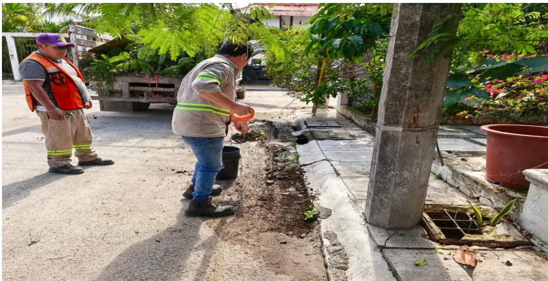
Limpieza de rejillas. Calle 17 entre calle 2 bis oriente; fraccionamiento villas Tulum.
