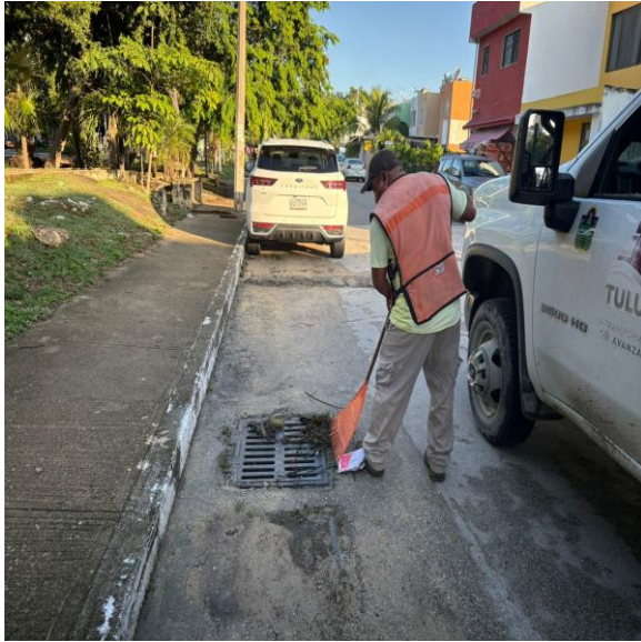
Limpieza de rejillas. Boulevard palma Tulum; fraccionamiento las palmas.
