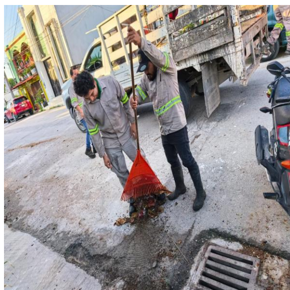
Limpieza de rejillas. Calle huracán Irene entre calle huracán Mitch; fraccionamiento huracanes.
