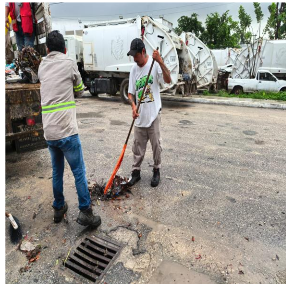
Limpeza de rejillas. Calle naval entre calle faisán; colonia tumben kaa.
