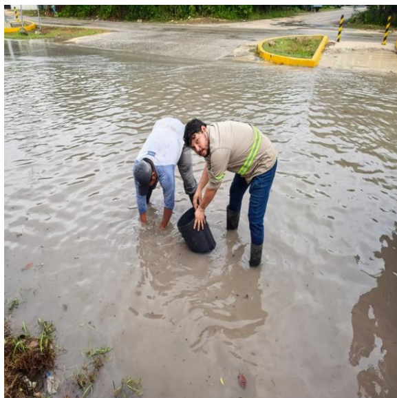
Limpieza de rejillas. Av. la selva; colonia tumben kaa.
