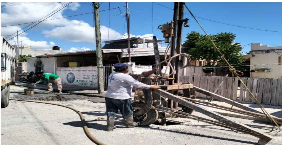
Desazolve. Calle sol oriente entre av. satélite sur; colonia lak'iin.
