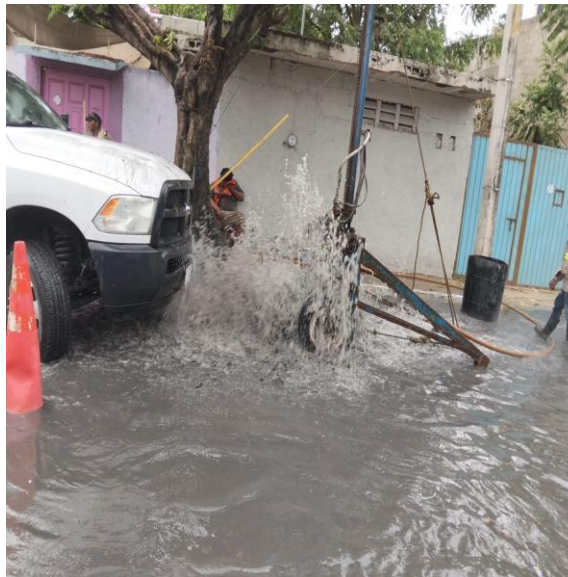
Desazolve. Calle luna poniente entre calle aries sur; colonia maya.
