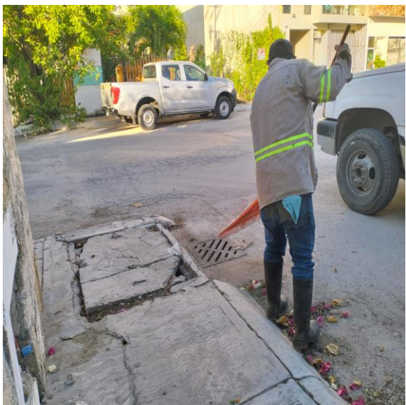
Limpieza de rejillas. Calle 2 a oriente entre calle 3 sur; fraccionamiento villas Tulum.
