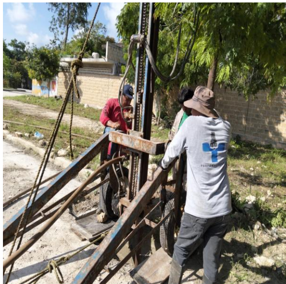
Desazolve. Av. 10 norte entre av. 4 norte y calle palma Reyna; fraccionamiento las palma.
