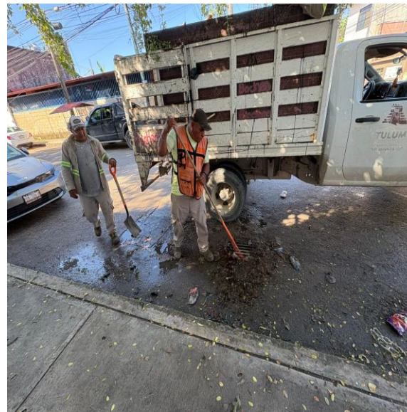
Limpeza de rejillas. Calle sol poniente entre calle omega sur; colonia maya.
