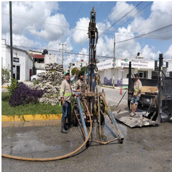
Desazolve. Av. satélite norte entre calle kii's; fraccionamiento guerra de castas.
