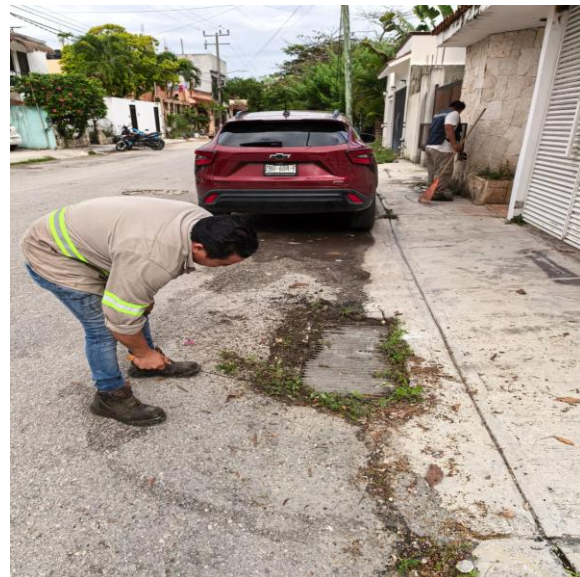
Limpeza de rejillas. Calle 11 entre calle 2 oriente; fraccionamiento villas Tulum.
