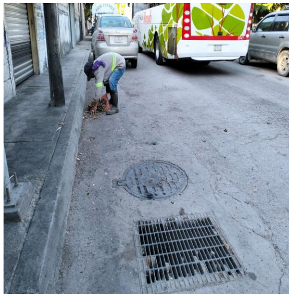
Limpeza de rejillas. Calle sagitario oriente entre calle osiris norte; colonia centro.
