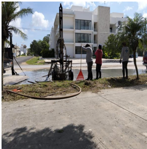
Desazolve. Av. 10 norte entre la av. 2 norte; fraccionamiento las palmas.
