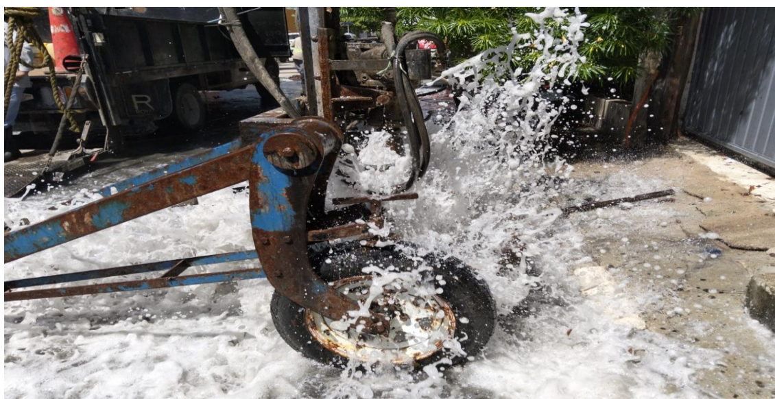
Desazolve. Calle 4 oriente entre calle 15 y calle 17; fraccionamiento villas Tulum, (Pozo 01).
