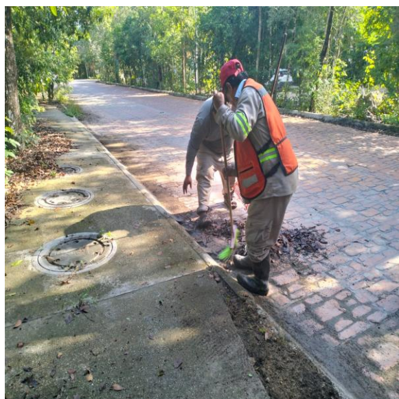
Limpieza de rejillas. Calle box-cay entre calle Itzamná; fraccionamiento aldea zama.
