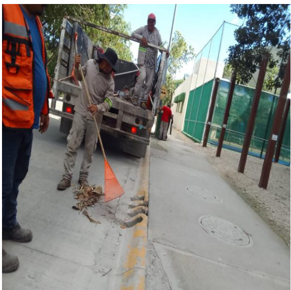
Limpeza de rejillas. Av. juanek entre calle alfa sur; fraccionamiento aldea zama.
