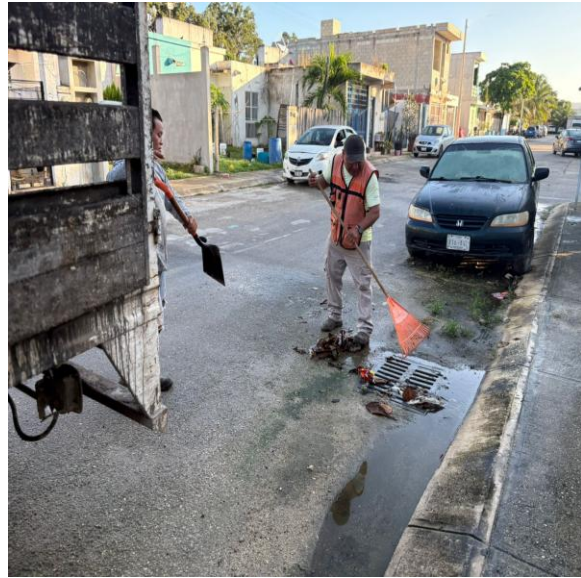
Limpieza de rejillas. Calle palma entre calle palma guinea; fraccionamiento las almas.
