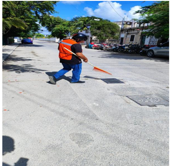
Limpieza de rejillas. Calle júpiter norte entre calle 2 poniente y calle 4 oriente; colonia mayapax.
