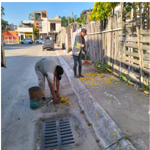
Limpeza de rejillas. Calle palmas reyna; fraccionamiento las palmas.
