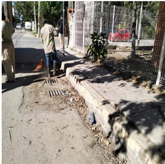
Limpeza de rejillas. Calle sol oriente entre calle huracán Gilberto; fraccionamiento huracanes.
