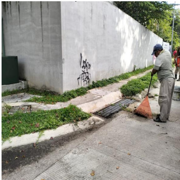
Limpeza de rejillas. Av. aldea zama entre calle yaxché y calle muun; fraccionamiento aldea zama.
