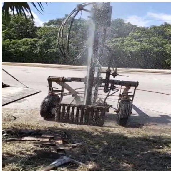
Desazolve. Av. 10 norte entre av. 2 norte y av. Tulum; fraccionamiento las palmas, (Pozo 02).
