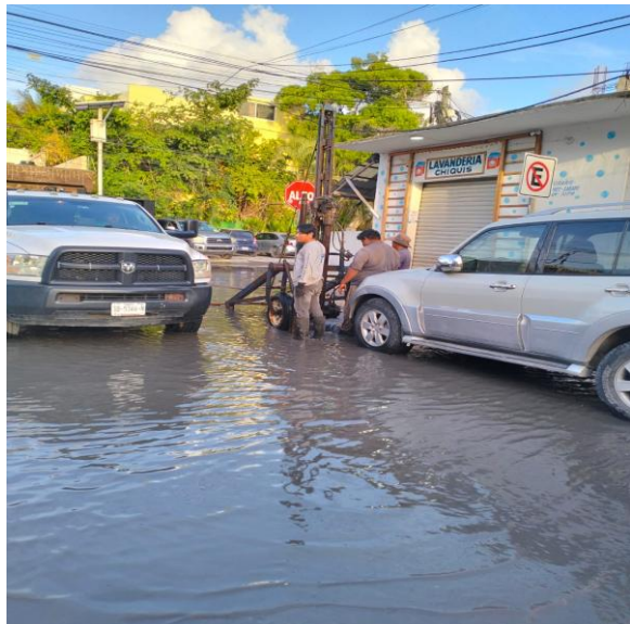
Desazolve. Calle palenque entre calle ontario; colonia la veleta.
