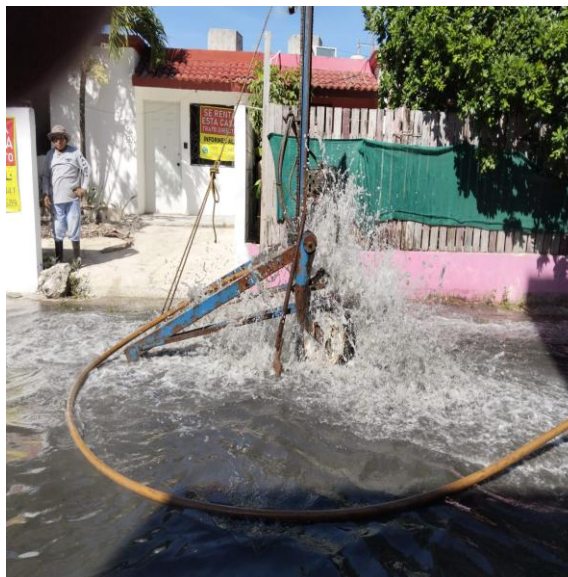
Desazolve. Calle 15 entre calle 4 oriente; fraccionamiento villas Tulum.
