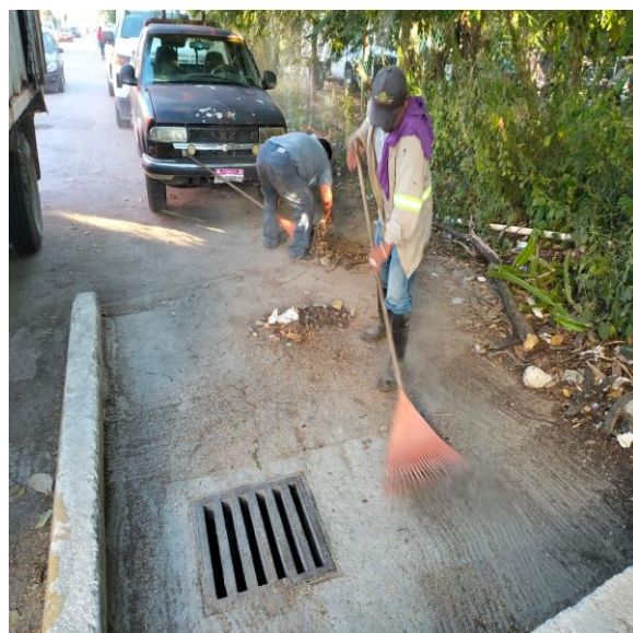
Limpieza de rejillas. Calle centauro norte entre calle polar poniente; colonia centro.
