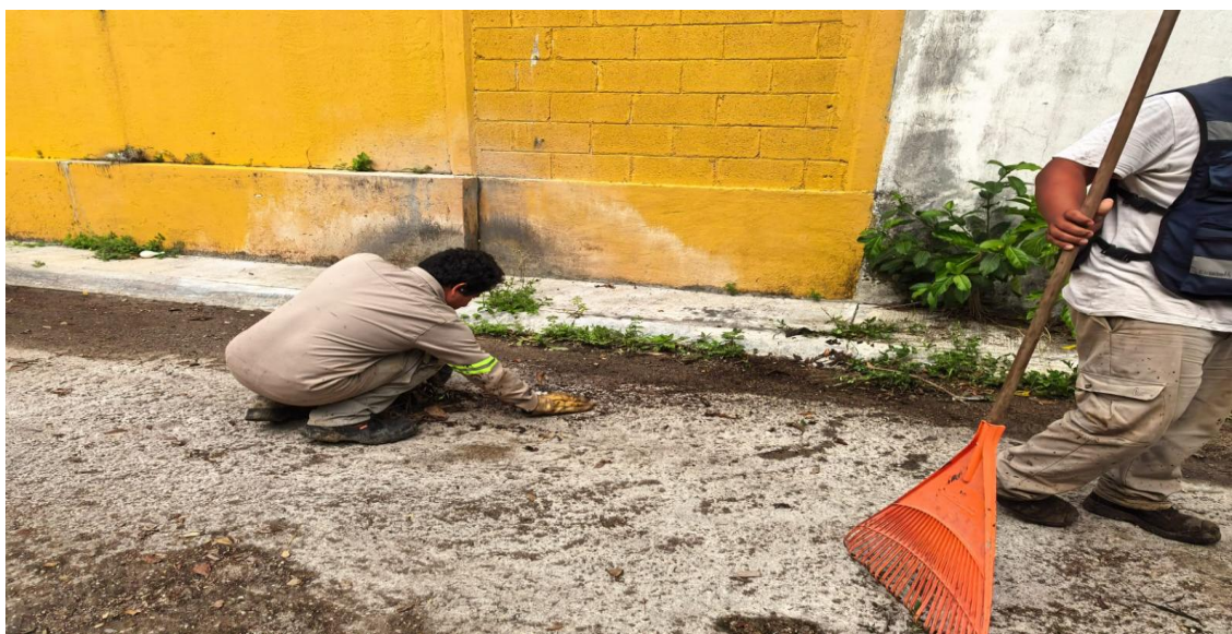
Limpieza de rejillas. Calle 17 entre calle 2 bis a oriente; fraccionamiento villas Tulum.
