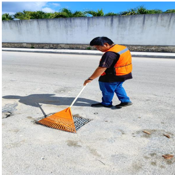
Limpieza de rejillas. Calle júpiter norte entre calle 4 poniente y calle tun-k'ul; colonia mayapax.
