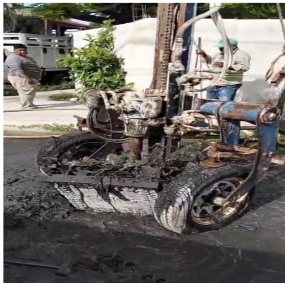
Desazolve. Calle júpiter sur entre calle luna poniente; colonia maya.
