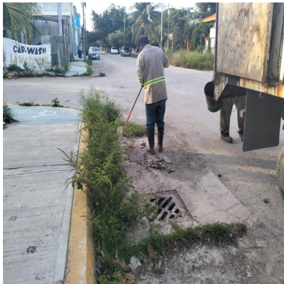
Limpeza de rejillas. Av. 18 entre calle 19; colonia tumben kaa.
