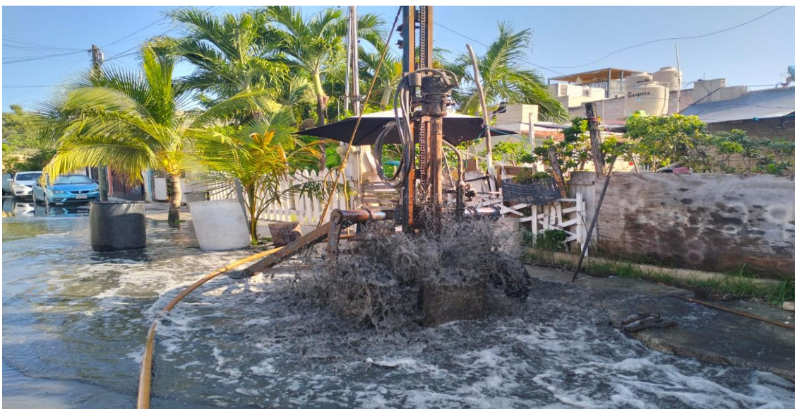
Desazolve. Calle huracán Rossana entre calle huracán Paulina; fraccionamiento huracanes, (Pozo 02).
