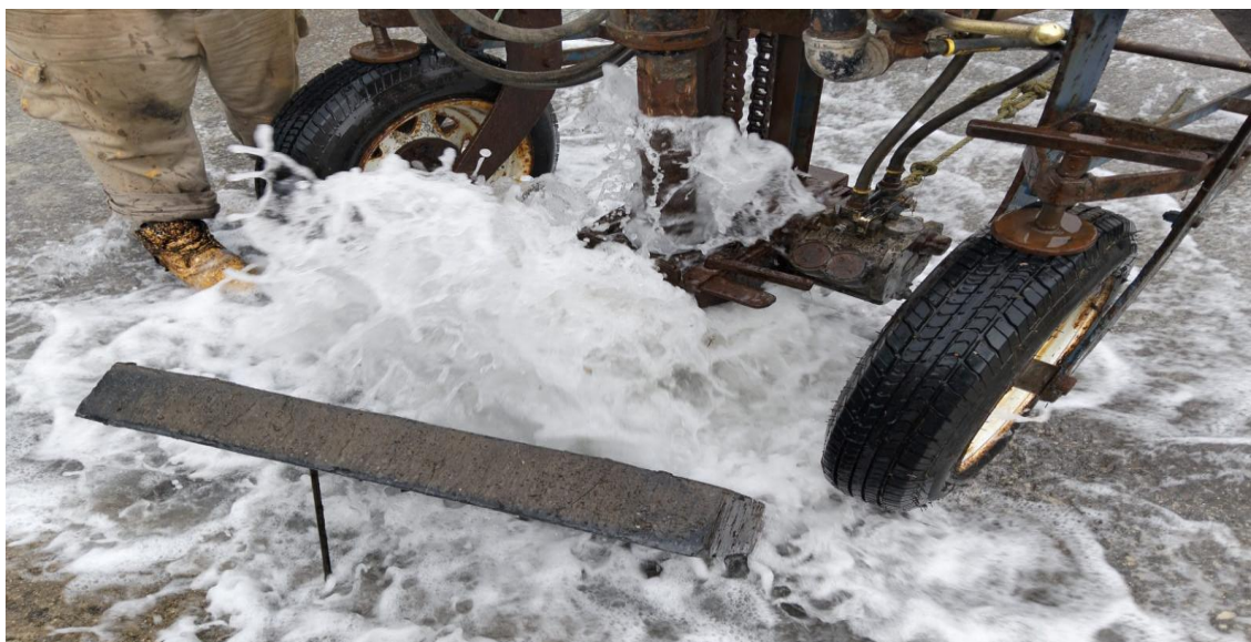
Desazolve. Calle palma navidad entre boulevard palmas Tulum; fraccionamiento las palmas, (Pozo 02).
