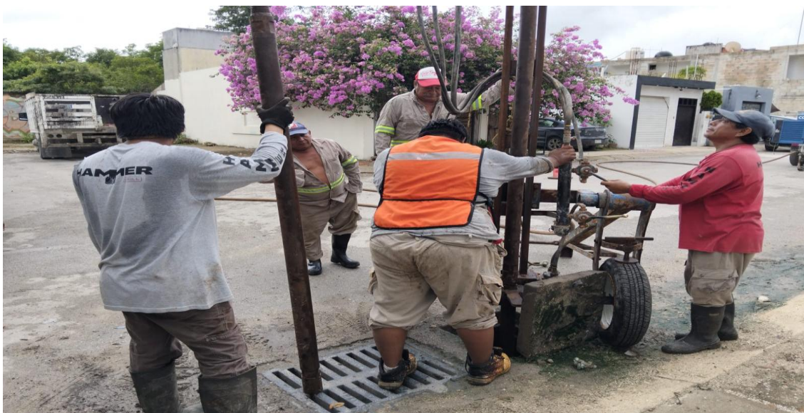
Desazolve. Calle palma abanico entre boulevard palmas Tulum; fraccionamiento las palmas, (Pozo 01).
