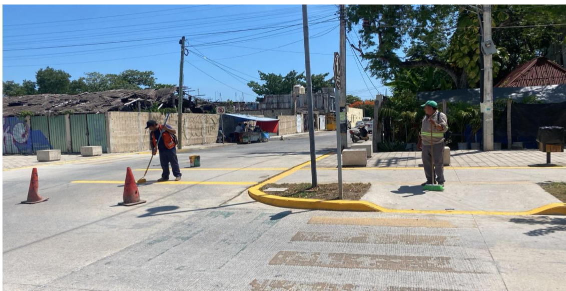
Limpieza de rejillas. Av. osiris sur entre calle sol oriente y calle venus oriente; colonia centro.
