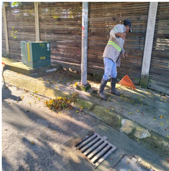
Limpeza de rejillas. Calle sagitario oriente; fraccionamiento guerra de castas.
