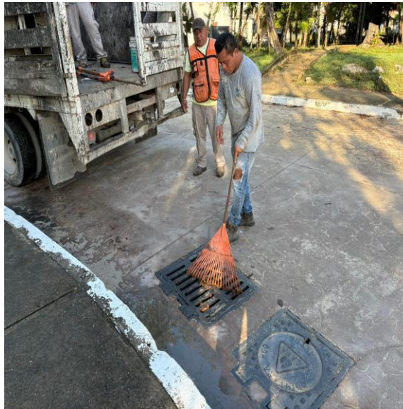
Limpieza de rejillas. Calle palma reyna entre boulevard palmas Tulum; fraccionamiento las palmas.
