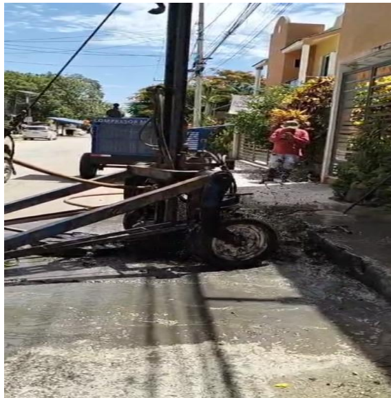
Desazolve. Calle mercurio poniente entre calle palenque; colonia la veleta.
