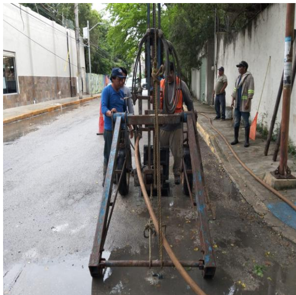
Desazolve. Calle neptuno poniente entre calle luna sur; colonia maya.
