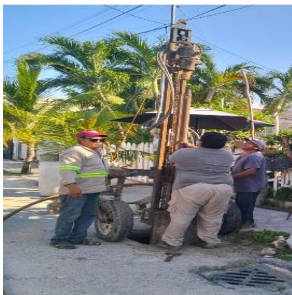
Desazolve. Calle neptuno oriente y calle gama oriente; colonia lak'iin, (Pozo 01).
