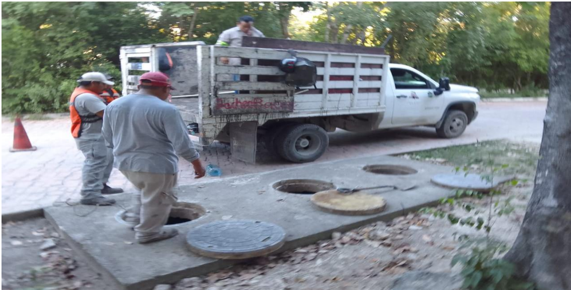
Limpieza de pozos. Calle box-cay entre av. Itzamná; fraccionamiento aldea zama.
