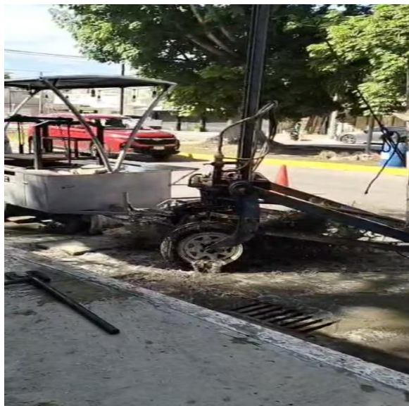
Desazolve. Av. satélite norte entre calle sagitario oriente; colonia centro.
