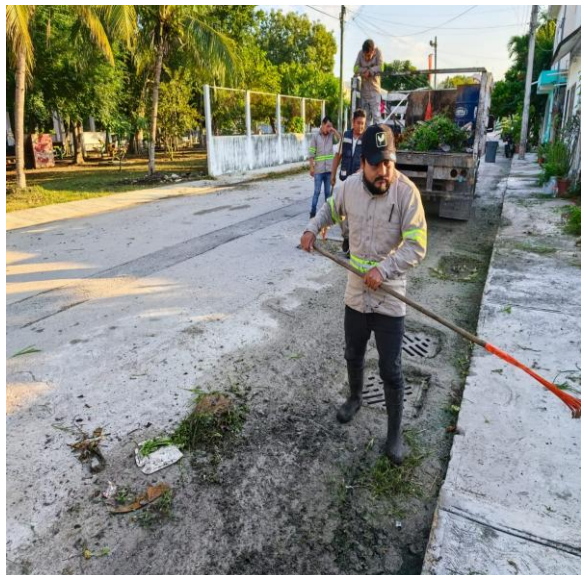
Limpieza de rejillas. Calle huracán Mitch entre calle huracán Rossana y calle huracán Janet; fraccionamiento huracanes.
