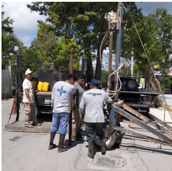
Desazolve. Calle chemuyil entre av. kukulkán; colonia ejido.
