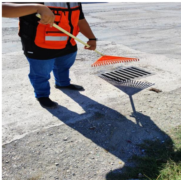
Limpeiza de rejillas. Calle 2 poniente entre calle osiris norte y calle beta norte; colonia mayapax.
