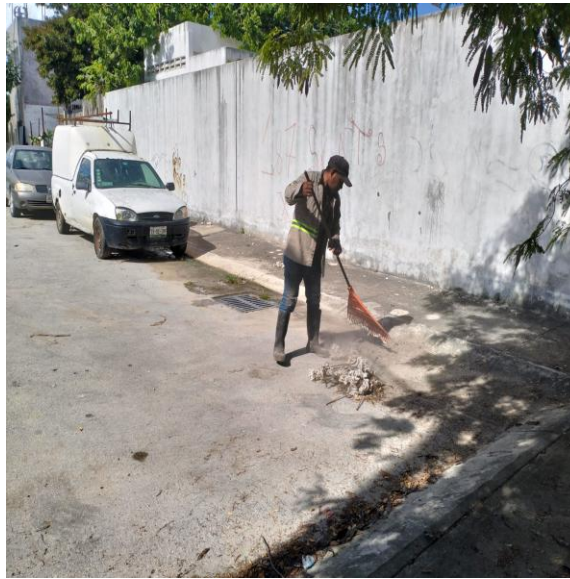
Limpeza de rejillas. Calle palma abanico; fraccionamiento las palmas.
