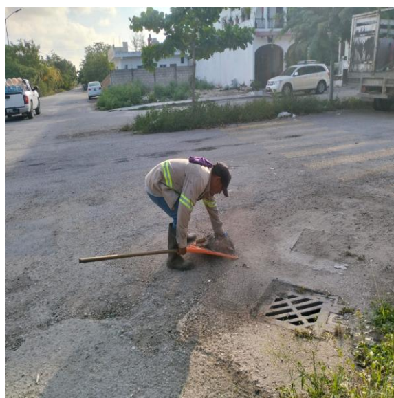
Limpeiza de rejillas. Av. yodzonot entre av. 18; colonia tumben kaa.
