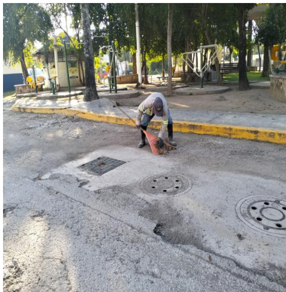
Limpeza de rejillas. Calle 19; colonia tumben kaa.
