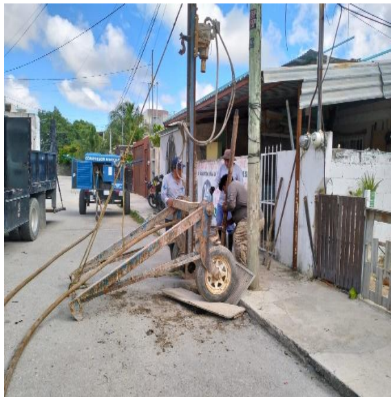
Desazolve. Calle asteroides oriente entre av. satélite sur; colonia lak'iin.
