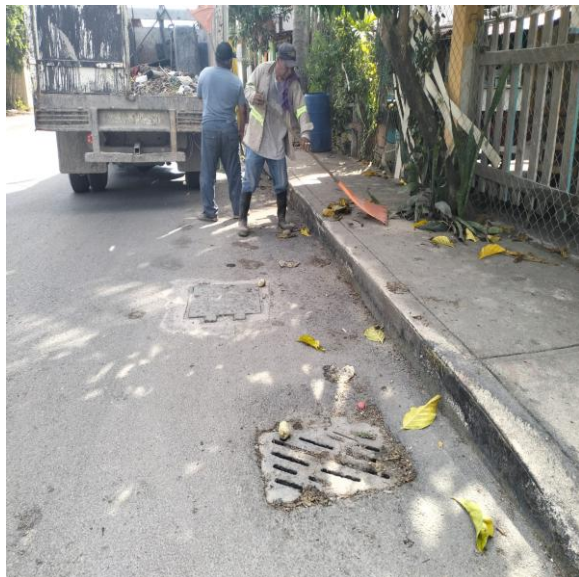
Limpieza de rejillas. Calle sian kan entre calle golondrinas; colonia ejido.
