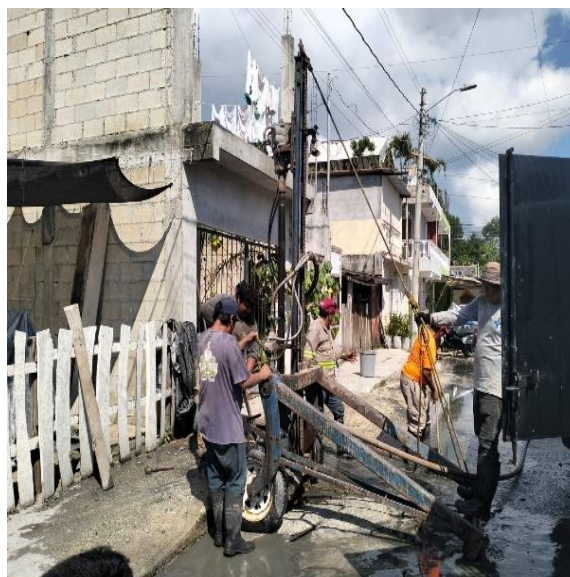
Desazolve. Calle neptuno oriente entre av. satélite sur; colonia lak'iin.
