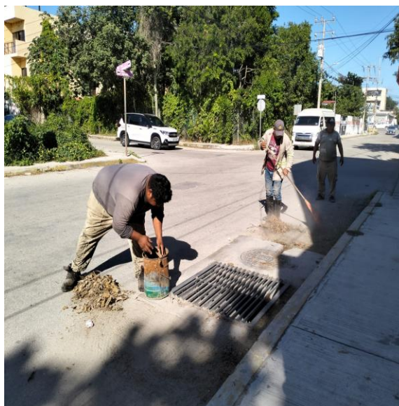
Limpeza de rejillas. Calle libra sur entre calle andrómeda oriente; fraccionamiento huracanes.
