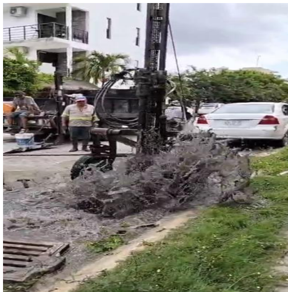
Desazolve. Calle Cecilio Chi entre calle libra norte; fraccionamiento guerra de castas.
