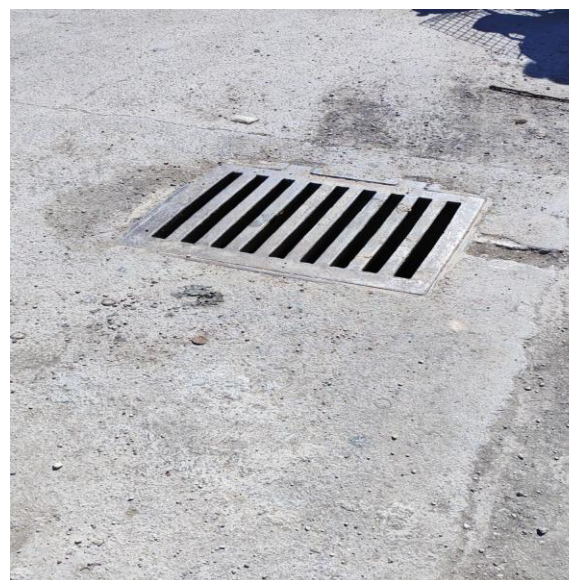
Limpeiza de rejillas. Calle 2 poniente entre calle orión norte y calle centauro norte; colonia mayapax.
