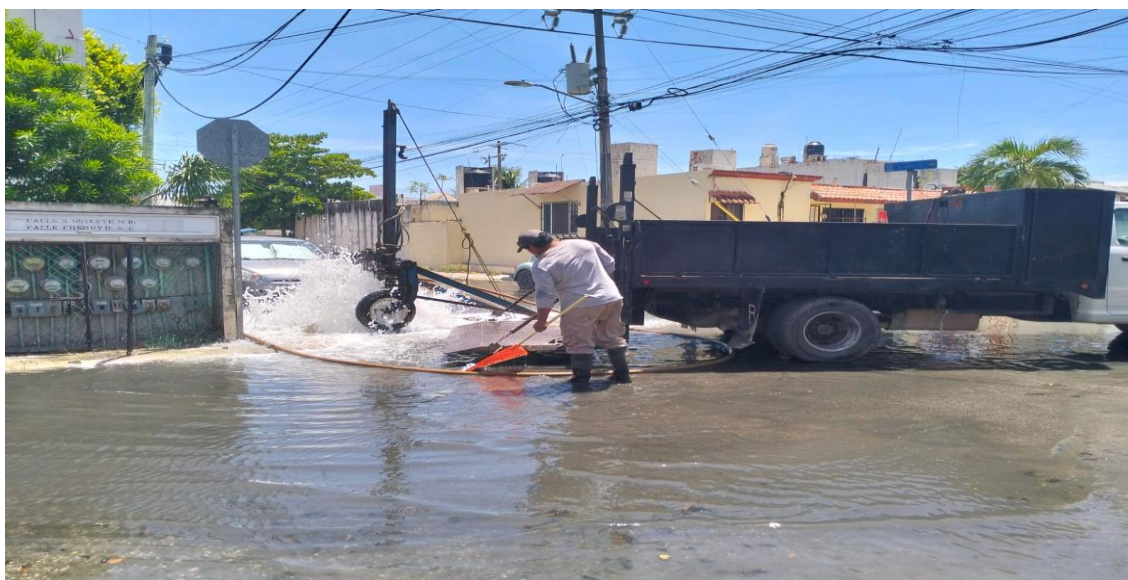
Desazolve. Calle 4 oriente entre calle chemuyil; fraccionamiento villas Tulum.
