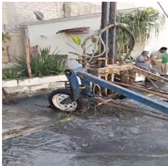
Desazolve. Calle 3 sur entre calle 2 bis a oriente; fraccionamiento villas Tulum.
