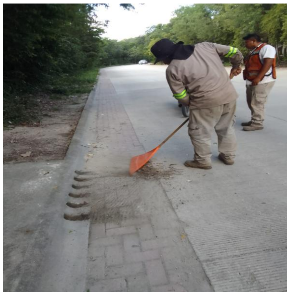
Limpeiza de rejillas. Av. aldea zama entre calle mar y miel; fracconamiento aldea zama.
