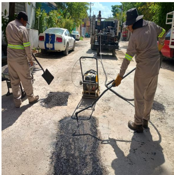
Bacheo. Calle mercurio oriente entre av. osiris sur y calle beta sur; colonia lak'iin.
