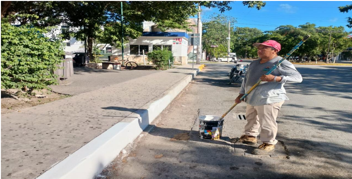
Limpieza de rejillas. Av. satélite entre calle neptuno oriente y calle gama oriente; parque la croc, colonia lak'iin.
