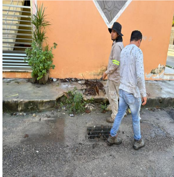
Limpeza de rejillas. Calle mercurio poniente entre calle palenque; colonia la veleta.
