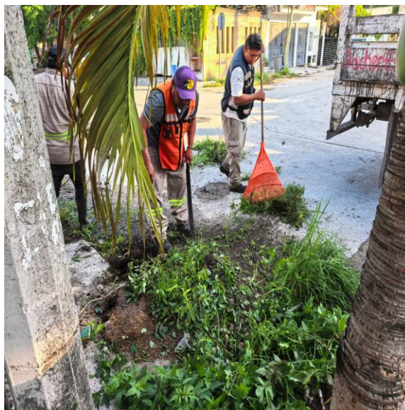
Limpieza de rejillas. Calle huracán Mitch entre cale huracán Irene; fraccionamiento huracanes.
