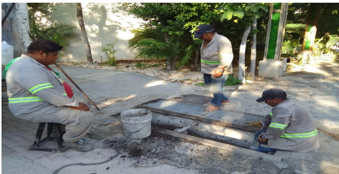
Limpieza de pozos. Av. aldea zama; fraccionamiento aldea zama, (Pozo 02).
