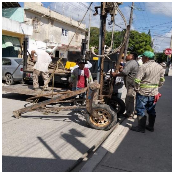
Desazolve. Calle tumben-ha entre calle chan-chen; colonia ejido.
