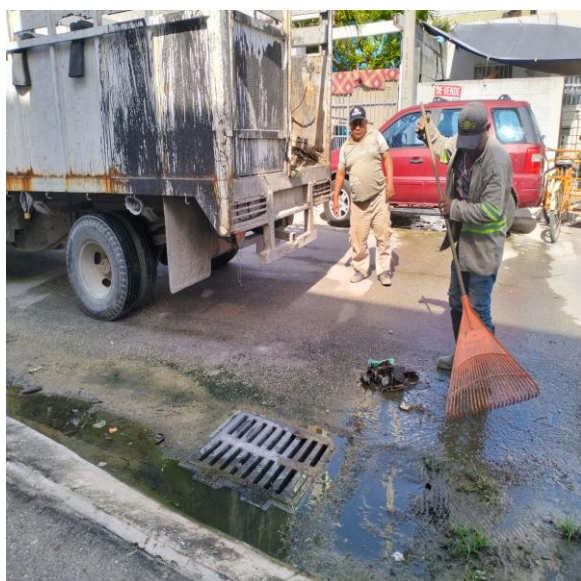
Limpeza de rejillas. Calle palmas chat; fraccionamiento las palmas.
