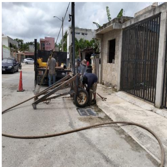
Desazolve. Calle centauro sur entre calle andrómeda oriente; colonia centro.
