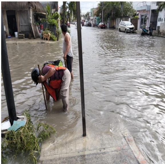
Limpieza de rejillas. Calle centauro entre calle tun-k'ul; colonia mayapax.
