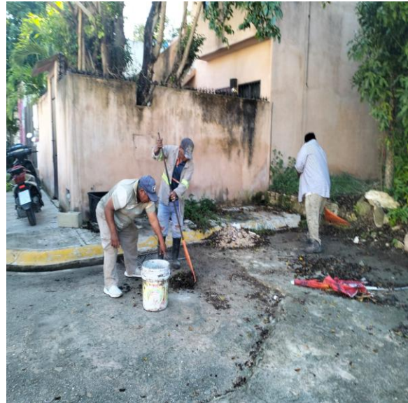
Limpieza de rejillas. Calle 7 sur; fraccionamiento villas Tulum.
