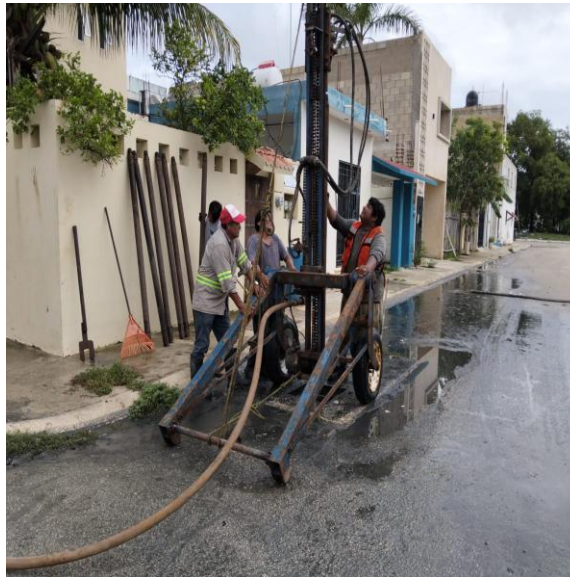
Desazolve. Calle palma rapis entre calle palma guinea; fraccionamiento las palmas.
