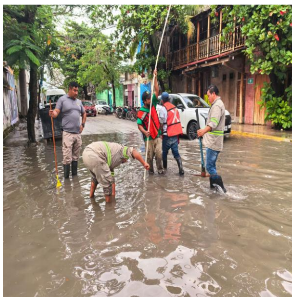
Limpeza de rejillas. Calle andrómeda oriente entre calle ori3n sur; colonia centro.
