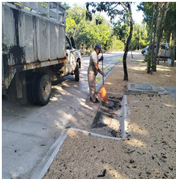
Limpieza de rejillas. Av. central; fraccionamiento aldea zama.
