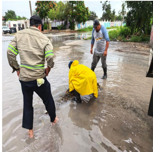
Limpieza de rejillas. Calle tepezcuintle entre av. 18; colonia tumben kaa.
