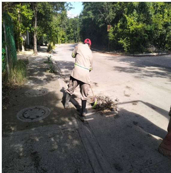
Limpieza de rejillas. Calle sayil; fraccionamiento aldea zama.
