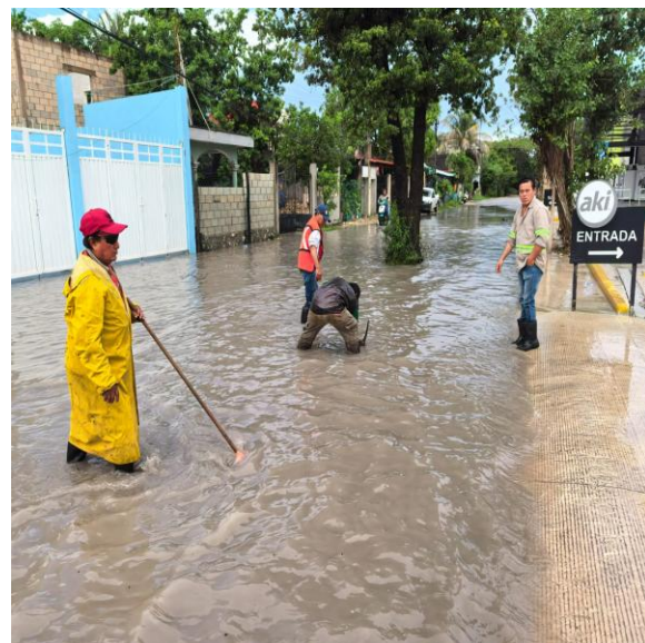
Limpieza de rejillas. Calle chemuyil; colonia ejido.
