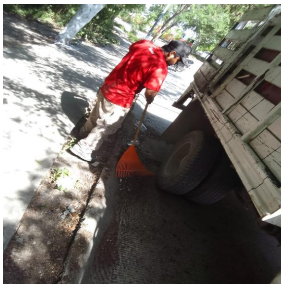
Limpieza de rejillas. Calle balam dzancab entre av. cobá y calle sayil; fraccionamiento aldea zama.
