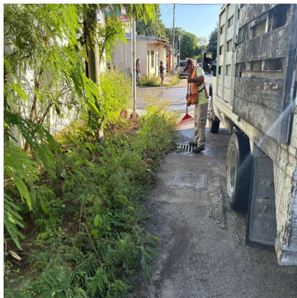
Limpeza de rejillas. Calle mercurio poniente entre calle saturno sur; colonia maya.
