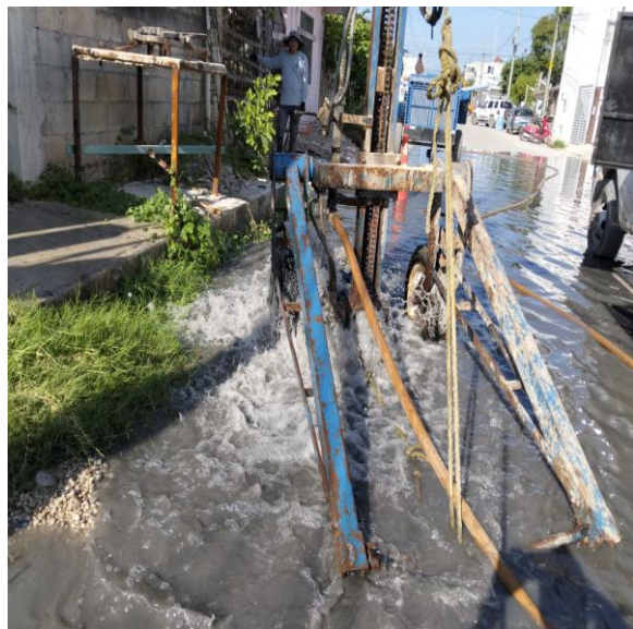
Desazolve. Calle kii's entre calle géminis norte; fraccionamiento guerra de castas, (Pozo 01).
