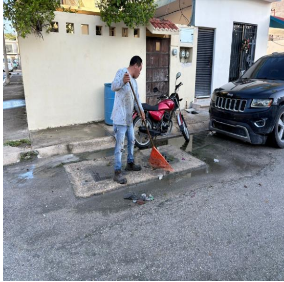
Limpieza de rejillas. Calle palma guinea entre calle palma rapis; fraccionamiento las palmas.
