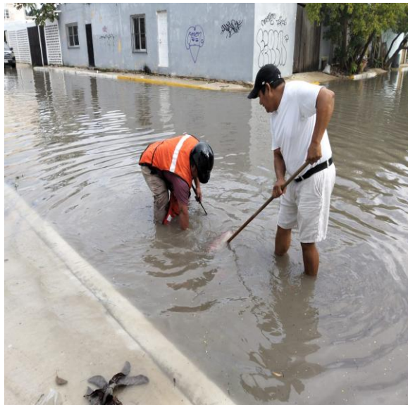
Limpieza de rejillas. Calle beta norte entre calle kiis; colonia mayapax.
