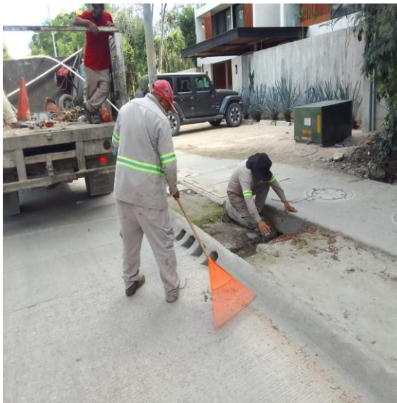
Limpeza de rejillas. Av. juanek entre av. balam dzancab; fraccionamiento aldea zama.
