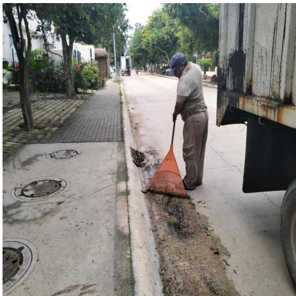
Limpieza de rejillas. Av. juanek; fraccionamiento aldea zama.
