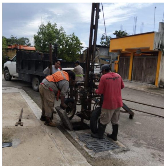
Desazolve. Calle palma navidad entre boulevard palmas Tulum; fraccionamiento las palmas, (Pozo 01).
