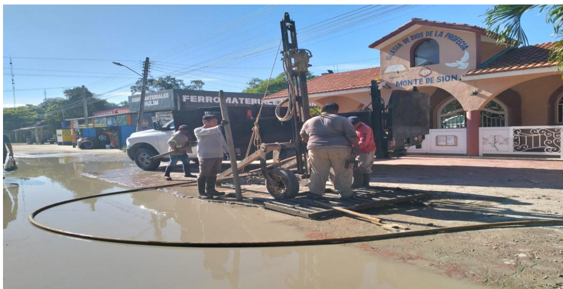
Desazolve. Carretera federal Tulum-nuevo xcán; poblado de Francisco Uh May.
