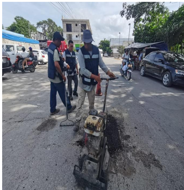
Bacheo. Calle neptuno oriente entre av. osiris sur y calle alfa sur; colonia centro.
