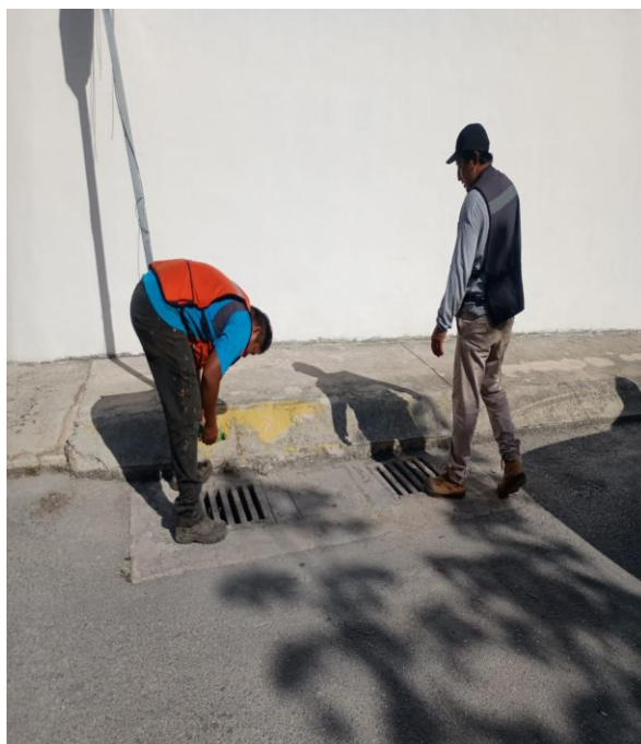
Limpieza de rejillas. Calle 4 poniente; fraccionamiento guerra de castas.
