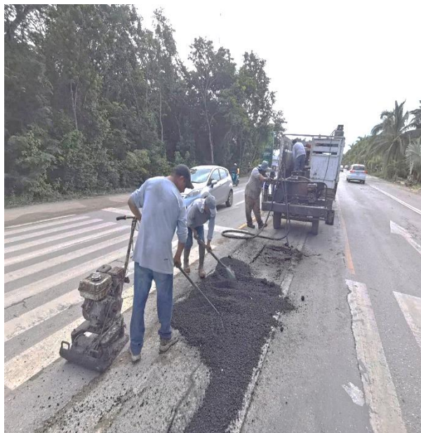
Bacheo. Av. cobá (Referencia frente a las oficinas de Seguridad Pública).
