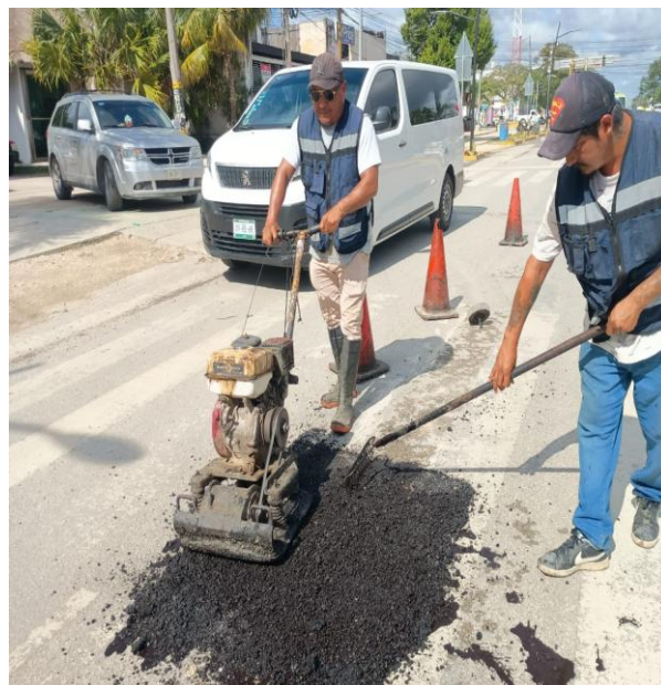
Bacheo. Av. coba entre calle andrómeda sur y calle sol oriente; colonia sac-be.
