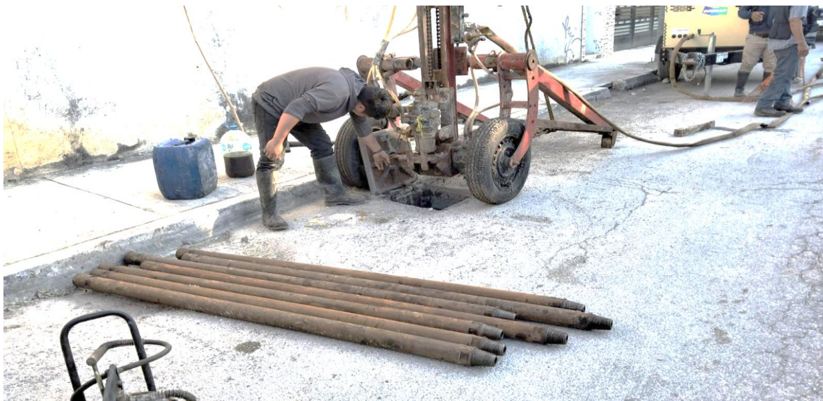
Desazolve. Calle osiris norte entre calle alfa norte; colonia centro.
