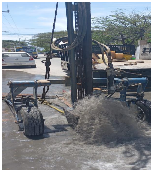
Desazolve. Calle 19 entre av. 18; colonia tumben kaa.
