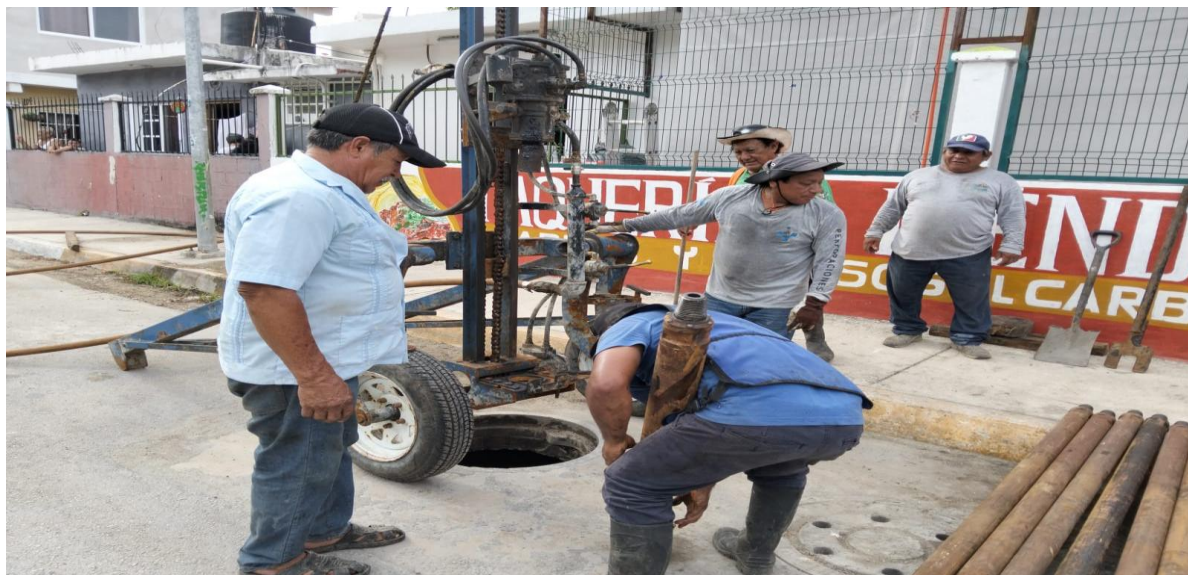
Desazolve. Calle sol oriente entre calle beta sur; colonia centro. (Pozo 01).
