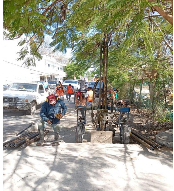
Desazolve. Calle centauro entre calle polar y calle sagitario oriente; colonia centro.
