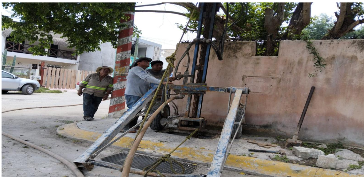
Desazolve. Calle 2 bis oriente entre calle 7 sur; fraccionamiento villas Tulum.
