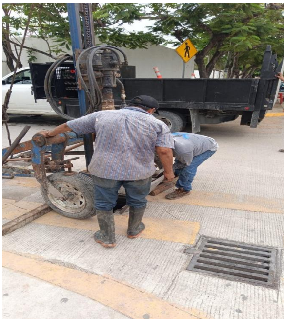
Desazolve. Calle sol oriente entre calle géminis sur; colonia centro.
