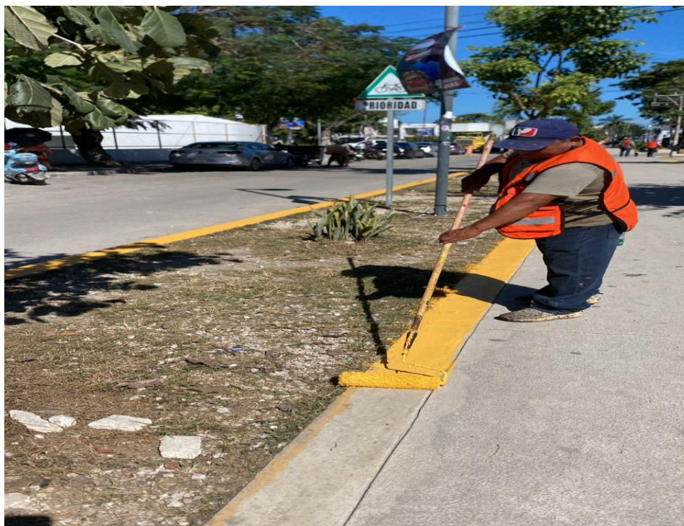
Pintura. Realización de pintura en los laterales de la av. osiris sur; colonia centro.
