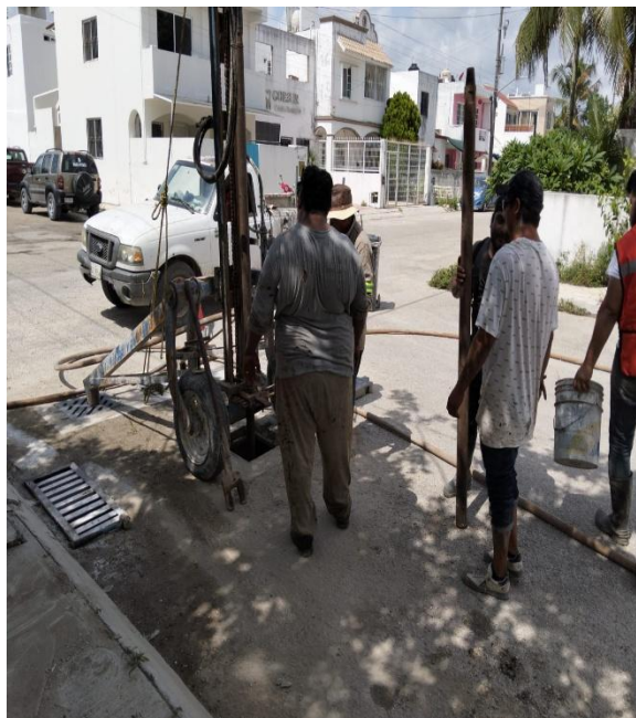
Desazolve. Calle 7 entre calle 2 oriente; fraccionamiento villas Tulum. (Pozo 02).
