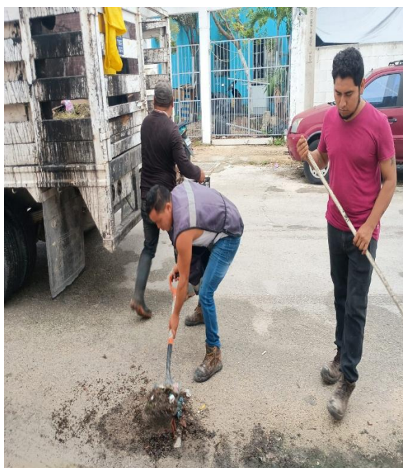
Limpieza de rejillas. Calle palmas chat ente boulevard palmas Tulum; fraccionamiento las palmas.
