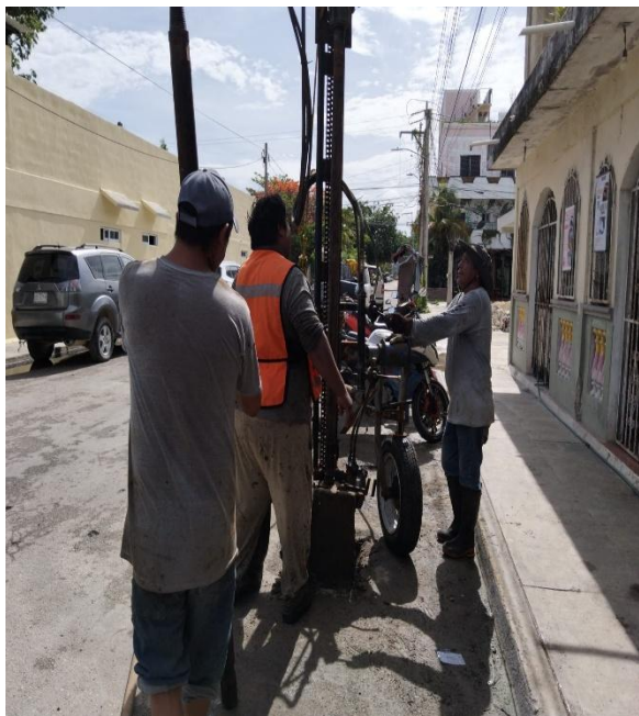
Desazolve. Calle venus oriente entre calle beta norte y calle osiris norte; colonia centro. (Pozo 01).
