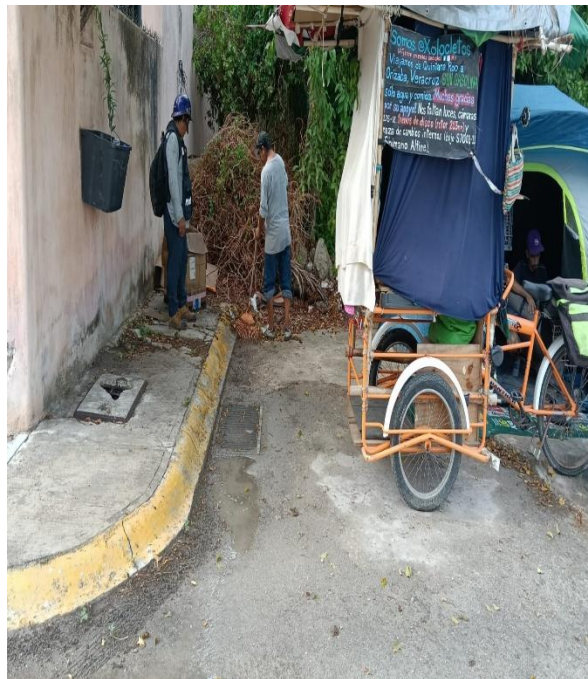
Limpieza de rejillas. Calle 2 bis entre calle 7 sur; fraccionamiento villas Tulum.
