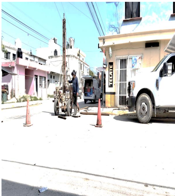
Desazolve. Calle gama sur entre calle ori3n sur; colonia lak'iin. (Pozo 01).
