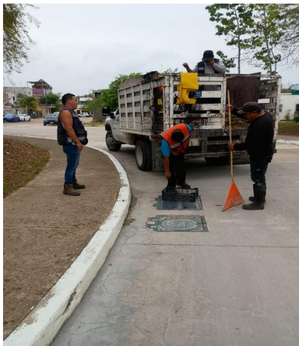
Limpieza de rejillas. Boulevard palmas Tulum entre calle palma reyna; fraccionamiento las palmas.
