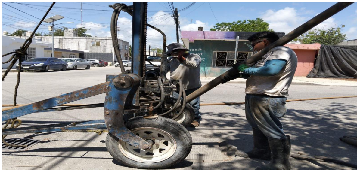
Desazolve. Calle andrómeda oriente entre calle beta sur; colonia centro.
