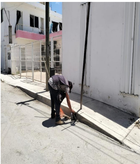
Limpieza de rejillas. Calle chikil entre calle tun-k'ul y av. ook- k'ot; colonia mayapax.
