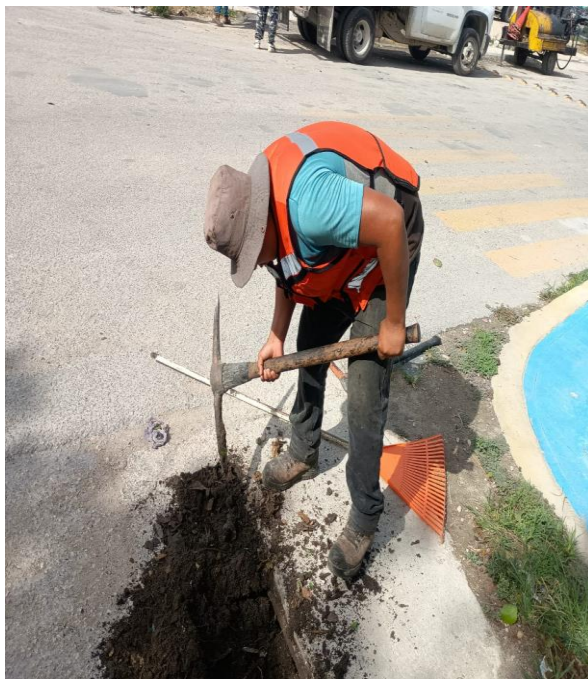
Limpieza de rejillas. Calle 18 entre calle faisán; colonia tumben kaa.
