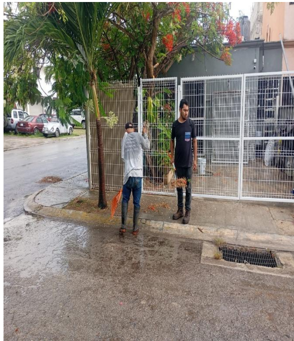
Limpieza de rejillas. Calle 2 bis norte entre calle 3 sur; fraccionamiento villas Tulum.
