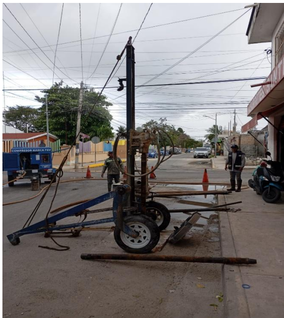
Desazolve. Calle beta norte entre calle 4 oriente; colonia centro.
