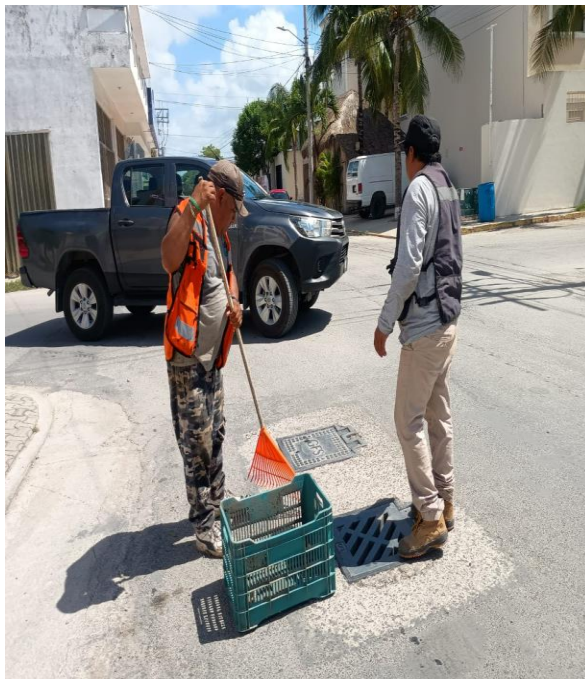
Limpieza de rejillas. Calle escorpión sur entre calle andrómeda oriente; colonia centro.
