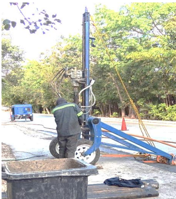
Desazolve. Calle 17 entre av. 2 y calle 12; colonia tumben kaa.
