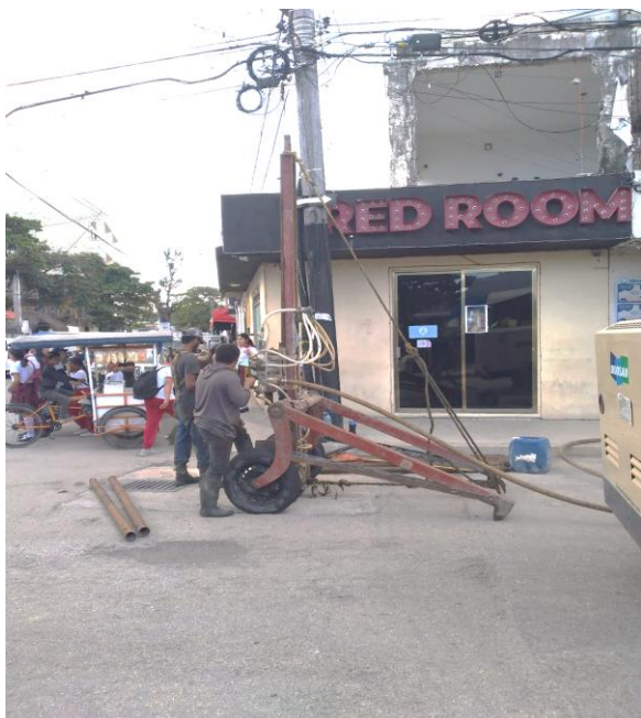
Desazolve. Calle júpiter sur entre calle sol poniente y av. Tulum; colonia maya.
