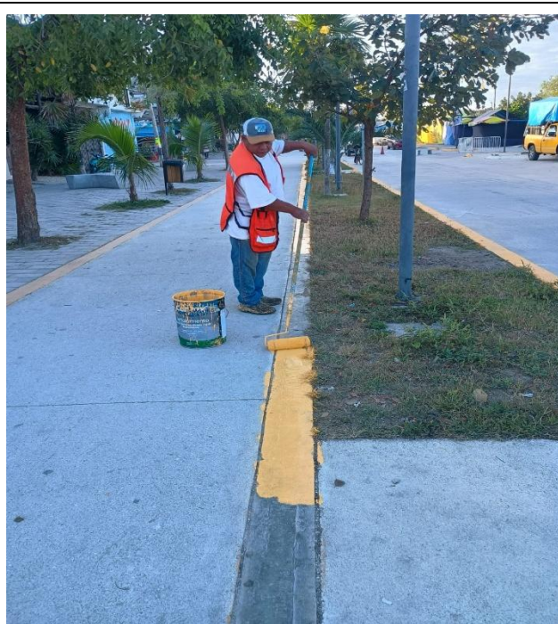
Pintura. Realización de pintura en las guarniciones laterales de la av. osiris sur; colonia centro.
