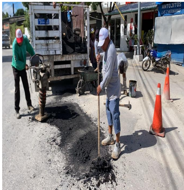
Bacheo. Av. kukulkán entre calle júpiter norte; colonia mayapax.
