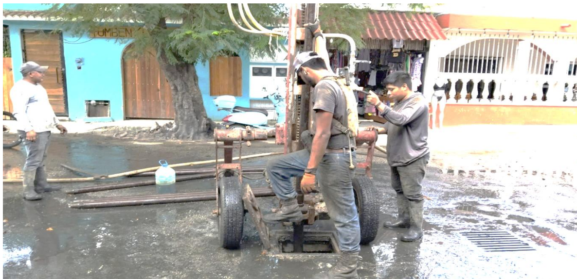
Desazolve. Calle júpiter sur entre calle sol poniente; colonia maya. (Pozo 02).
