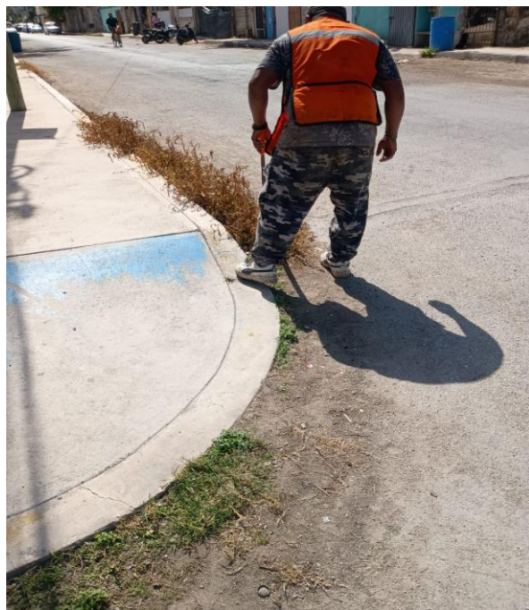
Limpieza de rejillas. Calle asteroides entre calle beta sur; colonia centro.
