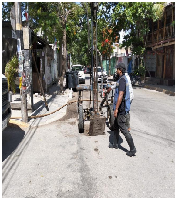
Desazolve. Calle andrómeda oriente entre calle orión sur; colonia centro.
