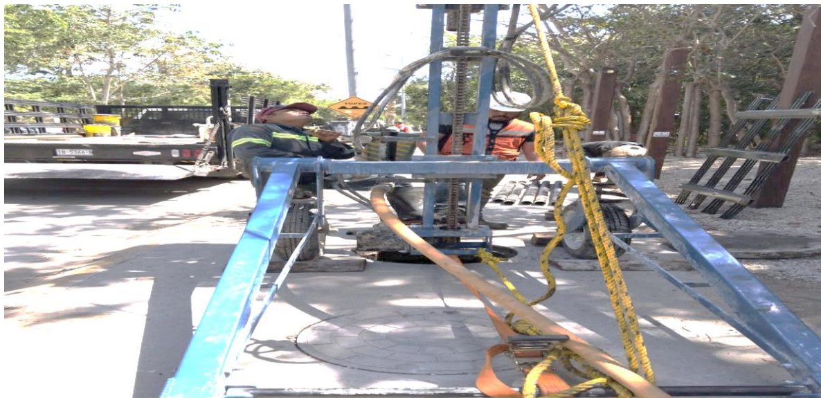
Desazolve. Calle juanek entre calle yaxchilán y calle itzamna; fraccionamiento aldea zama.
