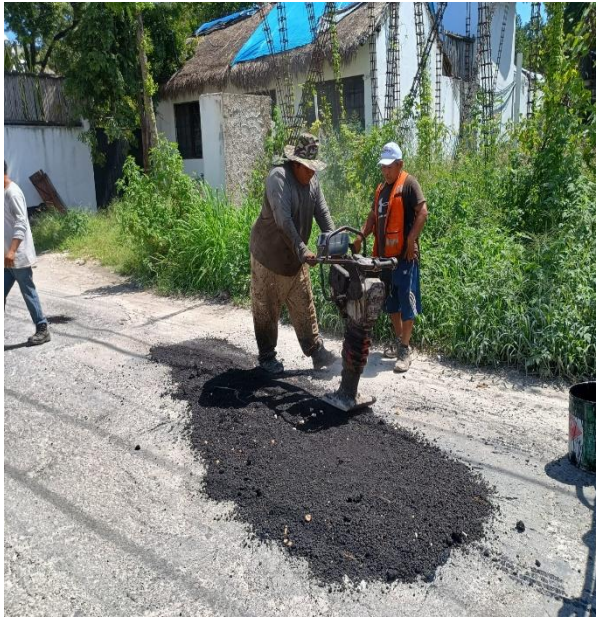
Bacheo. Calle sagitario oriente entre calle escorpión sur y calle libra sur; fraccionamiento guerra de castas.
