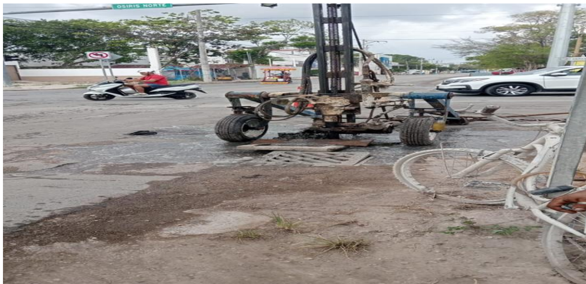
Desazolve. Av. ook-k'ot entre calle osiris norte; colonia mayapax.
