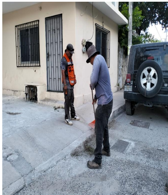
Limpieza de rejillas. Av. osiris norte entre calle polar; colonia centro.
