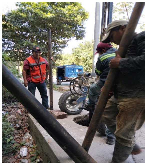
Desazolve. Av. 18 entre av. 2 y av. 1; colonia tumben kaa.
