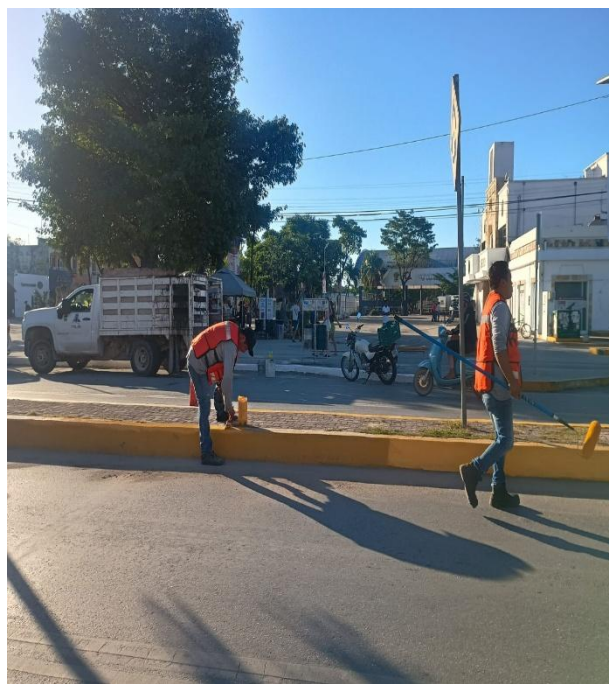
Pintura. Realización de pintura en el camellón central de la av. Tulum; colonia centro.
