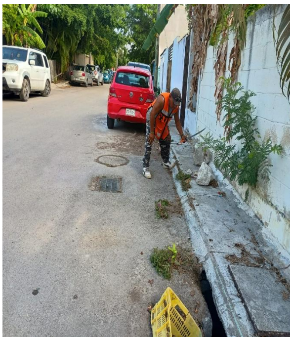
Limpieza de rejillas. Calle 17 entre calle 2 bis oriente; fraccionamiento villas Tulum.
