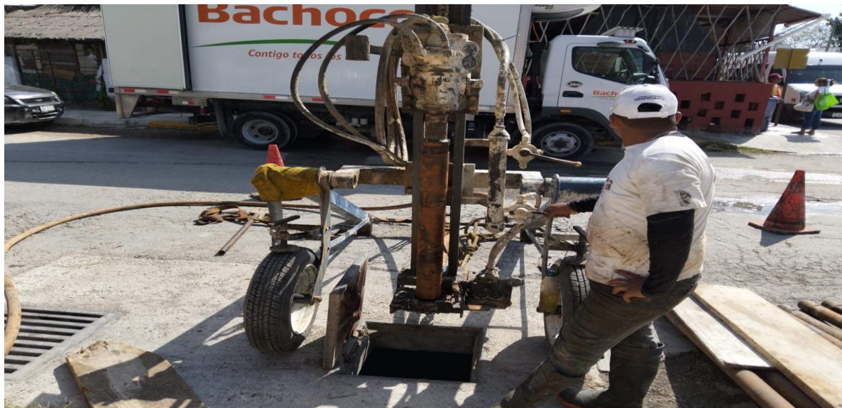
Desazolve. Calle beta norte entre calle 4 oriente; colonia centro.
