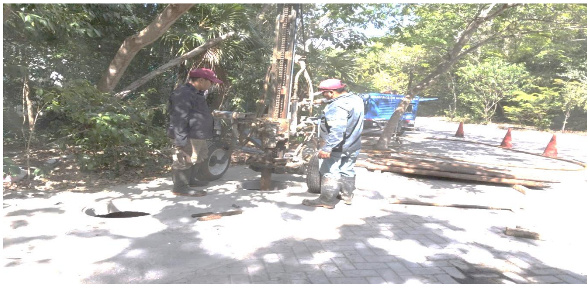
Desazolve. Av. aldea zama entre av. central y calle balam dzacab; fraccionamiento aldea zama.
