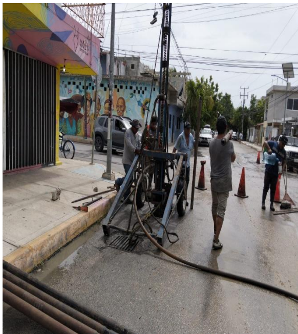
Desazolve. Calle sol oriente entre calle beta sur; colonia centro. (Pozo 02).
