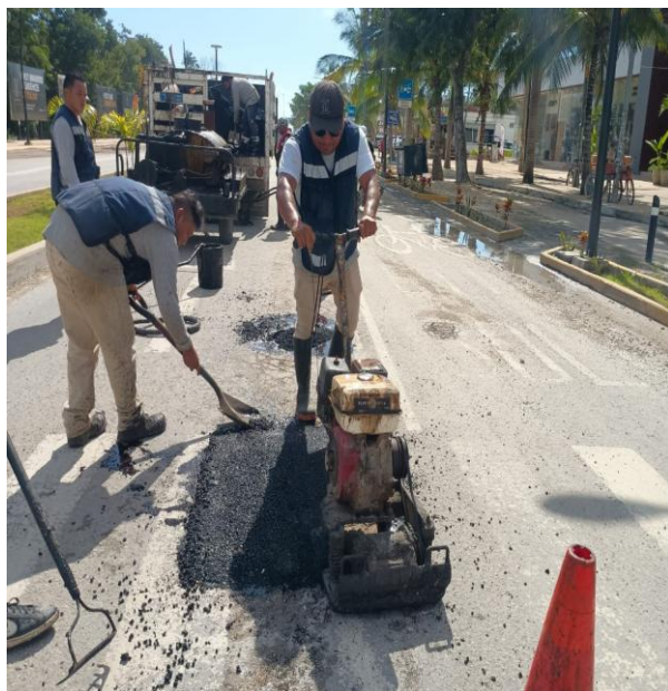
Bacheo. Av. coba entre calle andrómeda sur y calle sol oriente; colonia sac-be.
