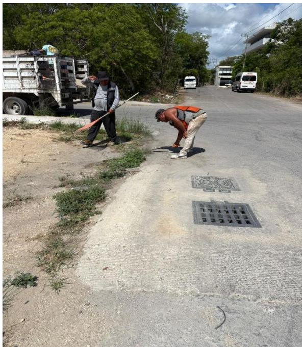
Limpieza de rejillas. Av. Tulum entre calle Kohunlich; colonia ejido.
