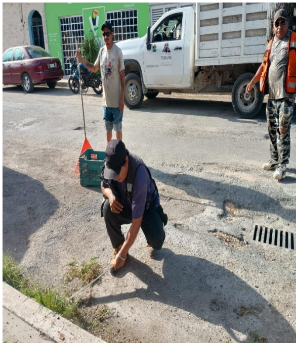
Limpieza de rejillas. Calle venus oriente entre calle ori3n sur y calle centauro sur; colonia centro.
