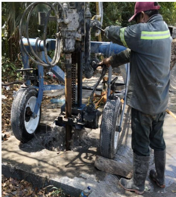
Desazolve. Calle 25 entre calle 12; colonia tumben kaa.
