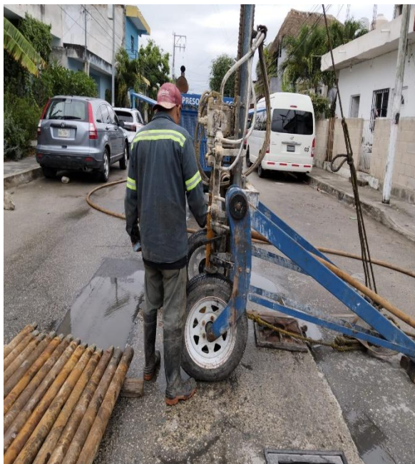
Desazolve. Calle 2 norte entre calle ori3n norte; colonia centro.
