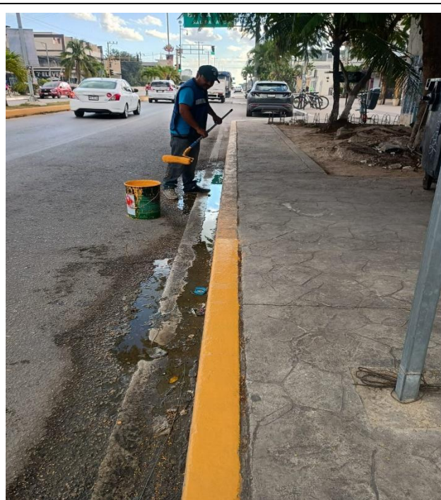
Pintura. Realización de pintura en el camellón central y laterales de la av. Tulum; colonia centro.
