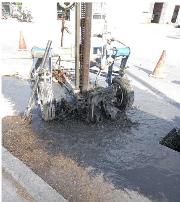
Desazolve. Av. la selva entre calle 25; colonia tumben kaa.
