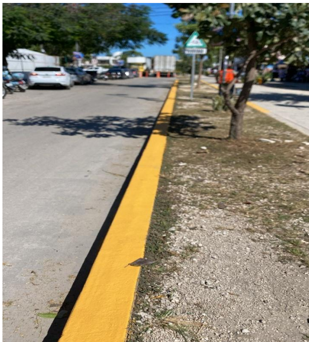
Pintura. Realización de pintura en los laterales de la av. osiris sur; colonia centro.
