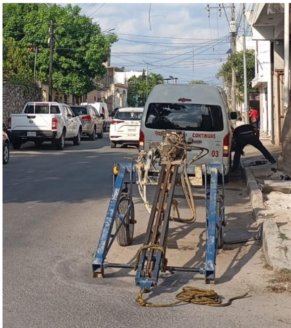
Desazolve. Calle 16 entre calle 19 y calle 21; colonia tumben kaa.
