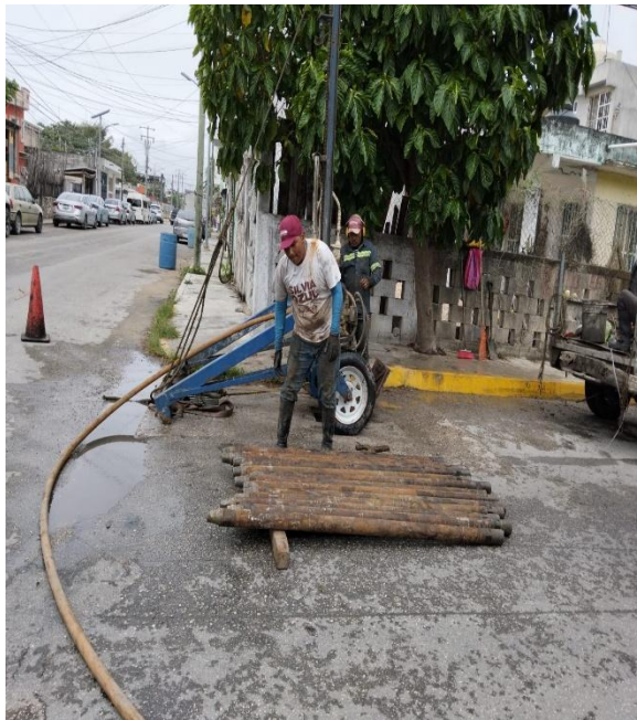
Desazolve. Calle ori3n norte entre calle 4 oriente; colonia centro.
