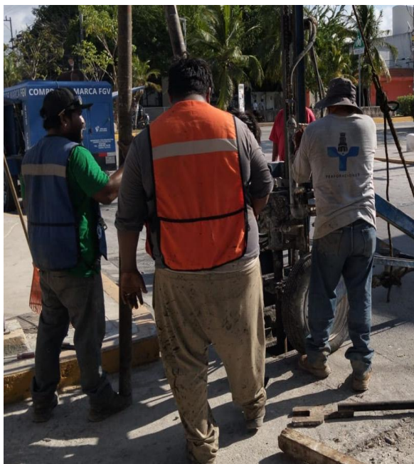
Desazolve. Calle 23 entre calle 24 y calle 26-a; colonia tumben kaa.
