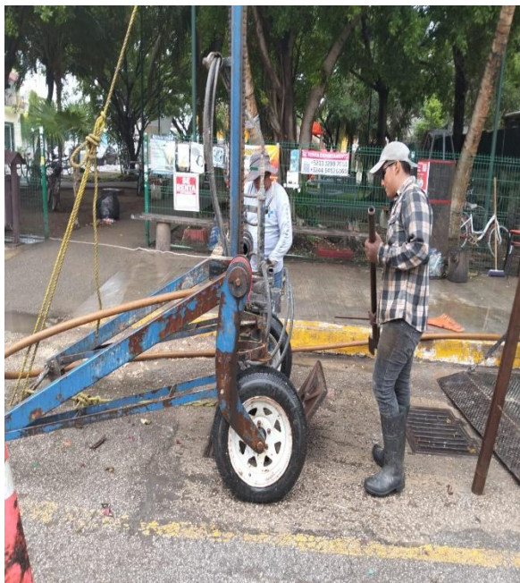
Desazolve. Calle venus oriente entre calle ori3n sur y calle beta sur; colonia centro.
