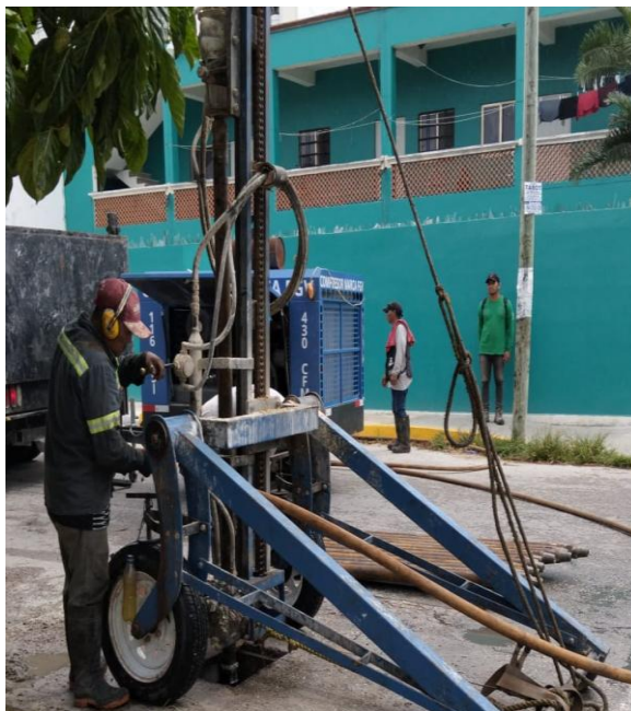
Desazolve. Calle 13 entre calle 24; colonia tumben kaa.
