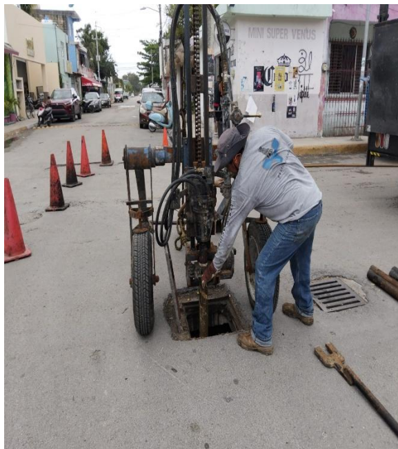
Desazolve. Calle ori3n sur entre calle sol oriente; colonia centro.
