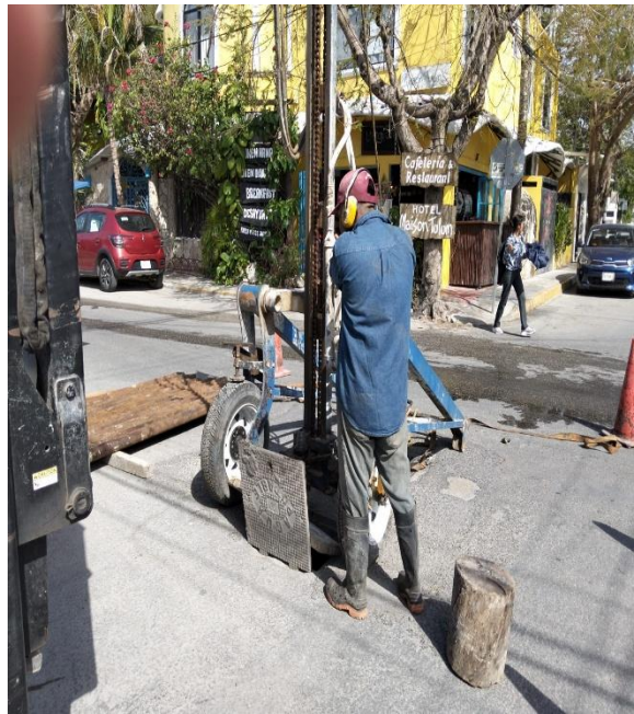
Desazolve. Calle alfa norte entre calle sagitario oriente; colonia centro.
