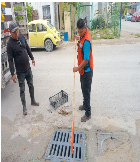
Limpieza de rejillas. Boulevard palmas Tulum entre calle palma baru; fraccionamiento las palmas.
