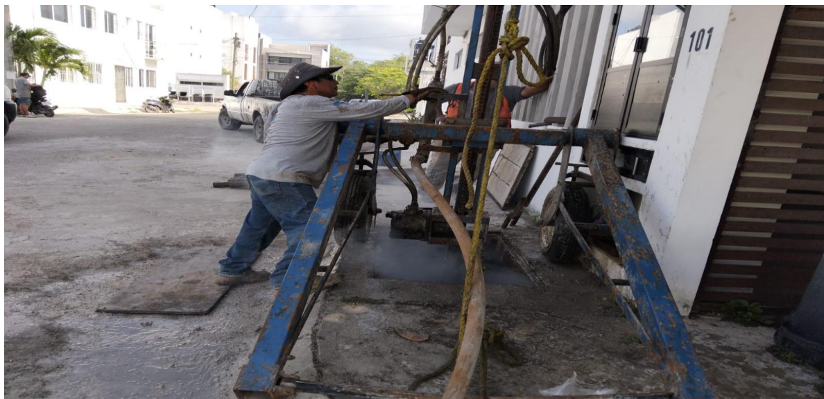
Desazolve. Calle 7 entre calle 2 oriente; fraccionamiento villas Tulum.
