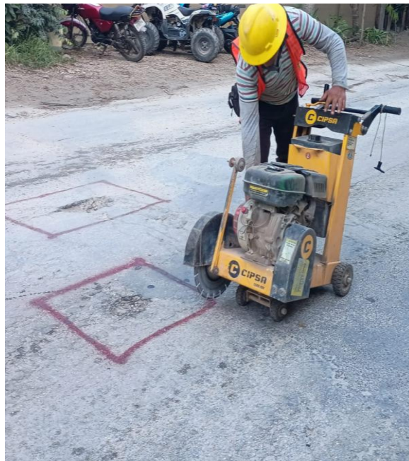
Bacheo. Calle sol oriente entre av. osiris sur y calle alfa sur; colonia centro.
