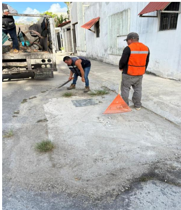
Limpieza de rejillas. Boulevard palmas Tulum entre calle palmas rapis; fraccionamiento las palmas.
