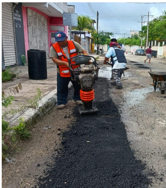
Bacheo. Calle venus oriente entre calle alfa sur y av. osiris sur; colonia lak'iin.
