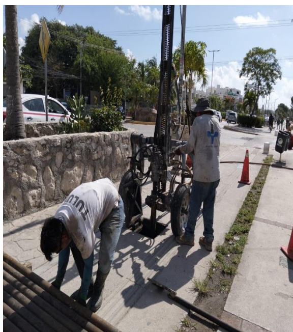
Desazolve. Av. Tulum entre calle alfa sur; colonia centro.
