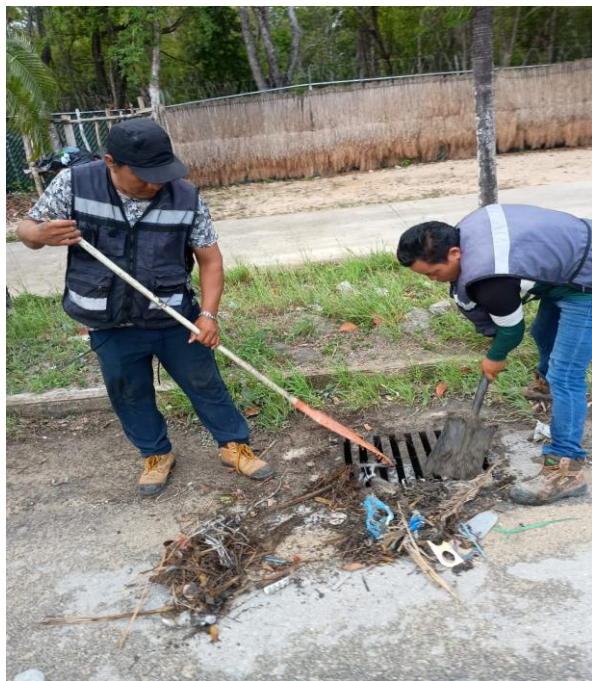
Limpieza de rejillas. Av. 10 norte; colonia tumben kaa.
