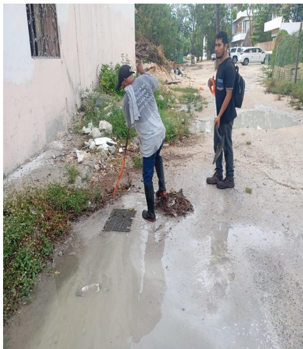
Limpieza de rejillas. Calle 2 bis entre calle 5 sur; fraccionamiento villas Tulum.
