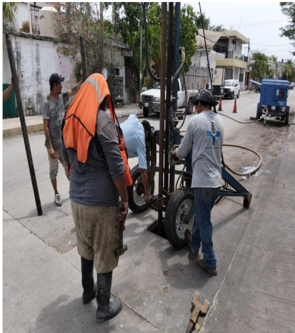
Desazolve. Calle sol oriente entre av. osiris sur y calle beta sur; colonia centro.
