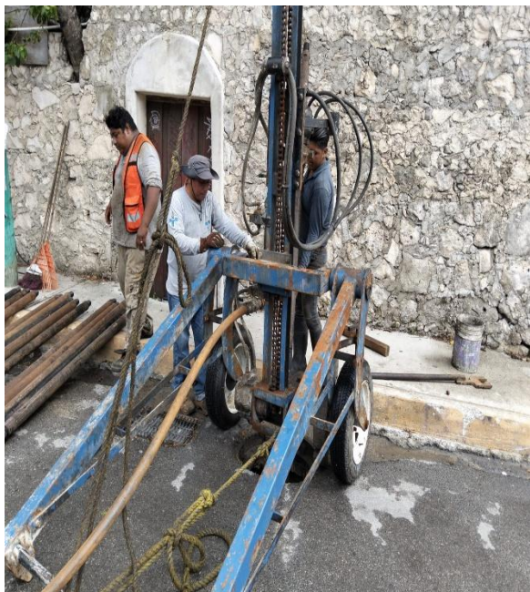
Desazolve. Calle sol oriente entre calle centauro sur; colonia centro. (Pozo 02).
