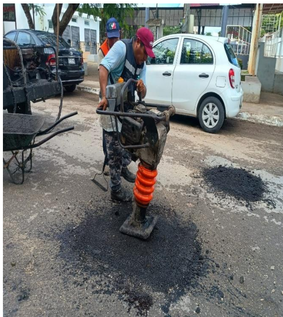
Bacheo. Calle sol oriente entre av. osiris sur y calle alfa sur; colonia centro.
