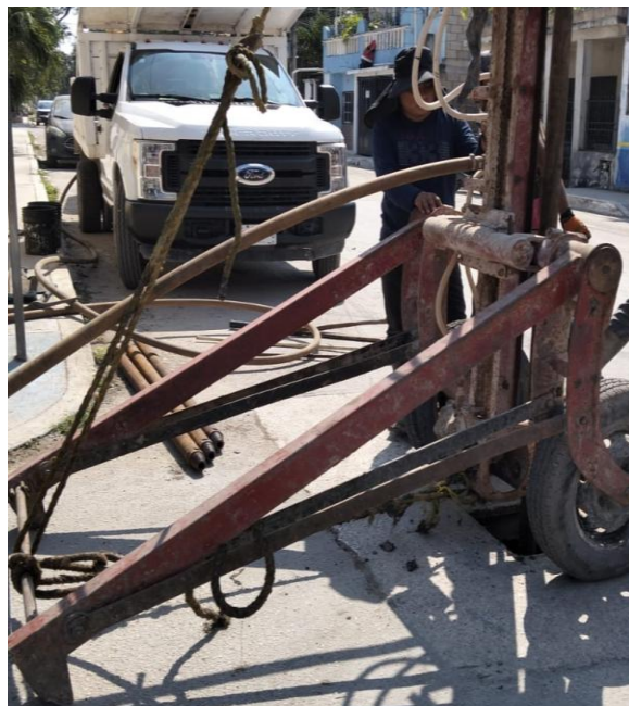
Desazolve. Calle escorpión sur entre calle andrómeda oriente; fraccionamiento huracanes.
