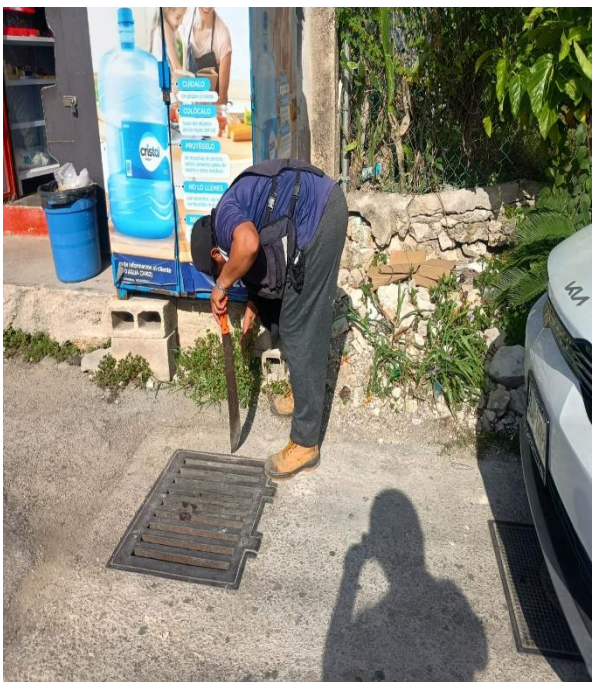
Limpieza de rejillas. Calle alfa sur entre calle gama oriente y calle mercurio; colonia centro.
