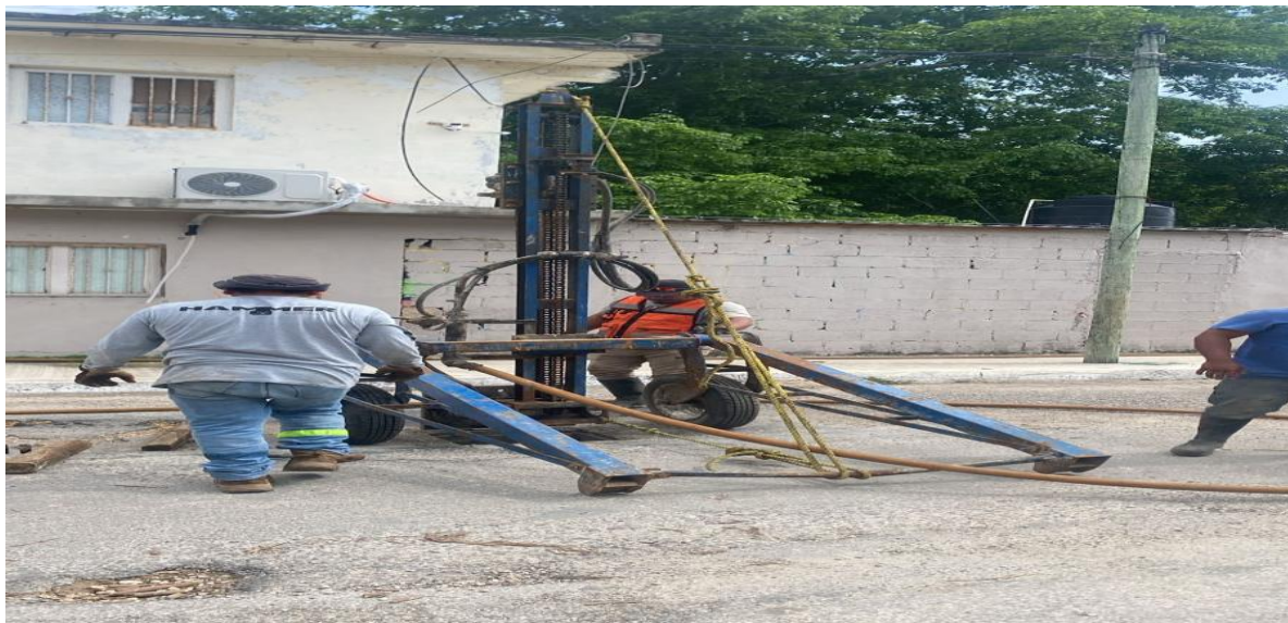
Desazolve. Calle venus oriente entre calle centauro sur; colonia centro.
