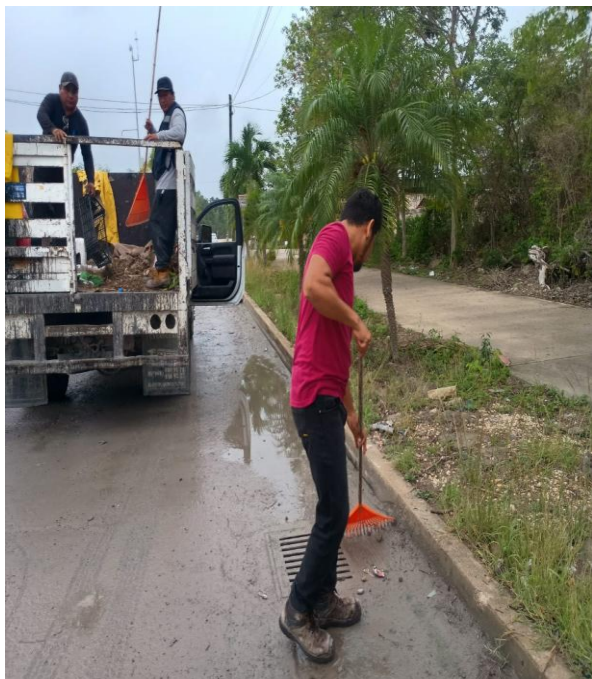
Limpieza de rejillas. Av. Tulum entre calle 2 norte; fraccionamiento las palmas.
