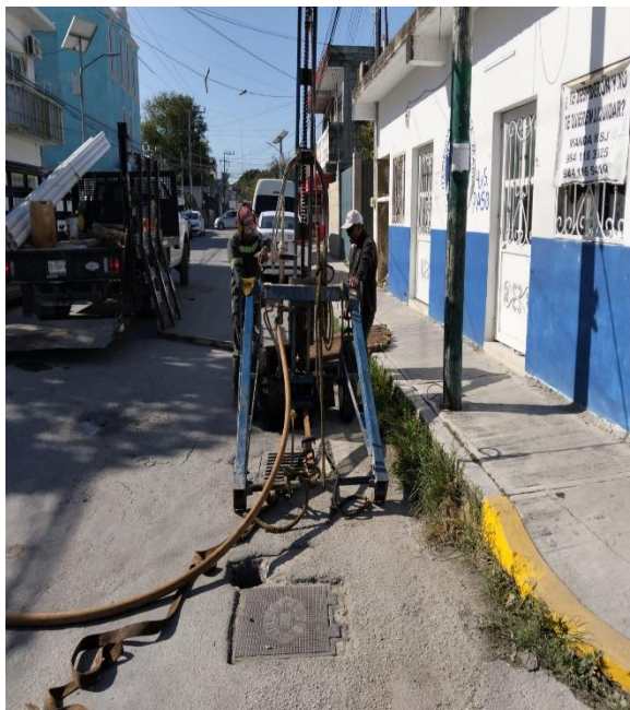
Desazolve. Calle alfa norte entre calle 4 poniente; colonia centro. (Pozo 01).
