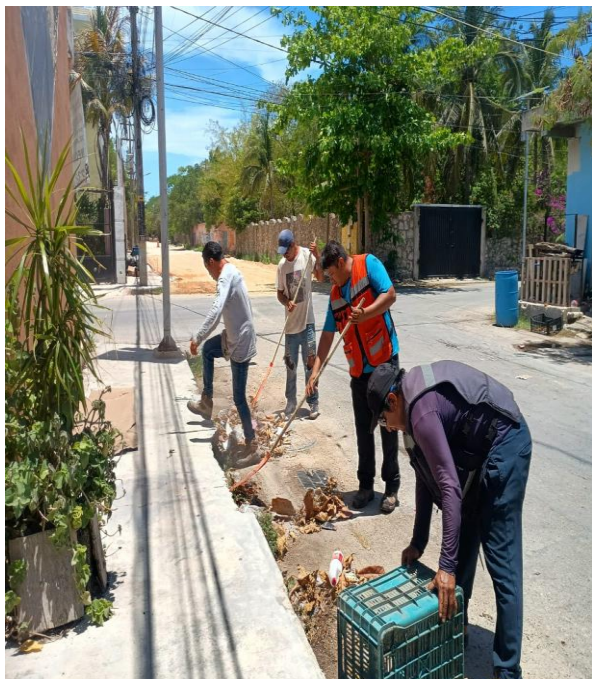
Limpieza de rejillas. Calle mercurio poniente entre calle palenque; colonia centro.
