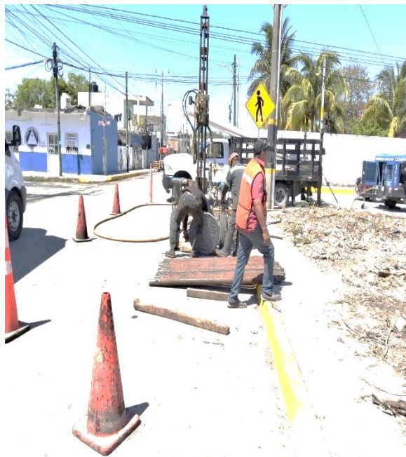
Desazolve. Calle 4 norte entre calle osiris norte y calle alfa norte; colonia centro.
