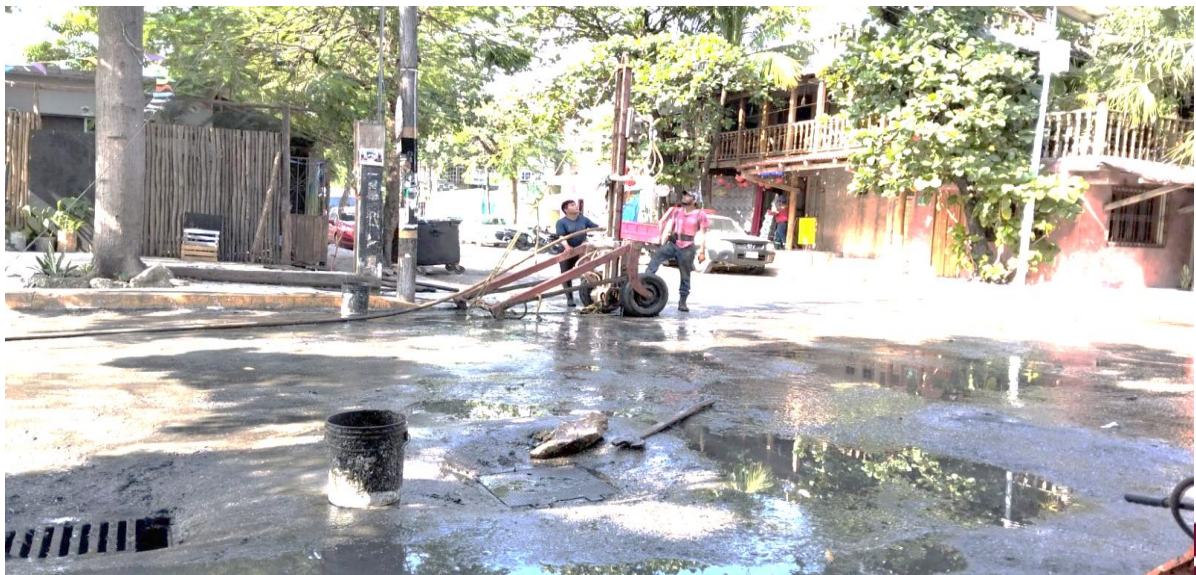
Desazolve. Calle ori3n sur y calle andr3meda oriente; colonia centro. (Pozo 02).
