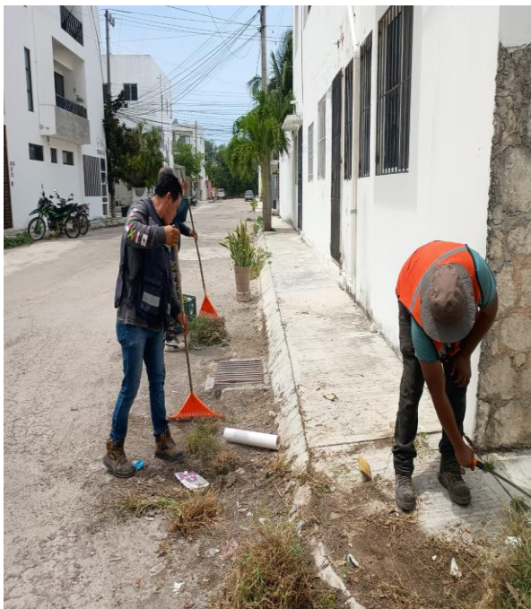
Limpieza de rejillas. Calle 2 oriente a entre calle 7 sur y calle 5 sur; fraccionamiento villas Tulum.
