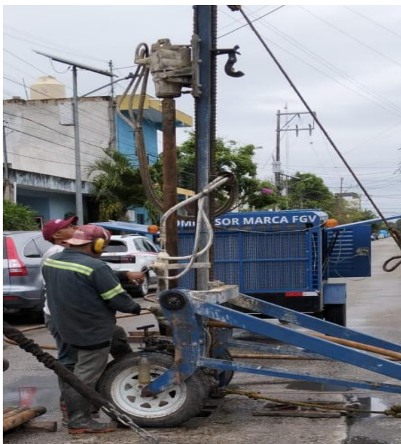
Desazolve. Av. 2 entre calle 24; colonia tumben kaa.
