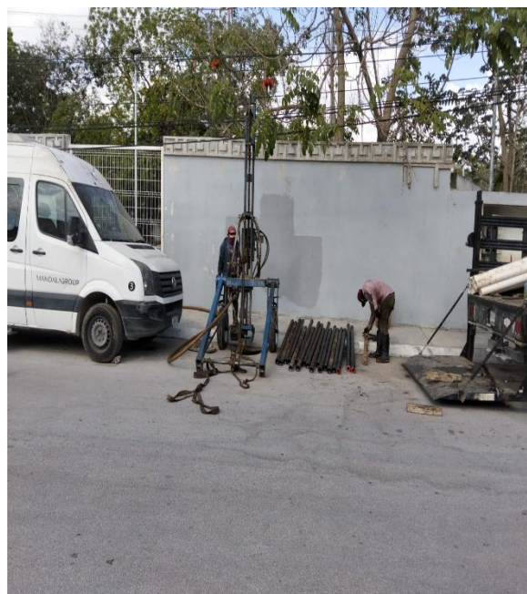
Desazolve. Calle júpiter entre calle le'xiu; colonia mayapax.
