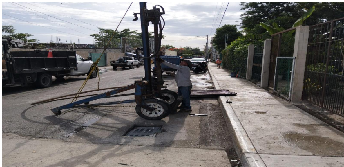
Desazolve. Calle venus oriente entre av. osiris sur; colonia centro.
