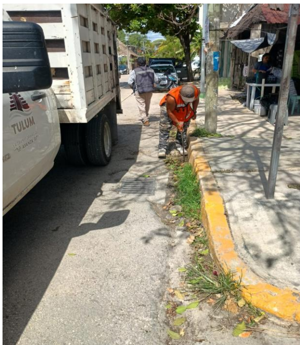
Limpieza de rejillas. Calle andrómada oriente entre av. satélite; colonia centro.
