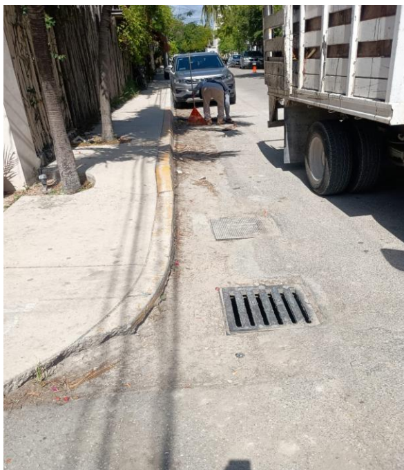
Limpieza de rejillas. Calle andrómada oriente entre calle centauro sur; colonia centro.
