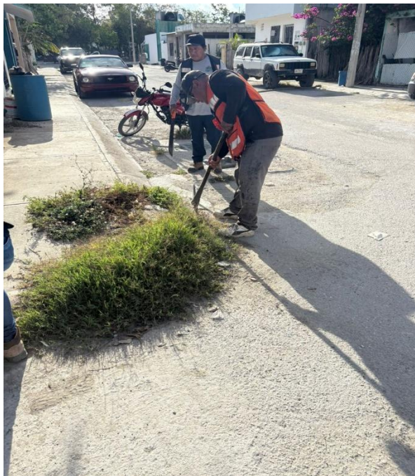
Limpieza de rejillas. Calle palmas rapis entre calle palma guinea; fraccionamiento las palmas.
