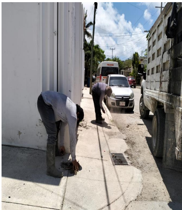
Limpieza de rejillas. Calle le'xiu entre calle ori3n; colonia mayapax.
