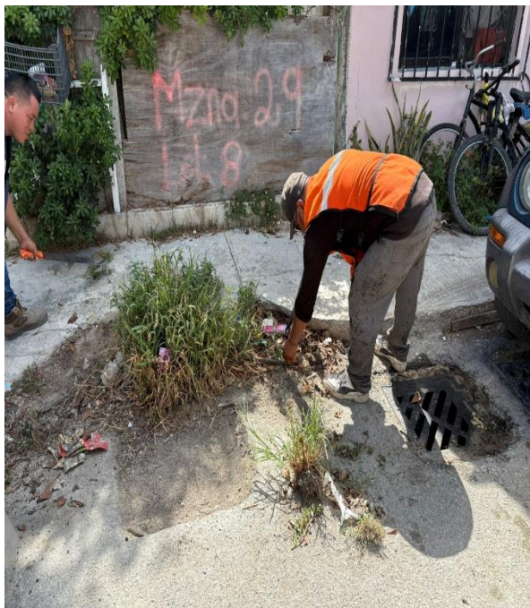
Limpieza de rejillas. Calle huracán rossana entre calle huracán paulina; fraccionamiento huracanes.
