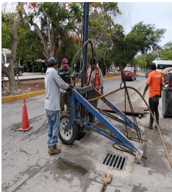
Desazolve. Av. satélite entre calle sol oriente; colonia centro. (Pozo 02).
