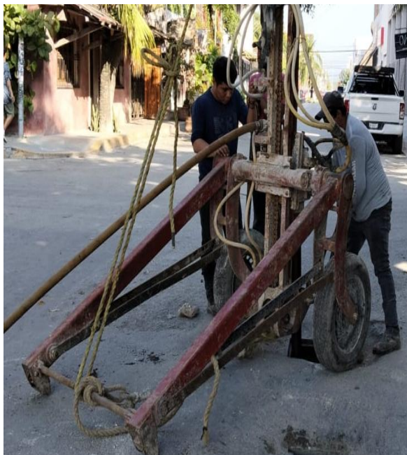
Desazolve. Av. 1 entre calle 24 y av. 18; colonia tumben kaa.
