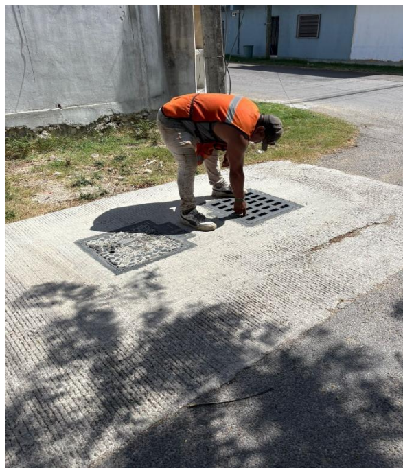
Limpieza de rejillas. Av. Tulum entre calle chan caa; colonia ejido.
