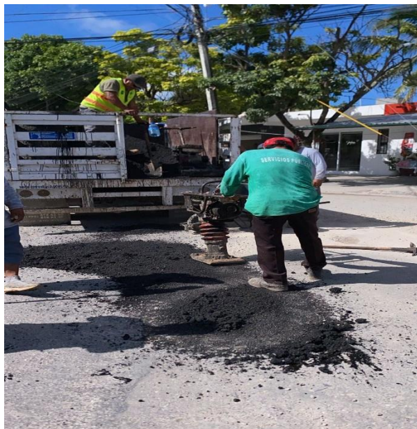
Bacheo. Av. kukulkán entre calle júpiter norte; colonia mayapax.
