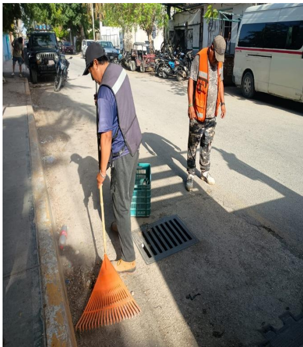
Limpieza de rejillas. Calle venus oriente entre calle beta sur y calle ori3n sur; colonia centro.
