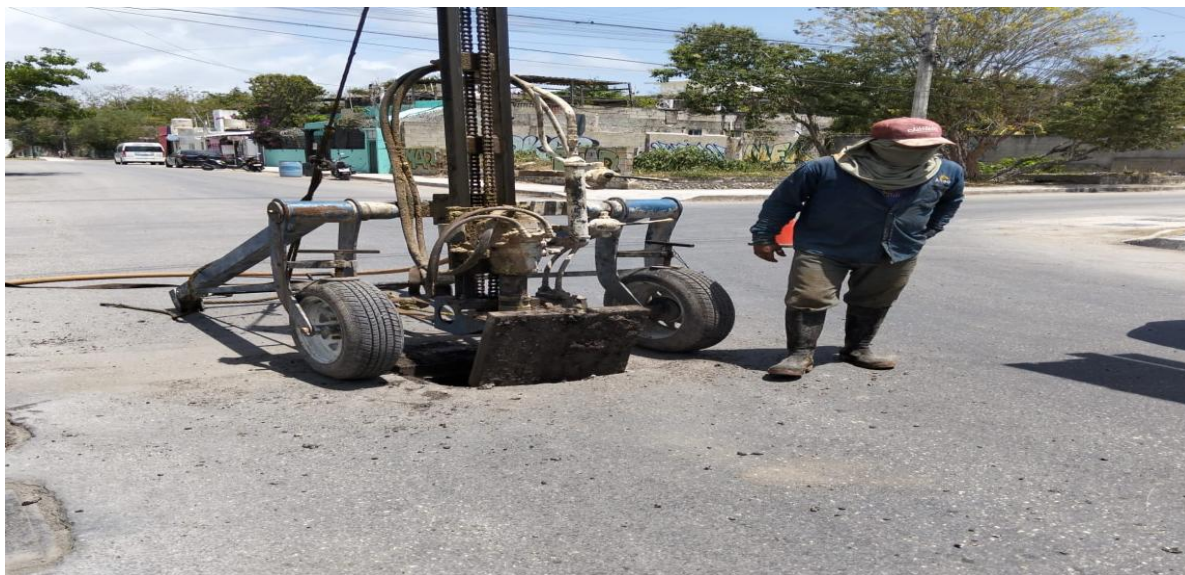
Desazolve. Calle acuario norte entre calle sagitario oriente y calle polar norte; colonia centro.
