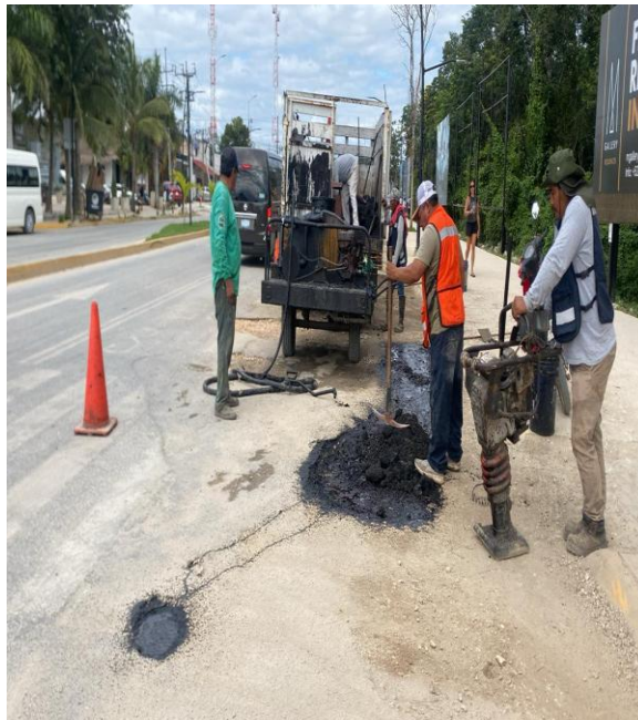
Bacheo. Av. cobá sur entre calle mercurio oriente; colonia sac be.
