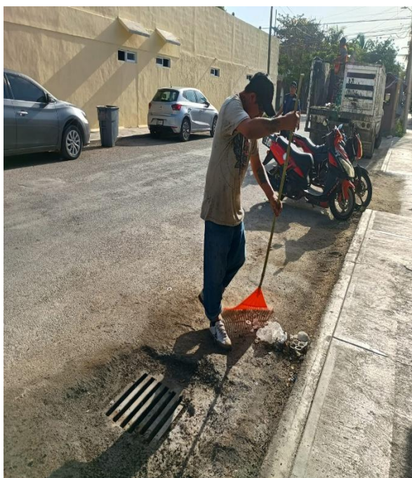
Limpieza de rejillas. Calle venus oriente entre av. osiris sur y calle beta sur; colonia centro.
