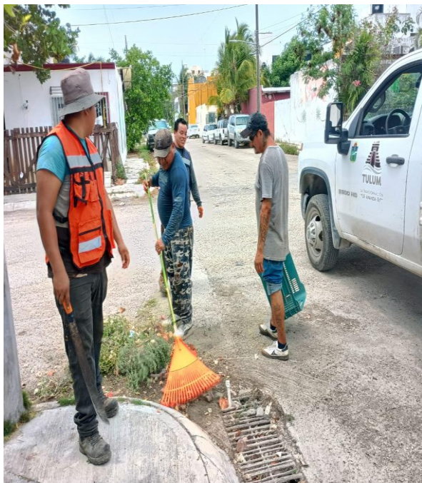
Limpieza de rejillas. Calle 2 oriente entre calle 5 sur; fraccionamiento villas Tulum.
