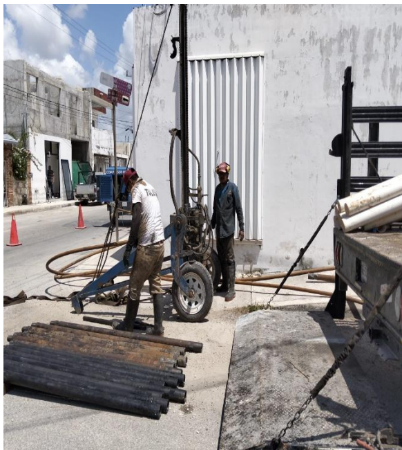
Desazolve. Calle le'xiu entre calle ori3n; colonia mayapax.
