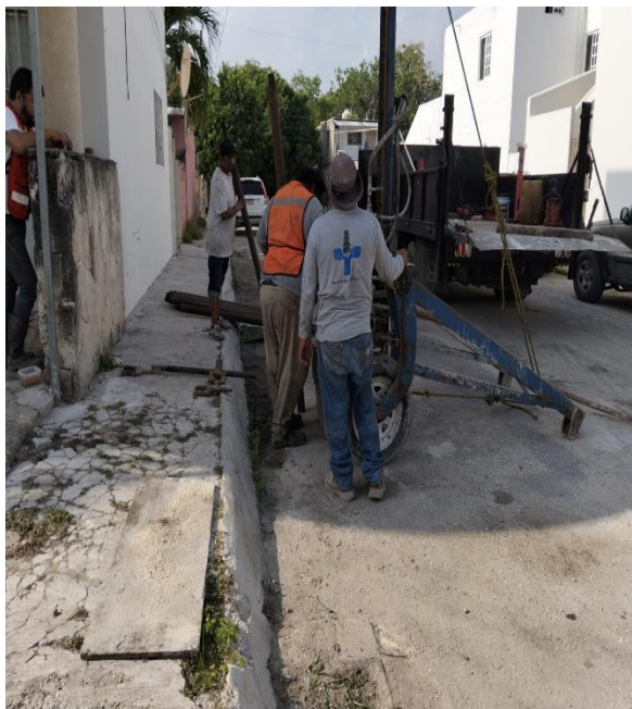
Desazolve. Calle 7 entre calle 2 oriente; fraccionamiento villas Tulum. (Pozo 01).
