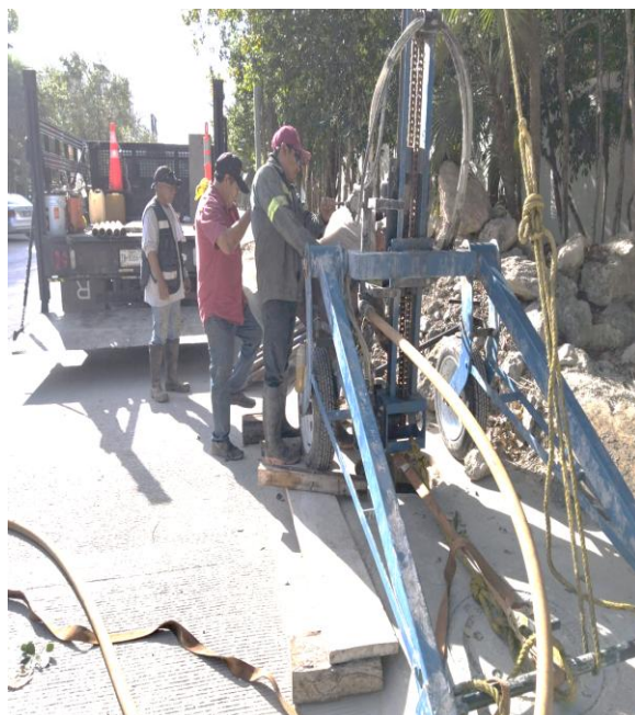
Desazolve. Calle itzamna entre av. central y calle and kaan; fraccionamiento aldea zama.
