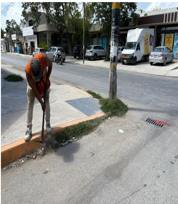
Limpieza de rejillas. Calle chanchén entre calle golondrinas; colonia ejido.
