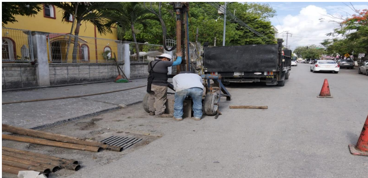
Desazolve. Calle sol oriente entre av. osiris sur y calle alfa sur; colonia centro.
