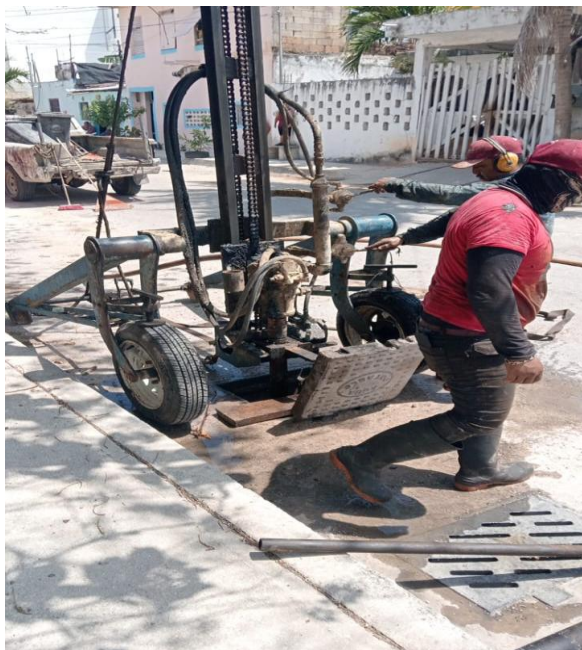
Desazolve. Calle chikil entre av. ook-k'ot y calle tun-k'ul; colonia mayapax.
