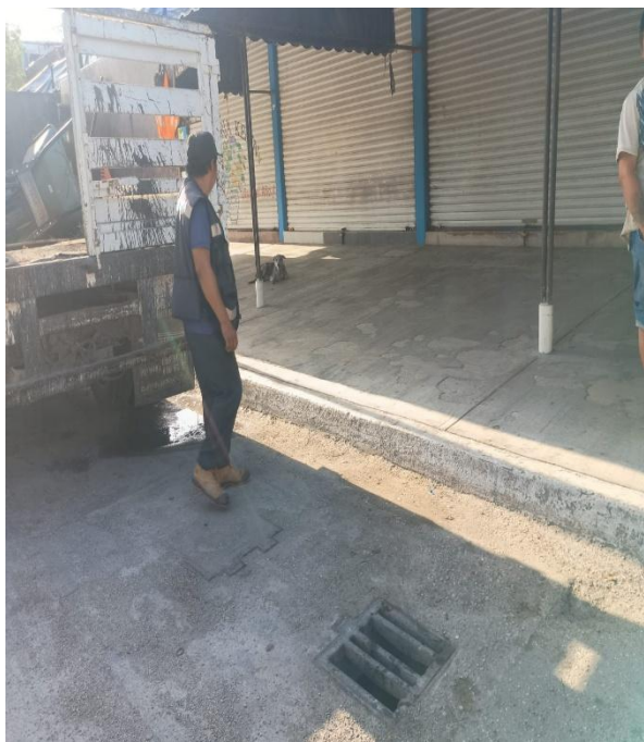
Limpieza de rejillas. Calle venus oriente entre av. osiris sur; colonia centro.
