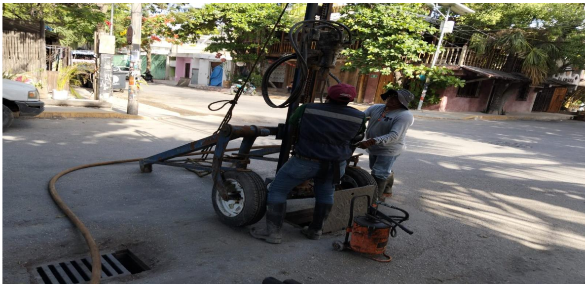
Desazolve. Calle orión sur entre calle andrómeda oriente; colonia centro.
