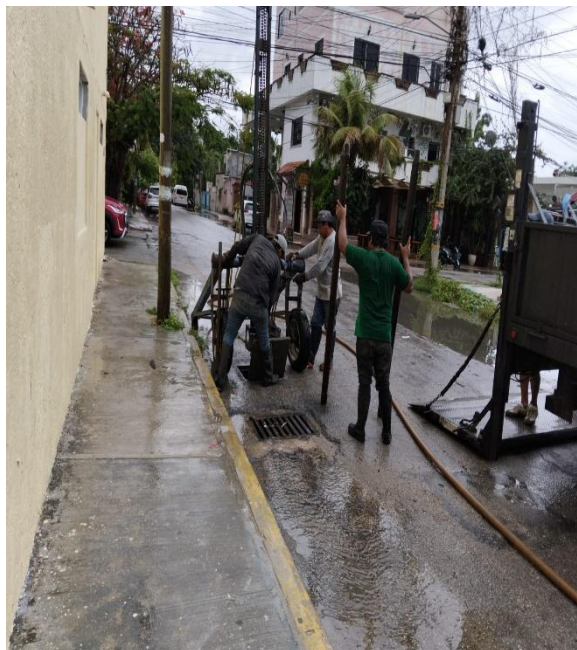
Desazolve. Calle venus oriente entre calle beta norte y calle osiris norte; colonia centro. (Pozo 02).
