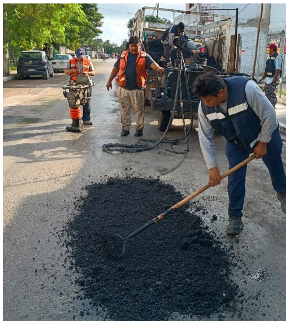
Bacheo. Calle venus oriente entre calle alfa sur y av. osiris sur; colonia lak'iin.
