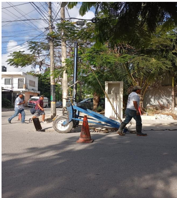
Desazolve. Calle júpiter entre calle 2 oriente; colonia centro.
