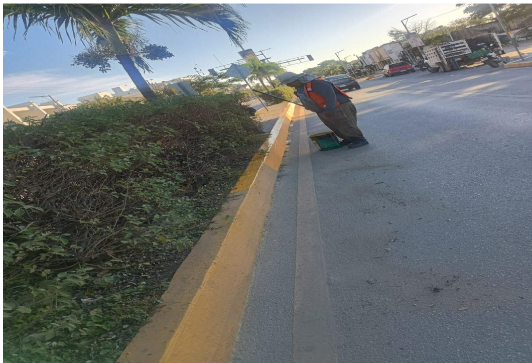
Pintura. Realización de pintura en el camellón central de la av. Tulum; colonia centro.
