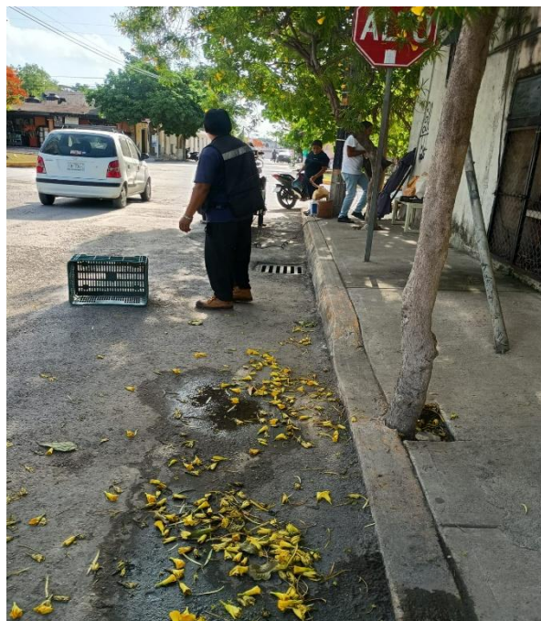
Limpieza de rejillas. Calle venus oriente entre calle centauro sur y av. sat3lite; colonia centro.
