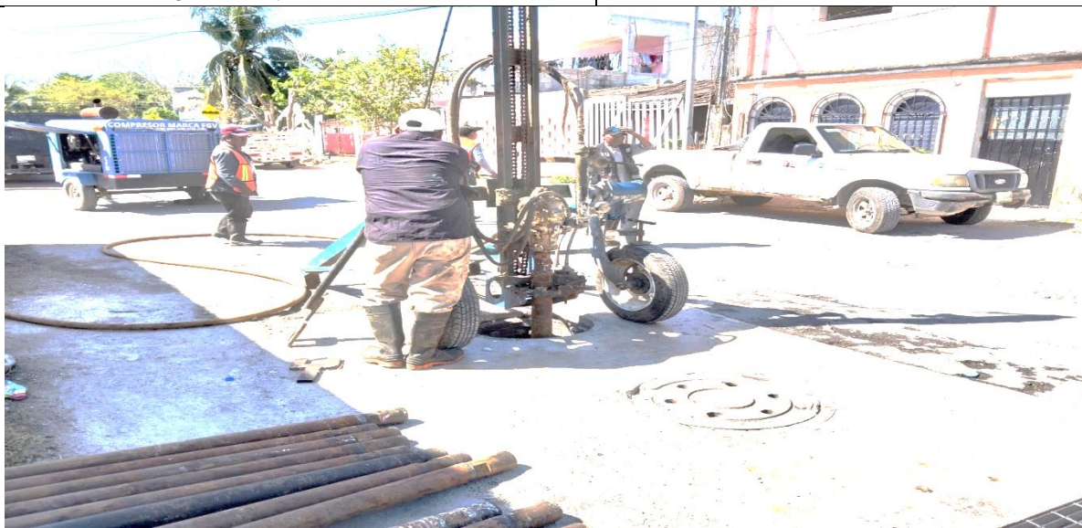
Desazolve. Calle omega norte entre calle 4 poniente; colonia centro.
