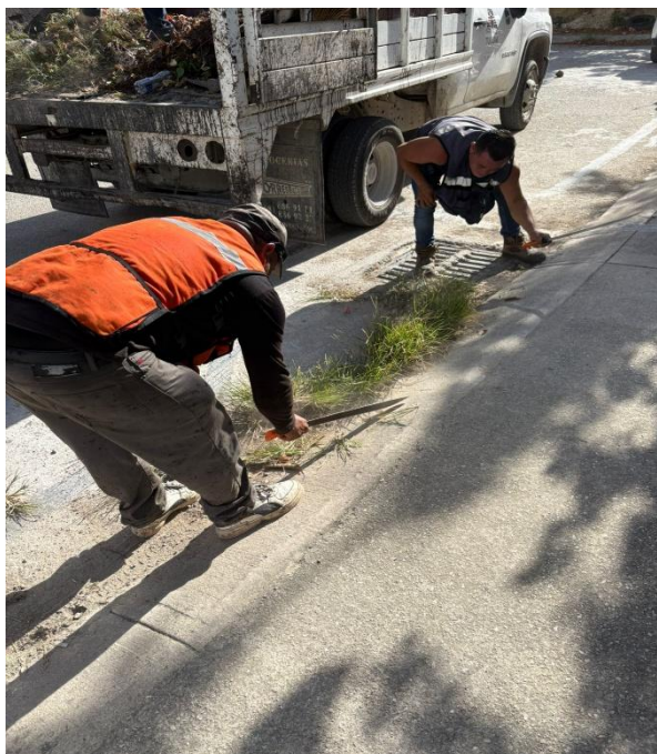
Limpieza de rejillas. Calle palma navidad entre boulevard palmas Tulum; fraccionamiento las palmas.
