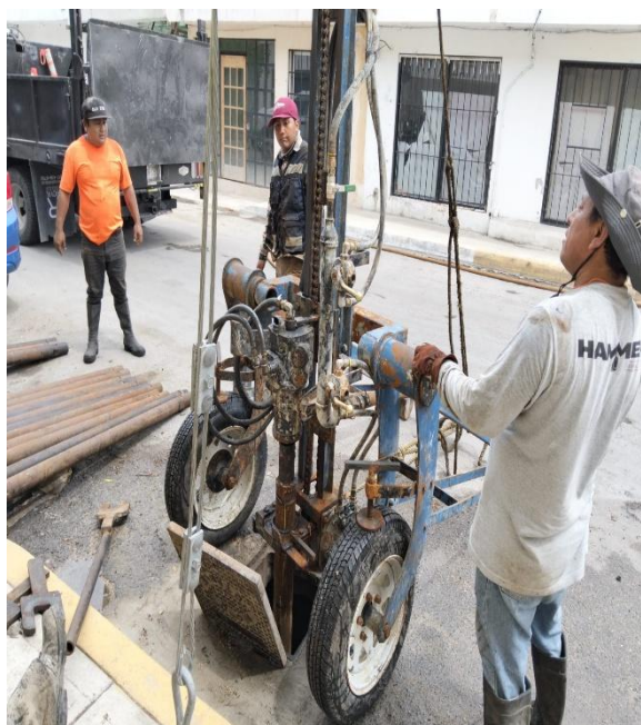
Desazolve. Calle sol oriente entre av. satélite; colonia centro.
