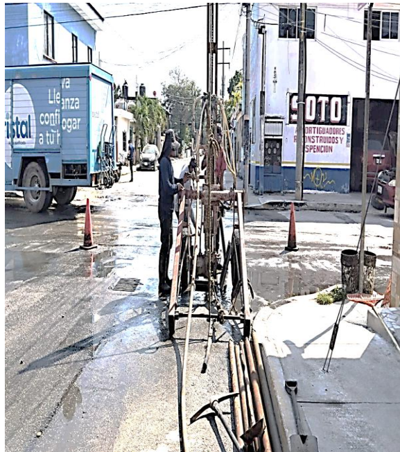
Desazolve. Calle gama sur entre calle ori3n sur; colonia lak'iin. (Pozo 02).
