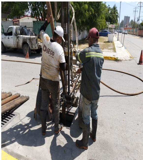
Desazolve. Calle osiris norte entre calle 4 oriente; colonia centro.
