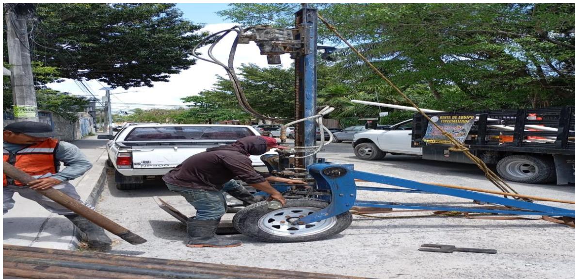
Desazolve. Calle osiris norte entre calle polar oriente y calle sagitario oriente; colonia centro
