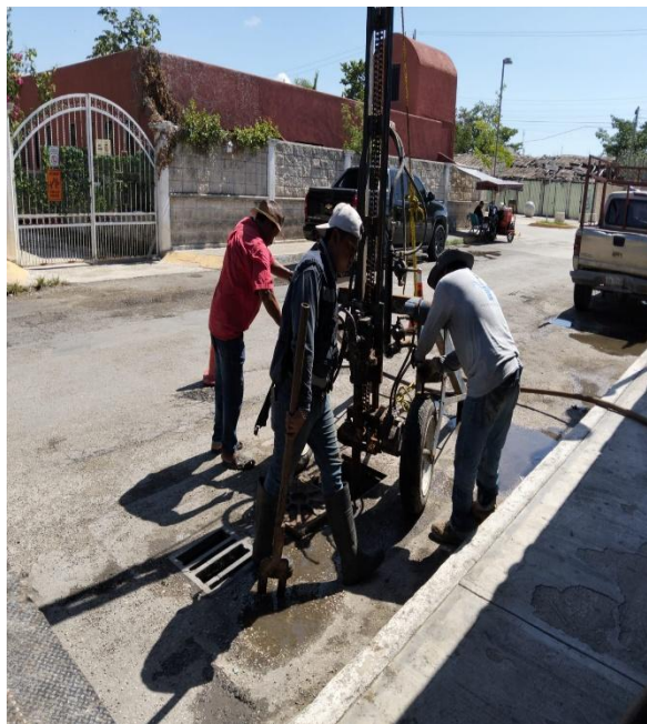
Desazolve. Calle venus oriente entre av. osiris sur; colonia centro.
