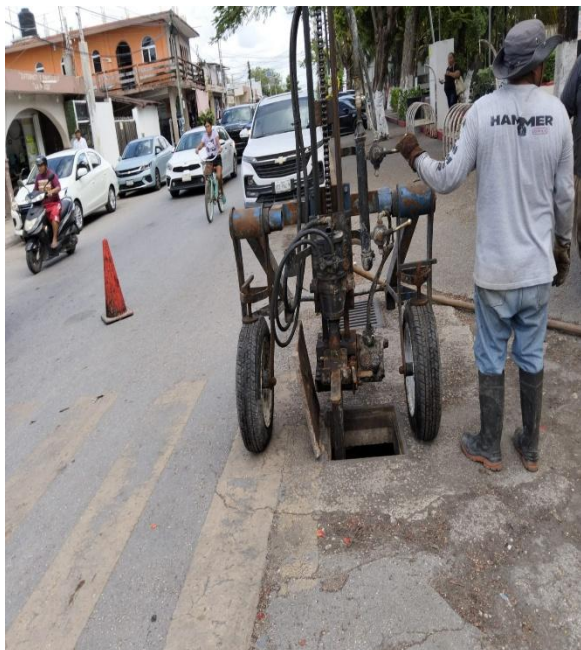
Desazolve. Calle alfa sur entre calle sol oriente; colonia centro.
