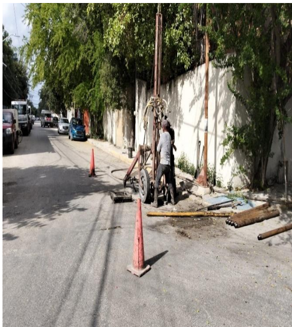
Desazolve. Calle mercurio poniente entre calle luna sur; colonia maya.
