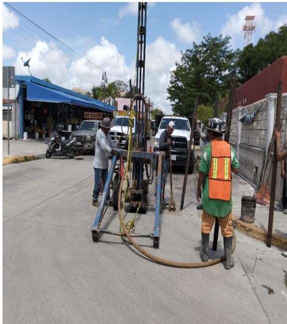
Desazolve. Av. osiris sur entre calle venus oriente; colonia centro.
