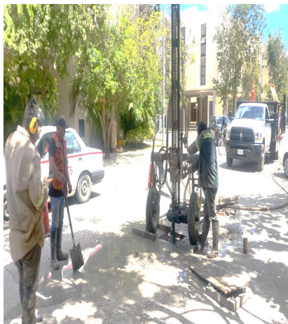
Desazolve. Calle itzamna entre calle yaxchilán; fraccionamiento aldea zama.
