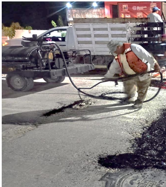
Bacheo. Av. cobá sur entre calle asteroides oriente y calle sol oriente; colonia sac be.
