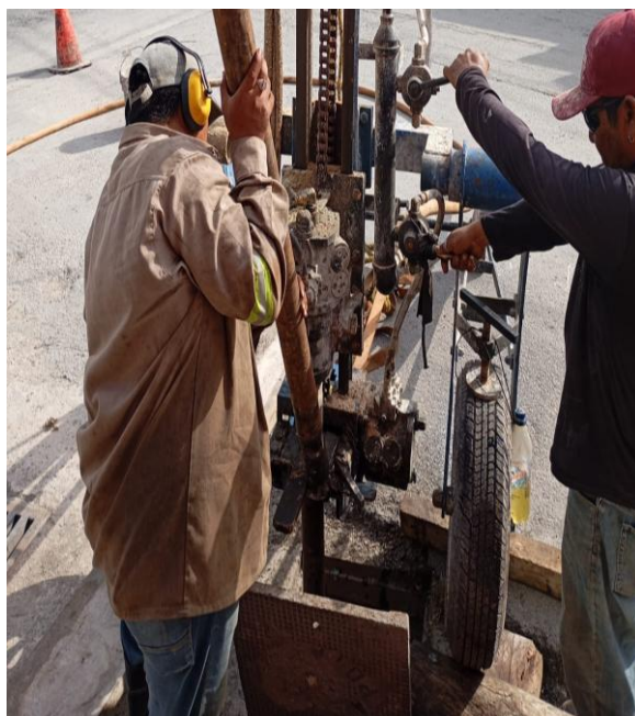
Desazolve. Calle 25 entre calle 14 y calle 16; colonia tumben kaa.
