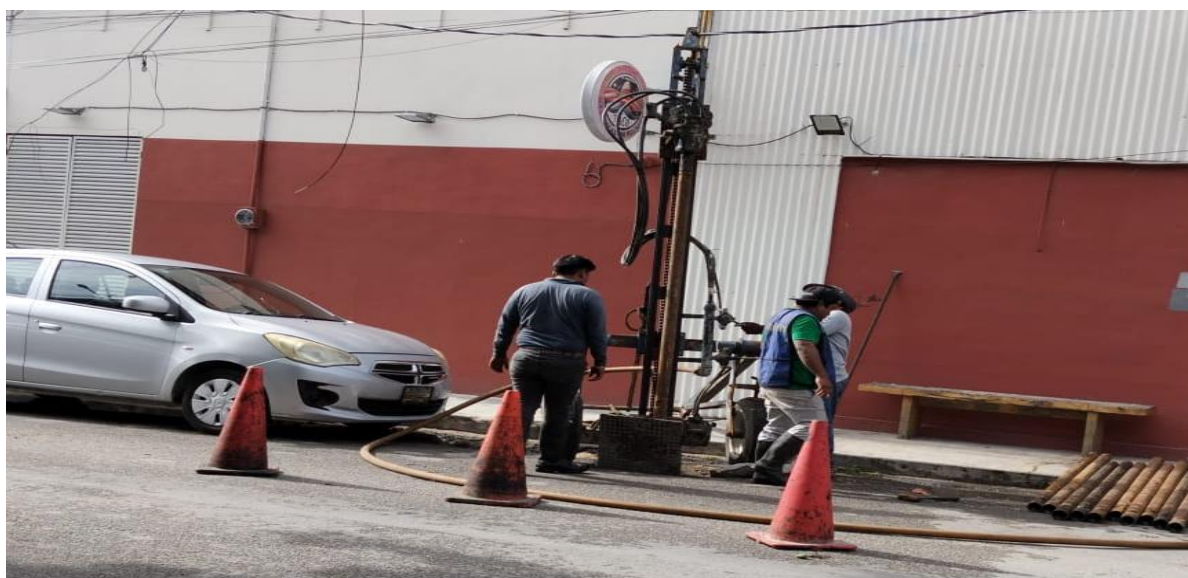
Desazolve. Calle sol oriente entre calle centauro sur; colonia centro. (Pozo 01).
