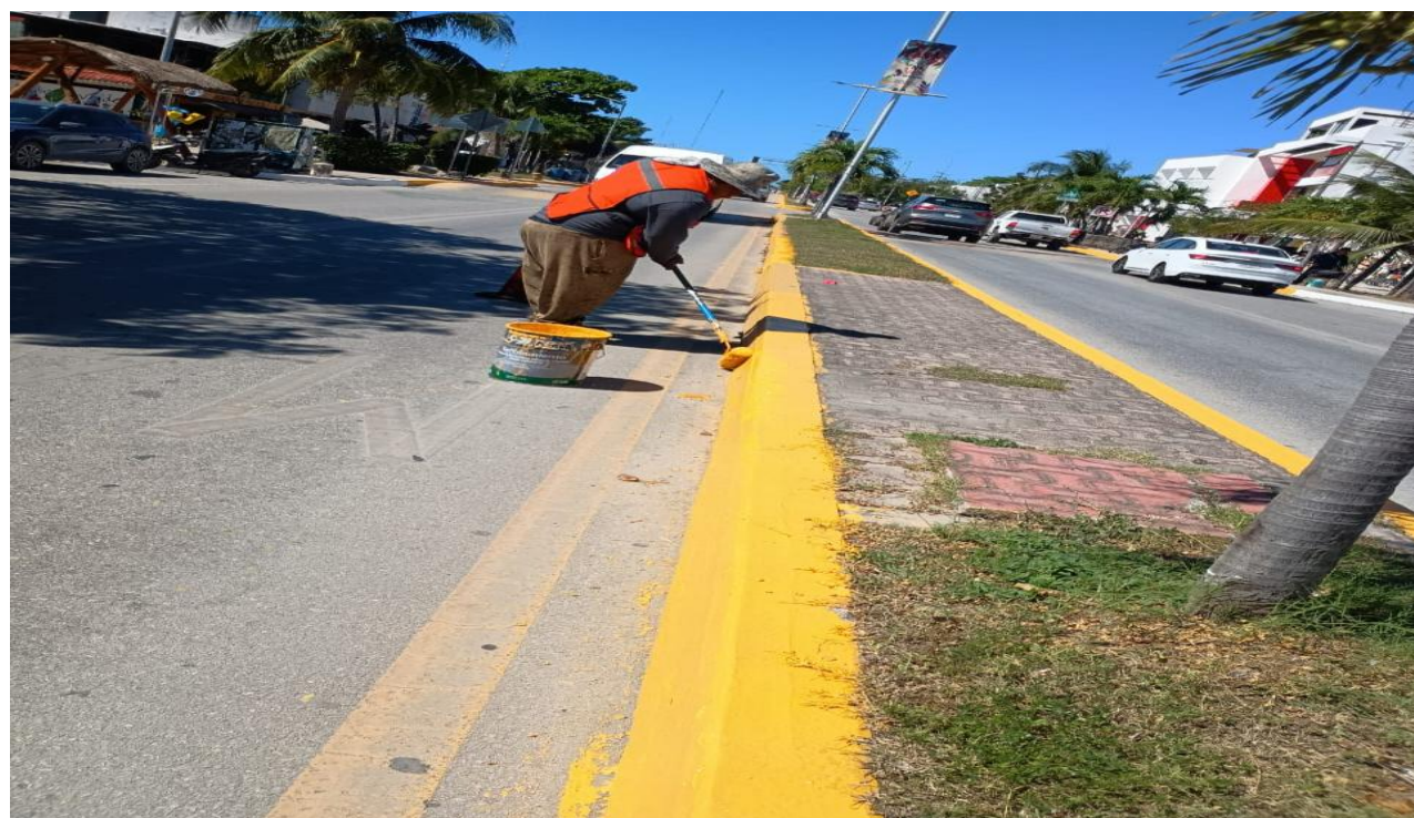
Pintura. Realización de pintura en el camellón central de la av. Tulum; colonia centro.
