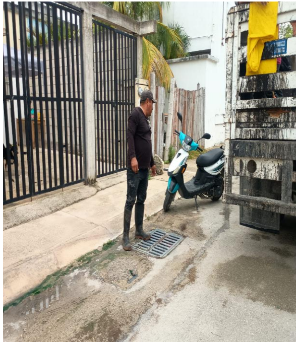
Limpieza de rejillas. Calle palma botella entre calle palma guinea y boulevard palmas Tulum; fraccionamiento las palmas.
