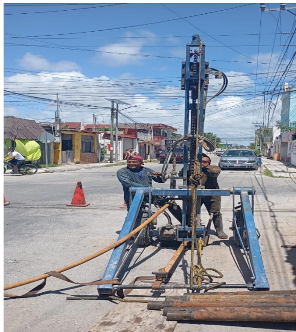
Desazolve. Calle 2 oriente entre calle alfa norte; colonia centro.
