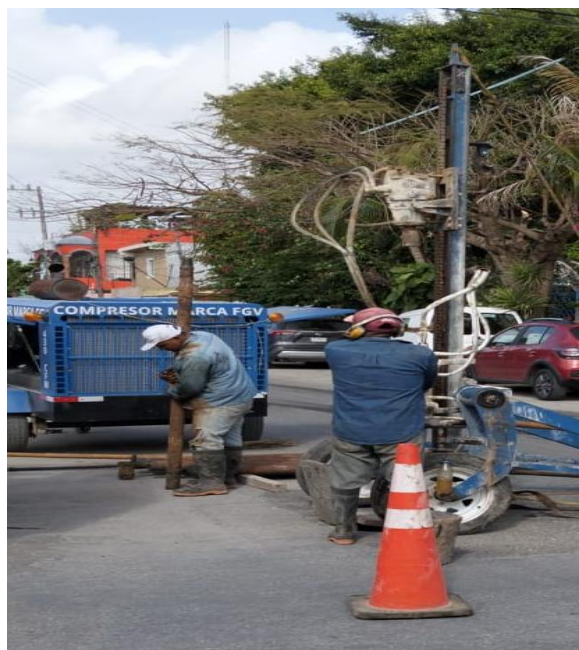
Desazolve. Calle 20 entre calle 13 y calle 15; colonia tumben kaa.
