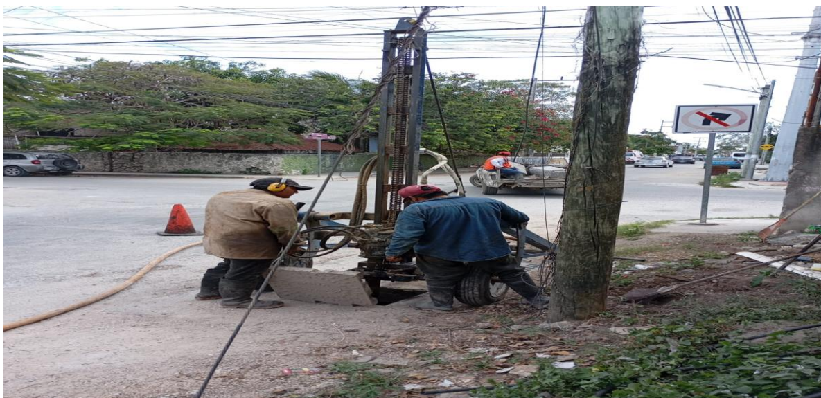
Desazolve. Calle 2 oriente entre calle júpiter norte; colonia centro.
