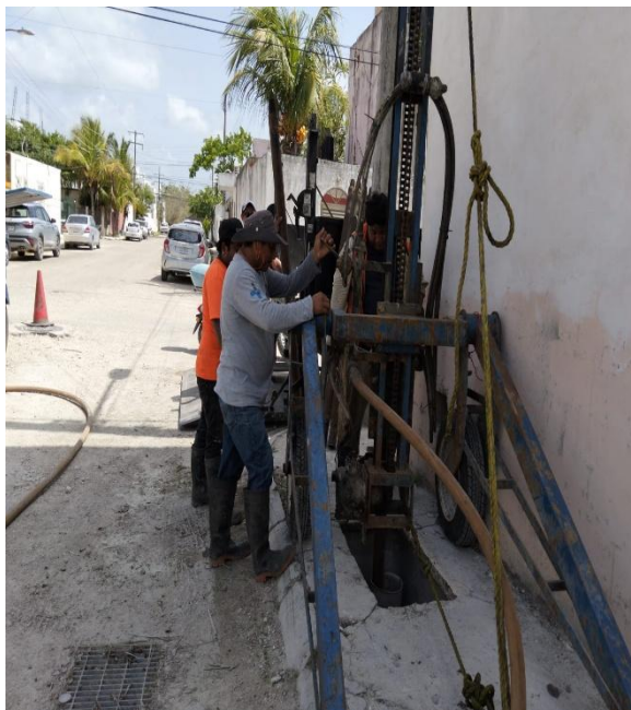
Desazolve. Calle 5 sur entre calle 2 bis oriente; fraccionamiento villas Tulum.
