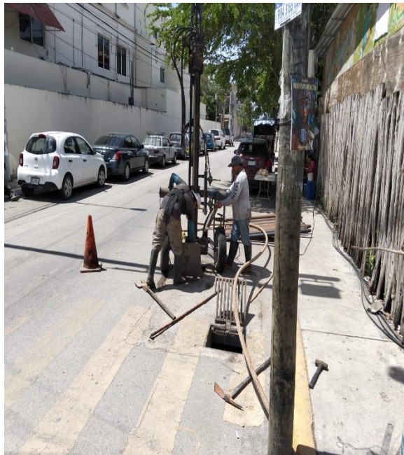
Desazolve. Calle alfa oriente entre calle sol sur; colonia centro.
