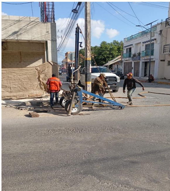
Desazolve. Calle sagitario entre calle centauro norte; colonia centro.
