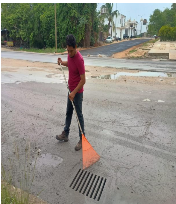
Limpieza de rejillas. Calle palmas Tulum entre calle 2 norte; fraccionamiento las palmas.
