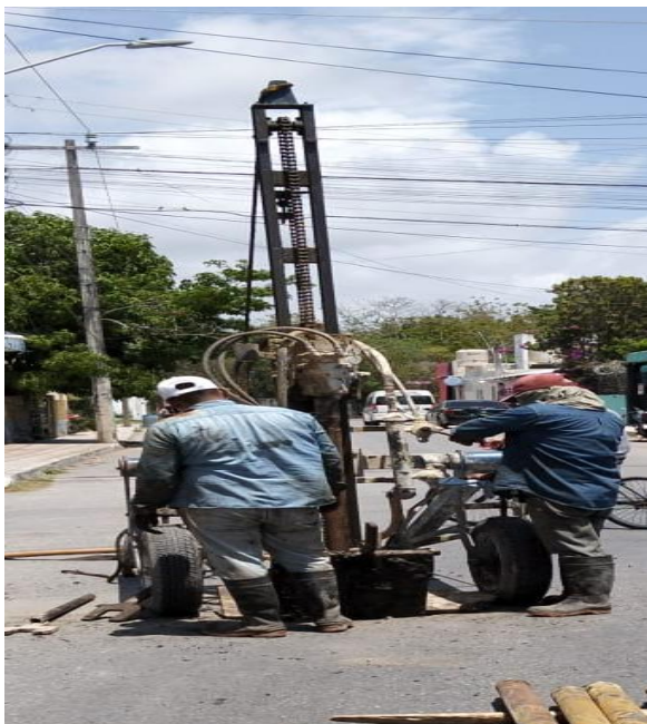
Desazolve. Calle 20 entre calle 21; colonia tumben kaa.
