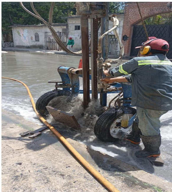
Desazolve. Calle 20 entre av. 2; colonia tumben kaa.
