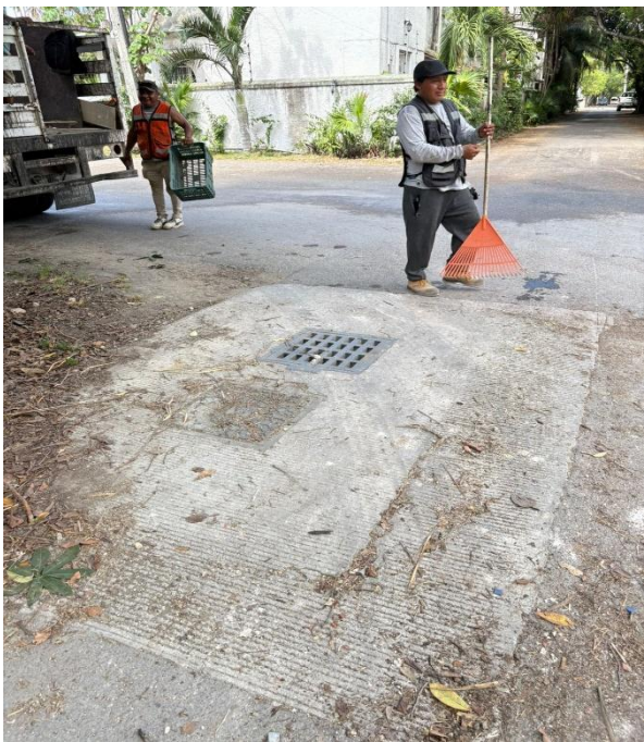
Limpieza de rejillas. Calle Chichén itzá entre calle chan caa; colonia ejido.
