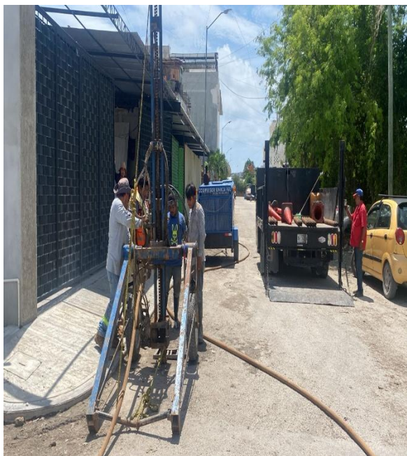
Desazolve. Calle bojom entre calle 21; colonia tumben kaa.
