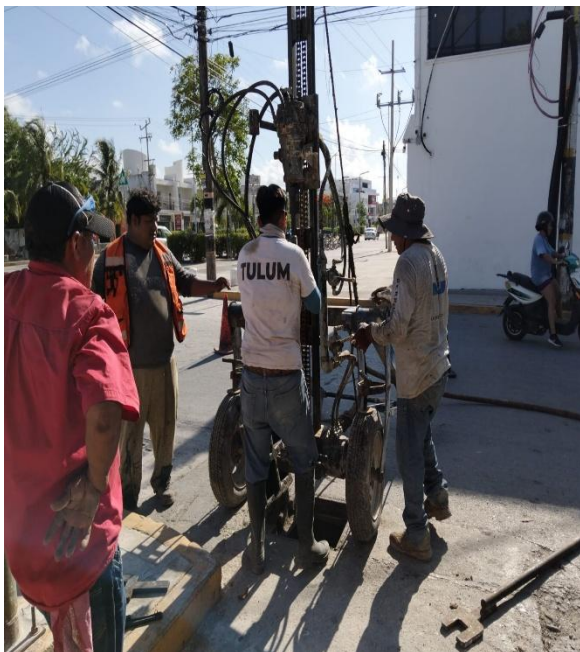
Desazolve. Calle alfa sur entre av. Tulum; colonia centro.
