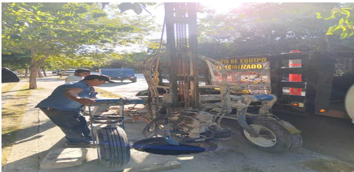
Desazolve. Av. cobá entre calle balam dzancab; fraccionamiento aldea zama. (Pozo 01).
