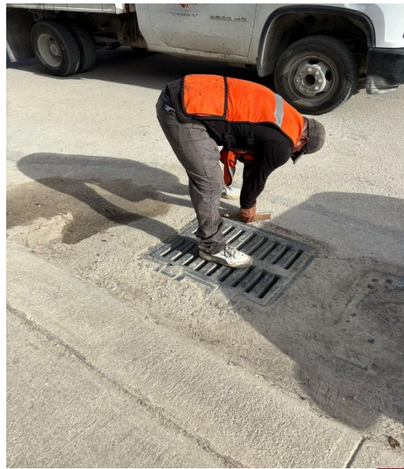
Limpieza de rejillas. Calle palmas kerpis entre calle palma guinea; fraccionamiento las palmas.
