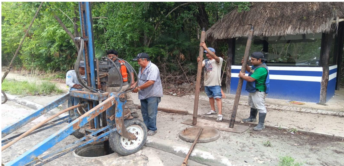
Desazolve. Av. cobá av. ramal y calle punta allen; fraccionamiento aldea Zama.
