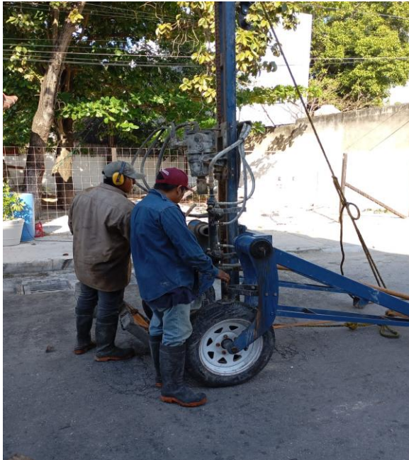
Desazolve. Calle beta norte entre calle polar y calle sagitario; colonia centro.
