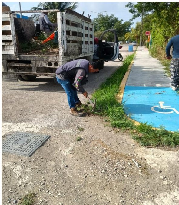
Limpieza de rejillas. Calle 18 entre calle 19; colonia tumben kaa.
