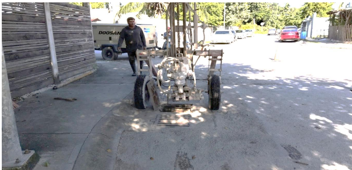
Desazolve. Calle 4 oriente entre calle Cecilio Chi; fraccionamiento guerra de castas.
