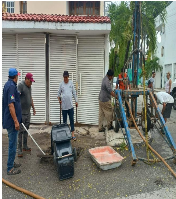
Desazolve. Calle 11 entre calle 2 oriente; fraccionamiento villas Tulum.
