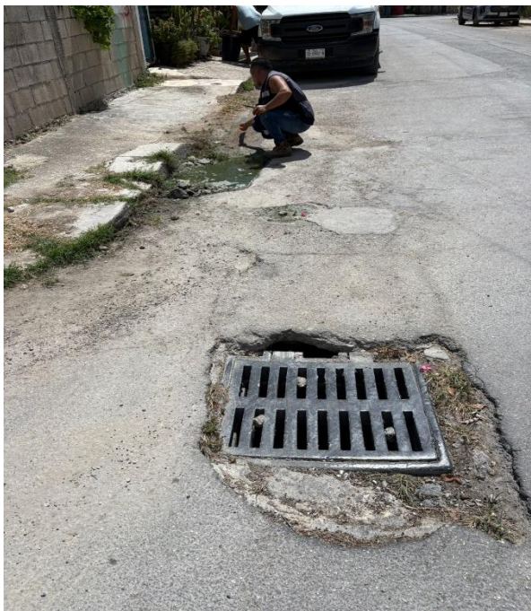
Limpieza de rejillas. Calle huracán gilberto entre calle huracán paulina; fraccionamiento huracanes.
