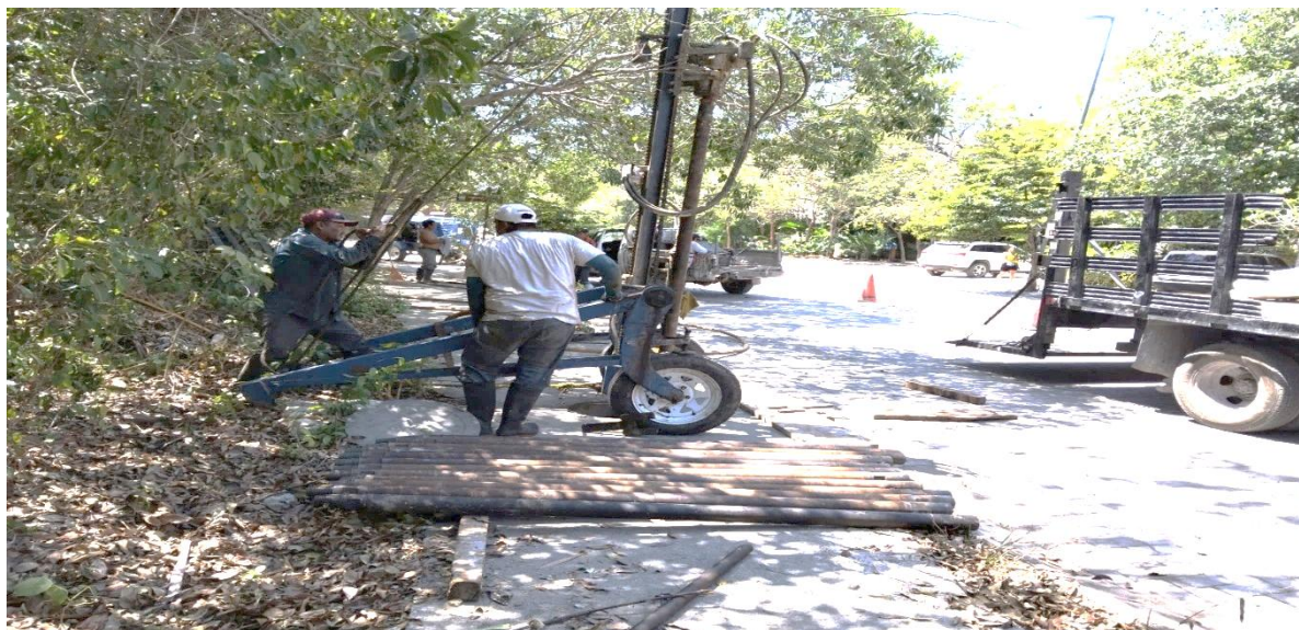
Desazolve. Calla kabah entre calle labnah y calle iximche; fraccionamiento aldea zama.
