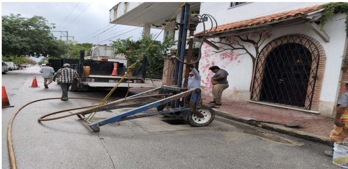
Desazolve. Calle venus oriente entre calle beta sur y calle ori3n sur; colonia centro.
