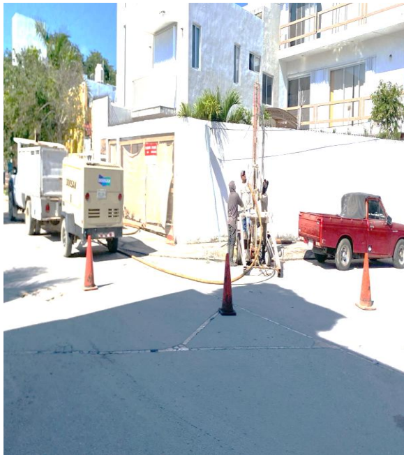
Desazolve. Calle libra norte entre calle 4 oriente; fraccionamiento guerra de castas.
