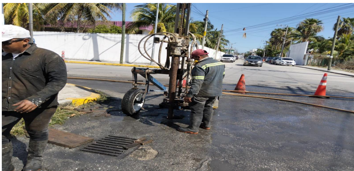
Desazolve. Calle alfa norte entre calle 4 poniente; colonia centro. (Pozo 02).
