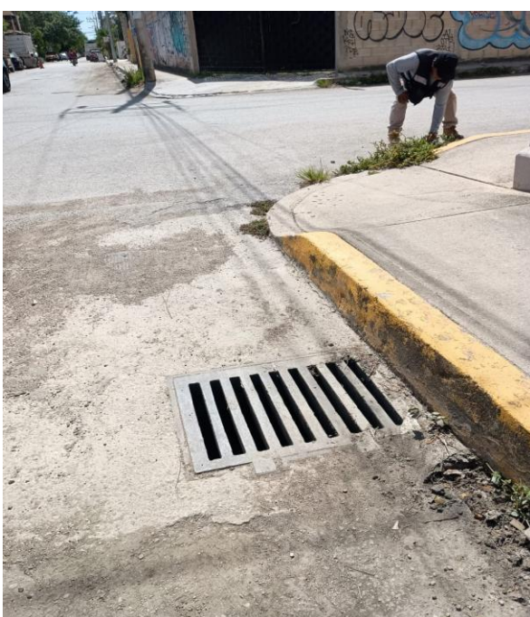
Limpieza de rejillas. Calle andrómada oriente entre calle géminis sur; colonia centro.
