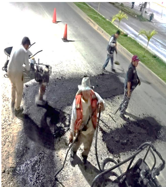
Bacheo. Av. cobá sur entre calle asteroides oriente y calle sol oriente; colonia sac be.
