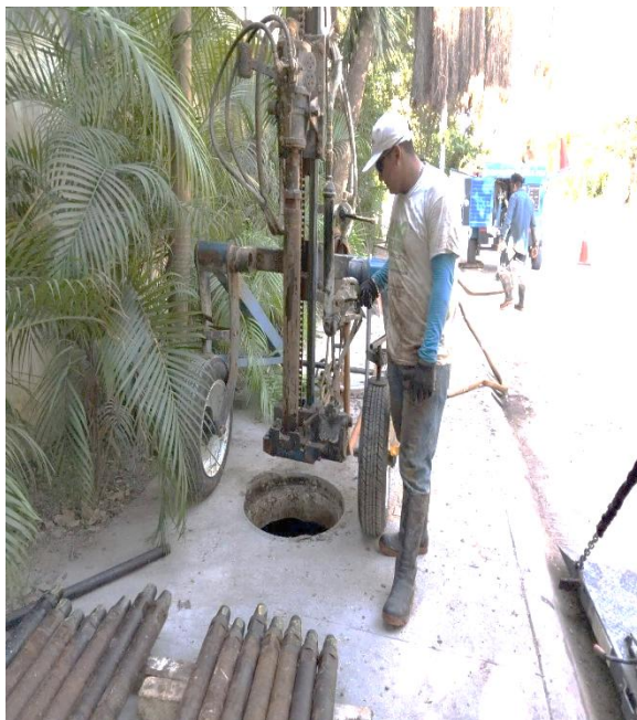
Desazolve. Av. juanek entre calle kabah; fraccionamiento aldea zama.
