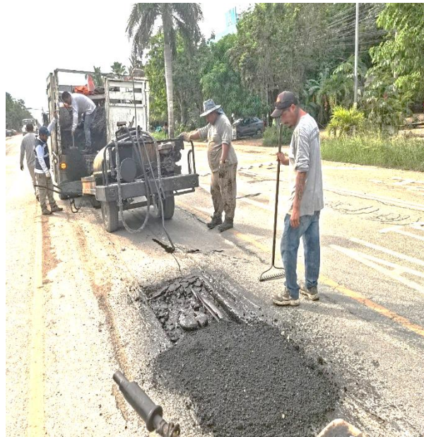
Bacheo. Av. cobá (Referencia frente a las oficinas de Seguridad Pública).
