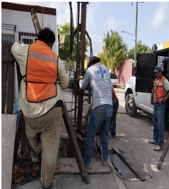
Desazolve. Calle 2 oriente entre calle 5 sur; fraccionamiento villas Tulum.
