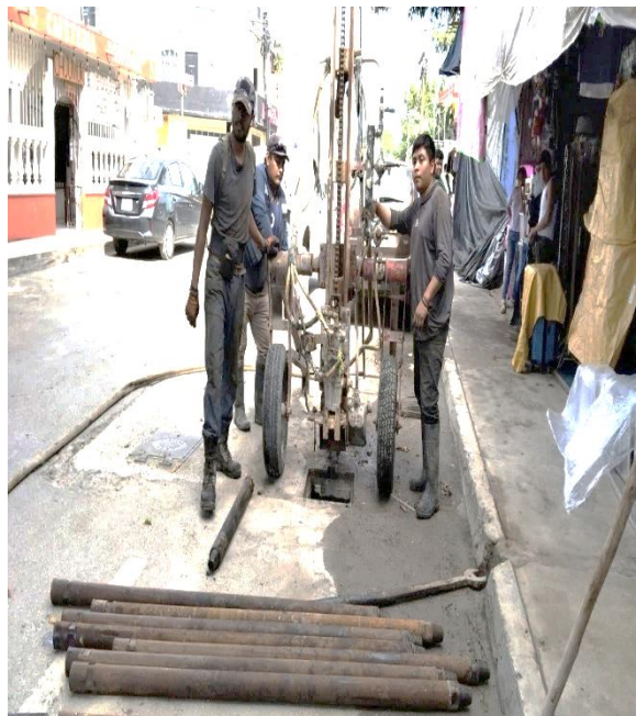
Desazolve. Calle júpiter sur entre calle sol poniente; colonia maya. (Pozo 01).
