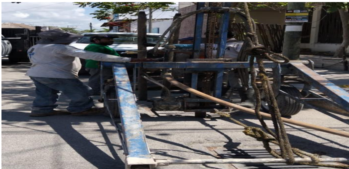
Desazolve. Calle 24 entre calle 23 y calle 25; colonia tumben kaa.
