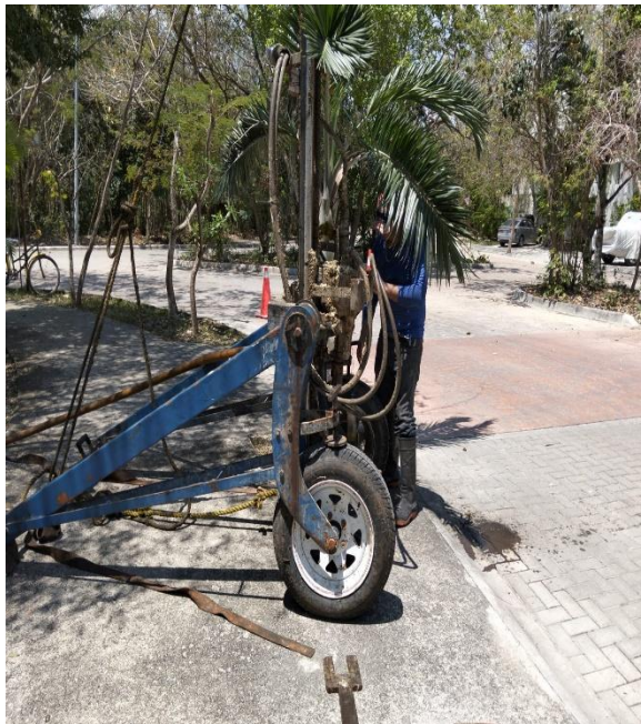
Desazolve. Calle balam dzacab y calle labnah; fraccionamiento aldea zama.
