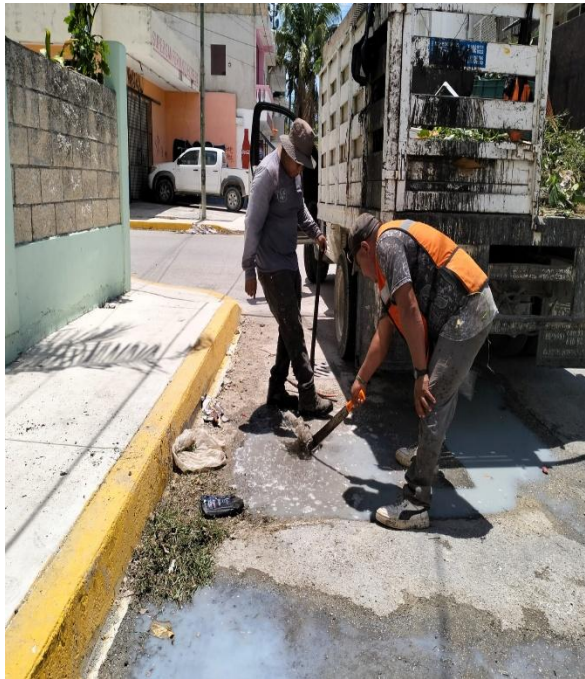
Limpieza de rejillas. Calle centauro norte entre calle tun-k'ul; colonia mayapax.
