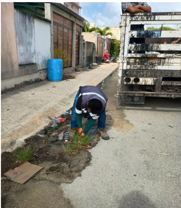
Limpieza de rejillas. Calle palma chat; fraccionamiento las palmas.
