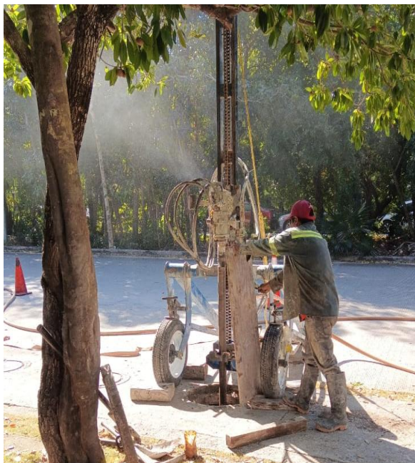
Desazolve. Av. 29 entre calle 12; colonia tumben kaa.
