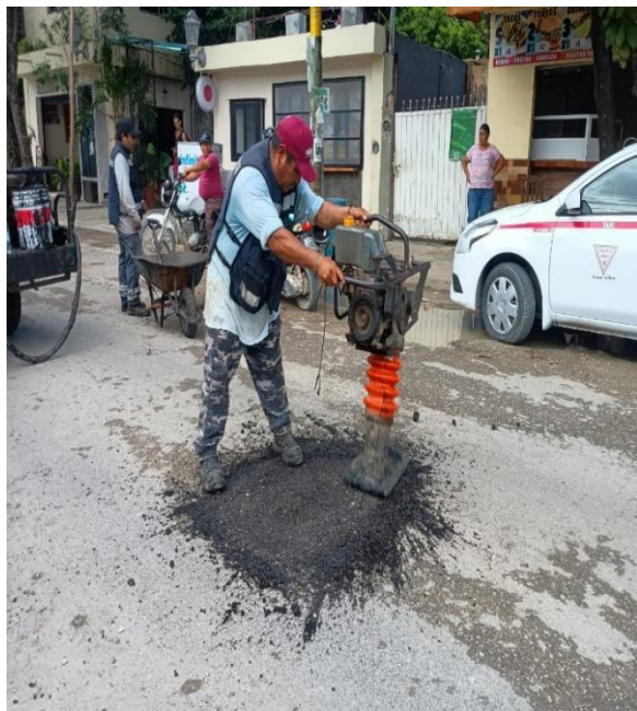
Bacheo. Calle sol oriente entre calle alfa sur y calle omega sur; colonia maya.
