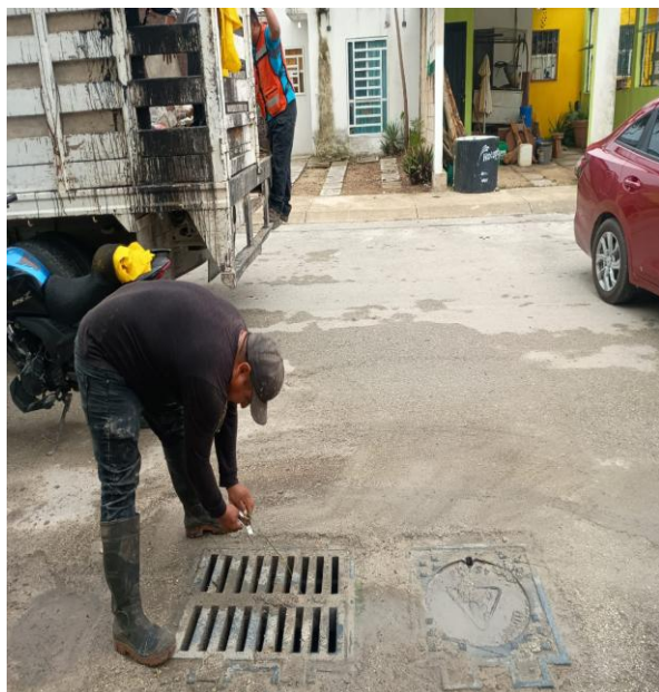
Limpieza de rejillas. Calle palma kerpis entre calle boulevard palmas Tulum; fraccionamiento las palmas.
