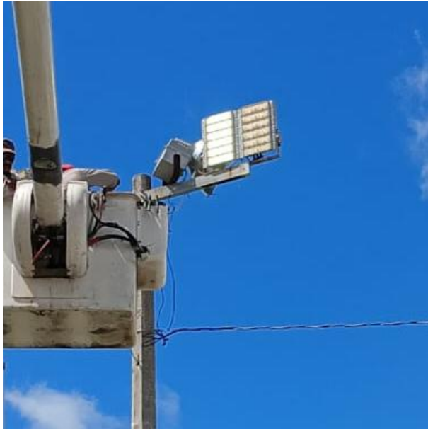
REPARACIÓN DE REFLECTOR; POBLADO CHEMUYIL.
