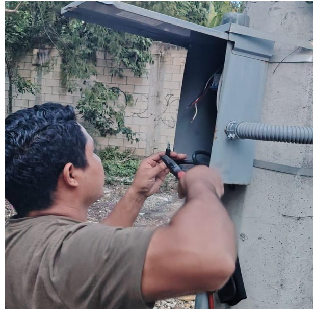
CAMBIO DE CONTACTOR OBSOLETO POR NUEVO PARA HABILITAR SECTOR APAGADO; C. TAURO ENTRE C. CHEMUYIL Y AV. LA SELVA. COL. EJIDO.
