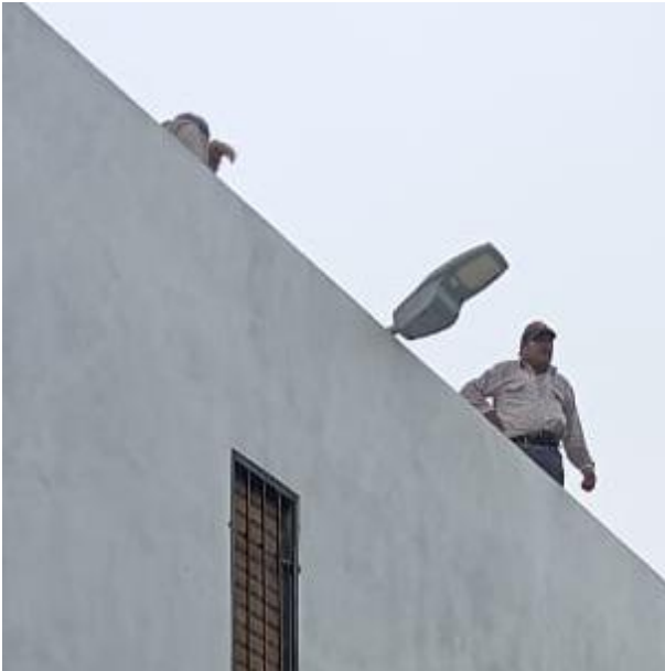
CAMBIO DE FOTOCELDA A LUMINARIAS; CAS, COLONIA CRISTAL.
