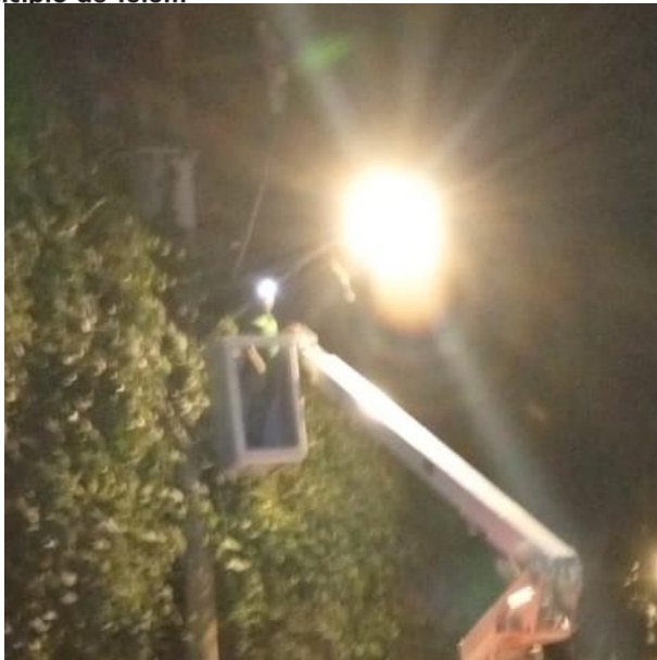
CAMBIO DE FOTOCELDA A LUMINARIAS; C. ASUNCIÓN ENTRE C. COBA Y C. PALENQUE, COL. LA VELETA.
