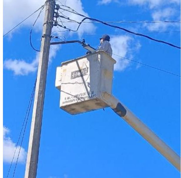
REPARACIÓN DE LUMINARIAS HACIENDO CAMBIO DE MATERIAL OBSOLETO POR NUEVO; POBLADO SAN JUAN DE DIOS.
