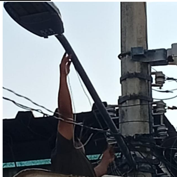
CAMBIO DE LINEAS QUEMADAS POR NUEVAS; C. ORION NTE ENTRE C. TUN-KUL Y C. OOK-K'OT, COL. MAYAPAX.
