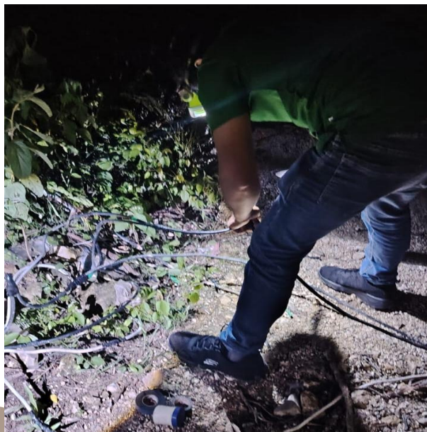
RECONEXIÓN DE LINEAS SUBTERRANEAS DAÑADAS; C. RIO OTATE ENTRE C. RIO PLAYON, COL. TUMBEN-KAA.
