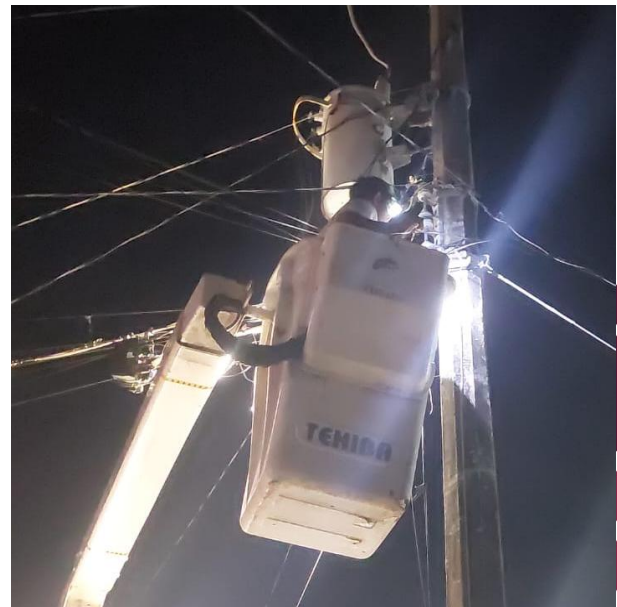
CAMBIO DE BASE DE FOTOCELDA Y FOTOCELDA; C. ACUARIO NTE ENTRE C. 2 PTE Y C. 4 PTE, COL. LUNA.
