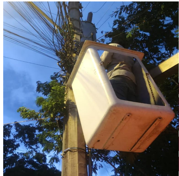
RECONEXIÓN DE LINEAS PARA HABILITAR LUMINARIAS; C. 8 ENTRE AV. LA SELVA Y C. CHICHEN-ITZA, COL. TUMBEN-KAA.
