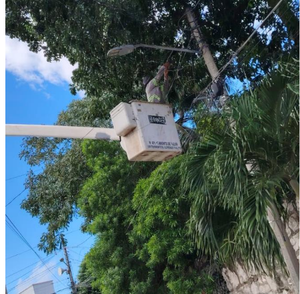
CAMBIO DE FOTOCELDA A LUMINARIA; C. SOL OTE ENTRE C. BETA SUR Y AV. OSIRIS SUR, COL. CENTRO.
