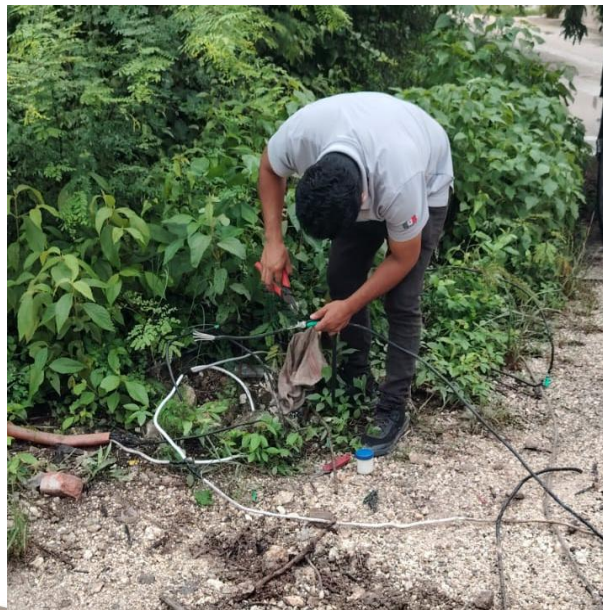
RECONEXIÓN DE LINEAS SUBTERRANEAS DAÑADAS; AV 1 ENTRE RIO PLAYON, COL. TUMBEN-KAA.
