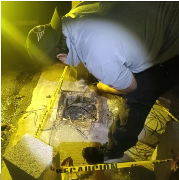
RECONEXIÓN DE LINEAS PARA HABILITAR LUMINARIA APAGADA; C. PALMA GUINEA, FRACC. PALMAS.
