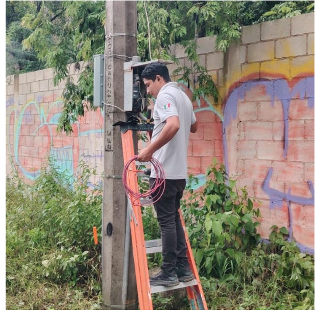
CAMBIO DE CONTACTOR E INTERRUPTOR OBSOLETOS POR NUEVOS; C. 24 ENTRE AV. 1, COL. TUMBEN-KAA.
