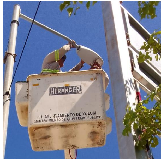
CAMBIO DE LUMINARIAS OBOELTAS POR LED NUEVAS; RUINAS TULUM.
