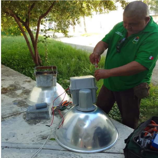
REPARACIÓN DE REFLECTORES; UNIDAD DEPORTIVA, COL. CENTRO.
