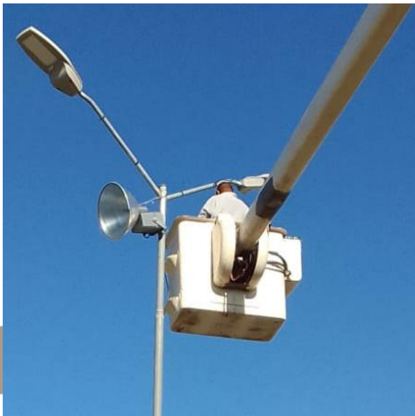
CAMBIO DE MATERIAL OBSOLETO POR NUEVO PARA HABILITAR REFLECTOR; AV. 2 ENTRE C. 24 Y C. 20, COL. TUMBEN-KAA.
