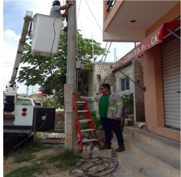
CAMBIO DE LINEAS OBSOLETAS PARA HABILITAR SECTOR; POBLADO AKUMAL.
