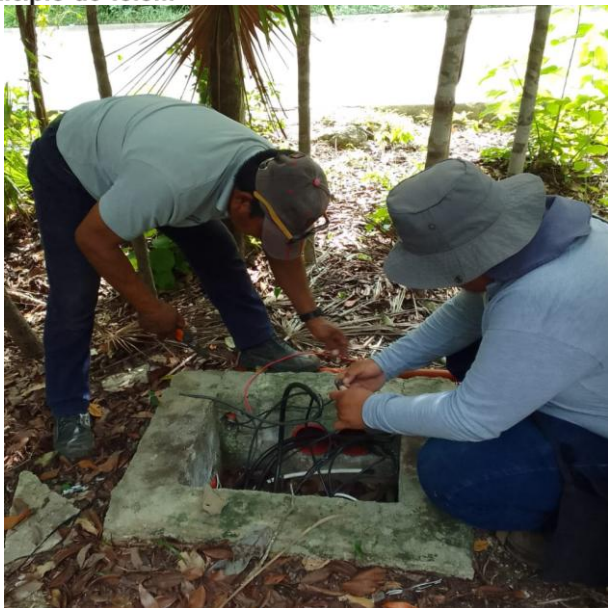
RECONEXIÓN DE LINEAS SUBTERRANEAS PARA HABILITAR SECTOR; AV. ITZAMNA, FRACC. ALDEA ZAMA.
