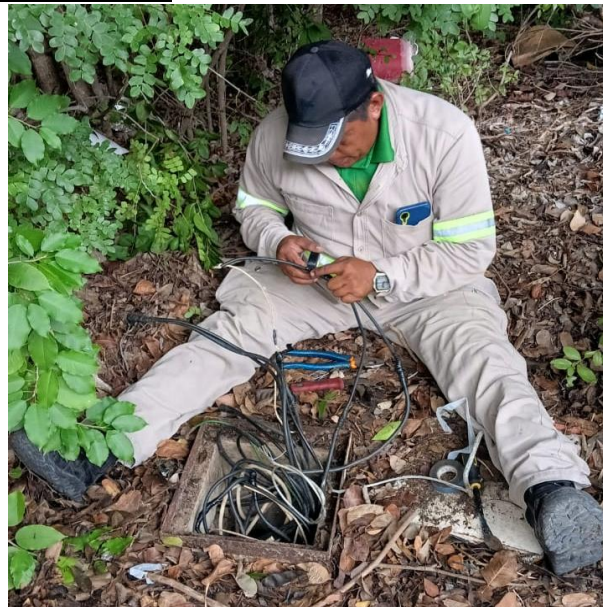
REHABILITACIÓN DE LINEAS SUBTERRANEAS POR CORTO CIRCUITO PARA HABILITAR SECTOR; AV. CENTRAL, FRACC. ALDEA ZAMA.
