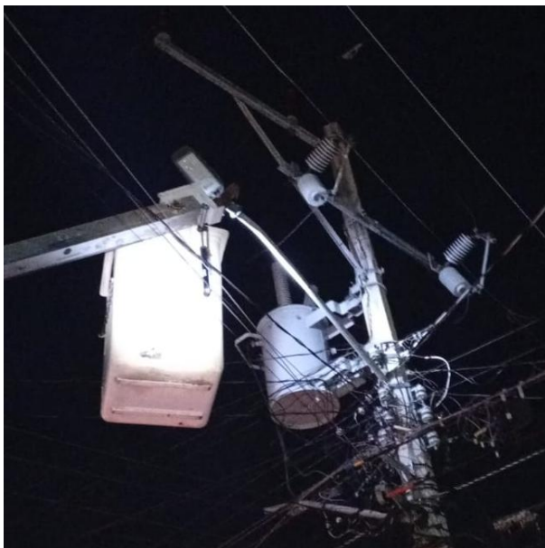
CAMBIO DE LUMINARIAS OBSOLETAS POR LED NUEVASC. 4 PTE ENTRE AV. SATELITE NTE Y C. CENTAURO NTE, COL. CENTRO.
