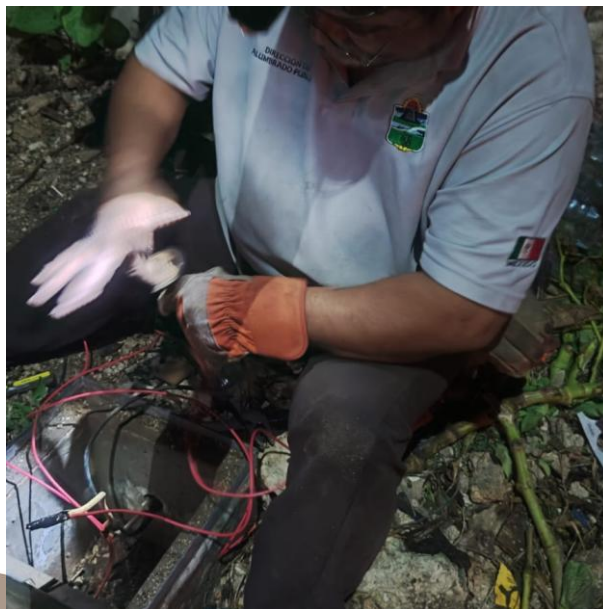
CAMBIO DE LINEAS DEL REGISTRO A LUMINARIA; C. 15 ENTRE C. 12 Y C. NAVAL, COL. TUMBEN-KAA.
