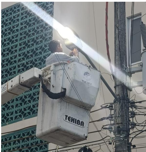
CAMBIO DE LUMINARIA OBSOLETA POR LED NUEVA; C. POLAR ENTRE C. JUPITER NTE Y C. ALFA NTE, COL. CENTRO.
