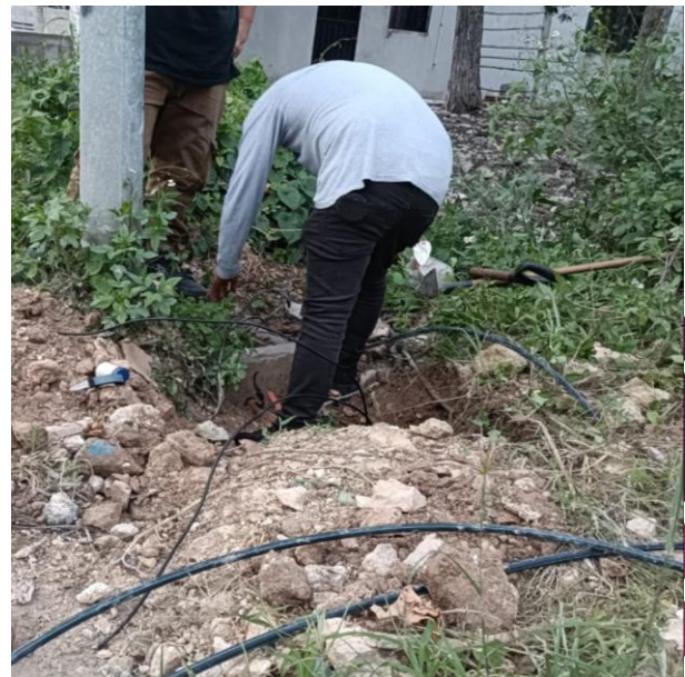
RECONEXIÓN DE LINEAS SUBTERRANEAS REVENTADAS; C. 20 ENTRE C. ALCATRAZ, FRACC. YA'AX TULUM.
