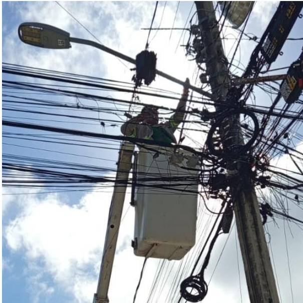
CAMBIO DE LINEAS PARA HABILITAR LUMINARIA APAGADA; C. OMEGA SUR ENTRE C. MERCURIO PTE, COL. CENTRO.
