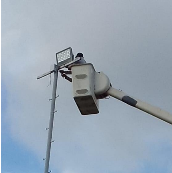
CAMBIO DE REFLECTOR OBSOLETO POR NUEVO; UNIDAD DEPORTIVA, COL. CENTRO.
