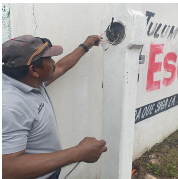
CAMBIO DE BASE DE MEDIDOR OBSOLETO POR NUEVO Y RECONEXIÓN DE LINEAS; C. 2 OTE ENTRE C. ACUARIO NTE, COL. CENTRO.
