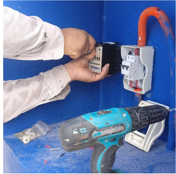
CAMBIO DE CONTACTOR Y BREAK OBSOLETOS POR NUEVOS; PARQUE, COL. XUL-KAA.
