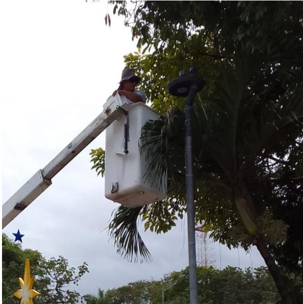
CAMBIO DE LUMINARIAS OBSOLETAS POR LED NUEVAS; OV OSIRIS ENTRE AV. TULUM Y C. SOL OTE, COL. CENTRO.
