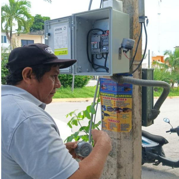
CAMBIO DE BASE DE FOTOCELDA PARA HABILITAR SECTOR; POBLADO AKUMAL.
