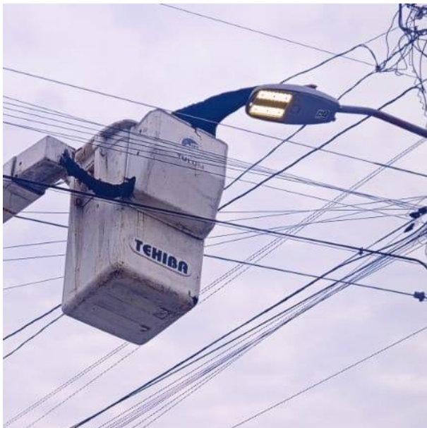
CAMBIO DE FOTOCELDA A SECTOR PARA HABILITARLO; C. KUKUKAN ENTRE C. GABILANES Y C. CODORNICES, COL. EJIDO.
