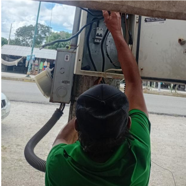
CAMBIO DE CONTACTOR OBSOLETO POR NUEVO Y CAMBIO DE FOTOCELDA; POBLADO COBA.
