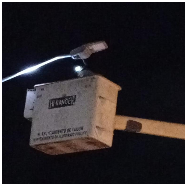
INSTALACIÓN DE LUMINARIA CON EQUIPO COMPLETO; C. 19 ENTRE C. 24 Y AV. 28, COL. TUMBEN-KAA.
