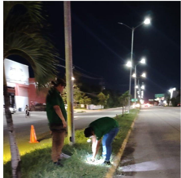
REPARACIONES DE LUMINARIAS APAGADAS Y RECONEXIONES DE LINEAS SUBTERRANEAS; AV. TULUM.
