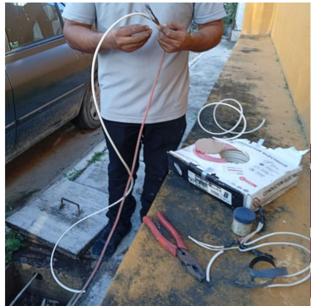
CAMBIO DE LINEAS SUBTERRANEAS DAÑADAS POR NUEVAS; C. 4 OTE ENTRE C. 13 Y CHEMUYIL; FRACC. VILLAS TULUM.
