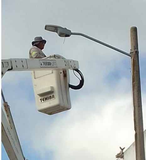
CAMBIO DE LUMINARIAS OBSOLETAS POR LED NUEVAS; C. PALMA BOTELLA, FRACC. PALMAS.
