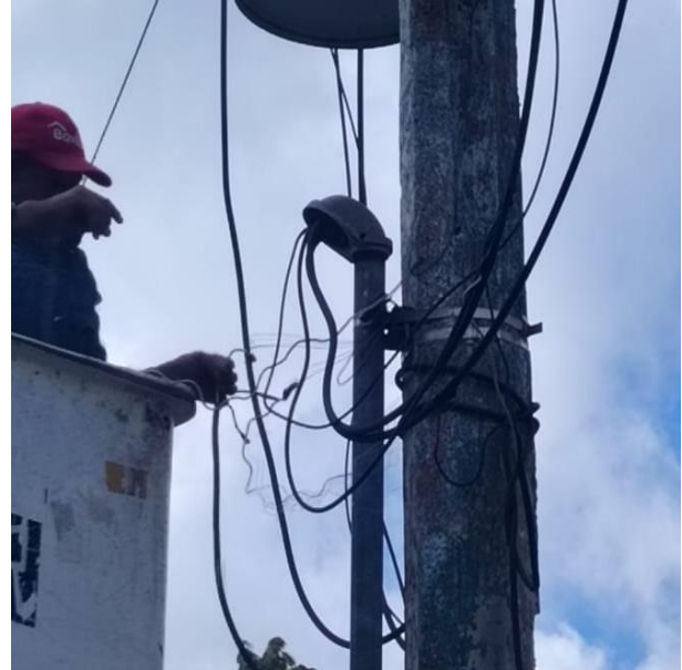
RECONEXIÓN DE LINEAS SULFATADAS; UNIDAD DEPORTIVA, COL. CENTRO.
