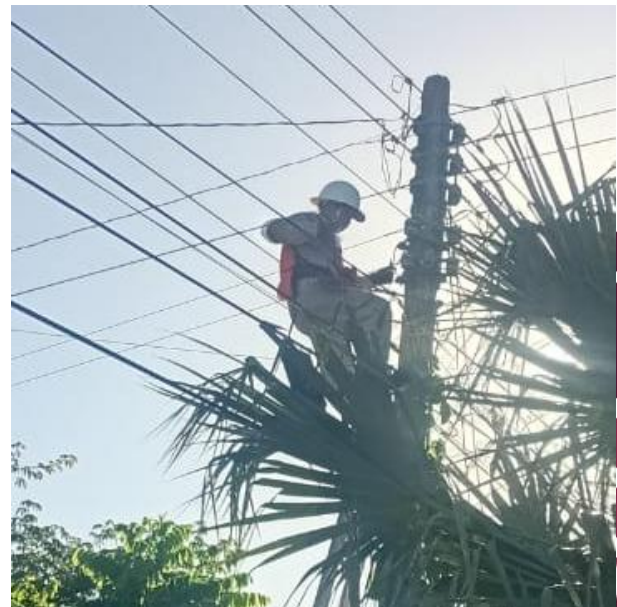
VERIFICACIÓN Y RECONEXIÓN DE LINEAS AEREAS; POBLADO MANUEL ANTONIO AY.
