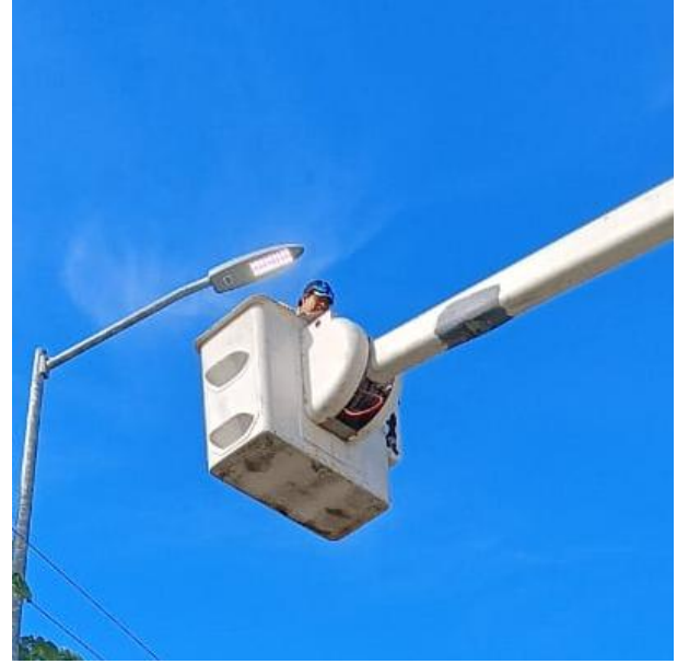
CAMBIO DE FOTOCELDAS DAÑADAS A LUMINARIAS LED; C. VIOLETA ENTRE C. GLADIOLA Y AV. NTE, FRACC. YA'AX TULUM.
