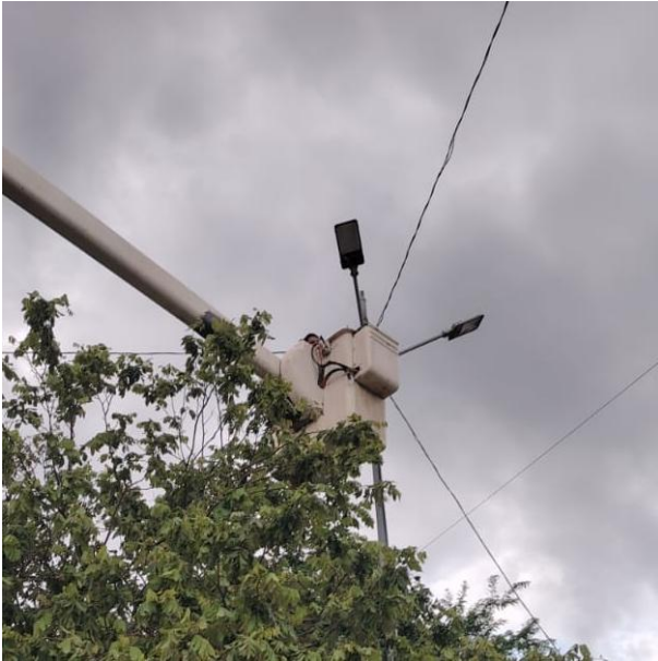
REPARACIÓN DE LINEAS AEREAS PARA HABILITAR LUMINARIAS; COLONIA
