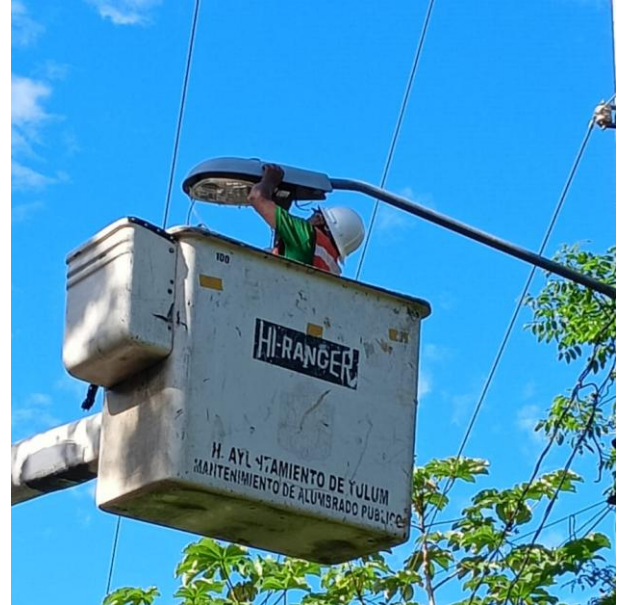
REPARACIÓN DE LUMINARIAS LED APAGADAS; POBLADO MACARIO GOMEZ.
