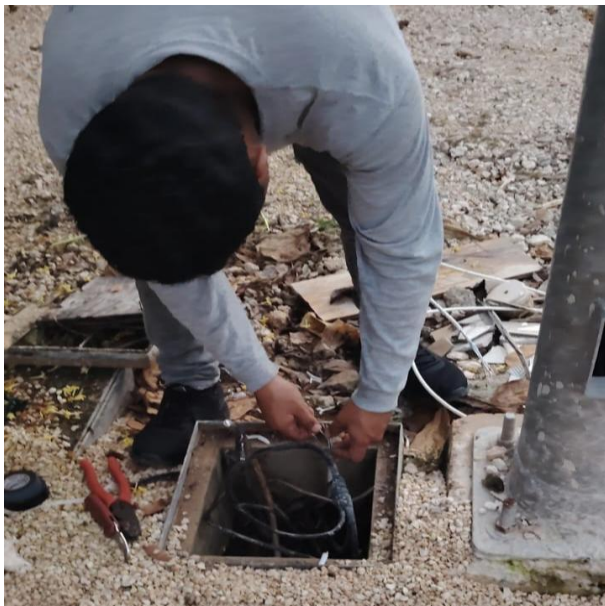
SE TENSIONA CABLE PARA HABILITAR SECTOR DAÑADO POR MAQUINARIA; FRACC. XUL-KAA.
