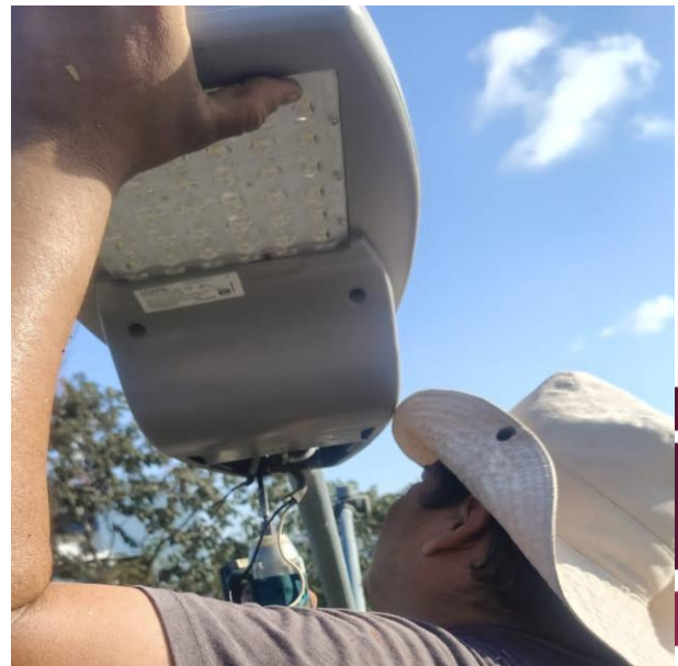
CAMBIO DE LUMINARIAS OBSOLETAS POR LED NUEVAS Y CAMBIO DE LINEAS DE ALIMENTACIÓN; AV. LA SELVA ENTRE AV. 5 BIS NTE Y AV. 10 NTE, FRACC. XUL-KAA.
