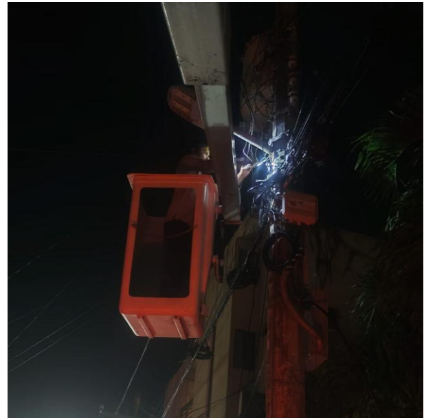
RECONEXIÓN DE LINEAS REVENTADAS PARA HABILITAR LUMINARIA; C. ORIÓN NTE ENTRE C. POLAR PTE Y C. SAGITARIO OTE, COL. CENTRO.
