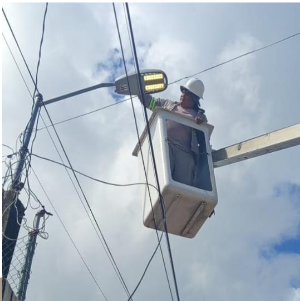
CAMBIO DE FOTOCELDA; COLONIA CENTRO.
