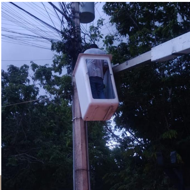
RECONEXIÓN DE LINEAS PRINCIPALES DEL SECTOR Y CAMBIO DE FOTOCELDA; C. 8 ENTRE AV. LA SELVA Y C. CHICHEN-ITZA, COL. TUMBEN-KAA.
