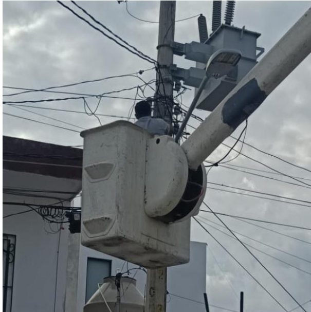
REHABILITACIÓN DE LÍNEAS PARA HABILITAR SECTOR; C. ORIÓN NTE ENTRE C. KII'S Y C. TUN-K'UL, COL. MAYAPAX.
