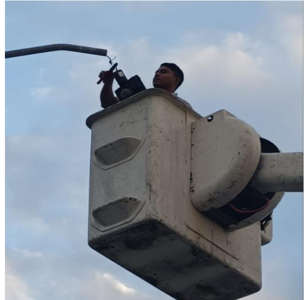
CAMBIO DE LUMINARIA OBSOLETA POR LED NUEVA; C. PALMA GUINEA, FRACC. PALMAS.
