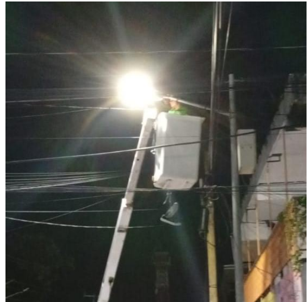
CAMBIO DE LUMINARIA OBSOLETA POR LED NUEVA; C. BETA SUR ENTRE C. SOL OTE Y C. ANDROMEDA OTE, COL. CENTRO.
