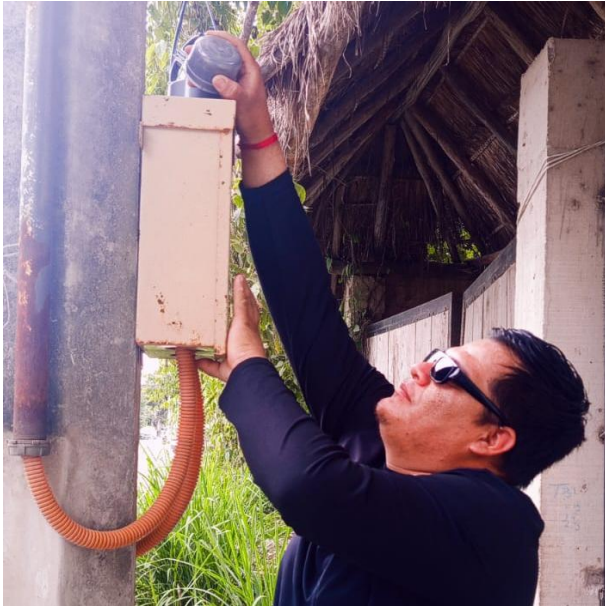
CAMBIO DE FOTOCELDA A SECTOR PARA HABILITARLO; C. KUKUKAN ENTRE C. GABILANES Y C. CODORNICES, COL. EJIDO.
