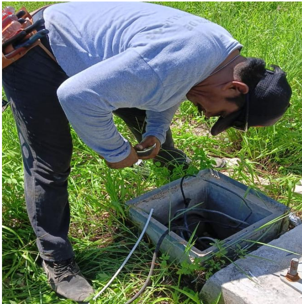
VERIFICACIÓN Y REHABILITACIÓN DE LINEAS SUBTERRANEAS POR CORTO CIRCUITO; PARQUE, COL.XUL-KAA.
