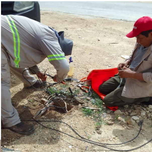
CAMBIO DE LINEAS DAÑANADAS POR NUEVAS; C. JAZMIN ENTRE C. AZUCENA Y AV. NTE, FRACC. YA'AX TULUM.
