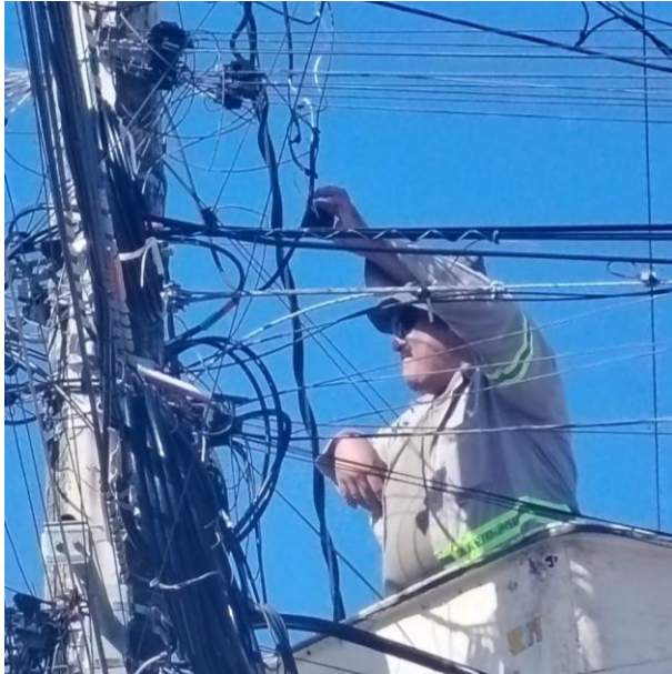
RECONEXIÓN DE LINEAS AEREAS; C. SOL OTE ENTRE C. BETA SUR Y AV. OSIRIS SUR, COL. CENTRO.
