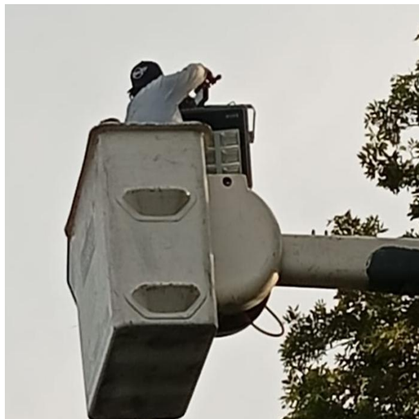
CAMBIO DE REFLECTORES LED OBSOLETOS POR NUEVOS; UNIDAD DEPORTIVA, COL. CENTRO.
