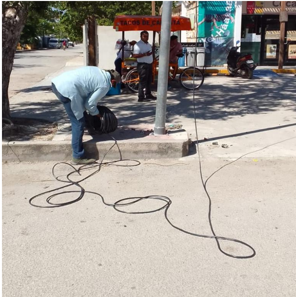
SE TENSIONAN LINEAS PARA HABILITAR LUMINARIAS; RUINAS TULUM.
