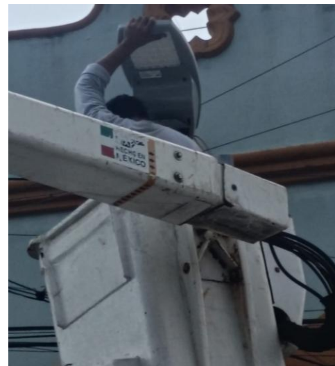
CAMBIO DE LUMINARIA OBSOLETA POR LED NUEVA; C. 2 OTE ENTRE C. JUPITER NTE Y C. OMEGA NTE, COL. CENTRO.
