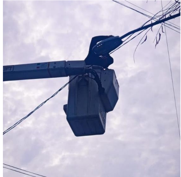
CAMBIO DE FOTOCELDA A LUMINARIA; C. JUPITER SUR ENTRE C. SOL PTE Y C. NEPTUNO PTE, COL. CENTRO.
