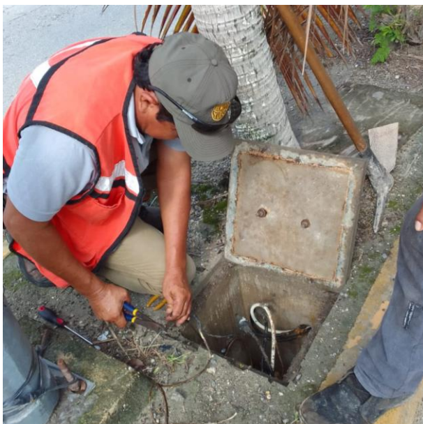
VERIFICACIÓN Y RECONEXIÓN DE LINEAS SUBTERRANEAS; POBLADO FRANCISCO UH MAY.
