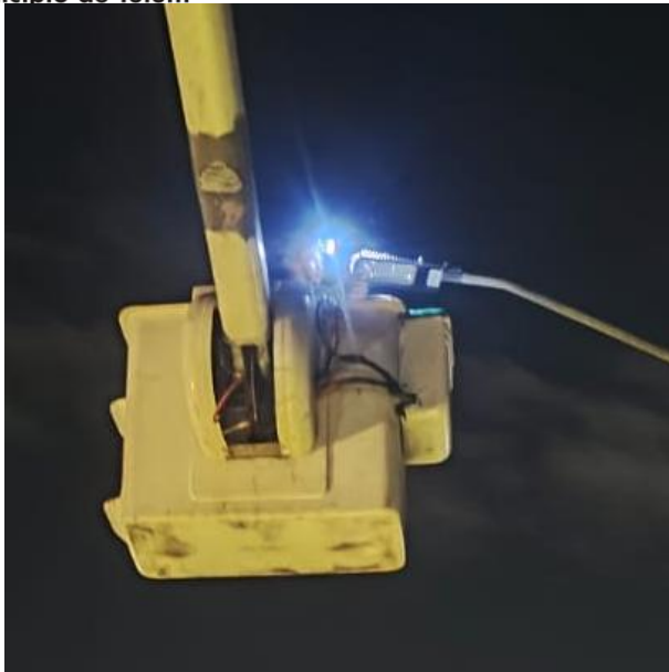
REPARACIÓN DE LUMINARIAS APAGADAS; C. 2 BIS NTE ENTRE C. 40 Y C. 23, COL. CRISTAL.
