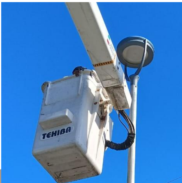
CAMBIO DE LUMINARIAS OBSOLETAS POR LED NUEVAS; UNIDAD DEPORTIVA, COL. CENTRO.
