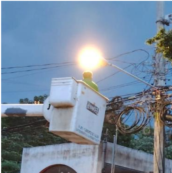
CAMBIO DE FOTOCELDA; COLONIA EJIDO.
