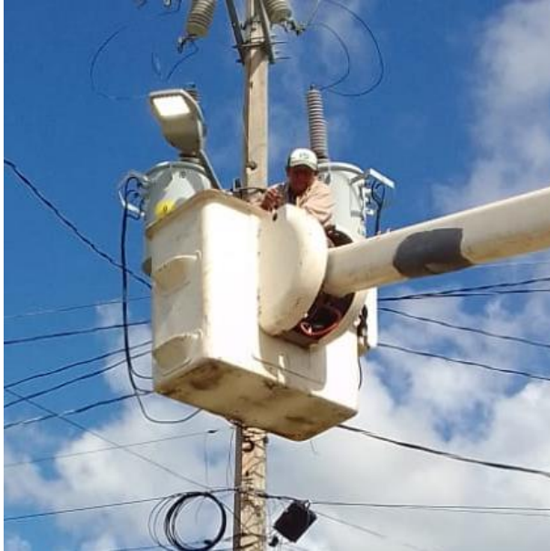
CAMBIO DE LUMINARIA OBSOLETA POR NUEVA; COLONIA CRISTAL.
