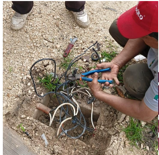
CAMBIO DE LINEAS DAÑADAS PARA HABILITAR SECTOR; 20 AV NTE ENTRE C. ALCATRAZ Y C. JAZMIN, FRACC. YA'AX TULUM.
