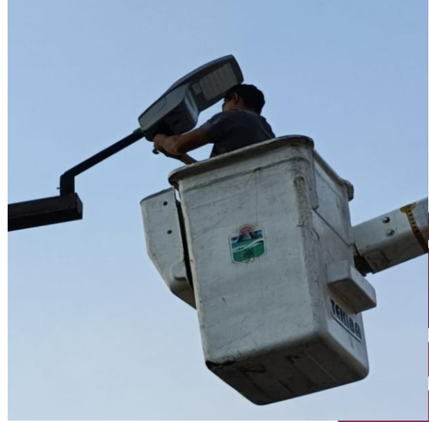
CAMBIO DE LUMINARIAS OBSOLETAS POR LED NUEVAS; AV. SATELITE NTE ENTRE AV. TULUM Y C. SAGITARIO.
