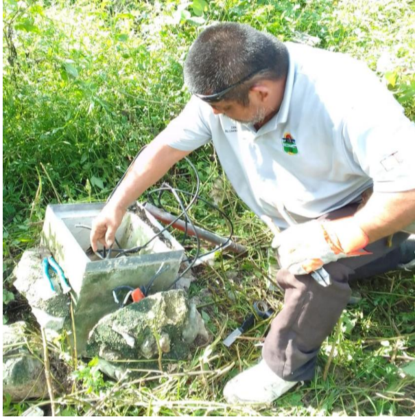
CAMBIO DE LINEAS DAÑADAS PARA HABILITAR SECTOR; C. VIOLETA ENTRE C. GLADIOLA Y AV. NTE, FRACC. YA'AX TULUM.
