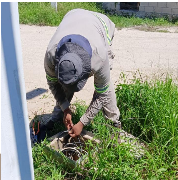
RECONEXIÓN DE LINEAS SUBTERRANEAS REVENTADAS; COLONIA MARITES.
