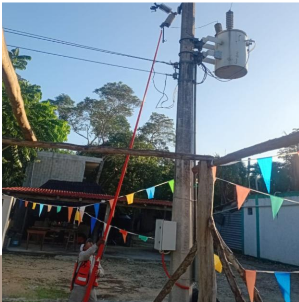
CAMBIO DE FUSIBLES A CUCHILLAS DE TRANSFORMADOR; POBLADO MANUEL ANTONIO AY.
