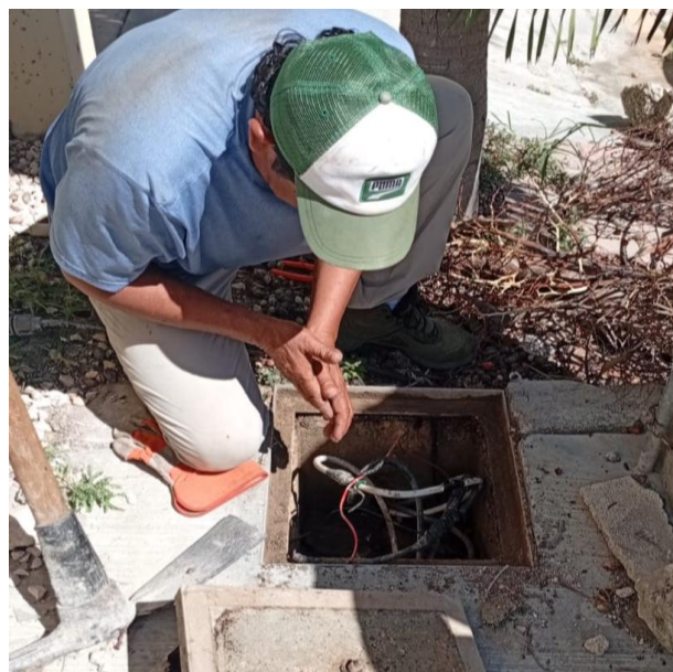
RECONEXIÓN DE LINEAS SULFATADAS PARA HABILITAR LUMINARIAS; C. 27 ENTRE C. 20 Y C. 12, COL. TUMBEN-KAA.
