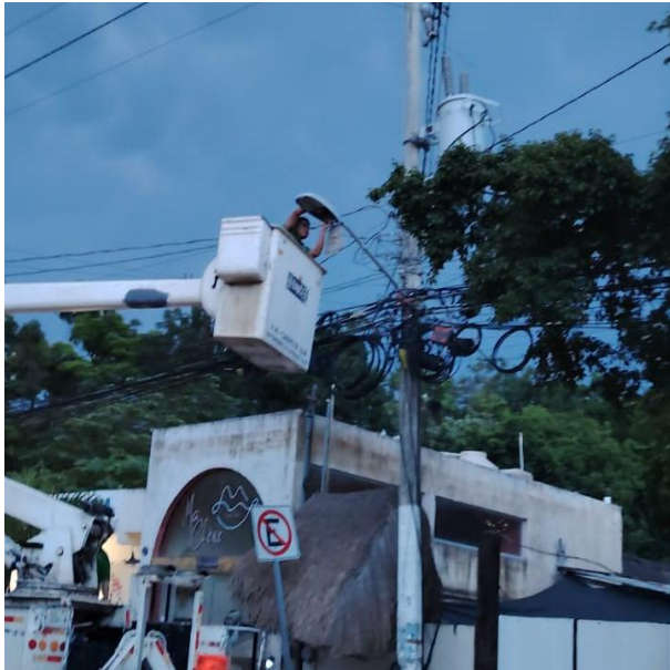
CAMBIO DE FOTOCELDA, REPOSICIÓN DE LUMINARIA Y BRAZO DE LUMINARIA; C. 7 SUR ENTRE AV. 10, COL. LA VELETA.
