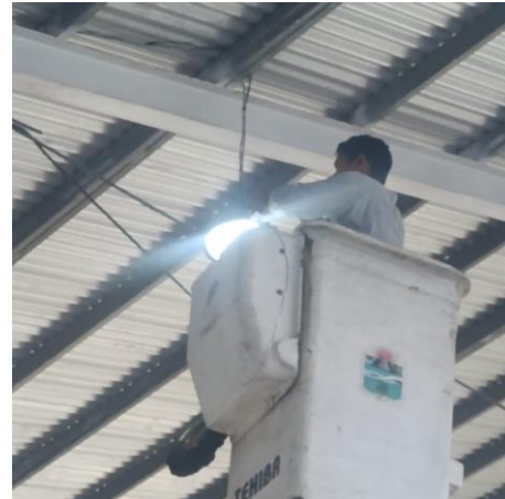
CAMBIO DE REFLECTORES OBSOLETOS POR NUEVOS; CENTRO DE ESTUDIOS TRILINGUE IN NAJIL XOOK TULUM.
