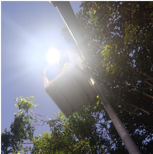
REPOSICIÓN DE LUMINARIA Y RECONEXIÓN DE LINEA SULFATADA; FRACC. ALDEA ZAMA.
