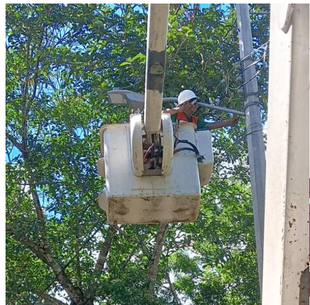
CAMBIO DE LUMINARIAS OBSOLETAS POR LED NUEVAS; POBLADO MACARIO GOMEZ.
