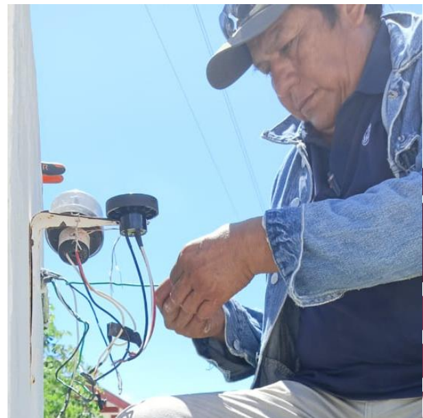
CAMBIO DE BASE DE FOTOCELDA OBSOLETA POR NUEVA; COL. MARITES.
