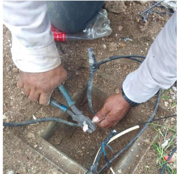
RECONEXIÓN DE LINEAS SUBTERRANEAS PARA HABILITAR LUMINARIAS; C. 27 ENTRE AV. YODZONOT Y CALLE 12, COL. TUMBEN-KAA.
