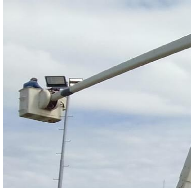
REPARACIÓN DE REFLECTOR; UNIDAD DEPORTIVA, COL. CENTRO.
