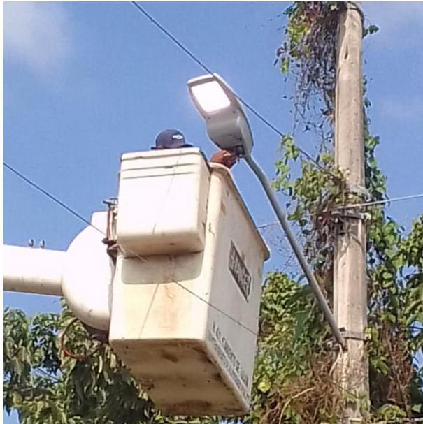
CAMBIO DE LUMINARIA OBSOLETA POR LED NUEVA; C. 27 ENTRE AV. YODZONOT Y CALLE 12, COL. TUMBEN-
