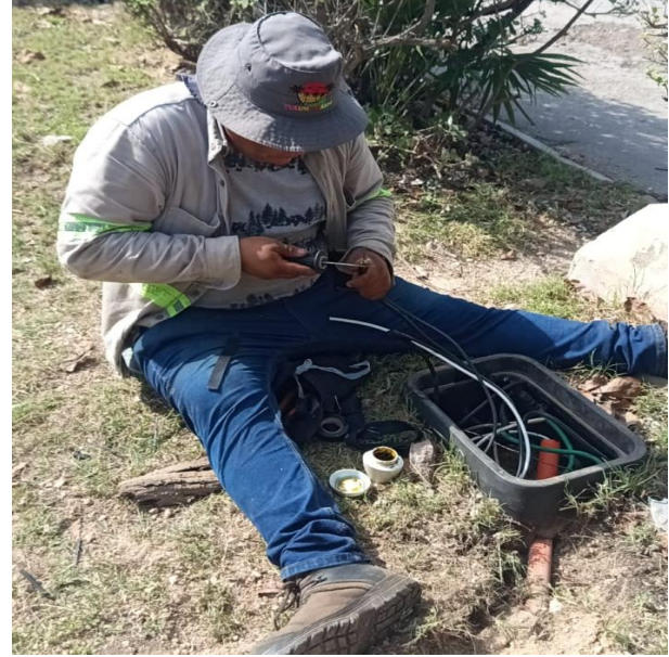
CAMBIO DE LINEAS SUBTERRANEAS QUEMADAS POR NUEVAS; UNIDAD DEPORTIVA, COL. CENTRO.
