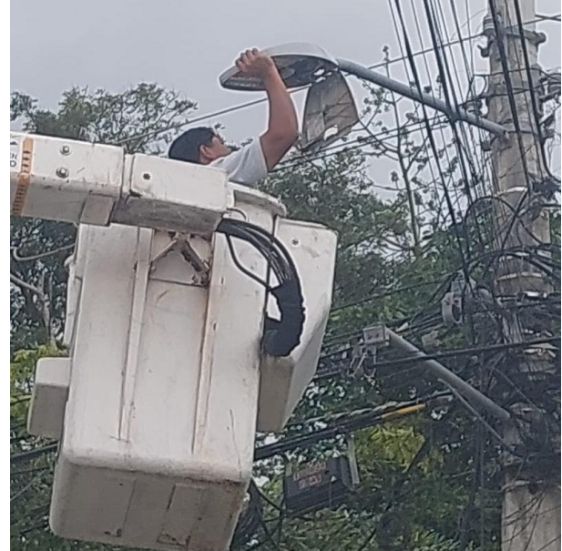
CAMBIO DE LINEAS Y BRAZO A LUMINARIA; C. 7 SUR ENTRE C. 12 SUR, COL. LA VELETA.
