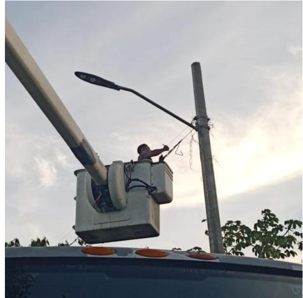
REPARACIÓN DE LUMINARIA CAMBIANDO LINEA DEL BRAZO; CALLE 4 ENTRE CALLE 2 NTE, COL. CRISTAL.
