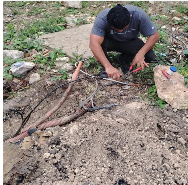
REHABILITACIÓN DE LINEAS SUBTERRANEAS EN CORTO CIRCUITO; CALLE 24 ENTRE AV. YODZONOT, COL. TUMBEN-KAA.
