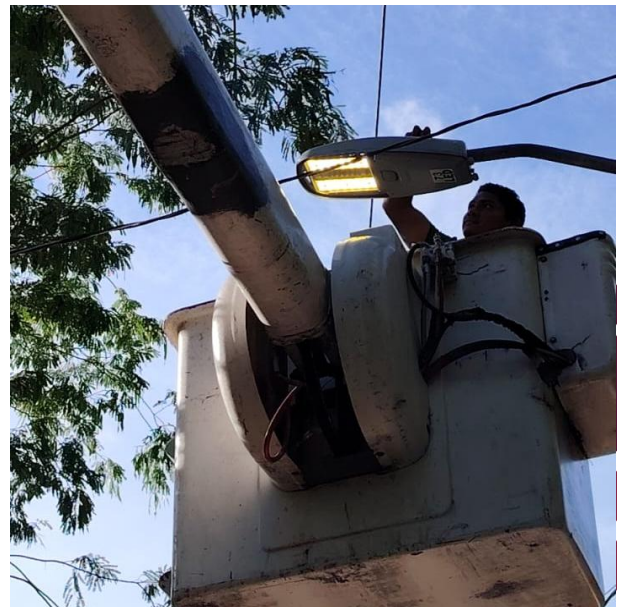
CAMBIO DE FOTOCELDA Y RECONEXIÓN DE LINEA AEREA A UNA LUMINARIA; CALLE 4 SUR ENTRE CALLE 7 SUR, COL. LA VELETA.
