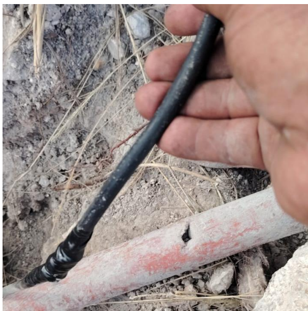
RECONEXIÓN DE LINEAS SUBTERRANEAS REVENTADAS POR MAQUINARIA; CALLE 2 NTE ENTRE CALLE GLADIOLAS, FRACC. YA'AX TULUM.
