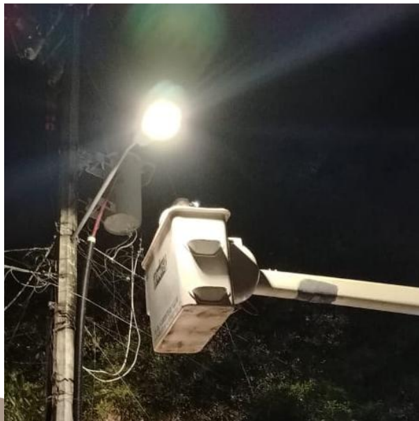
RECONEXIÓN DE LUMINARIA Y CAMBIO DE FOTOCELDA; CALLE POLAR OTE, COL. CENTRO.
