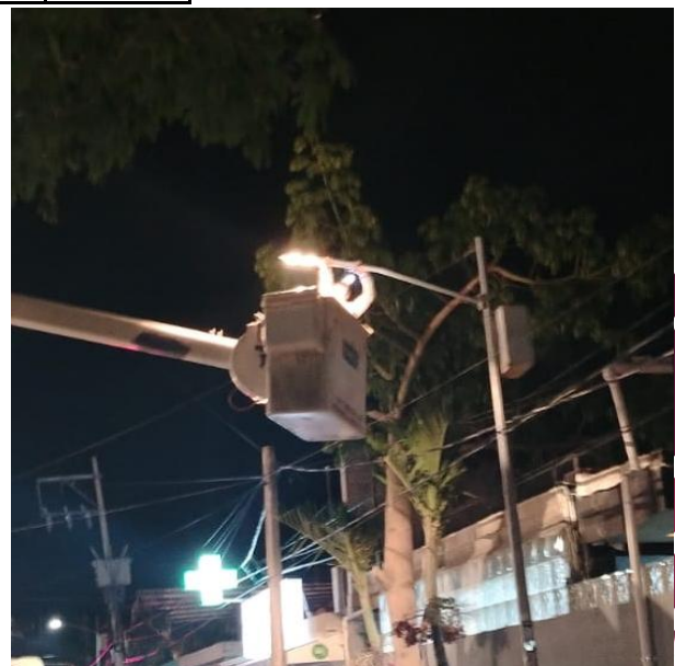
CAMBIO DE BASE Y FOTOCELDA PARA HABILITAR LUMINARIAS; CALLE ANDROMEDA ENTRE CALLE BETA SUR, COL. CENTRO.
