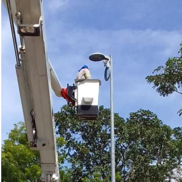
REPARACIÓN DE LUMINARIAS; MANZANA 13, FRACC. ALDEA ZAMA.
