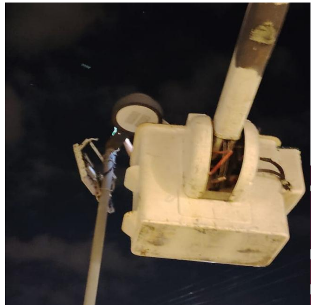
CAMBIO DE LINEAS Y RECONEXIÓN A LUMINARIAS; AV. OSIRIS SUR ENTRE CALLE SOL OTE, COL. CENTRO.
