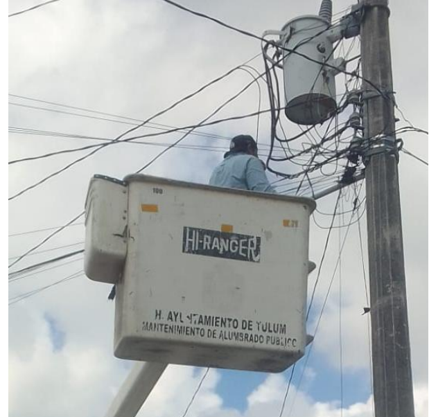
CAMBIO DE FOTOCELDAS PARA HABILITAR LUMINARIAS; CALLE ACUARIO NTE ENTRE CALLE 2 PTE, COL. CENTRO.
