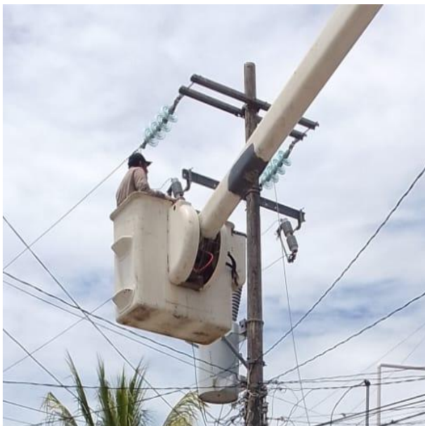
CAMBIO DE FOTOCELDA A LUMINARIAS; COL. LA-K'IIIN.
