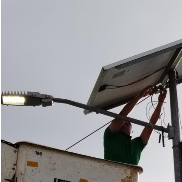
CAMBIO DE FOTOCELDA A LUMINARIA PARA HABILITARLA; CALLE SOL OTE ENTRE AV. SATÉLITE SUR, COL. CENTRO
