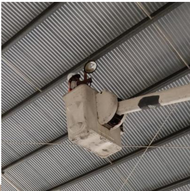
CAMBIO DE LUMINARIAS FLAT; DOMO LADO SUR, POBLADO COBA.
