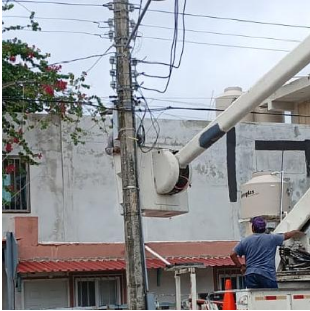
RECONEXIÓN DE LINEAS POR CORTO CIRCUITO PARA HABILITAR SECTOR; FRACC. HURACANES.
