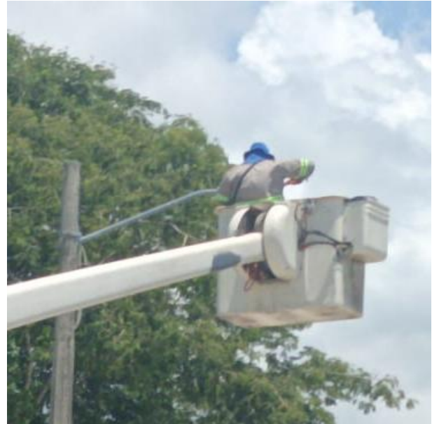
CAMBIO DE FOTOCELDAS A LUMINARIAS LED; FRACC. PALMAS.
