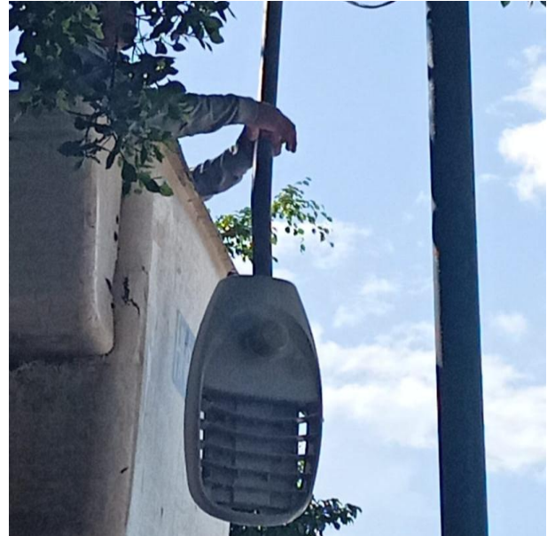
REPOSICIÓN DE LUMINARIA CON BRAZO; CANCHA MAYA.
