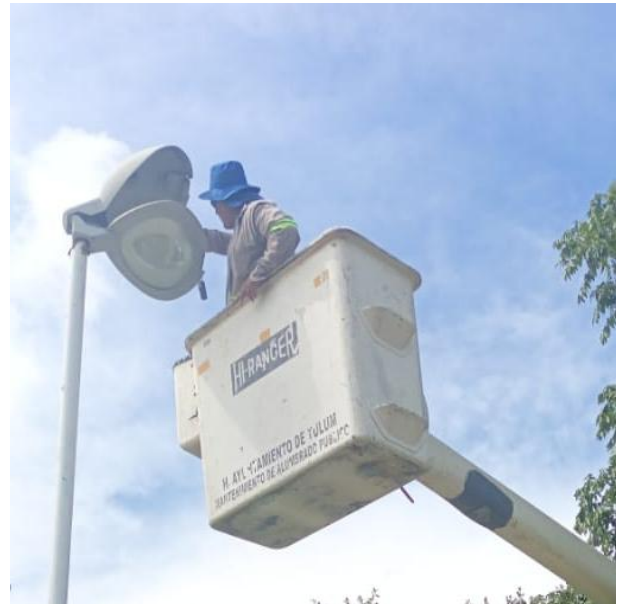
RECONEXIÓN DE LINEAS SUBTERRANEAS Y REPARACIÓN DE LUMINARIAS; BIBLIOTECAJACINTO PAT, COL. CENTRO.
