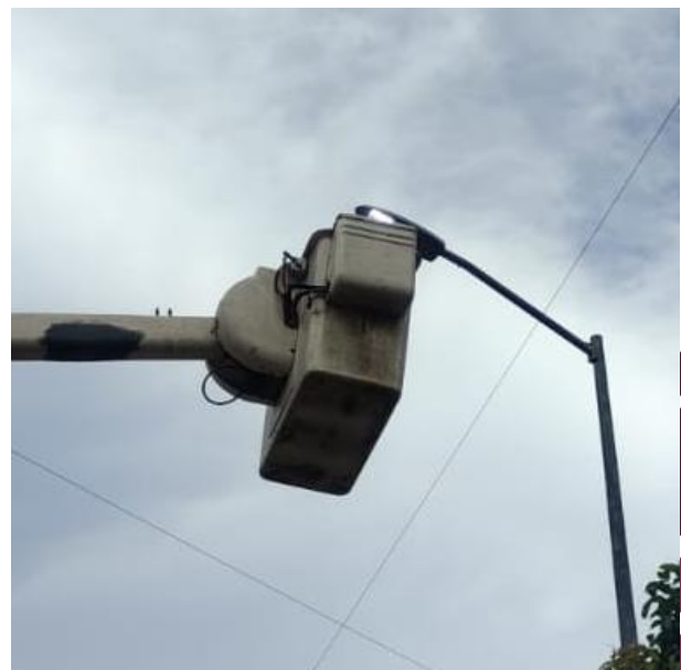
REPARACIÓN DE LUMINARIAS LED; FRACC. YA'AX TULUM.
