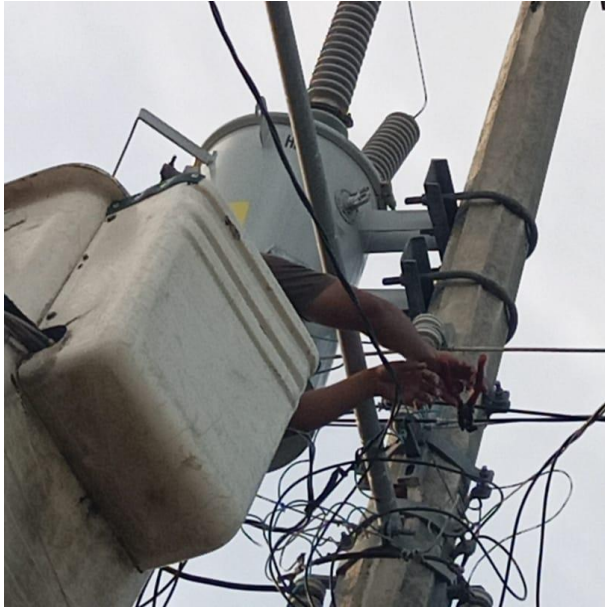
RECONEXIÓN DE LINEAS SULFATADAS; CALLE 4 ENTRE CALLE 2 NTE, COL. CRISTAL.
