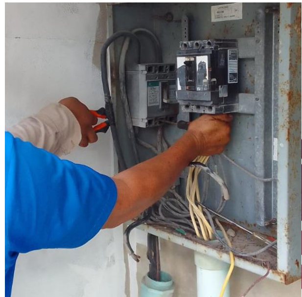
RECONEXIÓN DE ACOMETIDA EN EL CENTRO DE CARGA; UNIDAD DEPORTIVA, COL. CENTRO.
