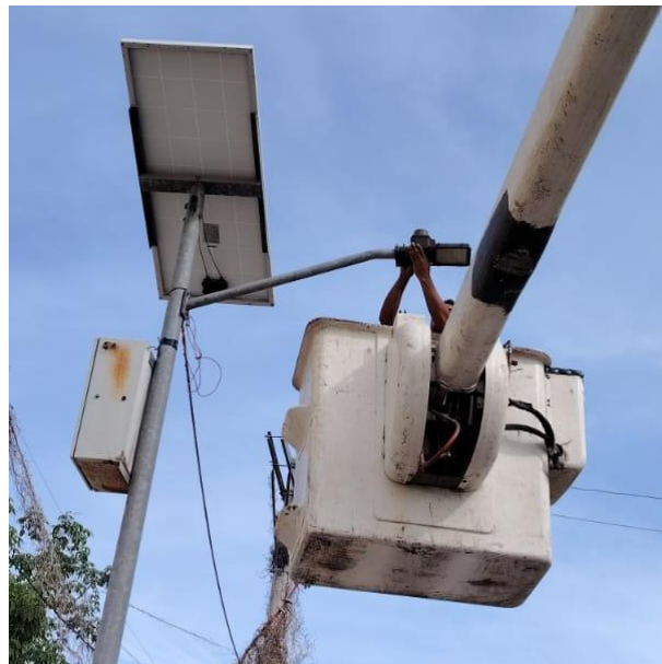
CAMBIO DE LUMINARIA OBSOLETA POR LED NUEVA; CALLE OSIRIS NTE ENTRE CALLE OK-K'OOT, COL. MAYAPAX.
