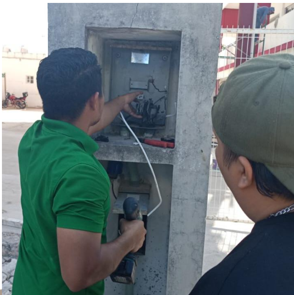
CAMBIO DE BASE DE MEDIDOR OBSOLETO POR NUEVO; CALLE CHACMOOL ENTRE CALLE CHA'AB, COL. XUL-KAA.
