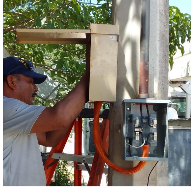
CAMBIO DE CENTRO DE CARGA OBSOLETO POR NUEVO; AV. KUKULKAN ENTRE CALLE GODORNIZ, COL. EJIDO.
