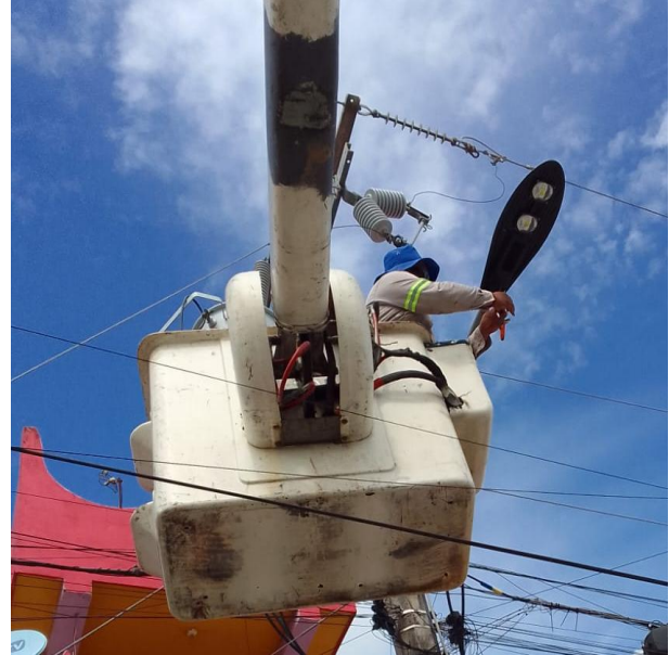
REPARACIÓN DE LAMPARA APAGADA; CALLE 24 ENTRE CALLE 19, COL. TUMBEN-KAA.
