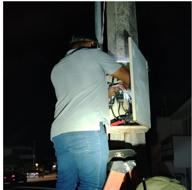
RECONEXIÓN DE ACOMETIDA EN EL CENTRO DE CARGA; AV. TULUM ENTRE CALLE LIBRA NTE, COL. CENTRO.
