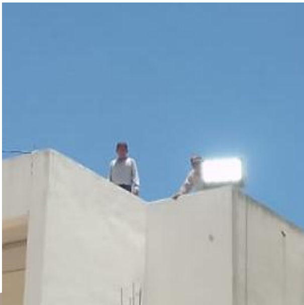
CAMBIO DE FOTOCELDA A REFLECTOR LED PARA HABILITARLA; CALLE FAISAN ENTRE AV. 18, COL. TUMBEN-KAA.
