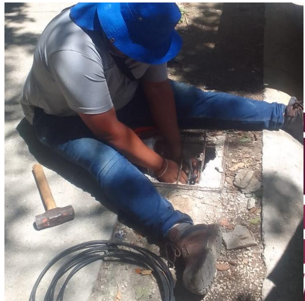
RECONEXIÓN DE LINEA SUBTERRANEA; CALLE KABAH, FRACC. ALDEA ZAMA.
