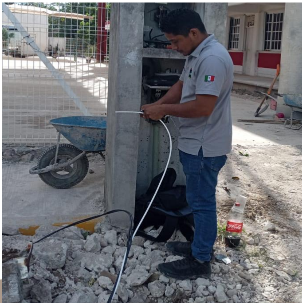
CAMBIO DE LINEAS SUBTERRANEAS DEL REGISTRO AL CENTRO DE CARGA PARA REHABILITAR SECTOR APAGADO; CALLE CHA'AB ENTRE CALLE KITAM, COL. XUL-KAA.
