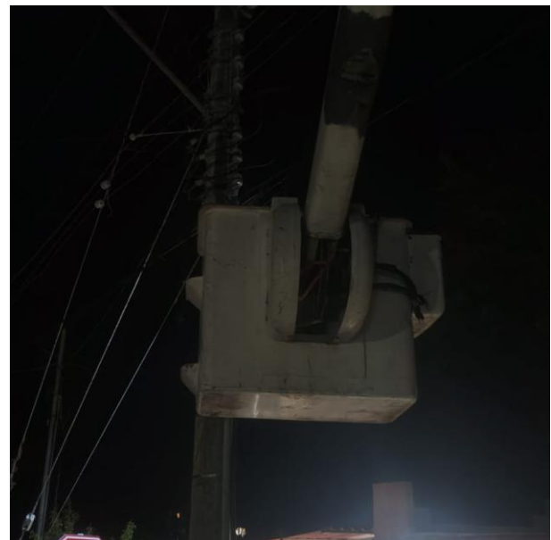
CAMBIO DE FOTOCELDA A SECTOR PARA HABILITARLO; CALLE LIBRA SUR ENTRE CALLE SOL OTE.
