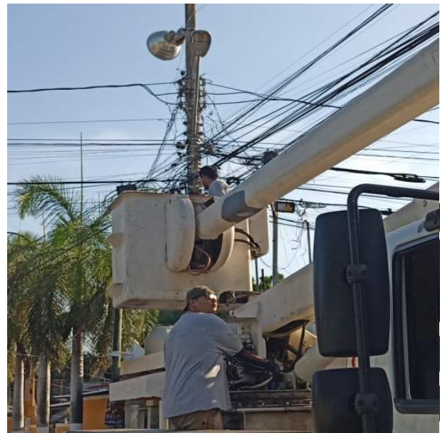
RECONEXIÓN DE LUMINARIAS PARA RESTABLECERLAS; CALLE MERCURIO OTE, COL. CENTRO.
