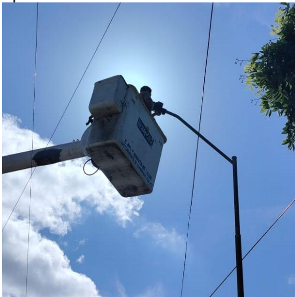
CAMBIO DE FOTOCELDA Y RECONEXIÓN DE LINEAS PARA HABILITAR LUMINARIA; CALLE POLAR PTE, COL.
