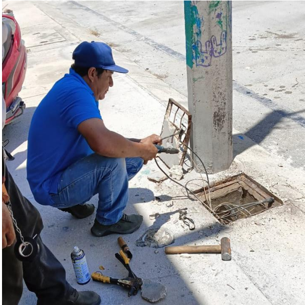
RECONEXIÓN DE LÍNEAS DAÑADAS PARA HABILITAR LUMINARIAS; FRACC. PALMAS.
