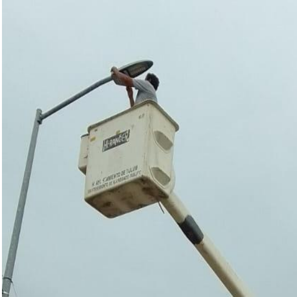
CAMBIO DE LINEAS DEL REGISTRO AL POSTE; CALLE LIRIO ENTRE CALLE MARGARITA, COL. YA'AX TULUM.
