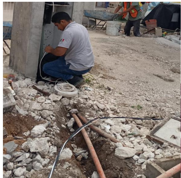
CAMBIO DE LINEAS SUBTERRANEAS DEL REGISTRO AL CENTRO DE CARGA PARA REHABILITAR SECTOR APAGADO; CALLE CHA'AB ENTRE CALLE KITAM, COL. XUL-KAA.
