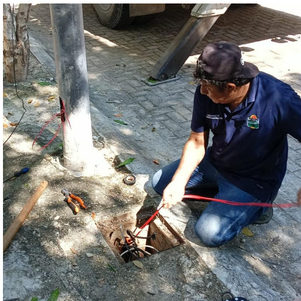
INSTALACIÓN DE LINEAS EN POSTE PARA HABILITAR LUMINARIAS; FRACC. ALDEA ZAMA.
