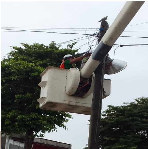
REPARACIÓN DE REFLECTOR; POBLADO CHEMUYIL.
