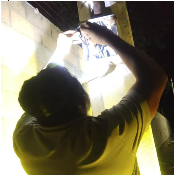
RECONEXIÓN DE ACOMETIDA EN EL CENTRO DE CARGA; AV. 1 ENTRE CALLE RIO ROSARIO, COL. TUMBEN-KAA.
