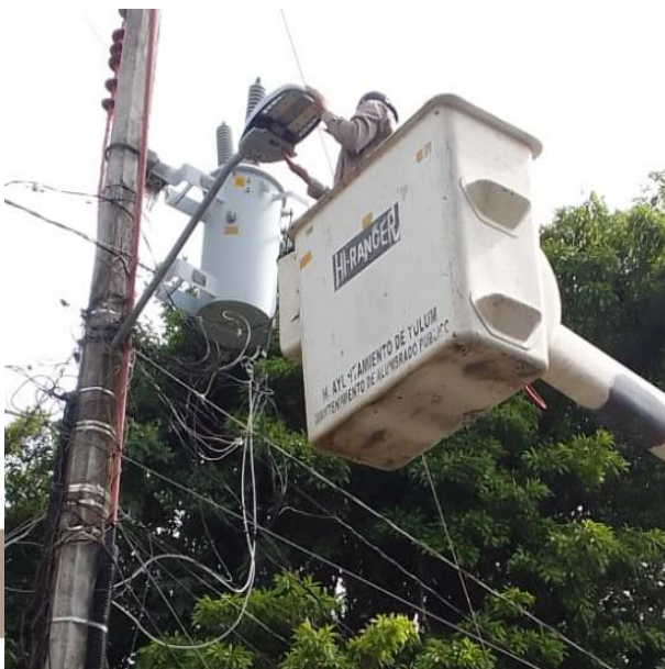
CAMBIO DE FOTOCELDA Y RECONEXIÓN DE LINEAS PARA HABILITAR LUMINARIA; CALLE CHAN-CHEN, COL. EJIDO.
