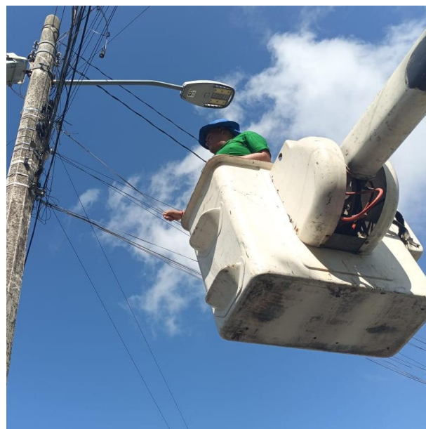
REPARACIÓN DE LAMPARA LED RECONECTANDO LINEAS Y CAMBIANDO BASE DE FOTOCELDA POR NUEVA; CALLE ONTARIO, COL. CENTRO.
