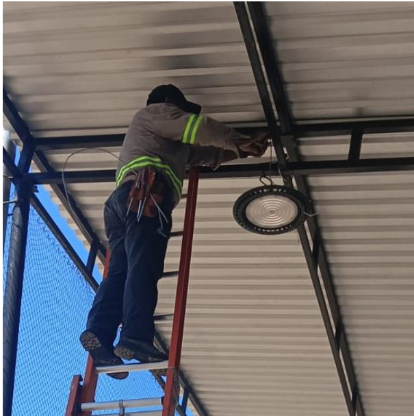
REPARACIÓN DE REFLECTOR FLAT; UNIDAD DEPORTIVA, COL. CENTRO.
