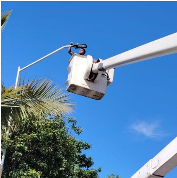
CAMBIO DE LUMINARIA OBSOLETA POR LED NUEVA; CALLE 17 ENTRE CALLE NAVAL, COL. TUMBEN-KAA.
