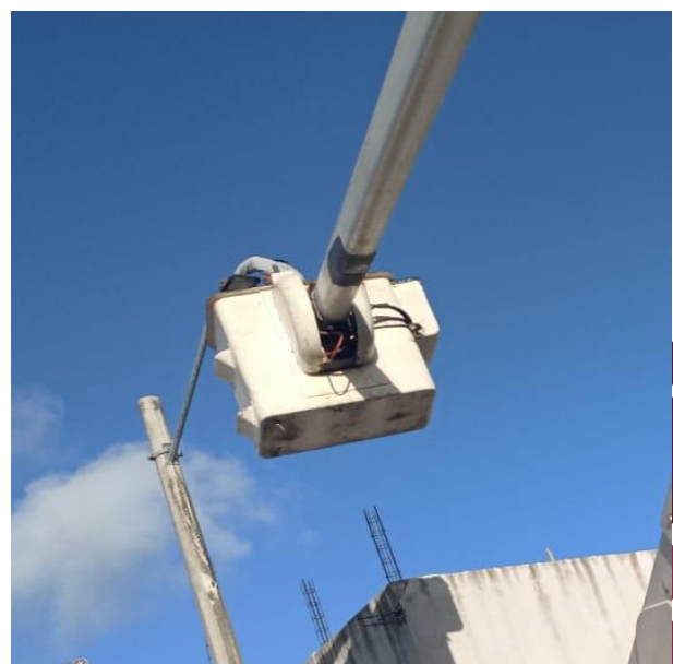
REPARACIÓN DE LUMINARIAS RECONECTANDO LINEAS SULFATADAS; CALLE GUINEA ENTRE CALLE PÁLMAS ABANICO, FRACC. PALMAS.
