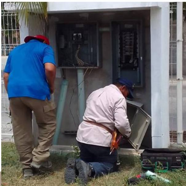
RECONEXIÓN DE ACOMETIDA EN EL CENTRO DE CARGA; UNIDAD DEPORTIVA, COL. CENTRO.
