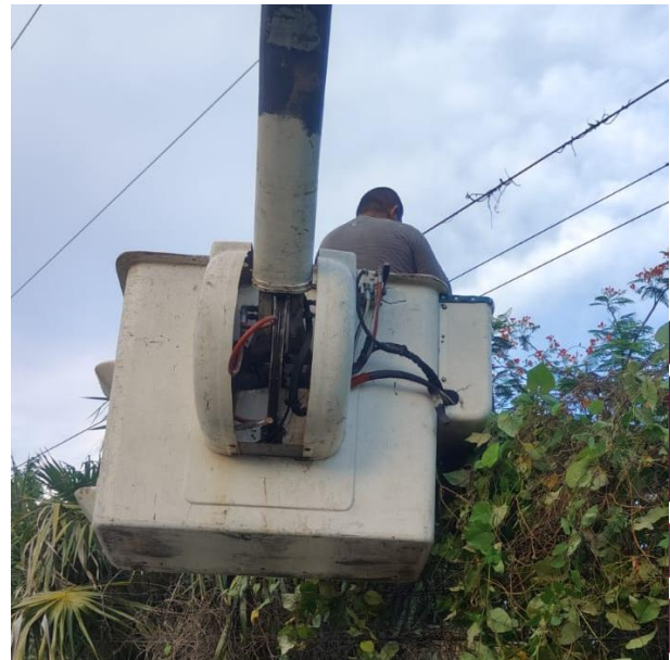
INSTALACIÓN DE SEPARADORES PARA CORREGIR CORTO CIRCUITO; CALLE GAVILANES ENTRE CALLE SIAN-KAAN, COL. EJIDO NTE.
