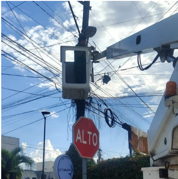
CAMBIO DE FOTOCELDA QUEMADA POR NUEVA; CALLE BETA NTE, COL. CENTRO.
