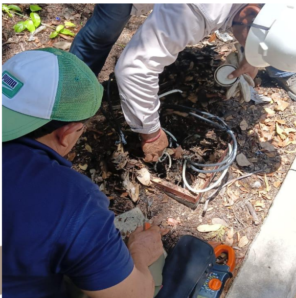
RECONEXIÓN DE LINEA SUBTERRANEA; CALLE KABAH, FRACC. ALDEA ZAMA.
