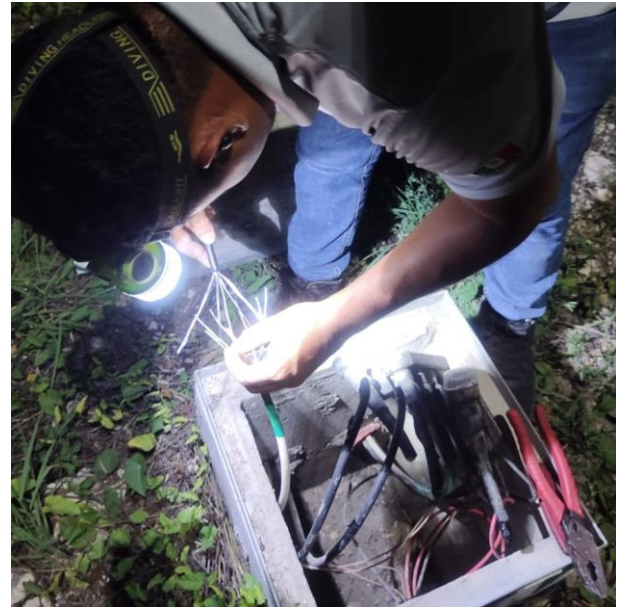
RECONEXIÓN DE LINEAS PARA HABILITAR LUMINARIAS; AV. LA SELVA ENTRE CALLE TEPEZCUINTLE, COL. TUMBEN-KAA.
