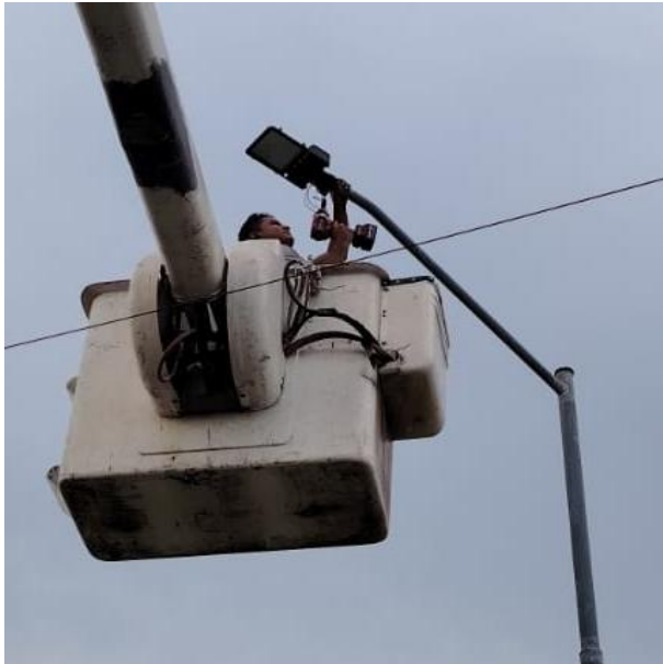
CAMBIO DE LUMINARIAS OBSOLETAS POR LED NUEVAS; CALLE 24 ENTRE CALLE 17, COL. TUMBEN-KAA.
