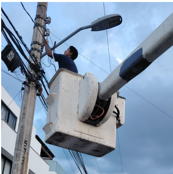
CAMBIO DE LINEAS POR CORTO CIRCUITO; CALLE TUN-KUL ENTRE CALLE CENTAURO NTE Y ORIÓN NTE, COL. MAYAPAX.
