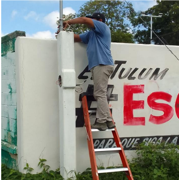
RECONEXIÓN DE ACOMETIDA; CALLE ACUARIO NTE ENTRE CALLE 2 PTE, COL. CENTRO.
