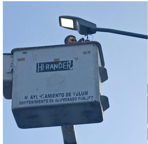
CAMBIO DE BASE DE FOTOCELDA Y FOTOCELDA OBSOLETA POR NUEVA; CALLE 2 NTE ENTRE AV. 20 NTE, FRACC. YA'AX TULUM.
