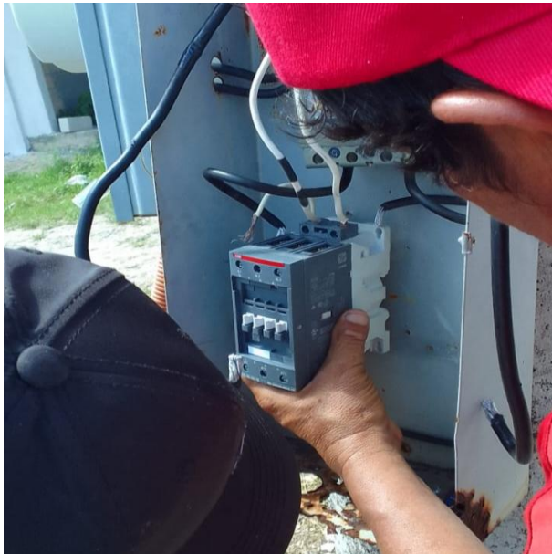
CAMBIO DE CONTACTOR QUEMADO POR NUEVO; LADO SUR, POBLADO COBA.
