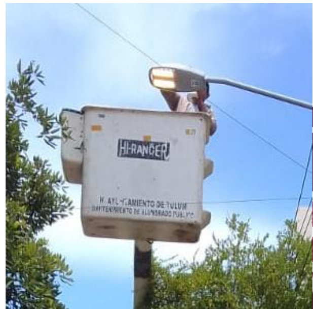
CAMBIO DE FOTOCELDA Y RECONEXIÓN DE LINEAS PARA HABILITAR LUMINARIA; AV. OSIRIS SUR, COL. CENTRO.
