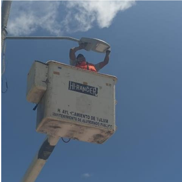
CAMBIO DE LUMINARIA OBSOLETA POR NUEVA; CALLE PALMAS CHAT, FRACC. PALMAS.
