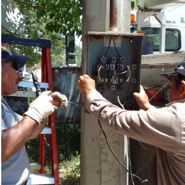
CAMBIO DE BASE DE MEDIDOR OBSOLETO POR NUEVO; AV. KUKULKAN ENTRE CALLE GODORNIZ, COL. EJIDO.
