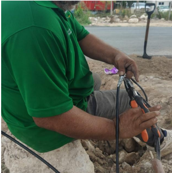
RECONEXIÓN DE LINEAS SUBTERRANEAS PARA HABILITAR LUMINARIAS; CALLE 2 NTE ENTRE CALLE GLADIOLAS, FRACC. YA'AX TULUM.
