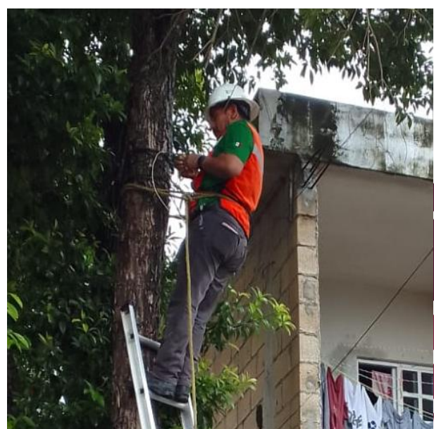
RECONEXIÓN DE LINEAS AEREAS PARA HABILITAR LUMINARIAS; POBLADO CHEMUYIL.
