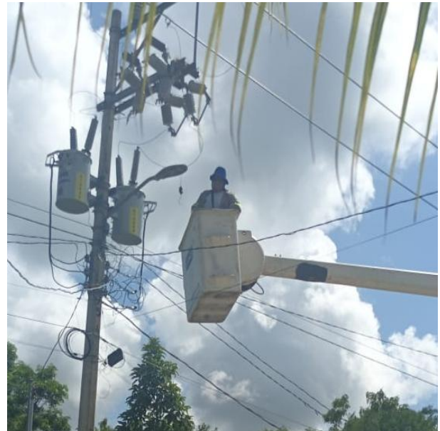
CAMBIO DE LUMINARIA OBSOLETA POR NUEVA; CALLE 20 ENTRE CALLE TEPEZCUINTLE, COL. TUMBEN-KAA.
