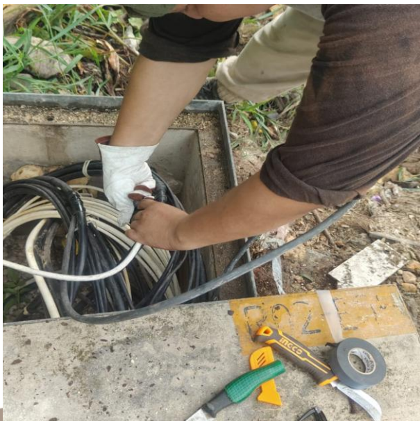
RECONEXIÓN DE LINEAS SUBTERRANEAS; FRACC. YA'AX TULUM.
