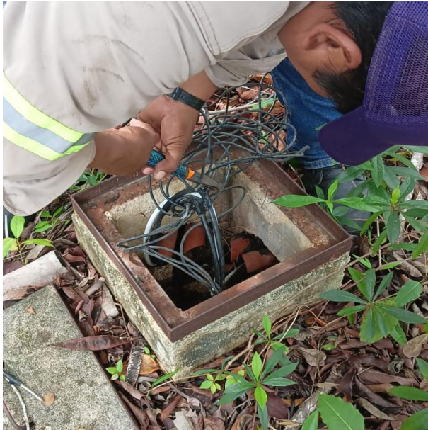
REPARACIÓN DE LINEAS SUBTERRANEAS REVENTADAS; FRACC. ALDEA ZAMA.
