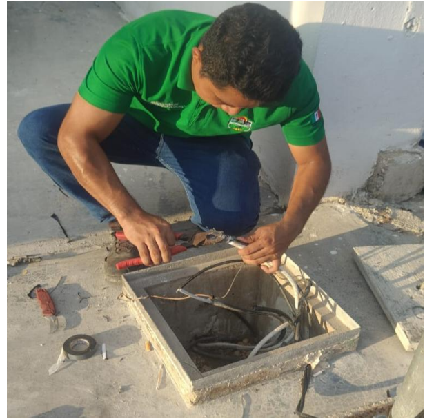
RECONEXIÓN DE LINEAS SUBTERRANEAS PARA HABILITAR LUMINARIAS; CALLE 13 ENTRE CALLE 24, COL. TUMBEN-KAA.
