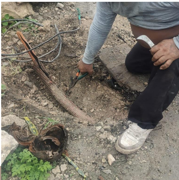
REPARACIÓN DE LINEAS REVENTADAS POR MAQUINARIA PARA HABILITAR SECTOR; CALLE GLADIOLAS ENTRE CALLE BUGAMBILIA, FRACC. YA'AX. TULUM.
