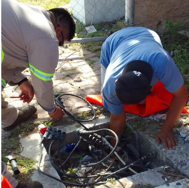
RECONEXIÓN DE LINEAS SUBTERRANEAS Y REPARACIÓN DE LUMINARIAS; BIBLIOTECAJACINTO PAT, COL. CENTRO.
