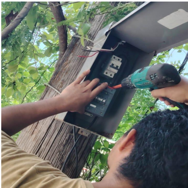
CAMBIO DE CONTACTOR QUEMADO POR NUEVO; AV. TULUM, COL. CENTRO.
