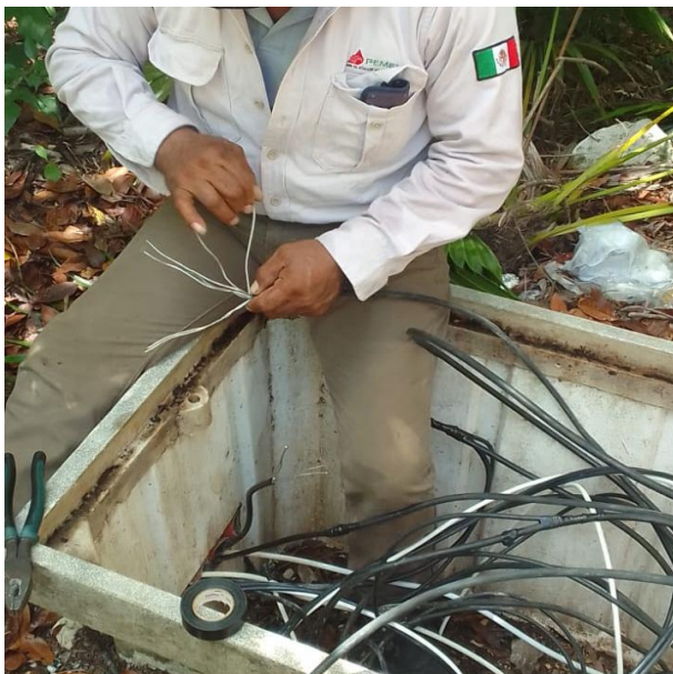
REPARACIÓN DE LUMINARIAS LED; POBLADO CHEMUYIL.
