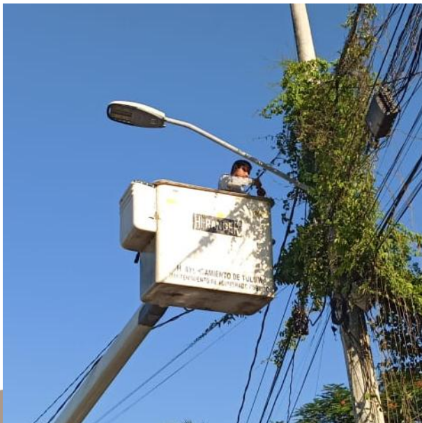
REPARACIÓN DE LUMINARIAS RECONECTANDO LINEAS; CALLE MERCURIO OTE, COL. CENTRO.
