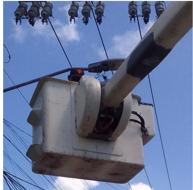
CAMBIO DE FOTOCELDAS A LUMINARIAS; CALLE PALENQUE ENTRE CALLE 11 SUR, COL. LA VELETA.
