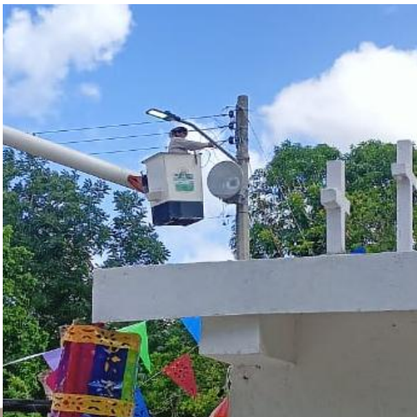
CAMBIO DE FOTOCELDAS OBSOLETAS A LUMINARIAS LED; POBLADO HONDZONOT.
