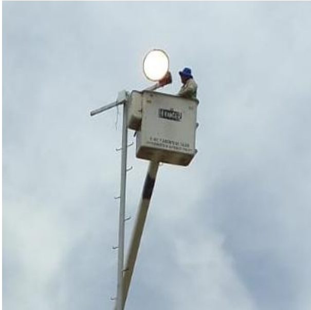
REPARACIÓN DE REFLECTORES; UNIDAD DEPORTIVA, COL. CENTRO.
