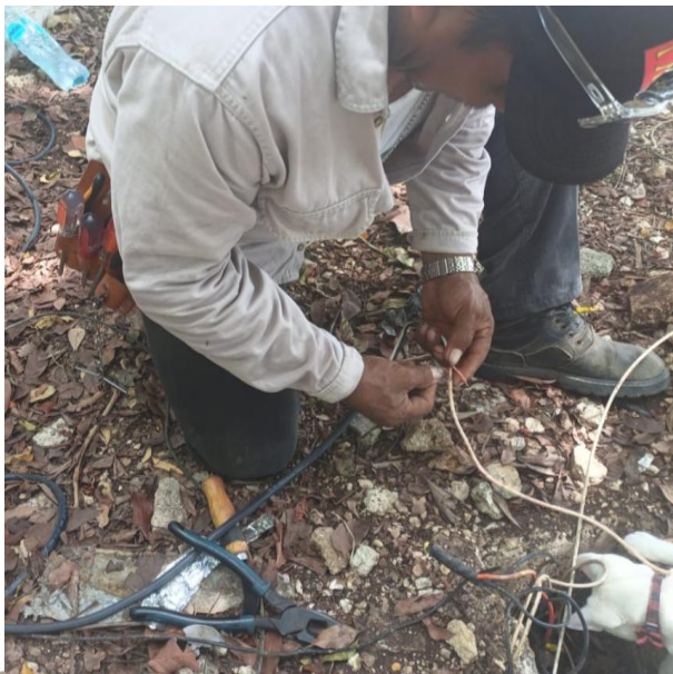
RECONEXIÓN DE LÍNEAS DAÑADAS PARA HABILITAR LUMINARIAS; FRACC. PALMAS.
