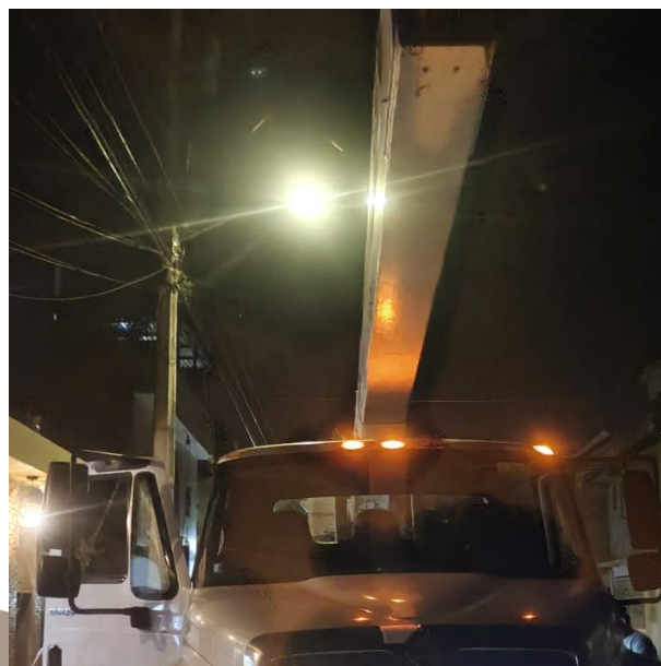
REPARACIÓN DE LUMINARIA LED; CALLE 17 ENTRE CALLE 20, COL. TUMBEN-KAA.
