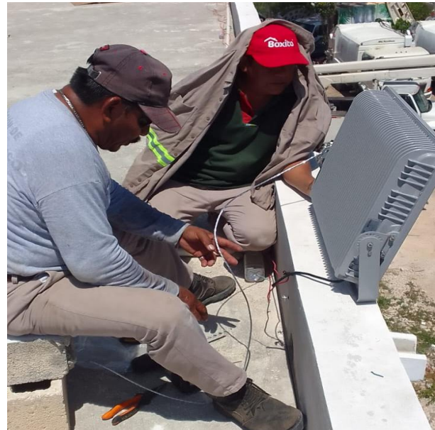
INSTALACIÓN DE REFLECTORES LED; AV. 18, COL. TUMBEN-KAA.
