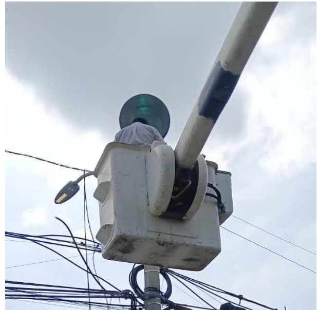
RECONEXIÓN DE LUMINARIAS; UNIDAD DEPORTIVA, COL. CENTRO.
