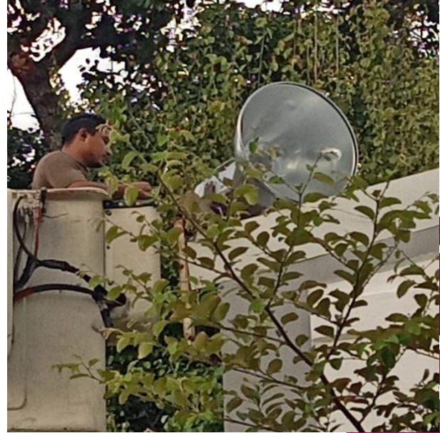
REPARACIÓN DE REFLECTOR LED; UNIDAD DEPORTIVA, COL. CENTRO.
