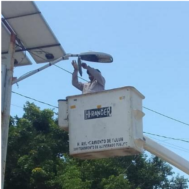
REPARACIÓN DE LAMPARAS LED; CALLE PALENQUE ENTRE CALLE 11 SUR, COL. LA VELETA.
