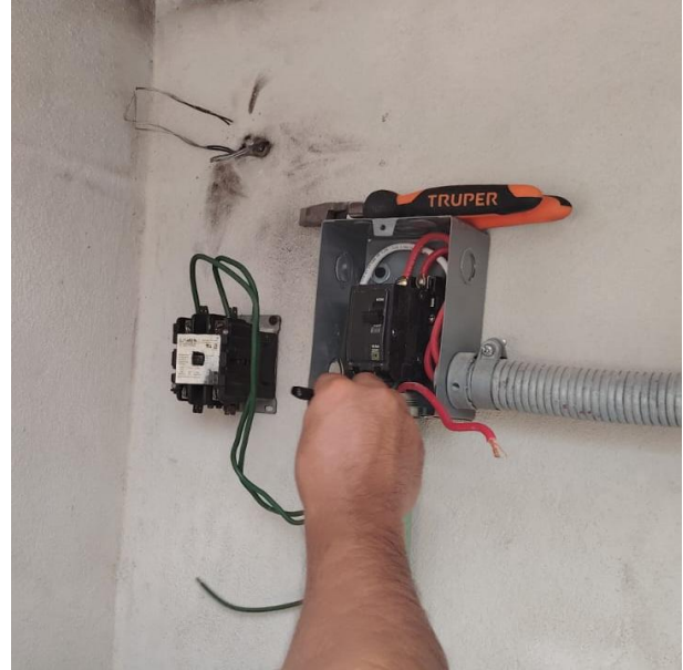
CAMBIO DE CONTACTOR QUEMADO POR NUEVO; CALLE ALCATRAZ ENTRE CALLE AZUCENA, FRACC. YA'AX TULUM.
