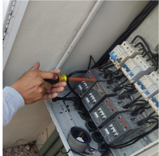
RECONEXIÓN DE LINEAS; FRACC. ALDEA TULUM.
