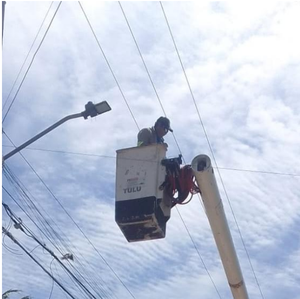
RECONEXIÓN DE LINEAS AEREAS; CALLE SOL OTE ENTRE CALLE OMEGA SUR, COL. CENTRO.
