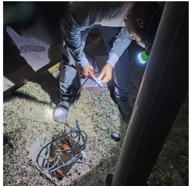
RECONEXIÓN DE LÍNEAS PARA HABILITAR LUMINARIA; AV. TULUM.
