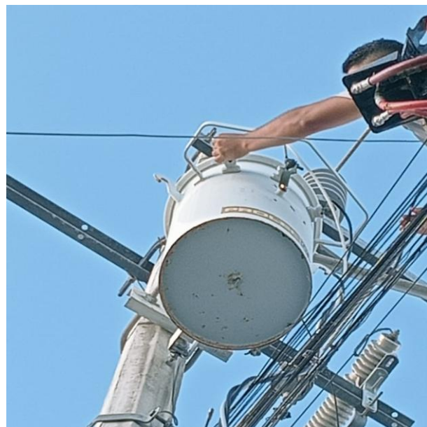
AJUSTE DE BUSH DE TRANSFORMADOR; AV. 18 ENTRE AV. 19 Y AV. 2, COL. TUMBEN-KAA.
