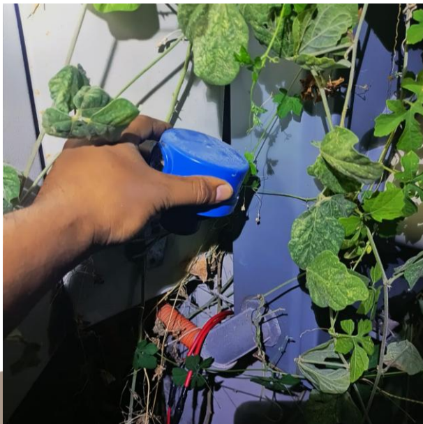
CAMBIO DE FOTOCELDA OBSOLETA PARA HABILITAR SECTOR; AV. KUKULKAN, COL.
