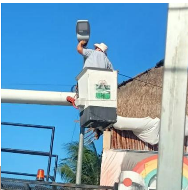
CAMBIO DE LAMPARAS OBSOLETAS POR LED NUEVAS; CALLE OMEGA NTE ENTRE CALLE 4 PTE ENTRE CALLE 2 PTE, COL. CENTRO.
