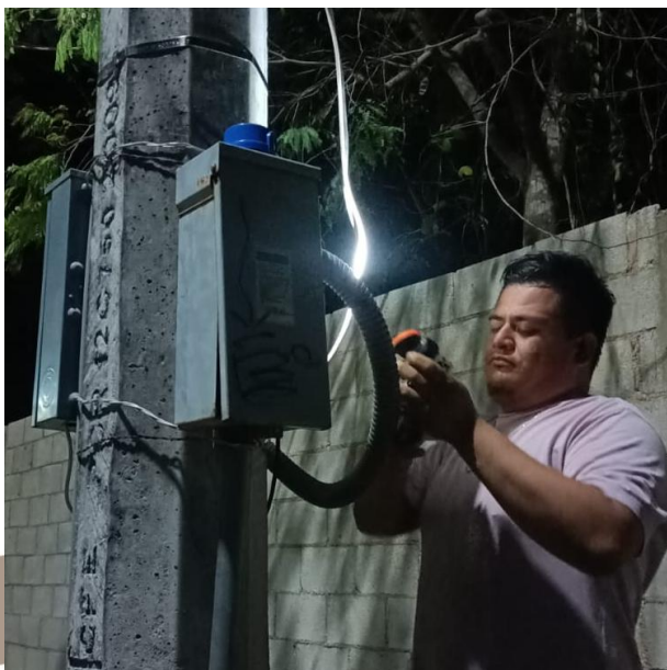
RECONEXIÓN DE ACOMETIDA EN EL CENTRO DE CARGA; CALLE 24 ENTRE AV.1 Y AV. 2, COL. TUMBEN KAA.
