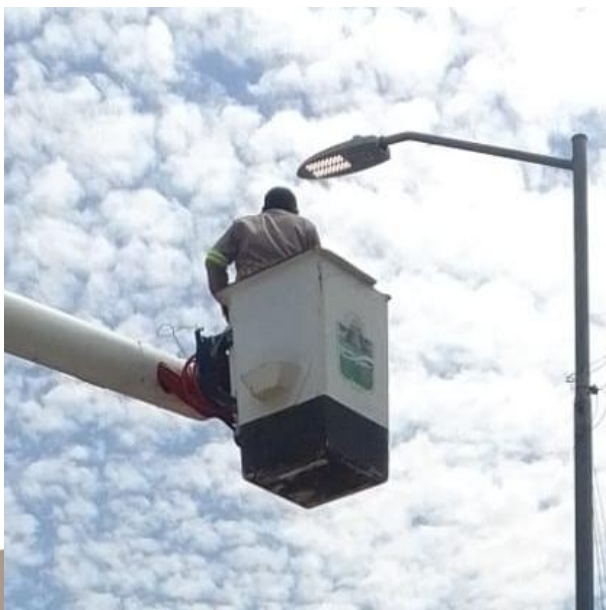
CAMBIO DE FOTOCELDA A LUMINARIA; CALLE 17, COL. TUMBEN-KAA.
