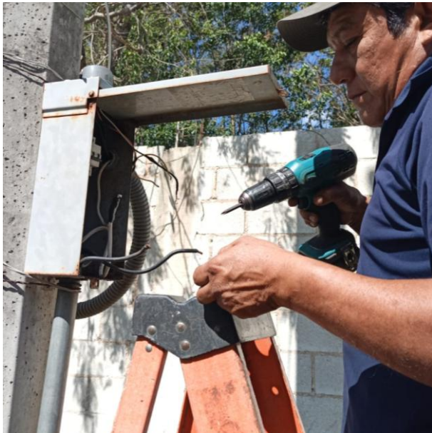
CAMBIO DE CONTACTOR QUEMADO POR NUEVO EN EL CENTRO DE CARGA; CALLE 24 ENTRE AV. 1 Y AV. 2, COL. TUMBEN-KAA.
