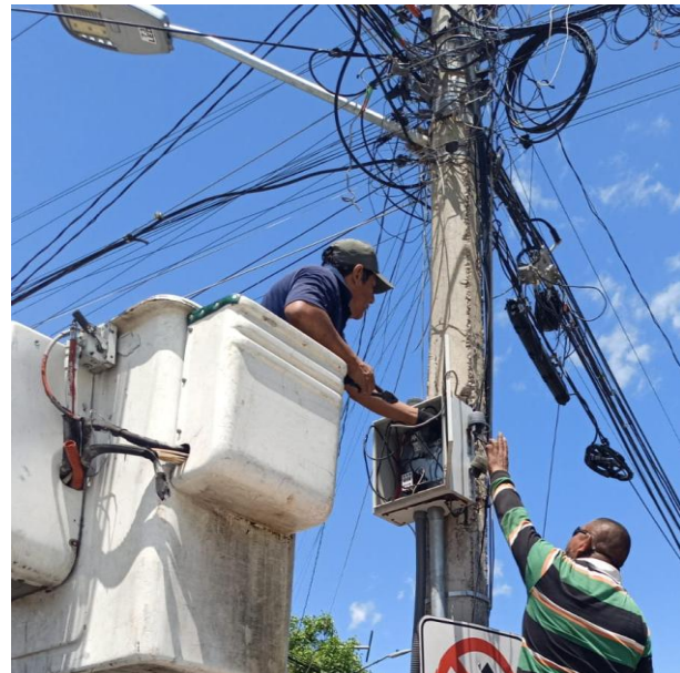
CAMBIO DE CONTACTOR QUEMADO POR NUEVO EN EL CENTRO DE CARGA; AV. OSIRIS SUR ENTRE CALLE ASTEROIDE Y AV. SATÉLITE, COL. CENTRO.
