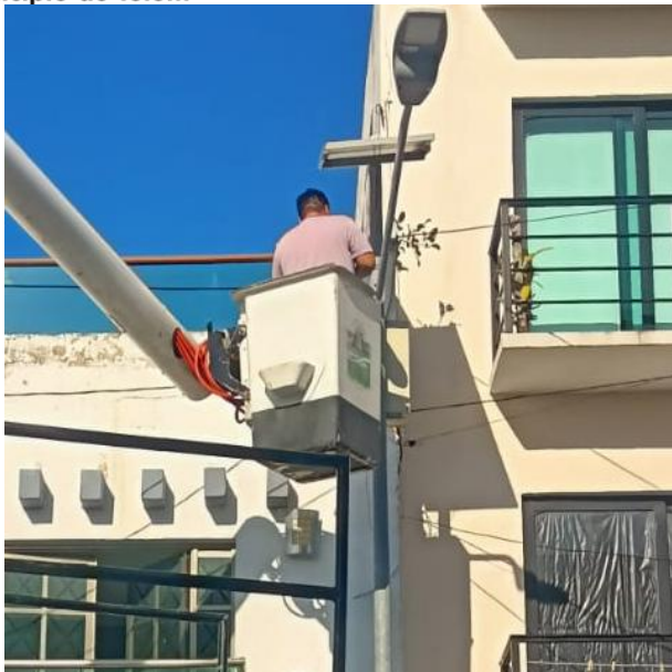
INSTALACIÓN DE BASE DE FOTOCELDA Y FOTOCELDA A LUMINARIA, CALLE CENTAURO ENTRE CALLE 2 Y CALLE SAGITARIO, COL. CENTRO.
