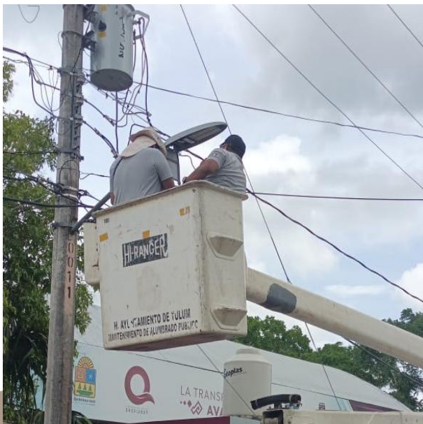
INSTALACIÓN DE LUMINARIA CON EQUIPO NUEVO; POBLADO COBA
