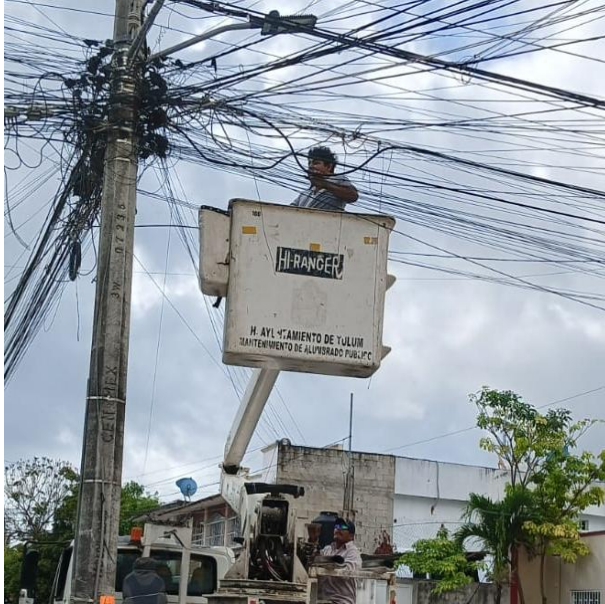
REPARACIÓN DE LUMINARIAS; CALLE 7 ENTRE CALLE 10 Y CALLE 12, COL. LA VELETA.
