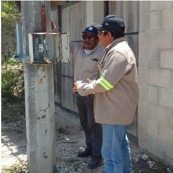
CAMBIO DE FOTOCELDA A LUMINARIA; AV. KUKULKAN ENTRE CALLE GABILANES, COL. EJIDO.
