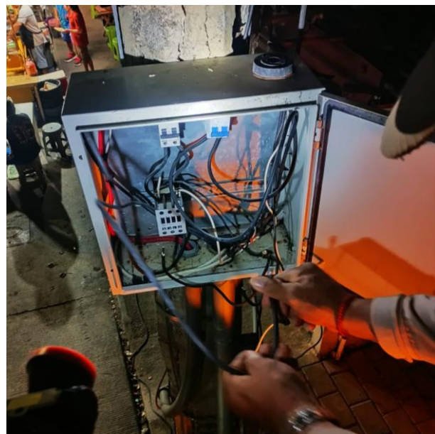
RECONEXIÓN DE ACOMETIDA; CALLE SOL OTE ENTRE AV. OSIRIS SUR Y CALLE BETA SUR, COL. CENTRO.
