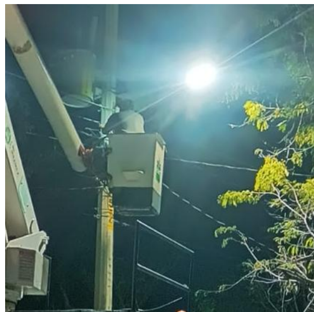
CAMBIO DE CONTACTOR QUEMADO POR NUEVO EN EL CENTRO DE CARGA; AV. OSIRIS SUR ENTRE CALLE ASTEROIDE Y AV. SATÉLITE, COL. CENTRO.
