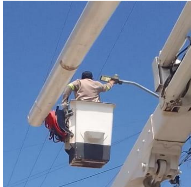
CAMBIO DE FOTOCELDA A LUMINARIA; CALLE SOL OTE ENTRE CALLE OMEGA SUR, COL. CENTRO.
