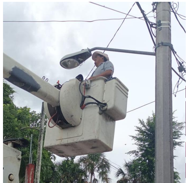
CAMBIO DE LUMINARIA QUEMADA POR LED NUEVA; POBLADO COBA
