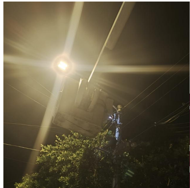
RECONEXIÓN DE LUMINARIA; CALLE TUN-KUL, COL. MAYA-PAX.
