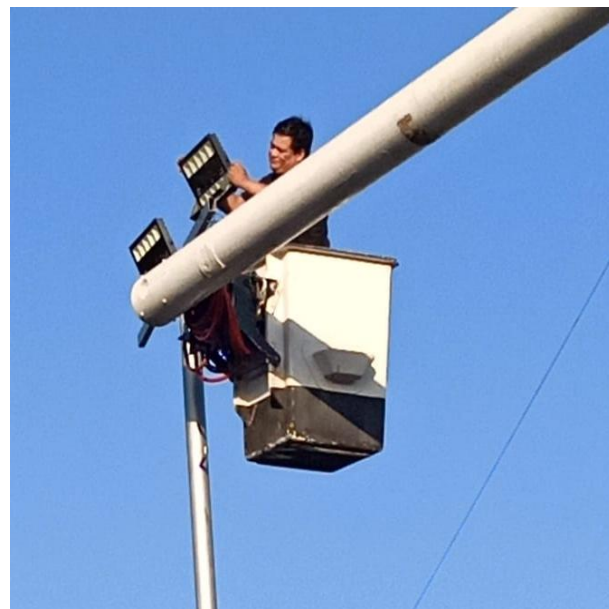
REPOSICION DE REFLECTOR LED; UNIDAD DEPORTIVA, COL. CENTRO.
