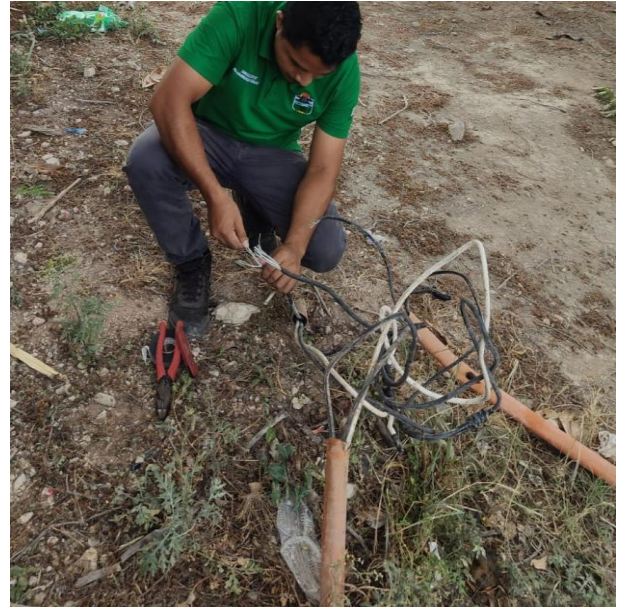
RECONEXIÓN DE LINEAS REVENTADAS PARA HABILITAR LUMINARIAS; CALLE CHA'AB ENTRE CALLE KITAM, COL. XUL- KAA.
