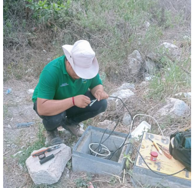
RECONEXIÓN DE LÍNEAS SUBTERRÁNEAS PARA HABILITAR LUMINARIAS; AV. 10 NTE, COL. MARITES.
