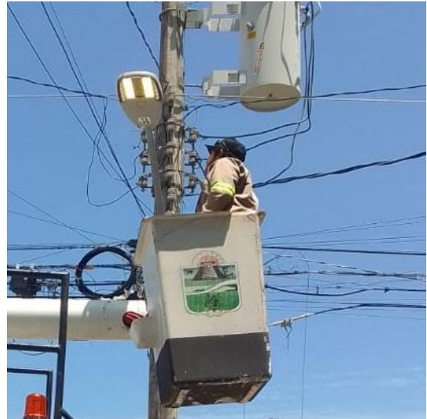
CAMBIO DE FOTOCELDA A LUMINARIA; CALLE CHAN-CHEN, COL. EJIDO.
