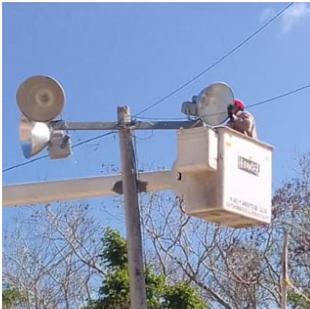
REHABILITACIÓN DE REFLECTORES LED; POBLADO YAXCHE.
