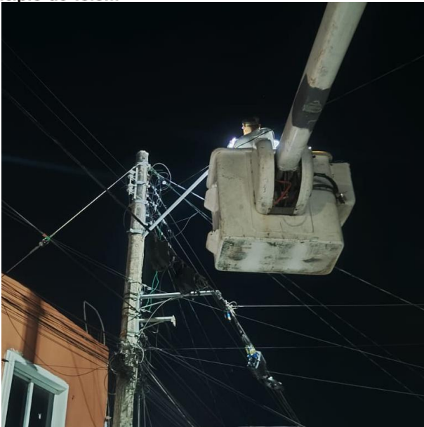
RECONEXIÓN DE LÍNEAS PARA HABILITAR LUMINARIA; COL. LA-K'IN.
