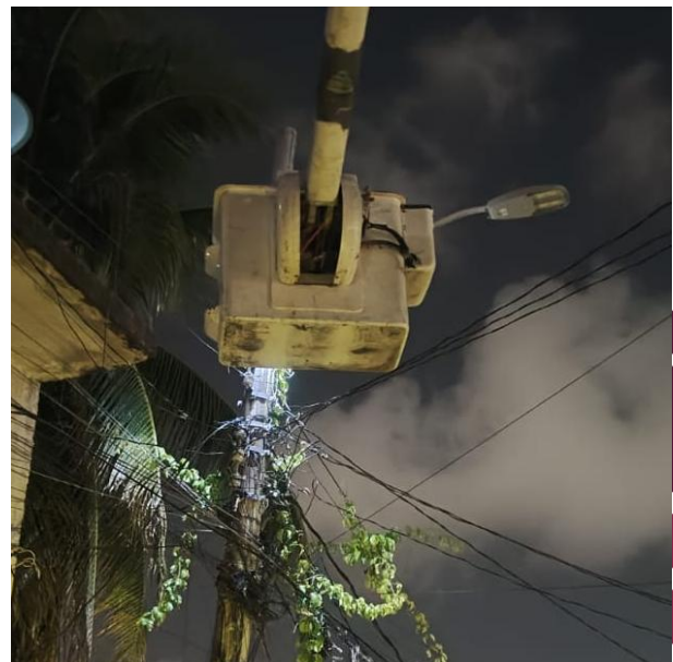
CAMBIO DE FOTOCELDA QUEMADA POR NUEVA; CALLE BUBUL-EK, COL. MAYA-PAX.
