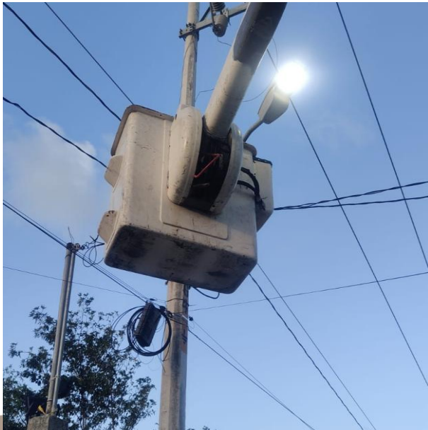
RECONEXIÓN DE LÍNEAS PARA HABILITAR LUMINARIA; COL. CRISTAL.
