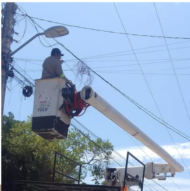
CAMBIO DE FOTOCELDA A LUMINARIA; CALLE COCODRILO ENTRE CALLE CHUN-YAXCHE, COL. EJIDO.
