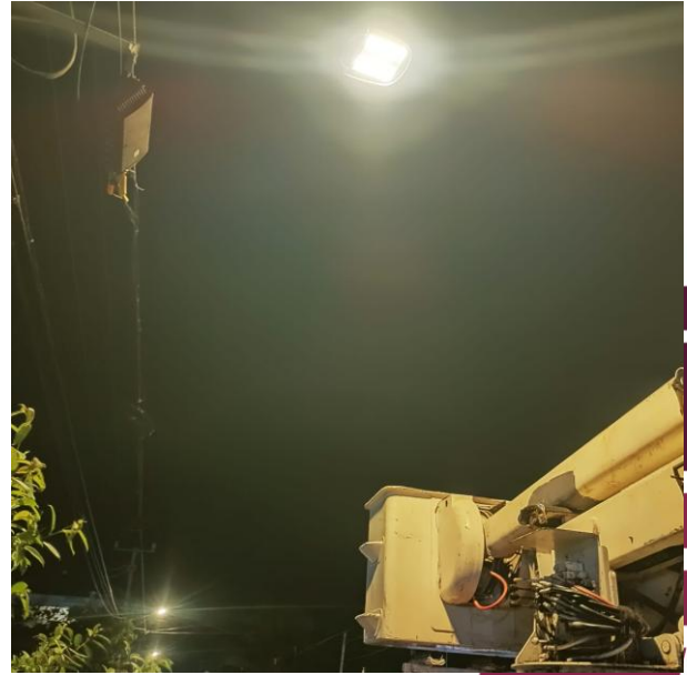
CAMBIO DE FOTOCELDA OBSOLETA PARA HABILITAR SECTOR; AV. KUKULKAN, COL.
