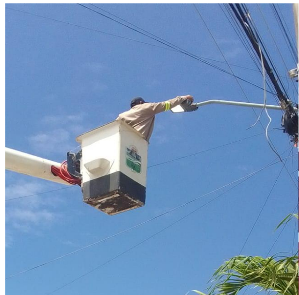
CAMBIO DE FOTOCELDA A LUMINARIA; CALLE 19, COL. TUMBEN-KAA.
