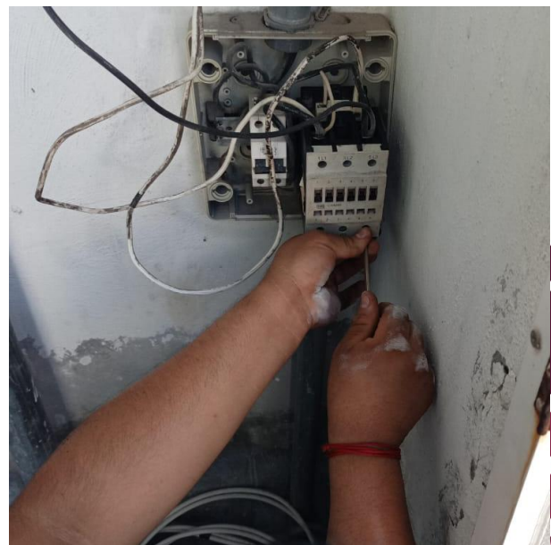
CAMBIO DE CONTACTOR DAÑADO POR NUEVO; CALLE ESCORPION NTE ENTRE CALLE 4 OTE, FRACC. GUERRA DE CASTAS.
