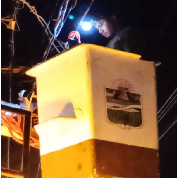
RECONEXIÓN DE LINEA AEREA PARA REHABILITAR SECTOR; CALLE OK-K'OT ENTRE CALLE ORIÓN NTE, COOL. MAYA PAX.
