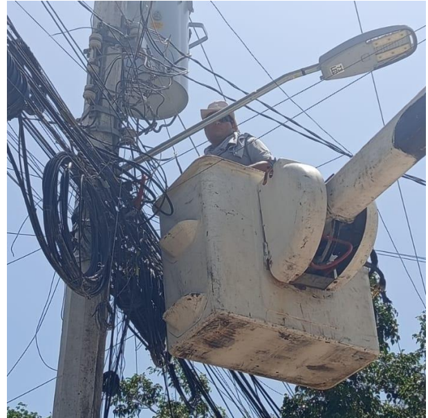
REPARACIÓN DE LUMINARIA; CALLE CHAN-CHEN ENTRE CALLE QUETZAL, COL. EJIDO.
