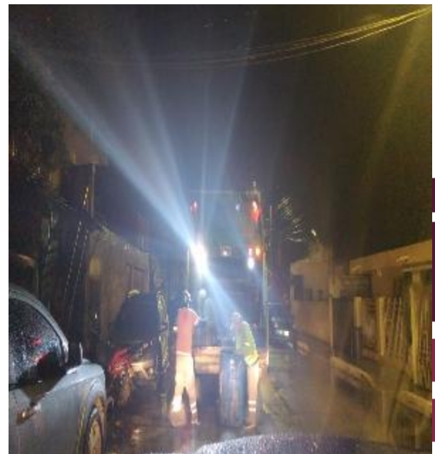
Colonia centro sur
