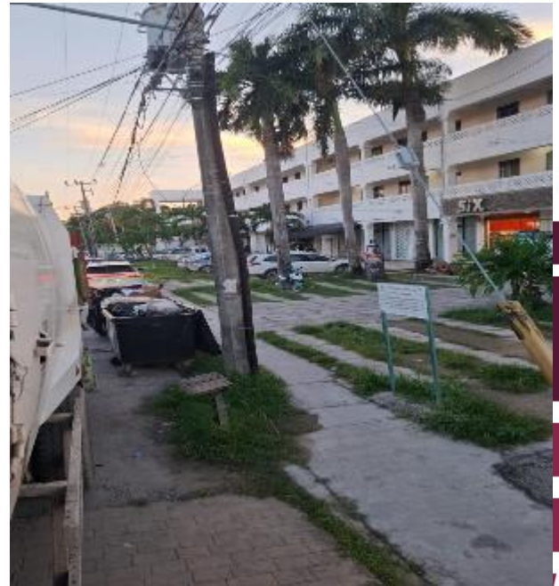
Fraccionamiento villas Tulum
