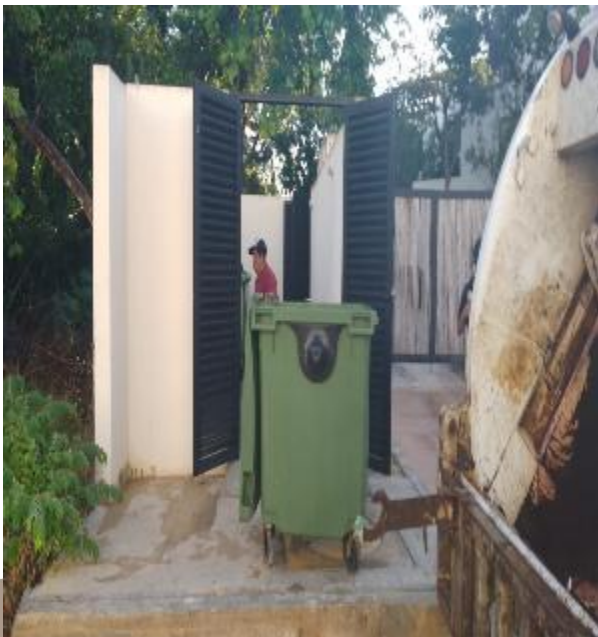
Fraccionamiento villas Tulum
