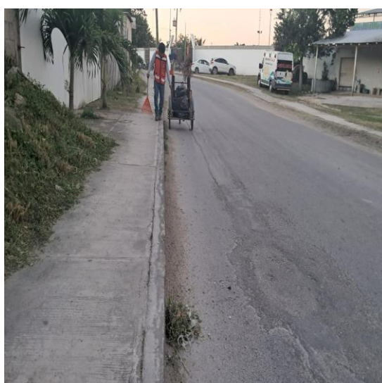
Calle zazil ha entre av. kukulkán y calle polar poniente, (sector 2).
