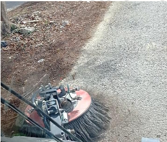
Limpieza de calles (barrido): Av. yodzonot entre av. 18 y calle 24; colonia tumben kaa.
