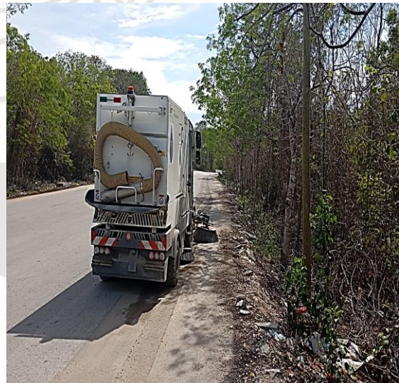
Limpeza de calles (barrido): Av.1 entre calle 2-e y calle tepezcuintle; colonia tumben kaa.
