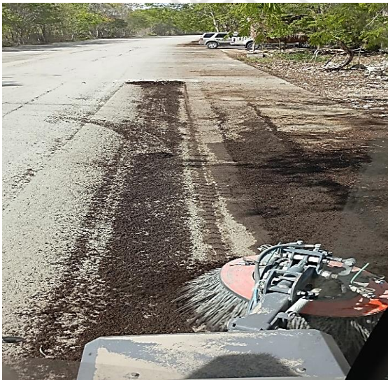
Limpeza de calles (barrido): Av.1 entre av. 18 y calle 2-e; colonia tumben kaa.
