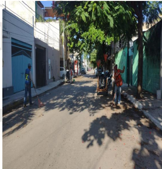
Calle Alfa Sur y calles cortas entre calle Alfa Sur y av. Osiris Sur.
