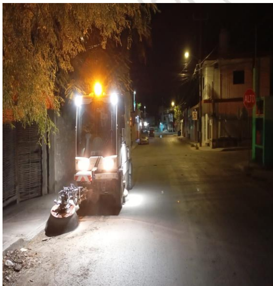
Calle acuario entre calle 2 oriente y av. Tulum, (barredora).
