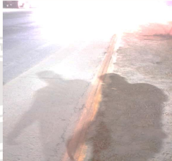
Limpieza de calles (barrido): Av. Tulum entre av. kukulkán y calle saturno poniente; colonia la veleta.
