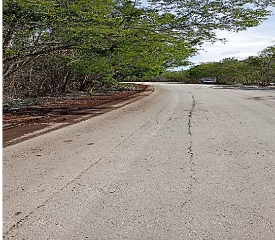
Limpieza de calles (barrido): Av. 1 entre calle tepezcuintle y calle 2-e; colonia tumben kaa.
