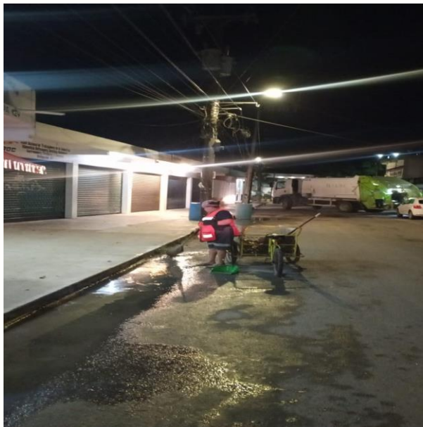
Calle Júpiter Sur entre av. Tulum y av. Luna Poniente, (telesecundaria).
