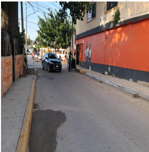
Calle acuario sur entre calle mercurio poniente y calle luna poniente.
