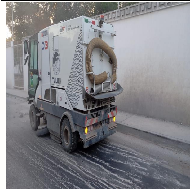
Av. Kukulkán entre av. Tulum y av. ook-k'ot, (barredora).
