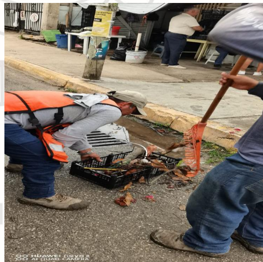
Limpeza de rejillas: Calle andrómeda oriente entre av. satélite sur; colonia centro sur.
