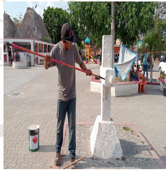
Pintura; Realización de pintura en la barda de la iglesia de la cancha maya y sus guarniciones; colonia maya.
