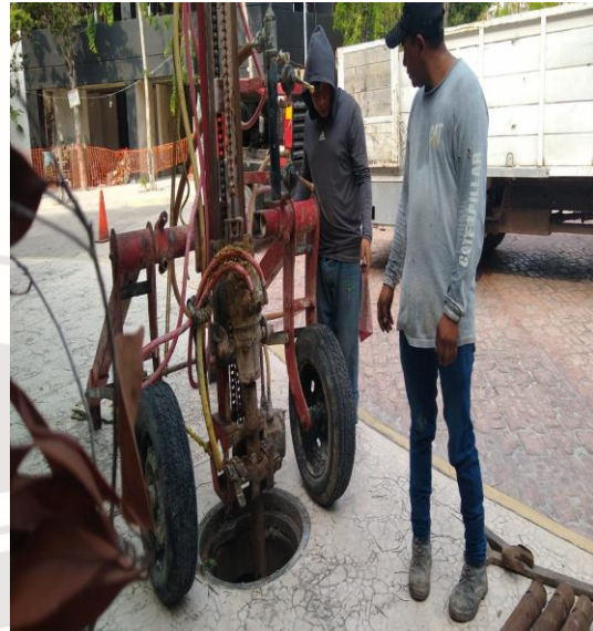
Desazolve de pozos Calle aldea zama entre calle kaam, fraccionamiento aldea zama. (pozo no. 02)
