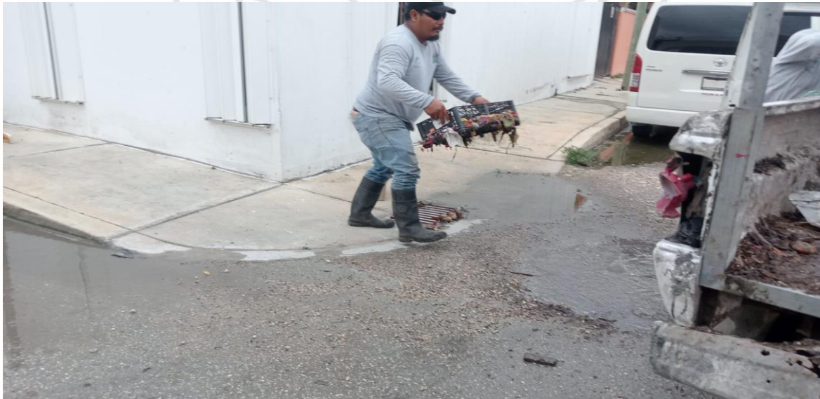
Limpieza de rejillas: Calle Orión norte entre calle lexu; colonia mayapax.
