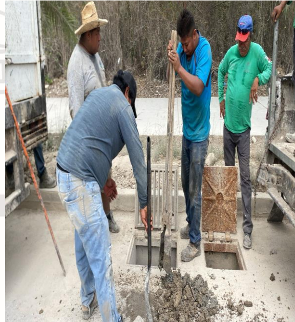
Limpeza de pozos; Av. 10 norte bis entre calle 2 bis norte; fraccionamiento villas Tulum.
