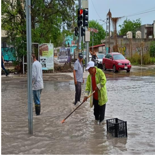
Limpieza de rejillas: Av. ook-k'ot entre calle osiris norte; colonia mayapax.
