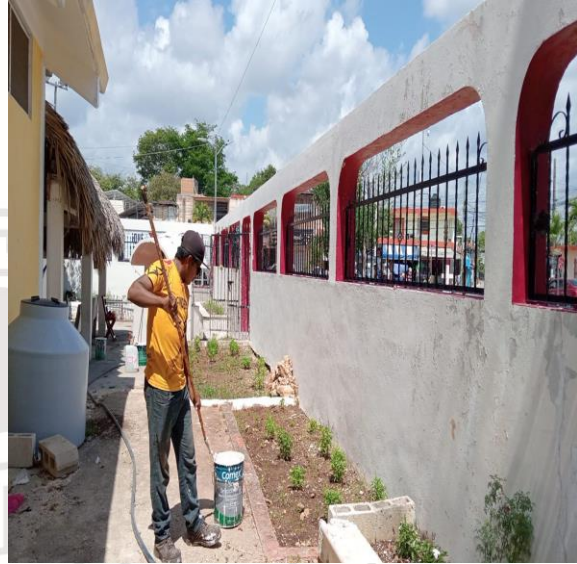
Pintura; Realización de pintura en la barda de la iglesia maya; colonia maya.
