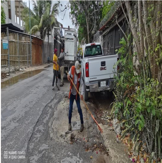
Limpieza de rejillas: Calle palenque entre calle 7 sur; colonia veleta.
