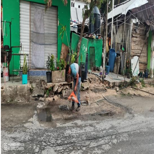
Limpieza de rejillas: Calle mercurio oriente entre calle palenque; colonia centro sur.
