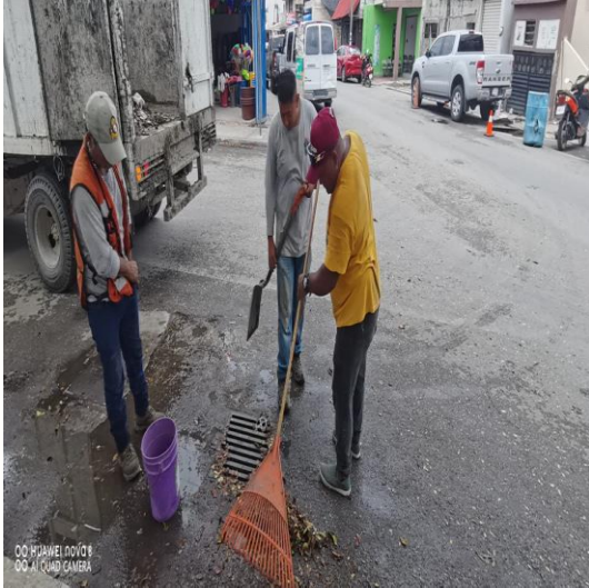
Limpeza de rejillas: Calle omega sur entre calle sol poniente; colonia centro sur.
