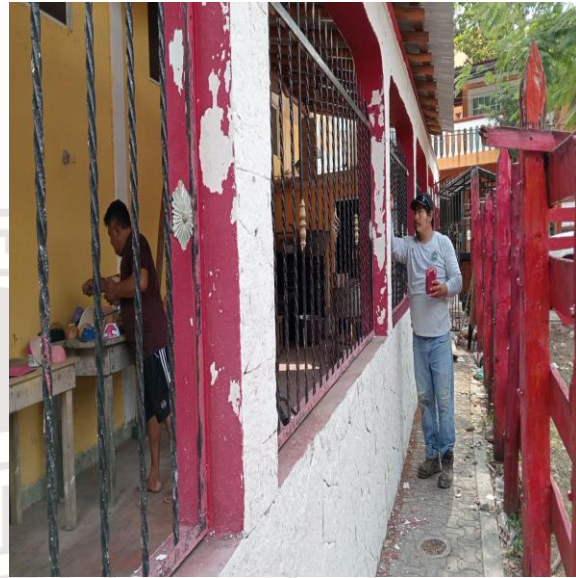
Pintura; Realización de pintura en la barda y guarniciones de la iglesia maya; colonia maya.
