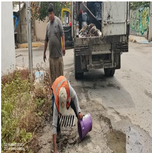
Limpieza de rejillas: Calle mercurio poniente entre calle saturno sur; colonia centro sur.
