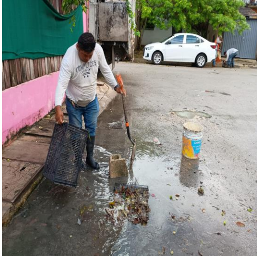
Limpeza de rejillas: Calle 15 entre calle 4 oriente; fraccionamiento villas Tulum.
