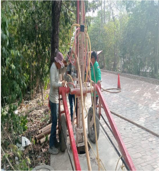
Desazolve de pozos Calle Juan-Ek entre calle itzamna. (pozo no. 01)
