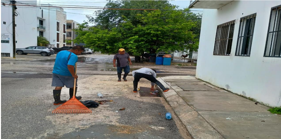
Limpeza de rejillas: Calle 7 sur entre calle 2 oriente; fraccionamiento villas Tulum.
