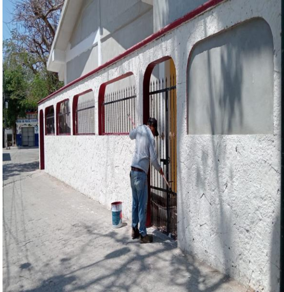
Pintura; Realización de pintura en la barda de la iglesia maya; colonia maya.
