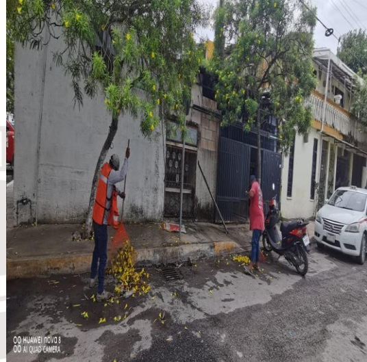
Limpieza de rejillas: Calle venus oriente entre calle centauro norte y la av. satélite; colonia centro sur.
