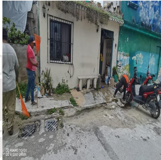
Limpieza de rejillas: Calle huracán rossana entre calle huracán paulina; fraccionamiento huracanes.
