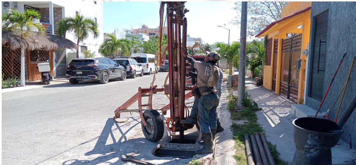
Desazolve de pozos Calle Cecilio chi entre calle libra norte, fraccionamiento guerra de casta.
