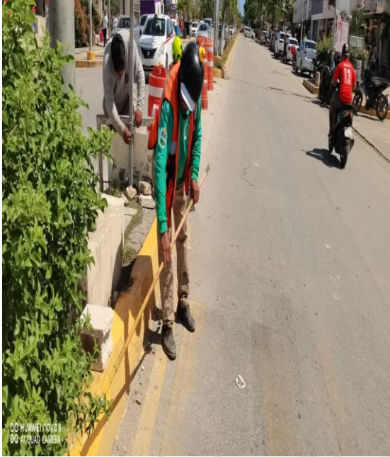
Pintura; Realización de pintura en el camellón central de la av. Tulum; colonia centro.
