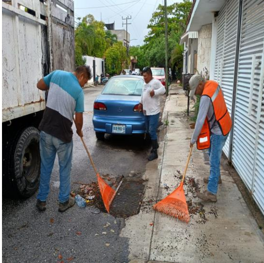
Limpieza de rejillas: Calle 11 entre calle 2 oriente; fraccionamiento villas Tulum.
