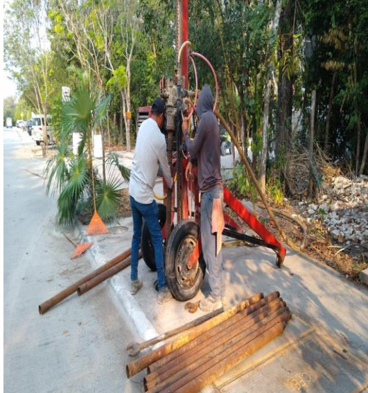
Desazolve de pozos Av. coba entre calle balam dzacab, fraccionamiento aldea zama.
