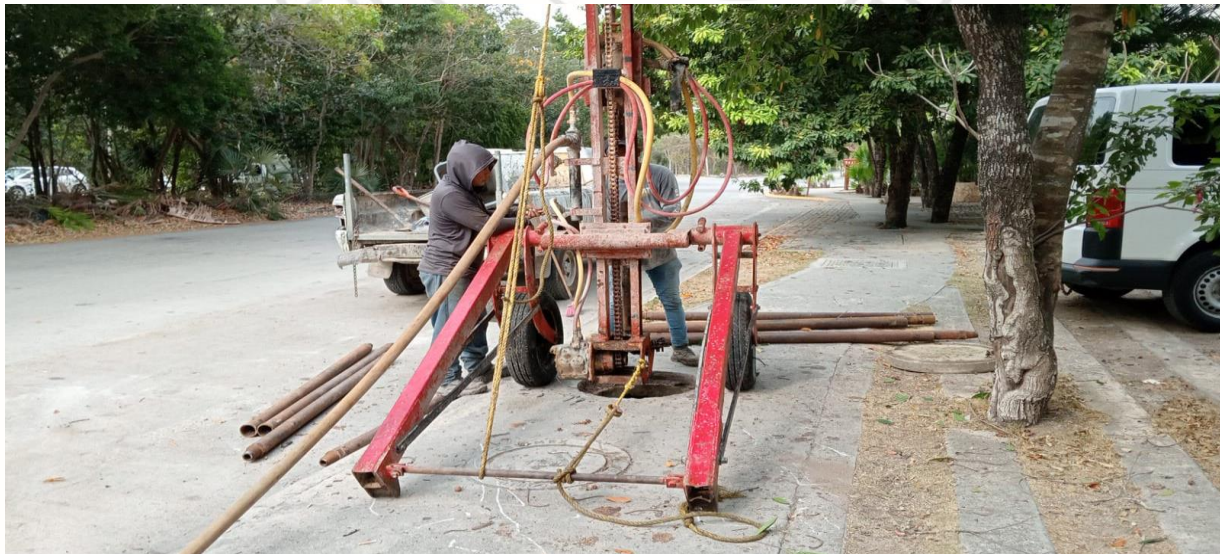
Desazolve de pozos Calle itzamna entre av. Kabah, fraccionamiento aldea zama.
