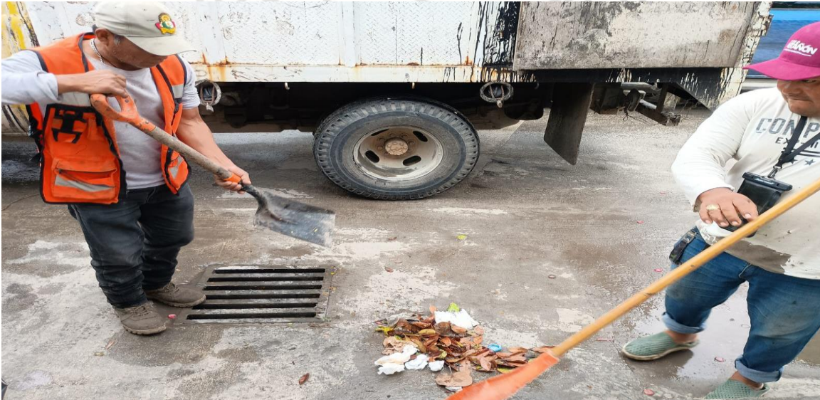
Limpieza de rejillas: Calle sol oriente entre calle osiris sur; colonia centro sur.
