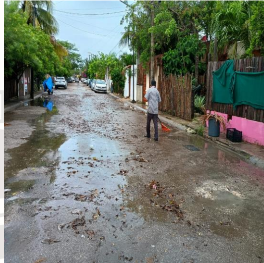
Limpieza de rejillas: Calle 4 oriente xel-ha entre calle 15 boca paila; colonia ejido norte.
