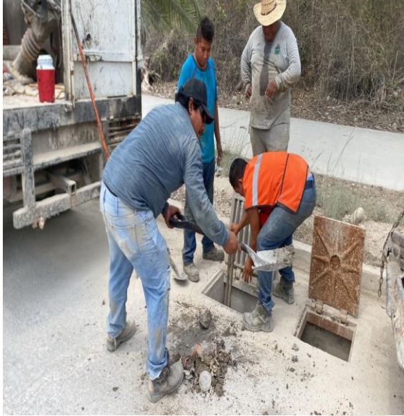
Limpeza de pozos; Av. 10 norte bis entre calle 2 bis norte; fraccionamiento villas Tulum.
