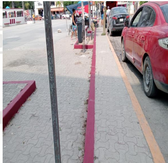
Pintura; Realización de pintura en la barda y guarniciones de la iglesia maya; colonia maya.
