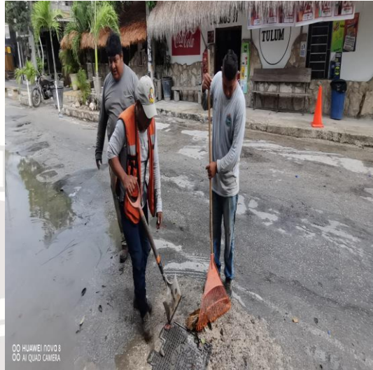
Limpieza de rejillas: Calle 7 sur entre calle 14 sur; colonia veleta.
