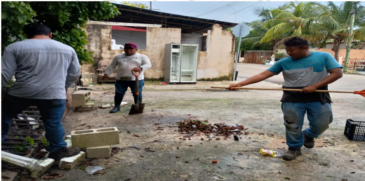
Limpieza de rejillas: Calle 7 sur entre calle 2 bis oriente; fraccionamiento villas Tulum.
