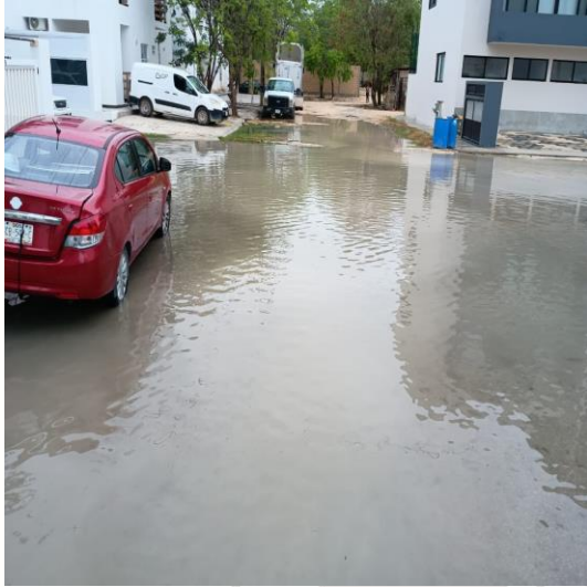
Limpieza de rejillas: Calle 5 sur entre calle 4 oriente; fraccionamiento villas TULUM.
