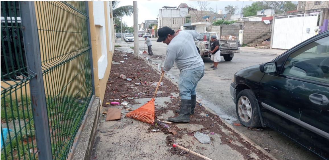
Limpieza de rejillas: Calle palma chat entre bulevar palmas TULUM; fraccionamiento las palmas.
