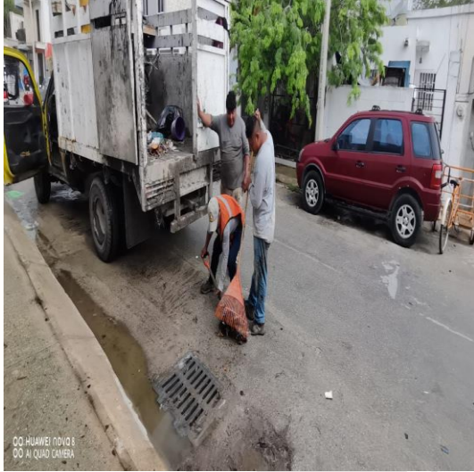
Limpieza de rejillas: Calle palmas chat entre bulevar palmas TULUM; fraccionamiento palmas.
