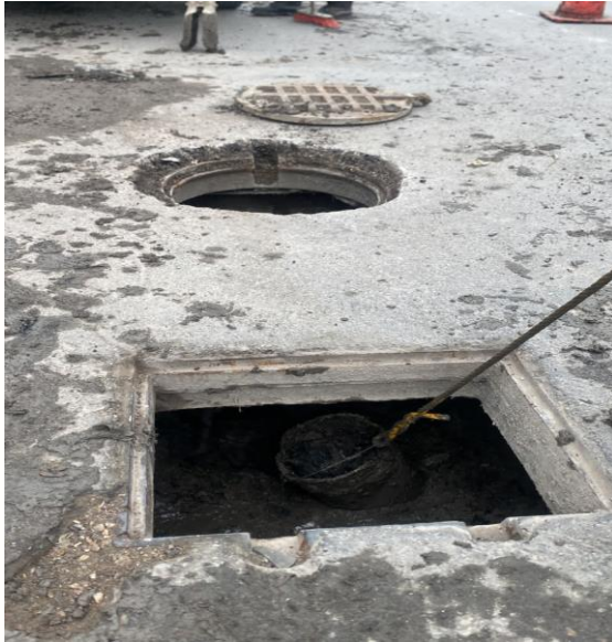
Limpeza de pozos; Av. kukulkán entre calle mercurio poniente y calle ontario; colonia la veleta.
