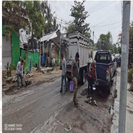
Limpieza de rejillas: Calle coba entre calle palenque; colonia veleta.
