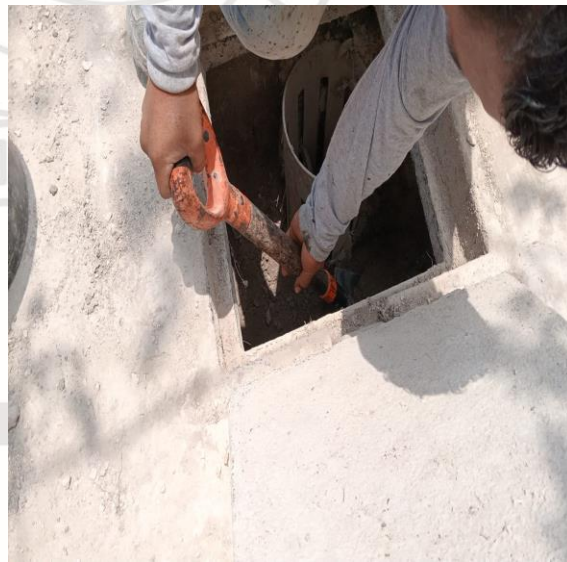
Limpieza de pozos; Av. 10 norte bis entre calle jaaleb y calle kitam; colonia ejido norte. Pozo 01.
