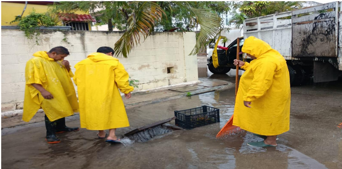
Limpeza de rejillas: Calle 17 entre calle 2 bis oriente; fraccionamiento villas Tulum.
