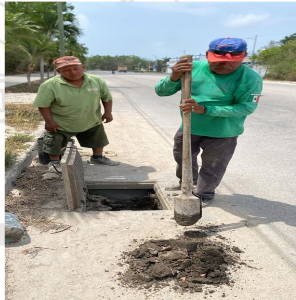
Limpieza de pozos; Av. 10 norte bis entre av. Tulum; fraccionamiento villas Tulum.
