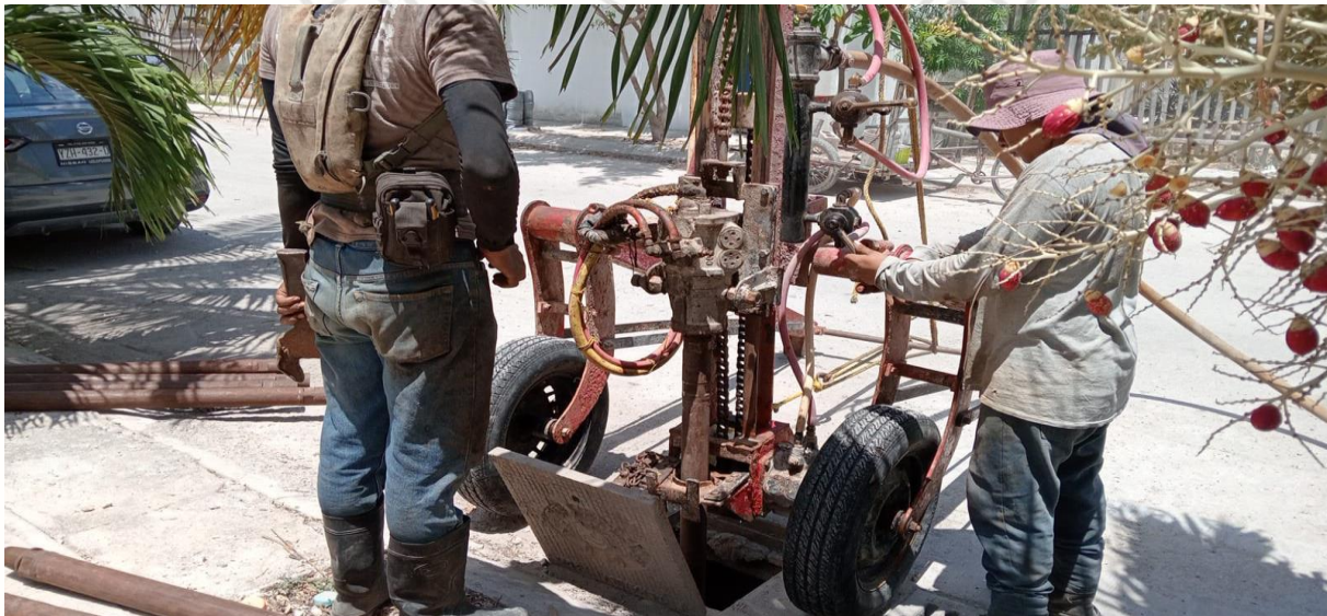
Desazolve de pozos; Calle Jacinto Pat entre calle 2 oriente y calle 4 oriente, colonia centro.
