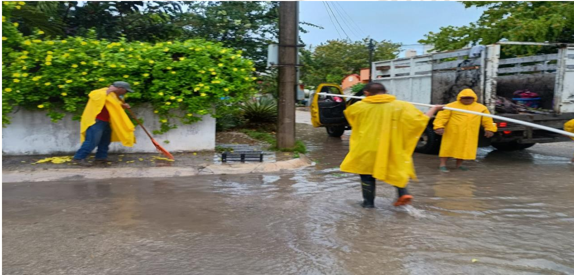
Limpeza de rejillas: Calle 5 sur entre calle 2 oriente; fraccionamiento villas Tulum.
