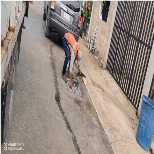
Limpieza de rejillas; Calle palmas botella entre bulevar palmas TULUM; fraccionamiento palmas.
