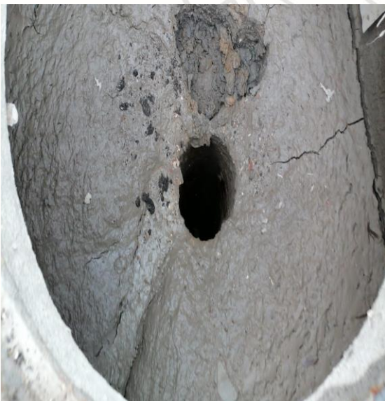
Limpeza de pozos; Av. kukulkán entre calle mercurio poniente y calle ontario; colonia la veleta.
