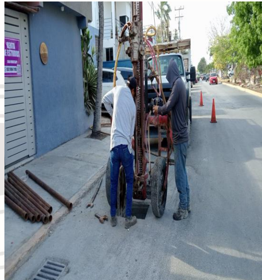
Desazolve de pozos Av. satélite entre calle 2 oriente, colonia centro. (pozo no. 01)
