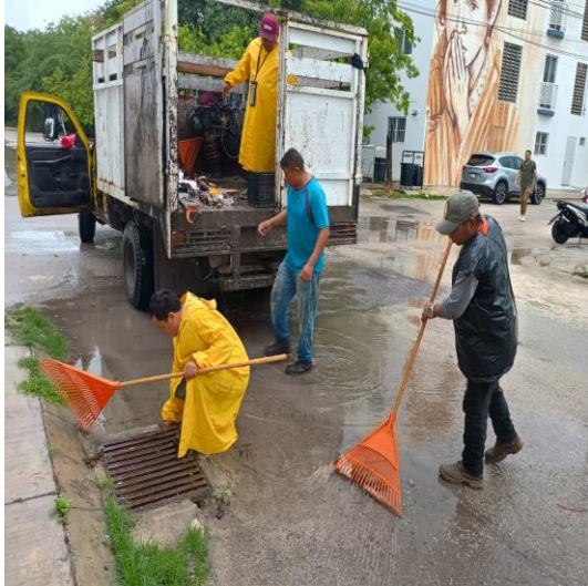
Limpeza de rejillas: Calle 7 sur entre calle 2 poniente; fraccionamiento villas TULUM.
