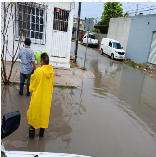
Limpieza de rejillas: Calle boca paila entre calle Faisán; colonia ejido norte.
