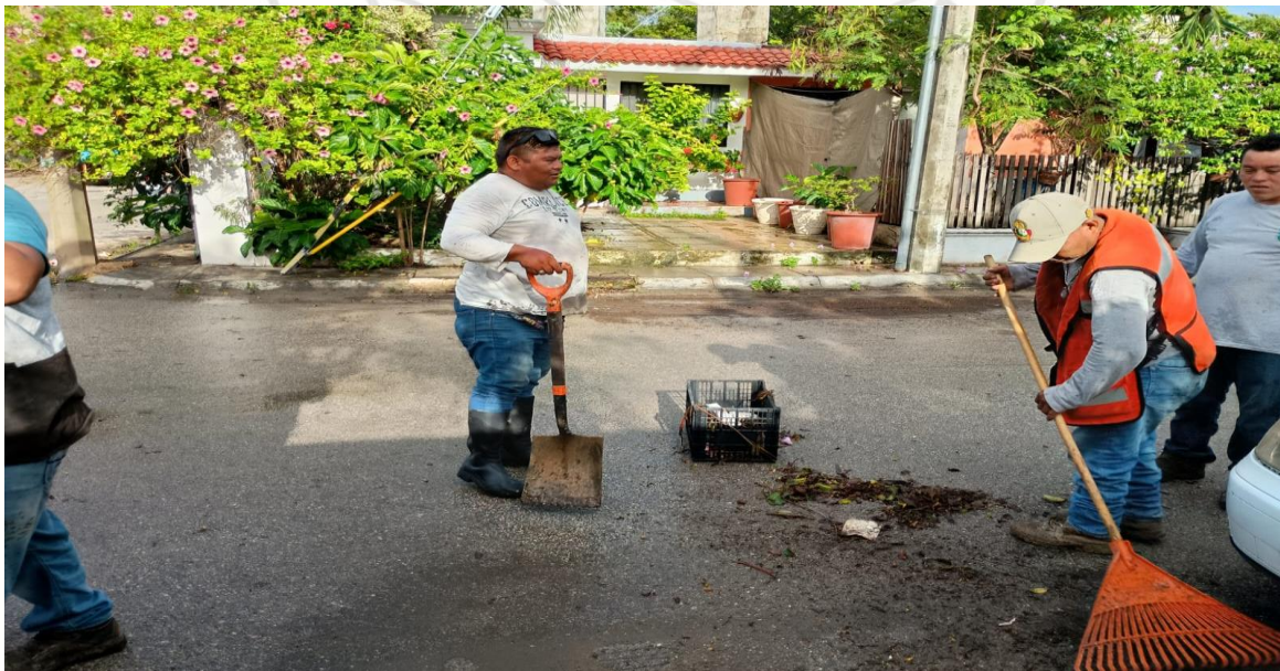
Limpeza de rejillas: Calle 17 entre calle 2 bis oriente; fraccionamiento villas Tulum.
