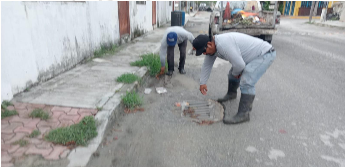
Limpieza de rejillas: Calle sagitario oriente entre calle alfa norte; colonia centro norte.
