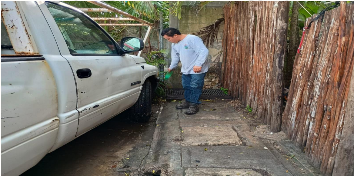
Limpieza de rejillas: Calle 2 bis oriente entre calle 11; fraccionamiento villas Tulum.
