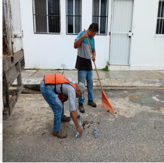
Limpieza de rejillas: Calle 7 sur entre la calle 2 a oriente; fraccionamiento villas Tulum.
