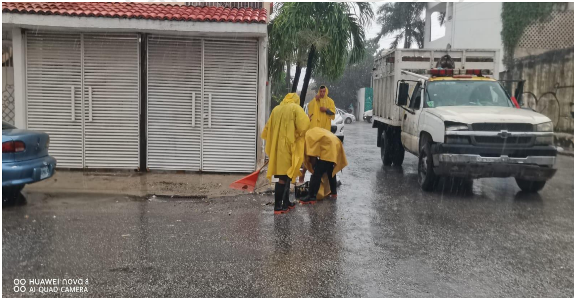
Limpieza de rejillas: Calle 11 entre calle 2 oriente; fraccionamiento villas Tulum.
