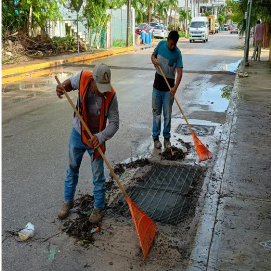
Limpieza de rejillas: Calle 3 entre calle 2 bis oriente; fraccionamiento villas Tulum.
