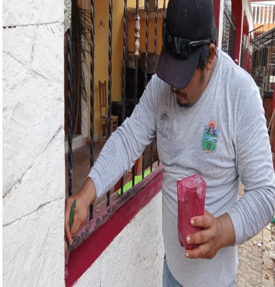
Pintura; Realización de pintura en la barda y guarniciones de la iglesia maya; colonia maya.
