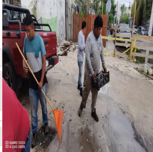
Limpieza de rejillas: Calle 2 bis oriente entre calle 5 sur; fraccionamiento villas Tulum.
