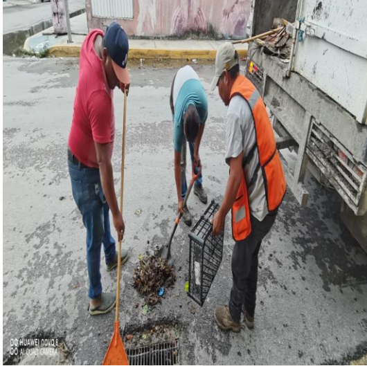
Limpieza de rejillas: Calle sol oriente entre calle centauro sur; colonia centro sur.
