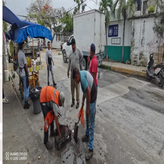
Limpieza de rejillas: Calle sol oriente entre av. osiris sur; colonia centro sur.
