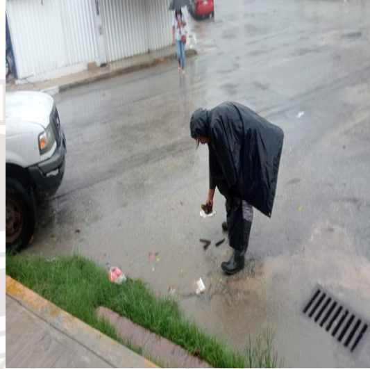
Limpeza de rejillas: Calle polar entre calle sagitario; colonia centro norte.
