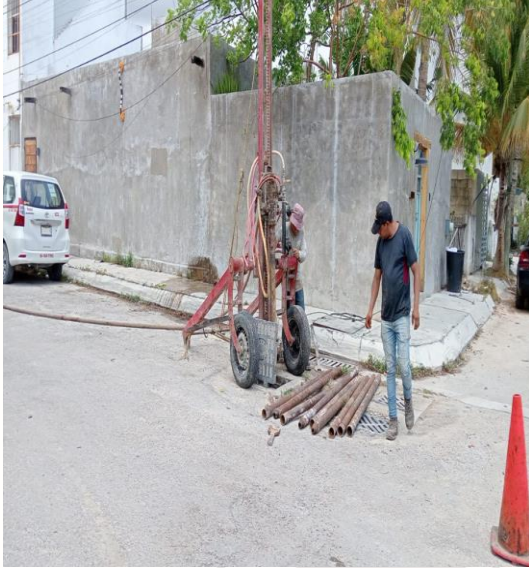
Desazolve de pozos Calle 5 sur entre calle 2 oriente, fraccionamiento villas Tulum.
