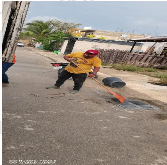
Limpieza de rejillas; Calle palmas abanico entre bulevar palmas TULUM; fraccionamiento palmas.
