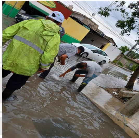
Limpieza de rejillas: Calle tun-kul entre calle alfa norte; colonia mayapax.
