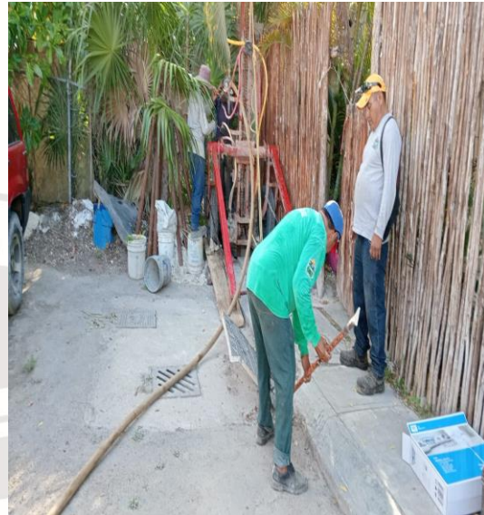
Desazolve de pozos Calle chemuyil entre calle 2 oriente, fraccionamiento villas Tulum.
