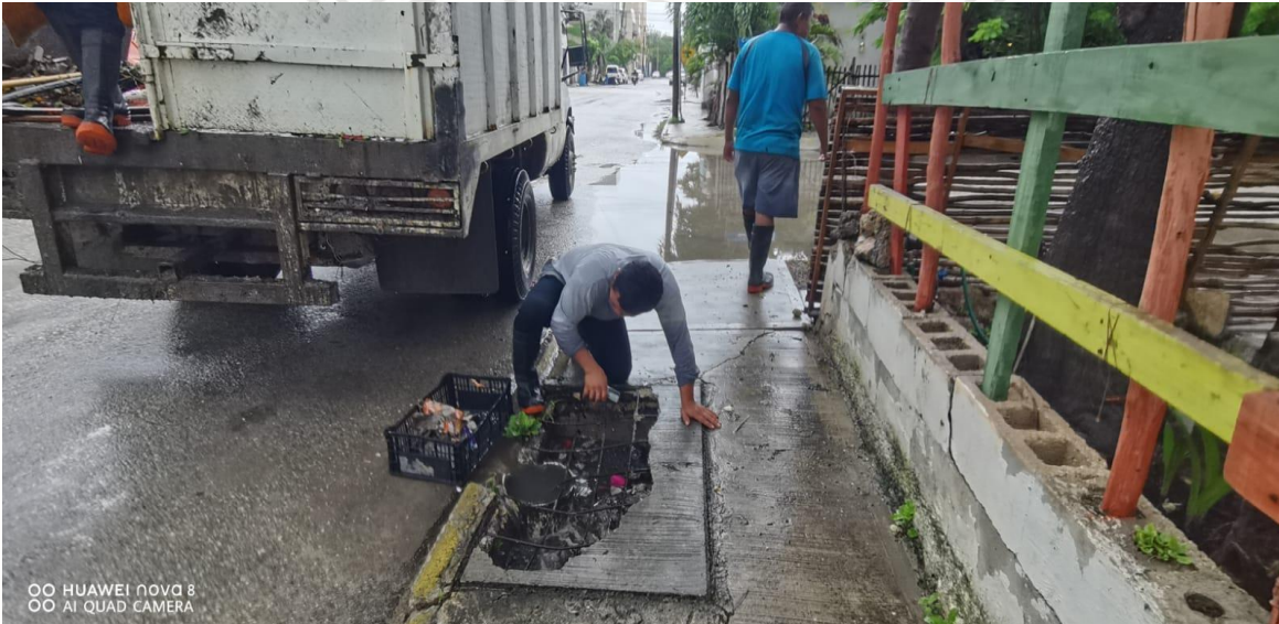
Limpeza de rejillas: Calle 3 entre calle 2 a oriente; fraccionamiento villas Tulum.
