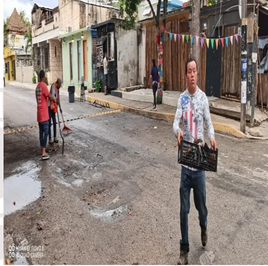
Limpeza de rejillas: Calle andrómeda oriente entre calle orión sur; colonia centro sur.
