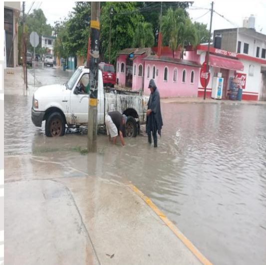
Limpieza de rejillas: Calle 11 entre calle sian kaan; colonia ejido norte.
