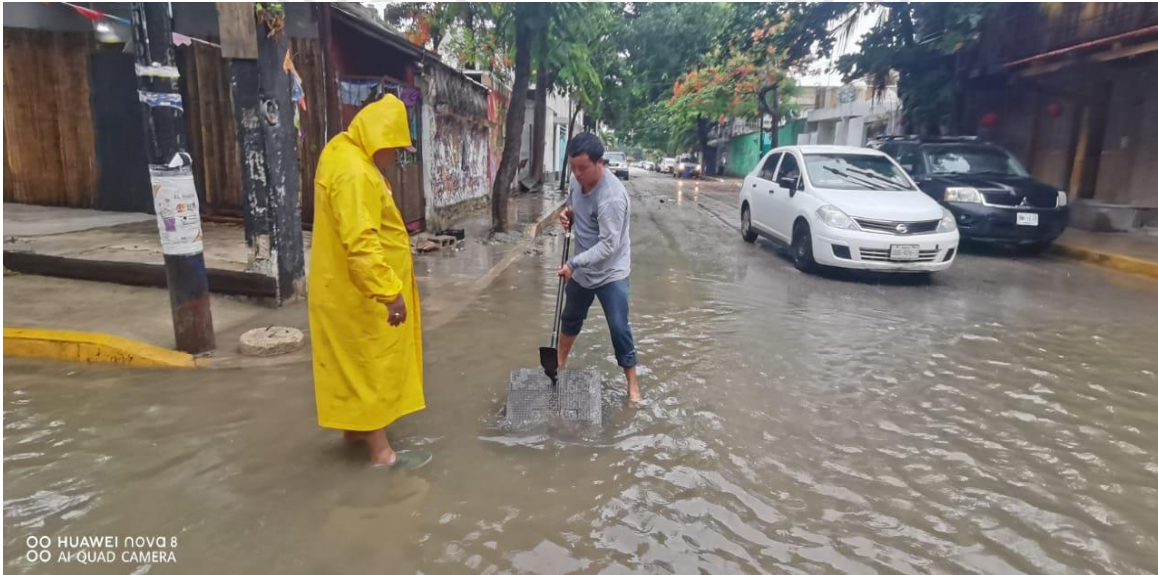
Limpieza de rejillas: Calle andrómeda oriente entre calle centauro sur; colonia centro sur.
