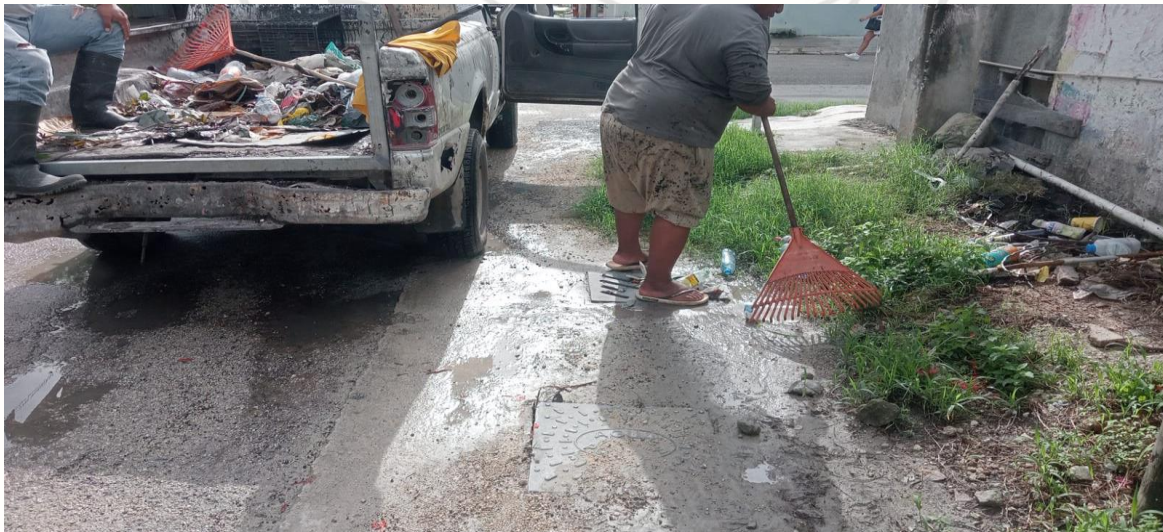
Limpieza de rejillas: Calle sagitario oriente entre calle beta norte; colonia centro norte.
