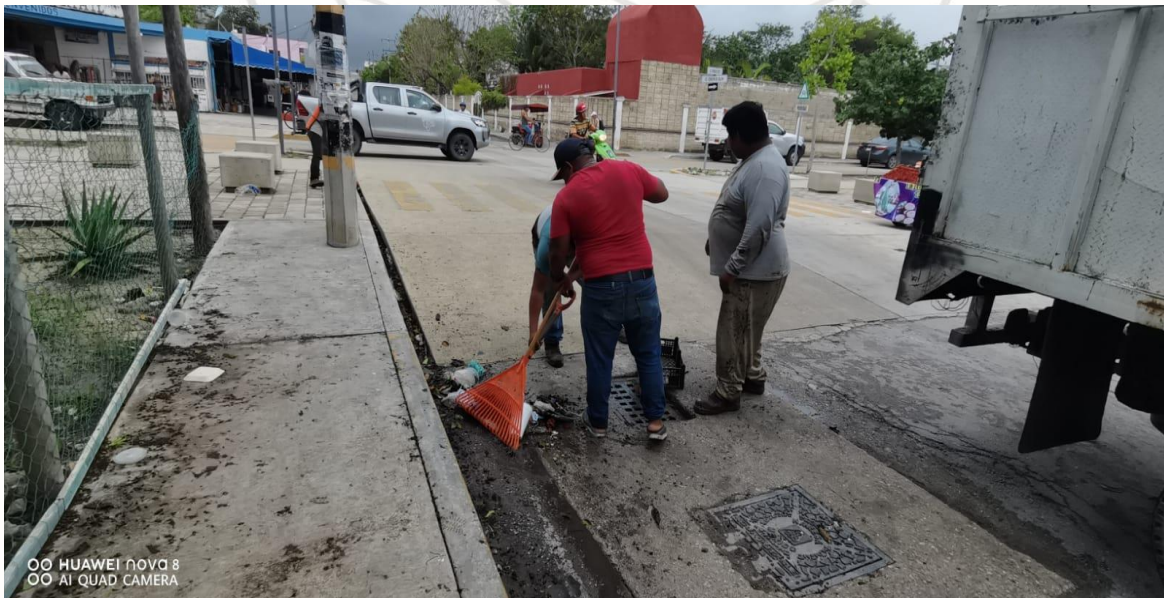
Limpieza de rejillas: Calle venus oriente entre av. osiris sur; colonia centro sur.
