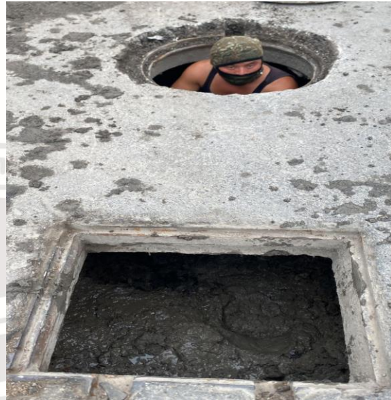
Limpieza de pozos; Av. kulkán entre calle polar poniente y calle saturno poniente; colonia luna.
