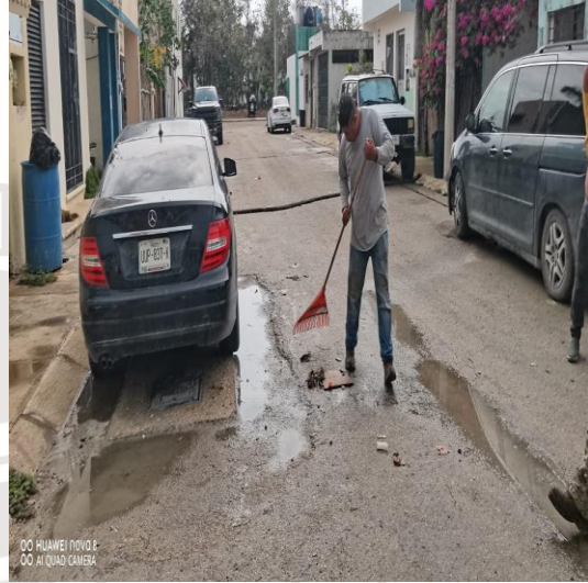
Limpieza de rejillas: Calle palma guinea entre calle palmas rapis y calle reina; fraccionamiento palmas.
