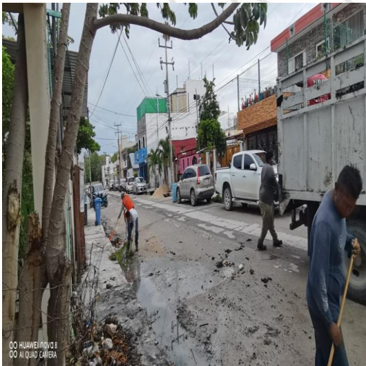
Limpieza de rejillas: Calle huracán beulah entre calle huracán mitch; fraccionamiento huracanes.
