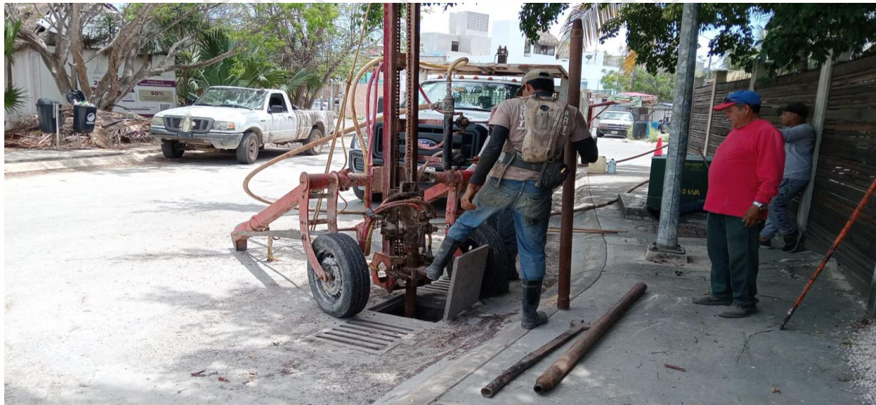
Desazolve de pozos Calle escorpión norte entre calle 4 oriente y calle Cecilio chi, fraccionamiento guerra de casta.
