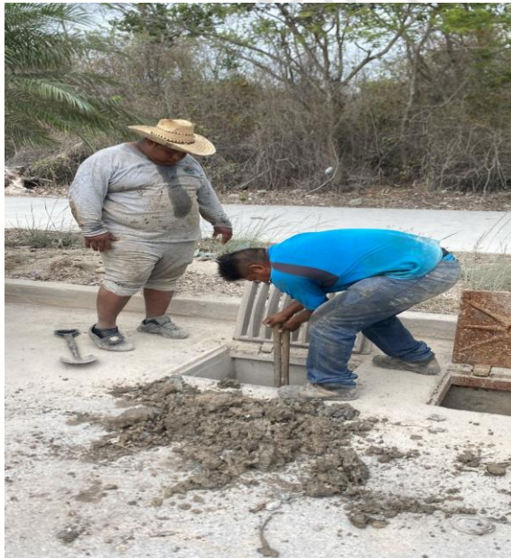
Limpeza de pozos; Av. 10 norte bis entre calle 2 bis norte;
