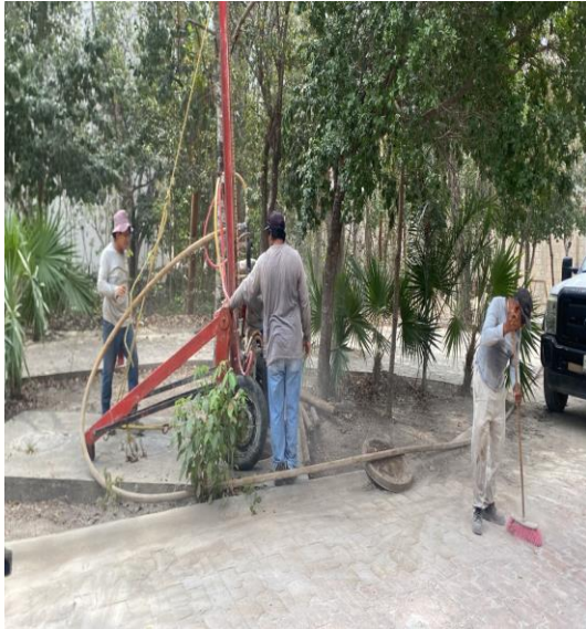
Desazolve de pozos Calle Juan-Ek entre av. balam dzacab, fraccionamiento aldea zama.
