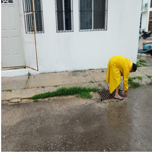
Limpieza de rejillas: Calle 7 sur entre calle 2 oriente; fraccionamiento villas Tulum.
