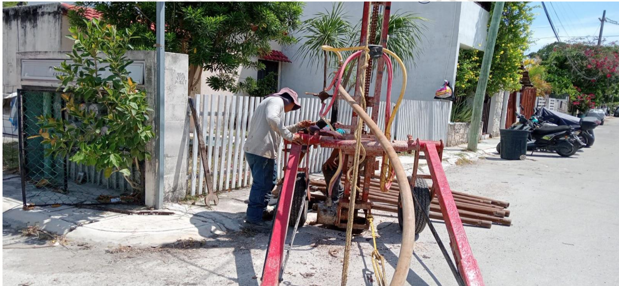
Desazolve de pozos Calle 4 oriente entre calle chemuyil, fraccionamiento villas Tulum.
