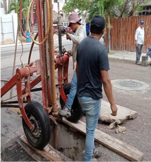
Desazolve de pozos Calle 2 bis oriente entre av. 3 sur, fraccionamiento villas Tulum. (pozo no. 01)
