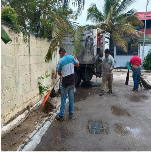
Limpieza de rejillas: Calle 17 entre calle 2 bis oriente; fraccionamiento villas Tulum.
