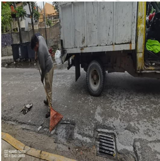
Limpeza de rejillas: Calle andrómeda oriente entre calle centauro sur; colonia centro sur.
