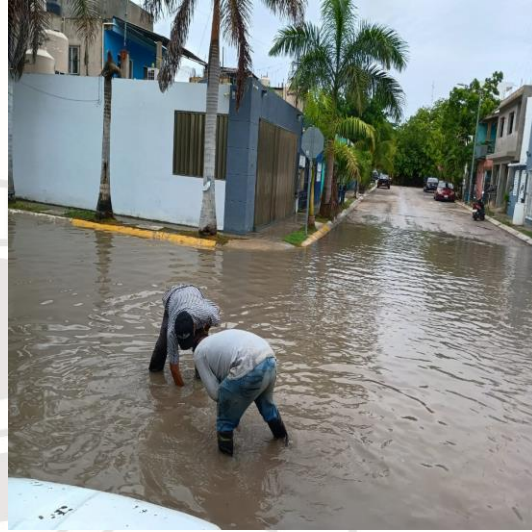
Limpieza de rejillas: Calle 2 poniente entre calle escorpión norte; fraccionamiento guerra de castas.
