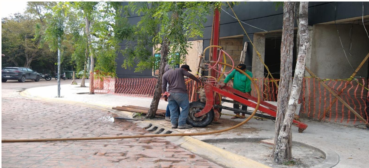
Desazolve de pozos Calle aldea zama entre calle kaam, fraccionamiento aldea zama. (pozo no. 03).
