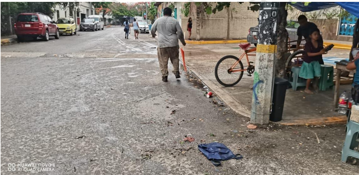
Limpieza de rejillas: Calle mercurio poniente entre calle luna sur; colonia centro sur.
