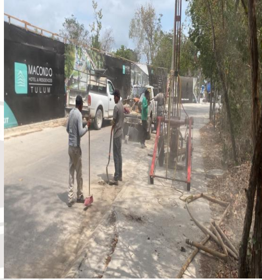
Desazolve de pozos Calle Juan-Ek entre calle itzamna y calle boca, fraccionamiento aldea zama.
