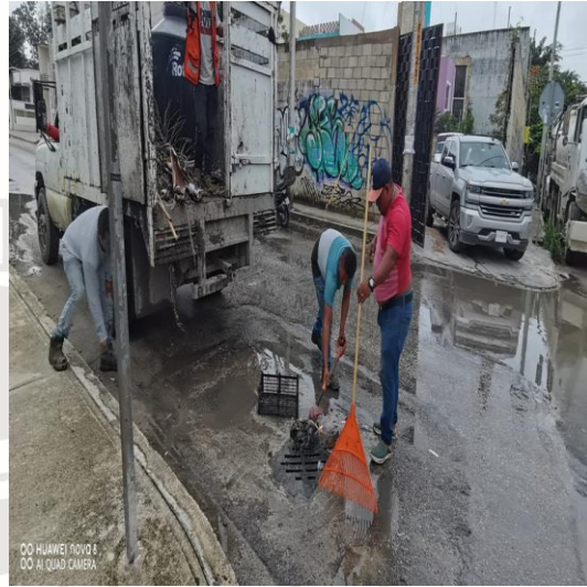
Limpieza de rejillas: Calle andrómada oriente entre calle gémunis sur; colonia centro sur.
