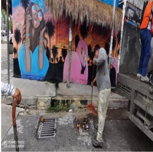
Limpeza de rejillas: Calle andrómeda oriente entre calle osiris norte; colonia centro norte.
