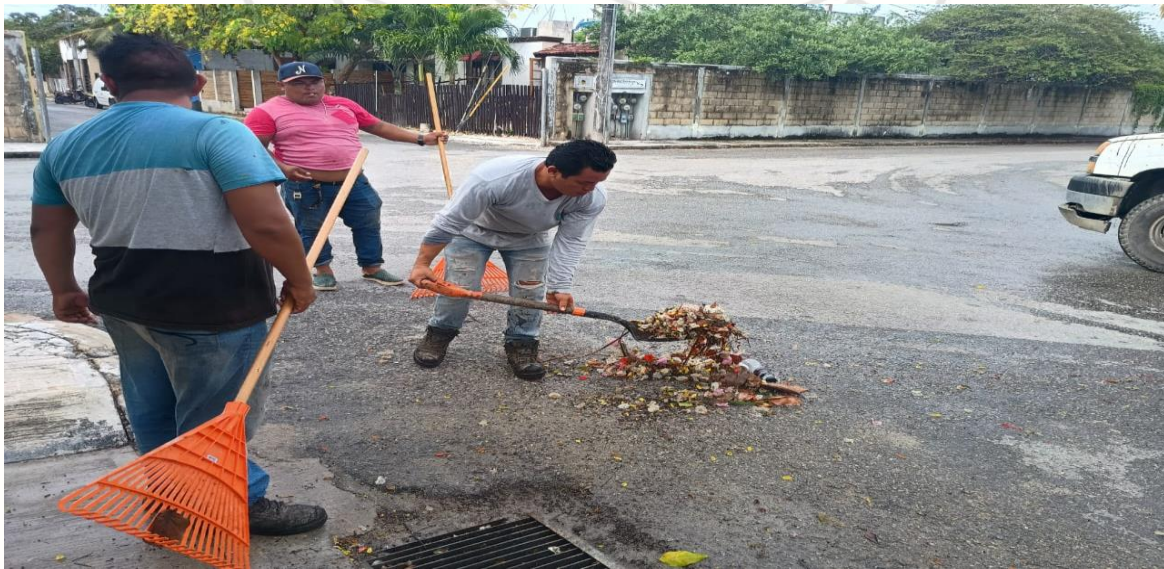
Limpieza de rejillas: Calle 11 entre calle 2 oriente; fraccionamiento villas Tulum.
