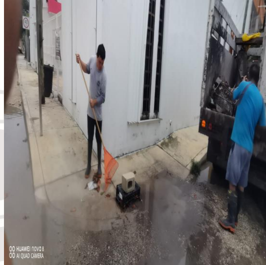
Limpieza de rejillas: Calle orión norte entre calle lexiu; colonia mayapax.
