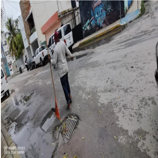
Limpieza de rejillas: Calle neptuno oriente entre calle centauro sur; colonia centro norte.
