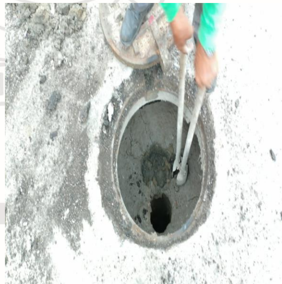
Limpeza de pozos; Av. kukulkán entre calle mercurio poniente y calle ontario; colonia la veleta.
