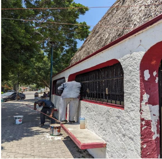
Pintura; Realización de pintura en el parque de la cancha maya; colonia maya.
