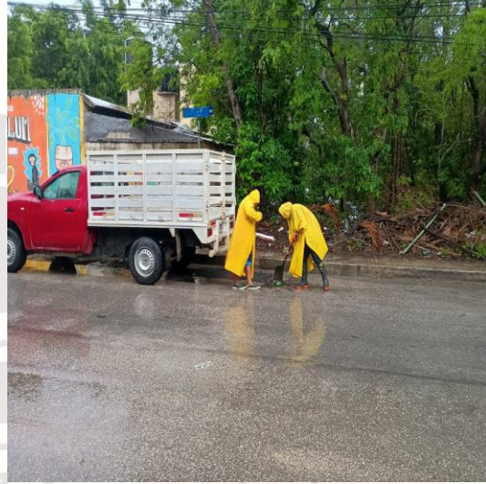
Limpieza de rejillas: Calle 3 sur entre calle 2 bis oriente; fraccionamiento villas Tulum.
