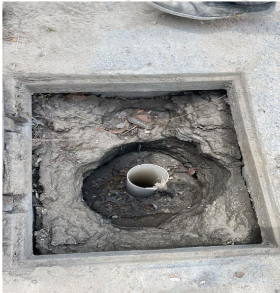
Limpieza de pozos; Av. 10 norte bis entre av. Tulum; fraccionamiento villas Tulum
