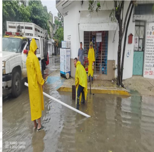
Limpieza de rejillas: Calle neptuno oriente entre calle centauro sur; colonia centro sur.
