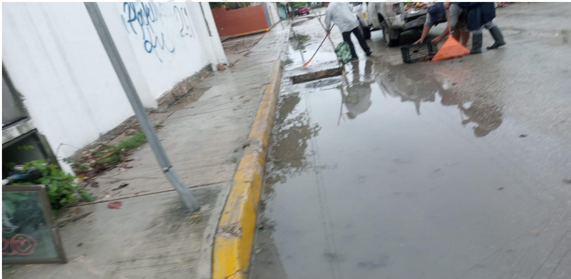
Limpeza de rejillas: Calle libra sur entre calle andrómeda oriente; colonia lak'iin.
