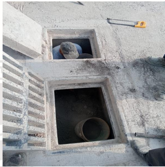
Limpeza de pozos; Av. 10 norte bis entre calle jaaleb y calle kitam; colonia ejido norte. Pozo 02.
