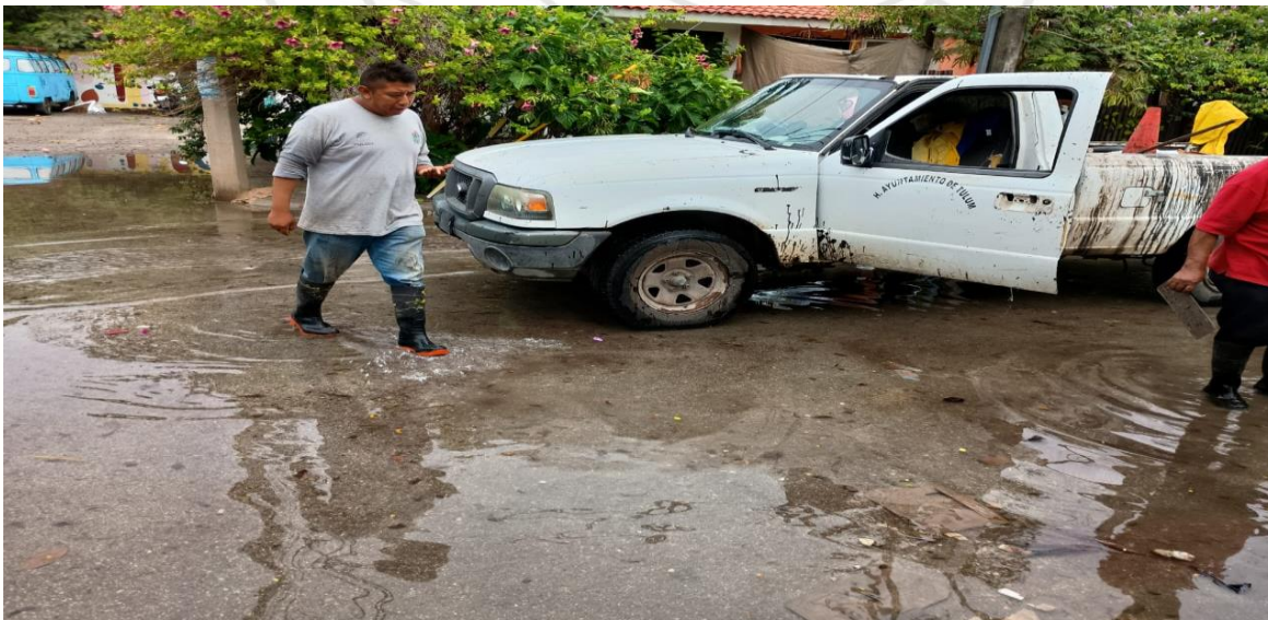
Limpieza de rejillas: Calle 17 entre calle 2 bis oriente; villas Tulum.
