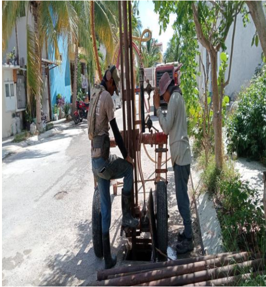
Desazolve de pozos Calle andador tepich entre calle 2 oriente, fraccionamiento guerra de casta.
