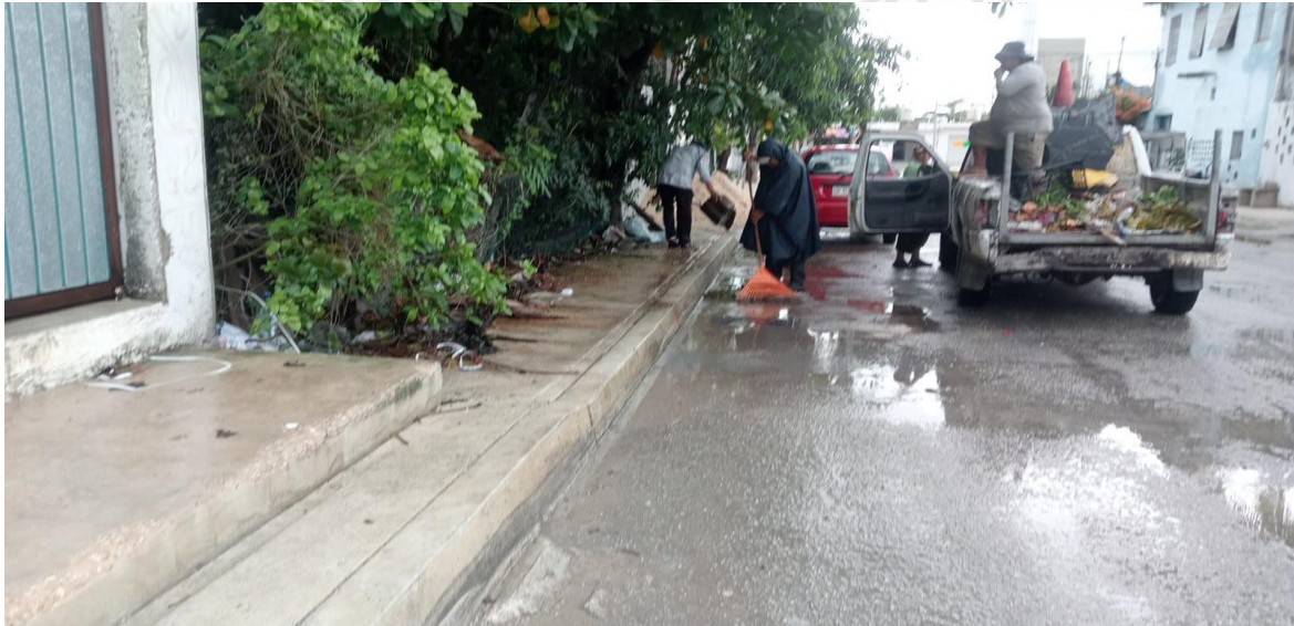
Limpeza de rejillas: Calle chikil entre calle tun-kul y av. ook-k'ot; colonia mayapax.
