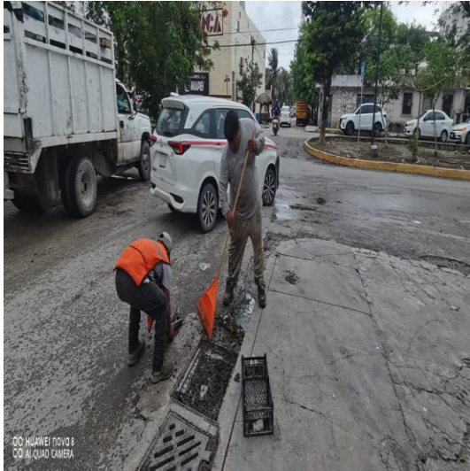
Limpieza de rejillas: Calle andrómada oriente entre av. satélite sur; colonia centro sur.
