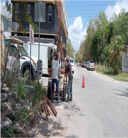
Desazolve de pozos Calle géminis norte entre calle 2 oriente, colonia centro.
