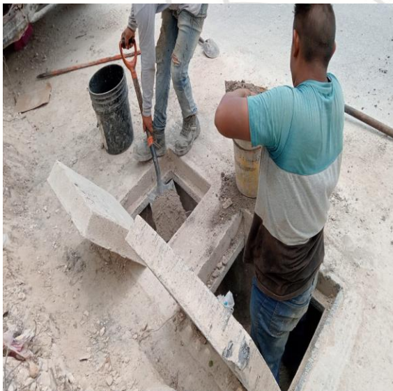
Limpieza de pozos; Calle 4 poniente entre calle osiris norte y calle 2 poniente; colonia centro norte.
