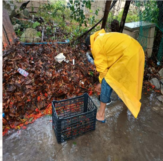
Limpeza de rejillas: Calle chemuyil entre calle 4 oriente; fraccionamiento villas Tulum.
