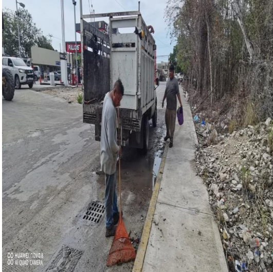
Limpieza de rejillas: av. selva entre calle kohunlich y la calle Akumal; colonia ejido norte.
