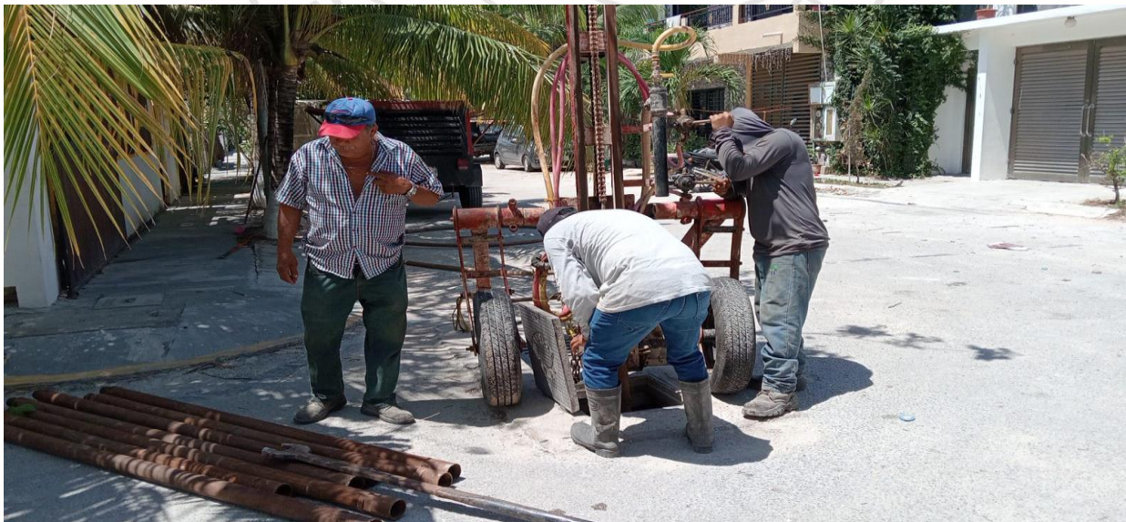
Desazolve de pozos Calle Jacinto Pat entre calle 2 oriente, colonia centro. (pozo no. 02)
