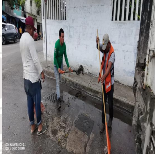
Limpieza de rejillas: Calle omega sur entre calle sol poniente; colonia centro sur.
