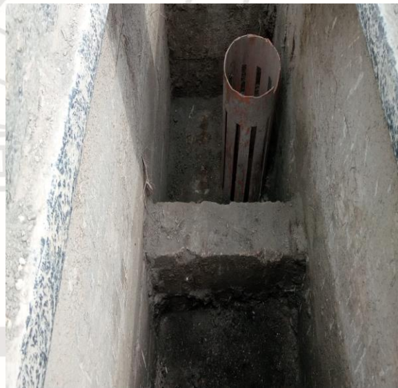
Limpieza de pozos; Calle saturno norte entre calle polar poniente; colonia centro norte.
