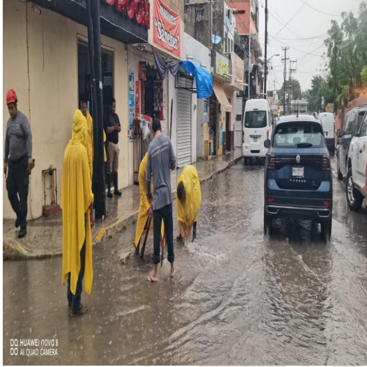
Limpeza de rejillas: Calle sol poniente entre calle júpiter sur; colonia centro sur.
