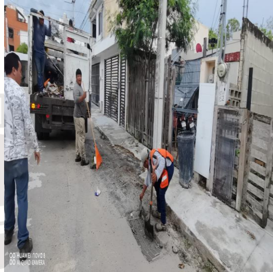
Limpieza de rejillas: Cale huracán mitch entre calle huracán janeth; fraccionamiento huracanes.
