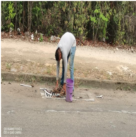
Limpieza de rejillas: Calle 10 norte entre av. Tulum; fraccionamiento villas Tulum.
