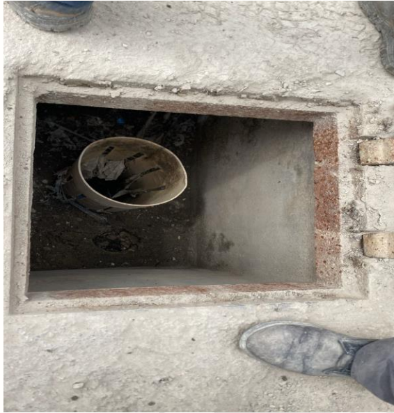
Limpieza de pozos; Calle saturno norte entre calle polar poniente; colonia centro norte.
