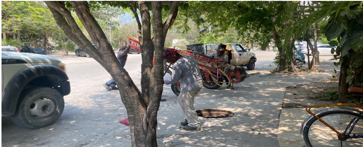
Desazolve de pozos Calle itzamna entre calle Ixchel, fraccionamiento aldea zama.
