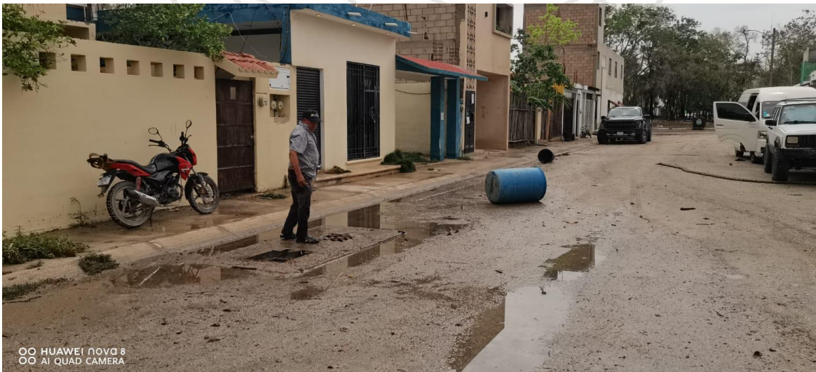
Limpieza de rejillas: Calle palma guinea entre calle palma rapiz; fraccionamiento las palmas.
