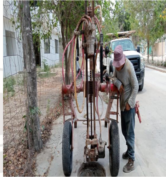
Desazolve de pozos; Calle gama oriente entre calle ori3n sur, colonia centro.
