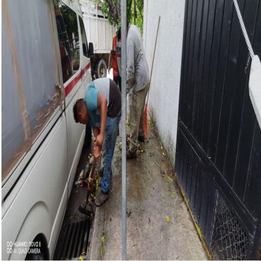
Limpieza de rejillas: Calle venus oriente entre av. satélite sur; colonia centros sur.
