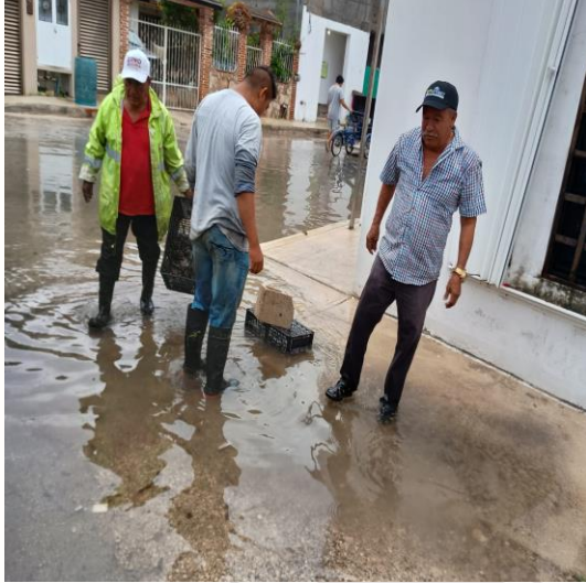
Limpieza de rejillas: Calle lexiu entre calle orión norte; colonia mayapax.
