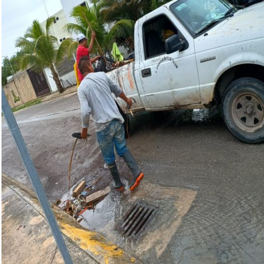
Limpieza de rejillas: Calle 4 poniente entre calle bubulek; fraccionamiento guerra de castas.
