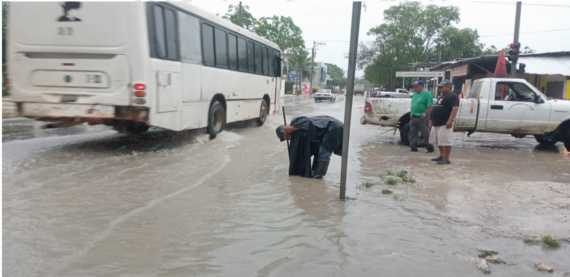
Limpieza de rejillas: Av. ook-k'ot; colonia mayapax.
