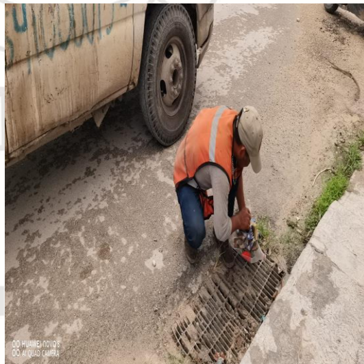
Limpeza de rejillas: Calle huracán janet entre calle huracán paulina; fraccionamiento huracanes.
