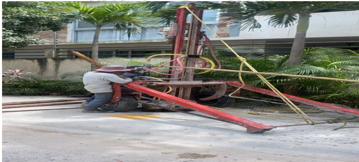
Desazolve de pozos Calle Juan-Ek entre calle Kabah y calle consejo ciudadano, fraccionamiento aldea zama.
