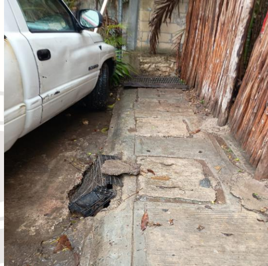
Limpeza de rejillas: Calle 2 bis oriente entre calle 11; fraccionamiento villas TULUM.
