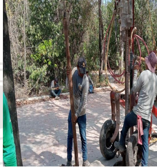
Desazolve de pozos Calle Jacinto Pat entre calle 2 oriente, colonia centro.
