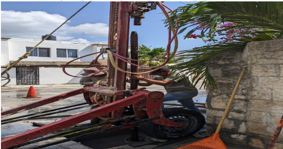
Desazolve de pozos; Calle 3 sur entre calle 2 oriente, fraccionamiento villas Tulum.
