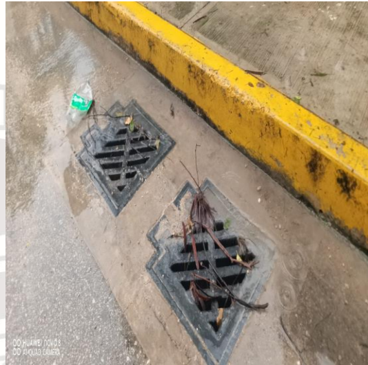
Limpeza de rejillas: Calle 3 entre calle 2 bis oriente, fraccionamiento villas Tulum.
