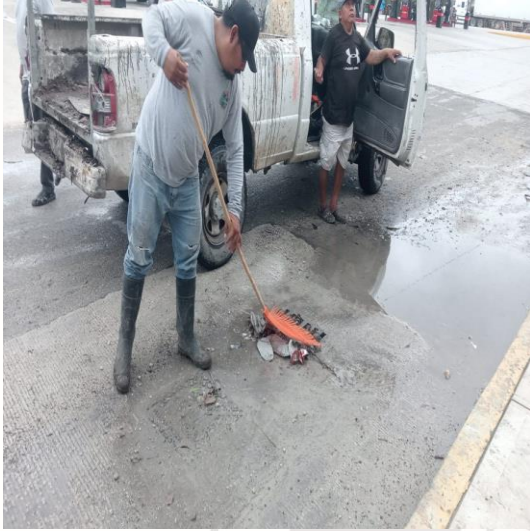
Limpieza de rejillas: Calle palma abanico entre bulevar palmas; fraccionamiento las palmas.
