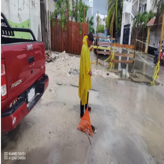
Limpieza de rejillas: Calle 5 sur entre calle 2 bis oriente; fraccionamiento villas Tulum.
