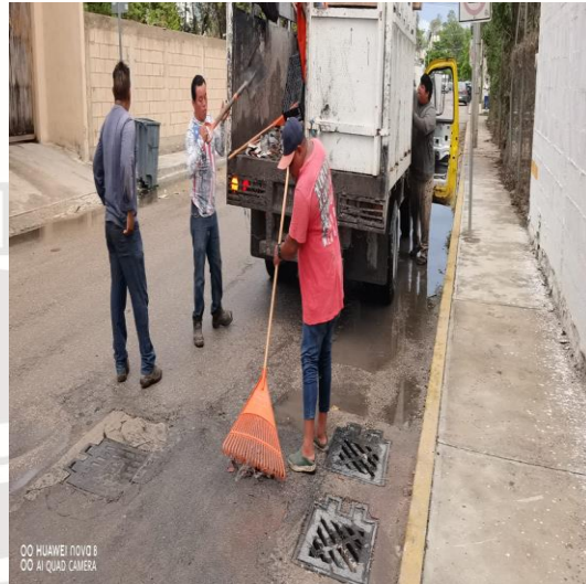
Limpieza de rejillas: Calle libra sur entre la av. Tulum y calle andrómeda; colonia lak'iin.
