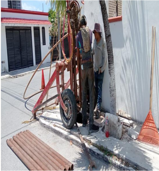
Desazolve de pozos Calle 11 entre calle 13 sur, fraccionamiento villas Tulum.
