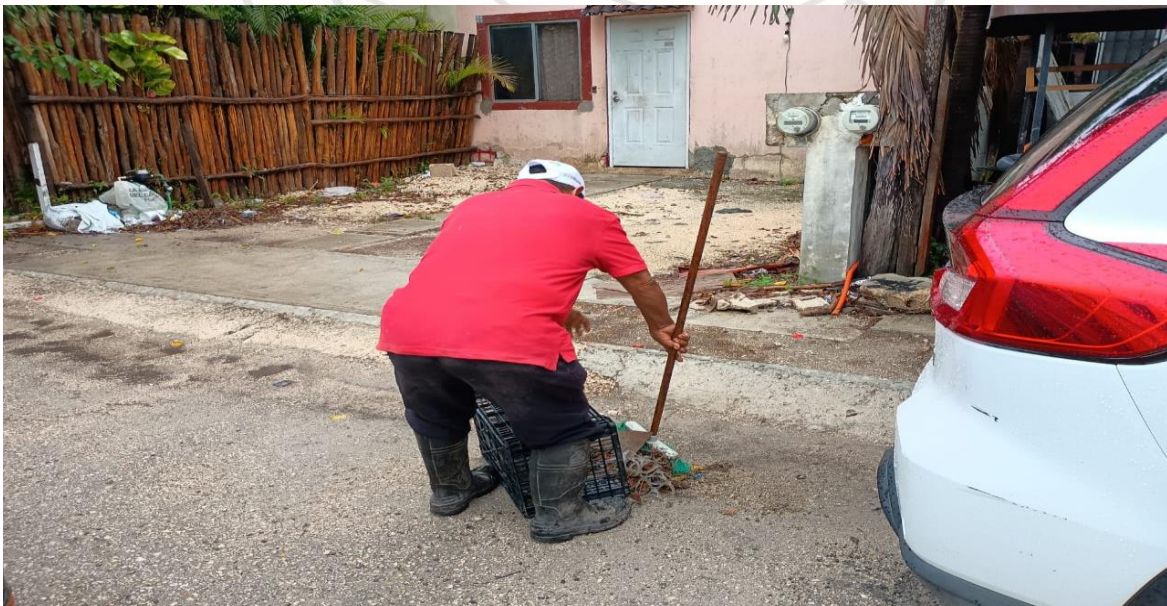
Limpieza de rejillas: Calle 2 bis oriente entre calle 5 sur; fraccionamiento villas Tulum.
