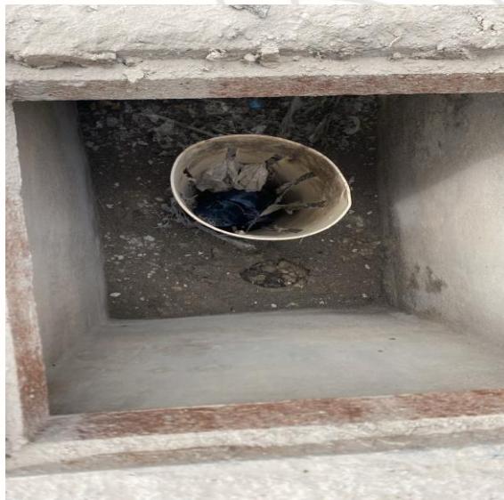
Limpieza de pozos; Calle saturno norte entre calle polar poniente; colonia centro norte.
