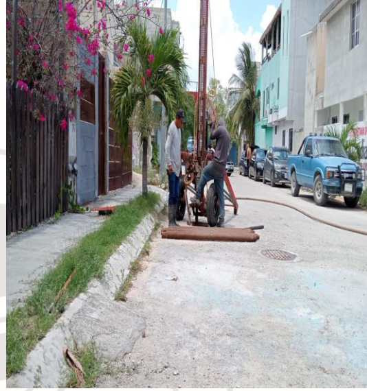
Desazolve de pozos Calle Jacinto Pat entre calle 2 oriente, colonia centro. (pozo no. 01)
