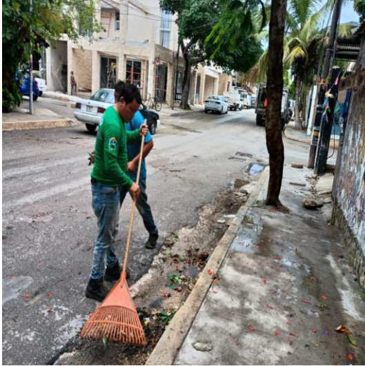
Limpieza de rejillas: Calle andrómeda oriente entre calle orión sur; colonia centro sur.
