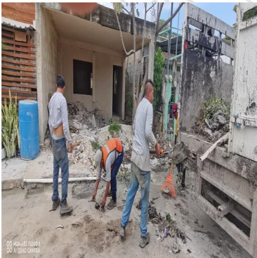
Limpeza de rejillas: Calle huracán beulah entre huracán mitch; fraccionamiento huracanes.
