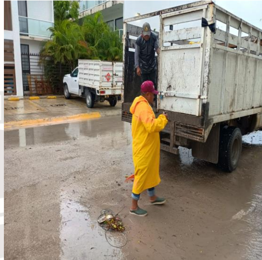
Limpeza de rejillas: Calle 5 sur entre calle 4 poniente; fraccionamiento villas TULUM.
