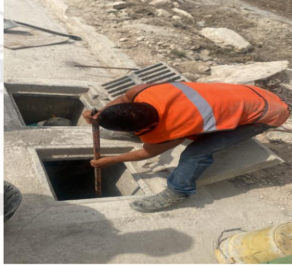
Limpeza de pozos; Av. 10 norte bis entre calle jaaleb y calle kitam; colonia ejido norte. Pozo 02.
