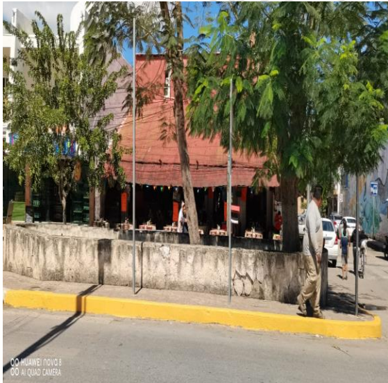
Pintura; Realización de pintura en el camellón central de la av. Tulum; colonia centro.
