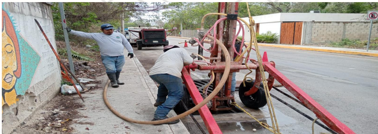
Desazolve de pozos Calle 3 bis sur entre calle 2 bis oriente y av. Tulum. Fraccionamiento villas Tulum. (pozo no. 02)
