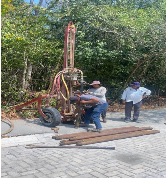
Desazolve de pozos Calle Kabah entre calle iximche, fraccionamiento aldea zama.
