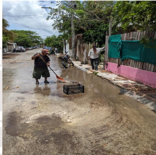
Limpeza de rejillas: Calle 15 entre calle 4 orientes; fraccionamiento villas Tulum.
