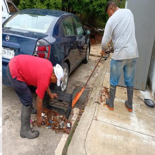
Limpieza de rejillas: Calle 2 bis oriente entre calle 7 sur; fraccionamiento villas Tulum.
