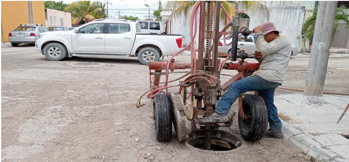
Desazolve de pozos Calle 2 bis entre calle 5 sur, Fraccionamiento villas Tulum.
