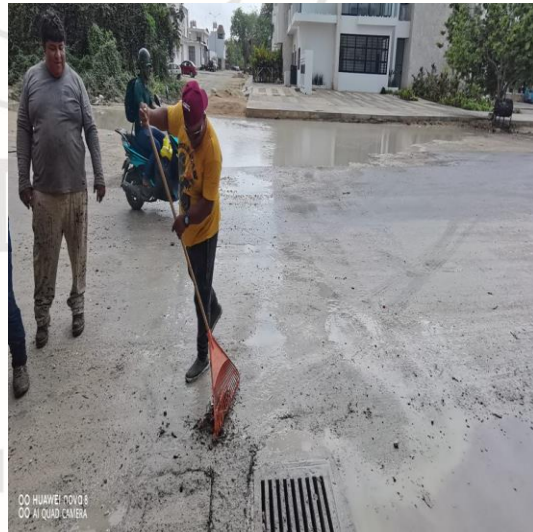
Limpieza de rejillas: Av. palmas Tulum entre calle 2 norte; fraccionamiento palmas.
