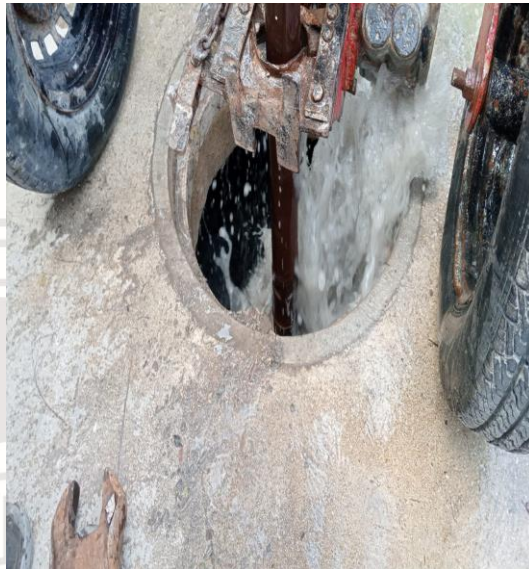
Desazolve de pozos Av. Juan-Ek entre calle balam dzacab y calle Kabah, fraccionamiento aldea zama.
