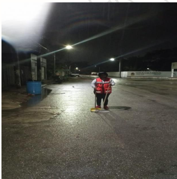
Calle 4 oriente entre av. satélite norte y calle júpiter norte.
