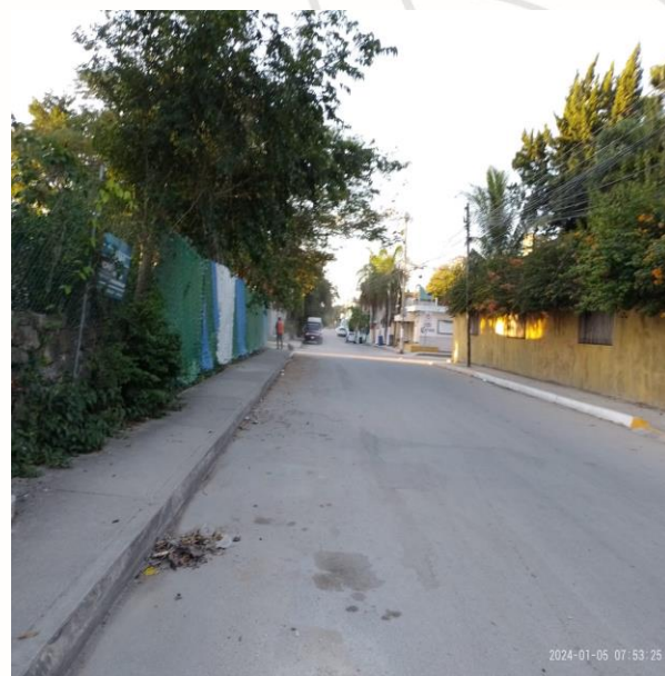
Calle neptuno poniente entre calle júpiter sur y calle alfa sur (sector 1).
